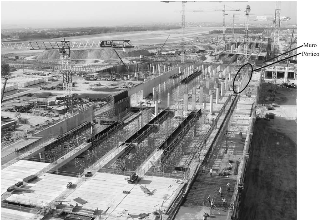
Figura 1. Vista aérea de la construcción del dique Norte del Edificio Satélite de la Nueva ÁREA Terminal del Aeropuerto de Barajas. En la imagen se ha señalado la ubicación de los elementos instrumentados.
