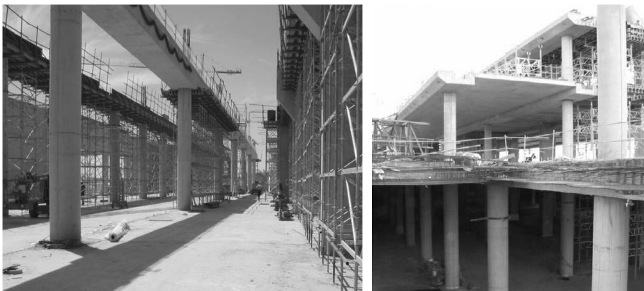
Figura 12. Vistas del pórtico instrumentado durante la construcción.
