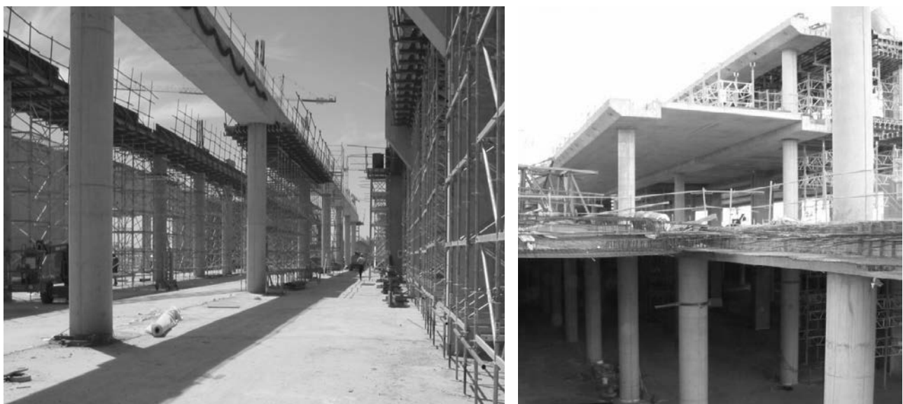
Figura 12. Vistas del pórtico instrumentado durante la construcción.
