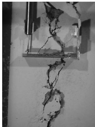
Figura 10. PC-JC. Estado en el que se encontraban las llaves en la fase de prerrotura.
