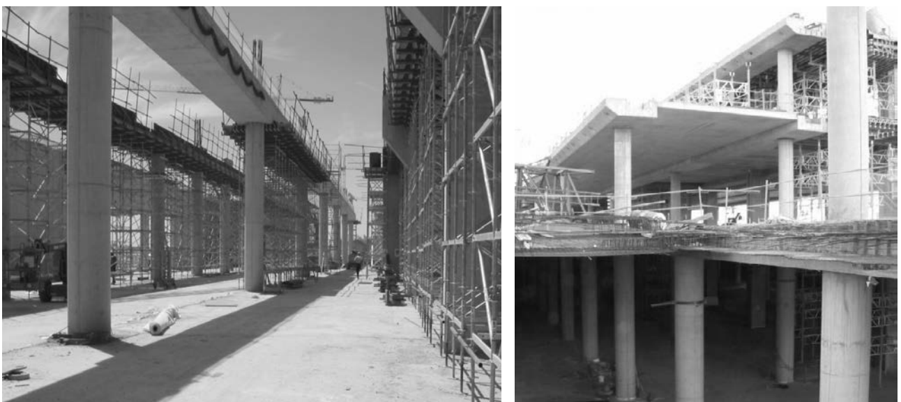
Figura 12. Vistas del pórtico instrumentado durante la construcción.
