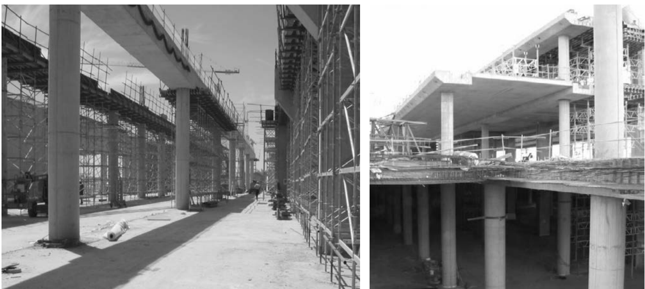
Figura 12. Vistas del pórtico instrumentado durante la construcción.
