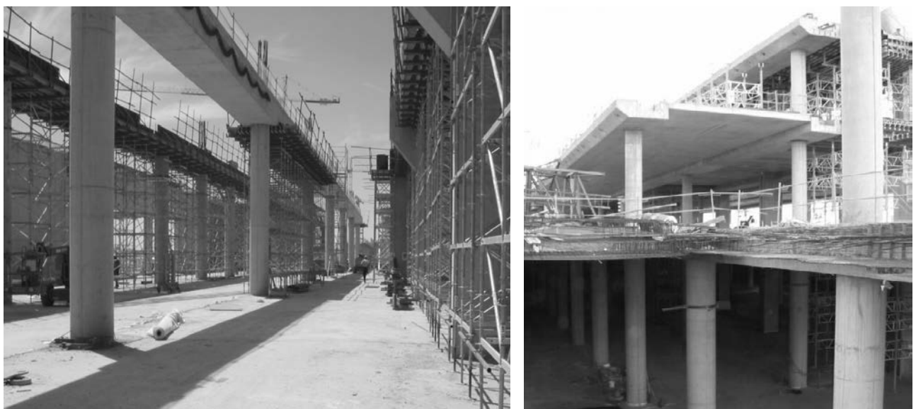
Figura 12. Vistas del pórtico instrumentado durante la construcción.
