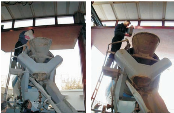
Figura 12. Introducción de las fibras y el aditivo
