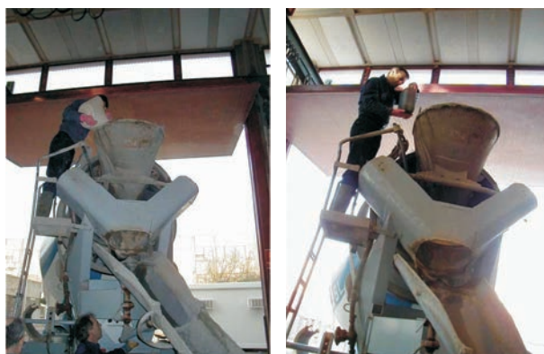
Figura 12. Introducción de las fibras y el aditivo
