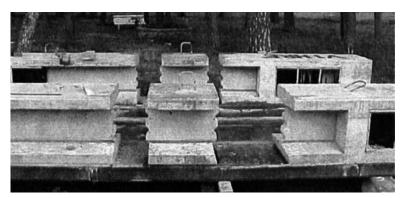
Figura 22. Segmentos de las vigas después del desmolde.
