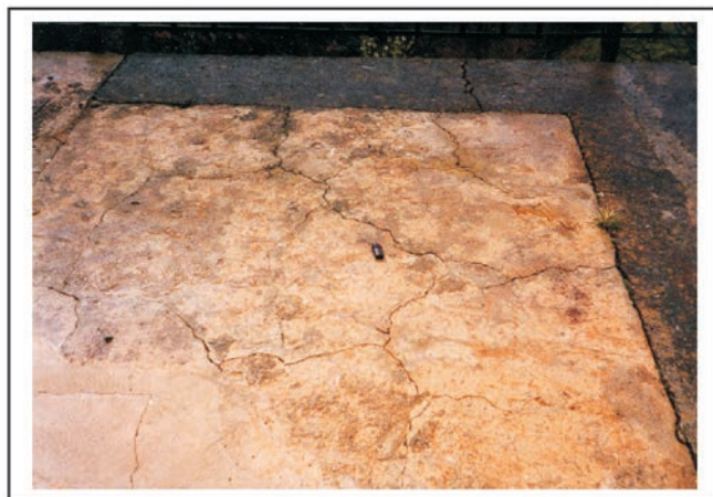
Figura 2. Fisuración enramada característica de hormigones con expansiones: a) Pilar pórtico auxiliar presa Belesar. b) coronación presa Tabescán
