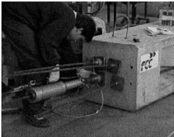
Figura 23. Operación de postesado.
