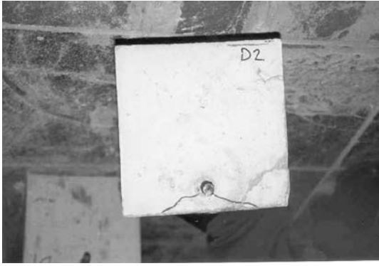
Figura 11. Fisuras radiales en el extremo pasivo (splitting) (probeta D2).
