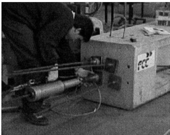
Figura 23. Operación de postesado.
