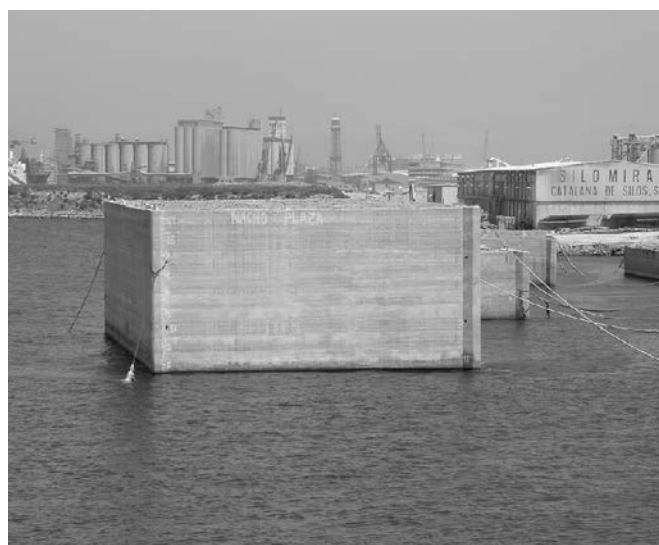
Foto1. Cajón portuario recién construido en el Puerto de Barcelona (UTE Nueva Bocana).
