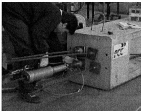
Figura 23. Operación de postesado.
