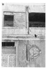
Figura 2. Degradación de estructura en ambiente agresivo.
