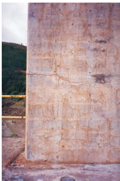
Figura 2. Fisuración enramada característica de hormigones con expansiones: a) Pilar pórtico auxiliar presa Belesar. b) coronación presa Tabescán
