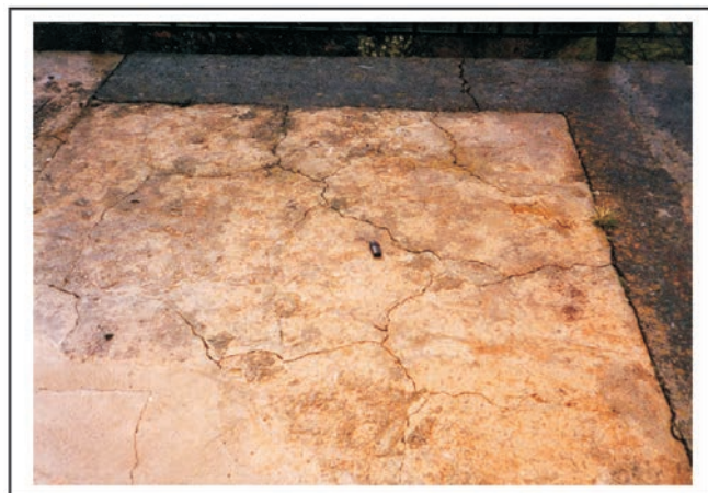
Figura 2. Fisuración enramada característica de hormigones con expansiones: a) Pilar pòrtico auxiliar presa Belesar. b) coronación presa Tabescán
