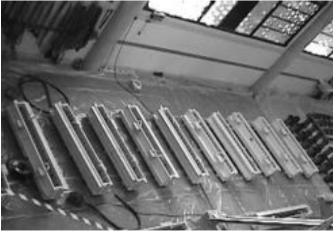
Figura 1. Vista de los encofrados para el hormigonado de las vigas.
