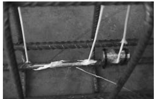
Figura 3. Detalle de los 3 tipos de sensor de fibra óptica para detección de corrosión colocados en la armadura: helicoidal sobre barra (en el centro), radial (a la izquierda) y helicoidal sobre testigo (a la derecha).
