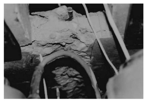
Foto 1. Rotura por compresión de la losa inferior.
