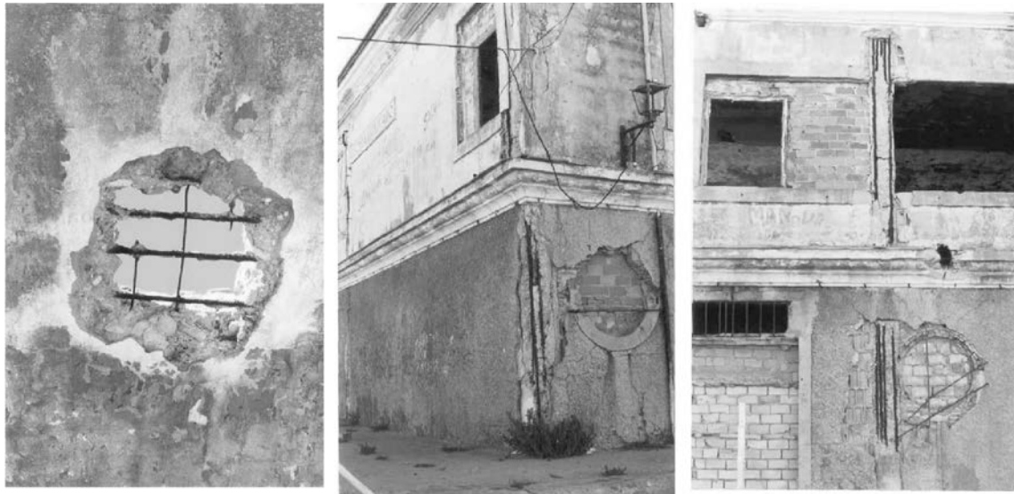
Figura 2. Degradación de estructura en ambiente agresivo.
