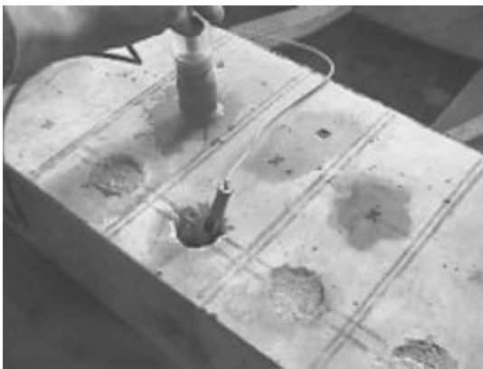
Fotografía 5. Medición de Potencial.
