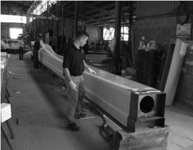
Figura 12: Detalle de colocación de una banda de CFRP sobre el molde
