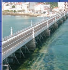
Puente de La Toja
