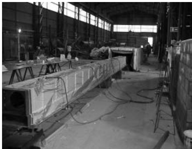
Figura 14: Colocación del túnel de curado sobre molde y vigas.
