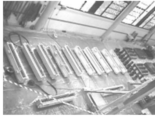
Fotografía 1. Vista general de la fase de hormigonado.
