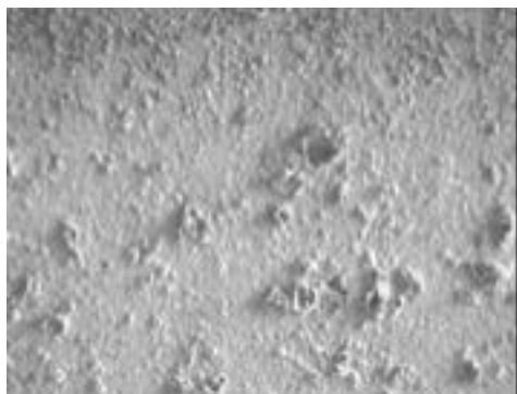
Fotografía 11. Explosiones en la superficie de las vigas.
