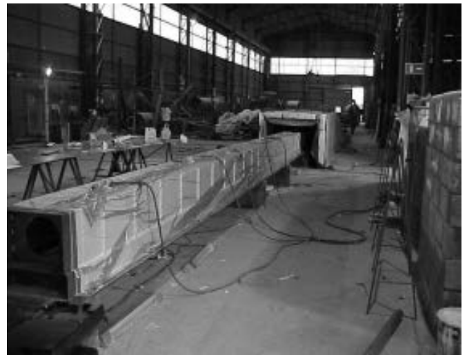
Figura 14: Colocación del túnel de curado sobre molde y vigas.
