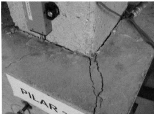
Figura 12. Detalle del agrietamiento de las piezas tras el ensayo.
