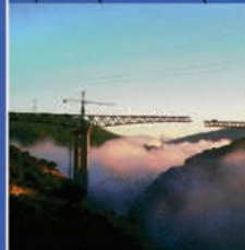
Puente sobre el Río Sil en Ponferrada
