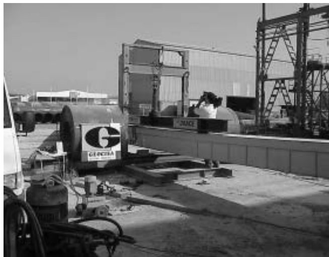
Figura 17: Vista general de la instalación de ensayo a escala real en Sagunto.
