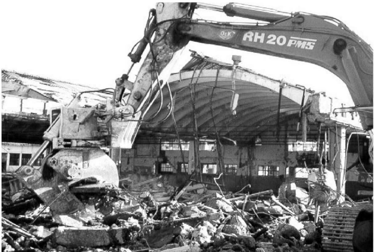
Fotografía 1. Proceso de demolición.
