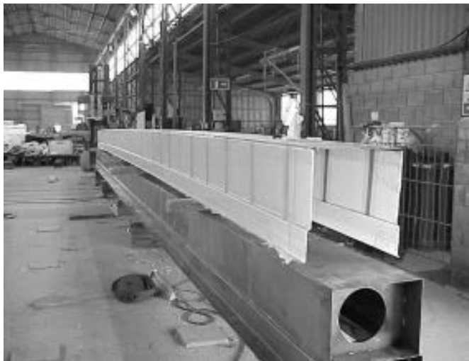
Figura 15: Vista general de la viga de composite sacada del molde.
