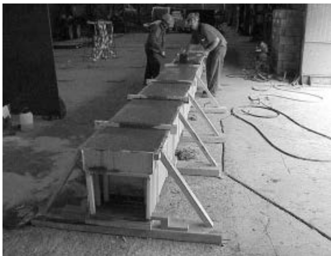
Figura 16: Proceso de hormigonado de la cabeza superior de la viga.
