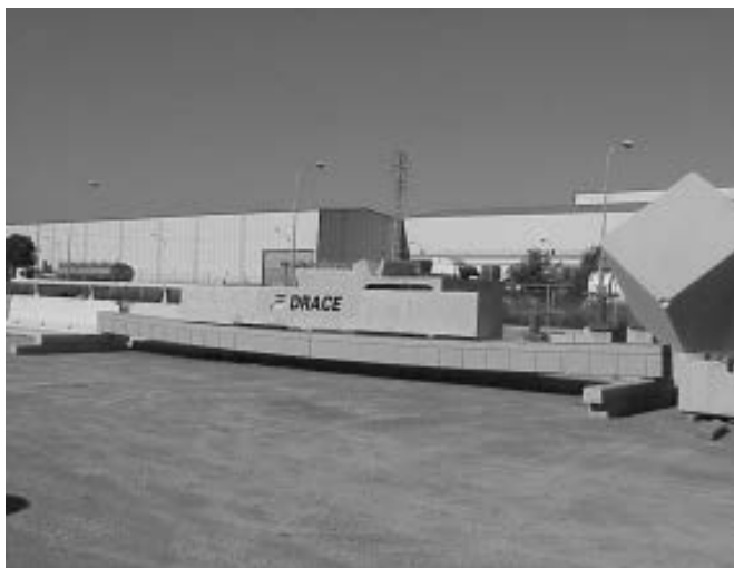
Figura 18: Vista general del ensayo a escala real de larga duración en Sagunto.
