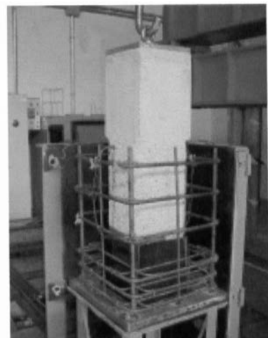
Figura 9. Detalle del pilar en molde y armado.
