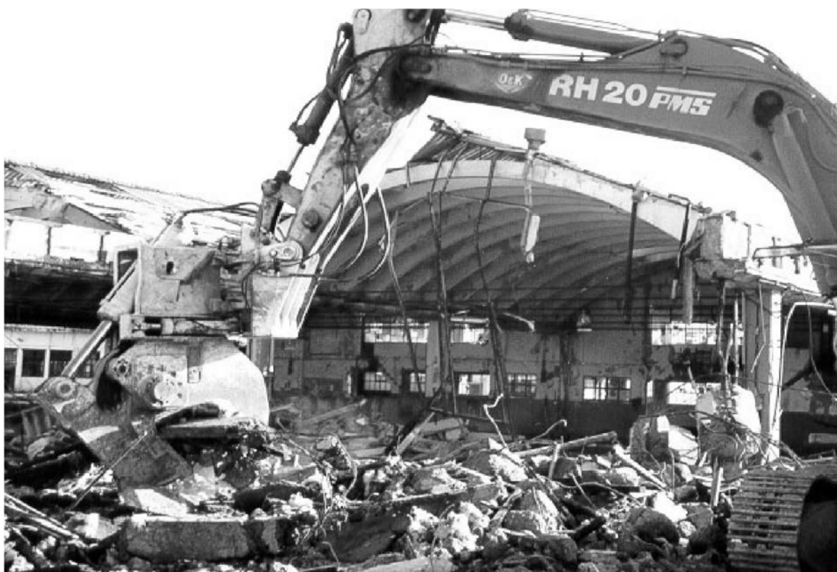
Fotografía 1. Proceso de demolición.
