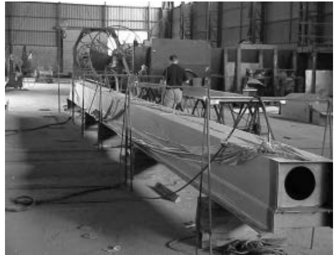
Figura 13: Vista general del compactado al vacío de las capas.
