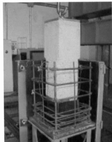
Figura 9. Detalle del pilar en molde y armado.
