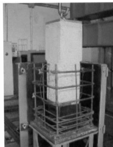
Figura 9. Detalle del pilar en molde y armado.
