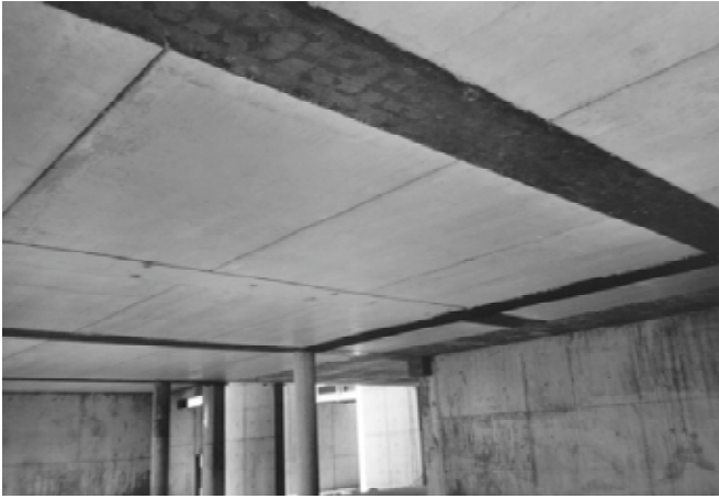
Foto 35. Vista interior estructura testero acabada.
