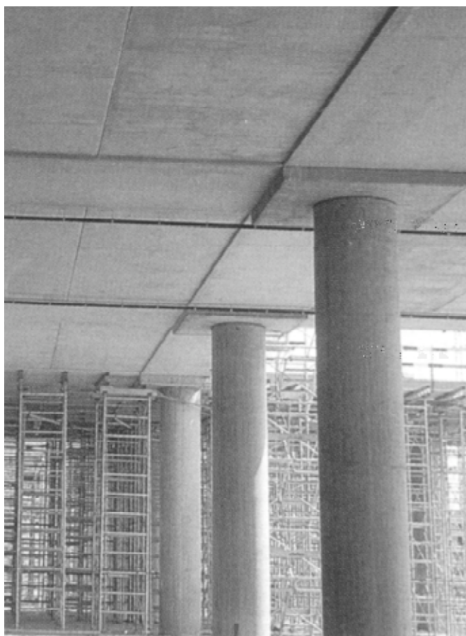
Foto 37. Vista interior estructura aeropuerto de Bruselas con prelosas.
