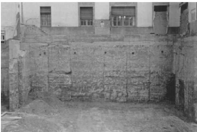
Foto 23. Muro pantalla recalce cimentación escuela.
