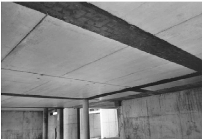
Foto 35. Vista interior estructura testero acabada.
