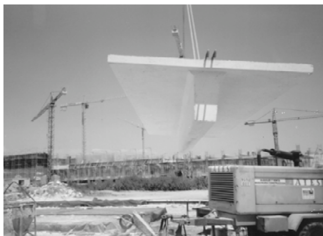
Foto 14. Placa Armada Nervada de hormigón blanco.
