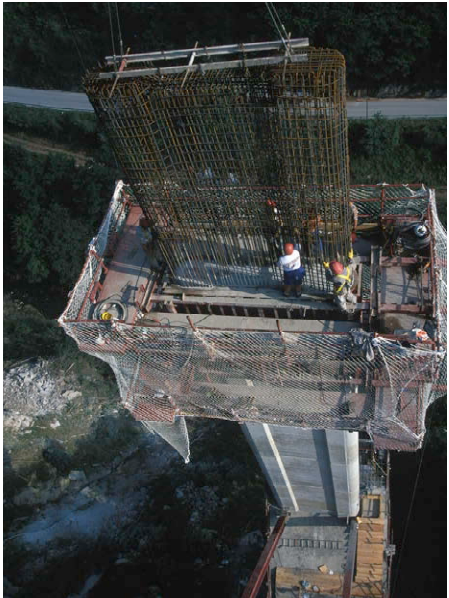
Figura 8. Colocación de la ferralla de la última prepa. Pilar 4.
