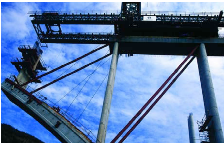
Figura 1. Vista de un semiarco durante la construcción. Figure 1. A semiarch during construction.
