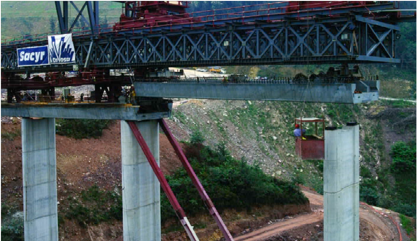
Figura 13. Montaje de una viga. Obsérvense los dos mecanismos de elevación. Figure 13. Installation of a beam. Please note the two lifting mechanisms.
