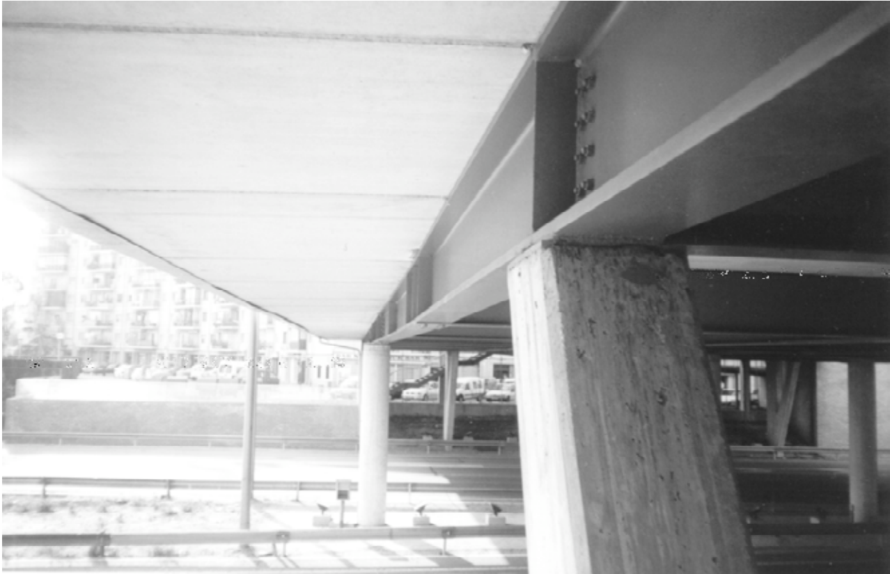
Foto 22. Pasarela de conexión peatonal. Barrio del Besós.
