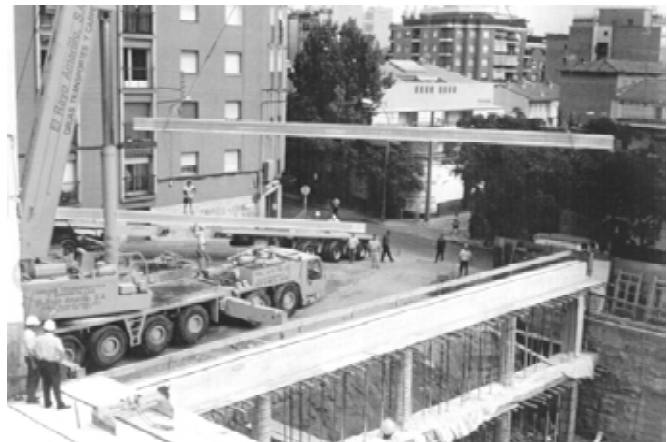
Foto 24. Superplaca Alveolar pretensada HORMIPRESA.
