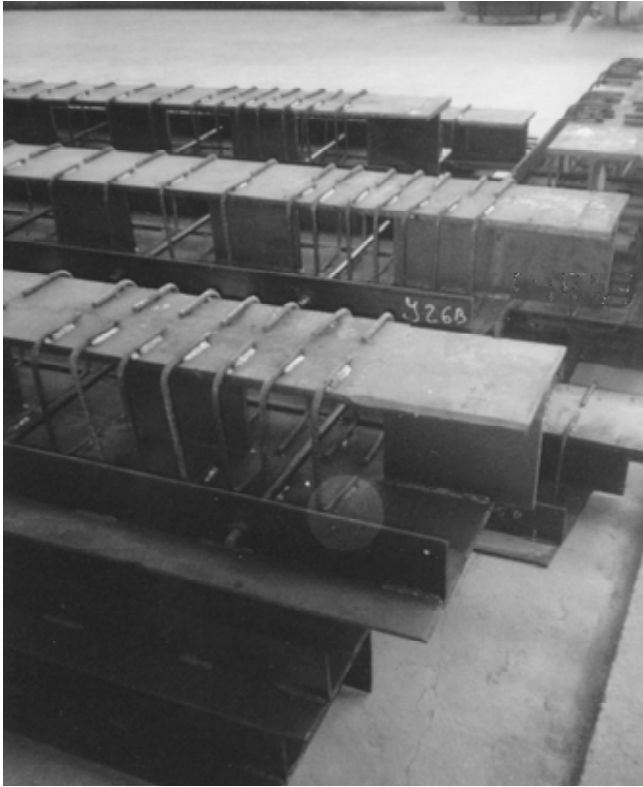
Foto 29. Carcasa metálica jácenas.
