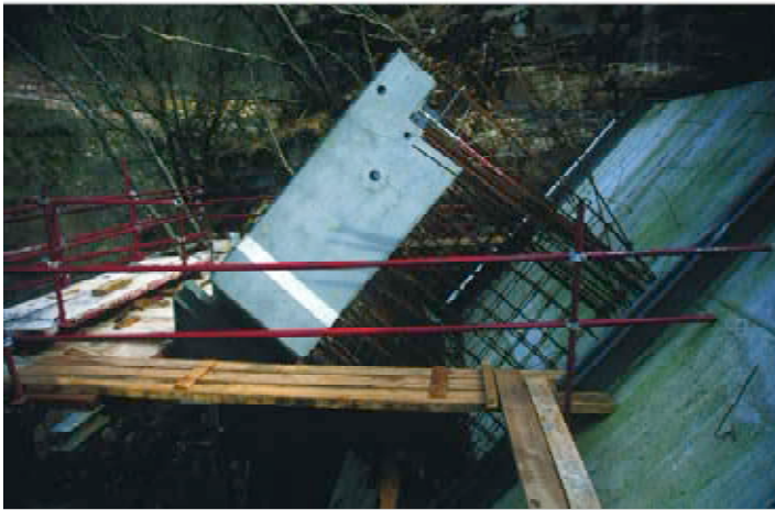
Figura 11. Dovela cero en posición y antes del hormigonado a la zapata. Esquema de fases de hormigonado. Figure 11. Zero segment in position before being concreted to the sill. Diagram of concreting stages.
