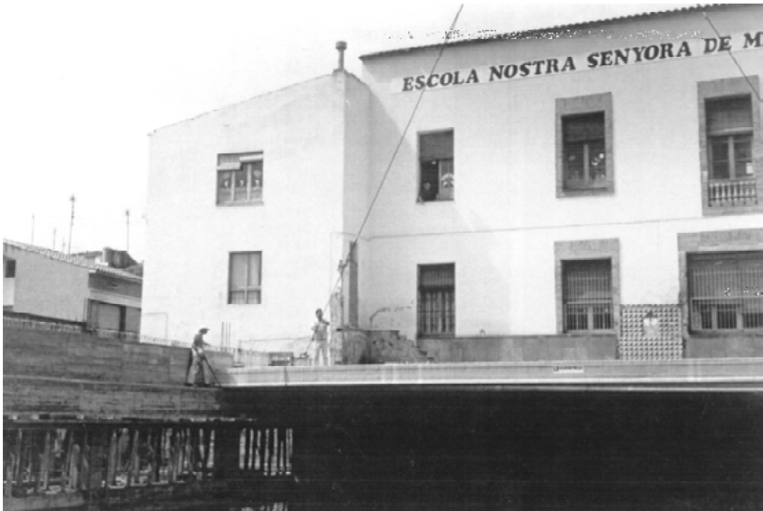
Foto 25. Vista exterior durante la colocación de placas.
