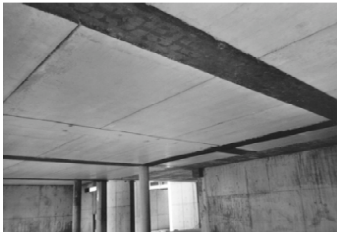
Foto 35. Vista interior estructura testero acabada.
