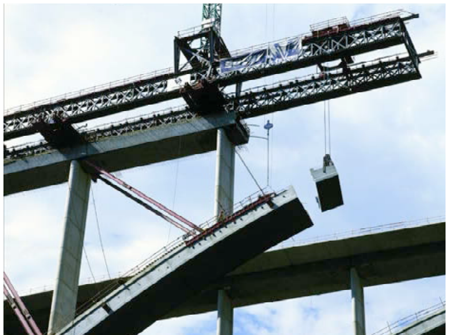
Figura 12. Montaje de una dovela prefabricada. Figure 12. Installation of a precast segment.
