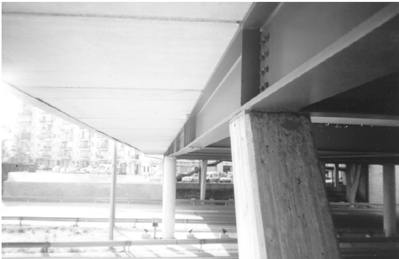
Foto 22. Pasarela de conexión peatonal. Barrio del Besós.
