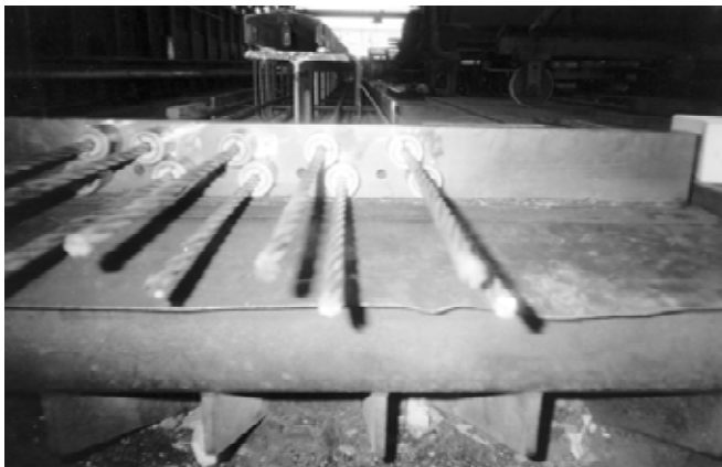
Foto 30. Cables de pretensado. Armaduras activas,
