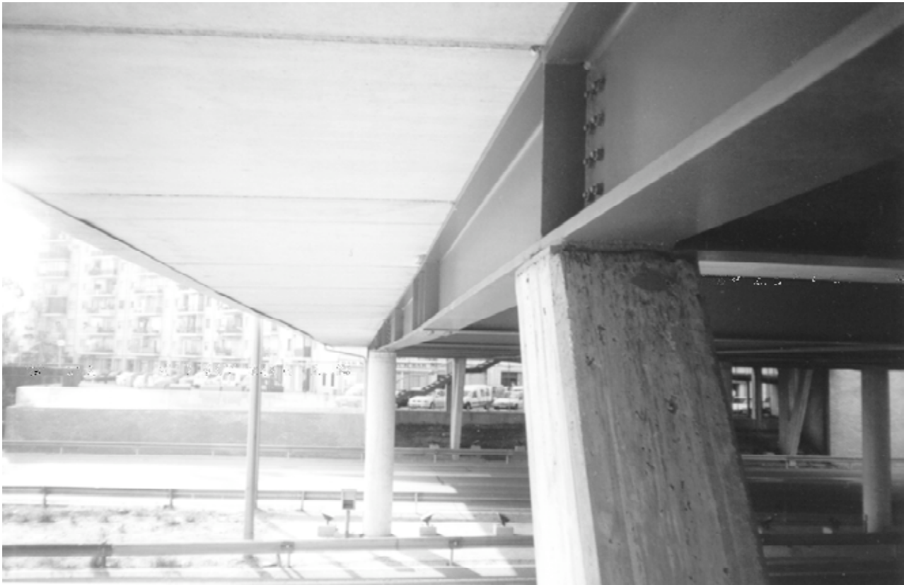
Foto 22. Pasarela de conexión peatonal. Barrio del Besós.
