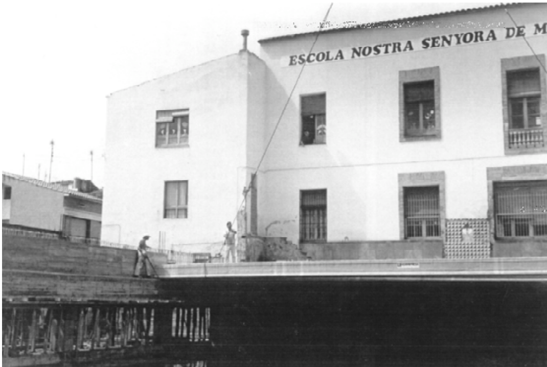
Foto 25. Vista exterior durante la colocación de placas.
