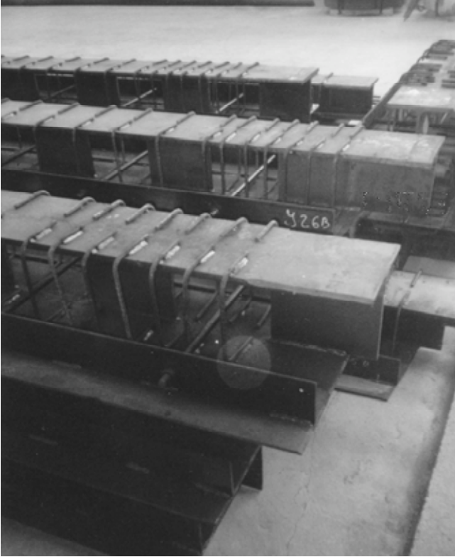
Foto 29. Carcasa metálica jácenas.
