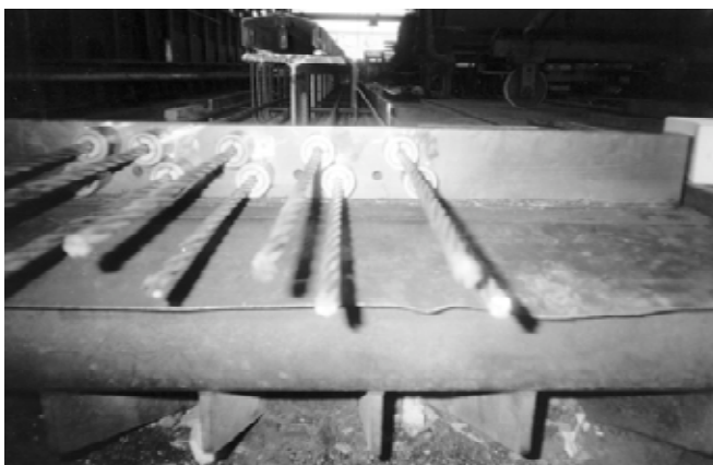
Foto 30. Cables de pretensado. Armaduras activas,
