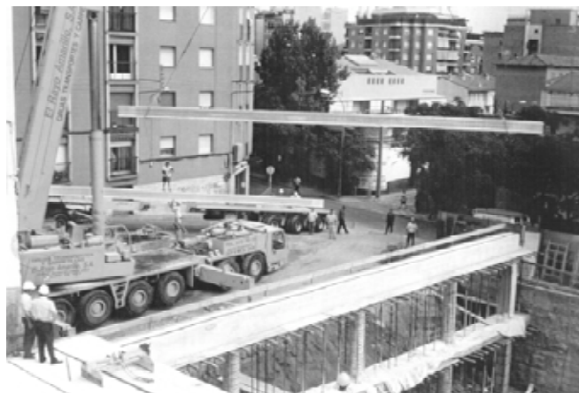
Foto 24. Superplaca Alveolar pretensada HORMIPRESA.
