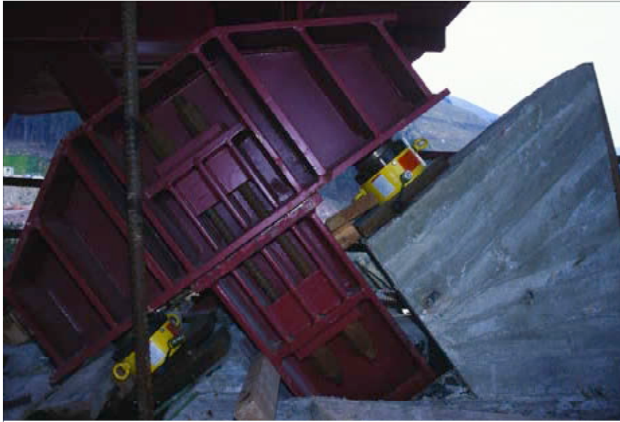
Figura 14. Gatos de retesado de los tirantes sobre el tablero. Figure 14. Hydraulic jacks for the tie rods fixed into the deck.
