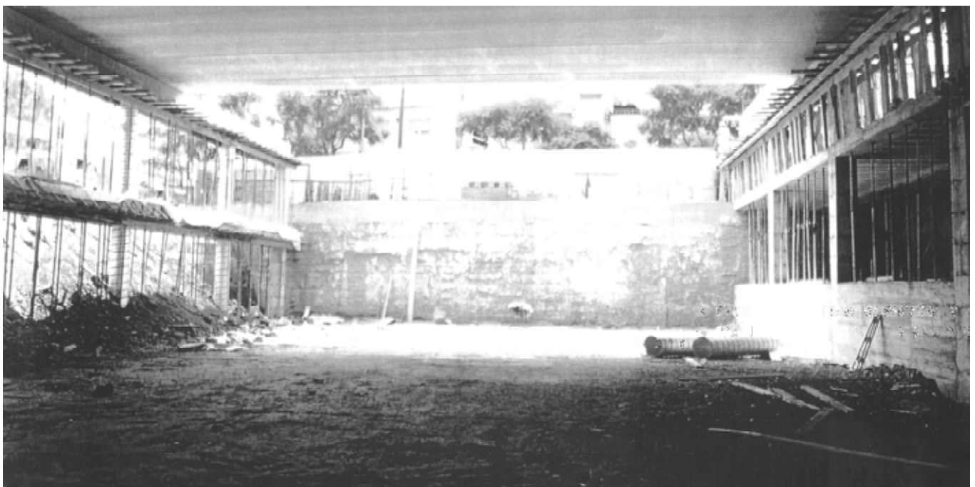
Foto 26. Vista interior durante la colocación de placas.
