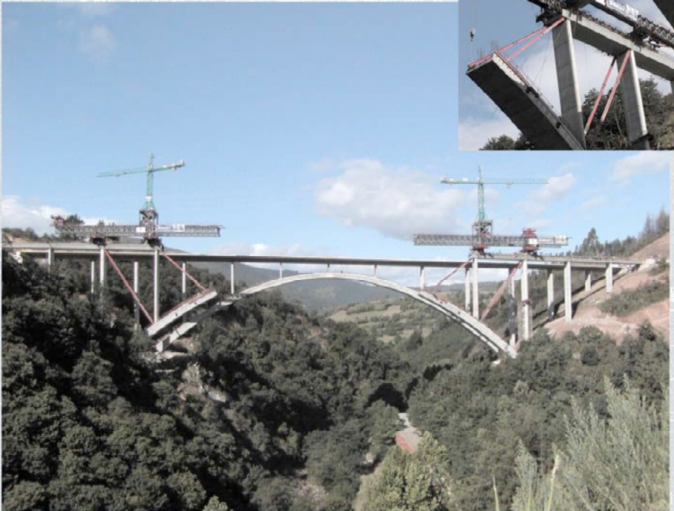
Viaducto de Cieza. Autovía Cantabria - Meseta. Subtramo: Corrales de Buelna (sur) - Molledo
