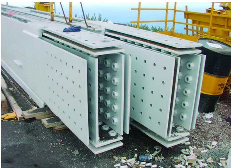
Figura 20. Unión machi-hembra. Figure 20. Box and pin.
