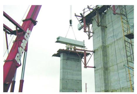
Figura 13. Colocación de traviesa *Figure 13. Placing of sleeper.*
