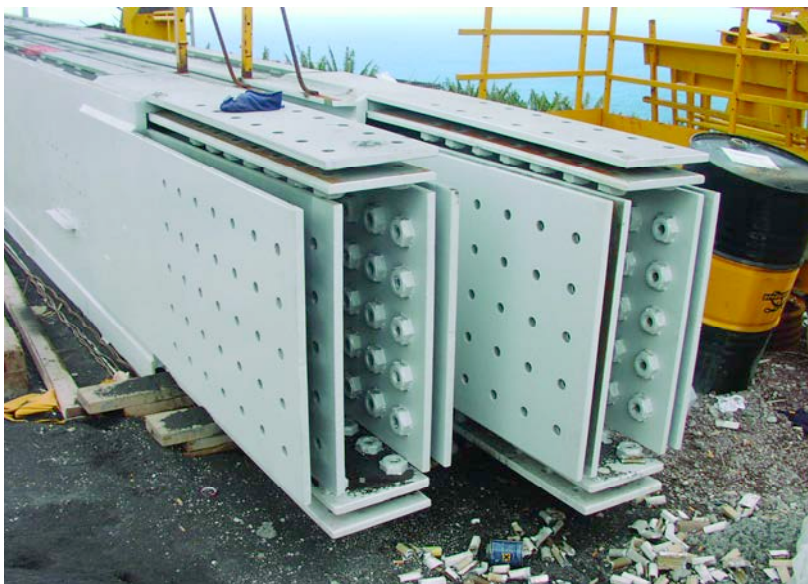
Figura 20. Unión machi-hembra. Figure 20. Box and pin.
