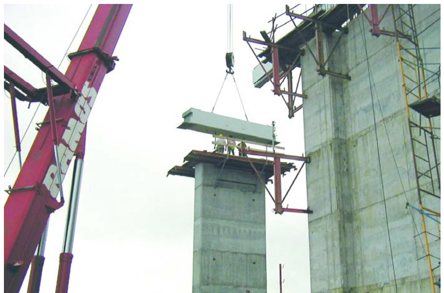
Figura 13. Colocación de traviesa Figure 13. Placing of sleeper.
