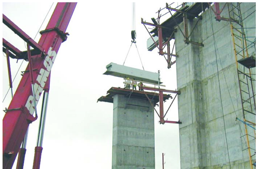
Figura 13. Colocación de traviesa Figure 13. Placing of sleeper.
