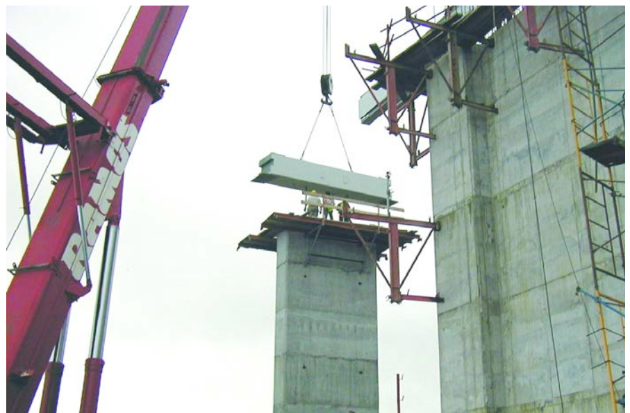
Figura 13. Colocación de traviesa Figure 13. Placing of sleeper.
