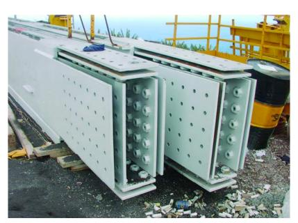
Figura 20. Unión machi-hembrada. Figure 20. Box and pin.
