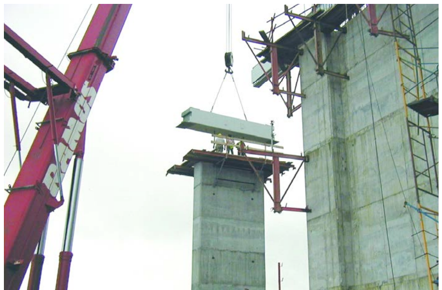
Figura 13. Colocación de traviesa Figure 13. Placing of sleeper.
