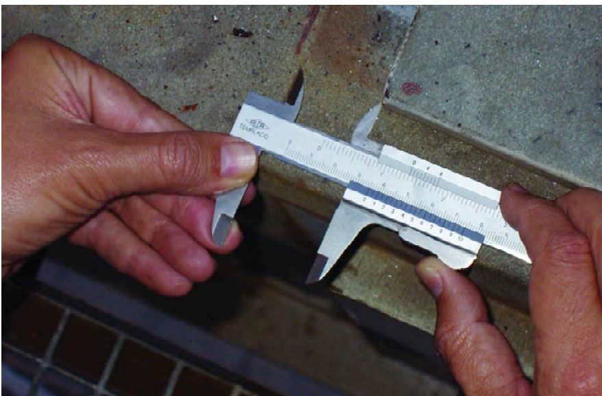
Figura 23. Deslizamiento de unión 2-3. Figure 23. Sliding of union 2-3-
