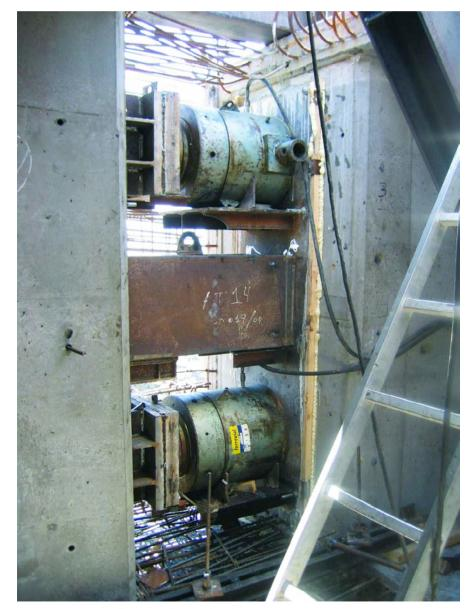
Figura 17. Gatos colocados para apertura en clave. Figure 17. Jacks placed for crown jack opening.
