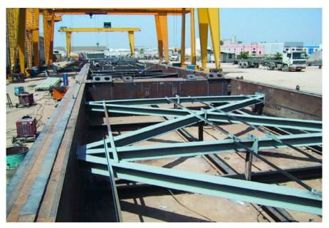
Figura 16. Arriostramiento horizontal. *Figure 16. Cross bracing.*
