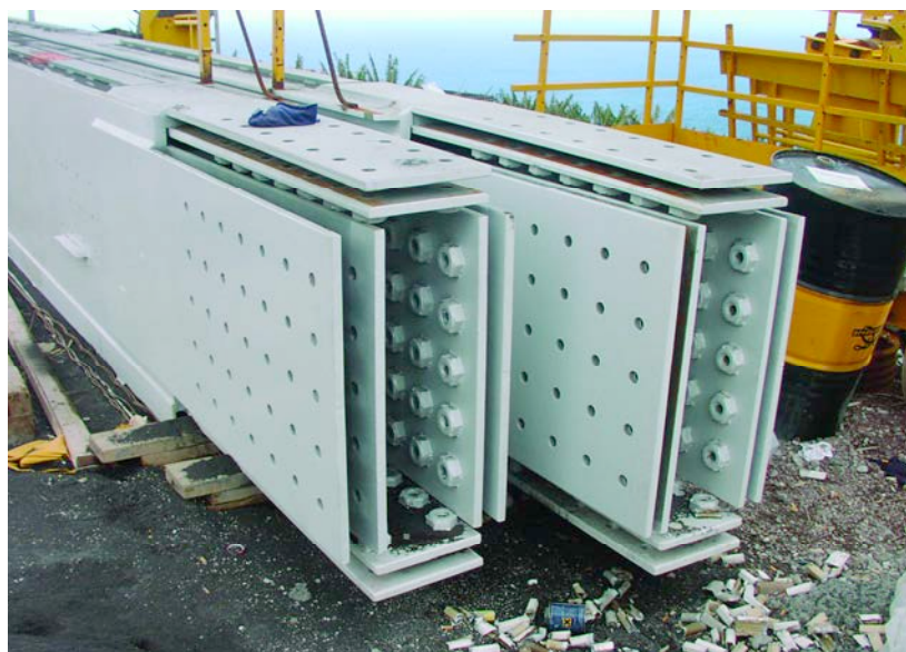
Figura 20. Unión machi-hembra. Figure 20. Box and pin.
