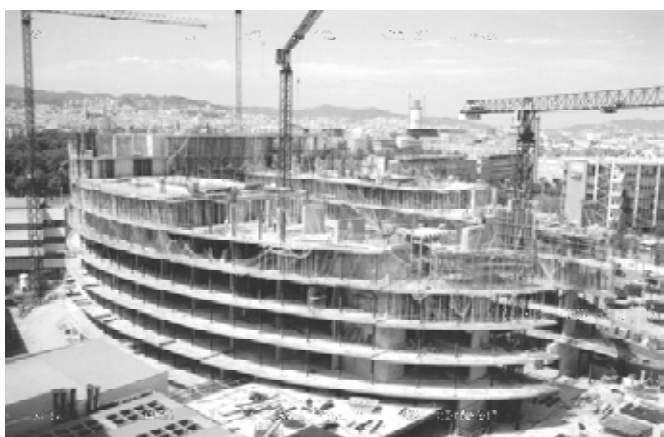
Ejecución de forjados apeados (Septiembre 2003).
