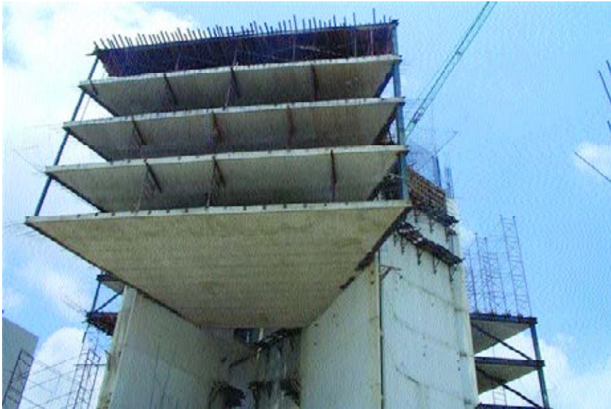
Figura 3. Entrada principal del edificio con luz libre en fachada de 22 m resuelto con forjados postensados de canto 40 cm (relación L/55) simplemente apoyados en las vigas celosía metálicas laterales. Las pletinas metálicas frontales están embebidas en los forjados para la posterior sujeción de la estructura de fachada.
