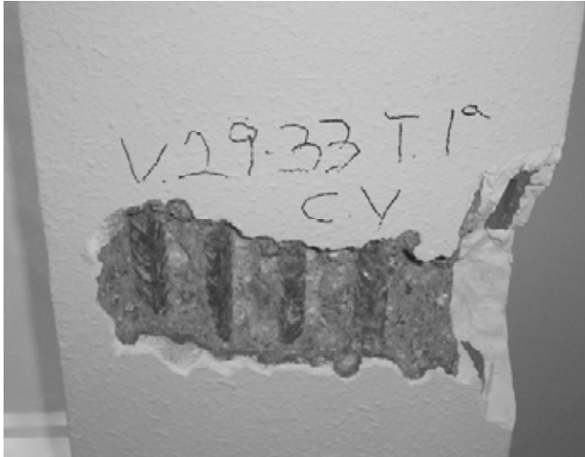
Figura 6. Comprobación del armado de una viga.
