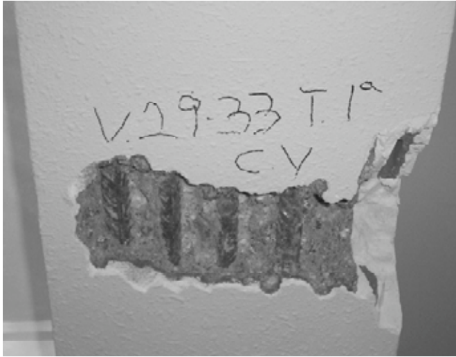
Figura 6. Comprobación del armado de una viga.
