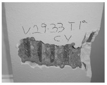
Figura 6. Comprobación del armado de una viga.
