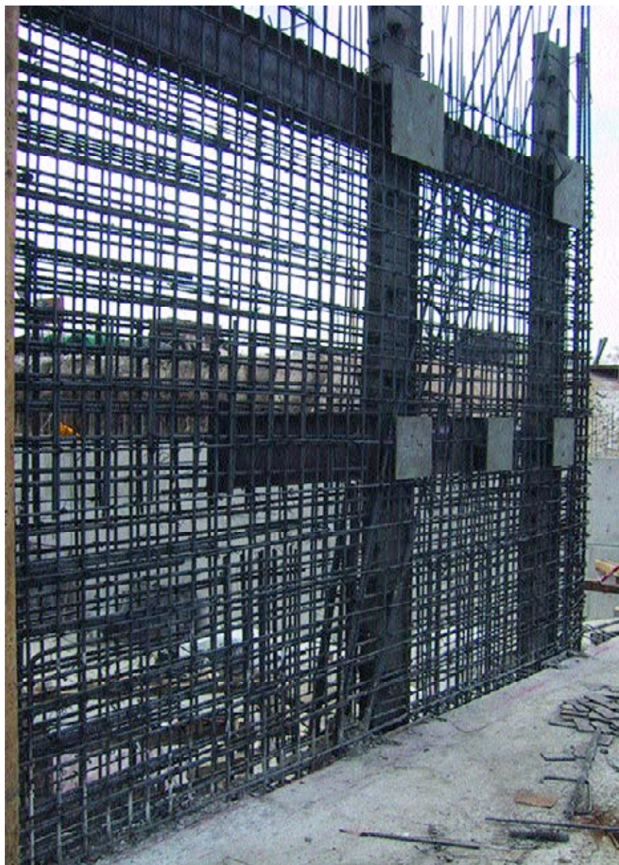
Figura 15. Conexión entre los muros de hormigón y las vigas pared de acero (plantas inferiores suspendidas).
