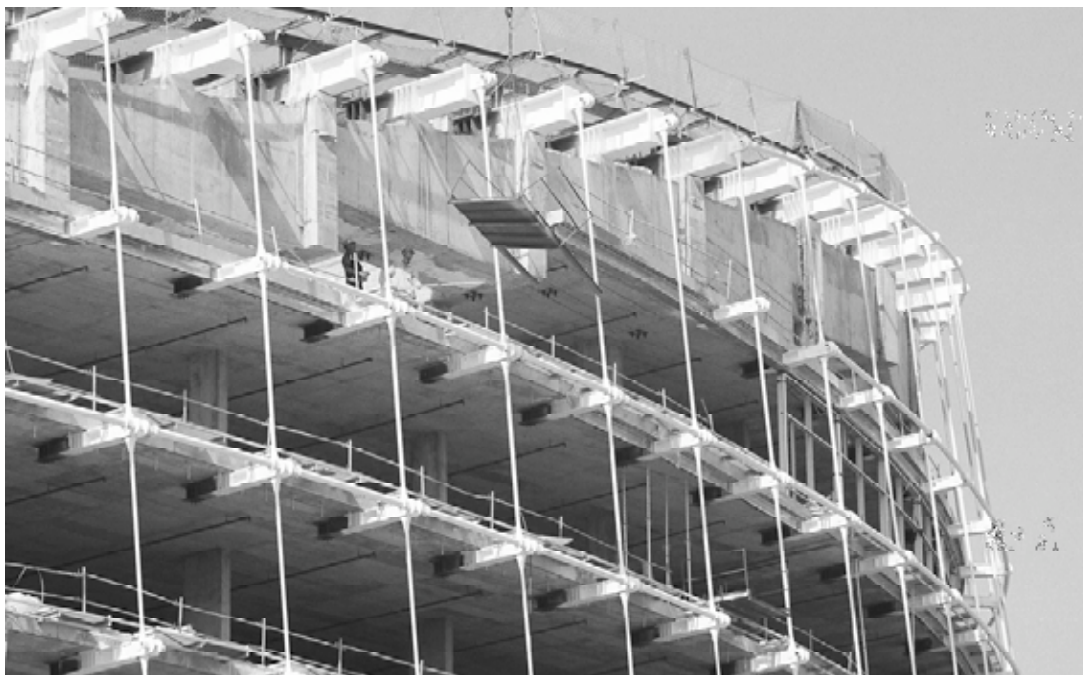
Figura 13. Detalle de tirantes exteriores, tetones exteriores de cuelgue de forjados, y tetones superiores de cuelgue exterior.
