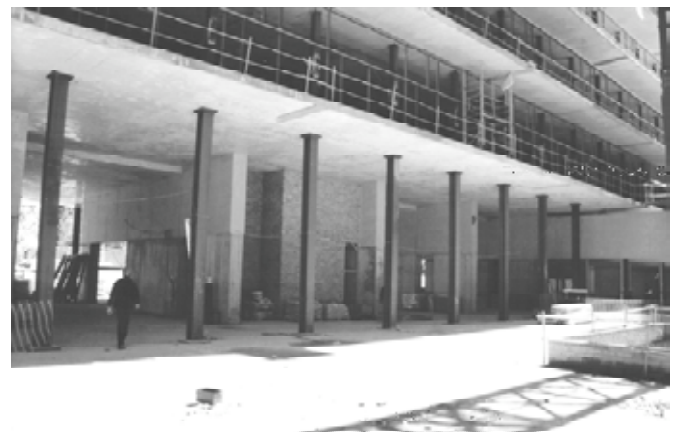
Figura 9. Apeos HEB 300 cada 3,60 m bajo los tirantes interiores.
