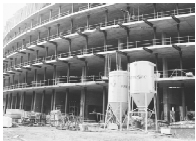
Figura 10. Forjados apeados exteriormente cada 3,60 m durante las fases constructivas.
