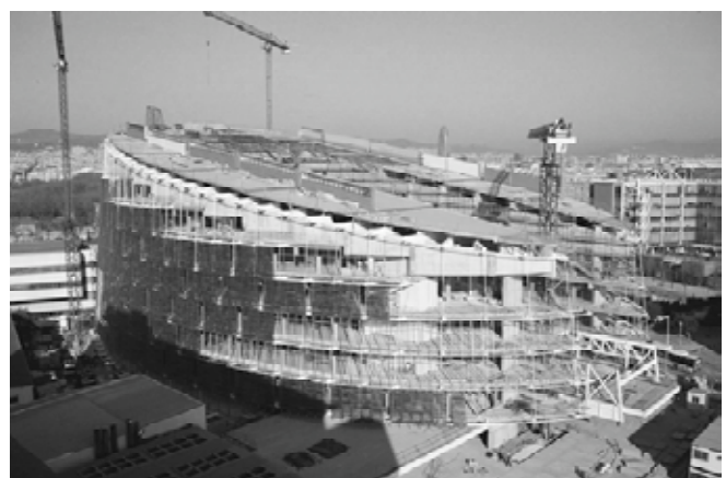
Ejecución de fachada exterior (Diciembre 2004).
