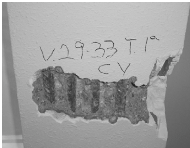
Figura 6. Comprobación del armado de una viga.
