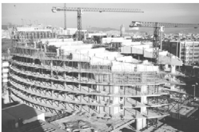
Ejecución de estructura superior de cuelgue (Enero 2004).
