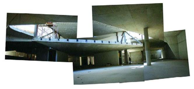
Figura 7. Teniendo el trabajador como referencia la fotografía muestra el vano de 16 m con sus 9 m de voladizo, suspendiendo el techo plano con los tirantes diagonales y cordones horizontales. El trabajador está en la planta sótano -1. Las pletinas frontales están embebidas en el forjado para el apoyo de los elementos de fachada, la cual es en madera de Finlandia.
