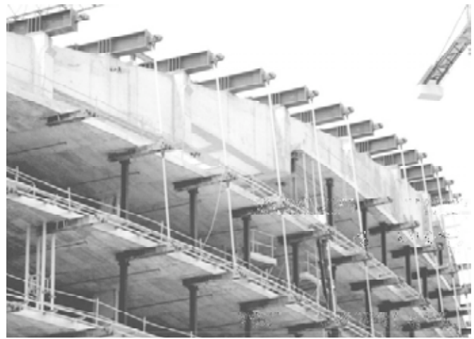
Figura 25. Doble riostra exterior.
