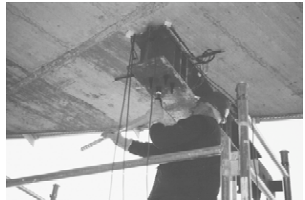
Figura 15. Ensayo de calibración de las uniones pretensadas, instrumentalizando los T.A.R.
