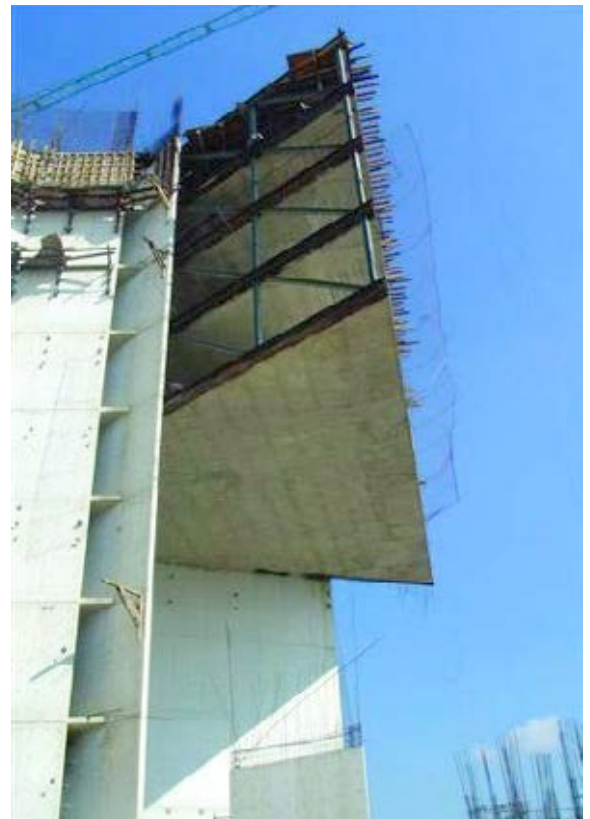
Figura 2. Vista lateral de módulo de oficinas con el voladizo principal de, aproximadamente, 8m y vista por debajo de la dirección de las viguetas postensadas.
