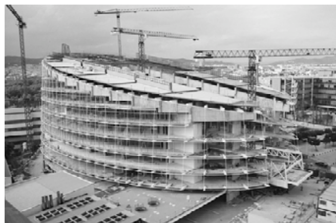
Desapeo y cuelgue del edificio (Septiembre 2004)
