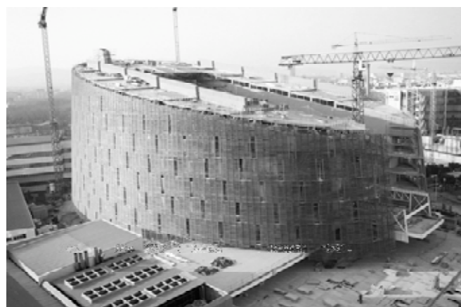
Fachada exterior concluida (Marzo 2005).
