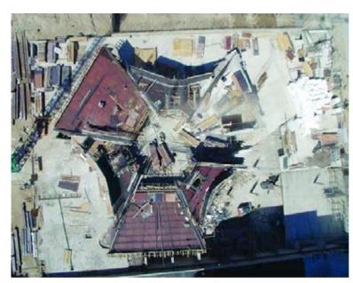
Figura 1. Vista en planta que muestra 2 módulos de oficinas, 3 núcleos de servicios y el área central interior para iluminación natural. En el módulo inferior se aprecia, además, la dirección de las viguetas postensadas paralelas a su fachada.
