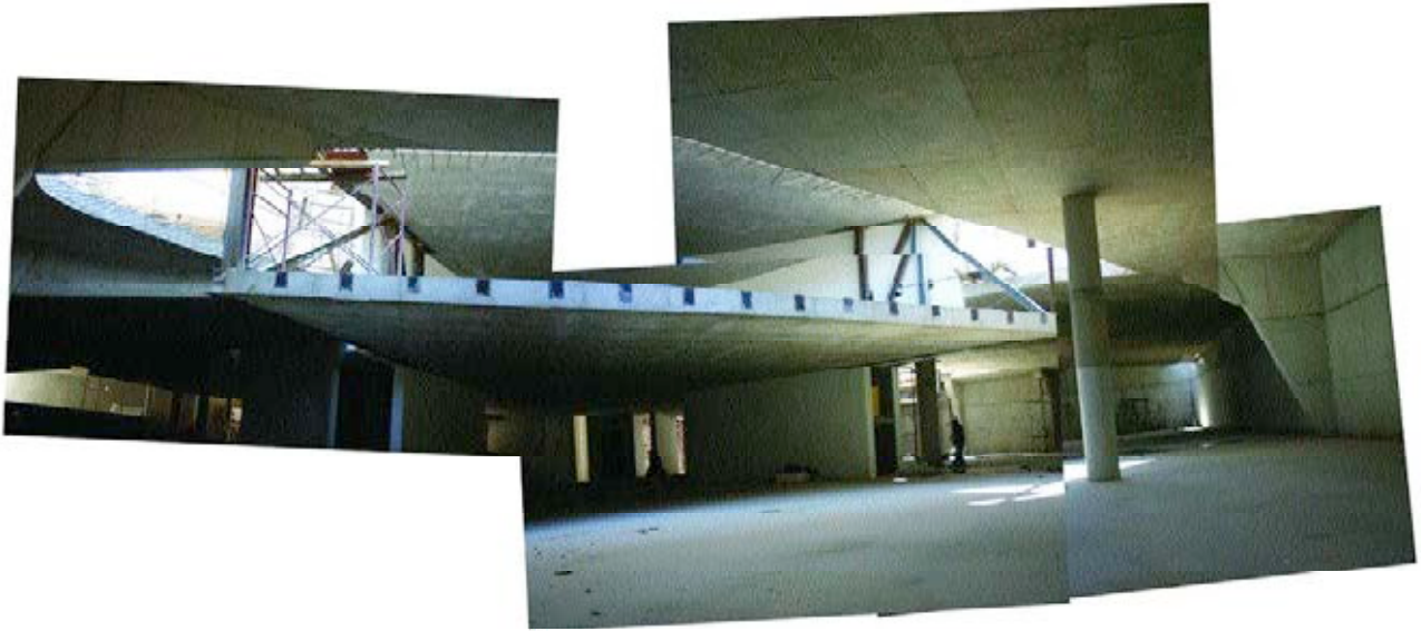
Figura 7. Teniendo el trabajador como referencia la fotografía muestra el vano de 16 m con sus 9 m de voladizo, suspendiendo el techo plano con los tirantes diagonales y cordones horizontales. El trabajador está en la planta sótano -1. Las pletinas frontales están embebidas en el forjado para el apoyo de los elementos de fachada, la cual es en madera de Finlandia.
