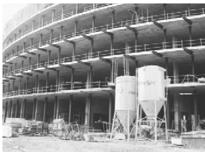
Figura 10. Forjados apeados exteriormente cada 3,60 m durante las fases constructivas.
