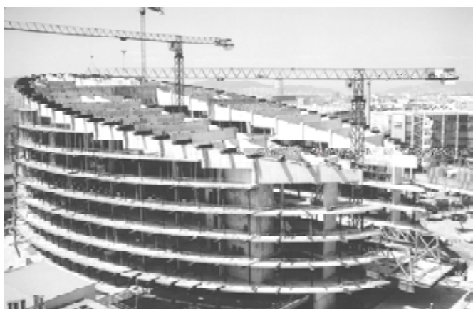
Colocación tetones superiores de cuelgue y enganche de tirantes a estructura de cuelgue (Abril 2004).
