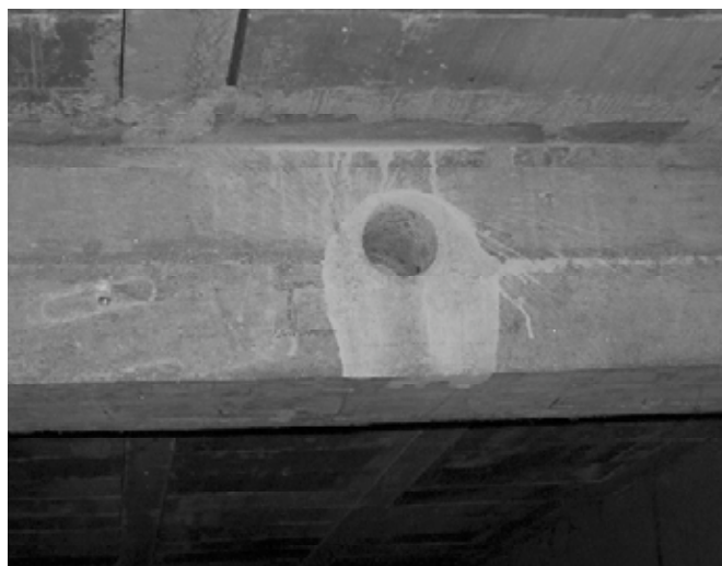
Figura 2. Extracción de probetas en vigas y pilares.
