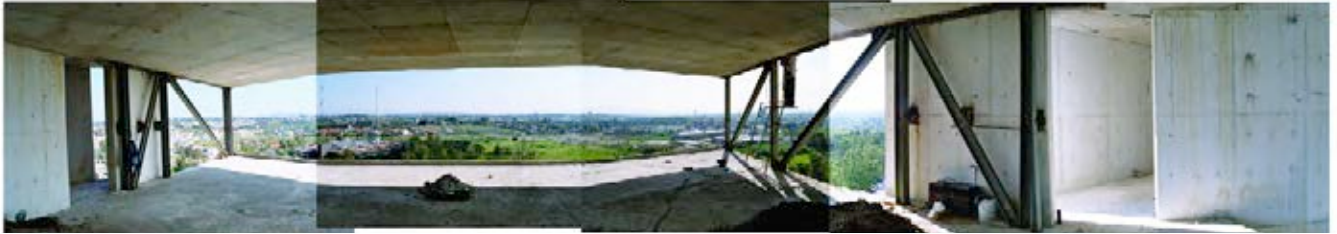
Figura 18. Visión exterior desde dentro de un módulo de oficinas. Figure 18. Outwardly vision taken from within a module of offices.
