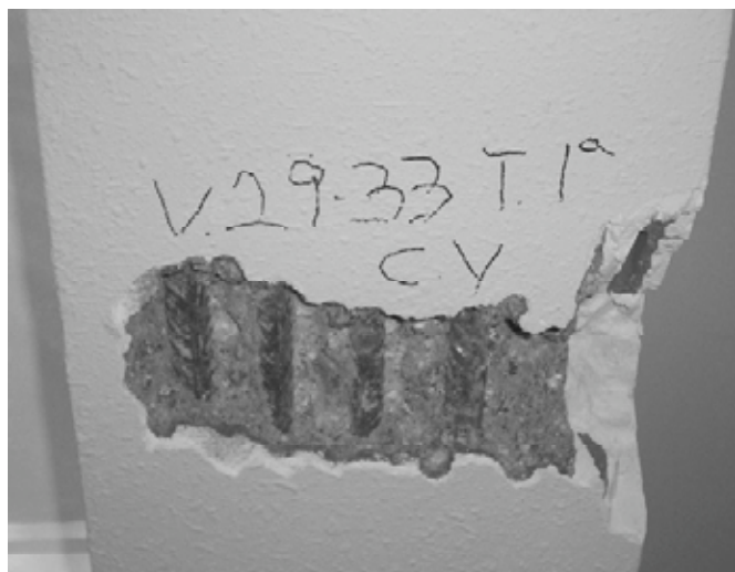
Figura 6. Comprobación del armado de una viga.
