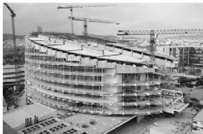
Desapeo y cuelgue del edificio (Septiembre 2004)
