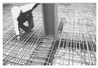
Figura 17. Tirantes interiores de Sectores II, y III. Unión mediante crucetas a forjados.
