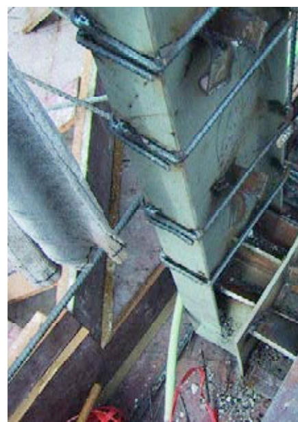
Figura 16. Detalle tipo para la conexión con perfiles tubulares y pletinas de refuerzo.
