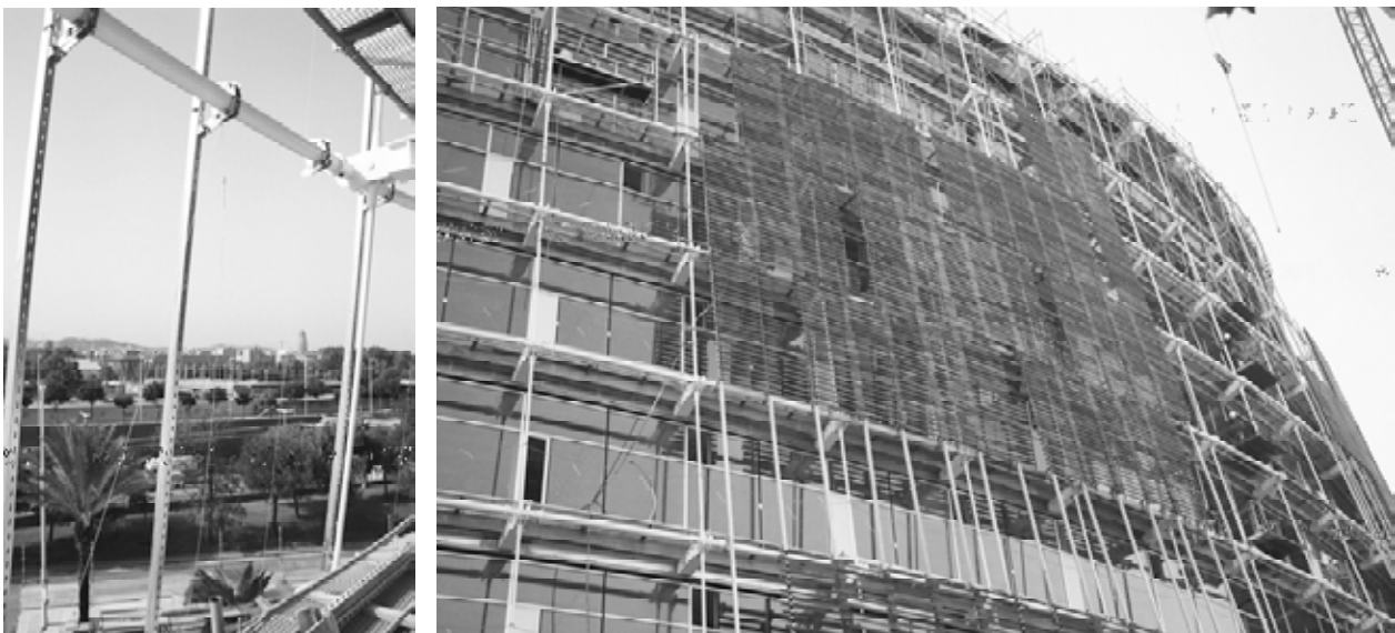
Figura 26. Detalle de tubo perimetral y montantes para sujeción de cerramiento exterior con lamas de madera, y detalle de fachada exterior.
