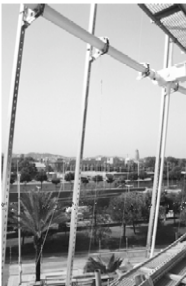
Figura 26. Detalle de tubo perimetral y montantes para sujeción de cerramiento exterior con lamas de madera, y detalle de fachada exterior.
