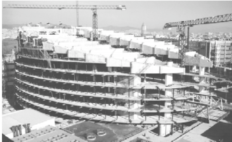
Figura 22. Vista de la estructura superior de cuelgue: Vigas principales, riostra interior y doble riostra exterior.
