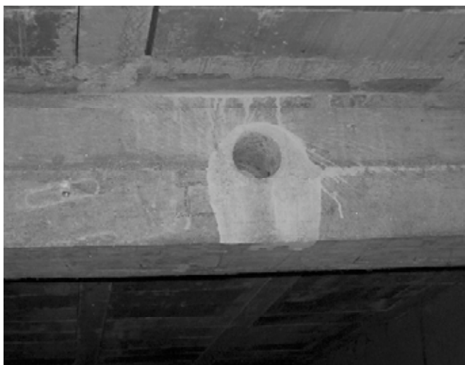
Figura 2. Extracción de probetas en vigas y pilares.
