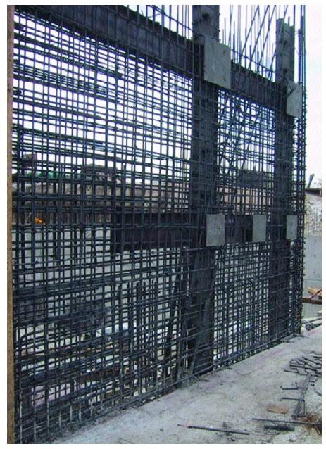
Figura 15. Conexión entre los muros de hormigón y las vigas pared de acero (plantas inferiores suspendidas).
