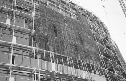
Figura 26. Detalle de tubo perimetral y montantes para sujeción de cerramiento exterior con lamas de madera, y detalle de fachada exterior.
