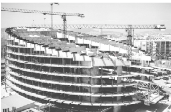
Colocación tetones superiores de cuelgue y enganche de tirantes a estructura de cuelgue (Abril 2004).
