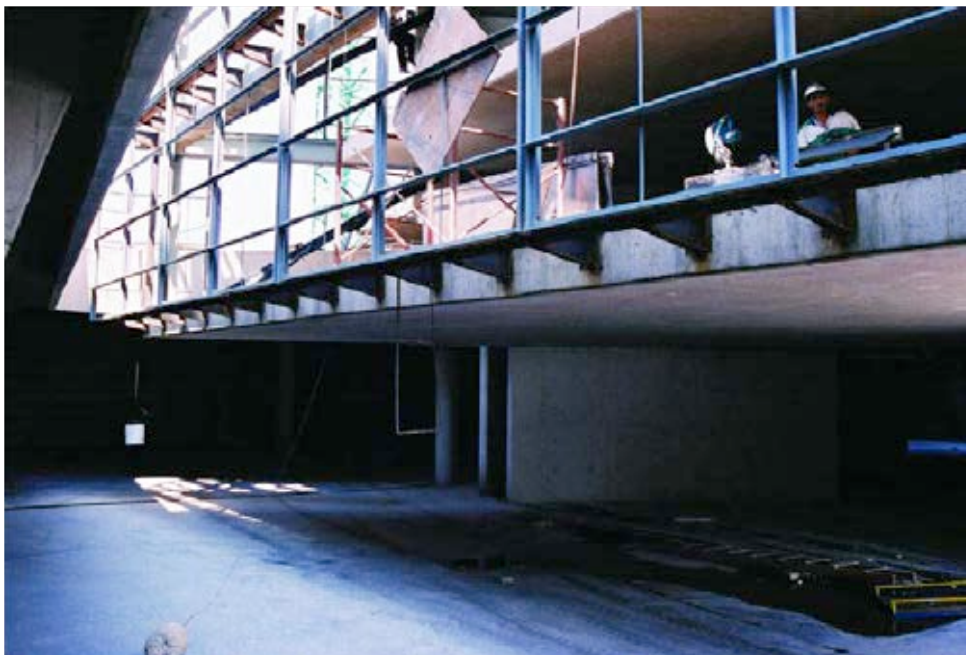
Figura 17.. Elementos verticales que proporcionan estabilidad lateral frente a viento para los paneles exteriores de madera y que reducen perceptiblemente las vibraciones.
