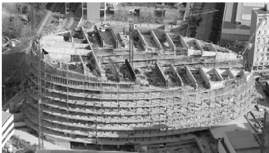
Figura 21. Vista superior durante la ejecución de las vigas principales de cuelgue.
