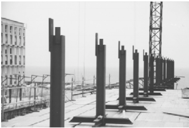
Figura 18. Uniones de Tirantes Interiores de Sectores II, y III con cubrejuntas.
