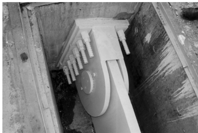
Figura 10. Anclaje del tablero al estribo.
