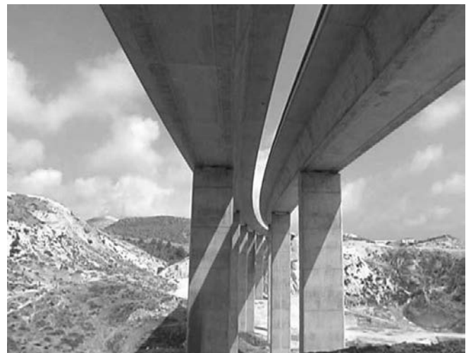
Figura 16. Viaducto Petra Tou Romiou.
