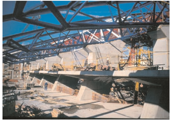
Figuras 14 y 15. Detalle de apoyo de las vigas longitudinales en el lado Jorge Juan. Figures 14 and 15. Detail of the connection between longitudinal roof beams and concrete pilaster on Jorge Juan side.
