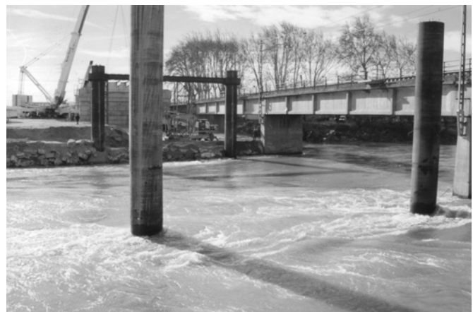
Figura 8. Apoyos provisionales para el vano central.
