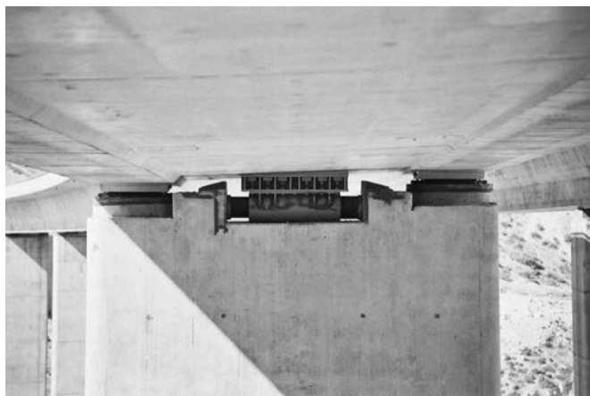
Figura 20. Amortiguador transversal en cabeza de pila.
