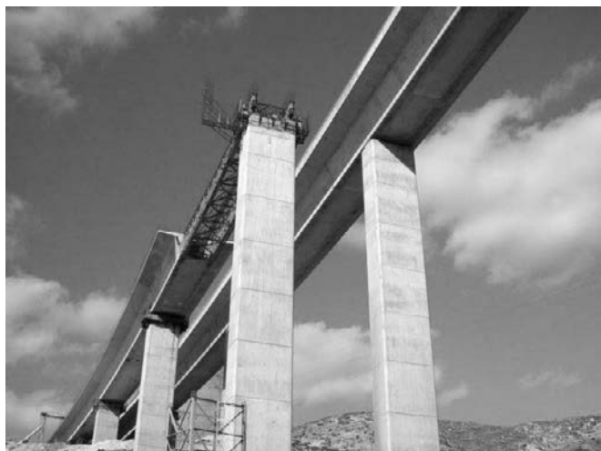
Figura 18. Tablero en proceso de empuje.
