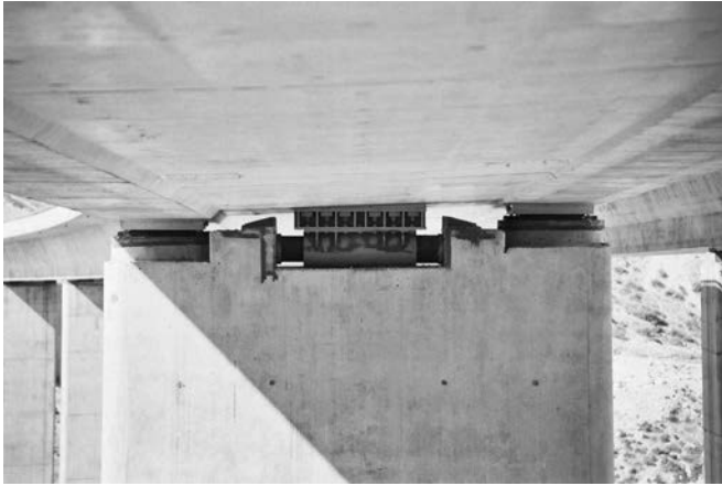
Figura 20. Amortiguador transversal en cabeza de pila.
