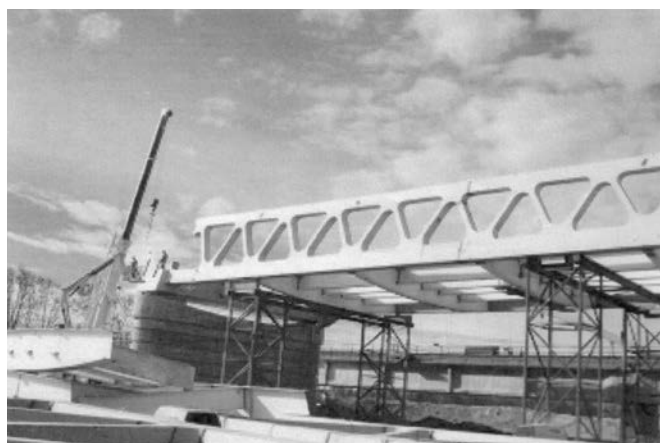
Figura 7. Montaje del vano cuatro.
