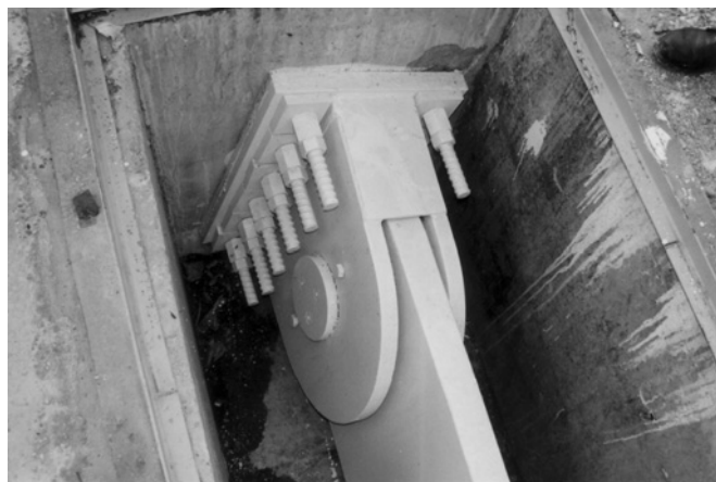
Figura 10. Anclaje del tablero al estribo.
