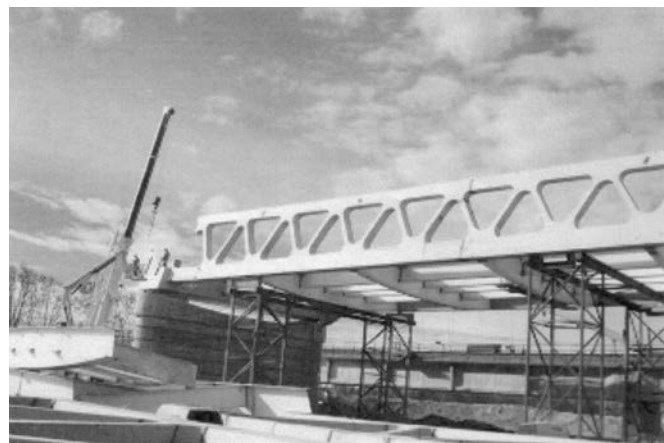
Figura 7. Montaje del vano cuatro.
