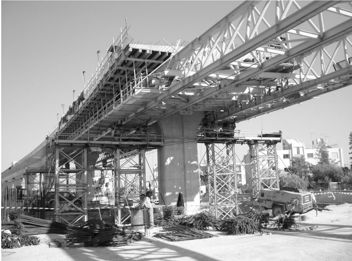
Figura 3. Viaducto de Limassol. Construcción del tablero con cimbra móvil.
