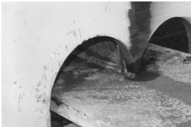
Figura 12. Detalle de cruce entre vigas.
