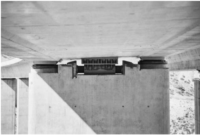
Figura 20. Amortiguador transversal en cabeza de pila.
