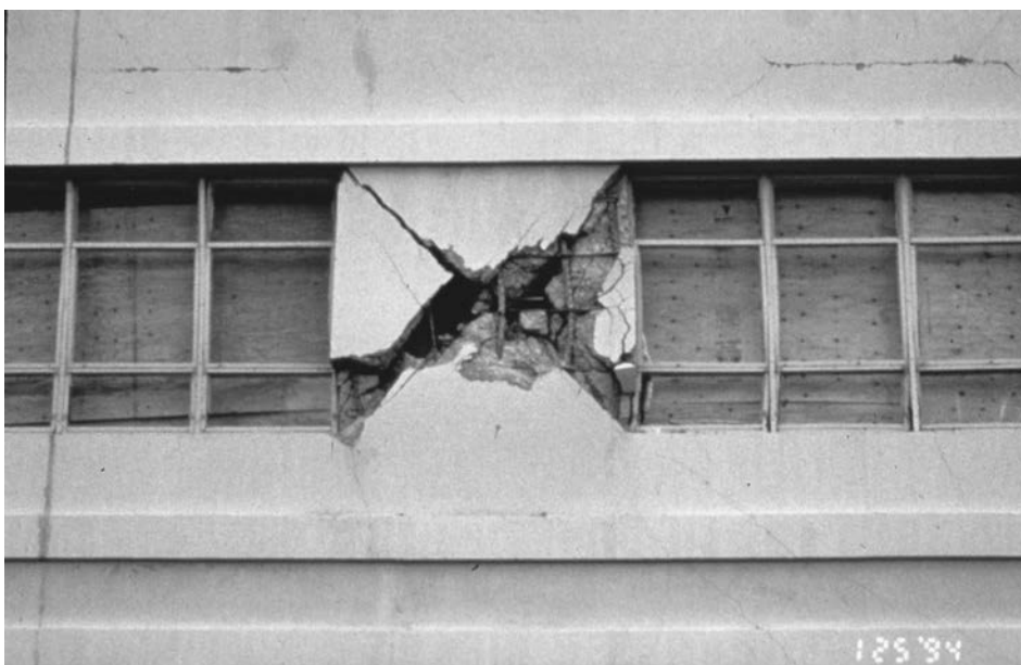
Figura 1. Rotura por cortante de un pilar corto.
