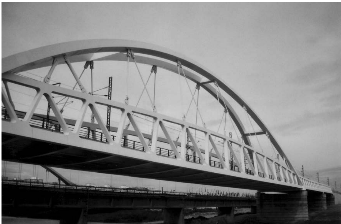
Figura 13. Vista general de la estructura terminada.
