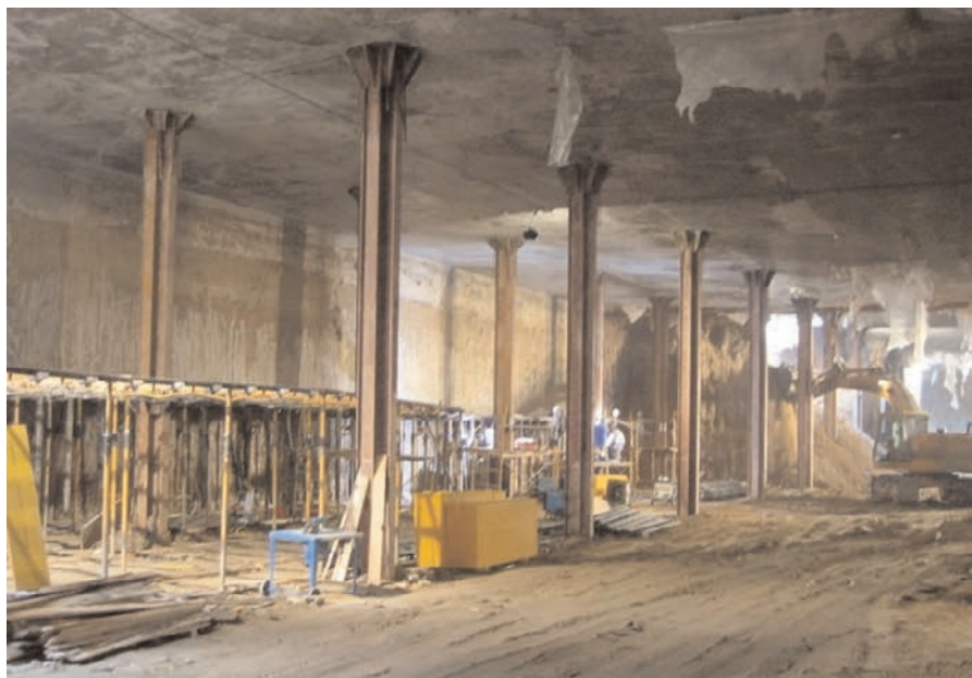
Figura 19. Construcción de sótanos. Figure 19. Basement construction.
