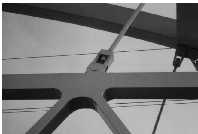
Figura 11. Detalle de las péndolas.
