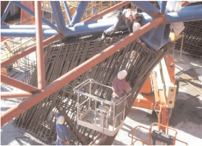
Figuras 14 y 15. Detalle de apoyo de las vigas longitudinales en el lado Jorge Juan. Figures 14 and 15. Detail of the connection between longitudinal roof beams and concrete pilaster on Jorge Juan side.
