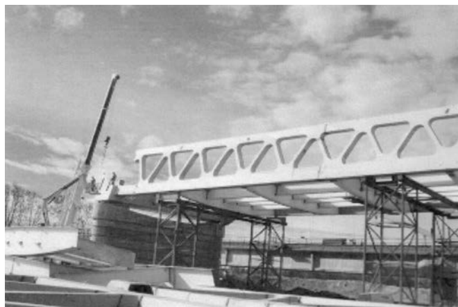
Figura 7. Montaje del vano cuatro.
