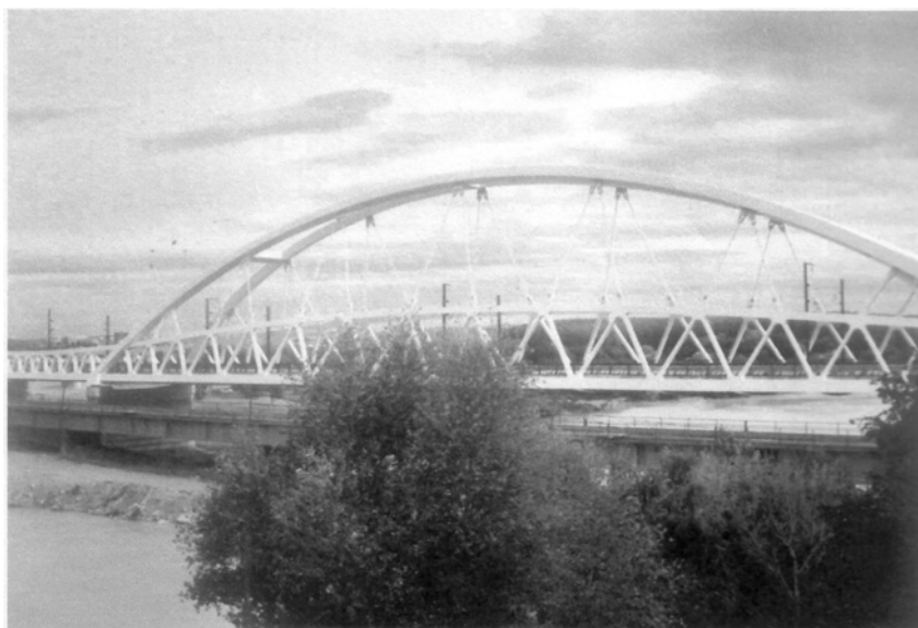
Figura 2. Vista general del puente construido.
