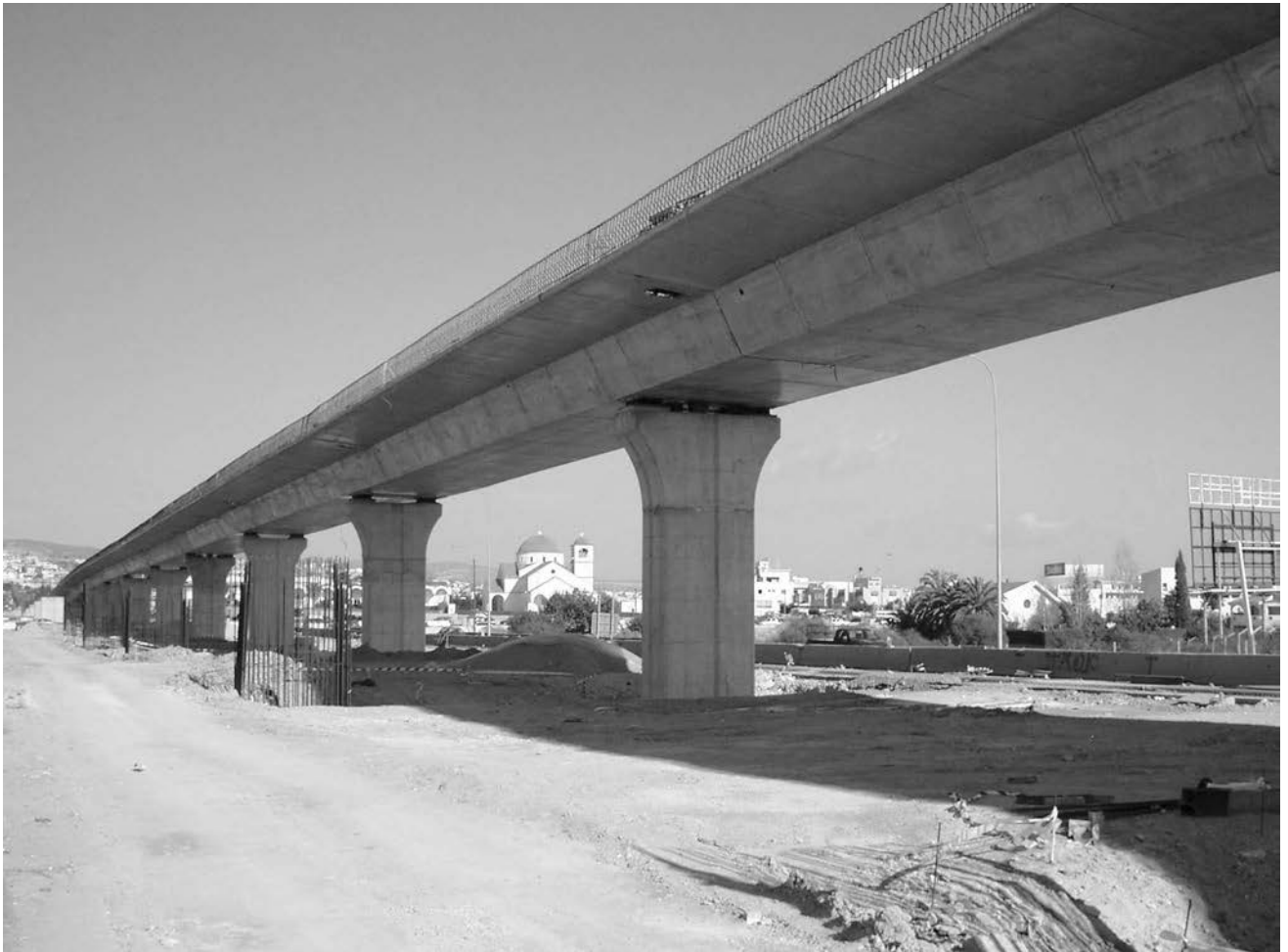
Figura 1. Viaducto de Limassol, en construcción.
