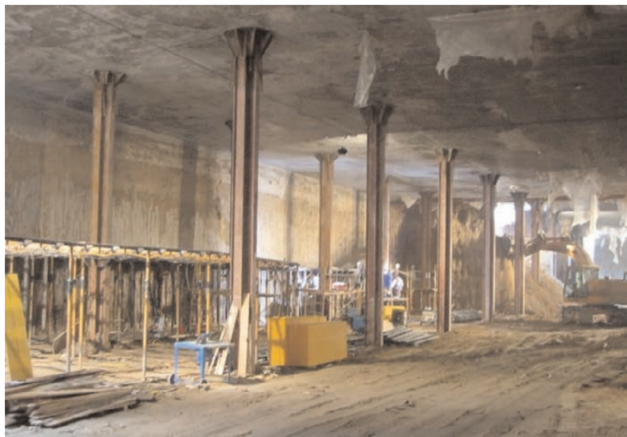
Figura 19. Construcción de sótanos. Figure 19. Basement construction.
