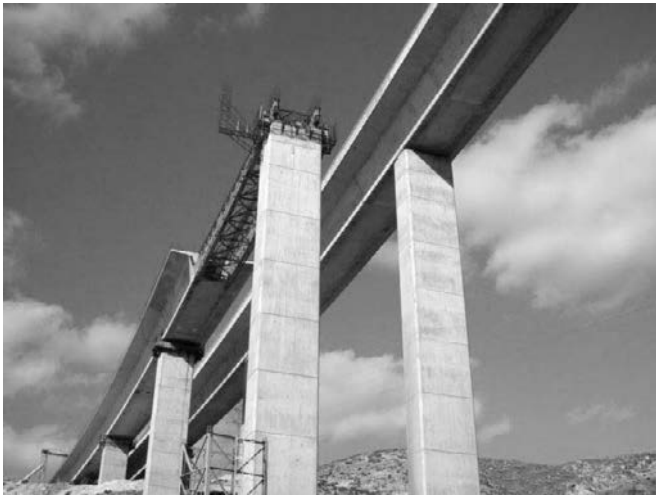
Figura 18. Tablero en proceso de empuje.
