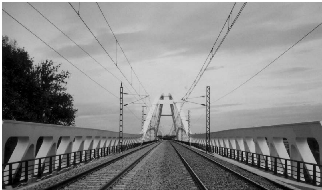
Figura 5. Vista del puente desde la plataforma.
