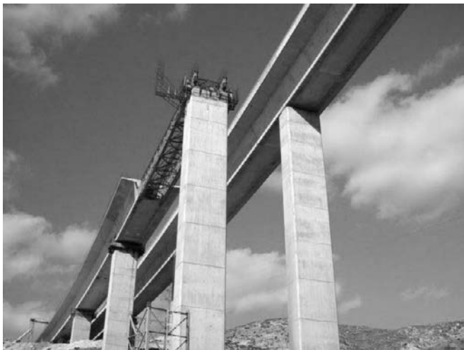
Figura 18. Tablero en proceso de empuje.
