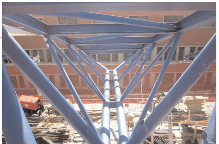
Figuras 12 y 13. Sección de las vigas longitudinales. Figures 12 and 13. Transversal section of the longitudinal beams.
