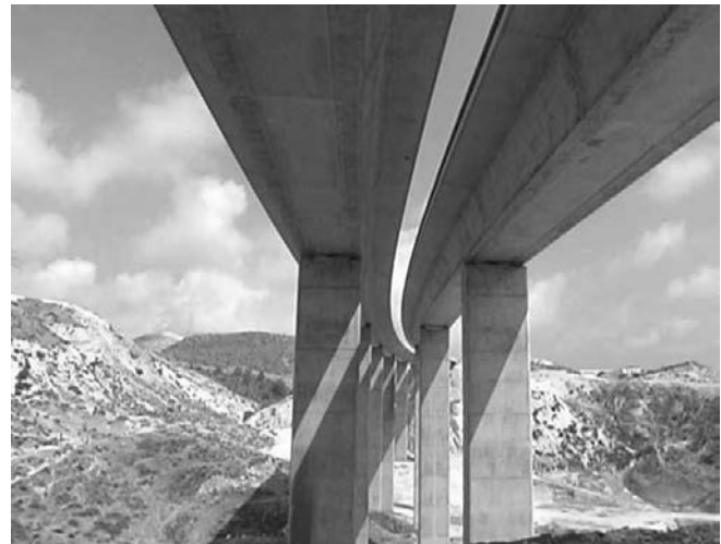
Figura 16. Viaducto Petra Tou Romiou.
