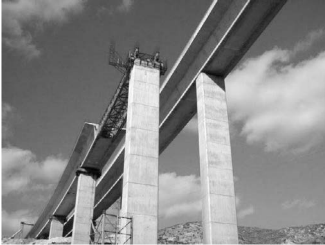
Figura 18. Tablero en proceso de empuje.
