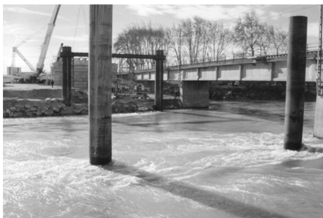
Figura 8. Apoyos provisionales para el vano central.
