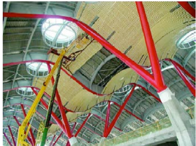
Figura 10. Vista general interior del falso techo.
