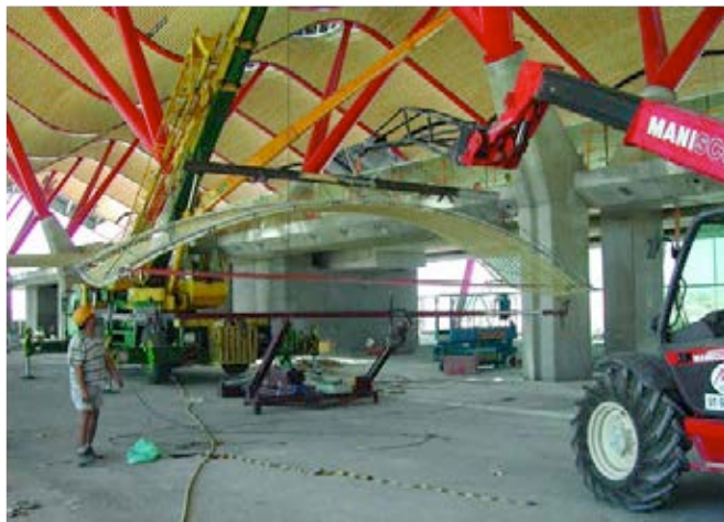
Figura 11. Elevación de módulos del falso techo.
