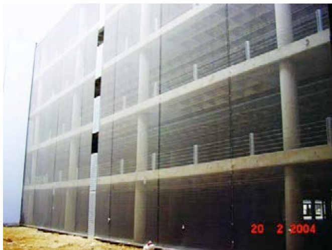
Figura 5. Fachada del aparcamiento.
