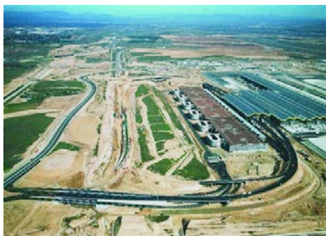
Figura 13. Aspecto general de las vías de acceso.
