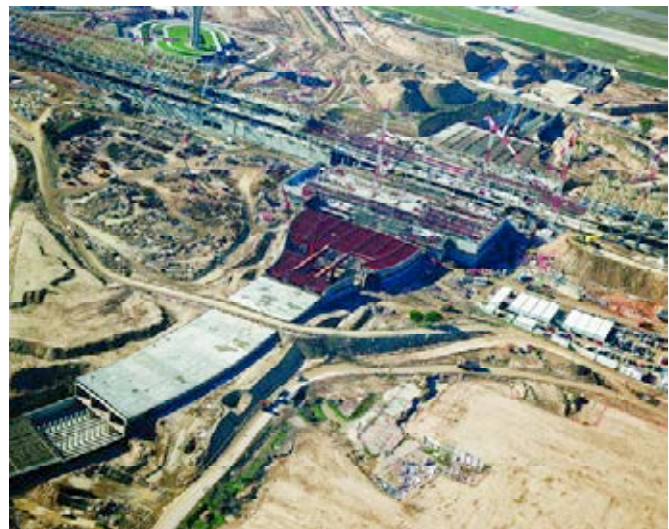
Figura 10. Vista aérea del túnel de servicio.
