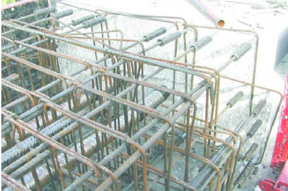
Figura 14. Montaje de vainas y armadura pasiva.
