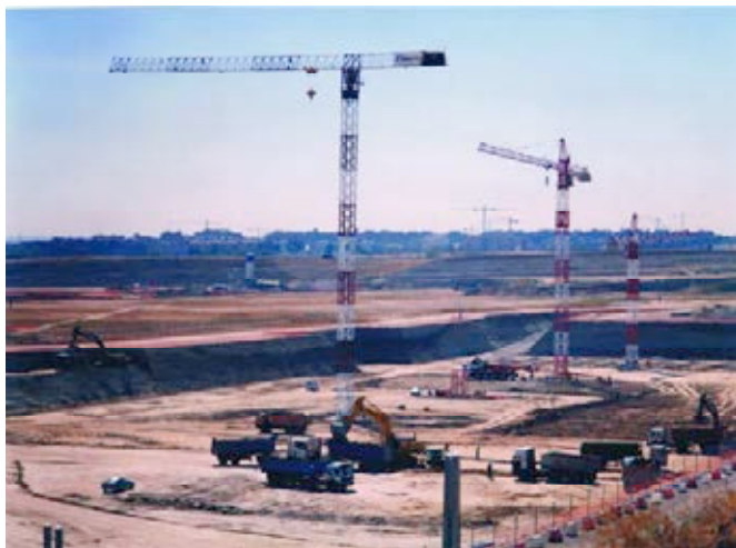
Figura 2. Ejecución del movimiento de tierras.
