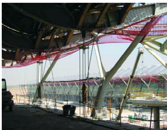
Figura 18. Detalle sistema invertido fachada tipo A-5.
