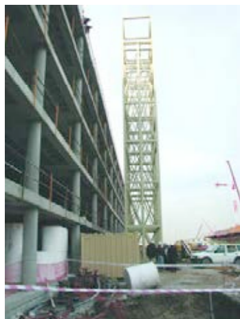
Figura 27. Ascensores y montacargas panorámicos de circulación vertical.
