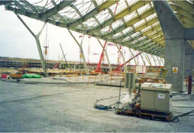
Figura 15. Tesado en vacío de uno de los módulos.
