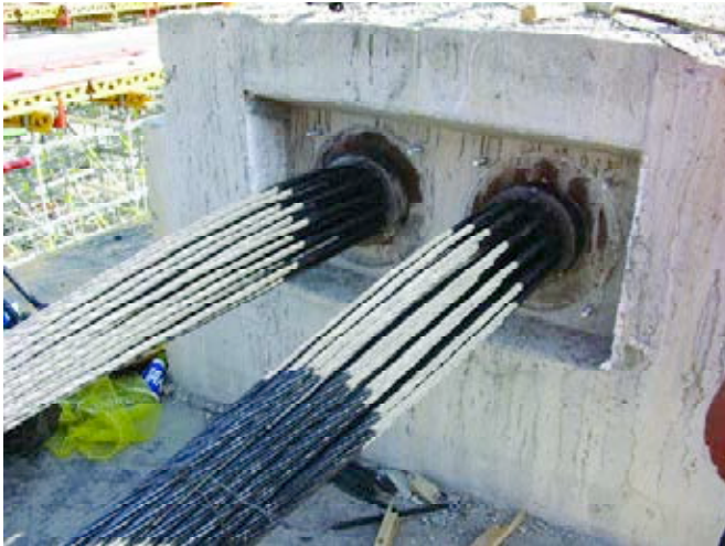
Figura 3. Anclajes en viga tipo de hormigón.
