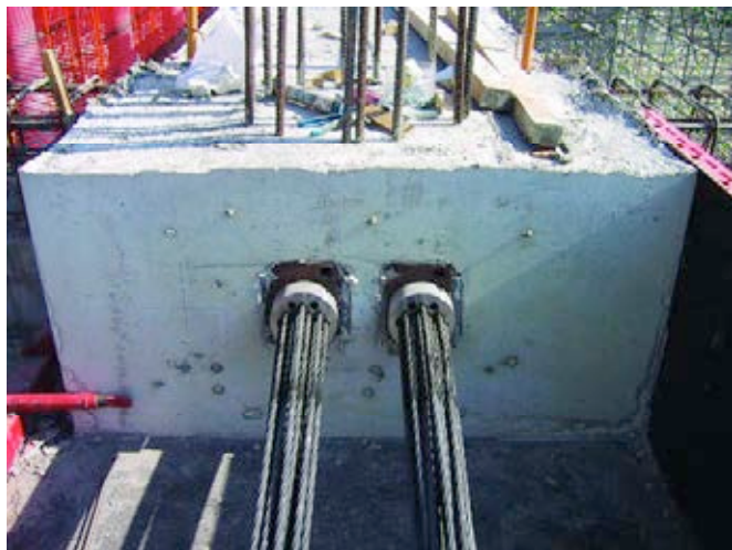
Figura 3. Disposición de anclajes en la viga.
