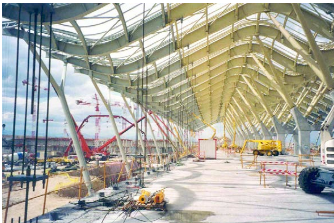
Figura 13. Detalle tirantes provisionales.
