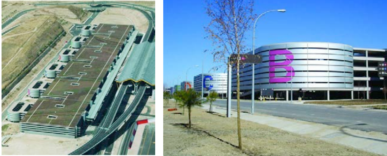
Figura 22. Vista general del aparcamiento.
