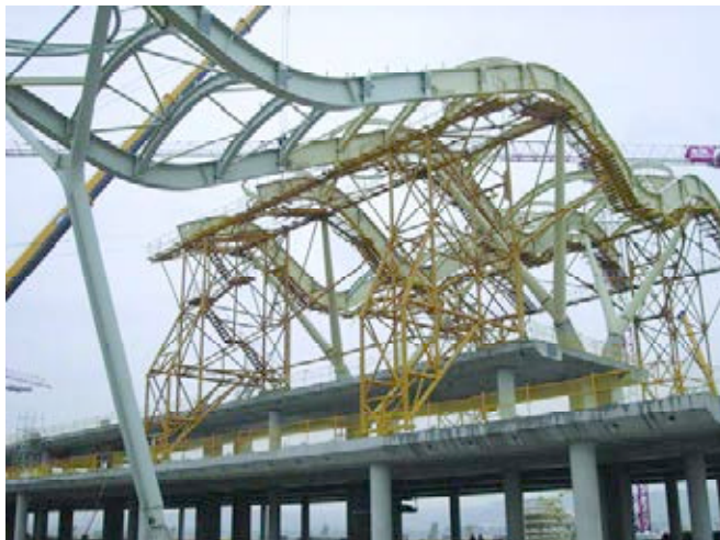
Figura 15. Montaje mediante carretes-plataforma en el dique sur.
