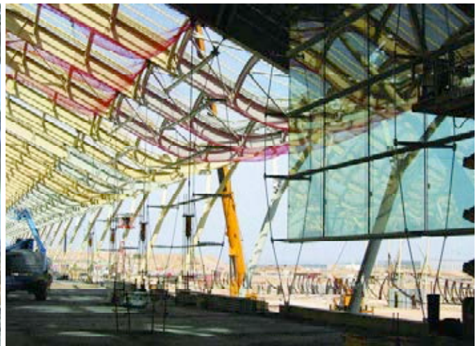
Figura 38. Tesado de módulo.
