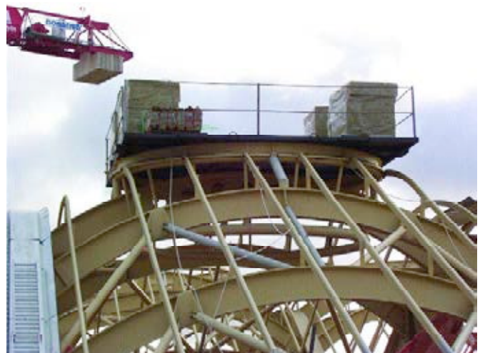
Figura 4. Aspecto del montaje de la cubierta.
