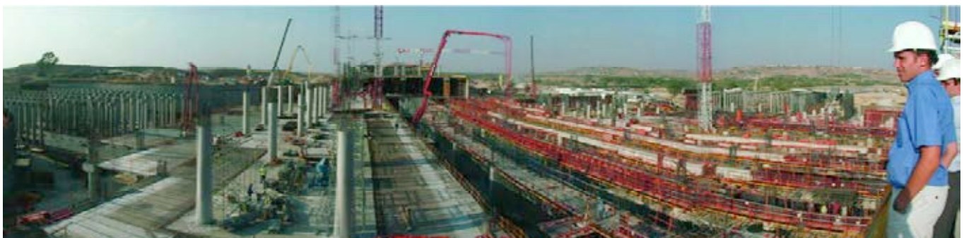
Figura 15. Zona central. Distintas etapas durante la construcción.
