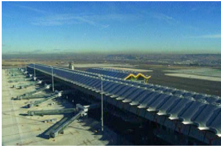
Figura 13. Vista general del Edificio Satélite.
