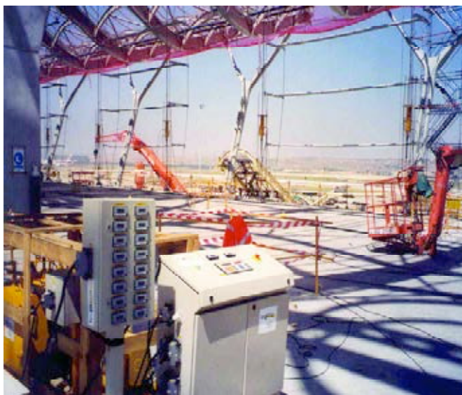
Figura 3. Vista general equipo de tesado desarrollado por Tecpresa.
