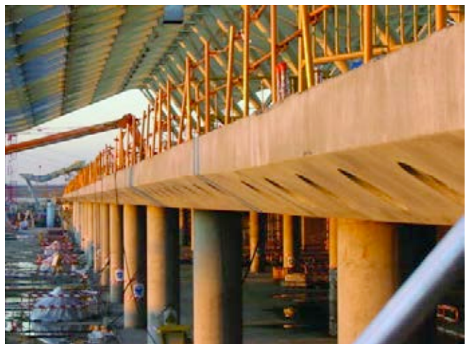
Figura 6. Viga borde. Acabado de la superficie de hormigón.
