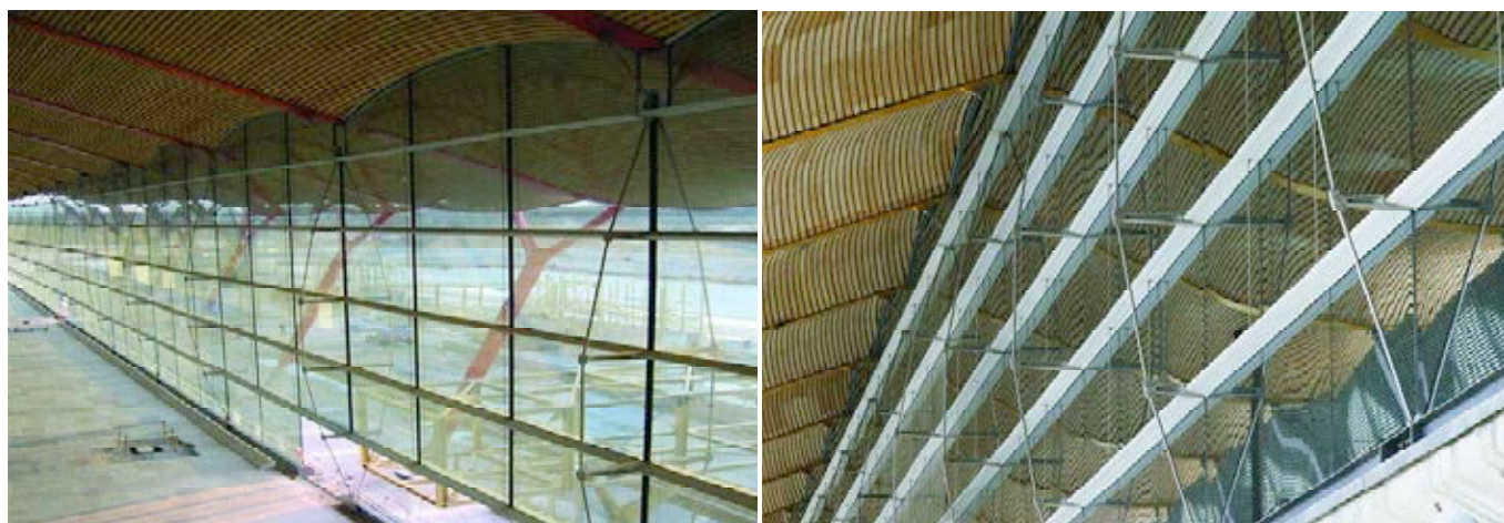
Figura 31. Vistas de la fachada tensada.
