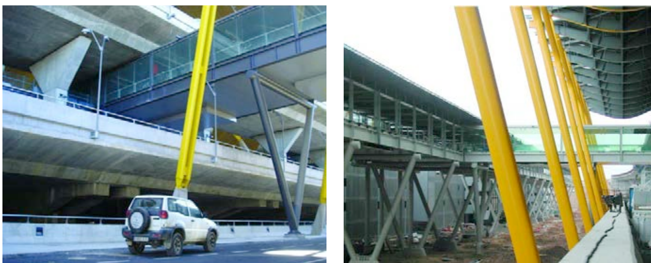
Figura 29. Pasarelas peatonales a la cota +5,775.
