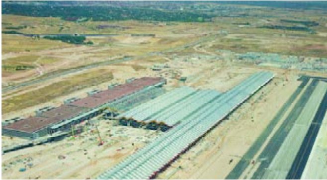
Figura 2. Vista general del Edificio Terminal.
