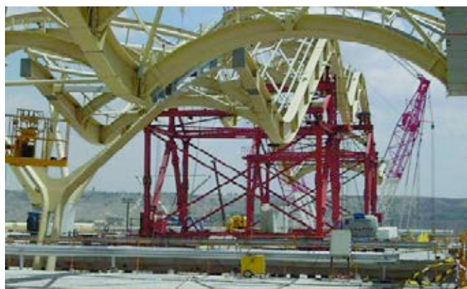
Figura 14. Ripado de un módulo de 9x72 m mediante sistema de patines sobre teflón.
