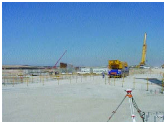
Figura 9. Recorrido de maquinaria en nivel 0.
