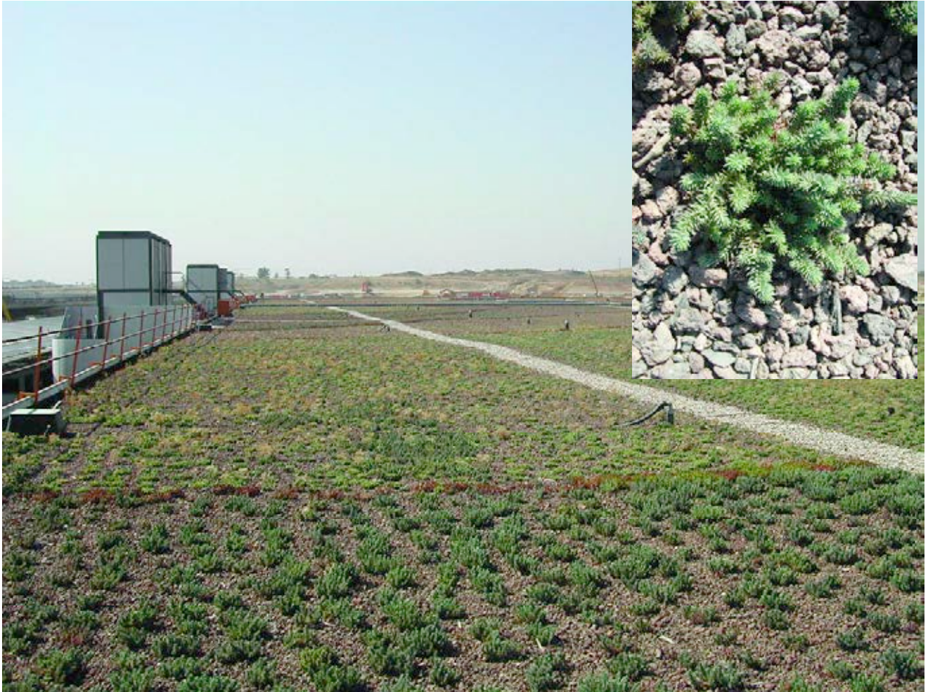
Figura 8. Aspecto de la cubierta ecológica.
