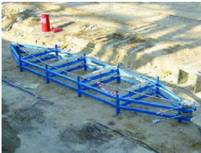
Figura 36. Estructura provisional de montaje.
