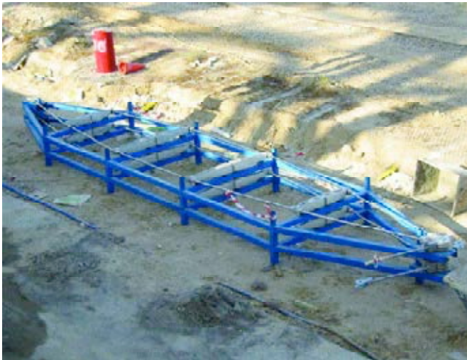
Figura 36. Estructura provisional de montaje.
