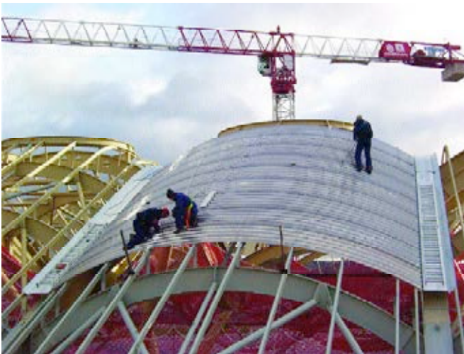
Figura 5. Láminas precurvadas de aluminio.
