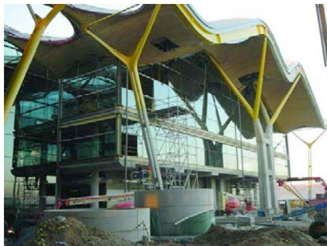
Figura 5. Muro cortina tipo A-4, vista exterior.
