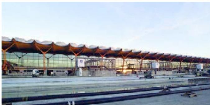
Figura 2. Vista longitudinal de la Fachada.
