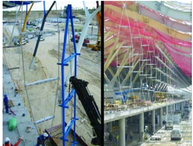
Figura 37. Montaje de kipper
