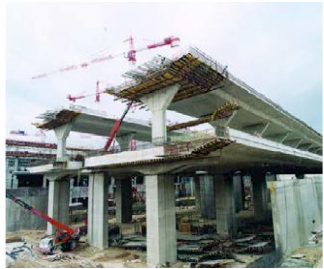
Figura 35. Dársenas en construcción.
