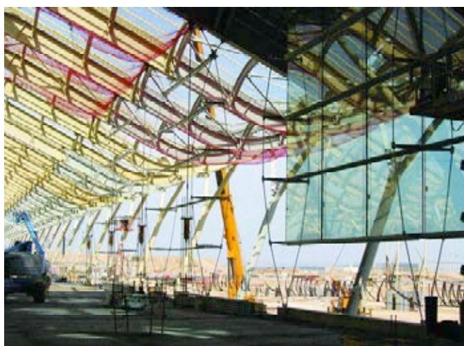
Figura 38. Tesado de módulo.
