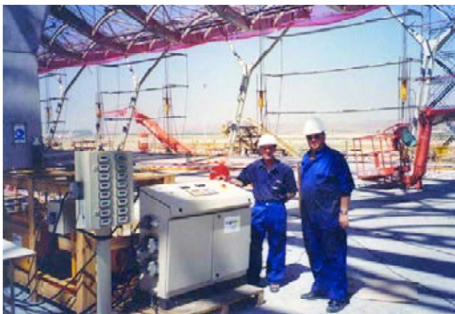
Figura 14. Vista general módulo simétrico con 16 gatos.
