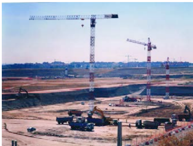
Figura 4. Aspecto del desarrollo de los forjados.
