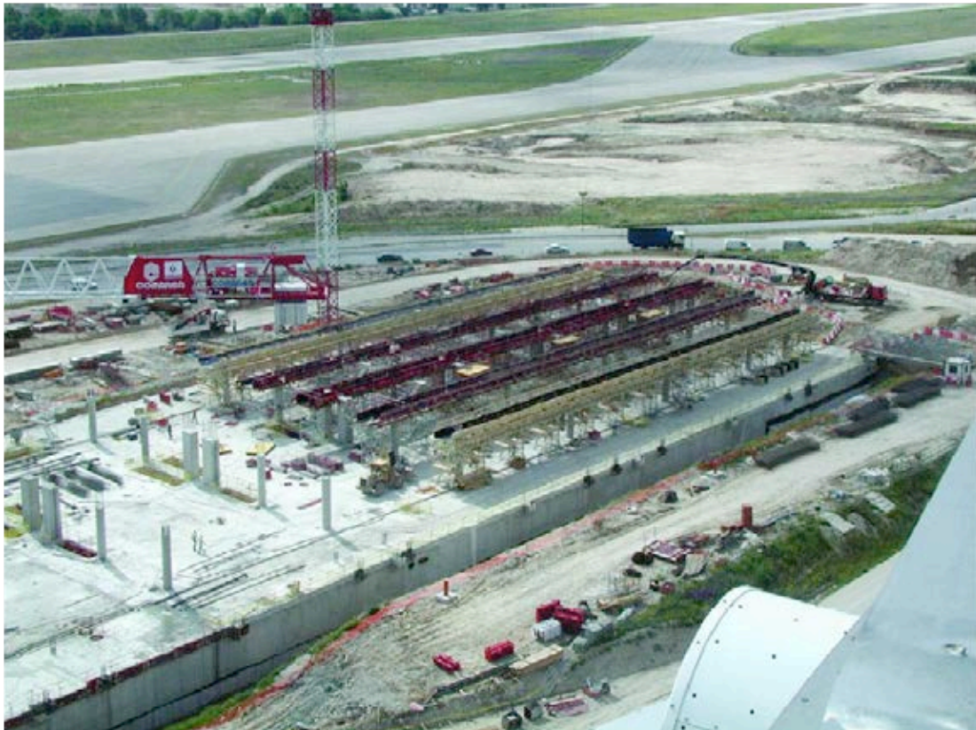
Figura 1. Aspecto de ejecución de la estructura.
