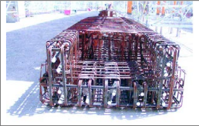
Figura 7.2. Fotografía de la ferralla de armadura pasiva de una de las partes de la junta de dilatación.
