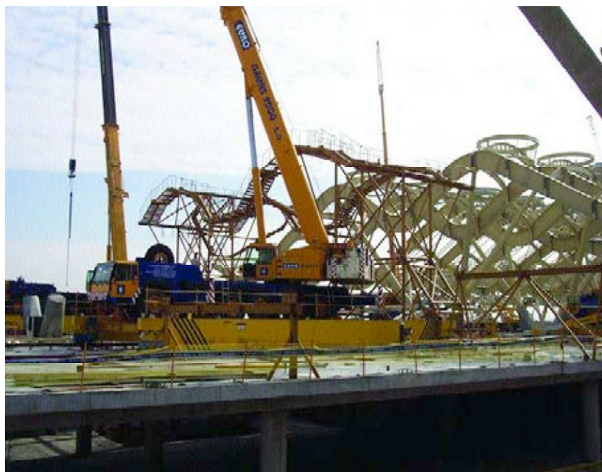
Figura 30. Grúas y plataformas de montaje.
