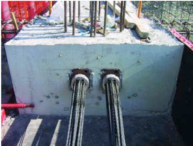
Figura 3. Disposición de anclajes en la viga.
