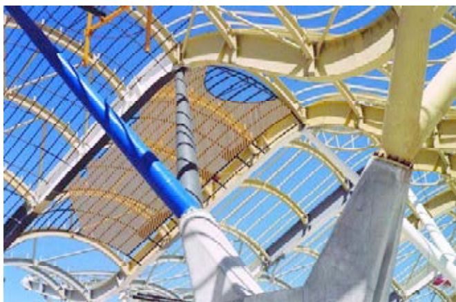
Figura 14. Pilares en V: vista general.
