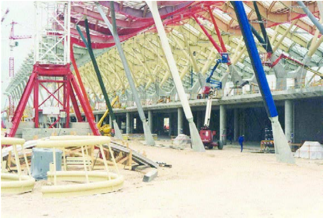
Figura 16. Módulo asimétrico del Dique.
