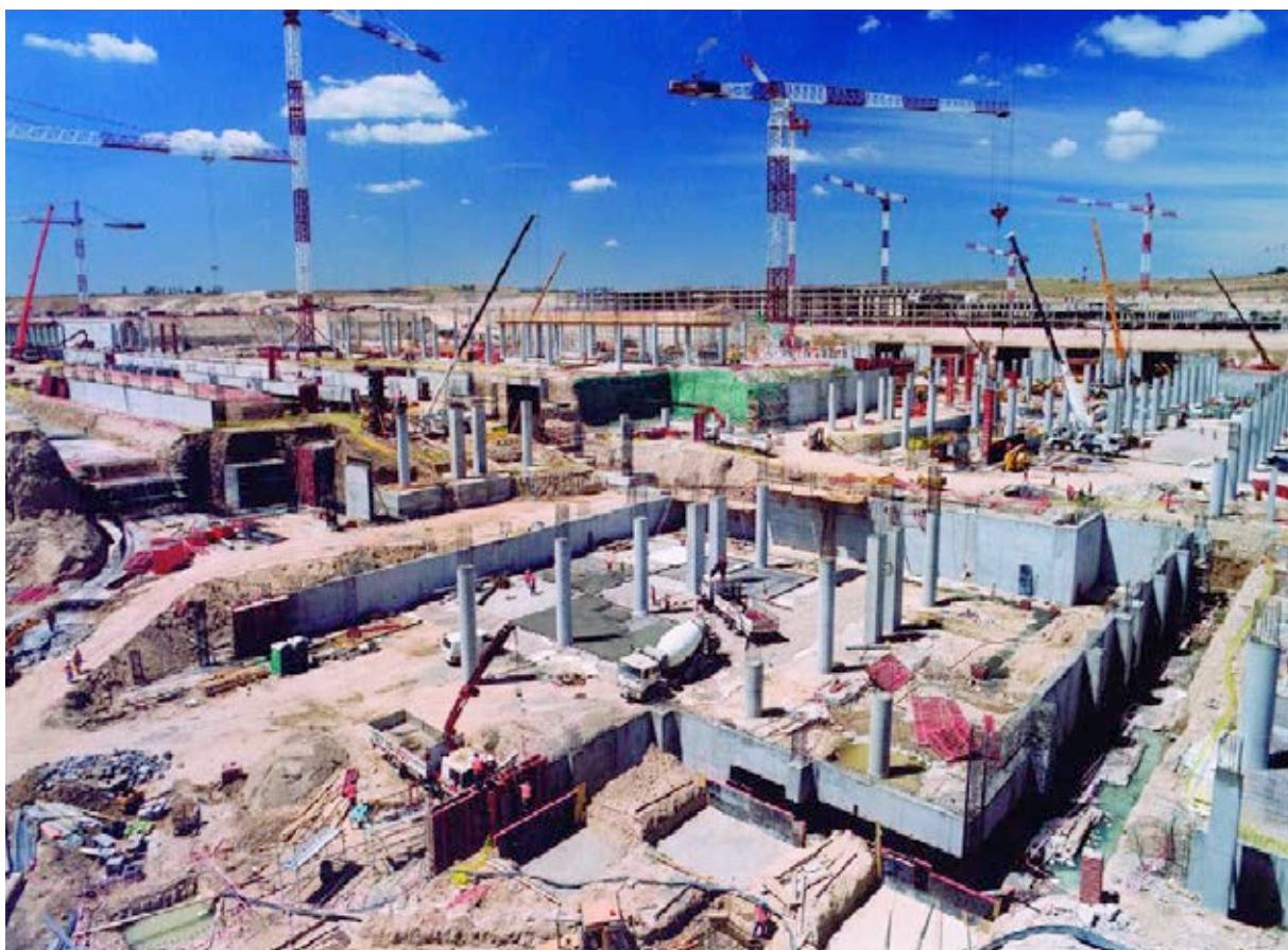
Figura 1. Vista general de cimentación.
