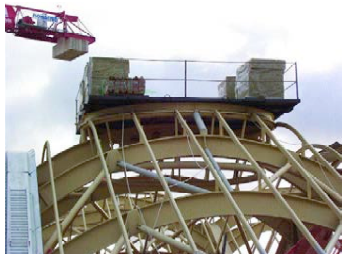
Figura 4. Aspecto del montaje de la cubierta.
