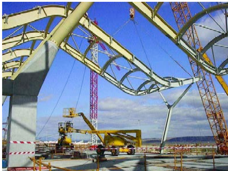
Figura 27. Montaje de parejas de dintel.
