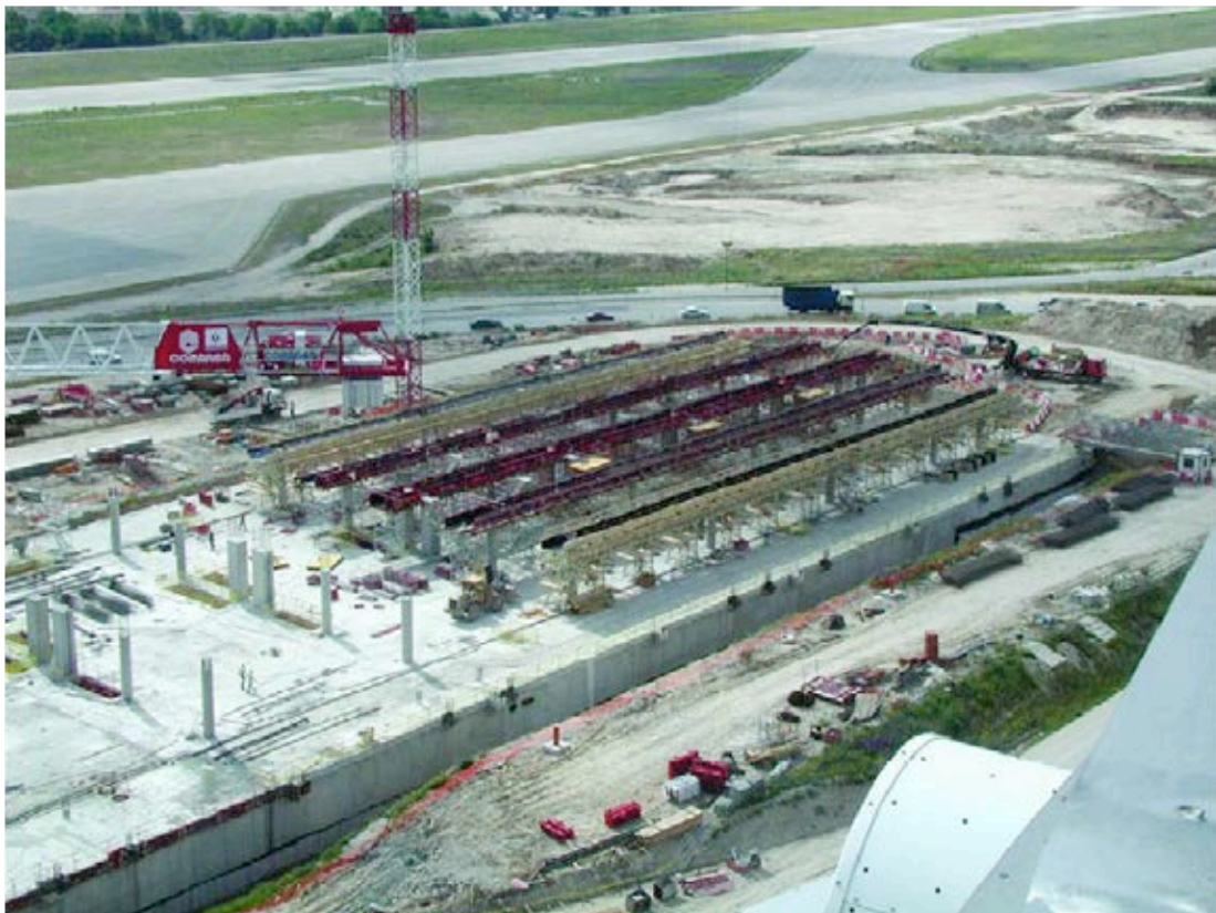
Figura 1. Aspecto de ejecución de la estructura.
