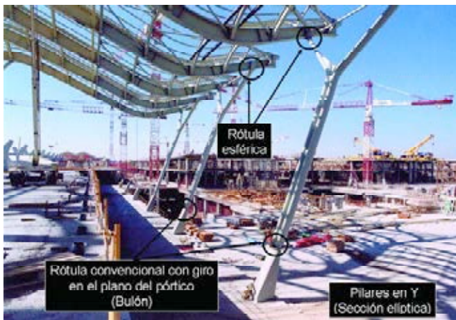
Figura 19. Pilares en Y: esquema resistente.
