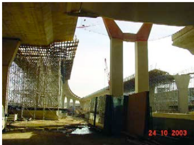
Figura 14. Ejecución de un paso elevado.
