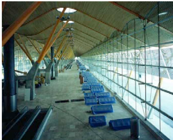
Figura 4. Detalle vista Interior celosías de fachada.
