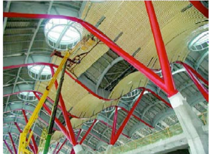
Figura 10. Vista general interior del falso techo.
