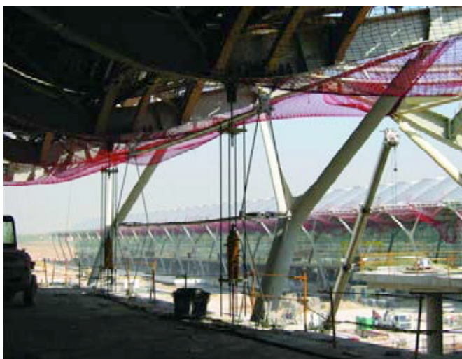
Figura 18. Detalle sistema invertido fachada tipo A-5.
