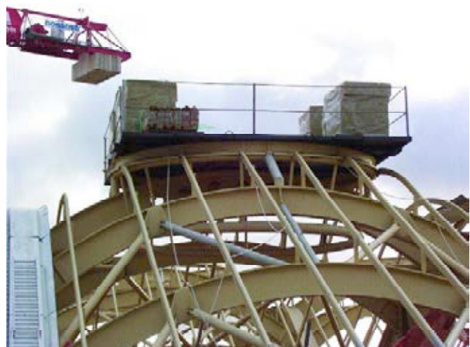
Figura 4. Aspecto del montaje de la cubierta.
