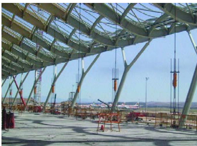
Figura 38. Tesado de módulo.
