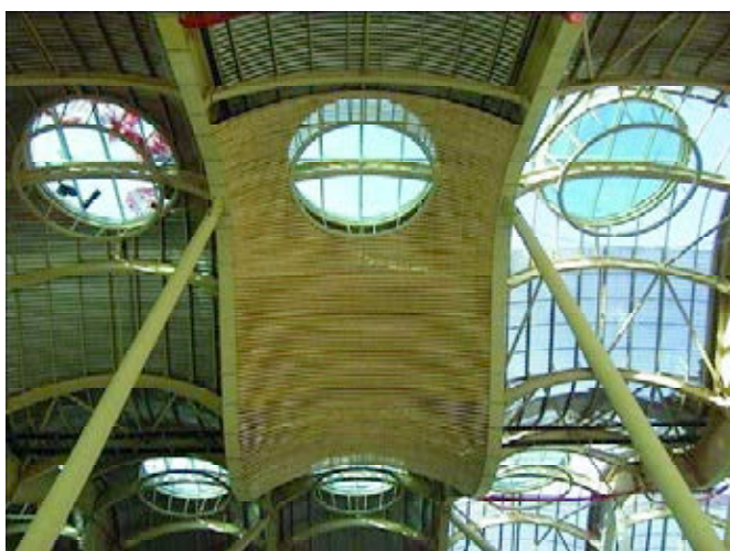
Figura 8. Vista inferior de cubierta.
