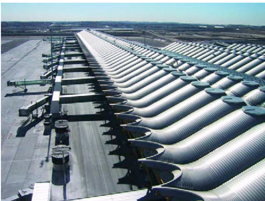
Figura 14. Cubierta de Terminal. Figure 14. Terminal Roof.
