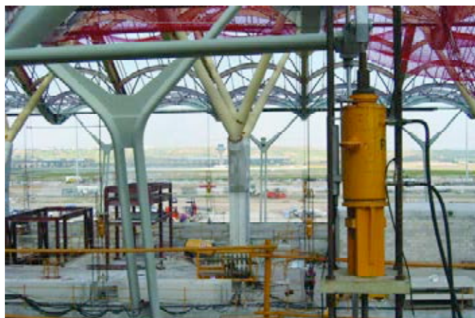
Figura 19. Vista parcial Tesado conjunto de Dique y Procesador.
