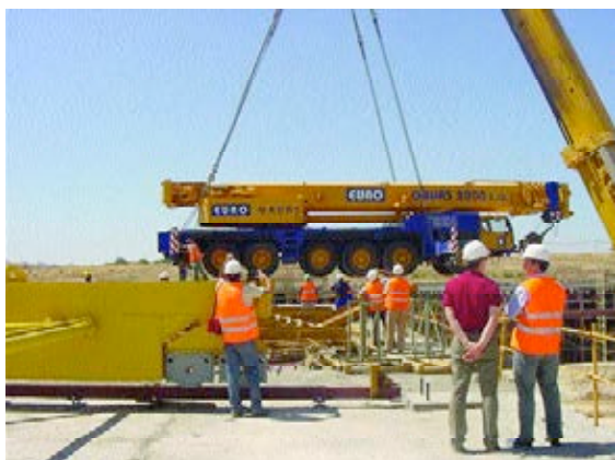
Figura 7. Carretín de grúa para montaje de estructura metálica.
