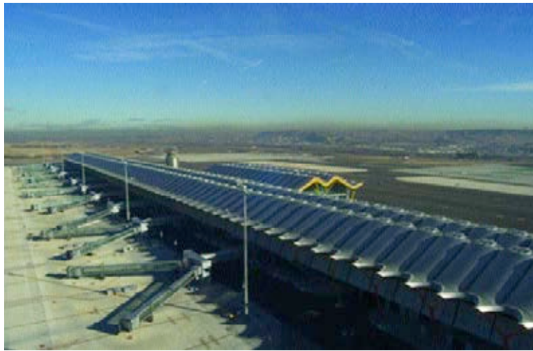
Figura 13. Vista general del Edificio Satélite.
