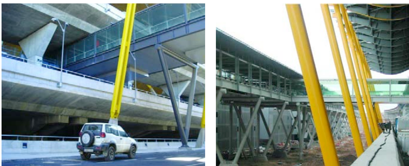
Figura 29. Pasarelas peatonales a la cota +5,775.
