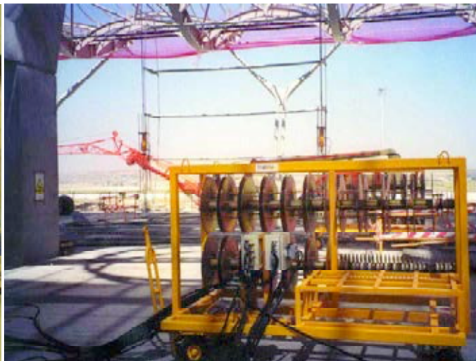
Figura 12. Detalle Sistema de desplazamiento en la obra.
