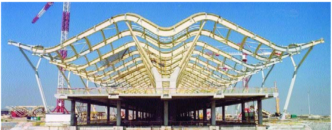
Figura 4. Pórtico tipo de estructura principal.
