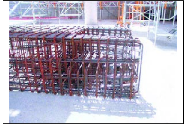
Figura 7.2. Fotografía de la ferralla de armadura pasiva de una de las partes de la junta de dilatación.
