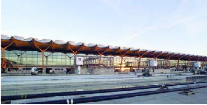
Figura 2. Vista longitudinal de la Fachada.
