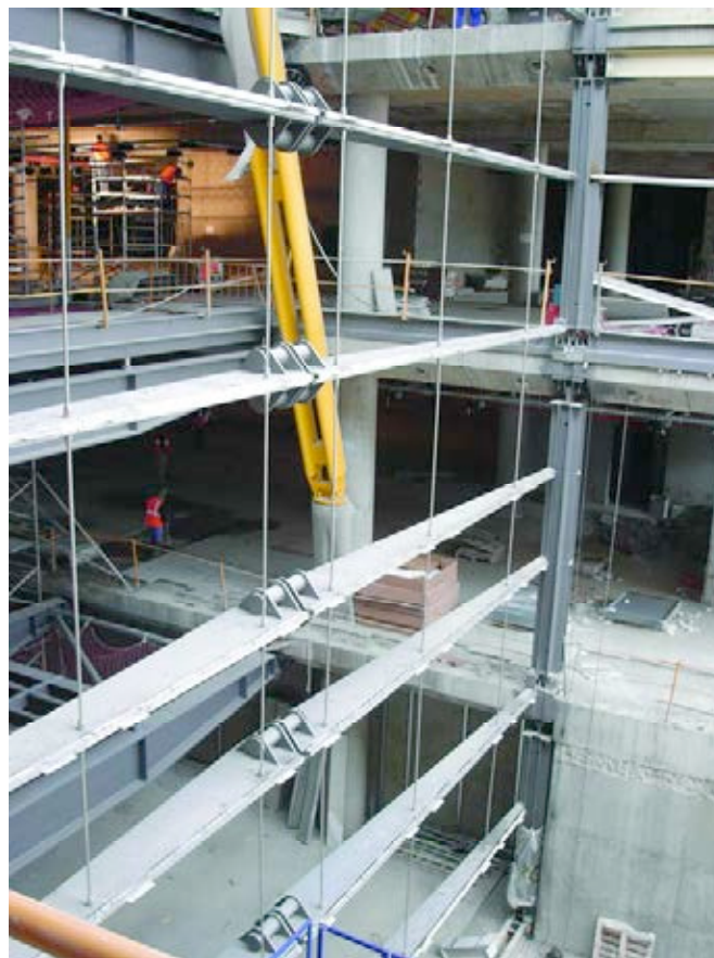
Figura 6. Muro cortina tipo B-2, vista exterior previa a la colocación del vidrio.
