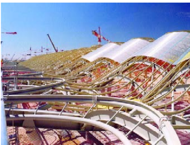
Figura 7. Vista superior de cubierta.
