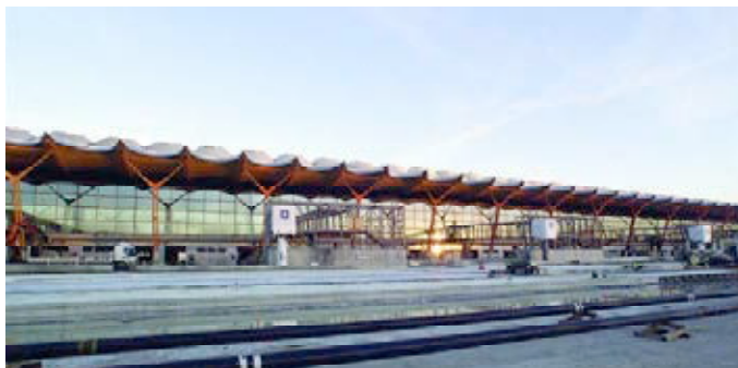
Figura 2. Vista longitudinal de la Fachada.
