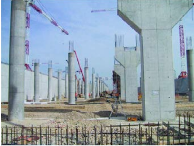
Figura 8. Estructura en zonas no públicas. Acabado de la superficie del hormigón II.
