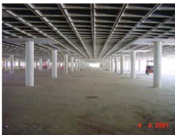
Figura 23. Detalles forjado y pilares del Edificio de Aparcamiento.
