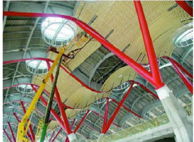
Figura 10. Vista general interior del falso techo.
