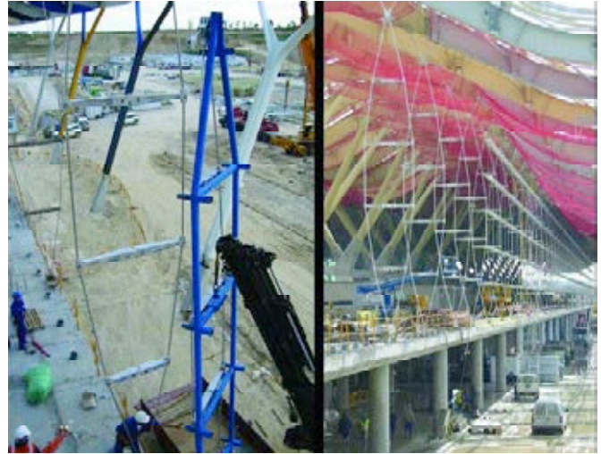
Figura 37. Montaje de kipper
