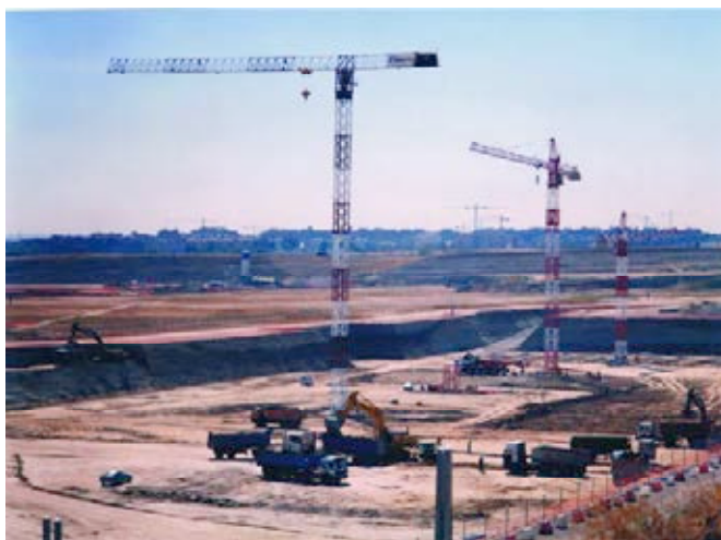
Figura 2. Ejecución del movimiento de tierras.
