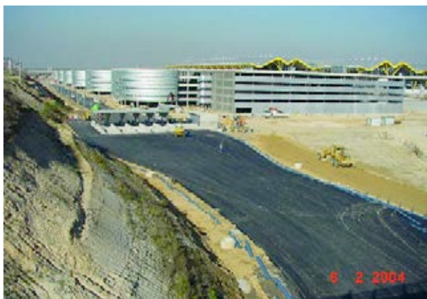
Figura 12. Construcción de los accesos.
