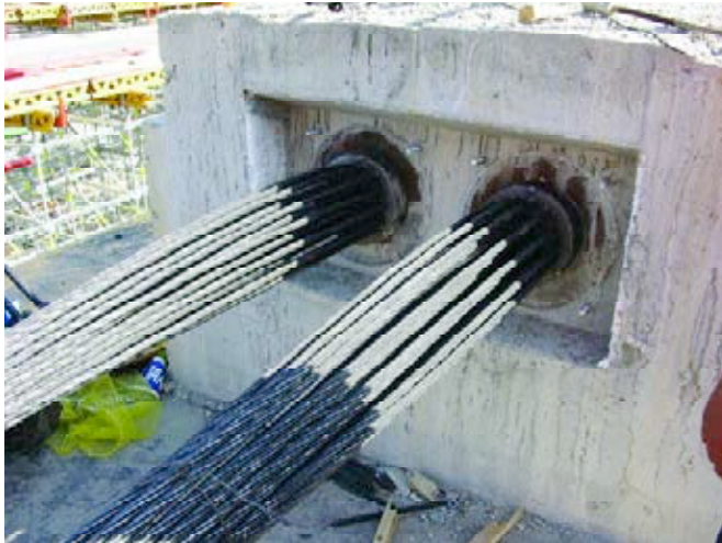
Figura 3. Anclajes en viga tipo de hormigón.
