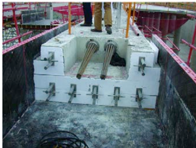
Figura 7.3. Fotografía de una de las partes de la junta ejecutada esperando la ejecución de la viga adyacente.
