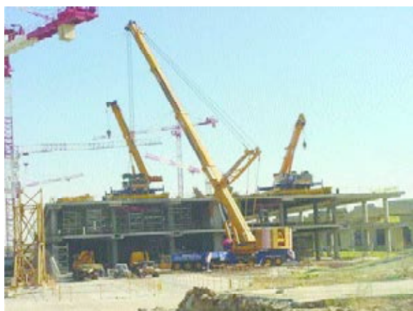
Figura 8. Izado de grúas al nivel +2.
