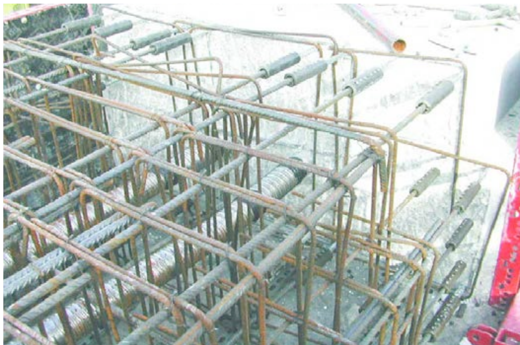
Figura 14. Montaje de vainas y armadura pasiva.
