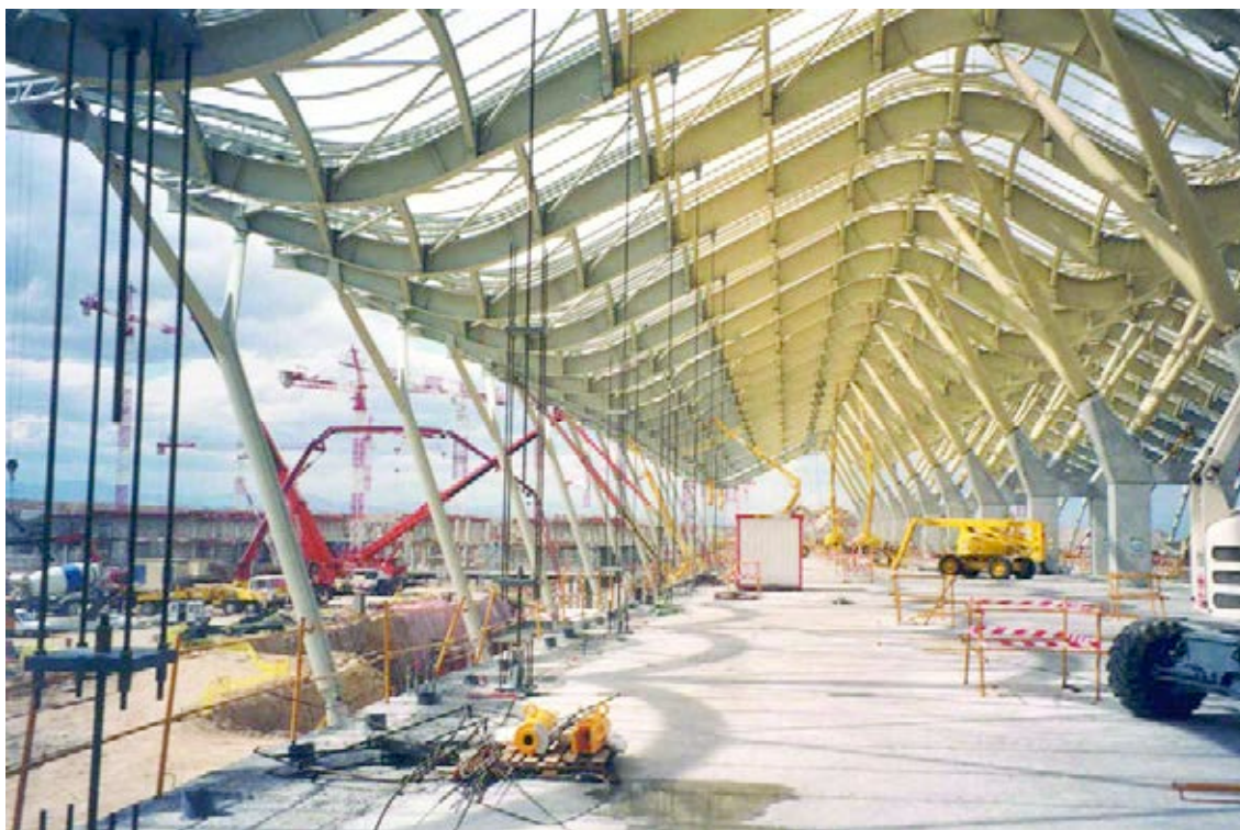
Figura 13. Detalle tirantes provisionales.
