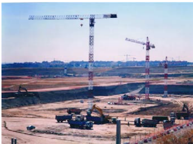
Figura 2. Ejecución del movimiento de tierras.
