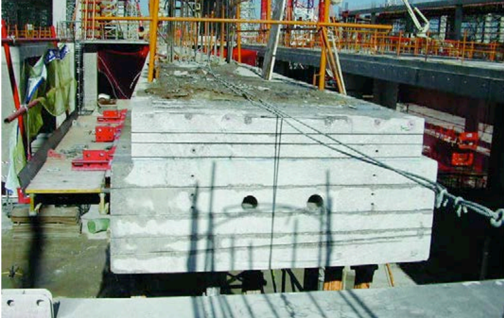
Figura 12. Precorte con disco de vigas.
