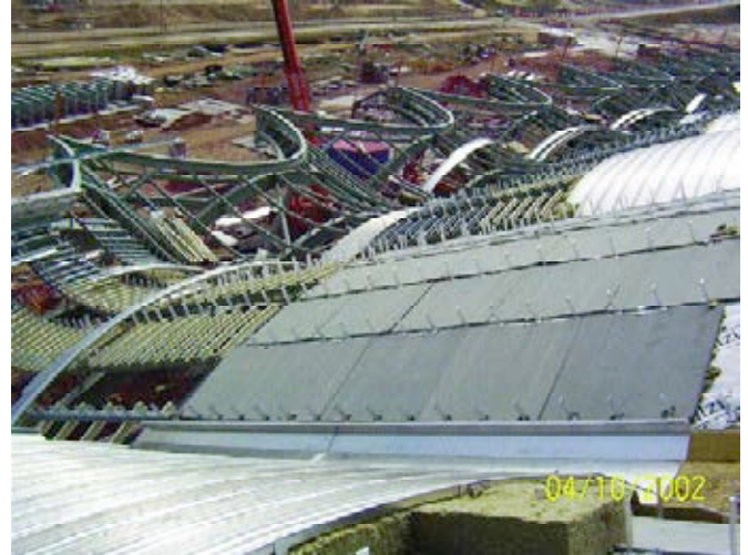
Figura 6. Ejecución de la impermeabilización y aislamiento.
