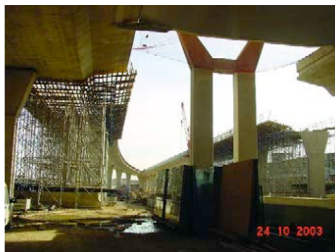
Figura 14. Ejecución de un paso elevado.
