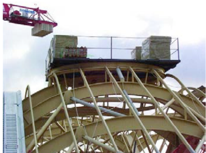
Figura 4. Aspecto del montaje de la cubierta.
