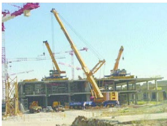
Figura 8. Izado de grúas al nivel +2.
