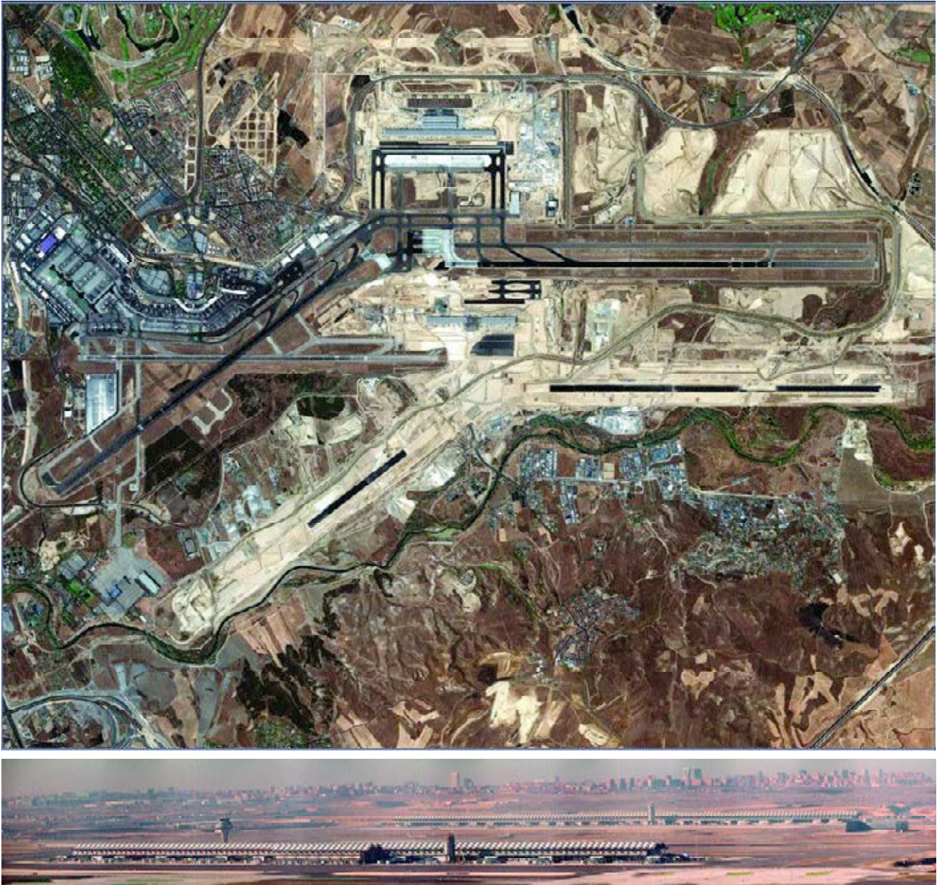
Figura 1. Vista general de las obras.
