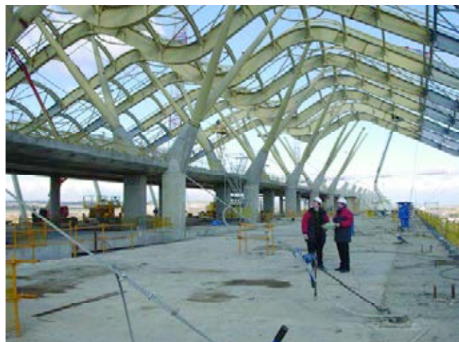
Figura 1. Estructura metálica de cubierta en construcción.
