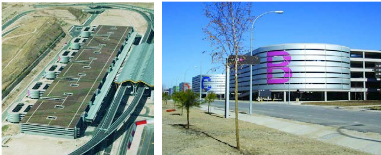
Figura 22. Vista general del aparcamiento.
