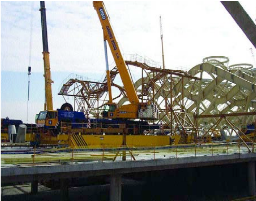
Figura 30. Grúas y plataformas de montaje.
