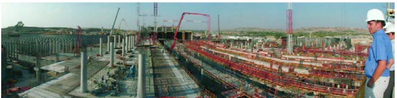
Figura 15. Zona central. Distintas etapas durante la construcción.
