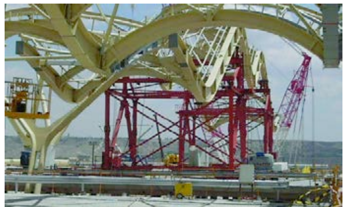
Figura 14. Ripado de un módulo de 9x72 m mediante sistema de patines sobre teflón.
