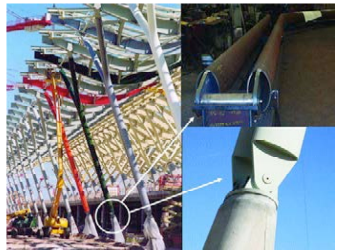
Figura 20. Pilares en Y: base de anclaje
