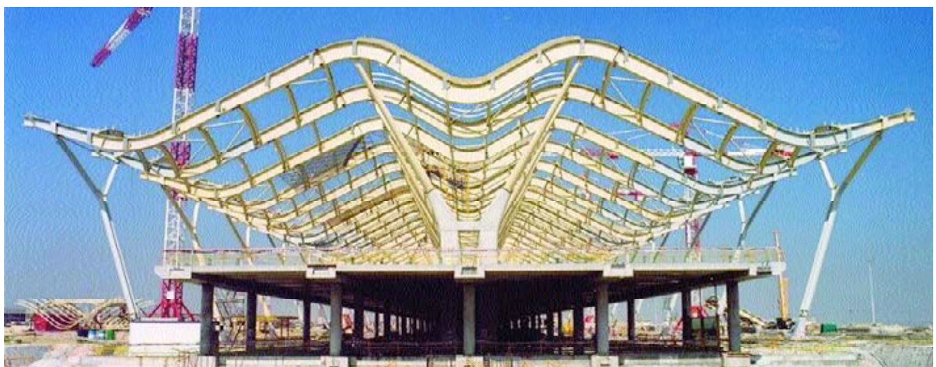
Figura 4. Pórtico tipo de estructura principal.
