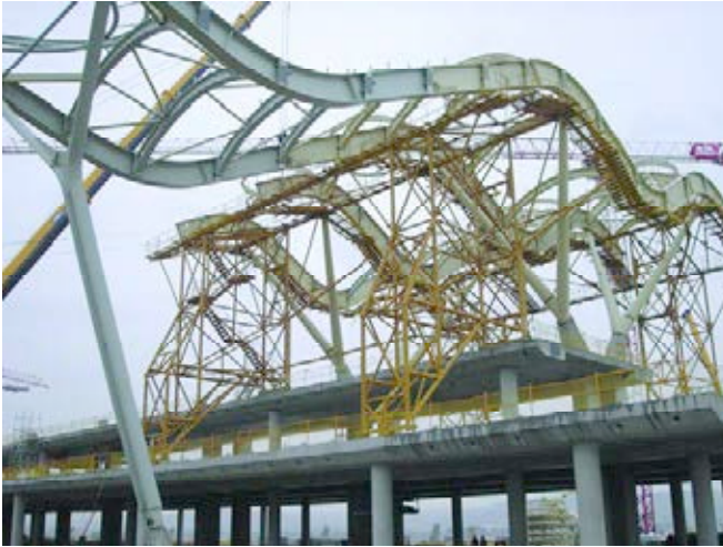
Figura 15. Montaje mediante carretes-plataforma en el dique sur.
