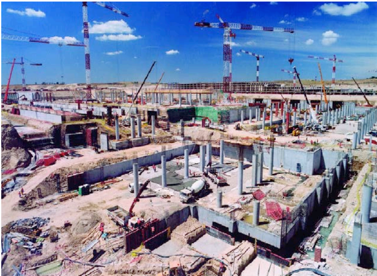
Figura 1. Vista general de cimentación.
