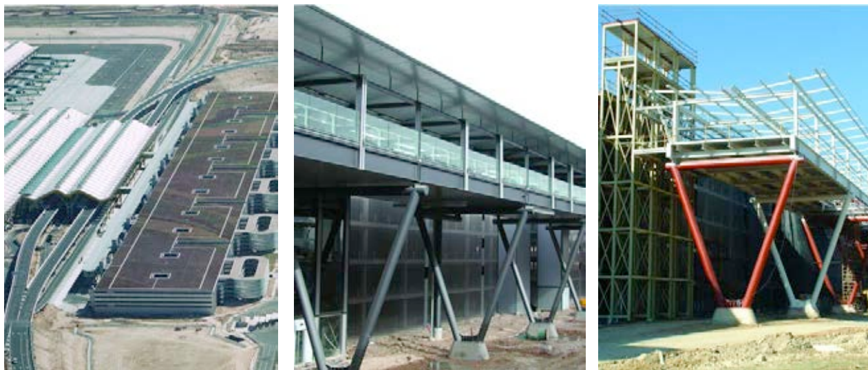
Figura 28. Pasillo Este de circulación horizontal a través de los distintos módulos del Edificio de Aparcamientos.
