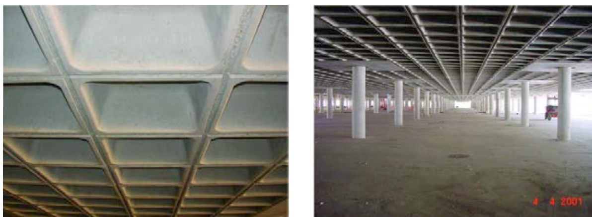
Figura 23. Detalles forjado y pilares del Edificio de Aparcamiento.
