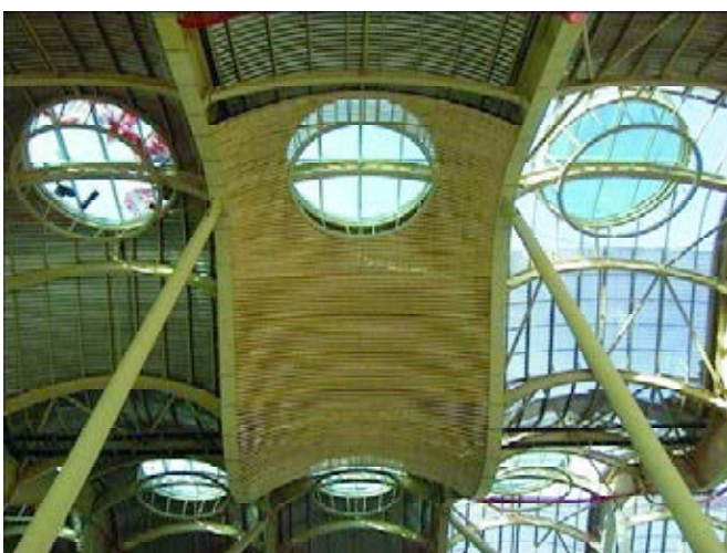
Figura 8. Vista inferior de cubierta.
