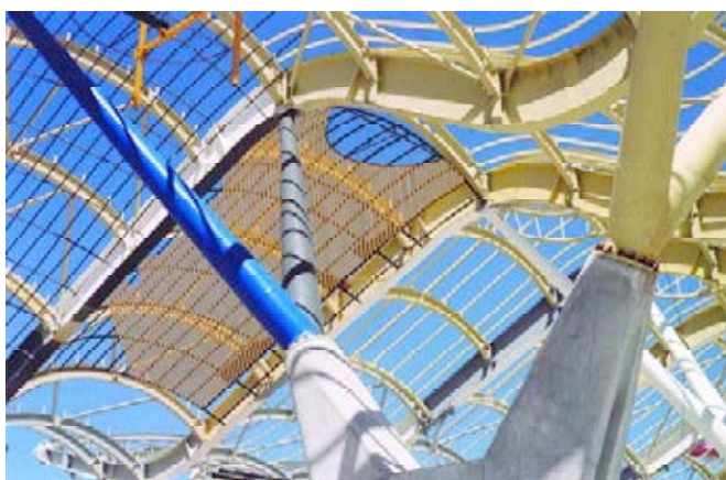
Figura 14. Pilares en V: vista general.
