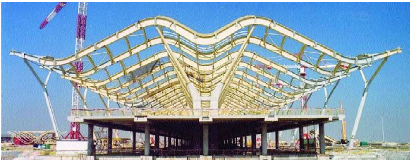
Figura 4. Pórtico tipo de estructura principal.
