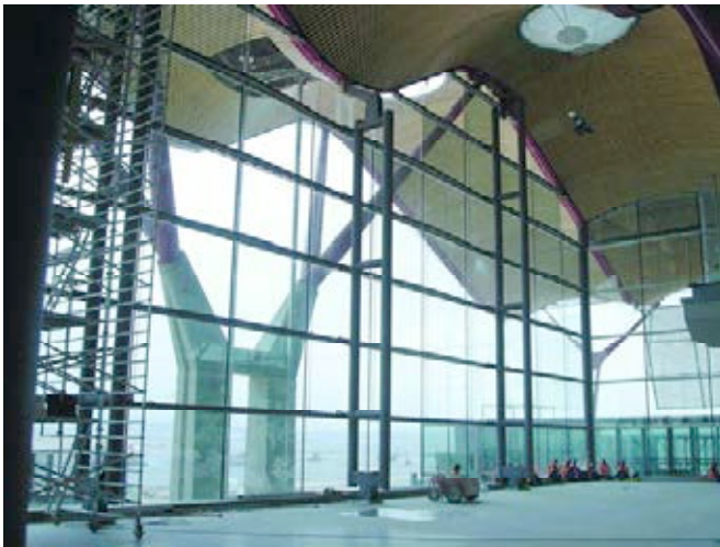
Figura 4. Muro cortina tipo A-3, vista interior.
