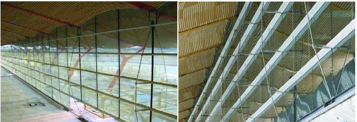
Figura 31. Vistas de la fachada tensada.
