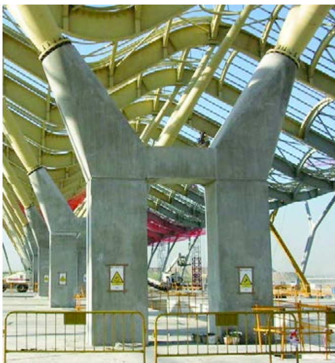
Figura 4. Pilar CORONA. Acabado de la superficie del hormigón I.
