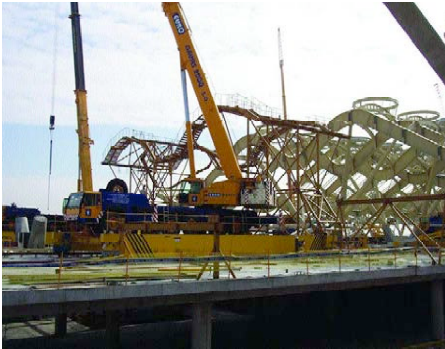
Figura 30. Grúas y plataformas de montaje.
