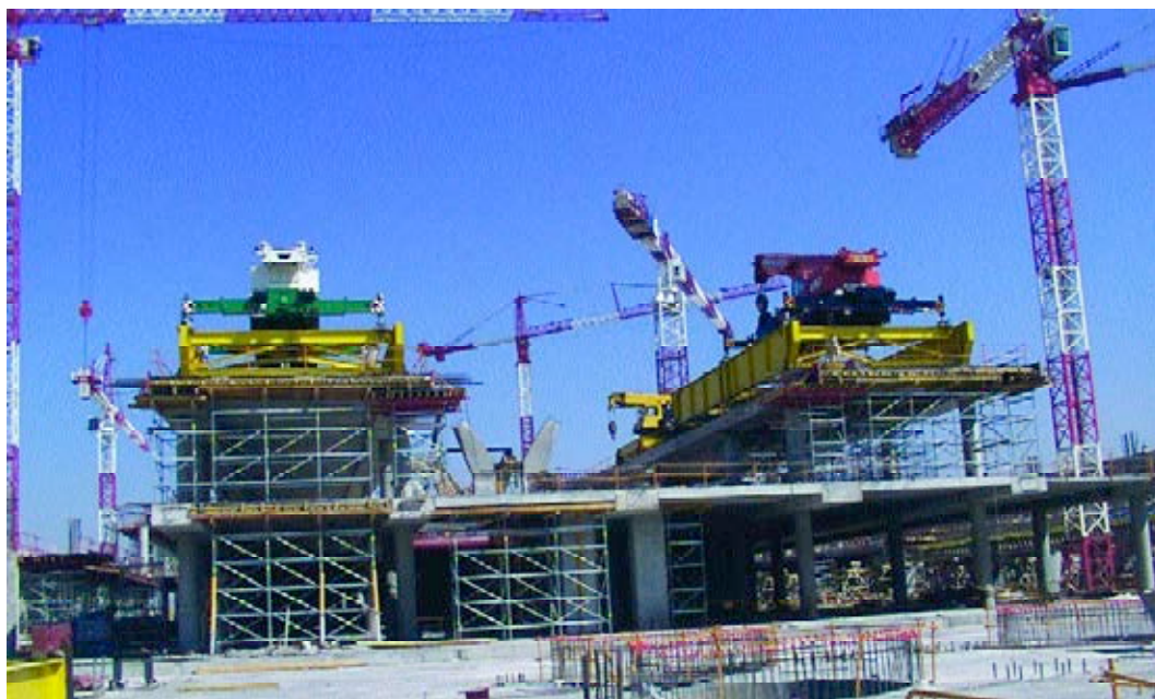
Figura 29. Situación de las grúas sobre forjados.
