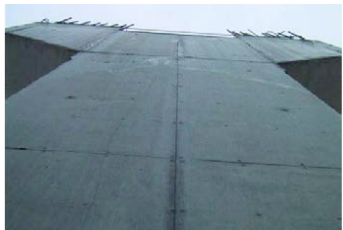
Figura 7. Estructura en zonas no públicas. Acabado de la superficie del hormigón I.
