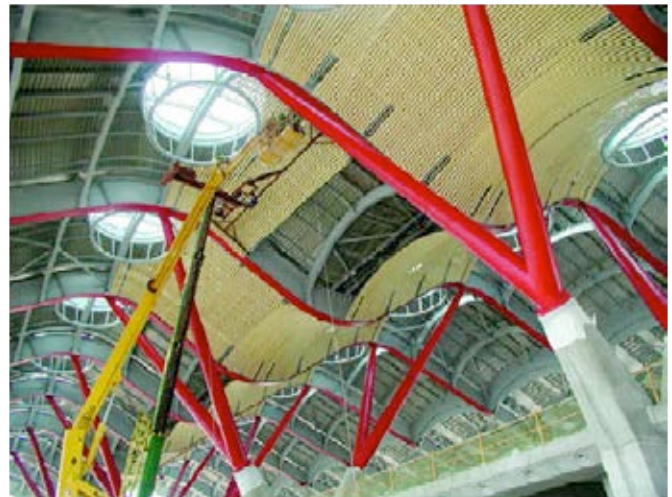
Figura 10. Vista general interior del falso techo.
