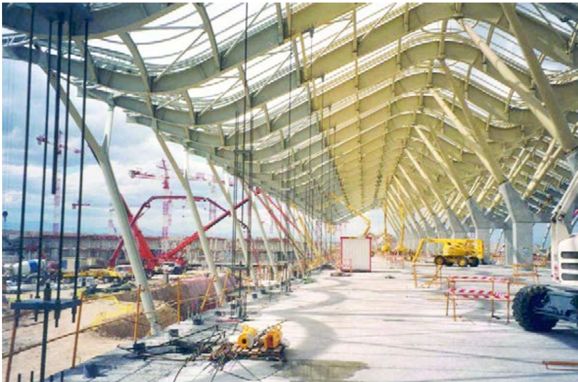
Figura 13. Detalle tirantes provisionales.
