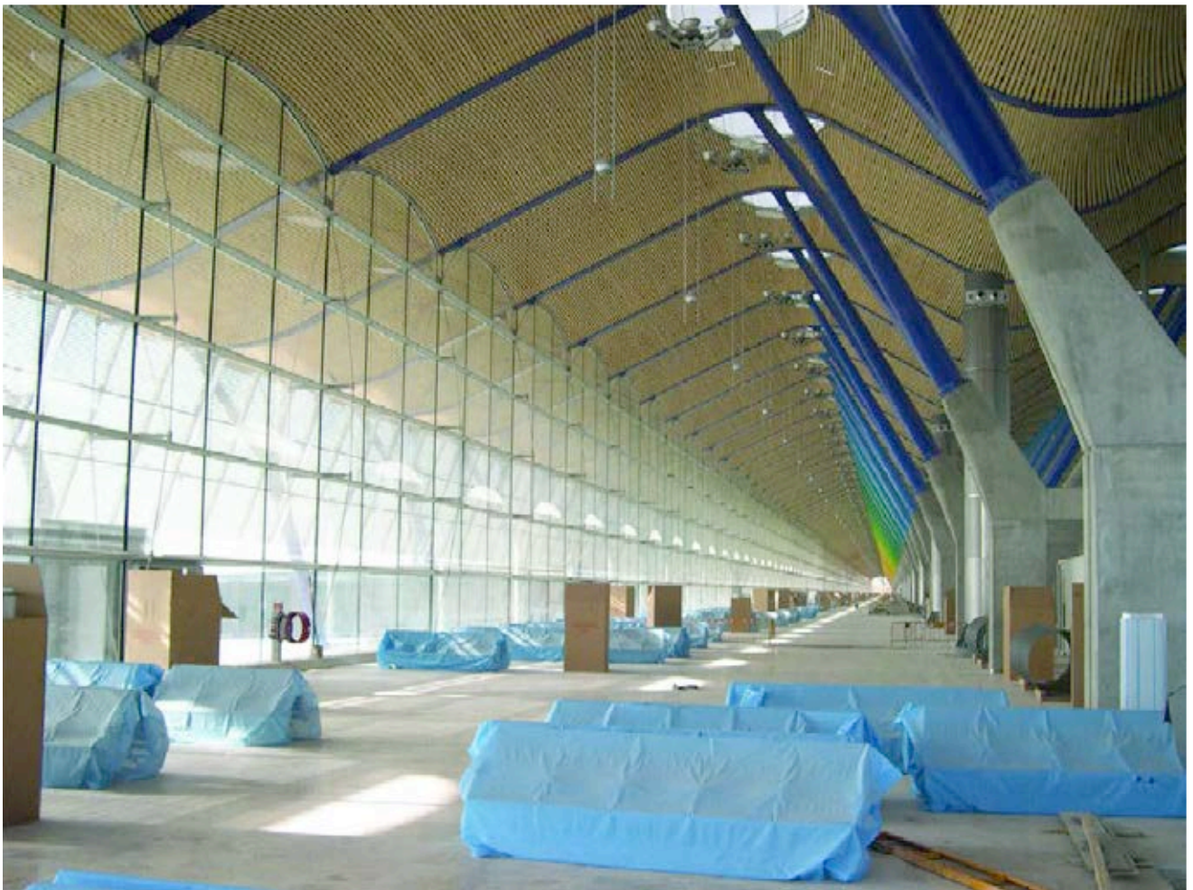
Figura 15. Alineación de la fachada obtenida mediante el control geométrico en el montaje.
