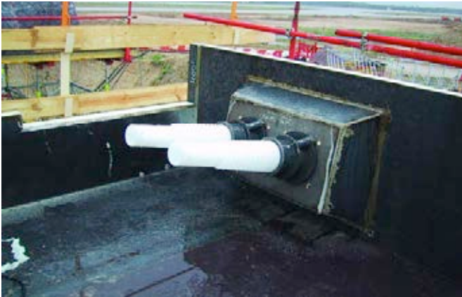
Figura 6. Fijación de placa y trompeta al cajetín de pretensado.
