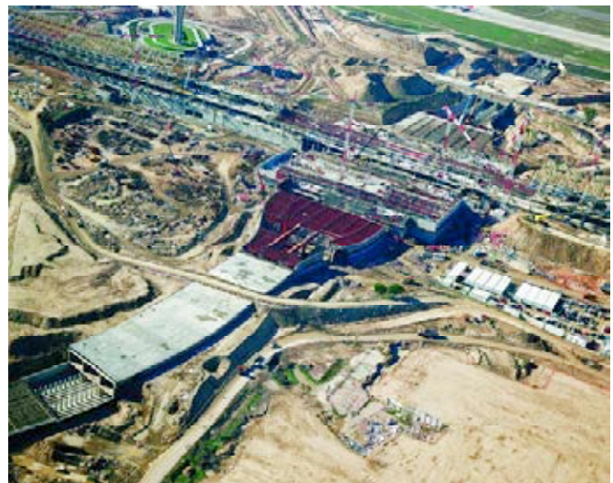
Figura 10. Vista aérea del túnel de servicio.
