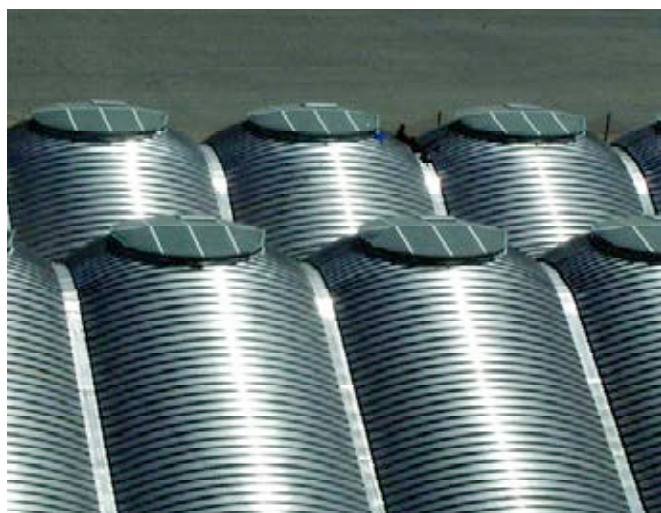
Figura 3. Cubierta exterior de aluminio.
