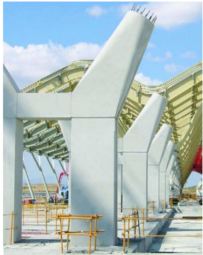
Figura 5. Pilar CORONA. Acabado de la superficie del hormigón II.
