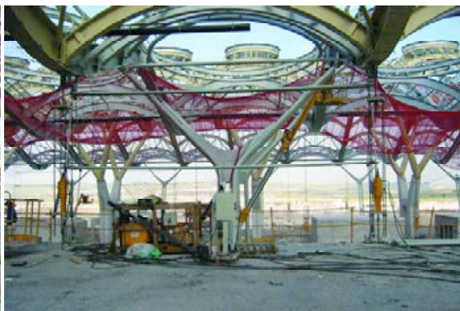
Figura 20. Vista parcial Tesado conjunto de Dique y Procesador.
