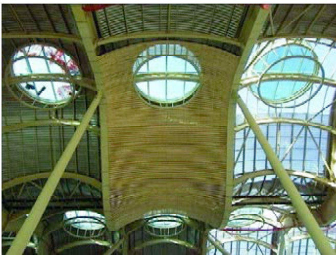
Figura 8. Vista inferior de cubierta.
