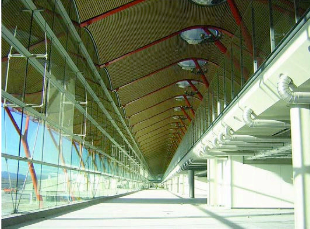
Figura 2. Fachada acristalada con perfil de aluminio.
