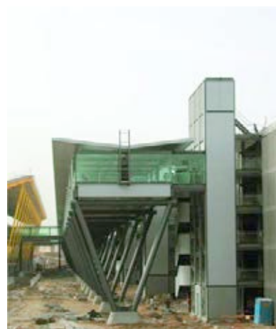
Figura 27. Ascensores y montacargas panorámicos de circulación vertical.
