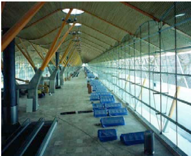
Figura 4. Detalle vista Interior celosías de fachada.
