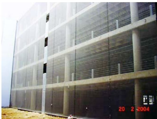
Figura 5. Fachada del aparcamiento.
