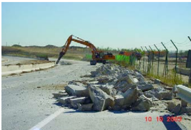
Figura 15. Demolición de pavimento (para reciclar).
