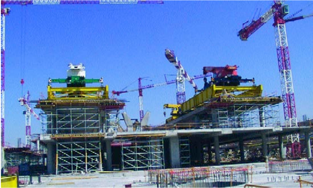
Figura 29. Situación de las grúas sobre forjados.
