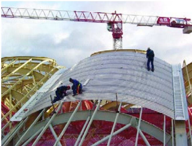
Figura 5. Láminas precurvadas de aluminio.
