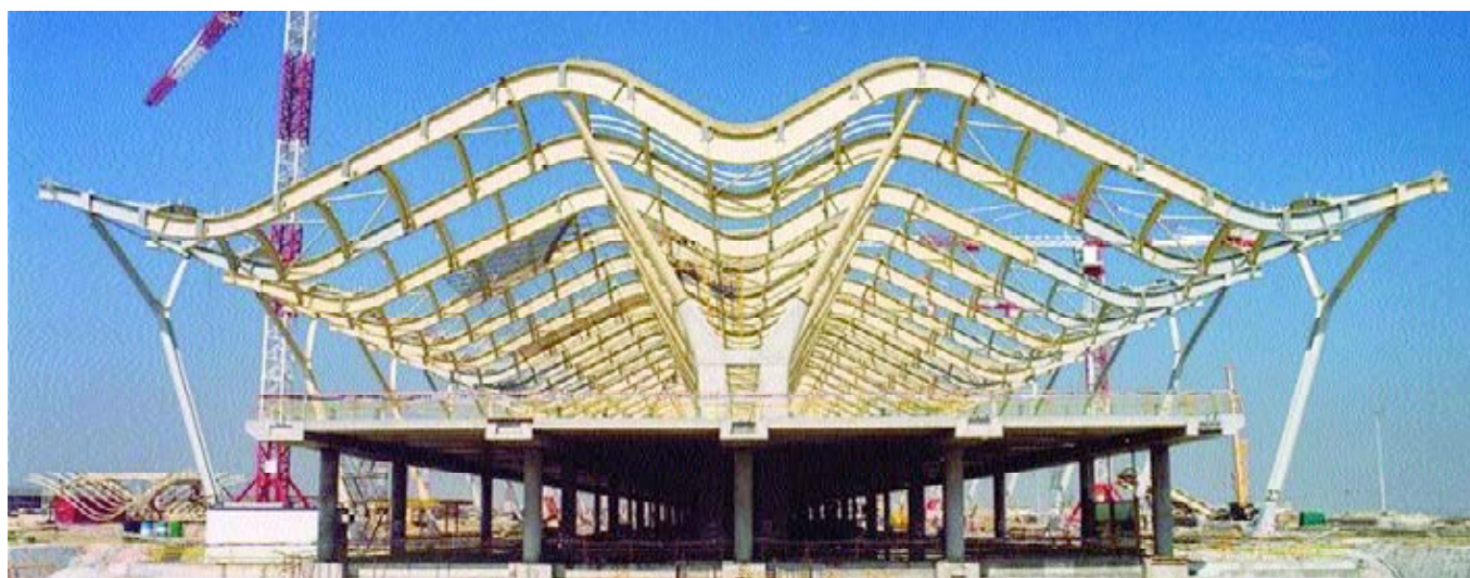
Figura 4. Pórtico tipo de estructura principal.
