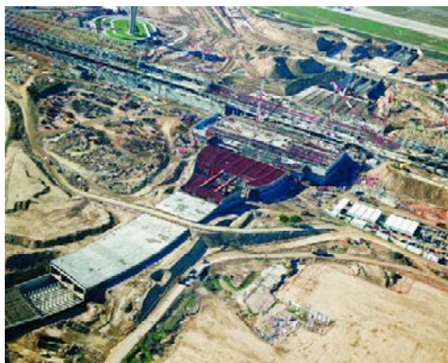
Figura 10. Vista aérea del túnel de servicio.
