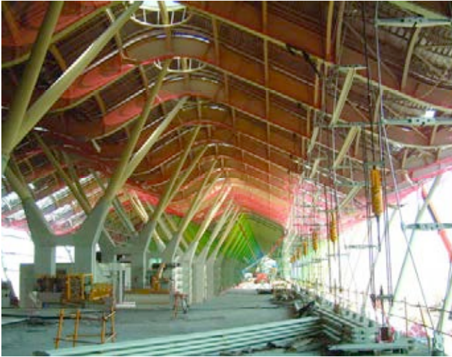
Figura 14. Control geométrico en el montaje.
