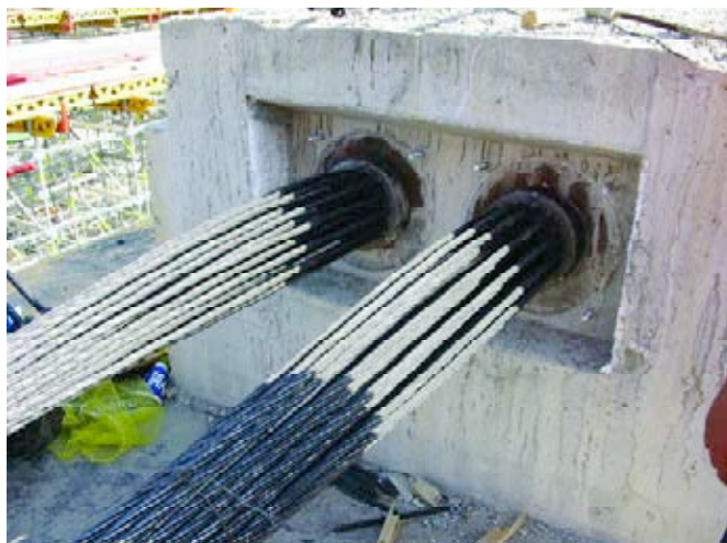
Figura 3. Anclajes en viga tipo de hormigón.
