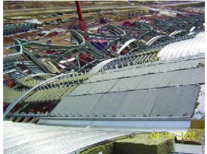
Figura 6. Ejecución de la impermeabilización y aislamiento.
