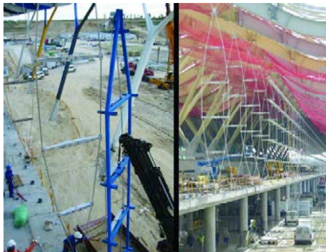
Figura 37. Montaje de kipper
