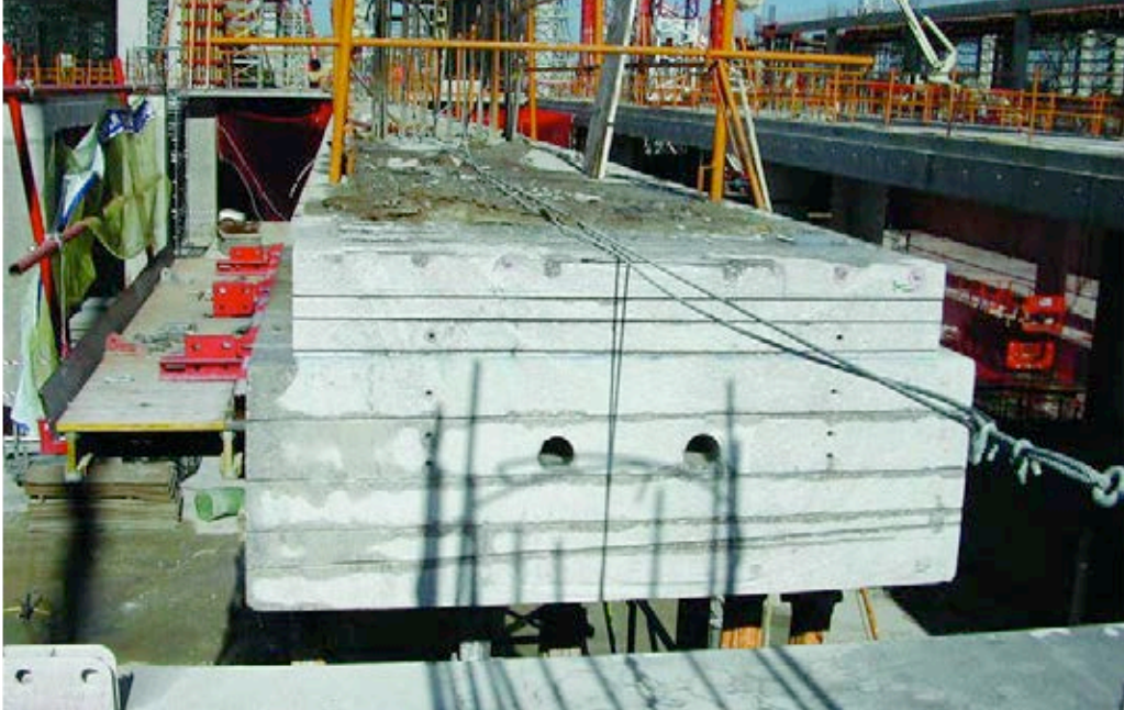
Figura 12. Precorte con disco de vigas.
