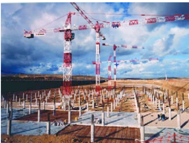
Figura 3. Realización de la Cimentación.
