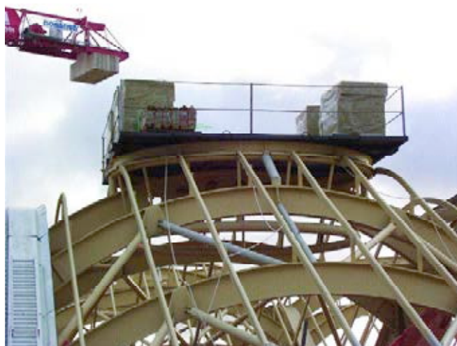
Figura 4. Aspecto del montaje de la cubierta.
