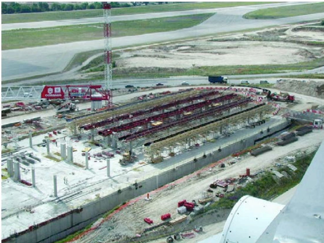
Figura 1. Aspecto de ejecución de la estructura.
