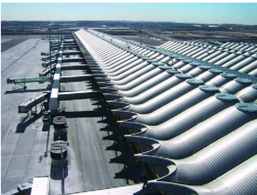
Figura 14. Cubierta de Terminal. Figure 14. Terminal Roof.
