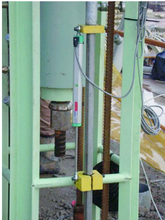
Figura 17. Detalle de transductor lineal de desplazamiento junto al gato de tesado.
