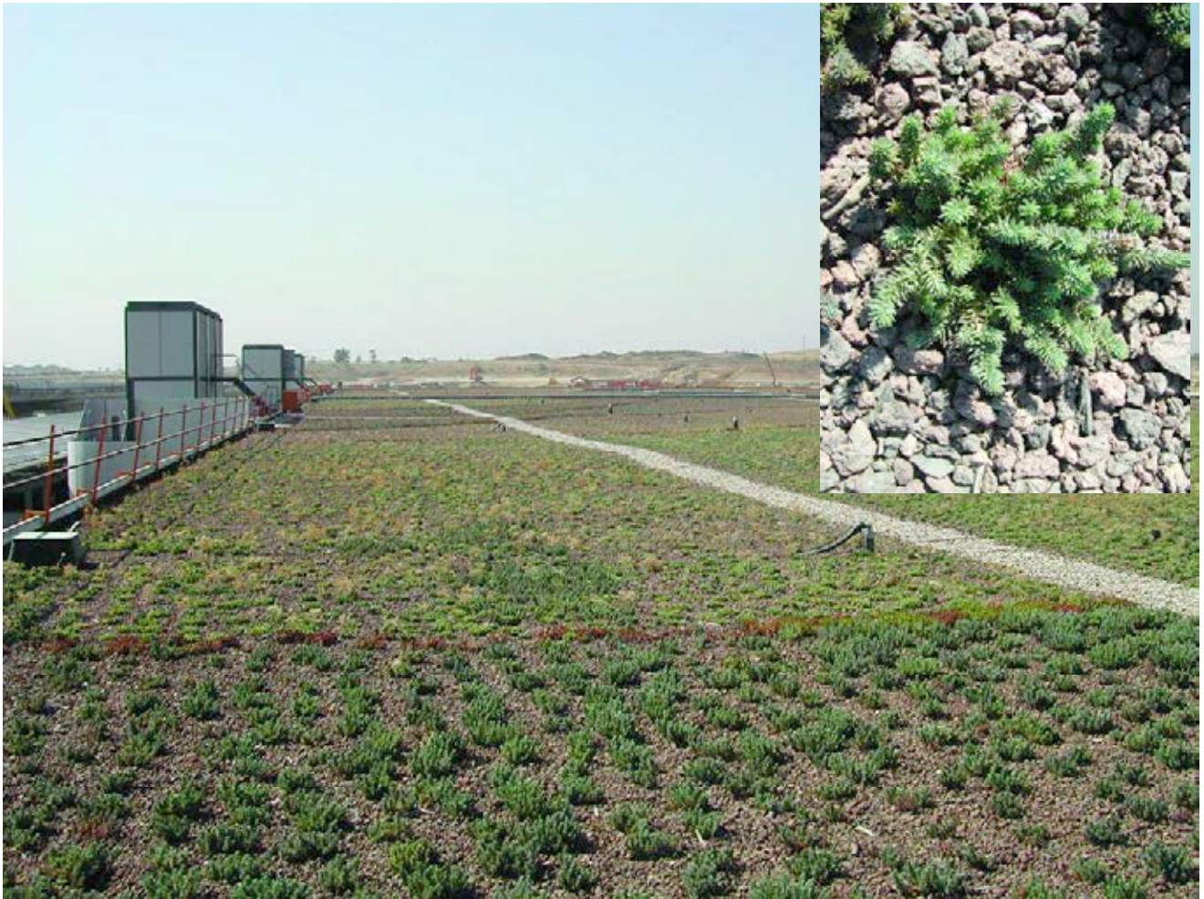
Figura 8. Aspecto de la cubierta ecológica.
