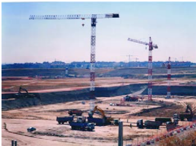
Figura 2. Ejecución del movimiento de tierras.
