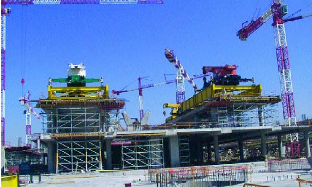
Figura 29. Situación de las grúas sobre forjados.
