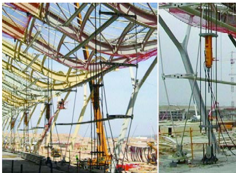
Figura 35. Elementos de tesado, por módulos.
