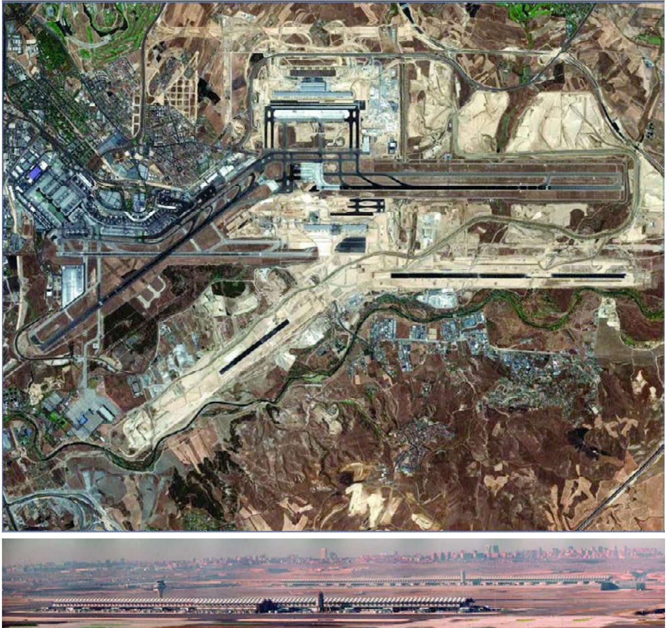
Figura 1. Vista general de las obras.
