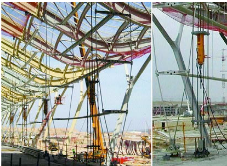
Figura 35. Elementos de tesado, por módulos.
