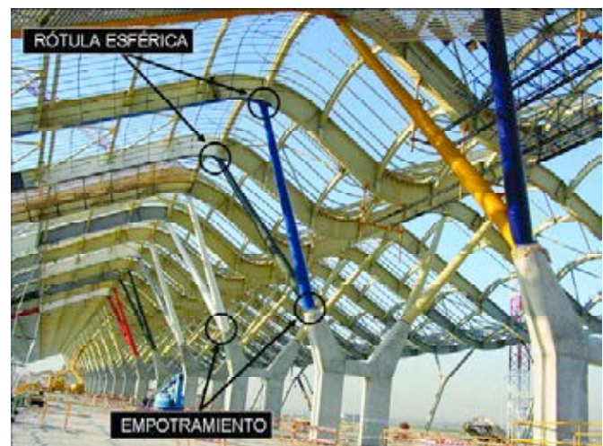
Figura 15. Pilares en V: esquema resistente.
