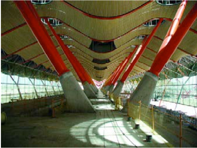
Figura 8. Vista interior del falso techo de bambú.
