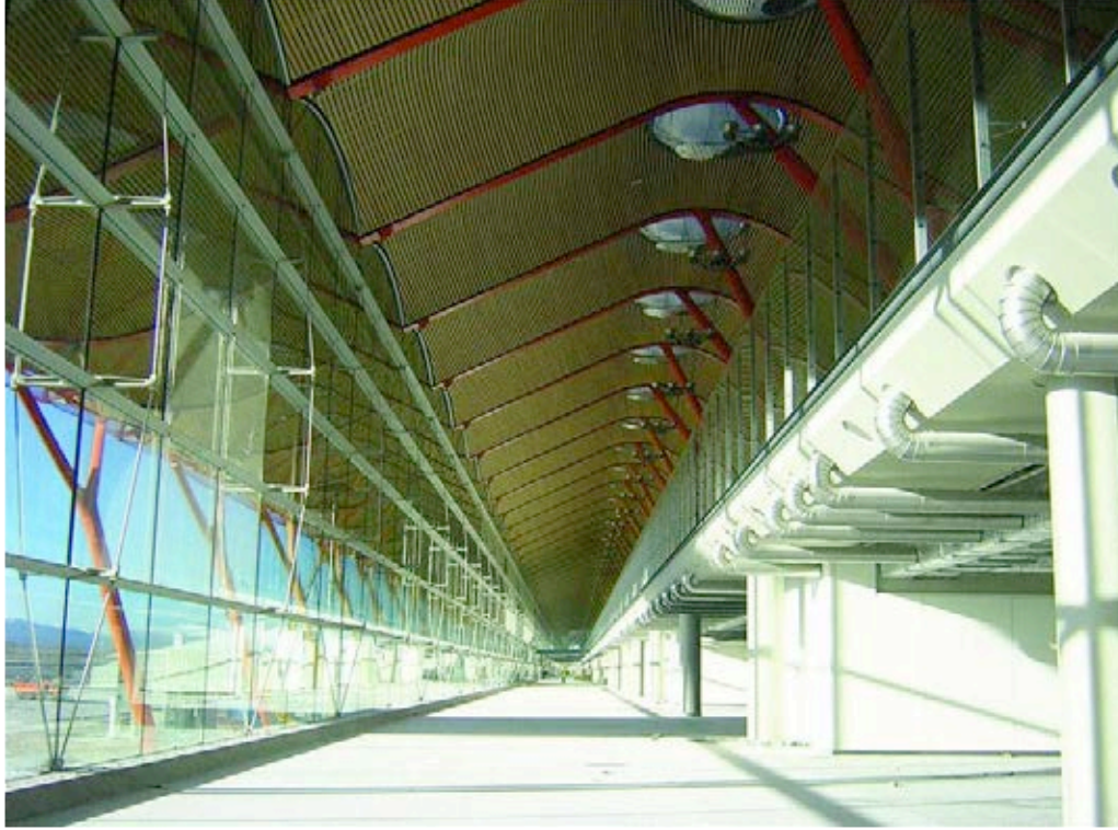
Figura 2. Fachada acristalada con perfil de aluminio.
