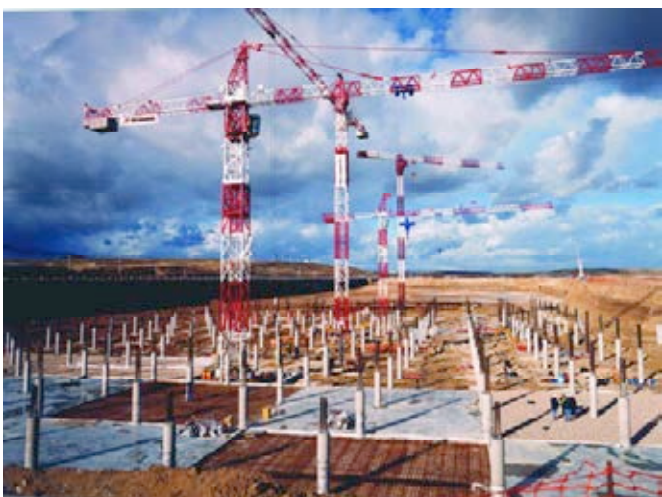
Figura 3. Realización de la Cimentación.
