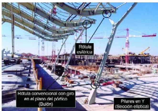
Figura 19. Pilares en Y: esquema resistente.
