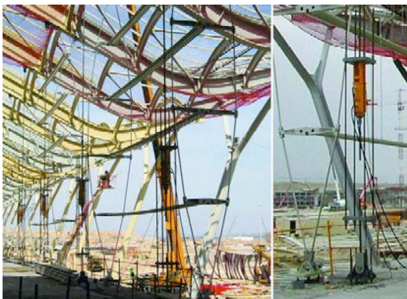
Figura 35. Elementos de tesado, por módulos.
