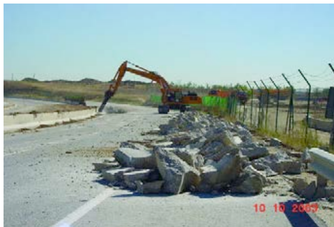
Figura 15. Demolición de pavimento (para reciclar).
