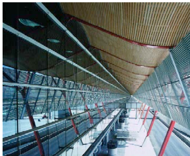
Figura 5. Detalle exterior de la Fachada.
