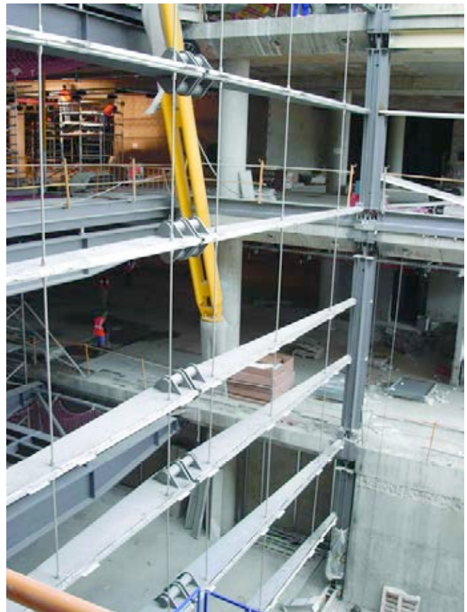
Figura 6. Muro cortina tipo B-2, vista exterior previa a la colocación del vidrio.
