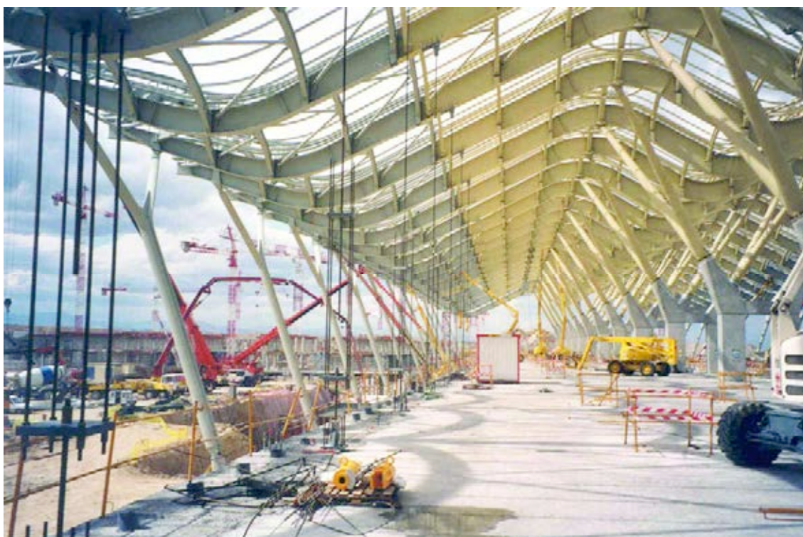
Figura 13. Detalle tirantes provisionales.
