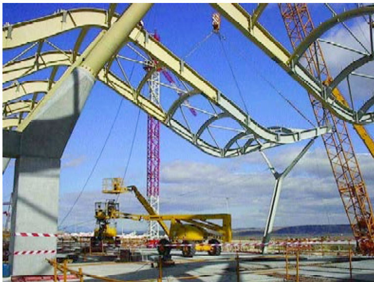
Figura 27. Montaje de parejas de dintel.
