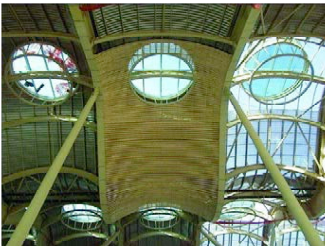
Figura 8. Vista inferior de cubierta.
