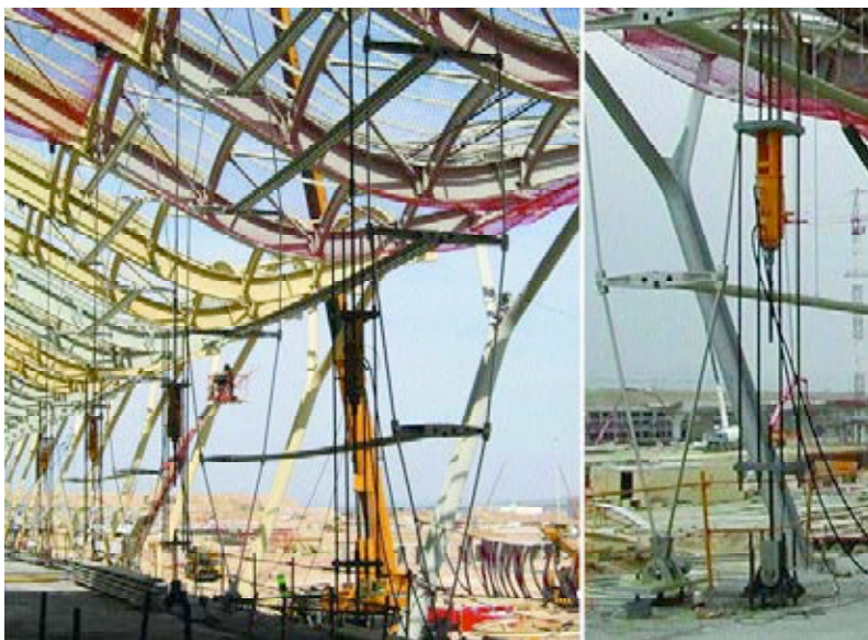
Figura 35. Elementos de tesado, por módulos.
