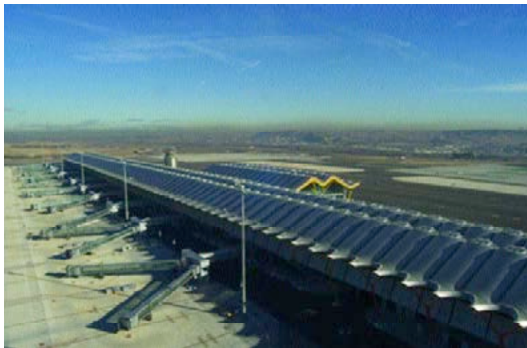
Figura 13. Vista general del Edificio Satélite.
