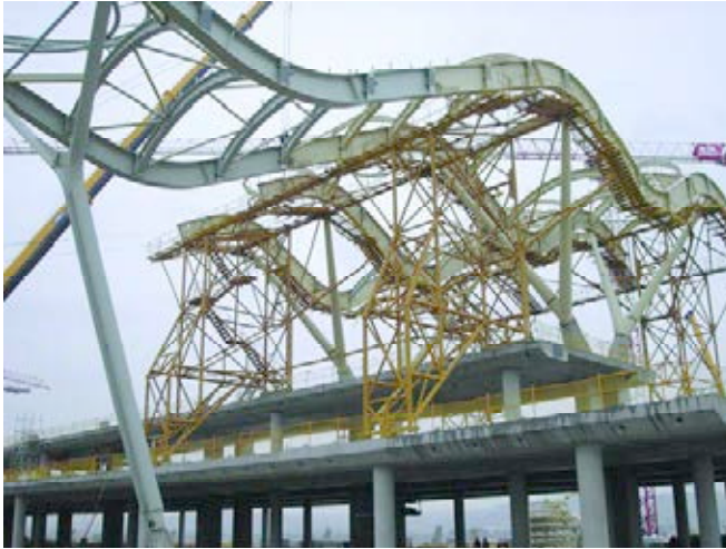
Figura 15. Montaje mediante carretes-plataforma en el dique sur.
