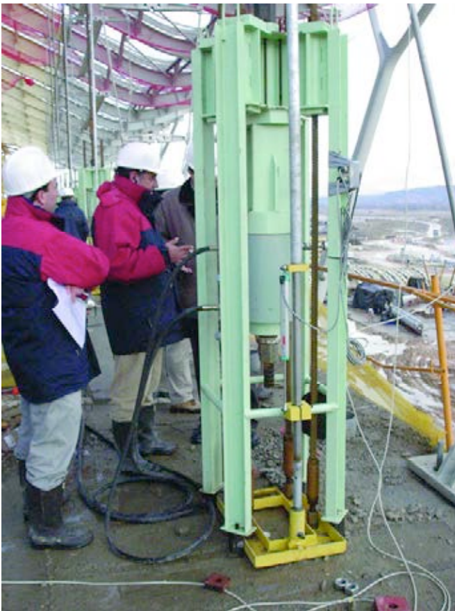
Figura 16. Tirante provisional junto a celosía de fachada A-1.
