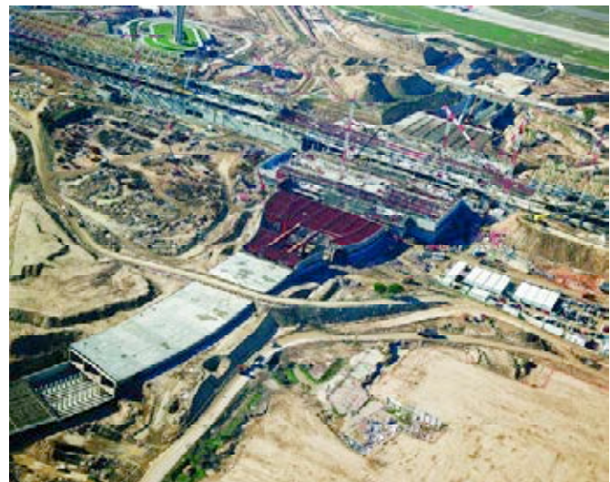
Figura 10. Vista aérea del túnel de servicio.
