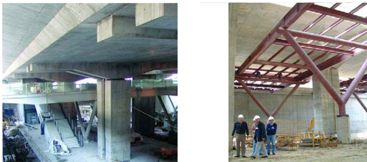
Figura 30. Pasarelas peatonales a la cota -4,90.
