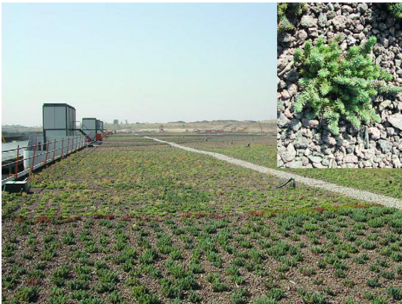
Figura 8. Aspecto de la cubierta ecológica.
