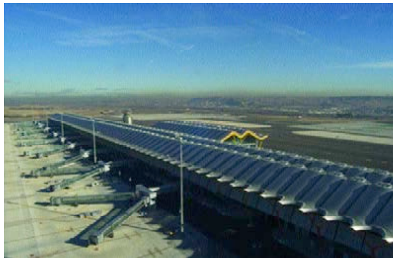
Figura 13. Vista general del Edificio Satélite.
