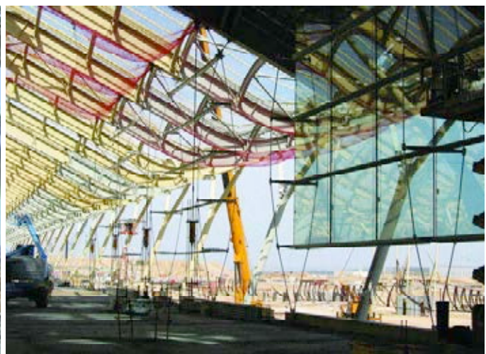
Figura 38. Tesado de módulo.
