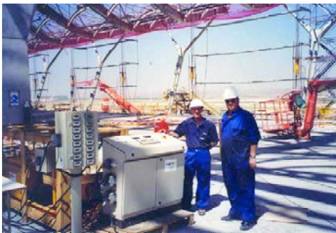
Figura 14. Vista general módulo simétrico con 16 gatos.
