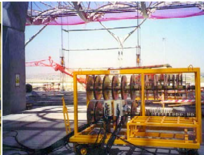
Figura 12. Detalle Sistema de desplazamiento en la obra.
