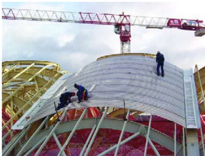
Figura 5. Láminas precurvadas de aluminio.
