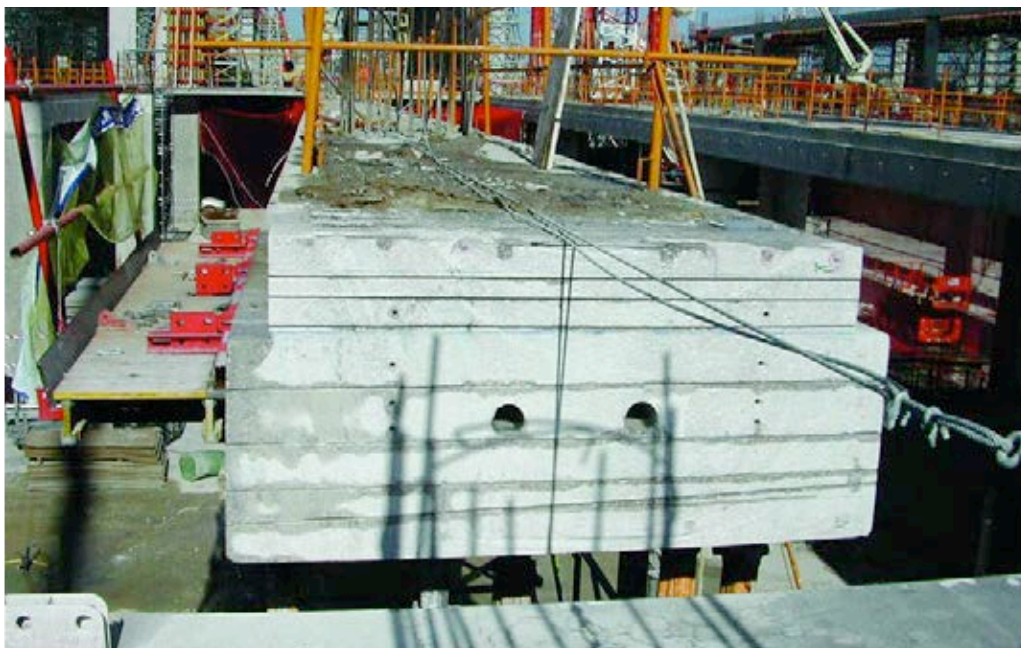
Figura 12. Precorte con disco de vigas.
