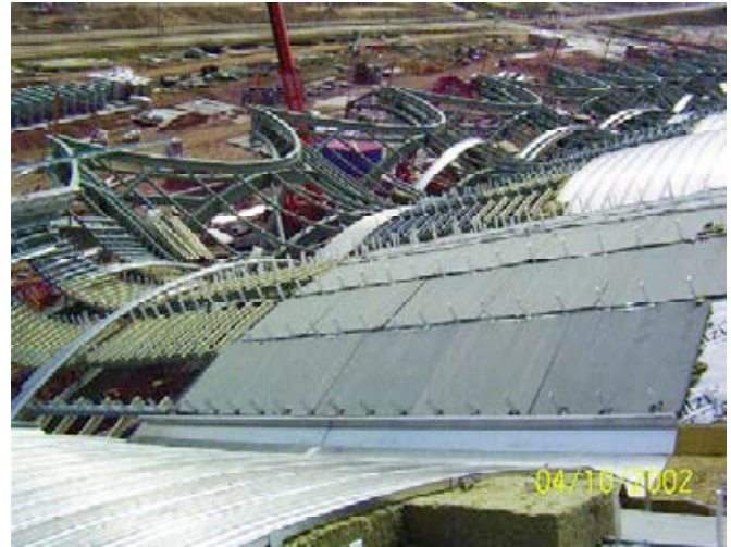
Figura 6. Ejecución de la impermeabilización y aislamiento.
