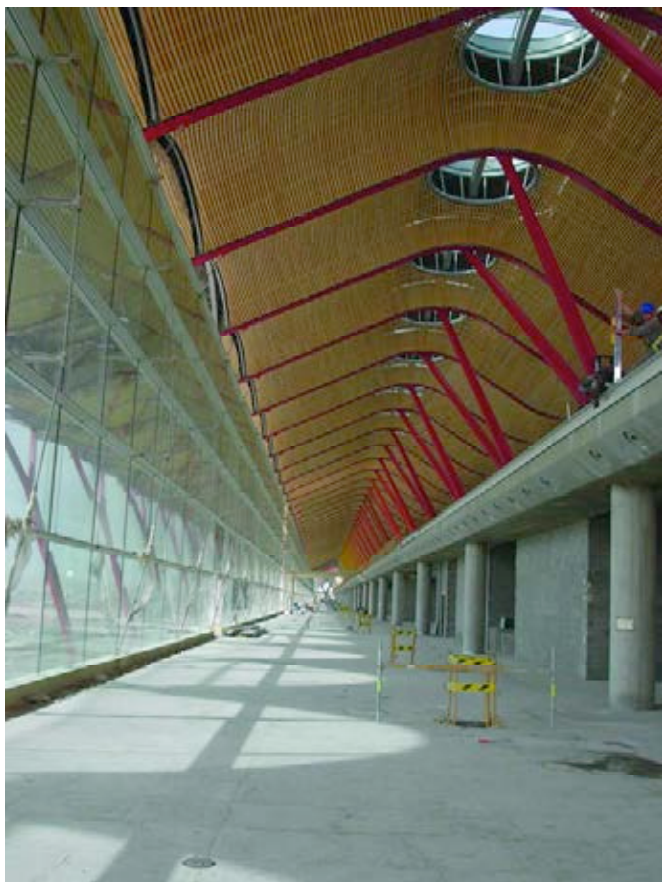
Figura 7. Vista interior del edificio con la fachada tipo A-1.
