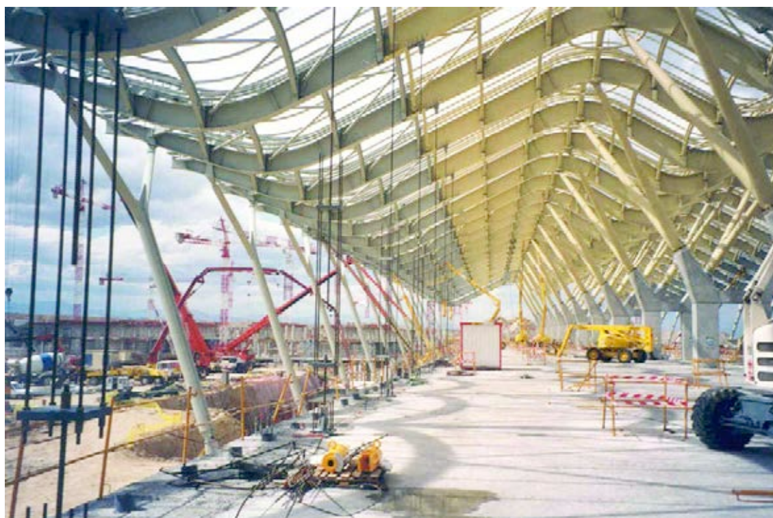
Figura 13. Detalle tirantes provisionales.
