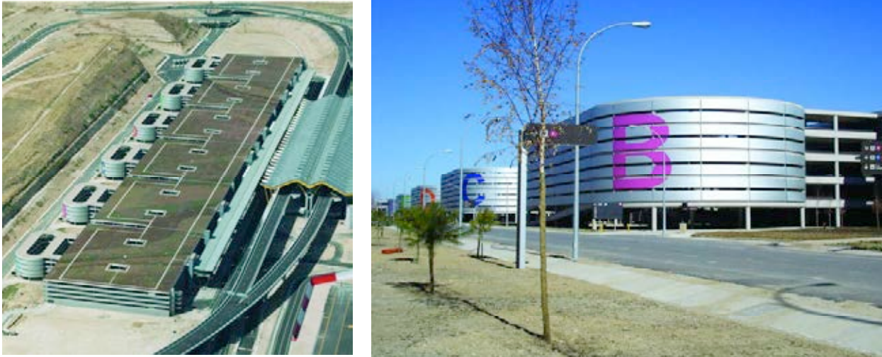
Figura 22. Vista general del aparcamiento.
