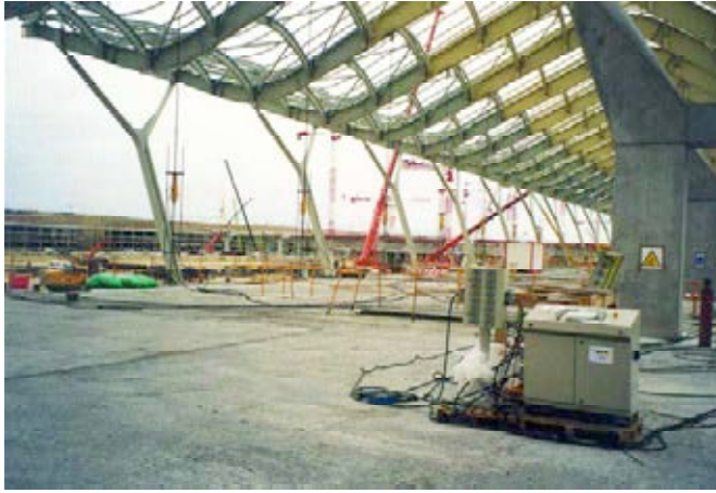
Figura 15. Tesado en vacío de uno de los módulos.
