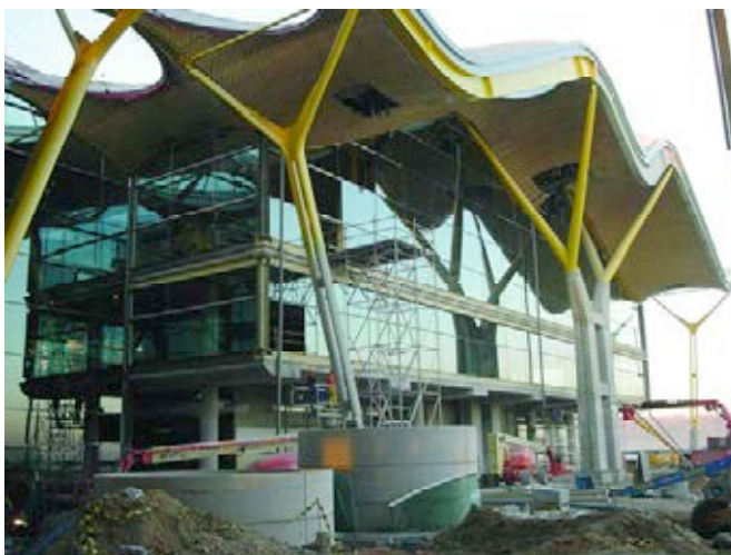
Figura 5. Muro cortina tipo A-4, vista exterior.
