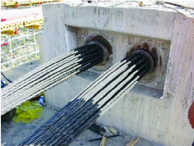
Figura 3. Anclajes en viga tipo de hormigón.
