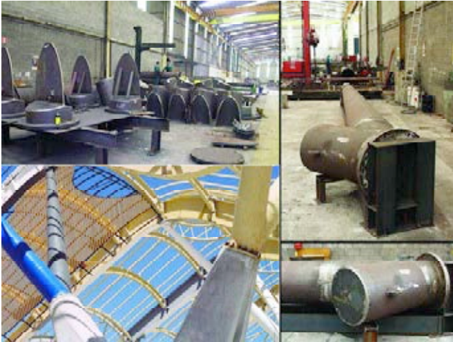
Figura 17. Base de pilar en V: fabricación.
