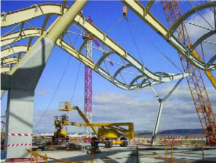
Figura 27. Montaje de parejas de dintel.
