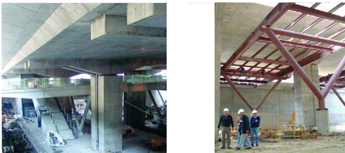
Figura 30. Pasarelas peatonales a la cota -4,90.
