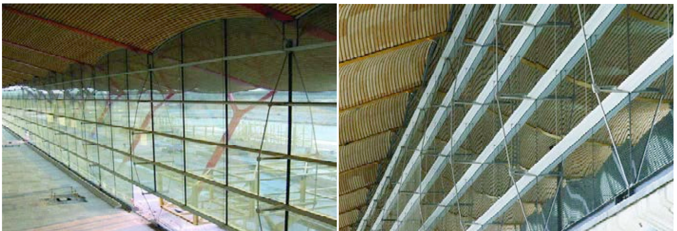
Figura 31. Vistas de la fachada tensada.
