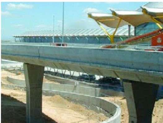
Figura 38. Junta de dilatación, en voladizo en el centro de vano, entre la dársena superior y los viaductos de acceso.
