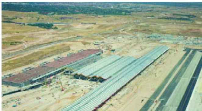
Figura 2. Vista general del Edificio Terminal.
