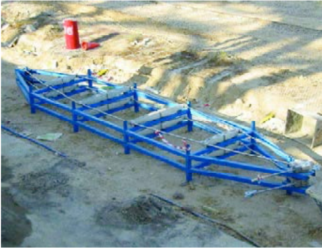
Figura 36. Estructura provisional de montaje.
