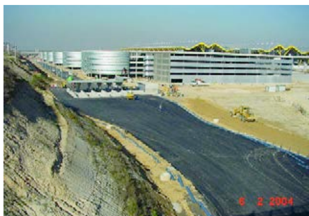
Figura 12. Construcción de los accesos.
