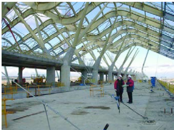
Figura 1. Estructura metálica de cubierta en construcción.
