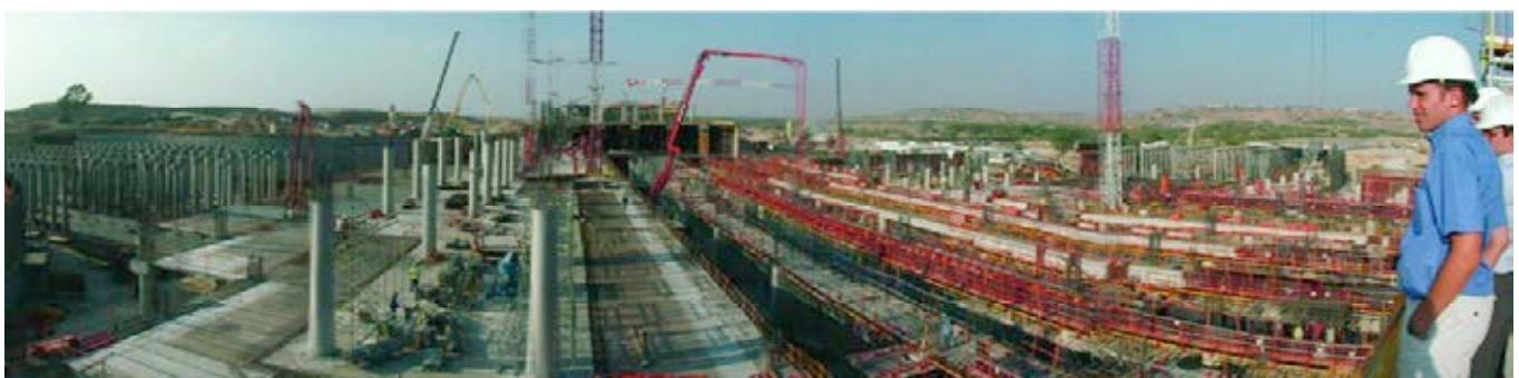
Figura 15. Zona central. Distintas etapas durante la construcción.
