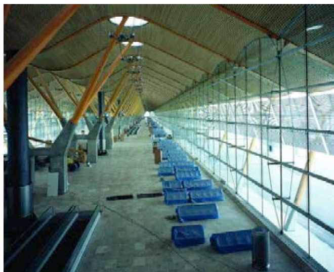
Figura 4. Detalle vista Interior celosías de fachada.
