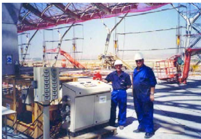
Figura 14. Vista general módulo simétrico con 16 gatos.
