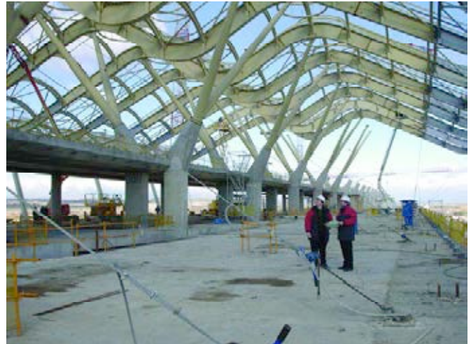
Figura 1. Estructura metálica de cubierta en construcción.
