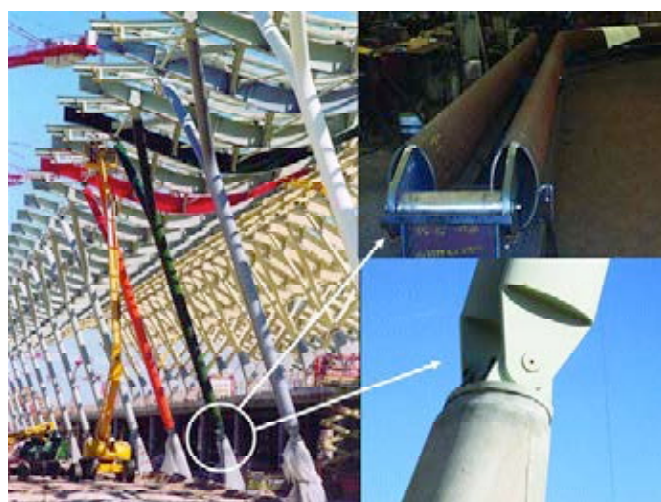
Figura 20. Pilares en Y: base de anclaje
