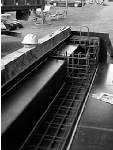
Figura 7. Armado de la viga V1-SFRC.
