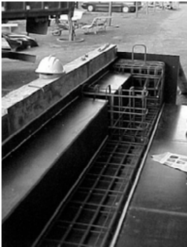
Figura 7. Armado de la viga V1-SFRC.
