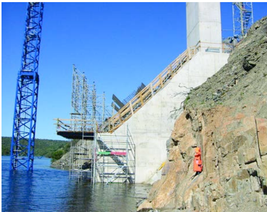
Fig. 4. Máximo nivel del embalse, en construcción. Fig. 4. Maximum level of the reservoir, under construction.
