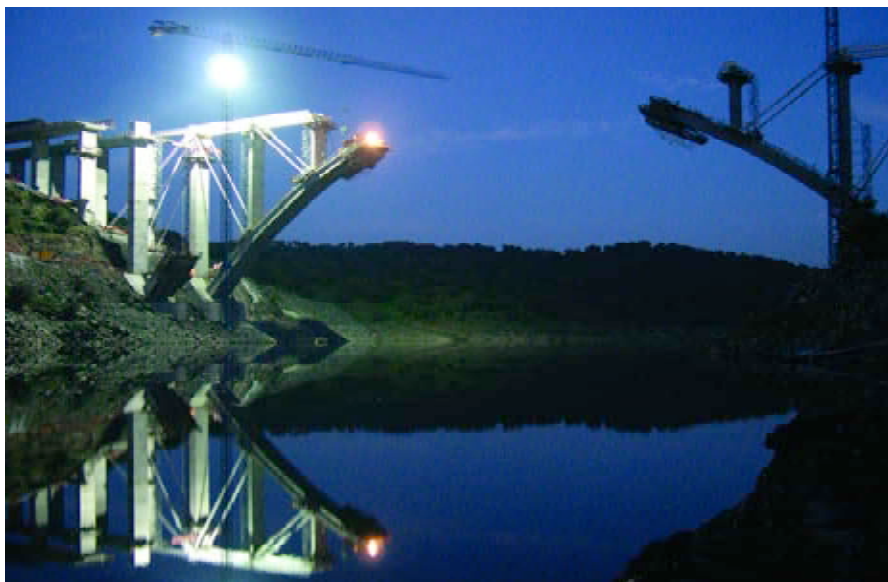
Fig.26. Avance del arco. Trabajos nocturnos. Fig.26. Arch advance. Night work.
