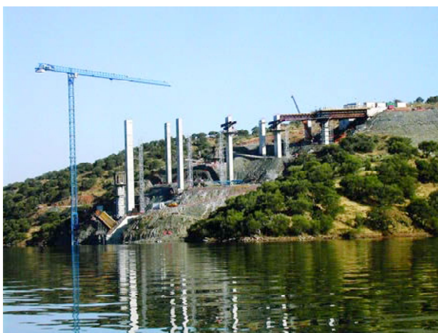
Fig. 5. Máximo nivel del embalse, en construcción. Fig. 5. Maximum level of the reservoir, under construction.
