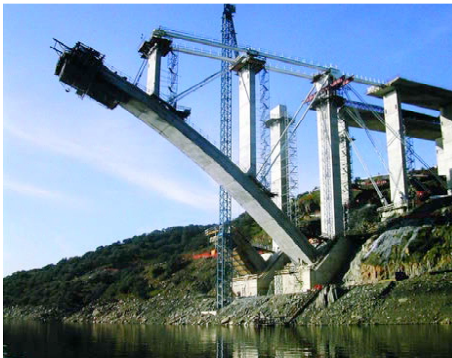
Fig.22. Viaducto de Almonte. Proceso constructivo por triangulación. Fig.22. Almonte Viaduct. Triangulation construction process.
