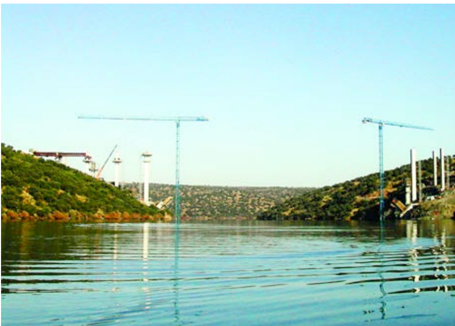
Fig. 25. Trabajos simultáneos en pilas, arcos y tablero. Fig. 25. Simultaneous work on piers, arches and deck.
