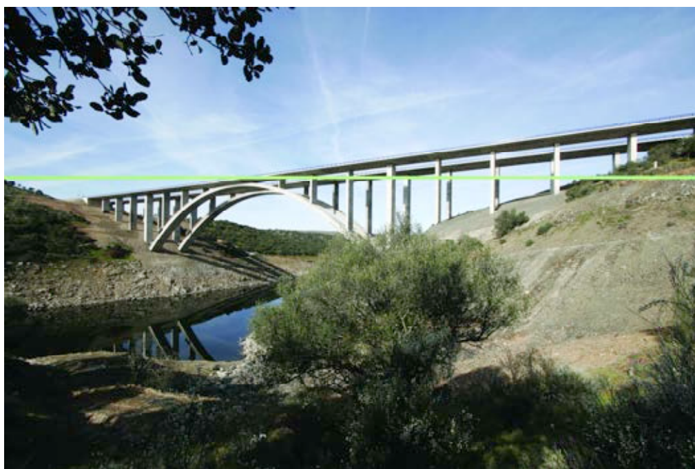
Fig.1. Viaducto de Almonte. Fig.1. Almonte Viaduct.
