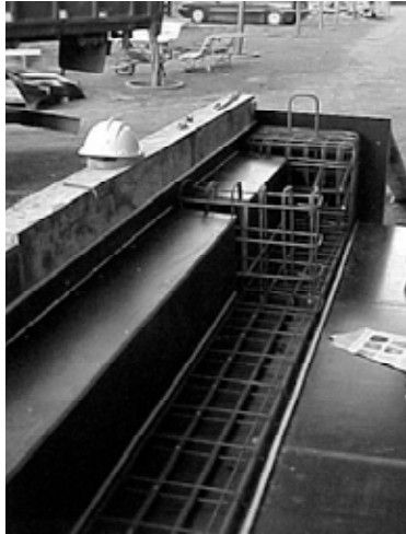
Figura 7. Armado de la viga V1-SFRC.
