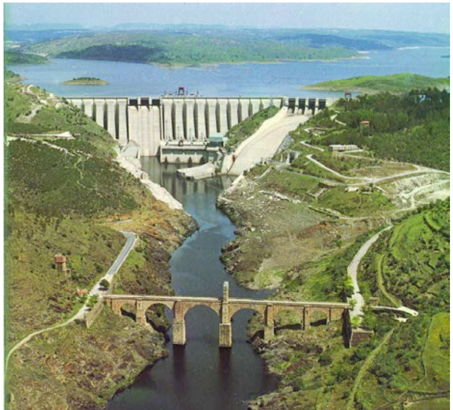
Fig.3. Puente Romano de Alcántara Fig.3. Alcántara Roman Bridge
