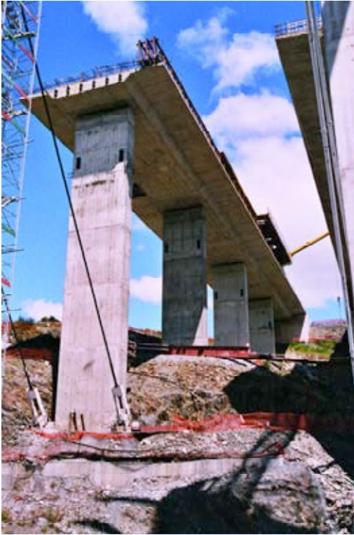
Fig.15. Vista tablero en construcción. Fig.15. View of deck under construction.
