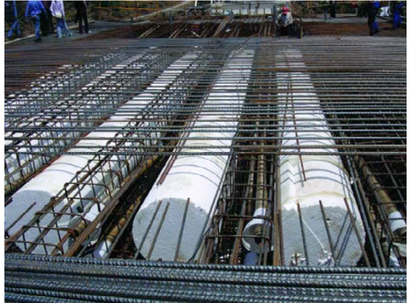
Fig.16. Tablero listo para hormigonar. Fig.16. Deck ready for concreting.
