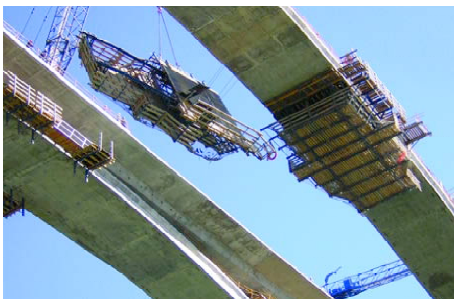
Fig.28. Desmontaje de los carros de avance Fig.28. Removing the advancing carriages.
