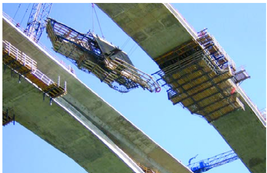
Fig.28. Desmontaje de los carros de avance Fig.28. Removing the advancing carriages.
