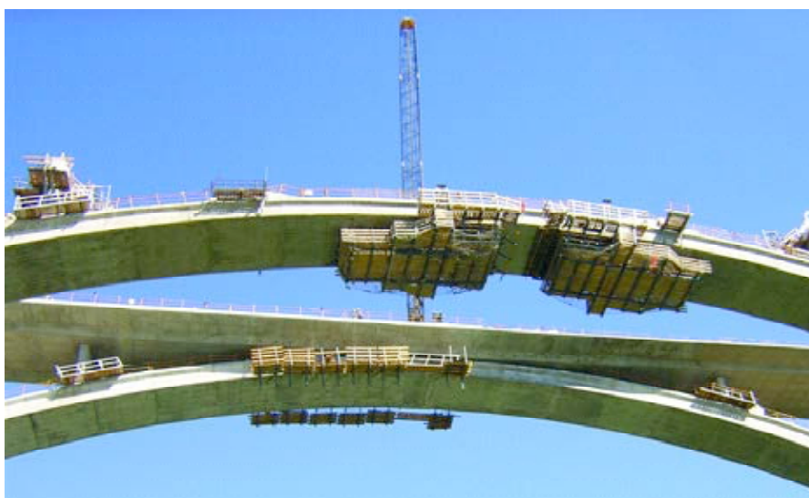
Fig.27. Carros de avance en posición final. Fig.27. Advancing carriages in the final position.
