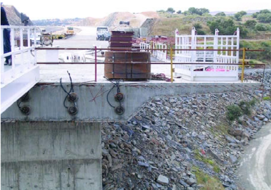
Fig.17. Detalles frente de fase del tablero. Fig.17. Details, front of deck phase.
