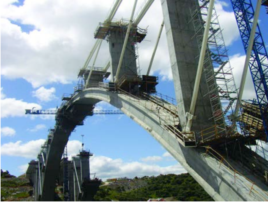
Fig. 24. Viaducto de Almonte. Proceso constructivo desarrollado para ACCIONA Infraestructuras. Fig. 24. Almonte Viaduct. Construction process developed by ACCIONA Infraestructuras.
