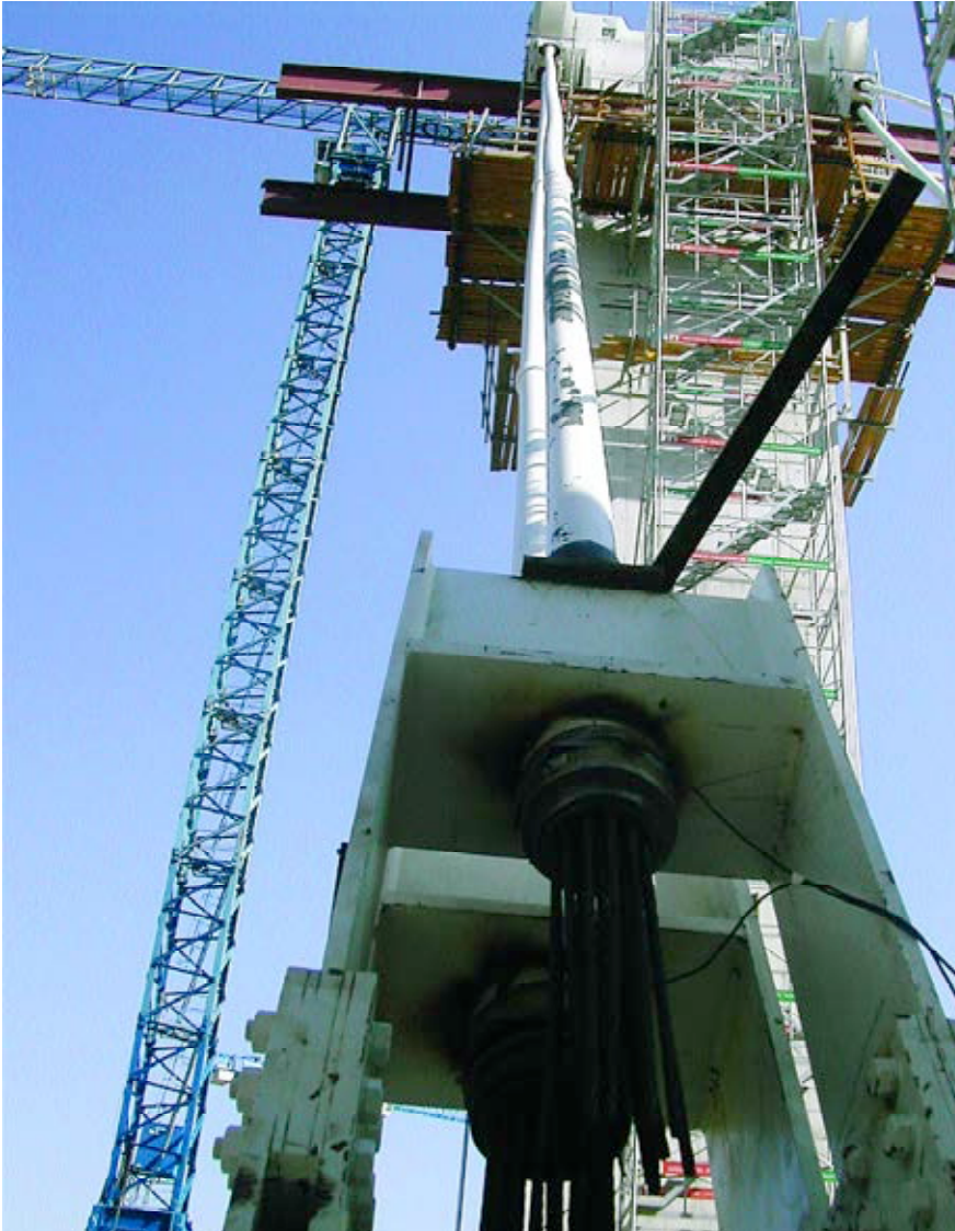
Fig.40. Detalle de tesado de los cables de retenida. Fig.40. Detail of retaining cable tensioning.
