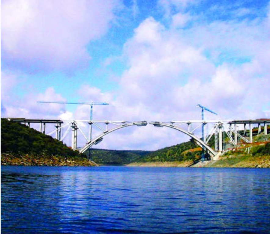
Fig.20. Alzado general en construcción. Fig.20. General elevation under construction.
