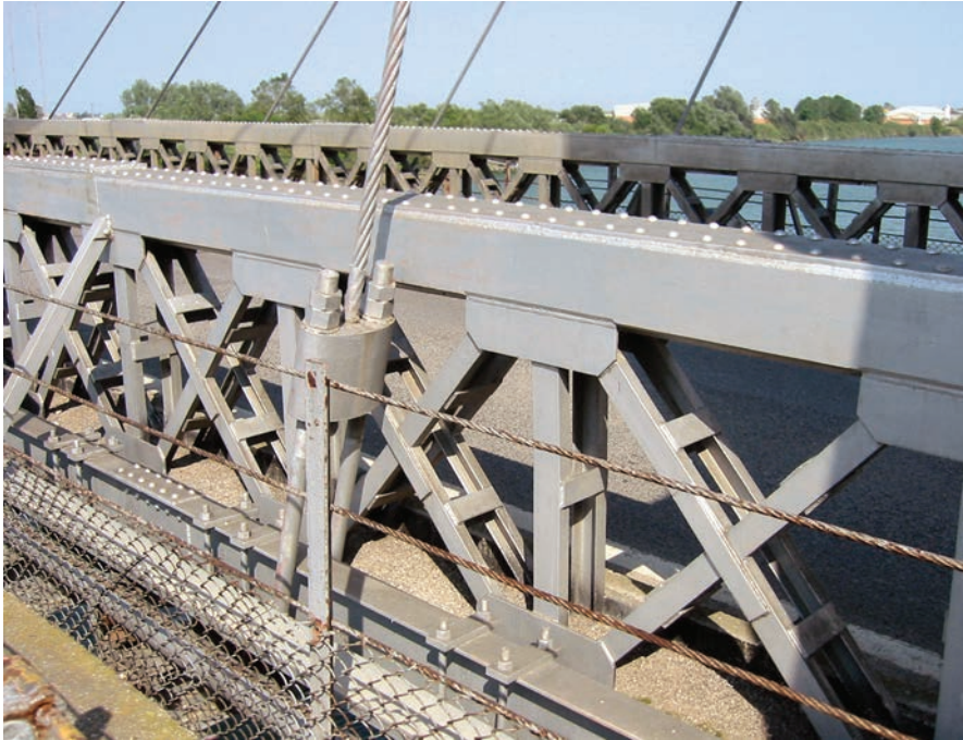
Figura 19. Viga de rigidez. Figure 19. Stiffening beam.
