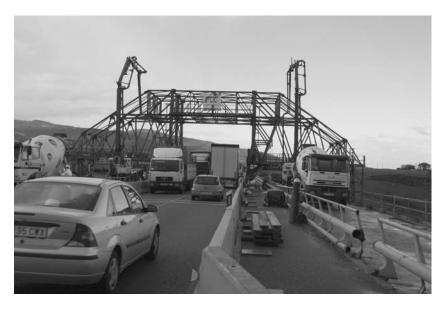
Figura 9. Circulación de camiones sobre la ampliación ejecutada.
