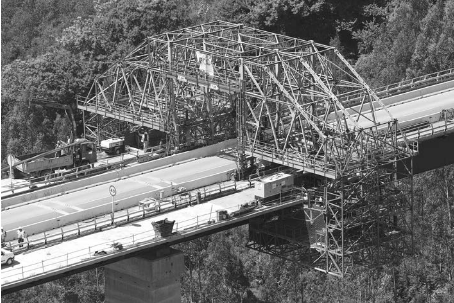
Figura 10. Perspectiva general del carro de hormigonado automóvil.
