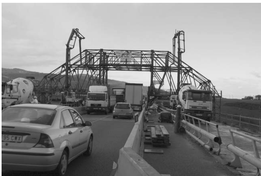
Figura 9. Circulación de camiones sobre la ampliación ejecutada.
