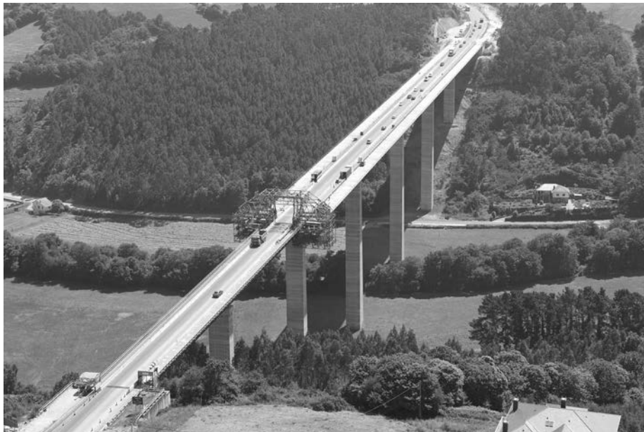
Figura 11. Viaducto de San Timoteo durante la ampliación del tablero.
