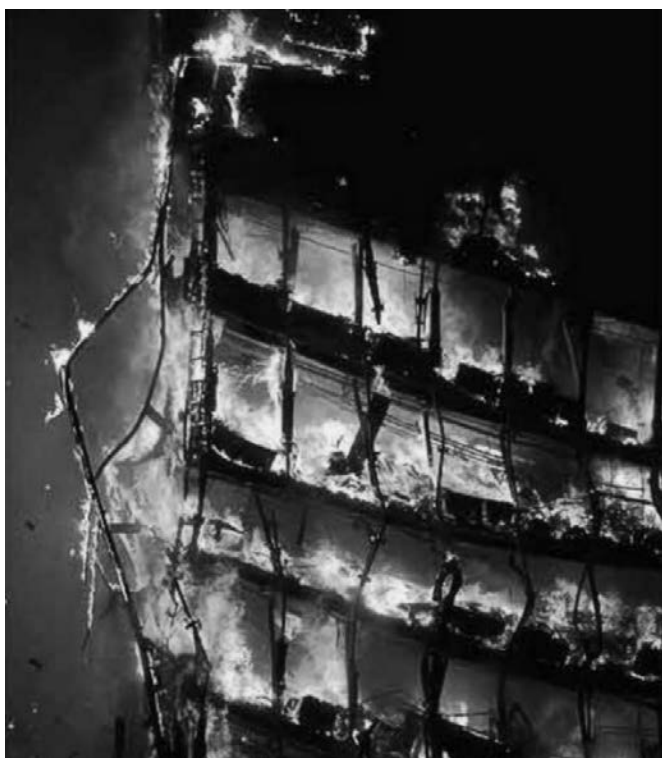
Figura 1: Incendio en el Edificio Windsor de Madrid
