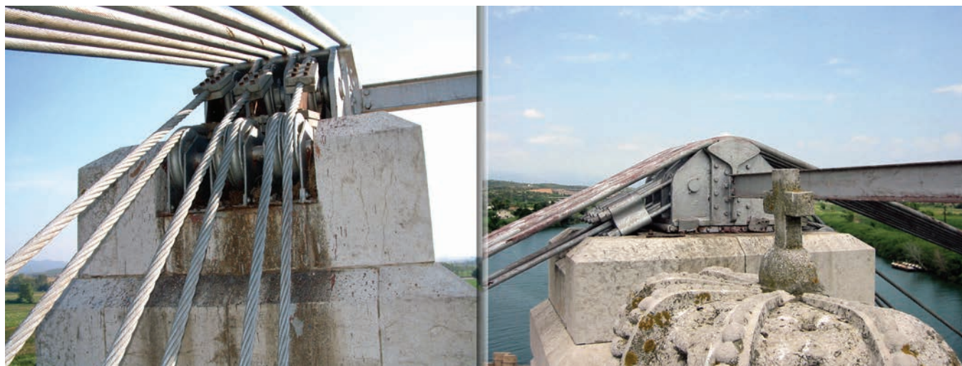
Figura 26. Detalle de elementos de las sillas. Figure 26. Detail of saddle elements.
