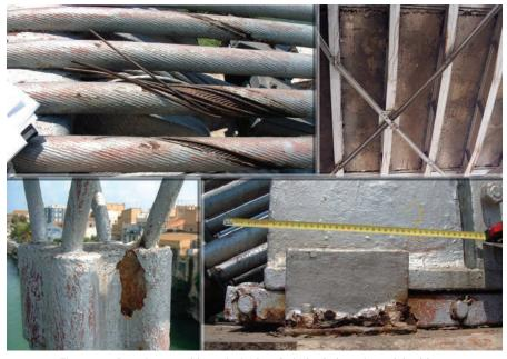
Figura 29. Deterioros: cables principales, forjado de hormigón del tablero, mazarota de una péndola y rodillos y tope transversal de una silla. Figure 29. Damage: main cables, deck's concrete slab floor, a suspender's head block and a saddle's rollers and cross stop.
