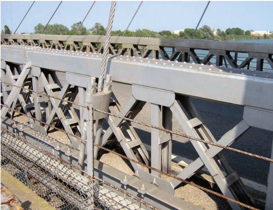
Figura 19. Viga de rigidez. Figure 19. Stiffening beam.
