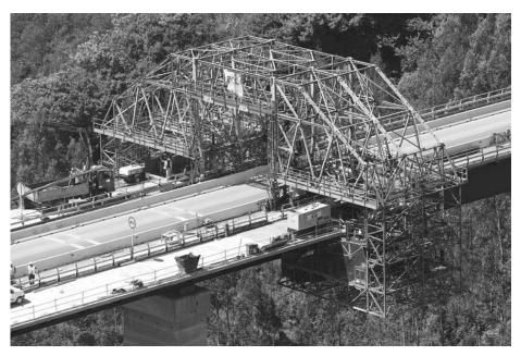
Figura 10. Perspectiva general del carro de hormigonado automóvil.
