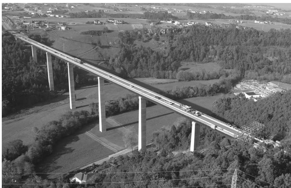
Figura 2. Vista general del Viaducto de San Timoteo.
