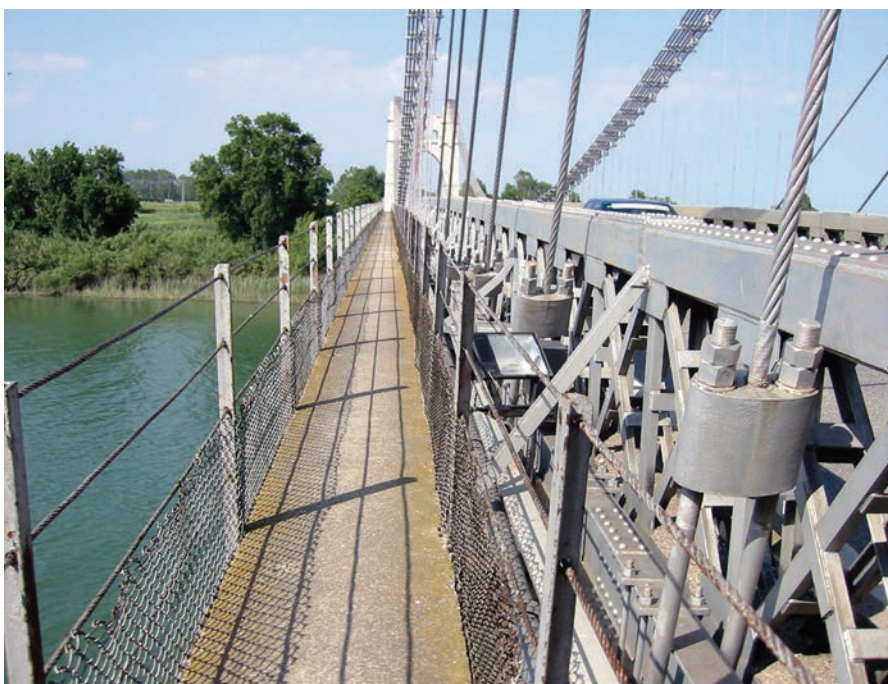
Figura 20. Acera. Figure 20. Sidewalk.
