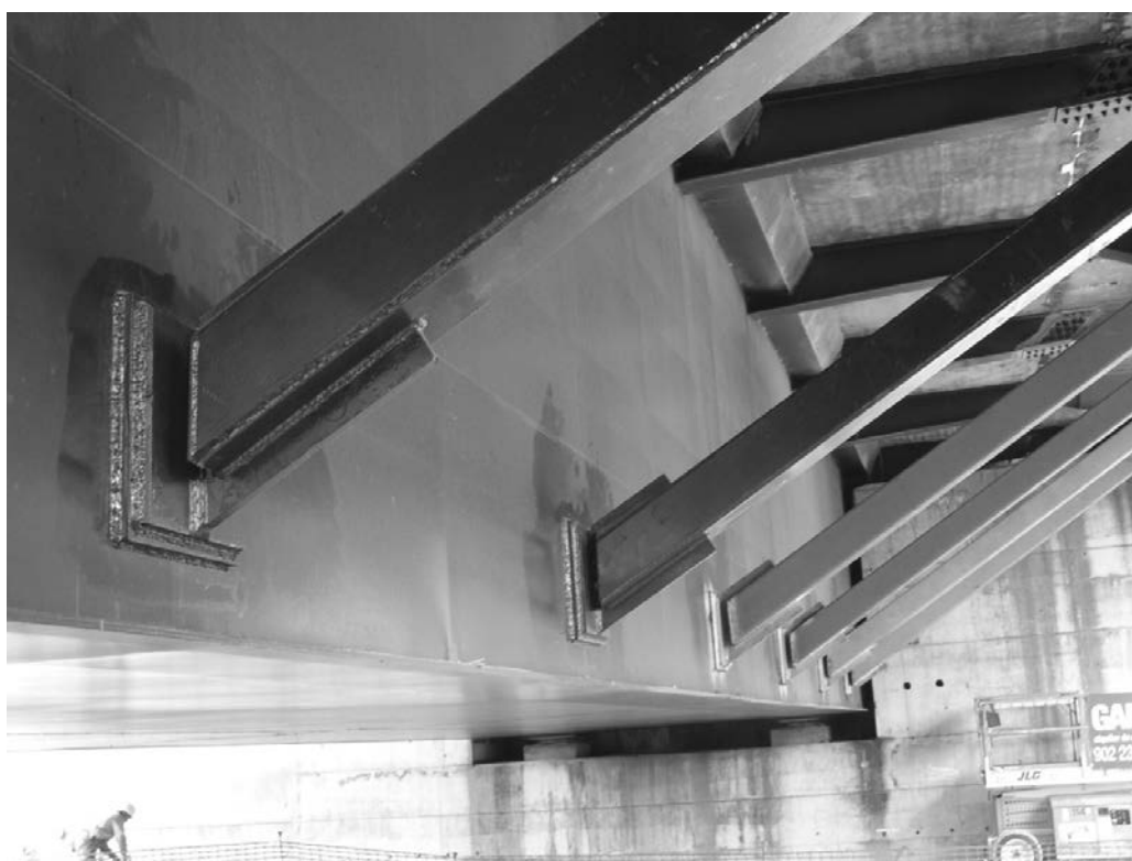
Figura 6. Unión inferior de los jabalones.
