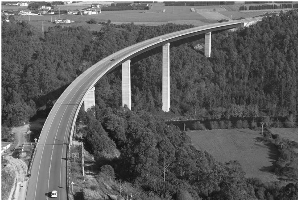
Figura 4. Vista General del Viaducto de Canero.
