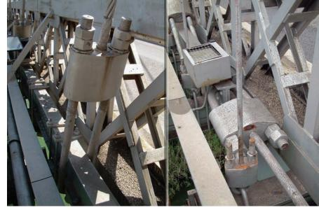
Figura 24. Anclajes del tirante inclinado y del cable horizontal. Figure 24. Inclined stay and horizontal cable elements.
