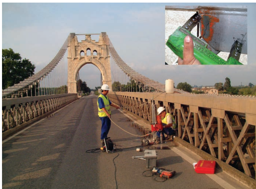
Figura 27. Extracción de testigos de la losa de hormigón y ensayo de partículas magnéticas. Figure 27. Core extraction from the concrete slab and detail of the magnetic particle test.
