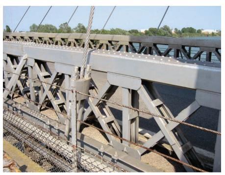
Figura 19. Viga de rigidez. Figure 19. Stiffening beam.
