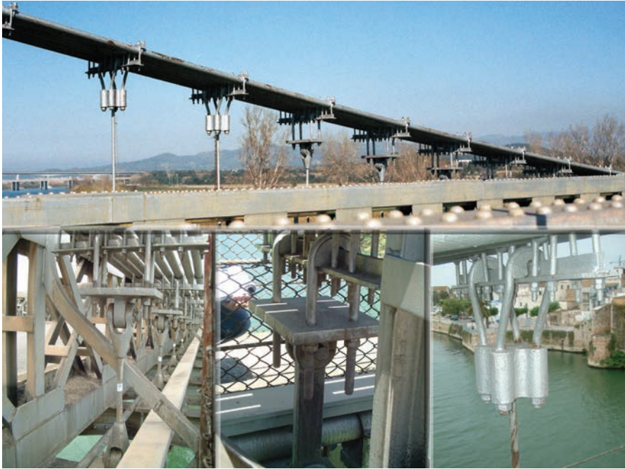
Figura 23. Péndolas tipo I, tipo II y tipo III. Figure 23. Type I, type II and type III suspenders.
