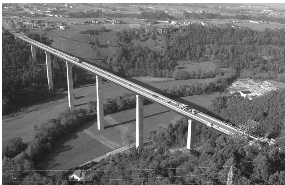
Figura 2. Vista general del Viaducto de San Timoteo.
