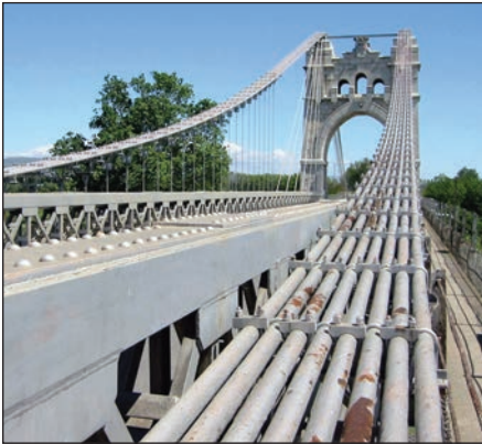
Foto de portada: Puente de Amposta
