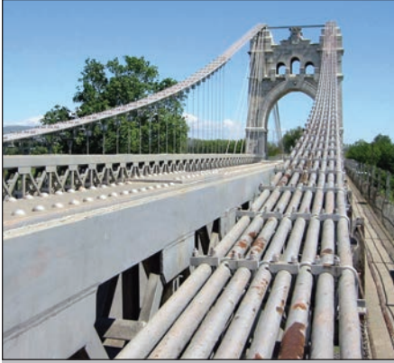
Foto de portada: Puente de Amposta
