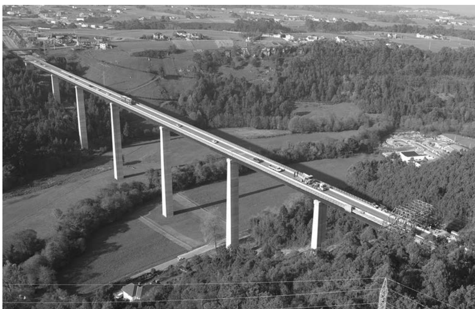
Figura 2. Vista general del Viaducto de San Timoteo.
