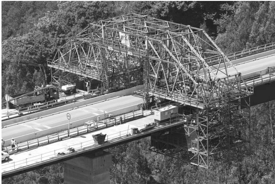
Figura 10. Perspectiva general del carro de hormigonado automóvil.
