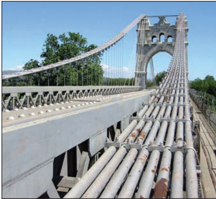
Foto de portada: Puente de Amposta
