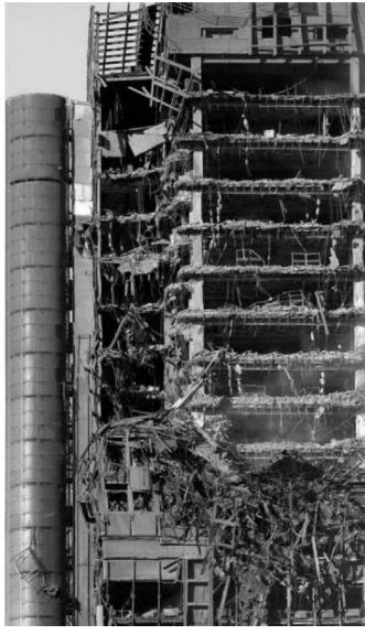
Figura 2. La estructura de hormigón después de resistir el incendio.
