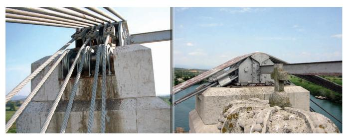
Figura 26. Detalle de elementos de las sillas. Figure 26. Detail of saddle elements.
