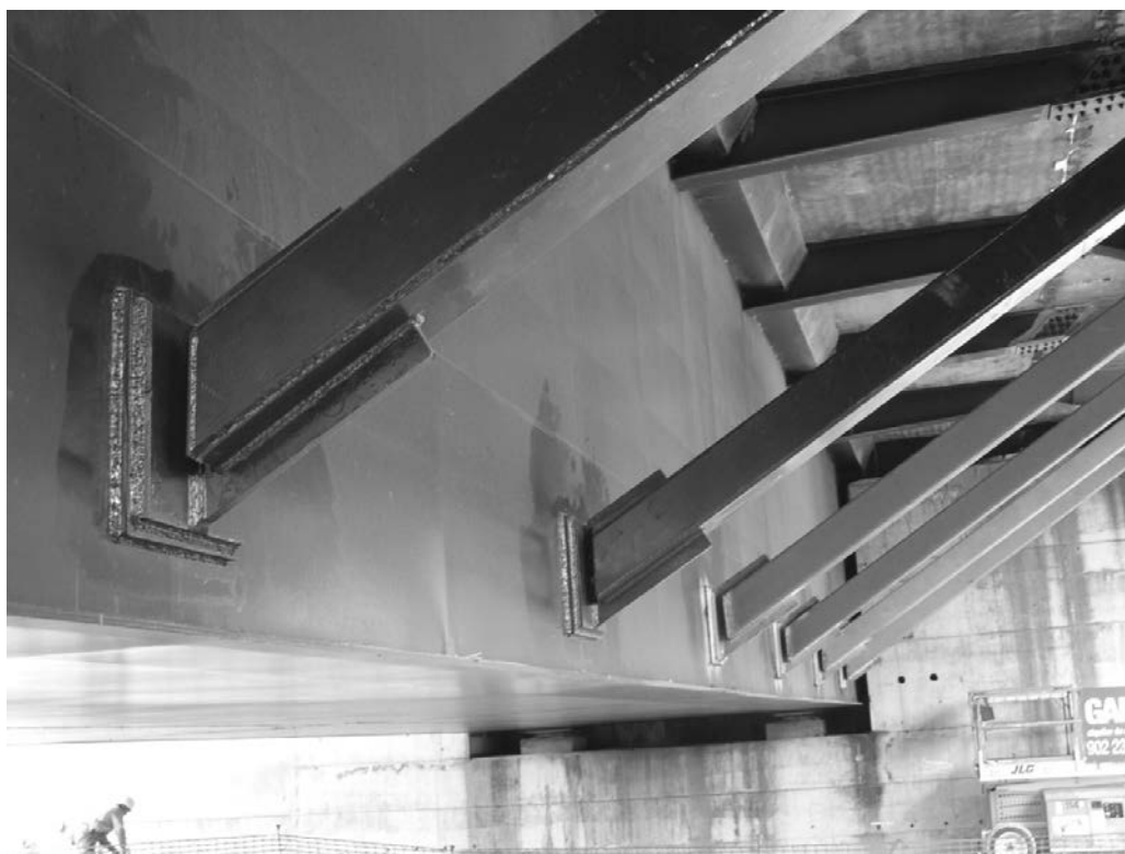
Figura 6. Unión inferior de los jабalcones.
