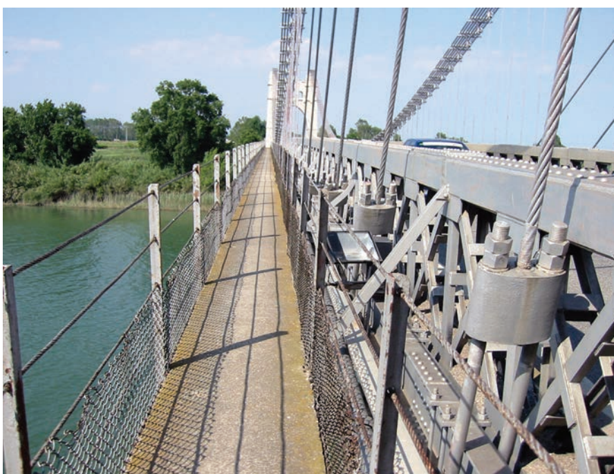
Figura 20. Acera. Figure 20. Sidewalk.
