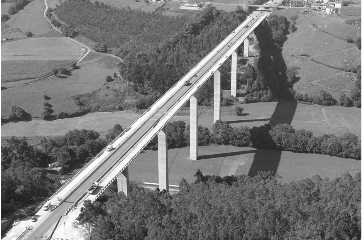
Figura 12. Viaducto de San Timoteo con el tablero ampliado.
