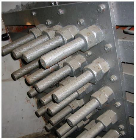
Figura 25. Detalle del emparrillado de anclaje. Figure 25. Detail of the anchorage grill.
