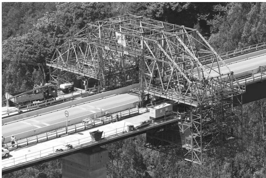
Figura 10. Perspectiva general del carro de hormigonado automóvil.
