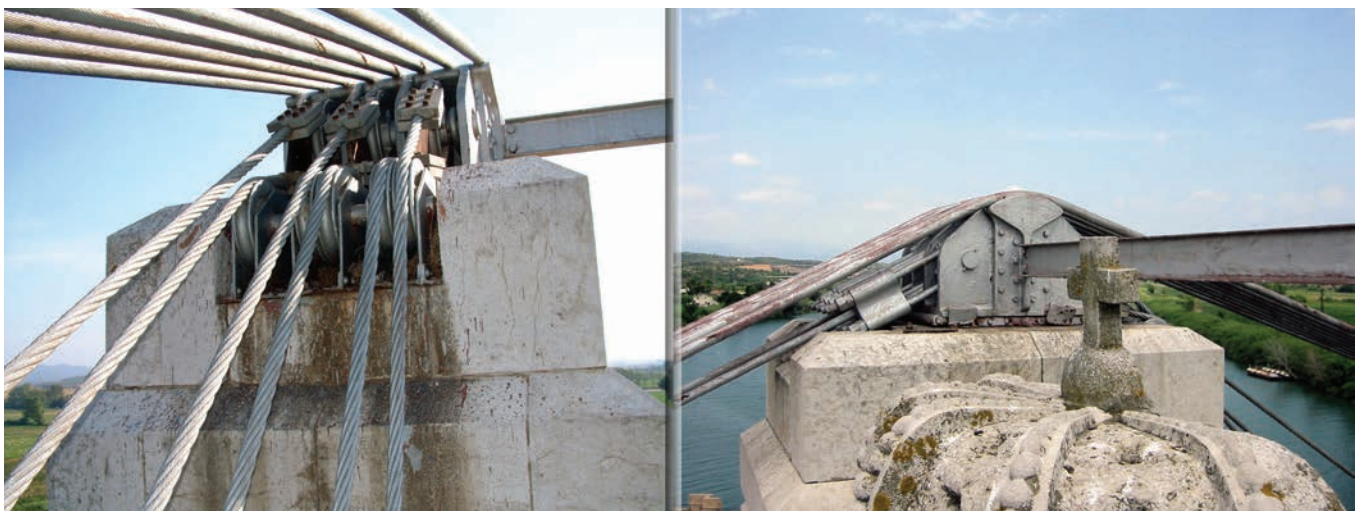
Figura 26. Detalle de elementos de las sillas. Figure 26. Detail of saddle elements.
