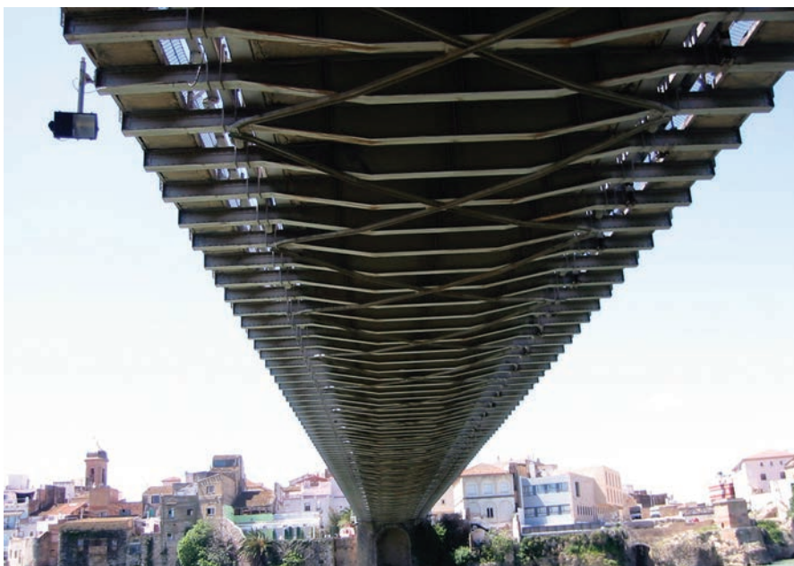
Figura 21. Parte inferior del tablero. Figure 21. Deck bottom.
