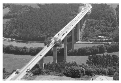
Figura 11. Viaducto de San Timoteo durante la ampliación del tablero.
