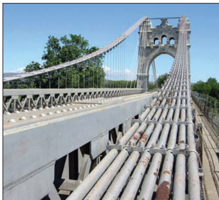
Foto de portada: Puente de Amposta
