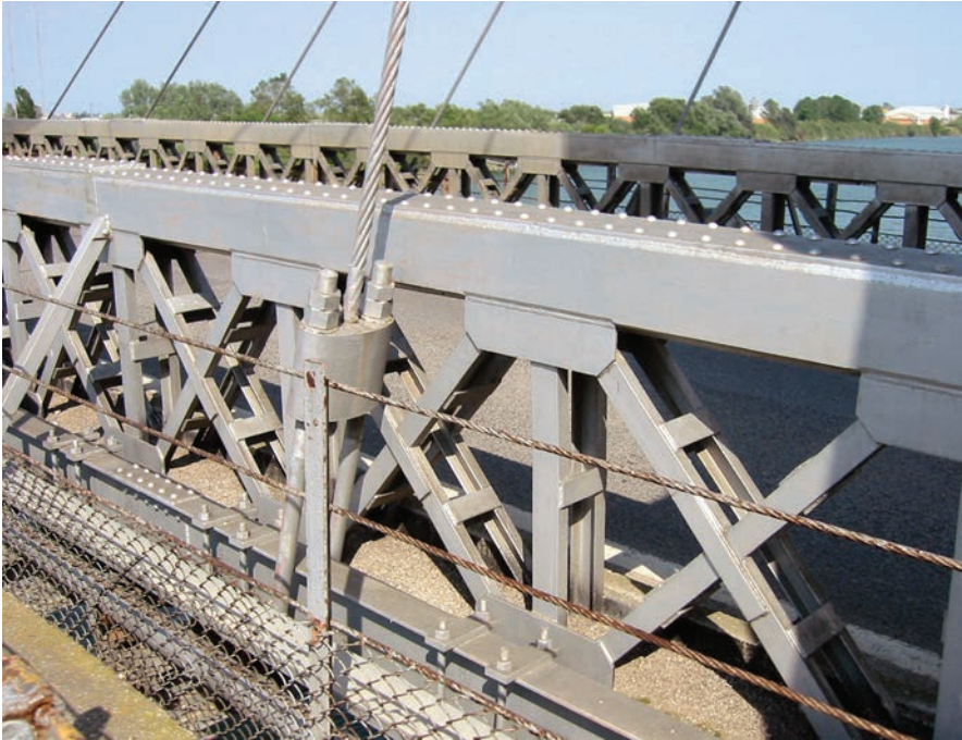
Figura 19. Viga de rigidez. Figure 19. Stiffening beam.
