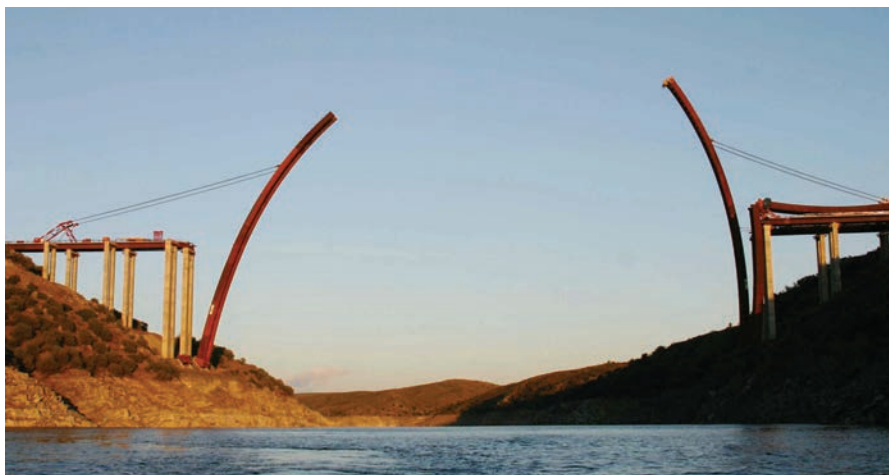
Figura 31. Abatimiento de semiarcos (1). Figure 31. Swivel lowering semi-arches (1).
