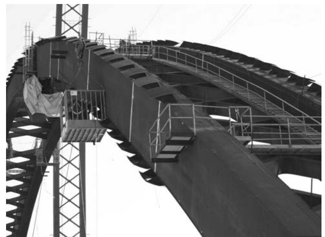
Figura 5. Vista de los arcos durante el proceso de instalación de los deflectores.
