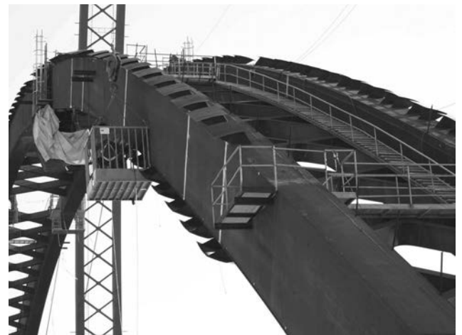
Figura 5. Vista de los arcos durante el proceso de instalación de los deflectores.
