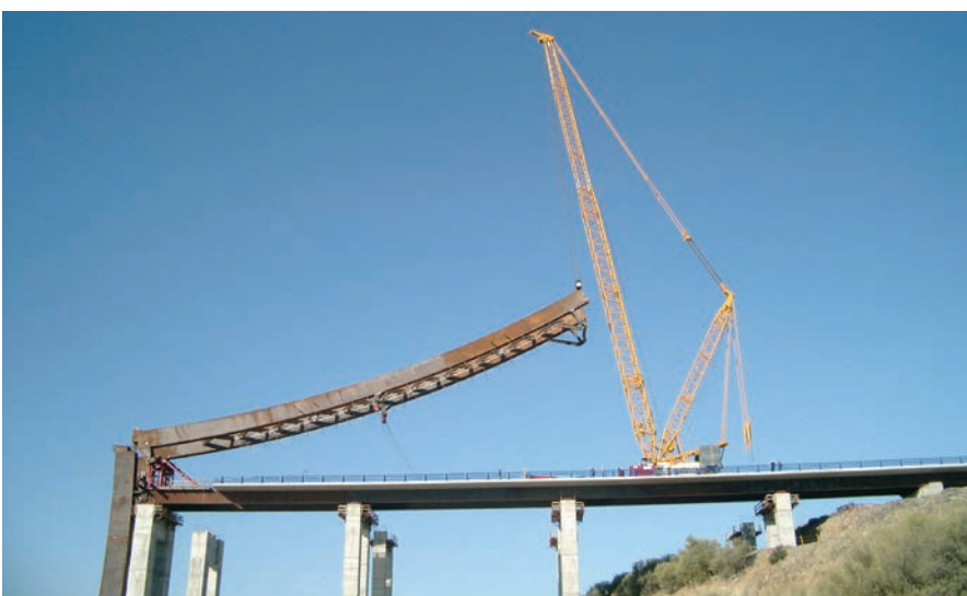
Figura 25. Izado de segundo cuarto de arco con grúa. Figure 25. Crane hoisting a second quarter arch.
