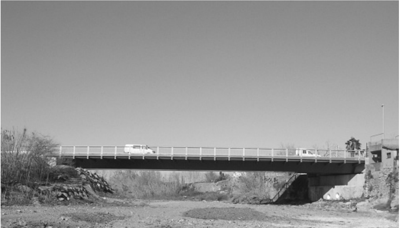
Figura 9. Vista del puente terminado.
