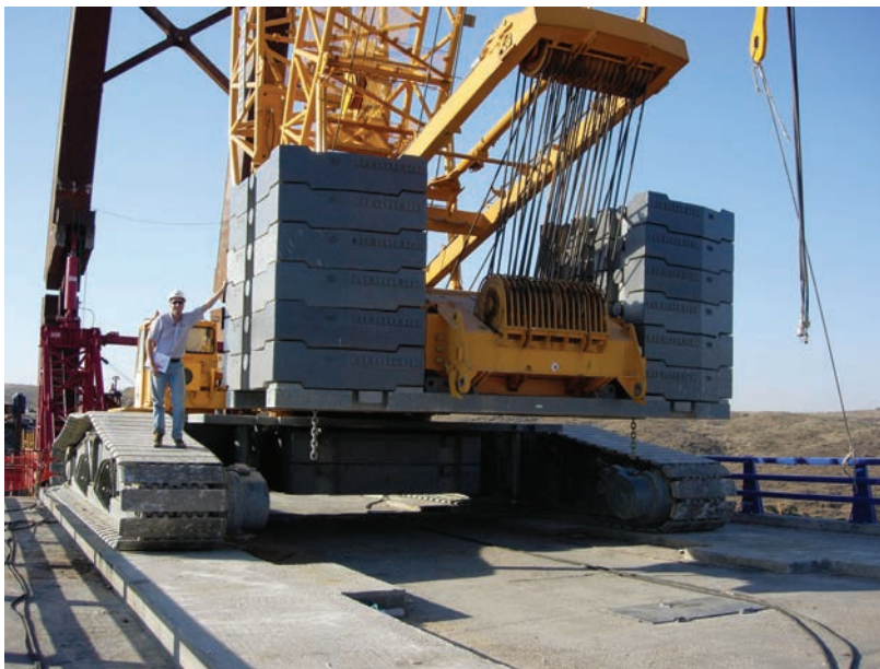
Figura 24. Grúa sobre tablero. Figure 24. Crane on deck.
