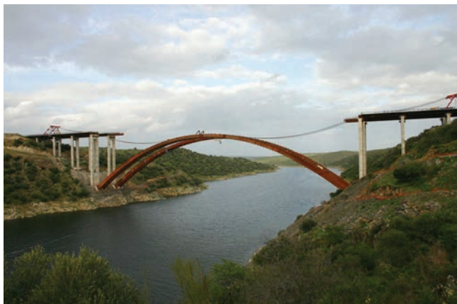
Figura 38. Cierre en clave de arco del segundo puente. Figure 38. Crown closure of second bridge's arch.
