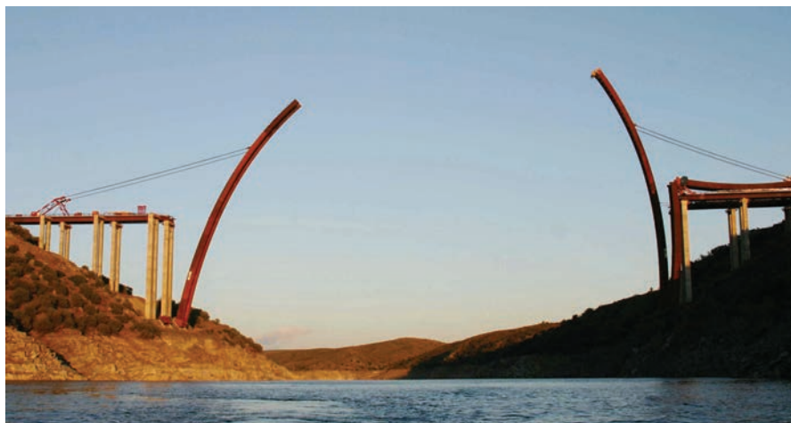
Figura 31. Abatimiento de semiarcos (1). Figure 31. Swivel lowering semi-arches (1).
