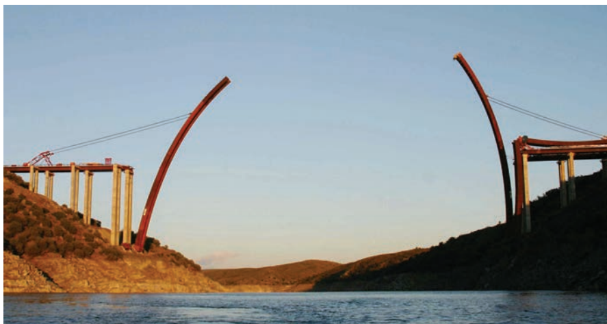
Figura 31. Abatimiento de semiarcos (1). Figure 31. Swivel lowering semi-arches (1).
