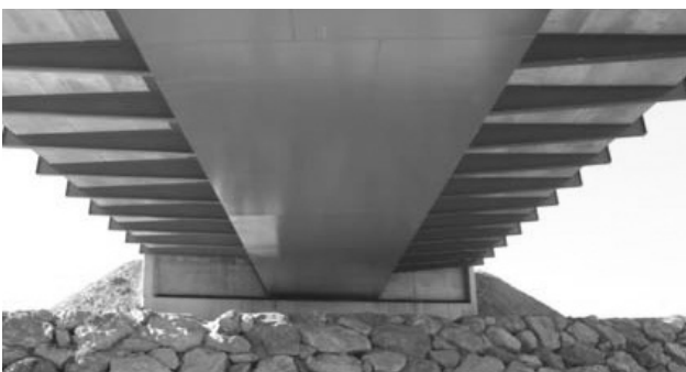
Figura 6. Vista inferior del tablero.
