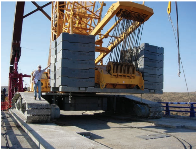
Figura 24. Grúa sobre tablero. Figure 24. Crane on deck.
