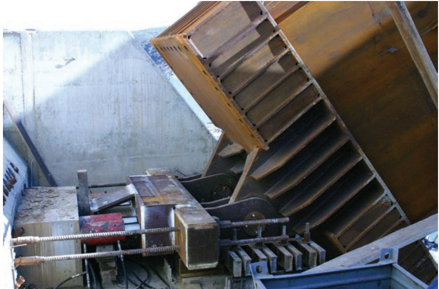
Figura 33. Pieza inferior de semiarco. Figure 33. Bottom semi-arch piece.
