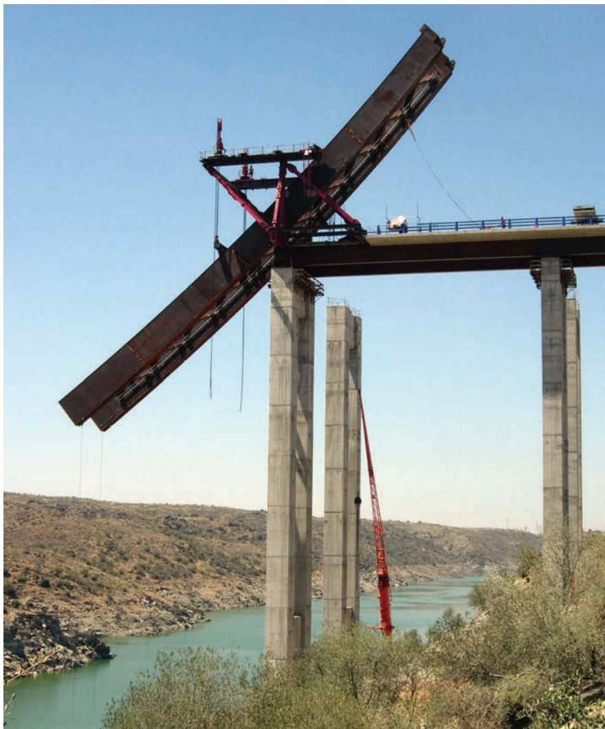
Figura 19. Basculamiento del primer cuarto de arco (1). Figure 19. Tilting the first quarter arch (1).
