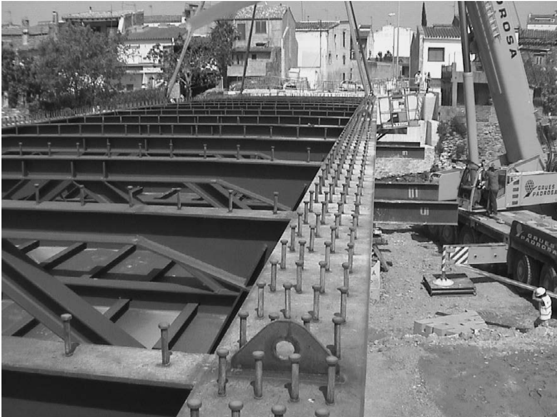
Figura 2. Detalle estructura metálica.
