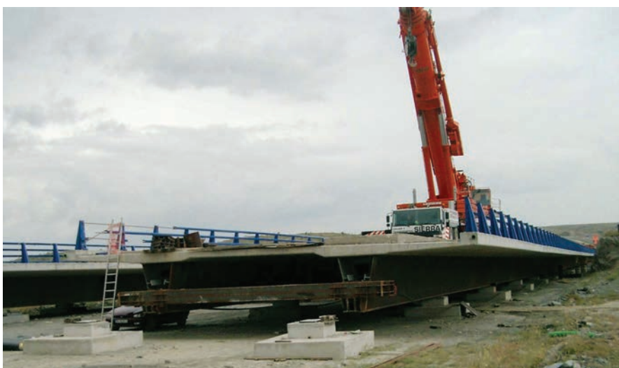
Figura 16. Empuje de un tablero. En la parte trasera, viga metálica transversal de empuje. Figure 16. Pushing a deck. At the back, metal cross pushing beam.
