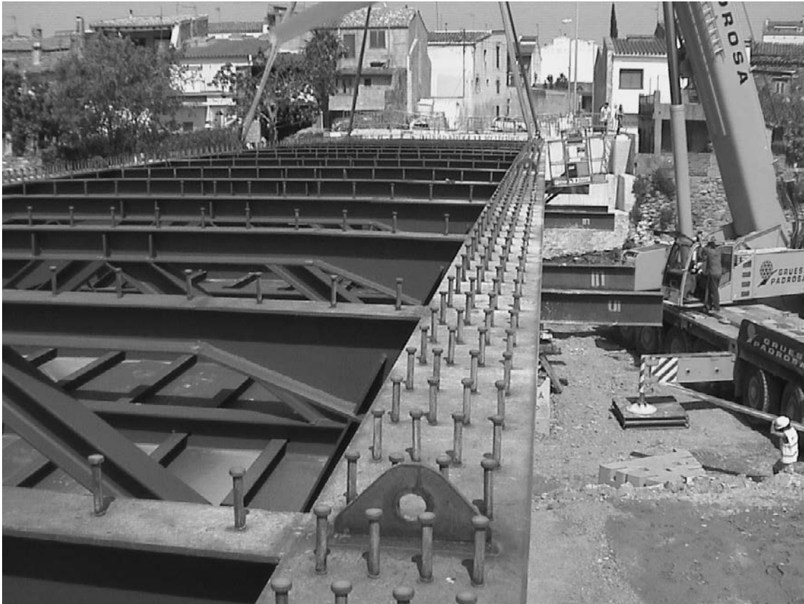
Figura 2. Detalle estructura metálica.
