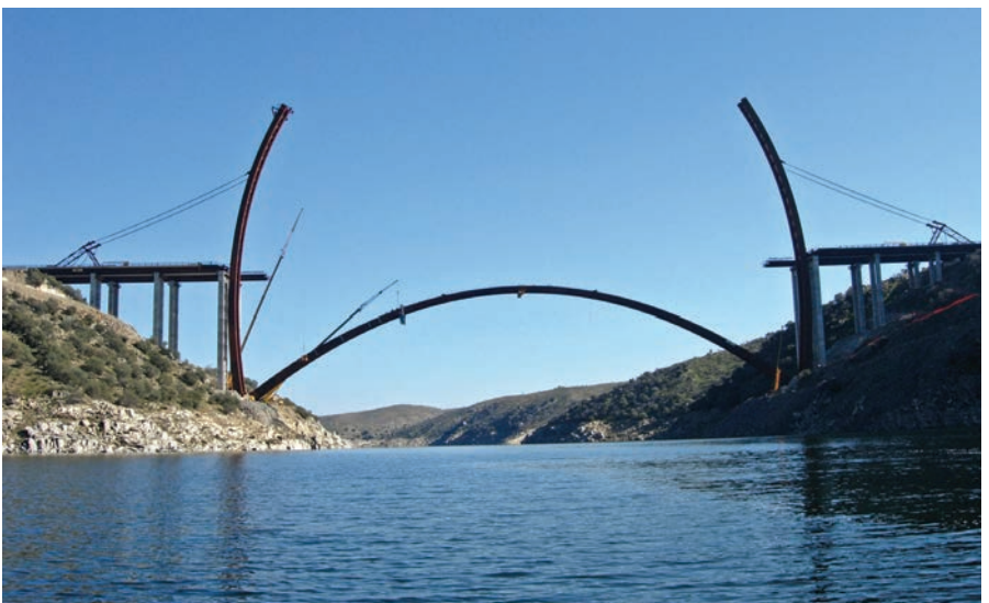
Figura 37. Semiarcos del segundo puente en posición vertical Figure 37. Semi-arches of the second bridge in a vertical position.
