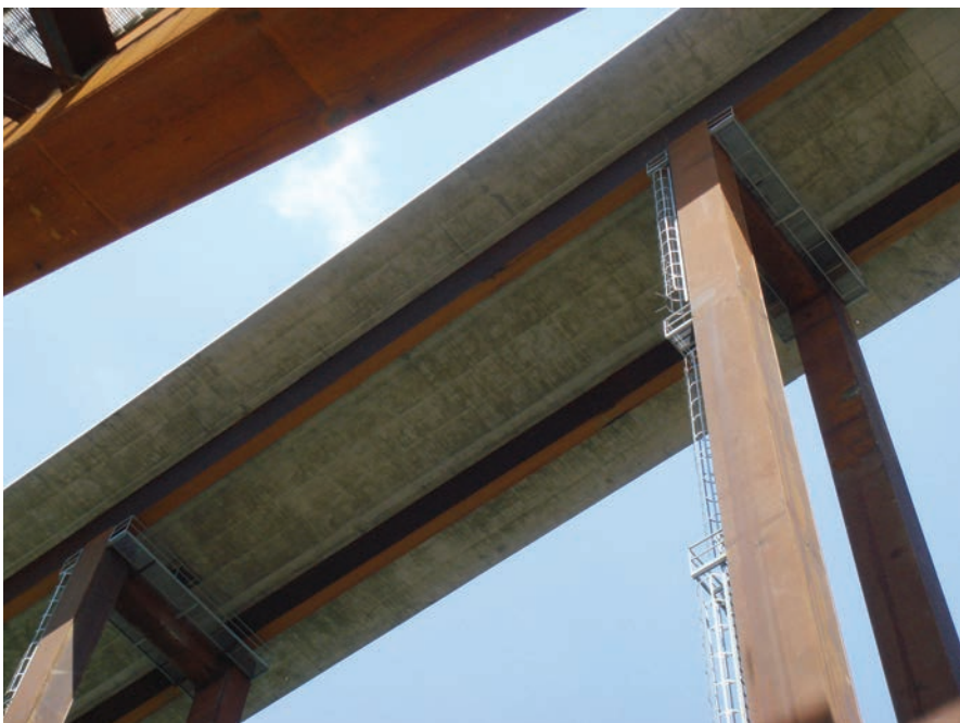
Figura 4. Tablero. Vista por la parte inferior. Figure 4. Deck. Underneath view.
