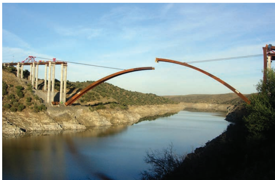
Figura 32. Abatimiento de semiarcos (2). Figure 32. Swivel lowering semi-arches (2).
