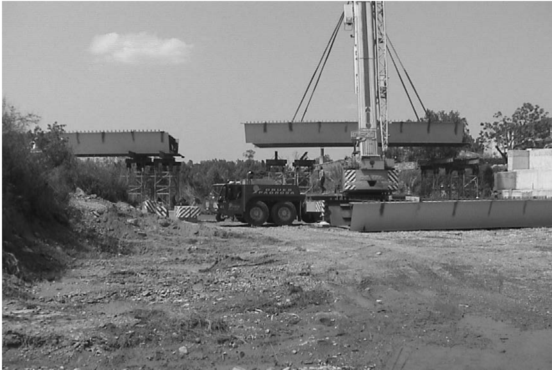
Figura 7. Montaje del tablero.
