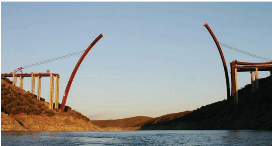
Figura 31. Abatimiento de semiarcos (1). Figure 31. Swivel lowering semi-arches (1).
