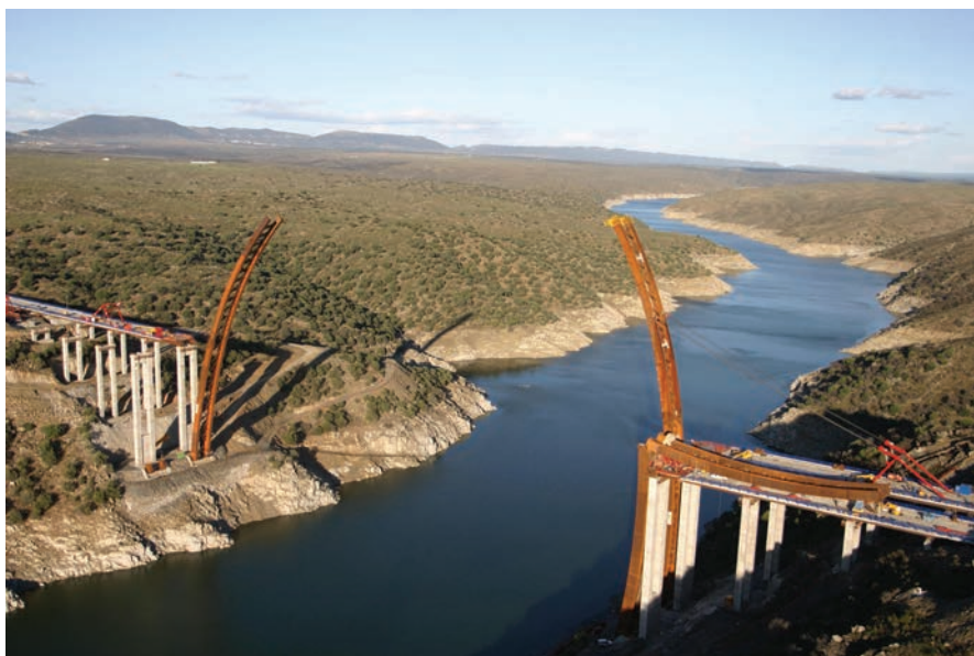
Figura 55. Embalse de Alcántara. Perspectiva general de la zona Situación de la obra con semiarcos en posición vertical. Figure 55. Alcántara Reservoir. General perspective of the area. Location of the construction with semi-arches in vertical position.
