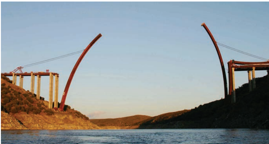
Figura 31. Abatimiento de semiarcos (1). Figure 31. Swivel lowering semi-arches (1).
