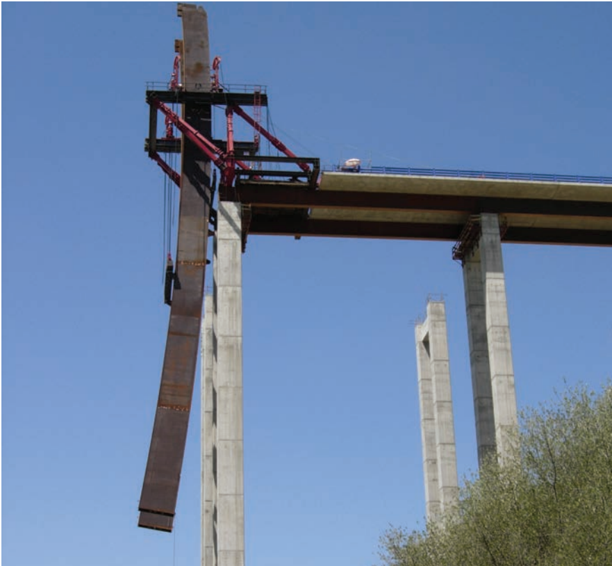
Figura 22. Descenso de primer cuarto de arco. Figure 22. Vertical lowering of first quarter arch.
