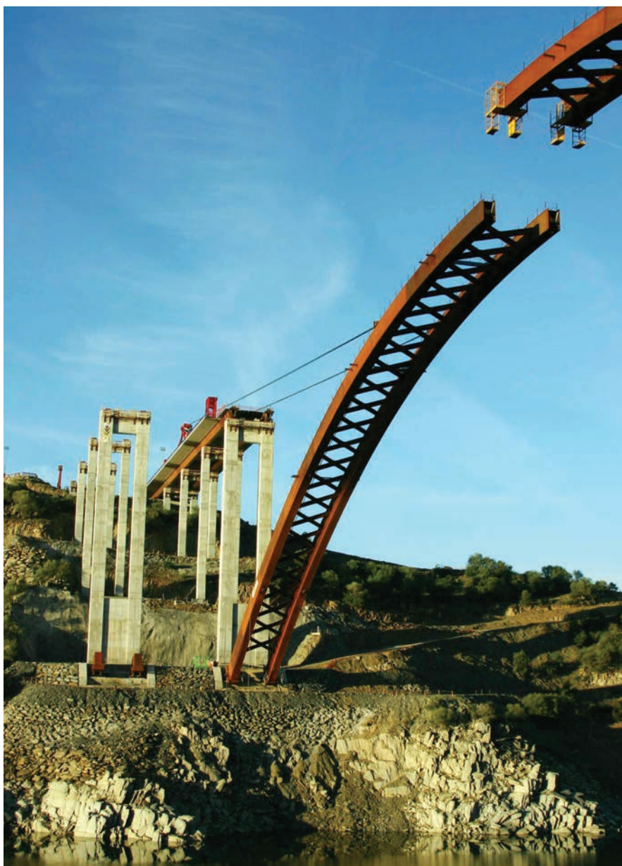
Figura 34. Maniobra de aproximación de semiarcos. Figure 34. Semi-arch approach manoeuvre.
