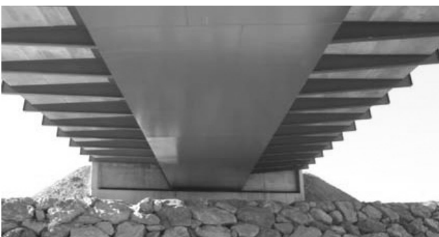
Figura 6. Vista inferior del tablero.
