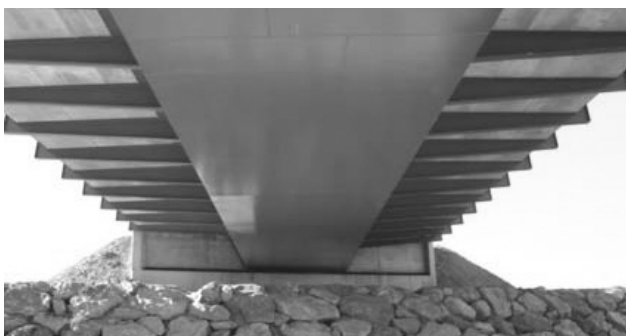
Figura 6. Vista inferior del tablero.
