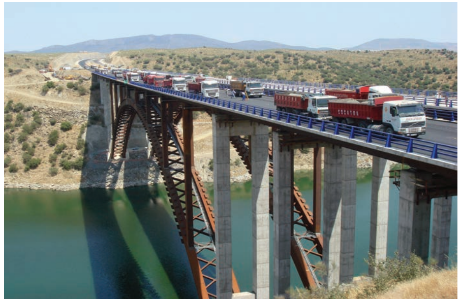
Figura 62. Prueba de carga. Figure 62. Load test.
