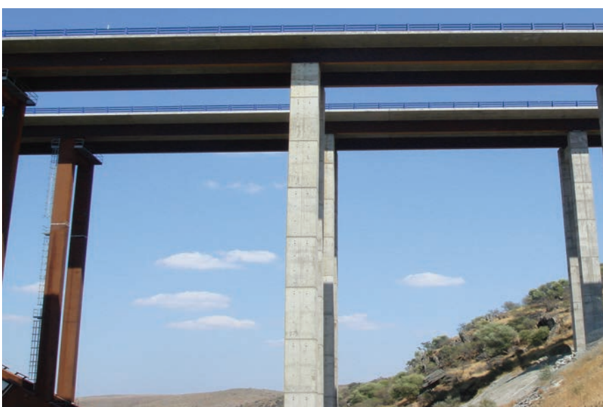
Figura 11. Tramo de acceso. Figure 11. Approach stretch.
