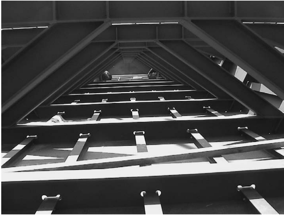
Figura 4 .Vista interior del cajón metálico.
