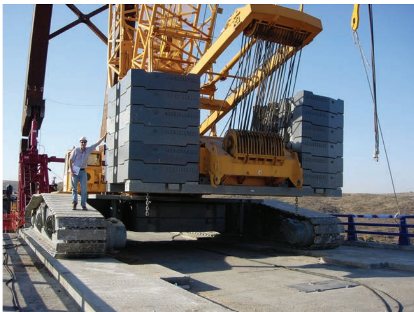
Figura 24. Grúa sobre tablero. Figure 24. Crane on deck.
