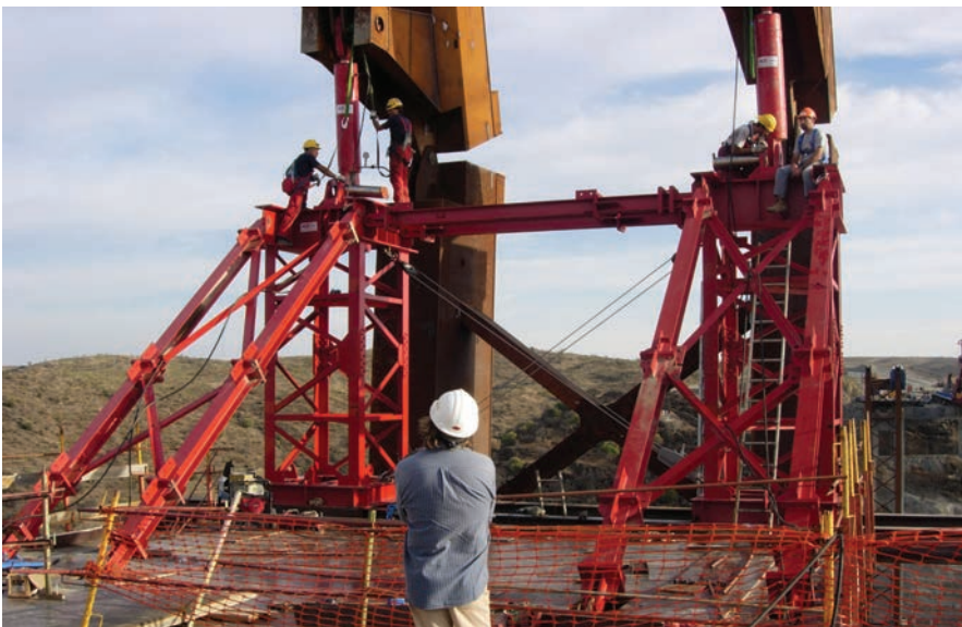
Figura 27. Estructura auxiliar sobre tablero. Figure 27. Auxiliary structure on deck.
