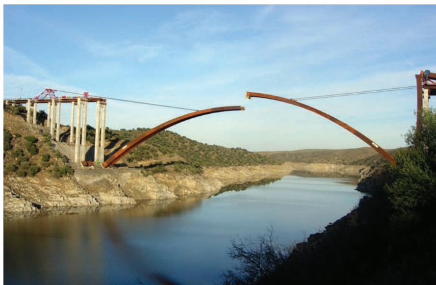
Figura 32. Abatimiento de semiarcos (2). Figure 32. Swivel lowering semi-arches (2).
