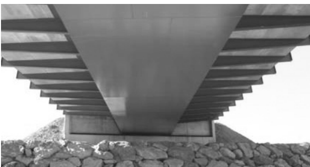
Figura 6. Vista inferior del tablero.
