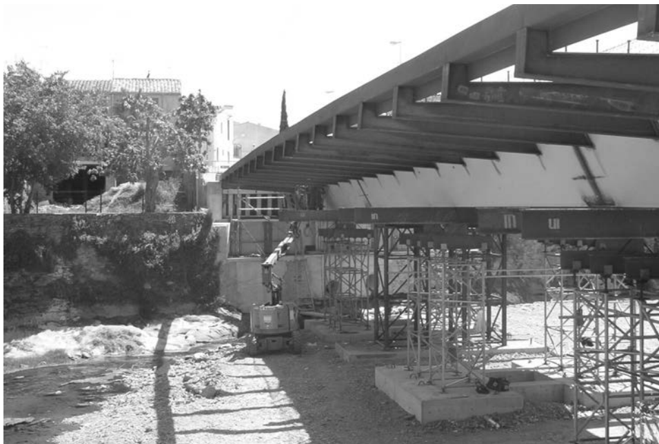
Fig.ura 5. Vista de las costillas del voladizo y remate lateral
