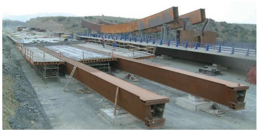
Figura 15. Construcción de tableros en tierra firme. En primer plano, construcción de losa superior, de uno de los tableros. Al fondo un tablero totalmente construido, incluida barrera de seguridad. Sobre el tablero, pieza correspondiente al primer cuarto de arco. Figure 15. On land deck construction. In the foreground, one of the decks' top slab construction. In the background, a completely built deck, including safety barrier. On the deck, part of the first quarter arch.
