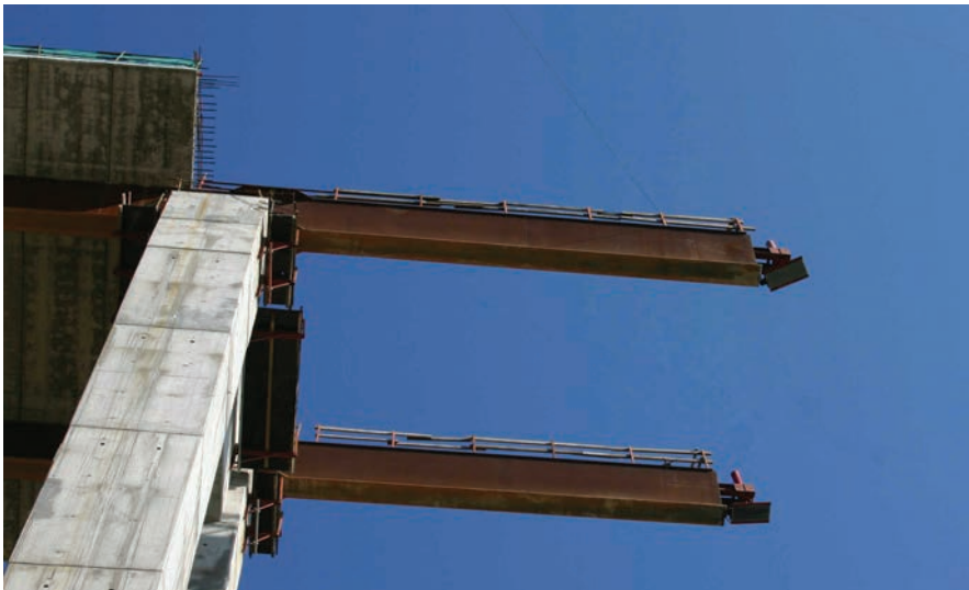
Figura 18. Zona frontal del tablero en fase de empuje. Figure 18. Deck's front area in the pushing phase.
