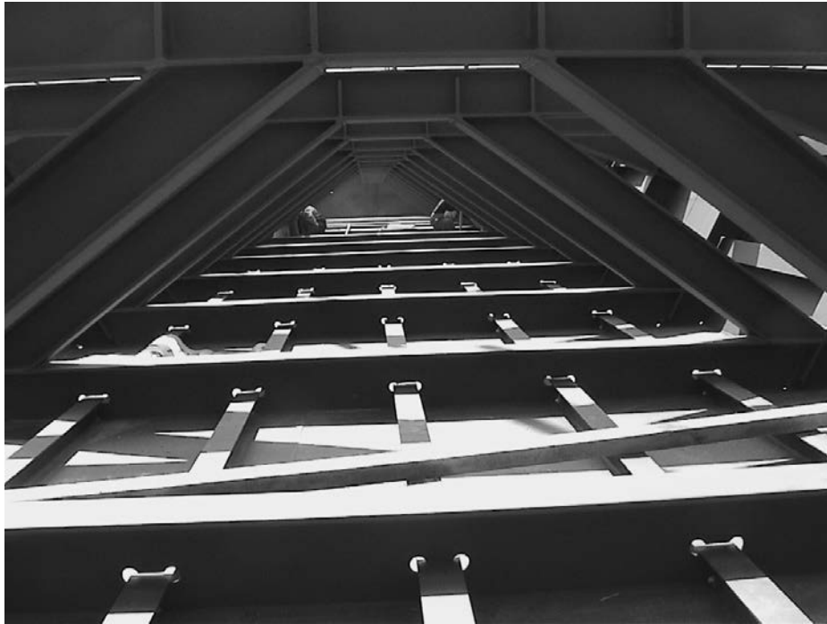
Figura 4 .Vista interior del cajón metálico.
