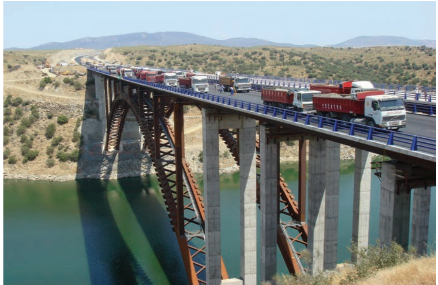
Figura 62. Prueba de carga. Figure 62. Load test.
