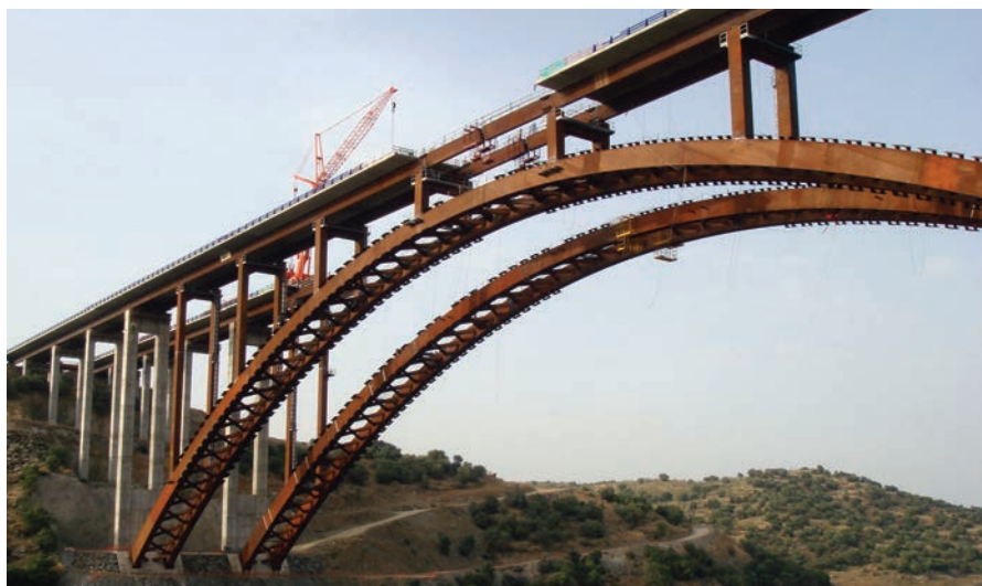
Figura 45. Cierre de tablero en el centro. Figure 45. Deck closure at centre.
