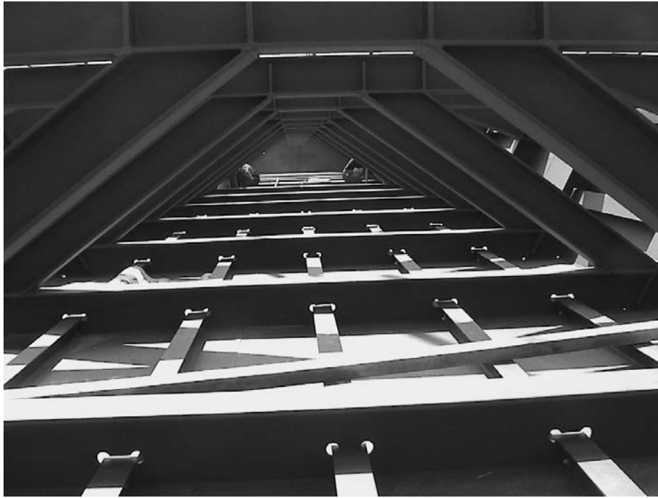
Figura 4 .Vista interior del cajón metálico.
