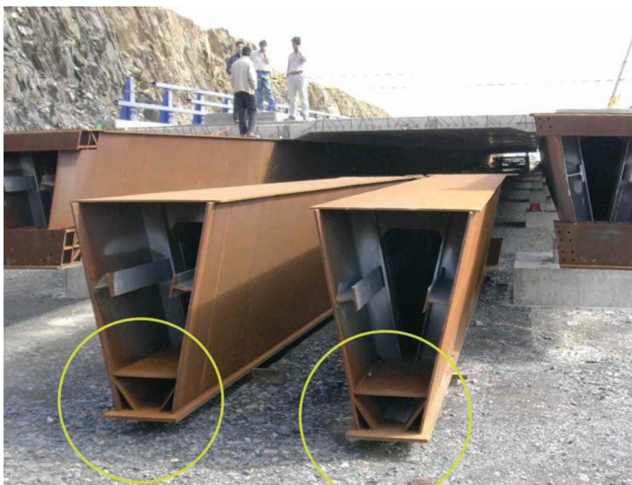
Figura 6. Tablero. Vigas – cajón metálicas. Rigidización en la parte inferior, apropiada para la situación de apoyo durante el empuje del tablero Figure 6. Deck. Metal box - beams. Stiffening at bottom suited to the support situation during deck pushing
