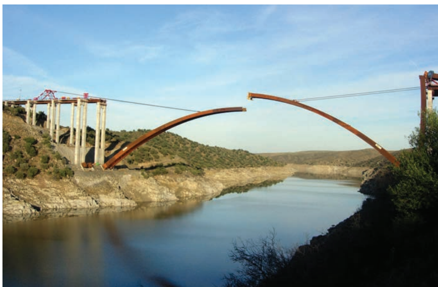
Figura 32. Abatimiento de semiarcos (2). Figure 32. Swivel lowering semi-arches (2).
