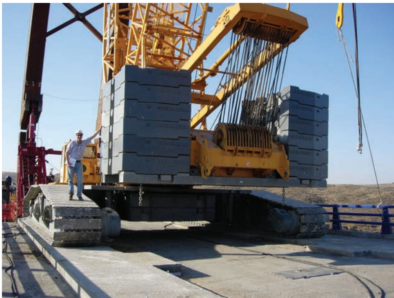
Figura 24. Grúa sobre tablero. Figure 24. Crane on deck.
