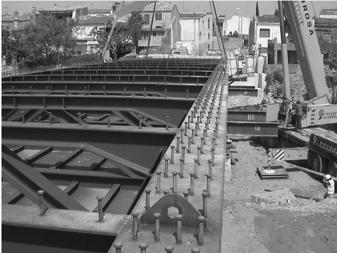
Figura 2. Detalle estructura metálica.
