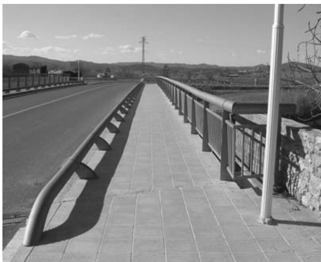
Figura 8. Montaje de la superestructura.
