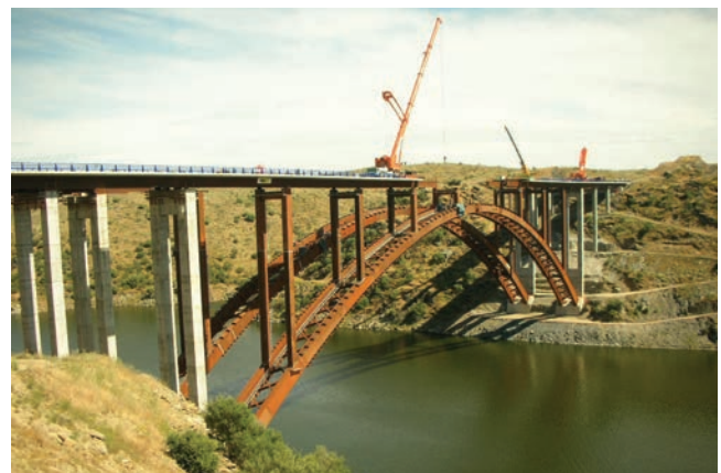
Figura 42. Empuje de tablero sobre arco (3). Figure 42. Deck pushing over arch (3).
