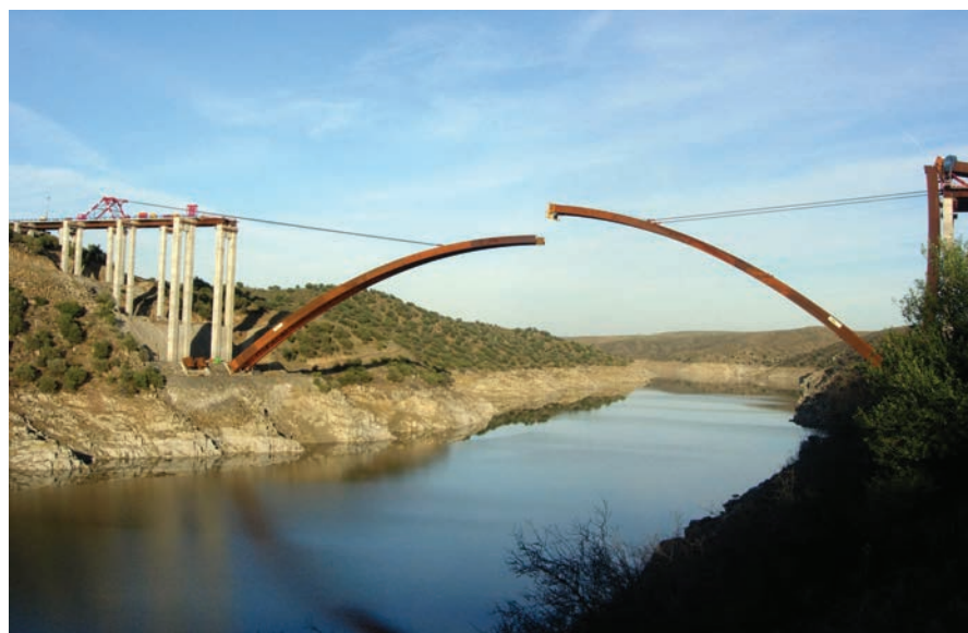
Figura 32. Abatimiento de semiarcos (2). Figure 32. Swivel lowering semi-arches (2).
