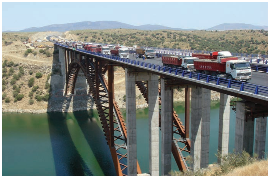
Figura 62. Prueba de carga. Figure 62. Load test.
