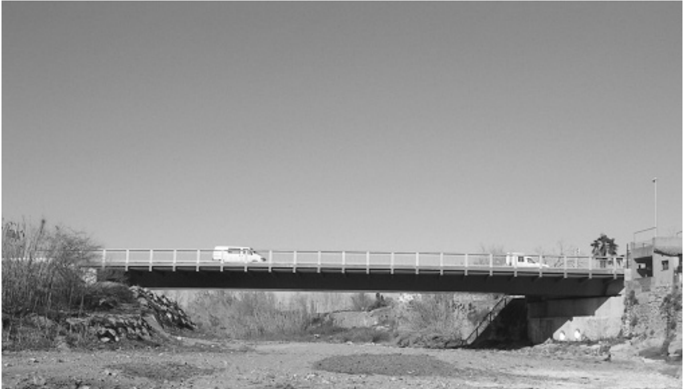
Figura 9. Vista del puente terminado.
