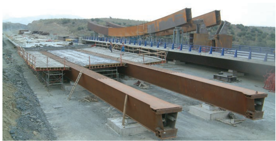
Figura 15. Construcción de tableros en tierra firme. En primer plano, construcción de losa superior, de uno de los tableros. Al fondo un tablero totalmente construido, incluida barrera de seguridad. Sobre el tablero, pieza correspondiente al primer cuarto de arco. Figure 15. On land deck construction. In the foreground, one of the decks' top slab construction. In the background, a completely built deck, including safety barrier. On the deck, part of the first quarter arch.
