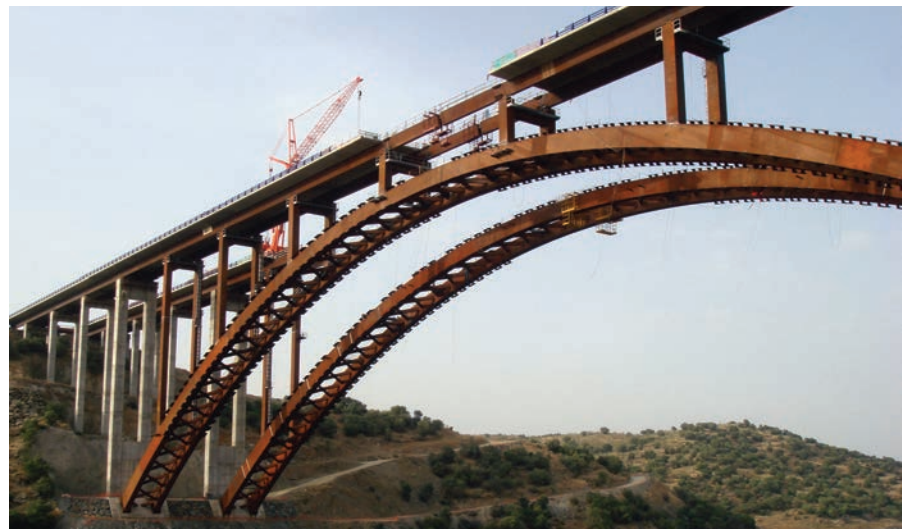
Figura 45. Cierre de tablero en el centro. Figure 45. Deck closure at centre.
