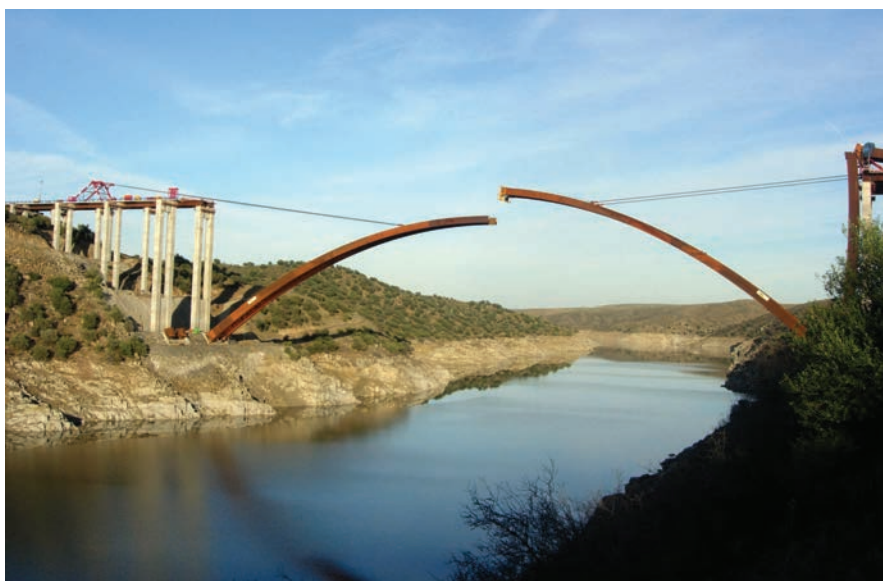
Figura 32. Abatimiento de semiarcos (2). Figure 32. Swivel lowering semi-arches (2).
