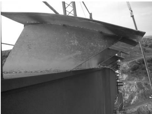
Figura 4. Deflectores instalados.
