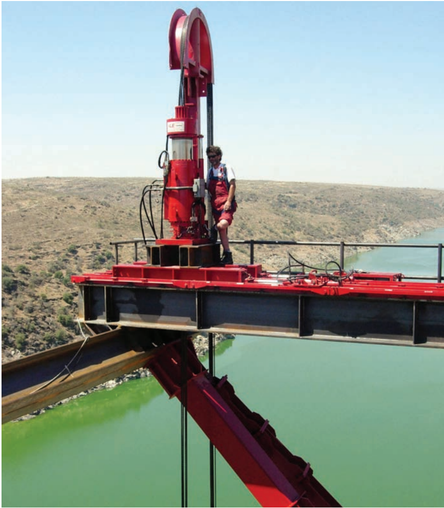
Figura 21. Pórtico de basculamiento. Detalle de un gato hidráulico. Figure 21. Tilting truss. Detail of a hydraulic jack.
