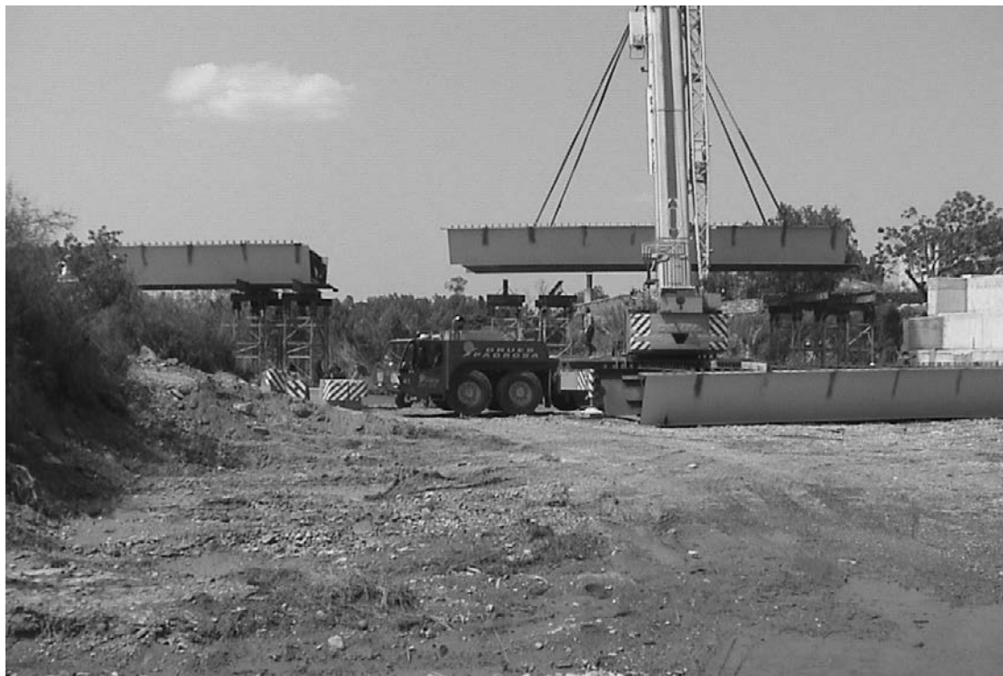
Figura 7. Montaje del tablero.
