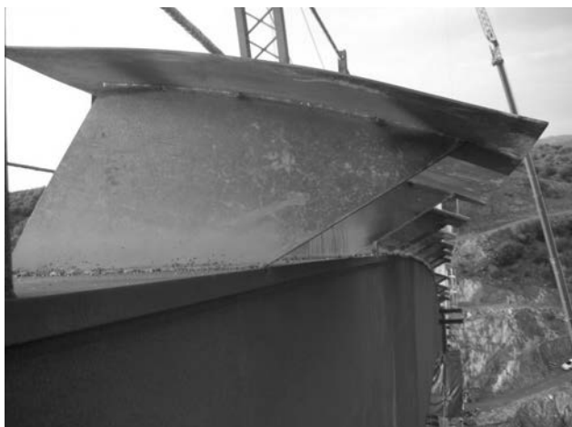
Figura 4. Deflectores instalados.
