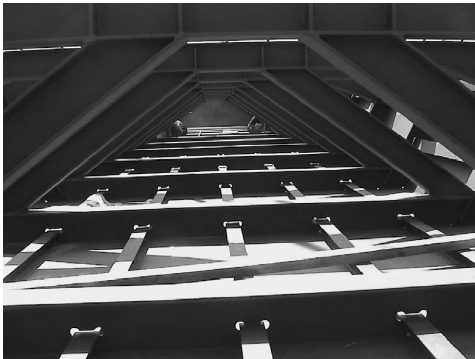
Figura 4 .Vista interior del cajón metálico.
