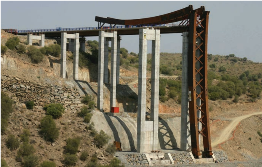
Figura 23. Segundo cuarto de arco conectado en una zona provista de rótulas. Figure 23. Second quarter arch connected in an area provided with hinges.
