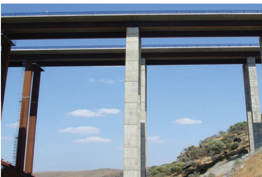
Figura 11. Tramo de acceso. Figure 11. Approach stretch.
