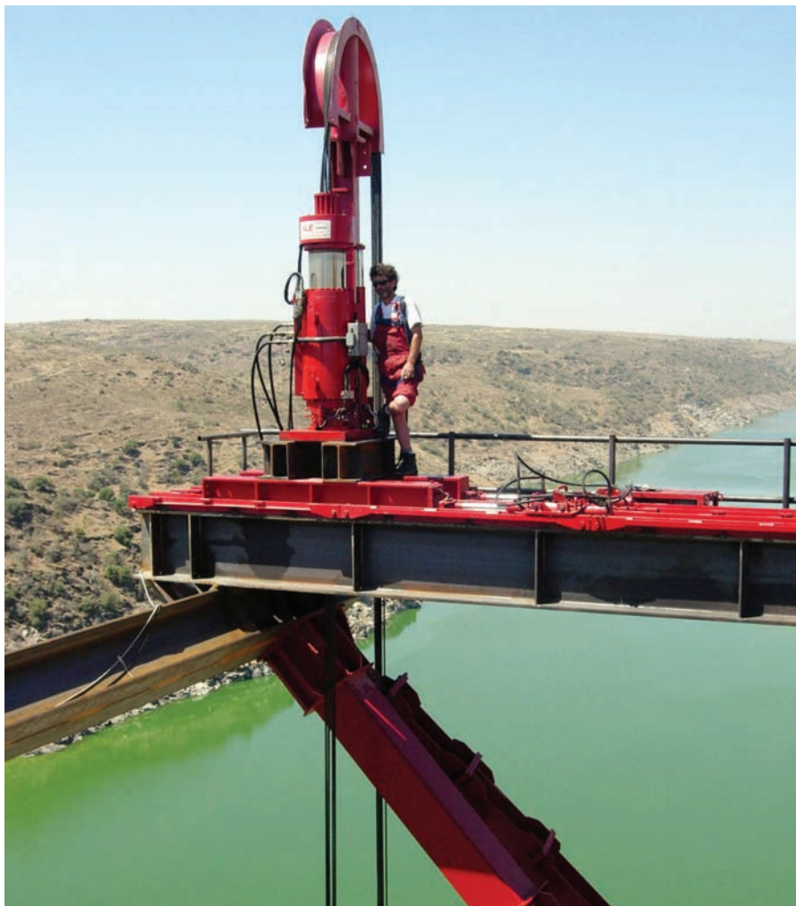
Figura 21. Pórtico de basculamiento. Detalle de un gato hidráulico. Figure 21. Tilting truss. Detail of a hydraulic jack.
