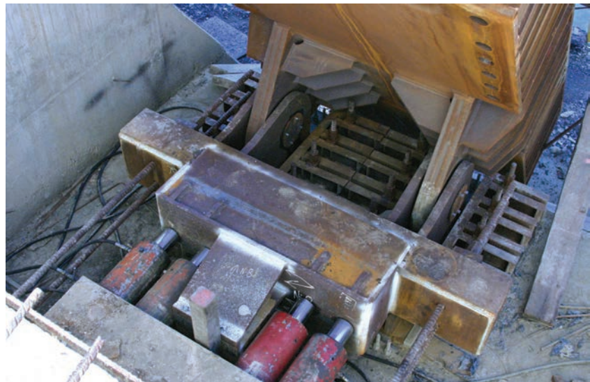
Figura 47. Zona inferior del arco Figure 47. Bottom arch area.
