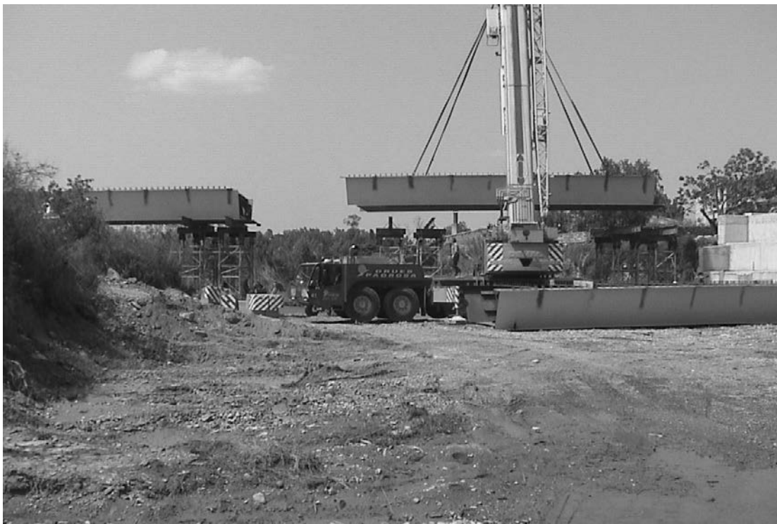
Figura 7. Montaje del tablero.
