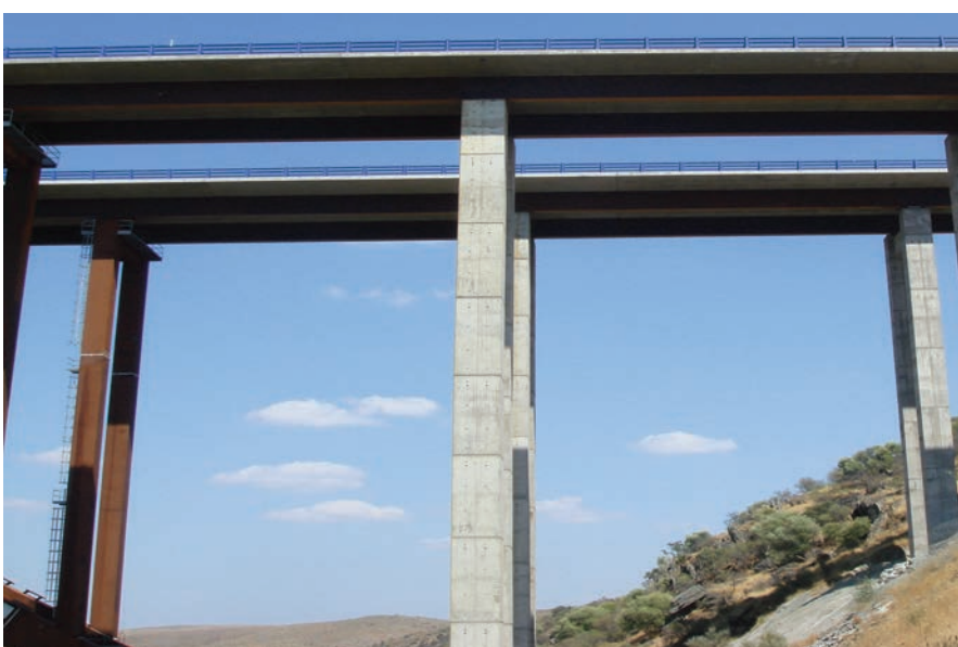
Figura 11. Tramo de acceso. Figure 11. Approach stretch.
