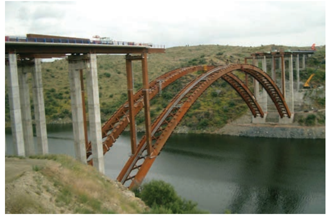
Figura 40. Empuje de tablero sobre arco (1). Figure 40. Deck pushing over arch (1).
