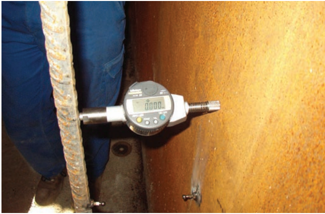
Fig. 29. Control deformaciones transversales en el alma. Fig. 29. Monitoring cross deformations in the web.
