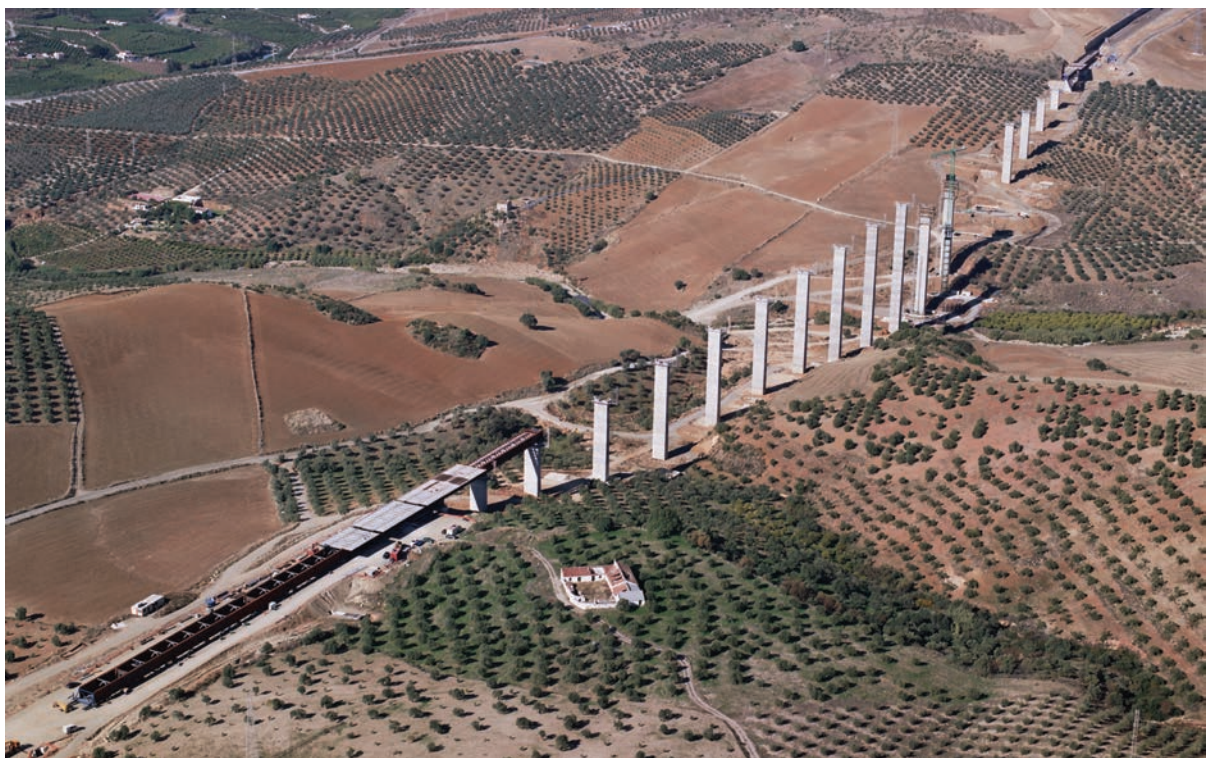
Fig. 11. Vista aérea del viaducto en construcción, con parte del tablero en el parque de empuje del Estribo 2. Fig. 11. Aerial view of the viaduct under construction, with part of the deck in the Abutment 2 launching yard
