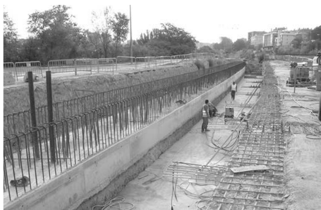
Figura 9. Viga de atado de pilotes.
