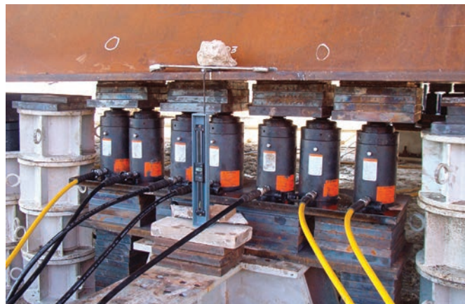
Fig. 30. Aplicación reacción localizada con gatos. Fig. 30. Localised reaction application with jacks.
