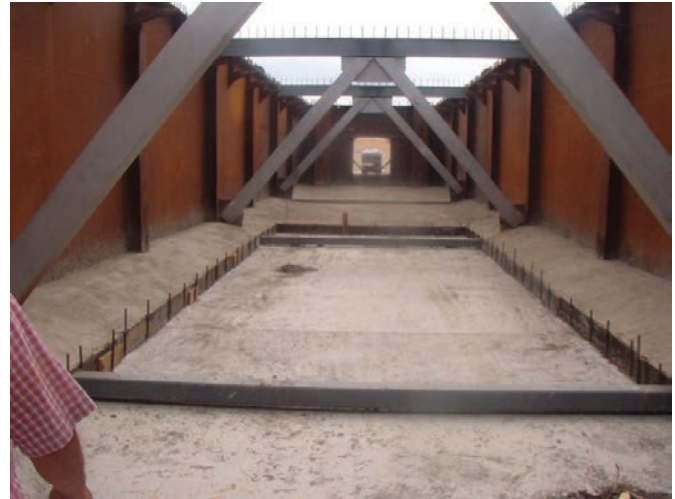
Fig. 13. Vista de prelasas inferiores y hormigón de fondo. Fig. 13. View of the bottom pre-slabs and bottom concrete.
