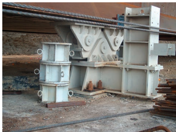
Fig. 26. Condiciones de apoyo durante la prueba. Fig. 26. Support conditions during testing.
