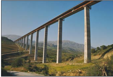
Foto de portada: Viaducto Arroyo de las Piedras.
