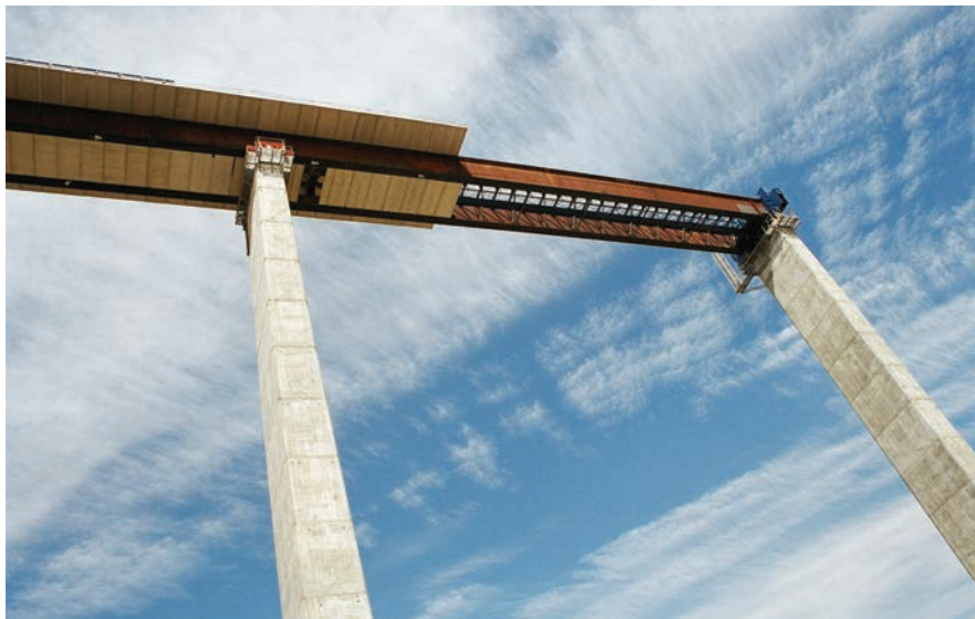
Fig. 14. Vista del primer vano sin prelasas inferiores ni superiores durante el empuje. Fig. 14. View of the first span with no top or bottom pre-slabs during launching
