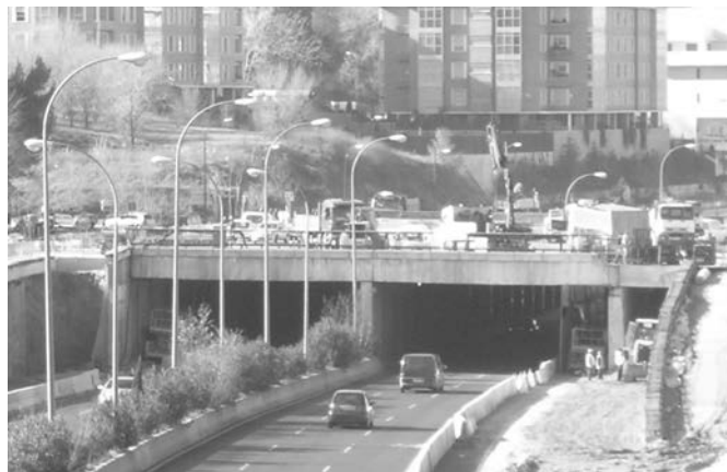
Figura 6. Solución adoptada en ejecución.
