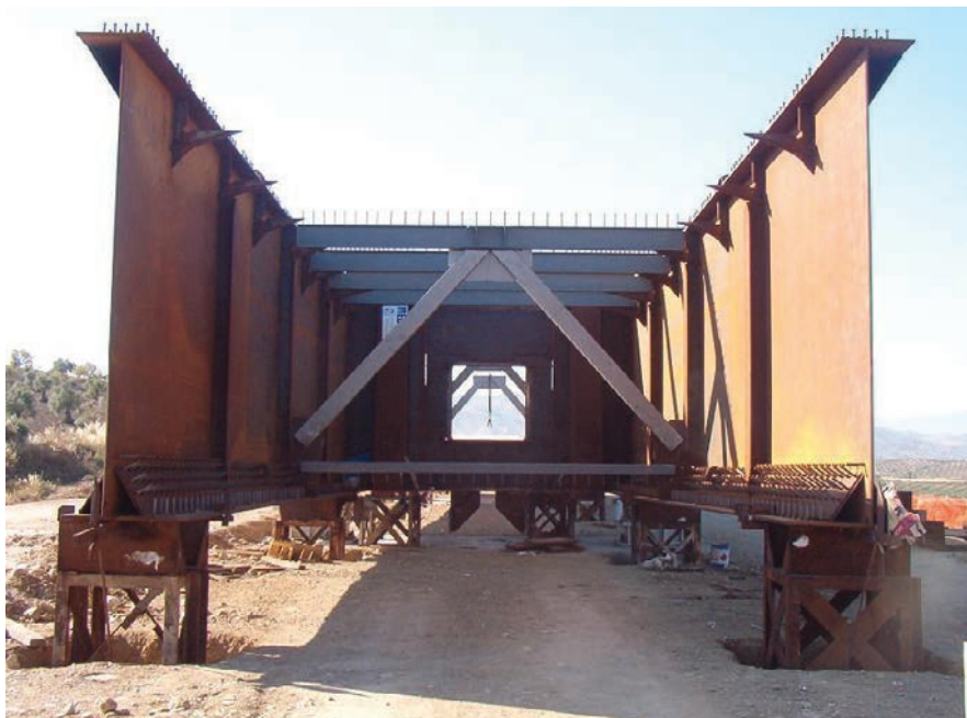
Fig. 10. Estructura metálica apeada en el parque de empuje. Ejecución por Dovelas. Fig. 10. Metal structure propped up in the launching yard. Segment construction.
