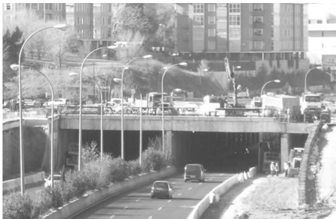
Figura 6. Solución adoptada en ejecución.
