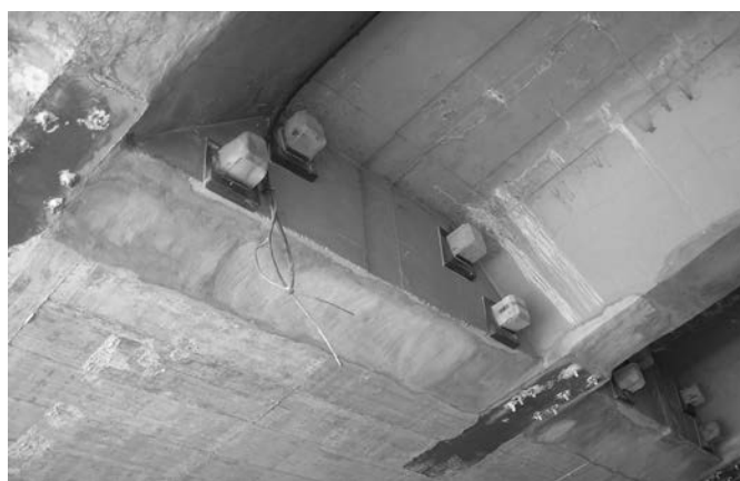
Figura 7. Detalle 1: Chapas conexión y postesado.
