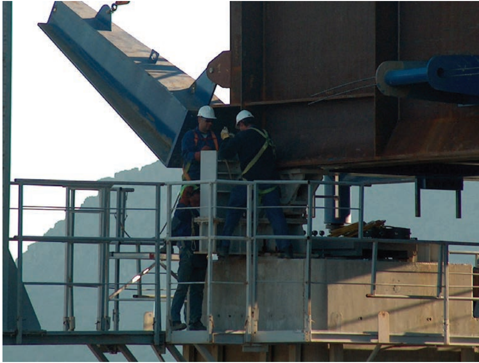
Fig. 21. Operación de paso de pila y repliegue de patines. Fig. 21. Pier passing and nose beam raising.
