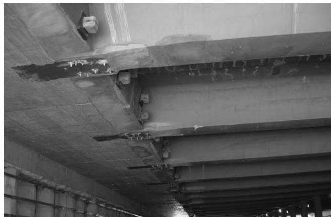
Figura 8. Detalle 2: Chapas conexión y postesado.
