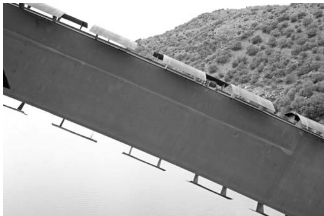
Figuras 4 y 5. Deflectores instalados en las esquinas externas de todos los arcos.
