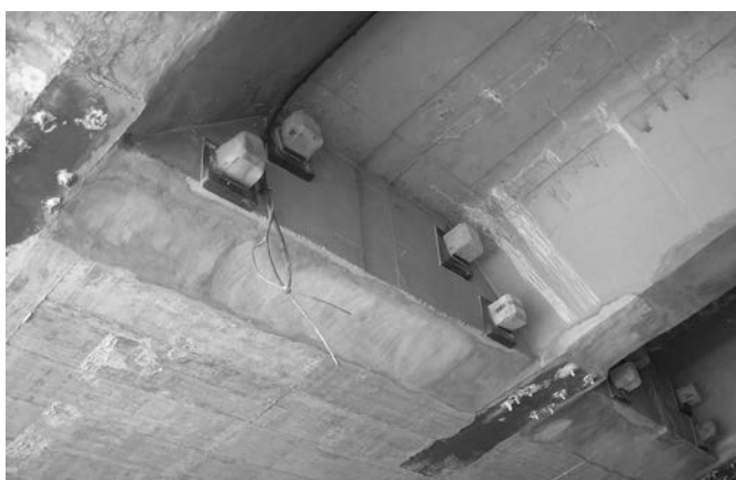
Figura 7. Detalle 1: Chapas conexión y postesado.
