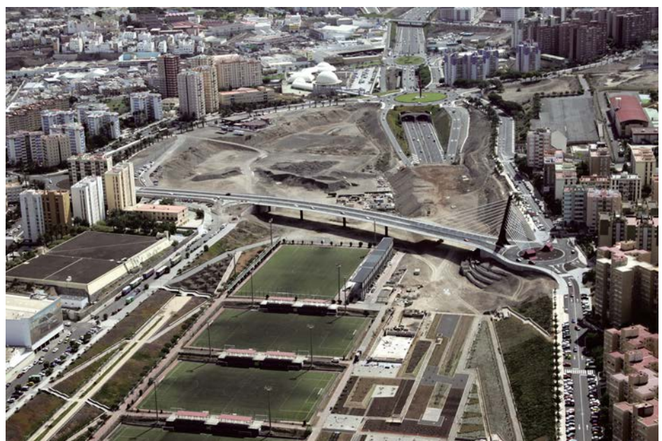
Figura 4. Vista del viaducto desde el inicio del barranco. Figure 4. View of the viaduct from the beginning of the gully.
