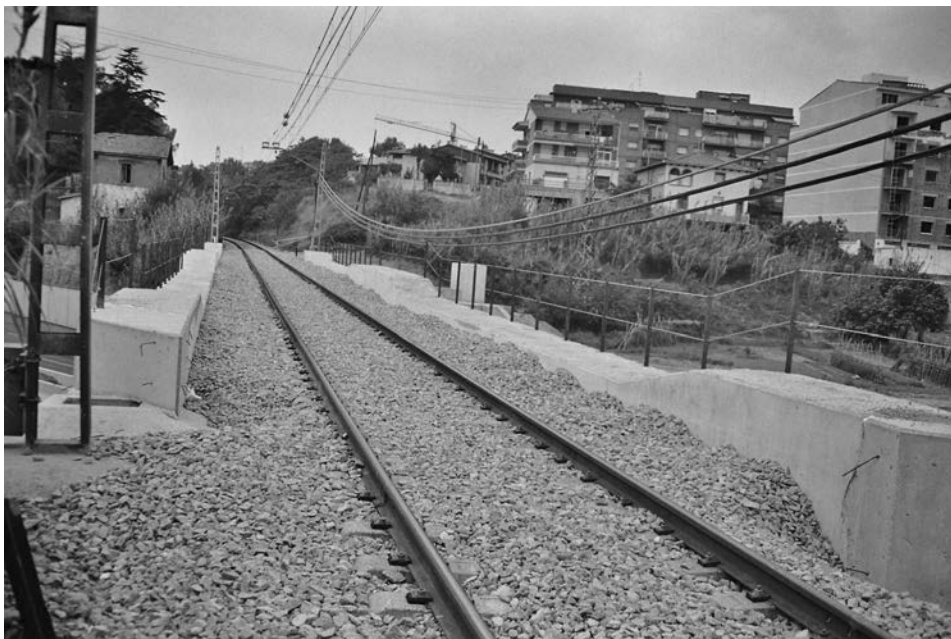
Figura 11. Vista de la superestructura
