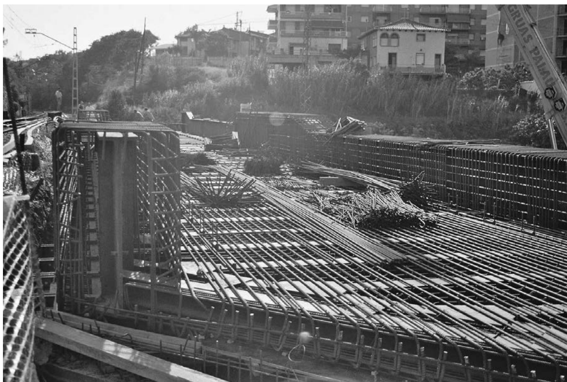
Figura 6. Armadura del tablero.
