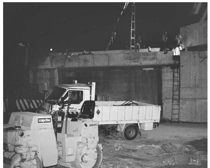
Figura 9. Montaje de la viga cargadero del estribo1.
