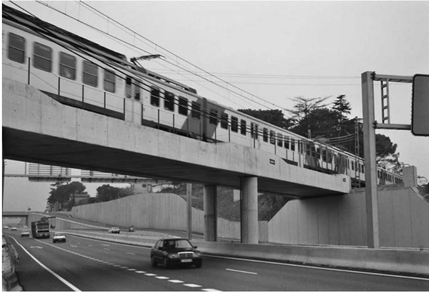
Figura 1. Vista lateral del puente acabado.
