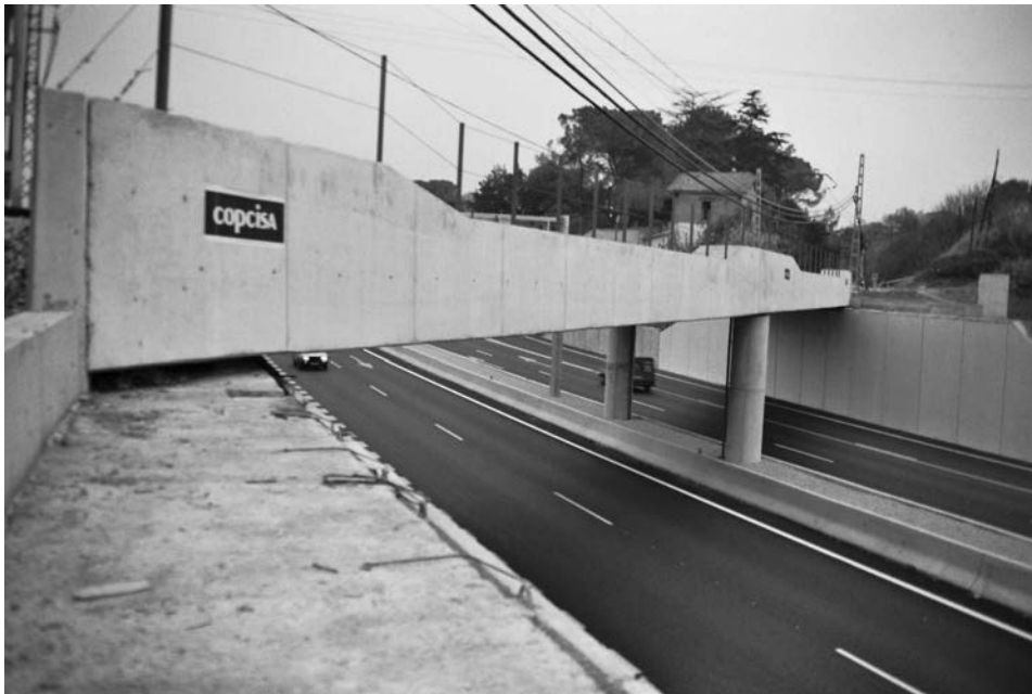
Figura 12. Vista lateral del tablero con la barandilla.
