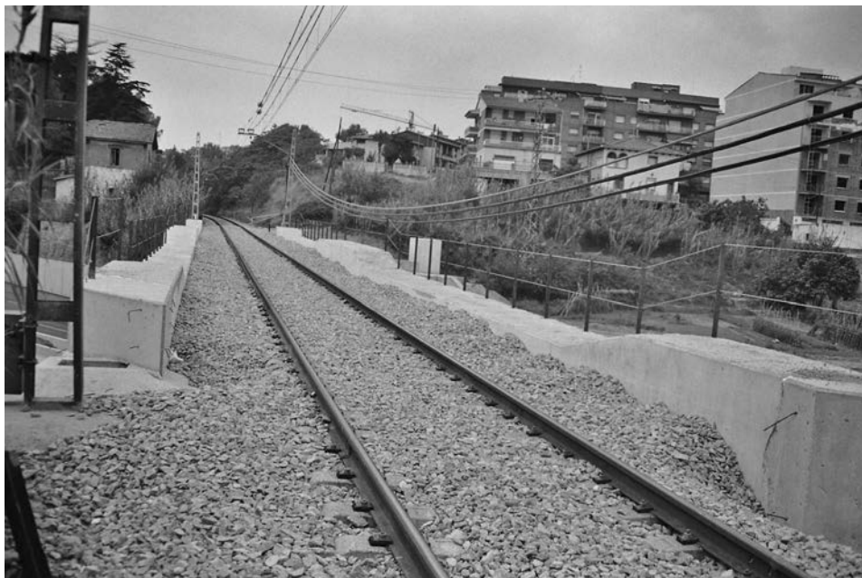
Figura 11. Vista de la superestructura
