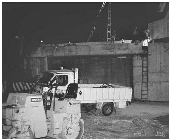
Figura 9. Montaje de la viga cargadero del estribo1.
