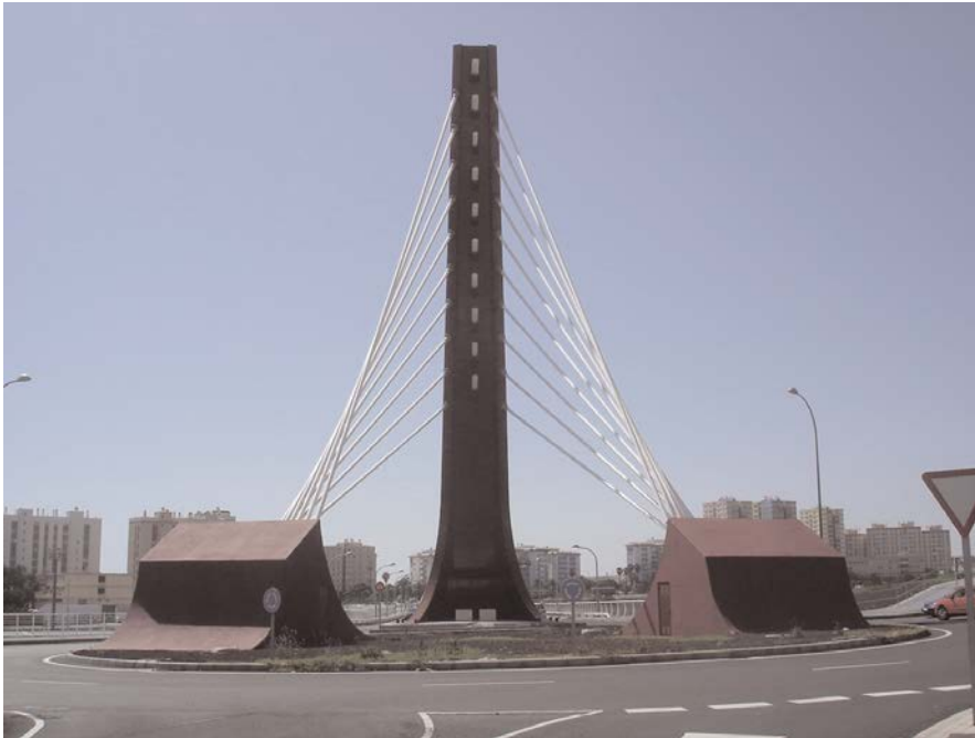
Figura 21. Vista trasera del mástil. Figure 21. Rear view of the pylon.
