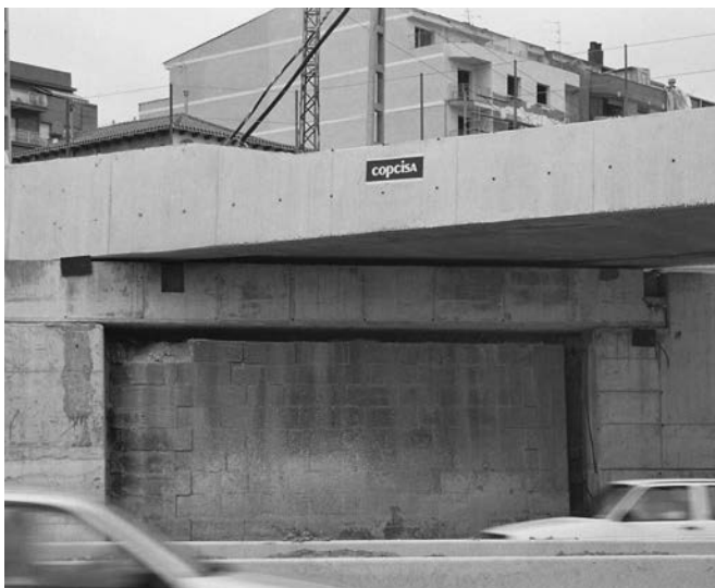
Figura 8. Fotografía del estribo 1 antes de colocar el revestimiento.
