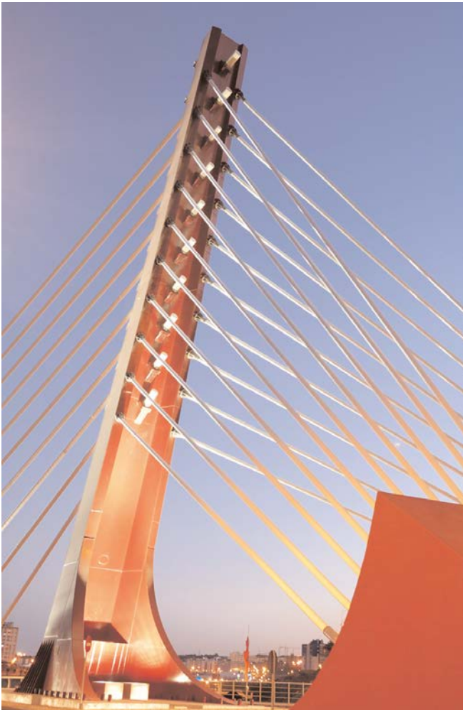
Figura 18. Vista del mástil iluminado desde la ladera oeste. Figure 18. View of the illuminated pylon from the west hillside.
