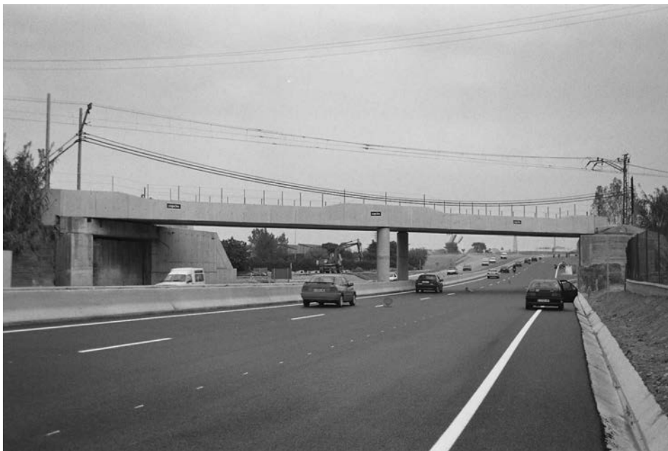
Figura 13. Vista general de la estructura.
