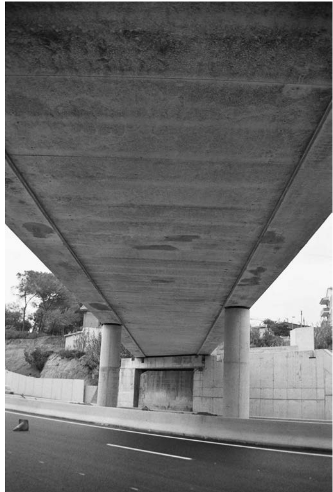
Figura 4. Vista inferior del tablero.
