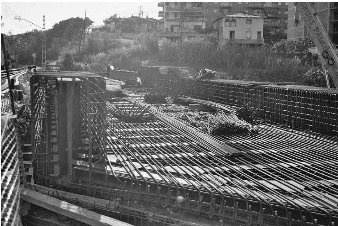
Figura 6. Armadura del tablero.
