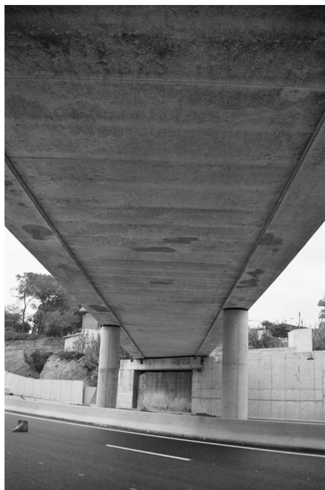
Figura 4. Vista inferior del tablero.
