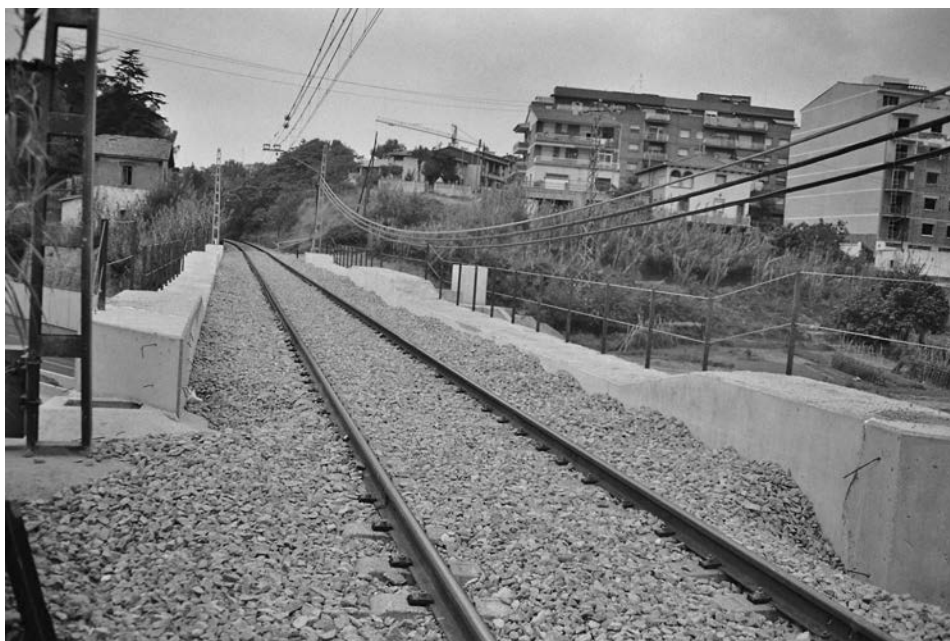
Figura 11. Vista de la superestructura
