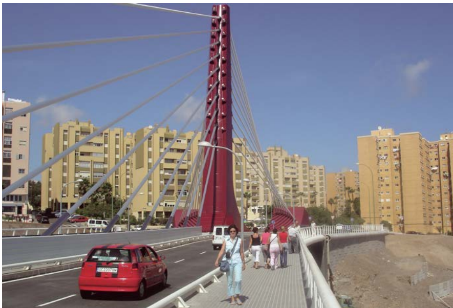
Figura 9. Vista del viaducto desde una de las aceras. Figure 9. View of the viaduct from one of the pavements.
