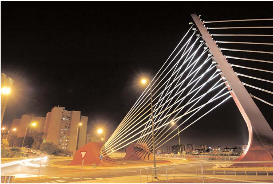
Figura 5. Vista del mástil en la glorieta 1. Toma realizada con gran angular. Figure 5. View of the pylon at roundabout 1. Wide angle picture.
