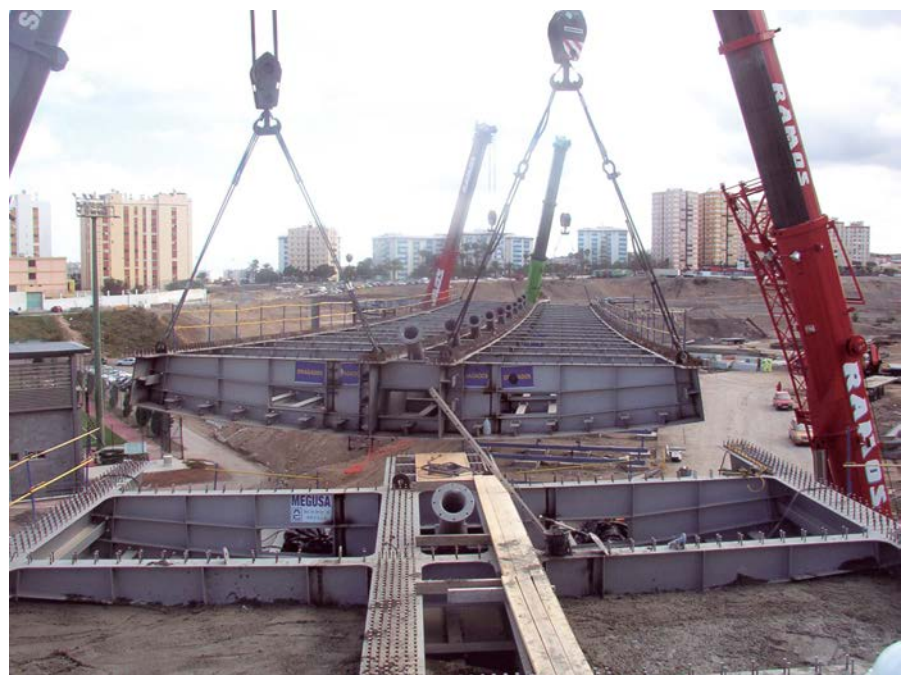
Figura 33. Izado de las dovelas 2, 3 y 4 del tablero. Figure 33. Hoisting of segments 2, 3 and 4 of the deck.
