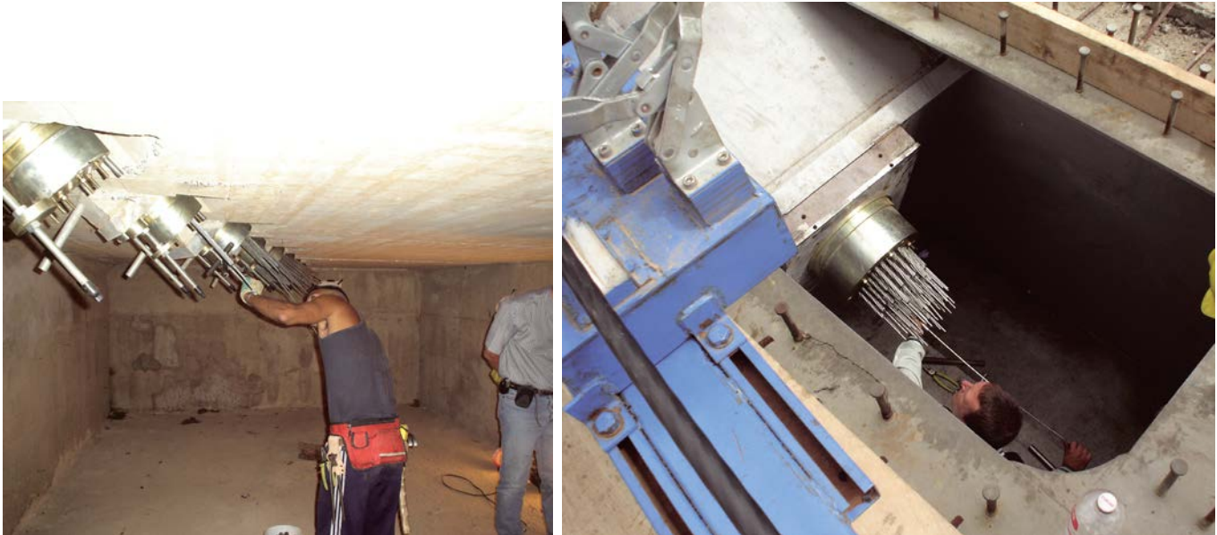
Figura 24. Anclajes fijos en macizo de retención y en tablero. Figure 24. Fixed anchorages at the retention block and at the deck.
