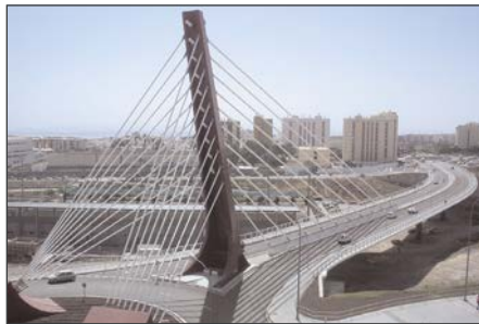
Foto de portada: Viaducto de Escaleritas
