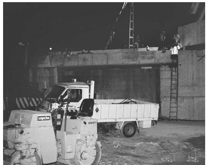
Figura 9. Montaje de la viga cargadero del estribo1.
