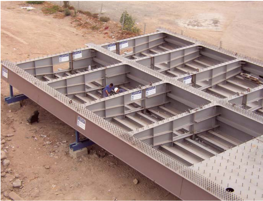
Figura 32. Unión de módulos en obra sobre bancadas de apoyo. Figure 32. Onsite welding of modules on support benches
