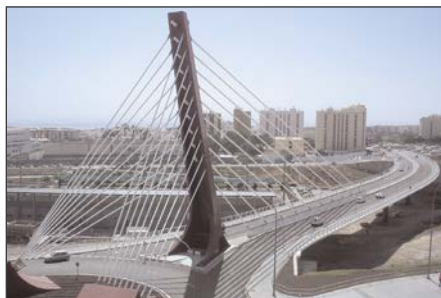
Foto de portada: Viaducto de Escaleritas
