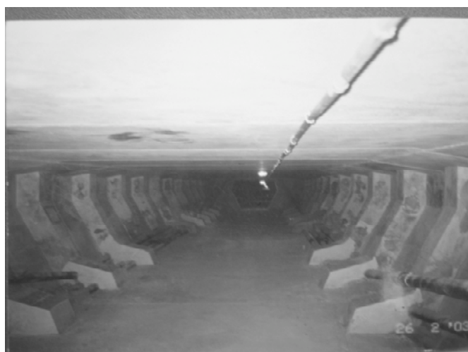
Figura 2. Imagen del interior de un vano del viaducto estudiado.
