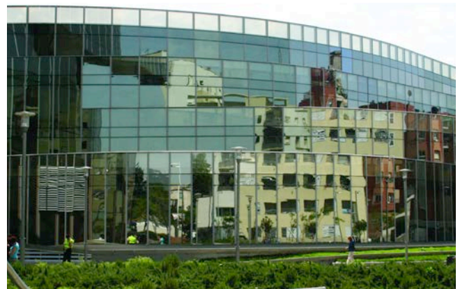
Figura 34. Edificio Cascada. Figure 34. Cascade Building.
