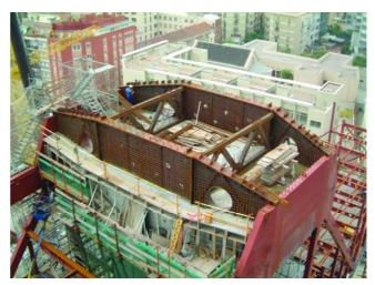
Figura 19. Posicionamiento de las piezas metálicas del elemento de suspensión.
