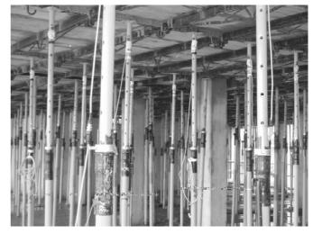
Figura 1. Puntales instrumentados colocados en obra.
