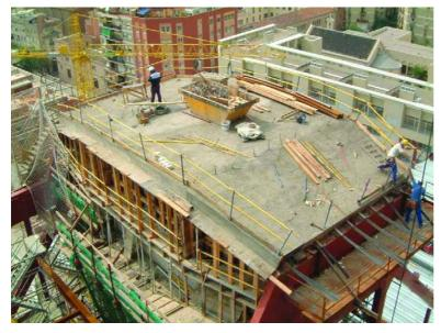
Figura 20. Vista de la estructura del elemento de suspensión durante el pretensado de la losa superior.
