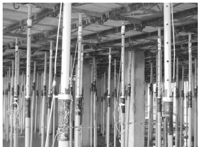
Figura 1. Puntales instrumentados colocados en obra.
