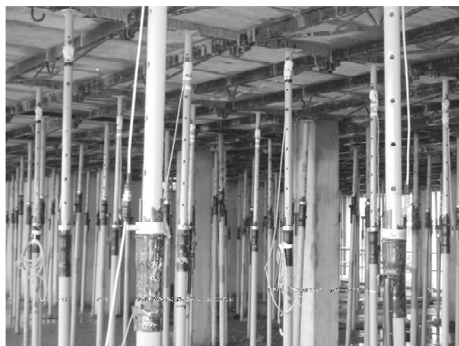
Figura 1. Puntales instrumentados colocados en obra.
