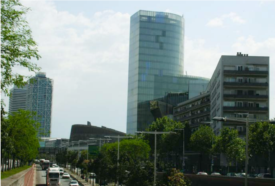
Figura 3. Perspectiva desde la Avenida Dr. Aiguader. Figure 3. Perspective from the Avenida Dr. Aiguader.
