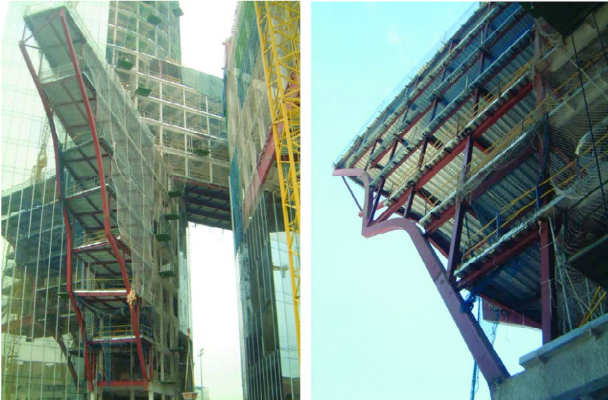
Figura 14. Ejecución del edificio Capitell. Figure 14. Erection of the Capitell Structure.
