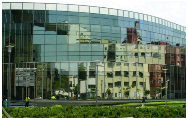
Figura 34. Edificio Cascada. Figure 34. Cascade Building.
