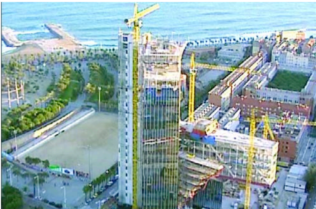
Figura 33. Vista aérea en construcción. Figure 33. Aerial view of construction.
