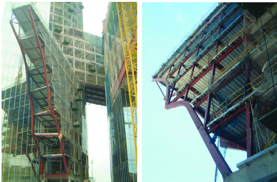
Figura 14. Ejecución del edificio Capital. Figure 14. Erection of the Capital Structure.
