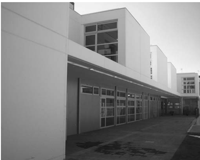
Figura 25. La escuela acabada destaca por sus módulos volumétricos exteriores en voladizo encima de la estructura de planta baja.
