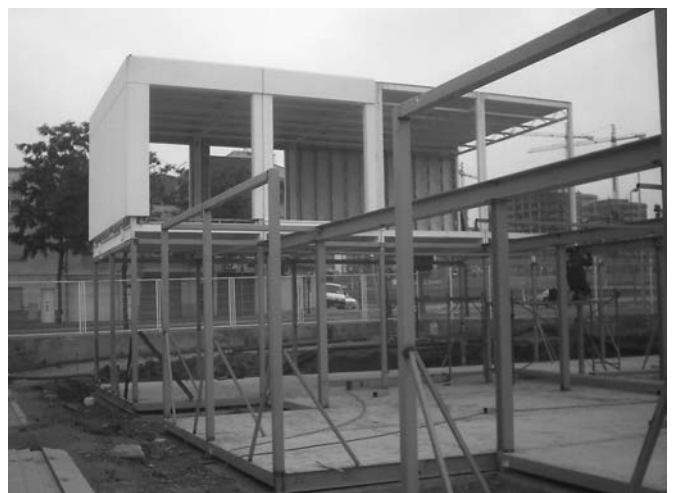
Figura 18. Los módulos prefabricados en la factoría DRACE de Sevilla son una caja con dimensiones múltiplos de 2,70 m. en planta y altura libre de 2,88 m.
