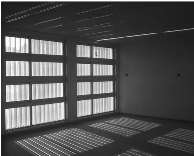
Figura 24. Aulas iluminadas lateralmente gracias al juego de módulos interiores y exteriores.
