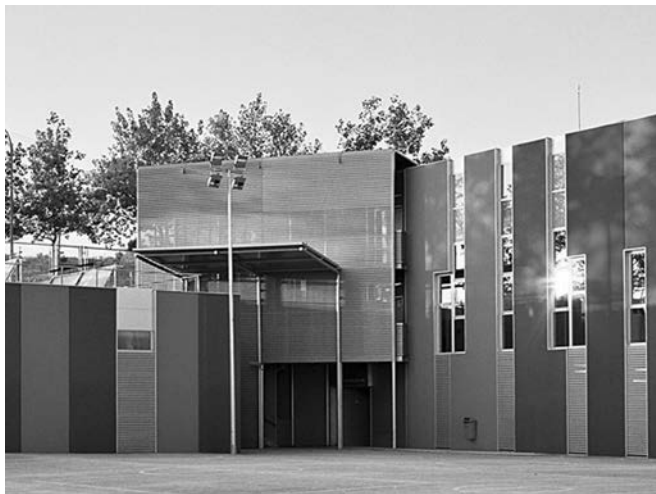
Figura 4. C.E.I.P. Ponent (Terrassa). Prefabricado de hormigón armado y pretensado. Arquitectura: F.Pich-Aguilera arq. Estructura: Prefabricados Pujol.
