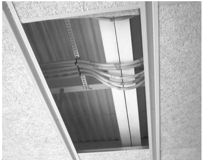
Figura 34. Conexión entre los módulos, que llegan equipados con todas sus instalaciones eléctricas y sanitarias.
