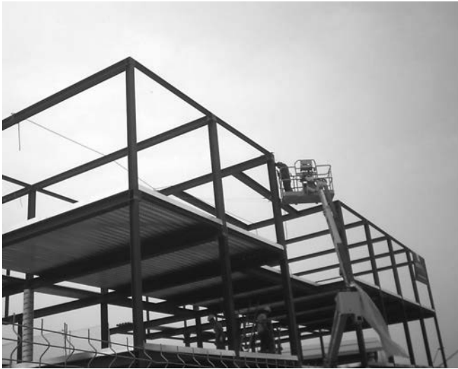
Figura 40. Pórticos metálicos, pautados cada 3,80 m. para que la chapa colaborante no necesitase apuntalamiento en fase de construcción.
