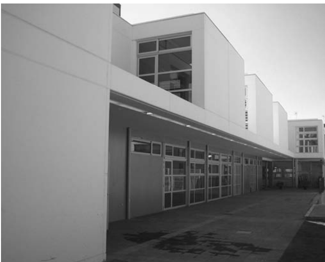
Figura 25. La escuela acabada destaca por sus módulos volumétricos exteriores en voladizo encima de la estructura de planta baja.
