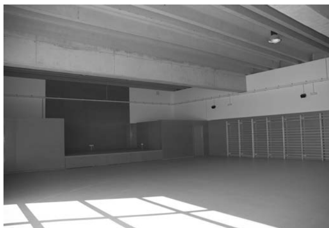
Figura 9. Espacio diáfano de 20x14x5m debajo de las aulas, para usos múltiples de gimnasio y sala de actos con el escenario al fondo. Forjado de placas nervadas pretensadas PI Trumes de 4 m.
