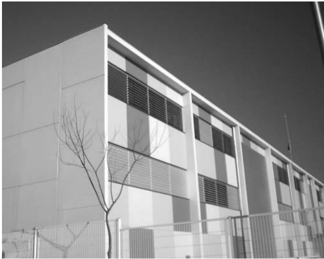
Figura 16. Fachada del edificio prefabricado de pórticos de hormigón armado, con pilares, jácenas y placas alveolares y también cerramientos prefabricados, en la última fase de construcción de la escuela de colocación de los marcos apaisados de las ventanas de las aulas y pintado exterior por damas.
