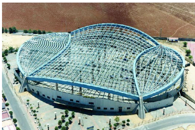
Figura 58. Vista aérea donde se ve la malla terminada, los puntales y el inicio del montaje de los elementos de la cubierta. Figure 58. Aerial shot showing the finished mesh, the struts and the first stages of the erection of the roof elements.
