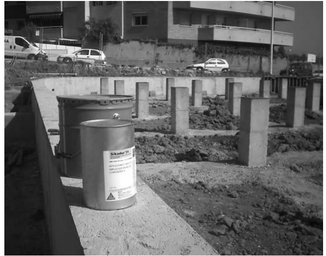
Figura 32. Detalle de los pilarcitos con la placa de apoyo pegada con resina epoxi SIKADUR 31.
