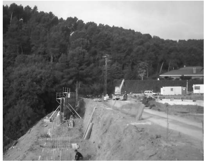
Figura 27. Muro de hormigón armado empotrado en el terreno natural de gravas, mediante elementos pantalla. Perímetro de la nueva edificación.
