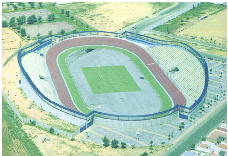
Figura 1. Estado inicial del recinto. Figure 1. Initial state of the site.
