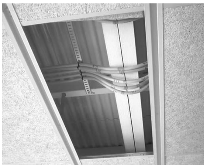
Figura 34. Conexión entre los módulos, que llegan equipados con todas sus instalaciones eléctricas y sanitarias.
