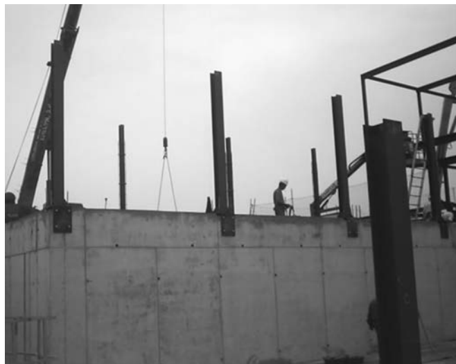
Figura 41. Placas metálicas conectadas con anclajes mecánicos atornillados al muro cambio de nivel, a la espera de los pórticos transversales.
