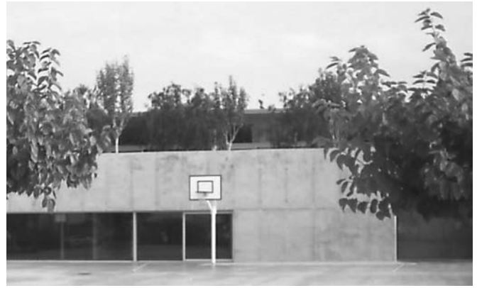
Figura 1. C.E.I.P. La Portalada (Altafulla) Estructura y cerramientos de hormigón in situ. Arquitectura: J.Grané arq. Estructura: PBX
