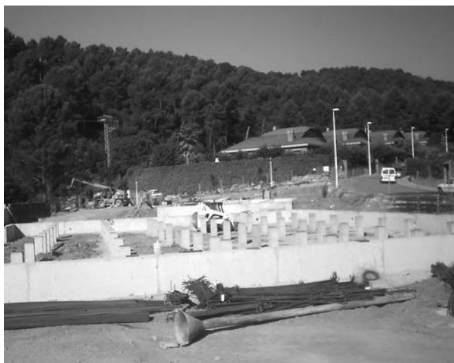
Figura 31. Pilares enanos del sanitario coronados por placas metálicas, a la espera de la llegada de los módulos integrales.
