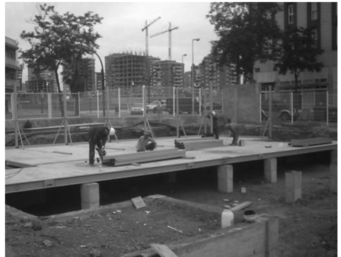
Figura 17. El sanitario prefabricado se apoya encima de pilares que arrancan de los encepados de las pilotes-pantalla de cimentación.
