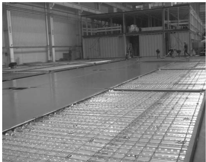
Figura 28. Factoría MODULTEC C (Asturias). Interior de la nave con el hormigonado de las placas base de chapa colaborante.
