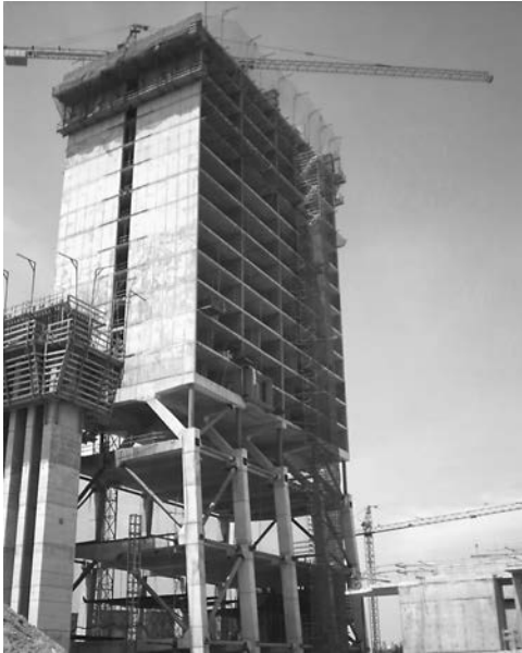
Figura 6. Hotel Hesperia. Estructura semiprefabricada de pantallas de hormigón in situ y prelasas AE FOR. Arquitectura: R.Rogers i Alonso-Balaguer arqs. Estructura: R.Brufau i Ass.
