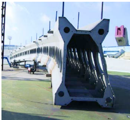
Figure 41. Stiffeners of an interior caisson. Figura 41. Rigidizadores de un cajón interior.
