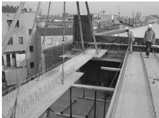
Figura 7. Edificio de Viviendas en Manresa. Estructura semiprefabricada de pilares y jácenas de hormigón armado y prelasas ATEFOR. Arquitectura: Fargas-Rovira arqs. Estructura: PBX.
