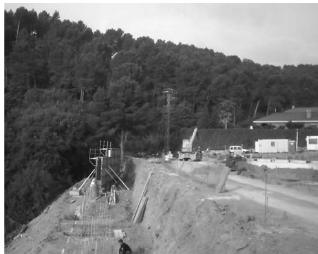
Figura 27. Muro de hormigón armado empotrado en el terreno natural de gravas, mediante elementos pantalla. Perímetro de la nueva edificación.
