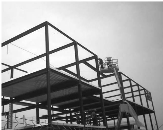
Figura 40. Pórticos metálicos, pautados cada 3,80 m. para que la chapa colaborante no necesite apuntalamiento en fase de construcción.
