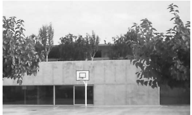
Figura 1. C.E.I.P. La Portalada (Altafulla) Estructura y cerramientos de hormigón in situ. Arquitectura: J.Grané arq. Estructura: PBX
