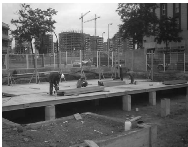
Figura 17. El sanitario prefabricado se apoya encima de pilares que arrancan de los encepados de las pilotes-pantalla de cimentación.
