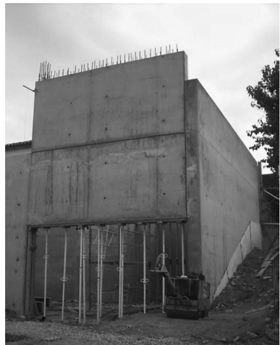
Figura 2. C.E.E. Palau (Girona) Estructura y cerramientos de hormigón in situ. Arquitectura: J.Fargas arq. Estructura: PBX
