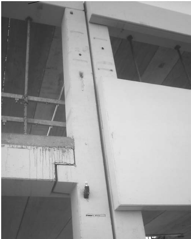
Figura 13. Los pilares se fabrican con el encaje necesario para colocar pequeñas ménsulas metálicas de conexión de los cerramientos prefabricados.
