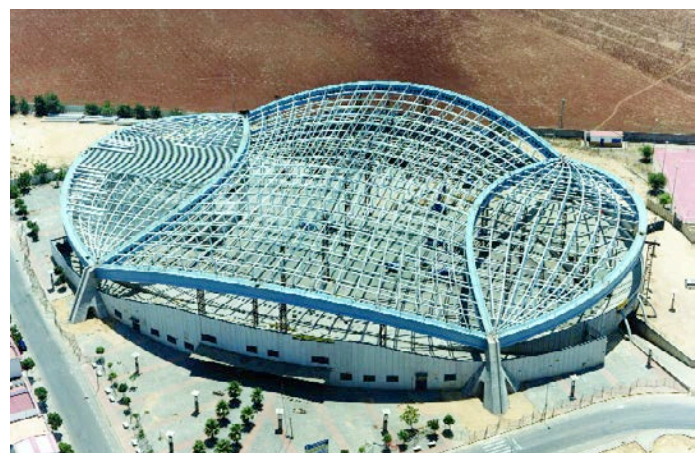
Figura 58. Vista aérea donde se ve la malla terminada, los puntales y el inicio del montaje de los elementos de la cubierta. Figure 58. Aerial shot showing the finished mesh, the struts and the first stages of the erection of the roof elements.
