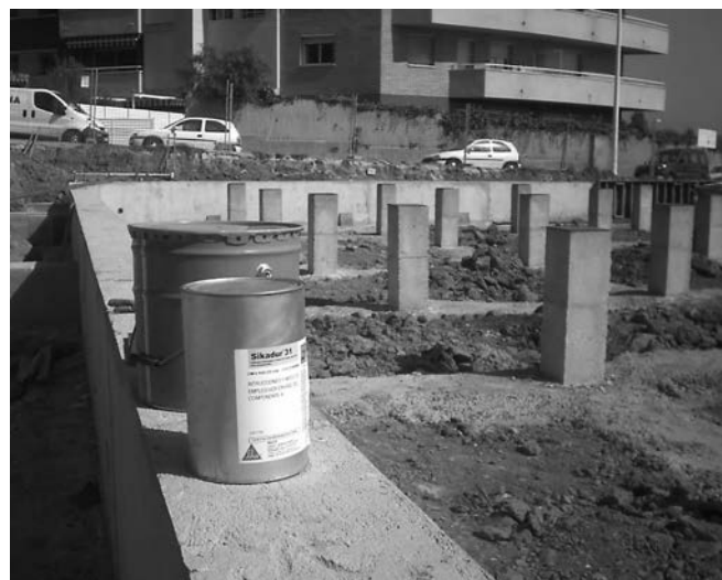
Figura 32. Detalle de los pilarcitos con la placa de apoyo pegada con resina epoxi Sika 31.
