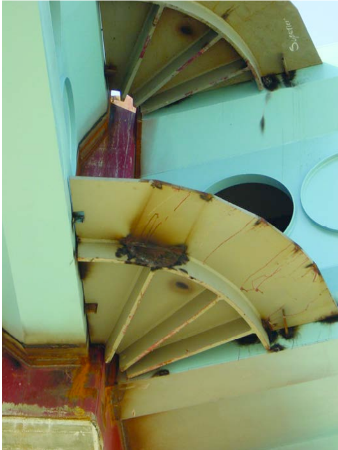
Figura 53. Montaje y conexión de la pieza de unión de las barras en una de las esquinas del voladizo. Figure 53. Assembly and connection of the joint of the bars to one of the corners cantilever sector.
