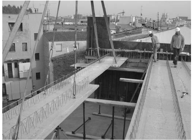
Figura 7. Edificio de Viviendas en Manresa. Estructura semiprefabricada de pilares y jácenas de hormigón armado y prelosas ATEFOR. Arquitectura: Fargas-Rovira arqs. Estructura: PBX.
