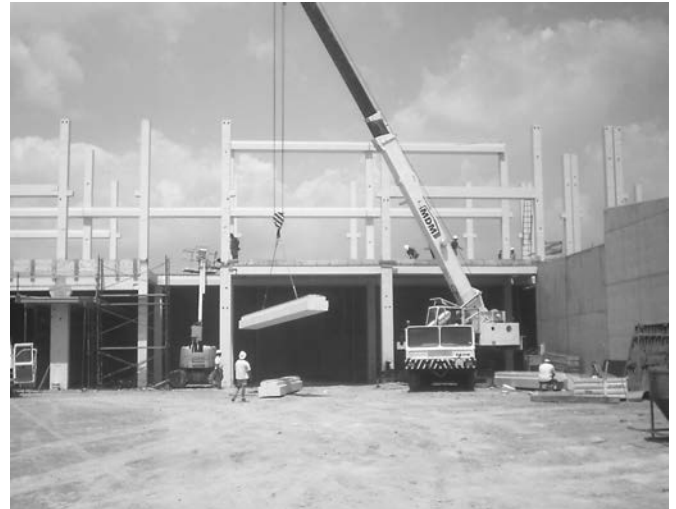
Figura 11. Montaje de la estructura con los nudos pilar-jácena resueltos con ménsulas en escalón embebidas y armadura pasante por pilar.
