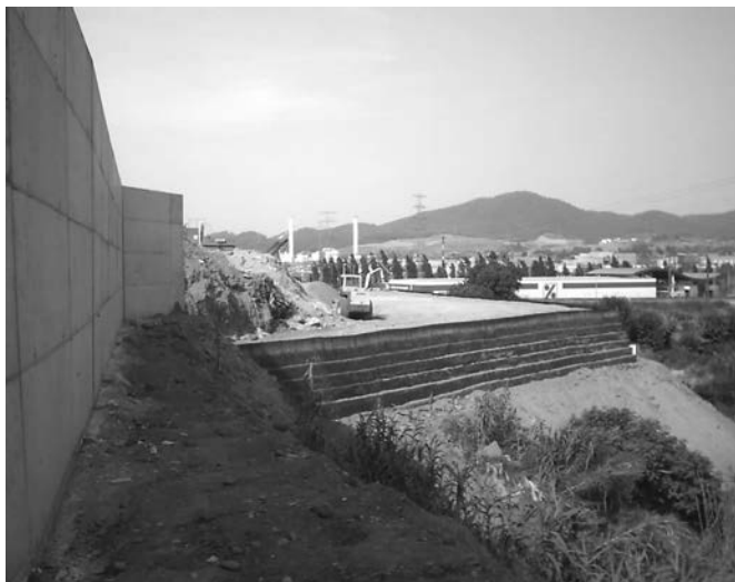
Figura 26. Muro ecológico de capas de tierra armada, para completar el solar de las pistas polideportivas.
