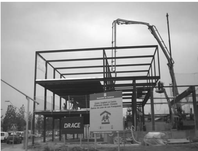
Figura 44. Esqueleto de la estructura del testero singular, en su fase inicial de montaje y hormigonado con bomba del forjado intermedio.
