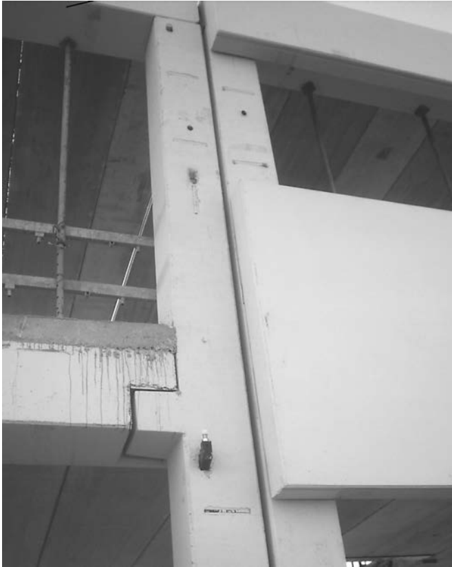
Figura 13. Los pilares se fabrican con el encaje necesario para colocar pequeñas ménsulas metálicas de conexión para colocar pequeñas ménsulas metálicas de conexión de los cerramientos prefabricados.
