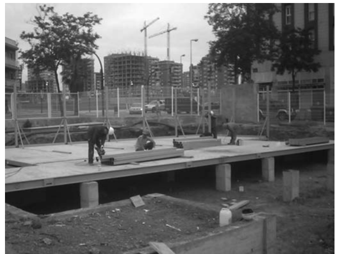
Figura 17. El sanitario prefabricado se apoya encima de pilares que arrancan de los encepados de las pilotes-pantalla de cimentación.
