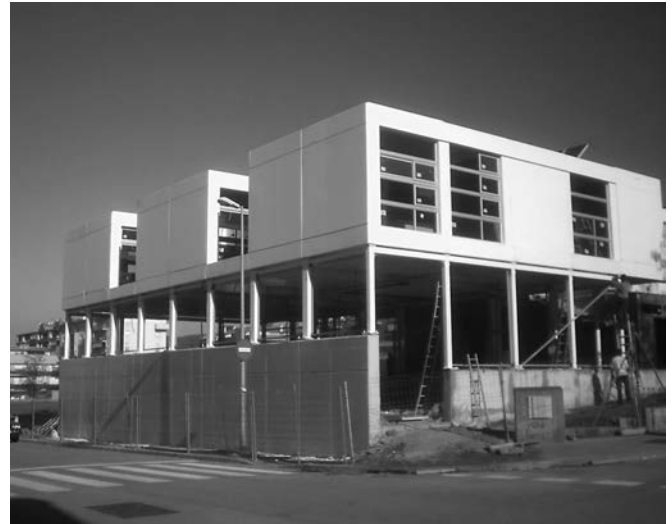
Figura 23. Testero del C.E.I.P. acabado con las aulas especiales que cubren el espacio deportivo libre del gimnasio.
