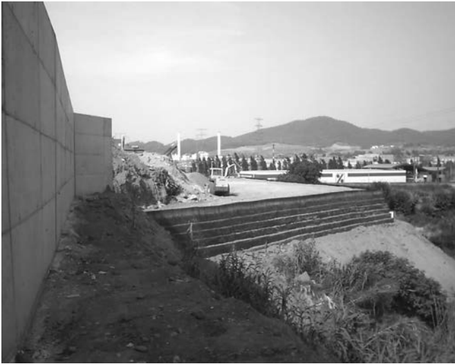
Figura 26. Muro ecológico de capas de tierra armada, para completar el solar de las pistas polideportivas.
