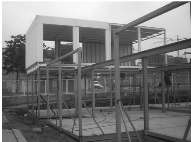
Figura 18. Los módulos prefabricados en la factoría DRACE de Sevilla son una caja con dimensiones múltiples de 2,70 m. en planta y altura libre de 2,88 m.
