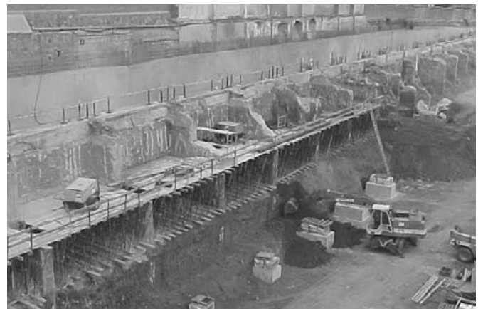
Figura 7. Muro pantalla con contrafuertes con la excavación completada. Ejecución de las losas de los forjados.
