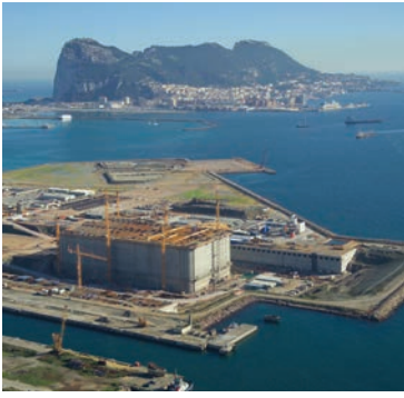
Foto de portada: Cajón Adriatic LNG terminal durante su construcción en Algeciras.
