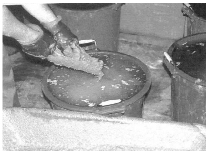
Moldeo de probetas bajo el agua dejando caer el hormigón en caída libre desde el borde de la lámina de agua (aproximadamente 5 cm. sobre la boca del molde) y sin aplicar compactación.
