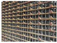
Figura 10. Esquematización del concepto de las T-heads. Figure 10. T-heads concept diagram.
