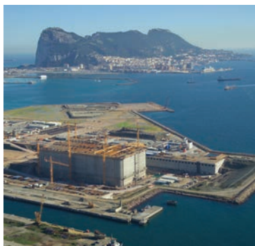
Foto de portada: Cajón Adriatic LNG terminal durante su construcción en Algeciras.
