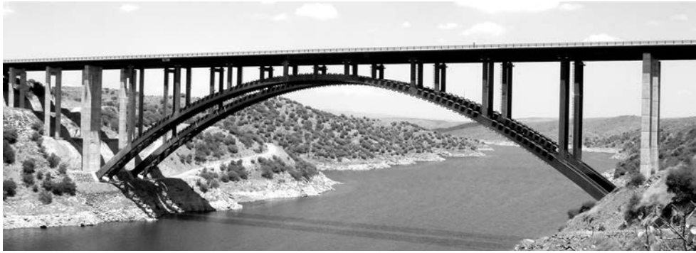
Figura 1. El puente sobre el Río Tajo en el Embalse de Alcántara.
