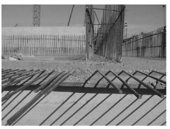
Figura 10. Vista del canto de la losa D-2-1 Mar con algunas esperas de armadura.
