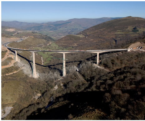
Foto de portada: Viaducto de Montabiz.
