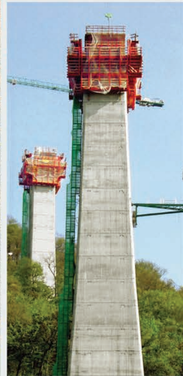
Pilas Viaducto de Montabliz
