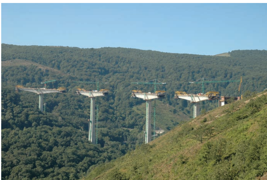
Figura 29. Vista general de las "Ts" de las cuatro pilas. Figure 29. General view of the four piers' "Ts".
