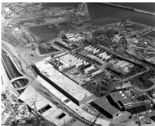
Figura 1. Vista aérea de la obra (Abril 2003).
