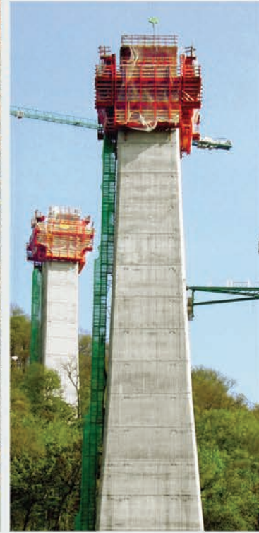
Pilas Viaducto de Montabliz
