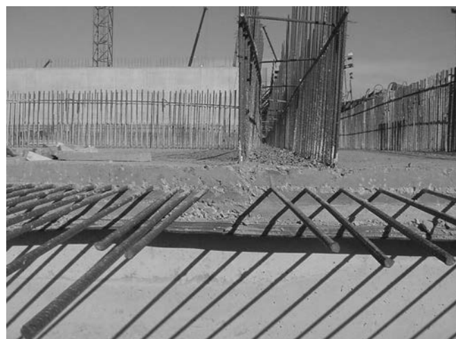
Figura 10. Vista del canto de la losa D-2-1 Mar con algunas esperas de armadura.
