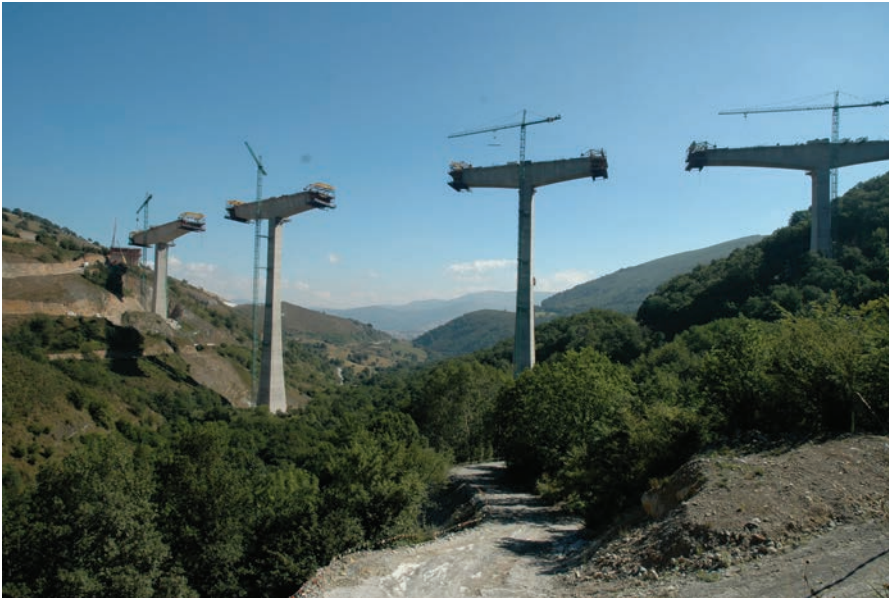
Figura 28. Avance progresivo de las "Ts" de la estructura. Figure 28. Progressive advance of the structure's "Ts".
