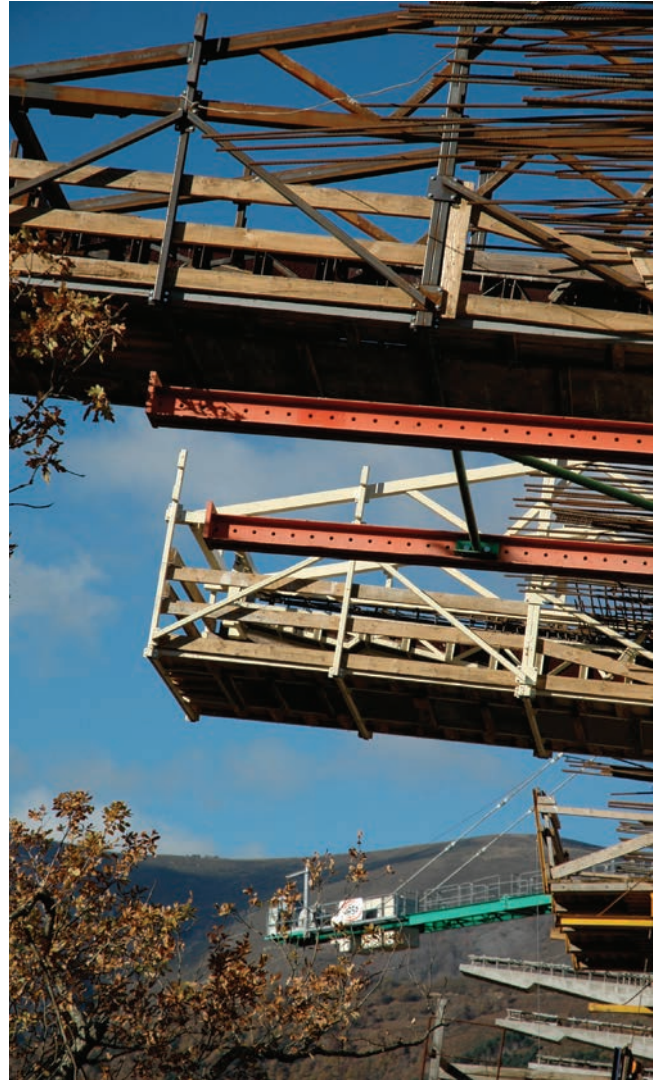
Figura 35. Carros de nervios transversales de voladizos.
