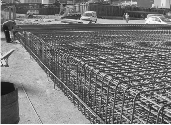
Figura 3. Vista de la armadura de una de las losas.
