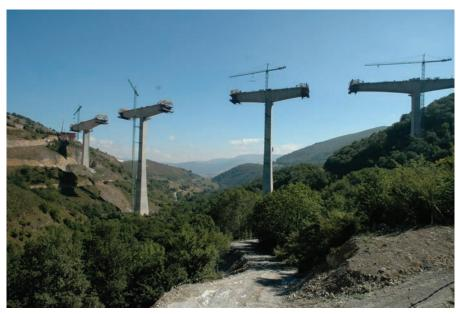
Figura 28. Avance progresivo de las "Ts" de la estructura. Figure 28. Progressive advance of the structure's "Ts".
