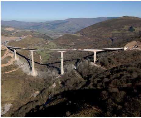
Foto de portada: Viaducto de Montabiz.
