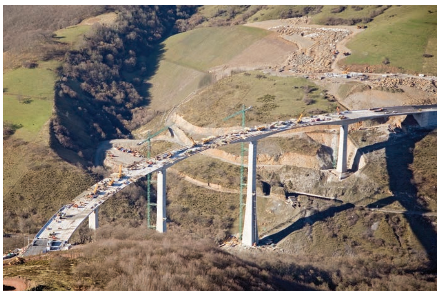
Figura 32. Detalle de cierre de vano 5 sobre el bosque mixto de Montabliz. Figure 32. Detail of span 5's closing over the mixed Montabliz wood.
