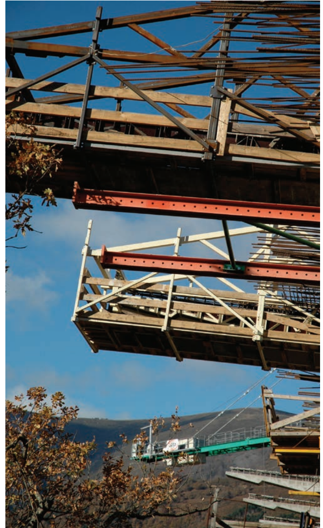
Figura 35. Carros de nervios transversales de voladizos.
