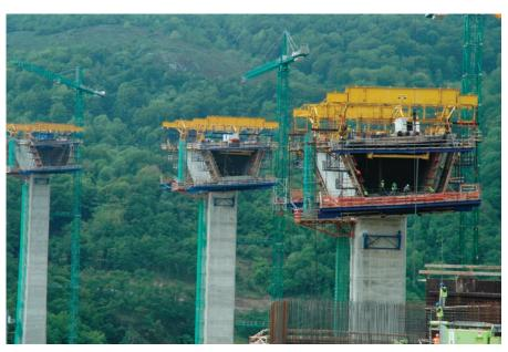
Figura 27. Ejecución de dovelas tipo mediante carros de avance. Figure 27. Building standard segments with travellers.
