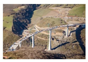
Figura 33. Vista aérea de la estructura durante la ejecución de los voladizos laterales.
