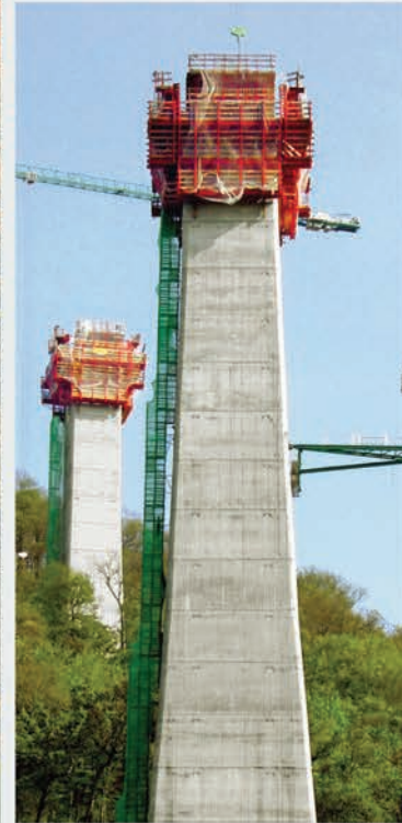
Pilas Viaducto de Montabliz
