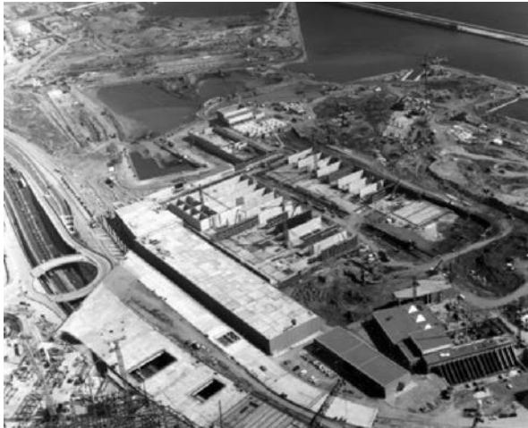
Figura 1. Vista aérea de la obra (Abril 2003).
