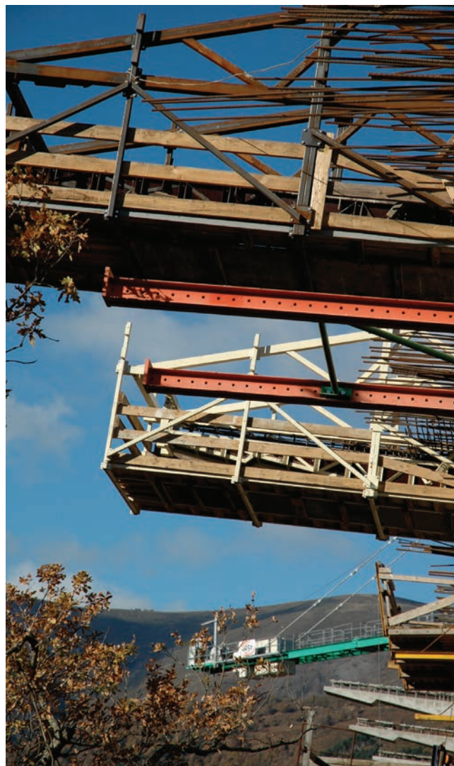
Figura 35. Carros de nervios transversales de voladizos.
