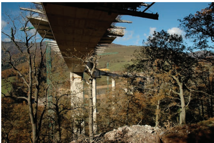
Figura 34. Vista inferior de tablero desde estribo 2.
