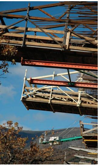
Figura 35. Carros de nervios transversales de voladizos. Figure 35. Transversal rib travellers.
