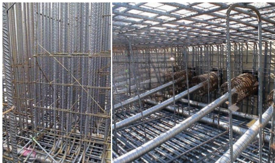
Figura 3. Detalle de arranque de núcleo central y fijación de cabezas al encofrado.
