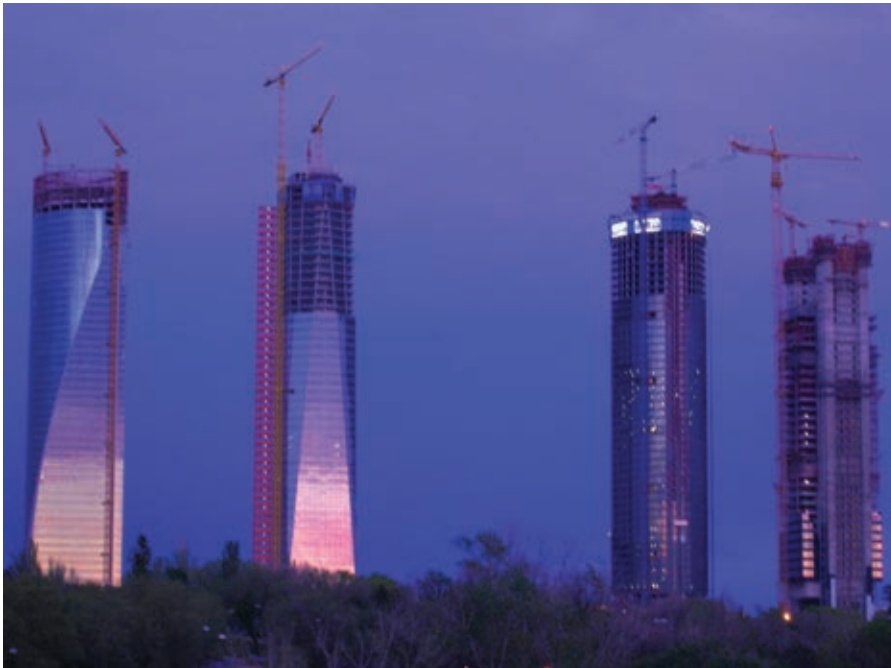
Figura 15. Avance de la ejecución de las obras de las cuatro torres. Figure 15. Progress of the work on the four towers.
