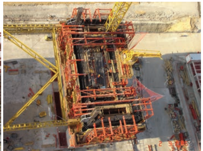
Figura 12. Estructura del encofrado autotrepante Figure 12. Slipform structure.
