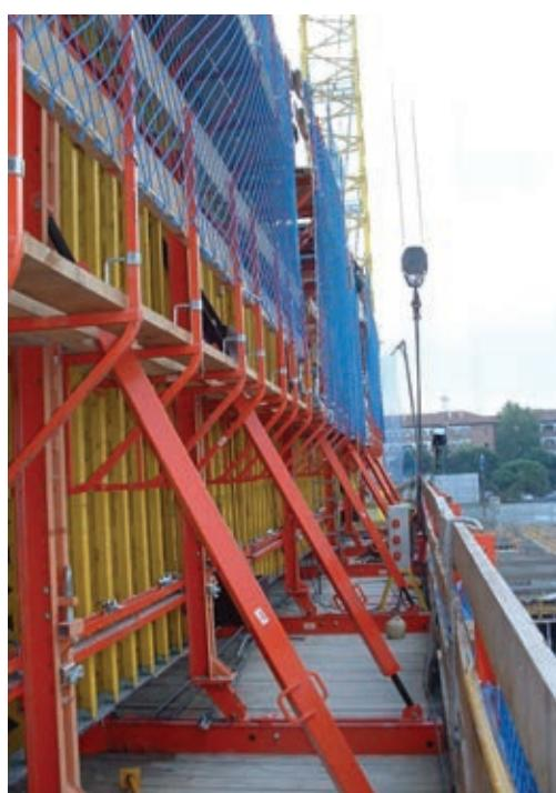
Figura 9. Encofrado autotrepante.
