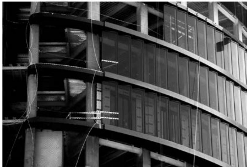
Figura 11. Esquema en sección del sistema de doble fachada (izqda.) y visión general del mismo durante el montaje en obra (dcha.) Figure 11. Section diagram of the double façade system (left) and general view of said system during the site assembly (right).
