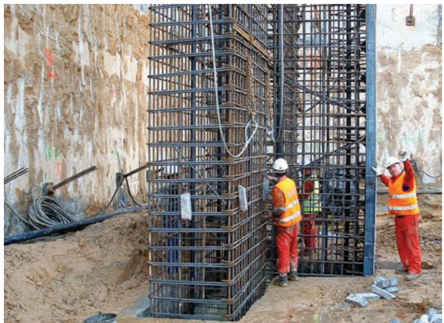
Figura 7. Ferralla para paneles de pantallas de cimentación. Figure 7. Rebar for foundation walls.
