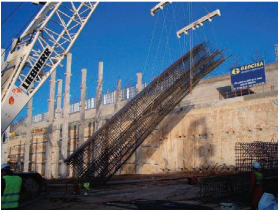
Figura 5. Izado de la ferralla de un panel de pantalla.
