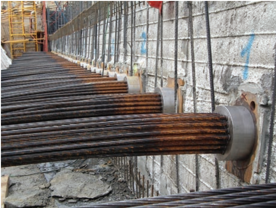
Figura 3. Anclajes activos después del tesado en losa de cimentación de Torre Espacio. Figure 3. Active anchorages after tensile stressing in the Torre Espacio foundation slab.
