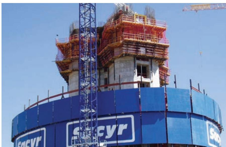
Figura 19. Ejecución del núcleo central.
