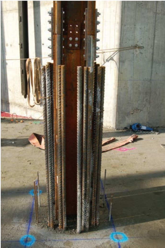
Figura 8. Uniones entre tramos de soportes metálicos con capacidad para resistir los esfuerzos debidos al viento durante la construcción. Figure 8. Joints between sections of steel supports, capable of withstanding the wind loads during construction.
