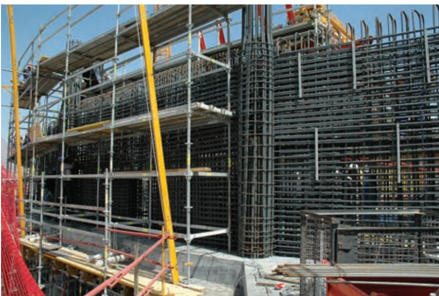
Figura 12. Ferrallado de las pantallas perimetrales del cinturón de rigidez conectadas con los soportes de la fachada.
