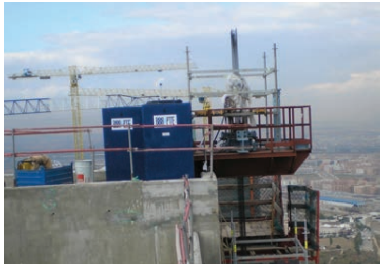
Figura 28. Plataforma de gatos en coronación de núcleo. Figure 28. Core crown platform for jacks.
