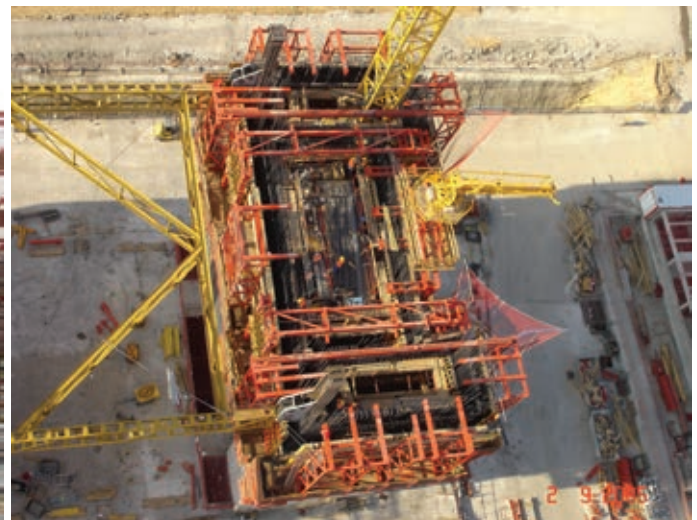
Figura 12. Estructura del encofrado autotrepante Figure 12. Slipform structure.
