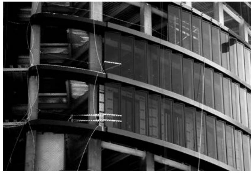
Figura 11. Esquema en sección del sistema de doble fachada (izqda.) y visión general del mismo durante el montaje en obra (dcha.).
