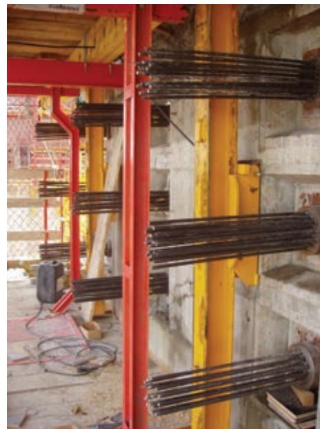
Figura 18. Losa desencofrada. Vista antes y después del tesado de cables.
