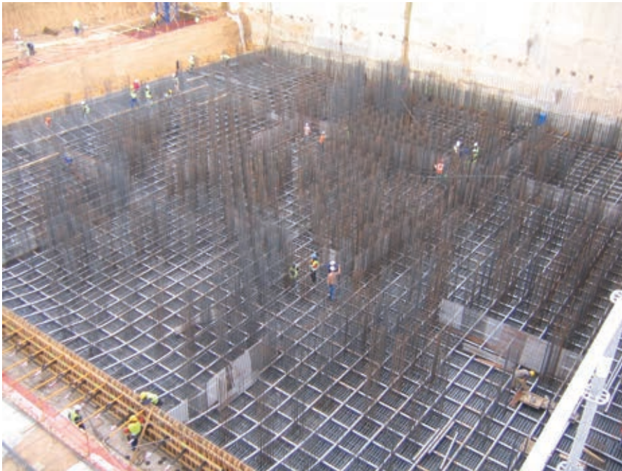
Figura 3. Vista general de la losa de cimentación, incluyendo los cables de pretensado y la armadura de cortante.
