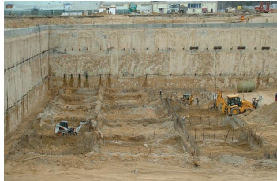
Figura 2. Excavación y muro pantalla.
