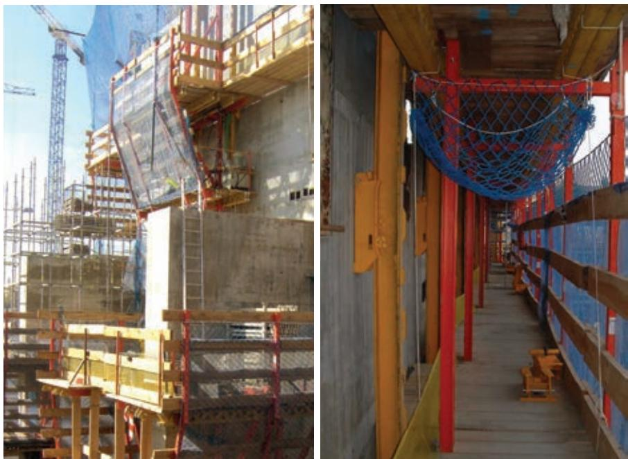
Figuras 12 y 13. Encofrado Autotrepante.
