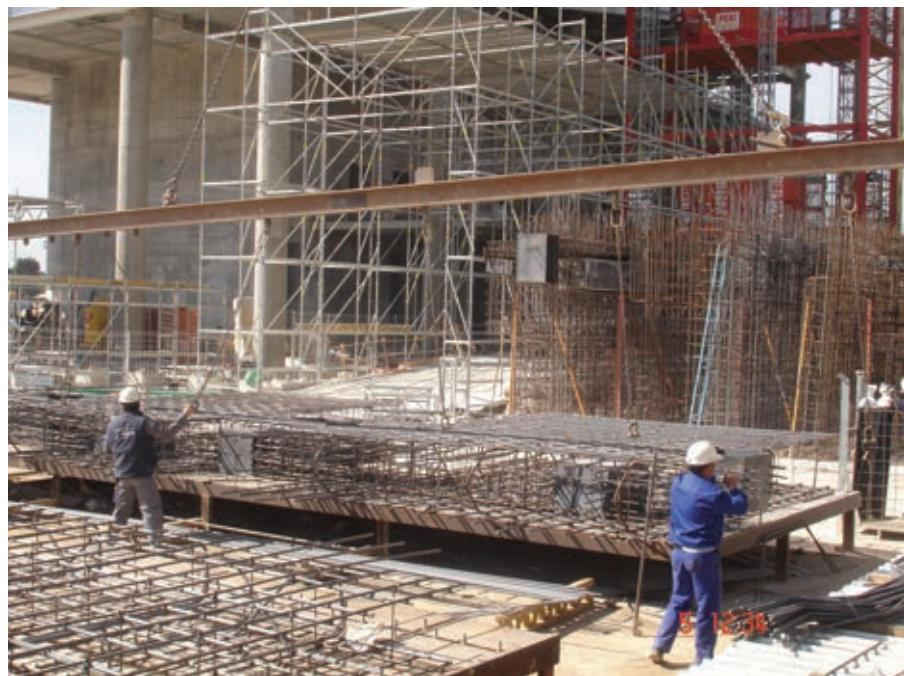
Figura 2. Taller de prefabricación de ferralla.
