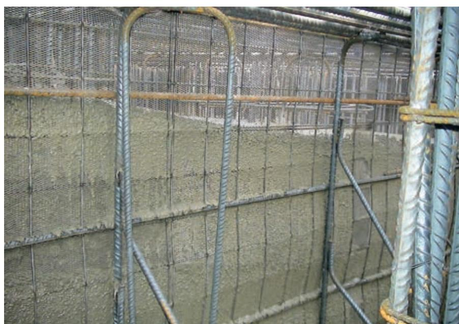
Figura 5. Detalle de junta vertical con nervometal.
