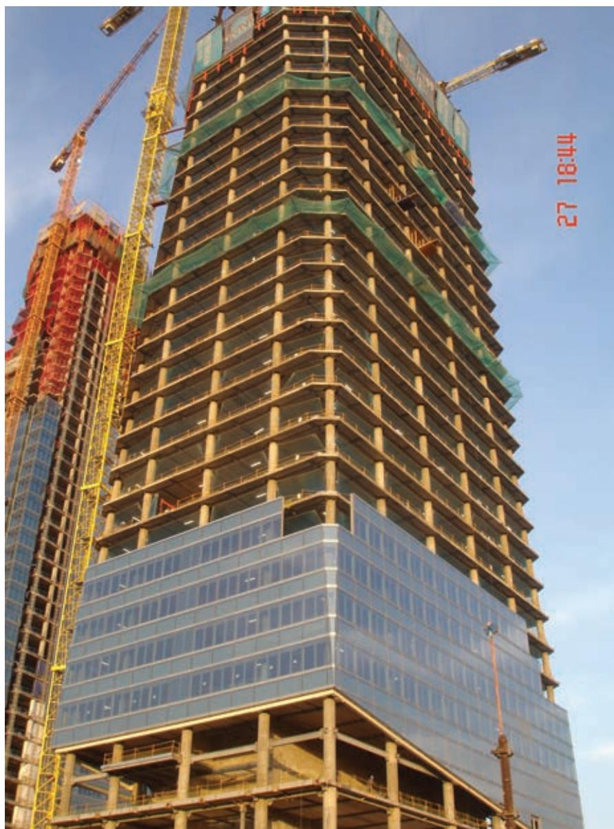
Figura 18. Muro cortina parcialmente instalado,
