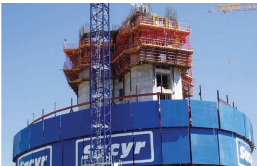
Figura 19. Ejecución del núcleo central. Figure 19. Execution of the central core.
