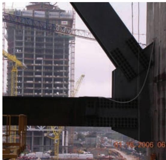
Figura 14a. Conexión del cordón inferior de la cercha principal
