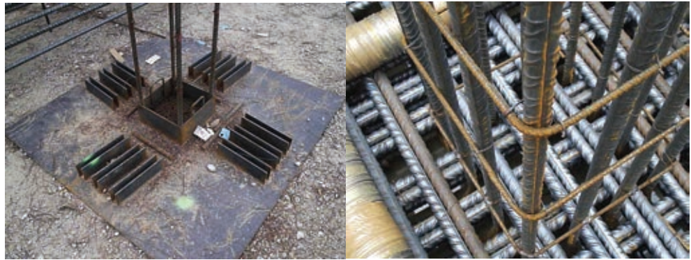
Figura 2. Disposición de armado de torretas de cortante y plantilla de armado. Detalle de paso de armado longitudinal inferior entre las barras verticales de las torretas de cortante, en zona de solapo.
