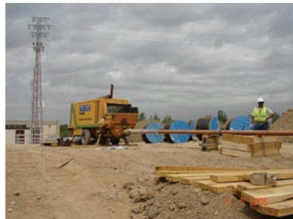
Figura 3. Bombeo de hormigón.
