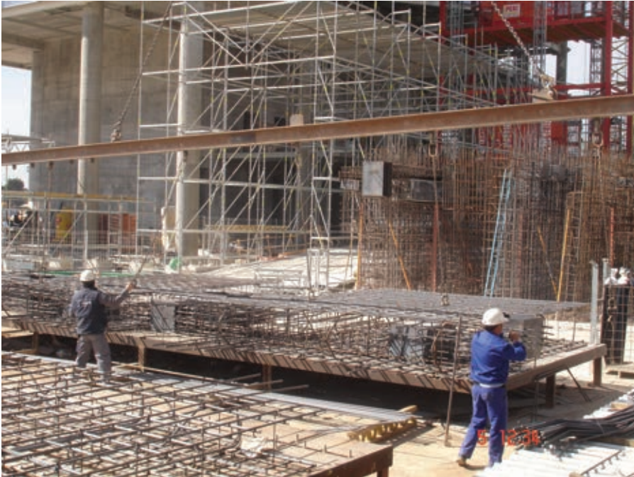
Figura 2. Taller de prefabricación de ferralla. Figure 2. Rebar prefabrication shop.
