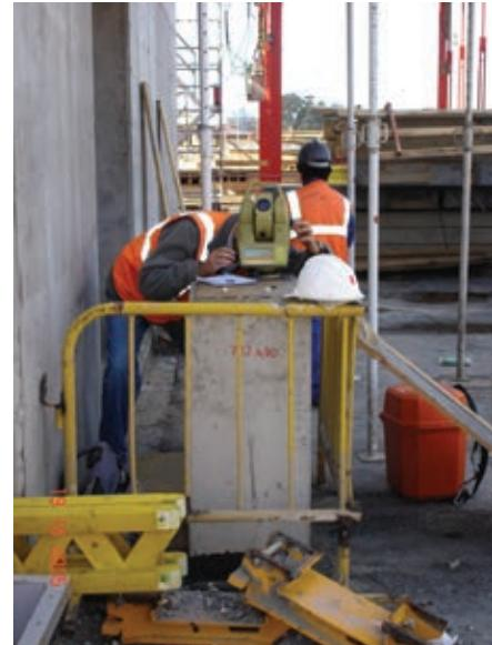
Figura 2. Bases fijas de replanteo. Posición y detalle
