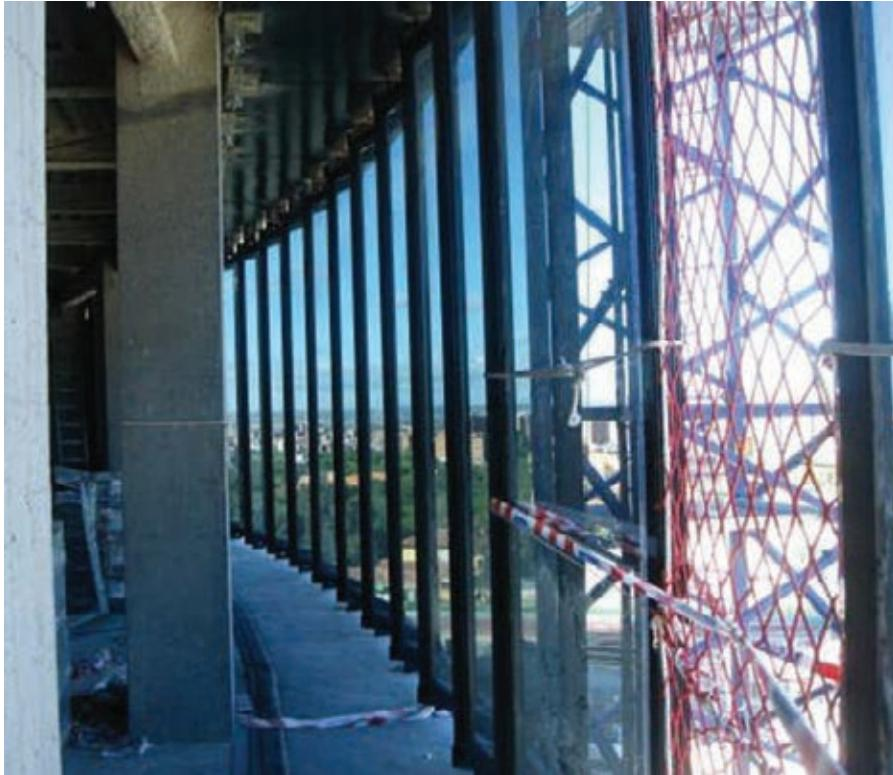
Figura 12. Espacio comprendido entre las fachadas interior y exterior.
