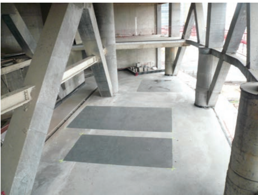
Figura 15. Aspecto de los niveles técnicos N4 y N5. Figure 15. Picture of technical floors N4 and N5.
