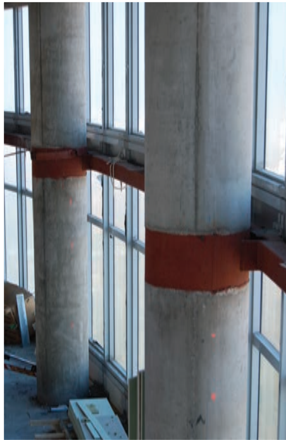
Figura 24. Estructura metálica auxiliar para sujeción de la fachada: vista general (izqda.); detalle de conexión con los soportes (dcha.).
