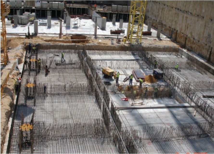
Figura 7. Armado de la losa de cimentación. Figure 7. Foundation slab reinforcement.
