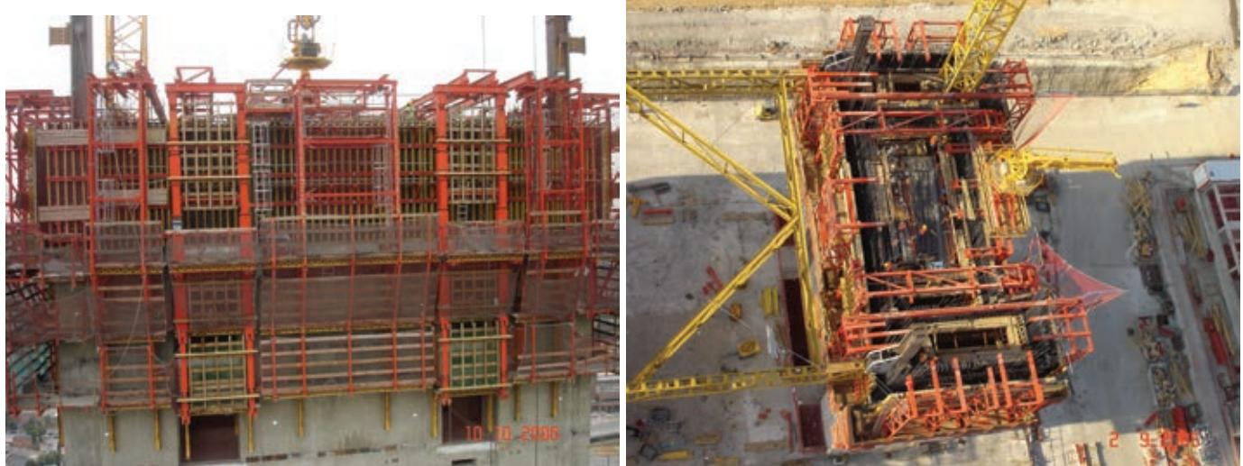
Figura 12. Estructura del encofrado autotrepante
