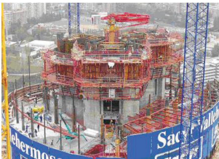
Figura 21. Ejecución de los forjados.
