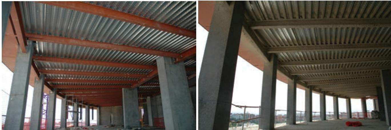
Figura 28. Vista inferior de un forjado tipo antes y después de aplicar la protección ignífuga a las vigas y viguetas.
