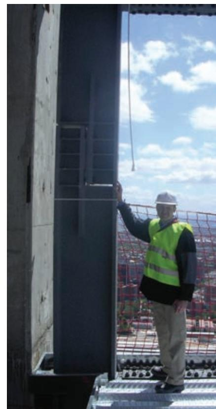
Figura 19. Columna adyacente al núcleo.
