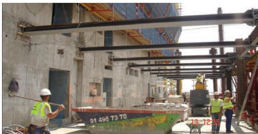
Figura 11. Vigas de soporte del forjado.
