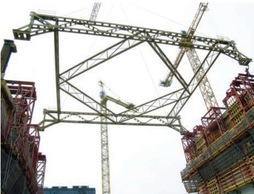
Figura 23. Escantillón para replanteo de pilares embebidos. Figure 23. Template for staking out embedded columns.
