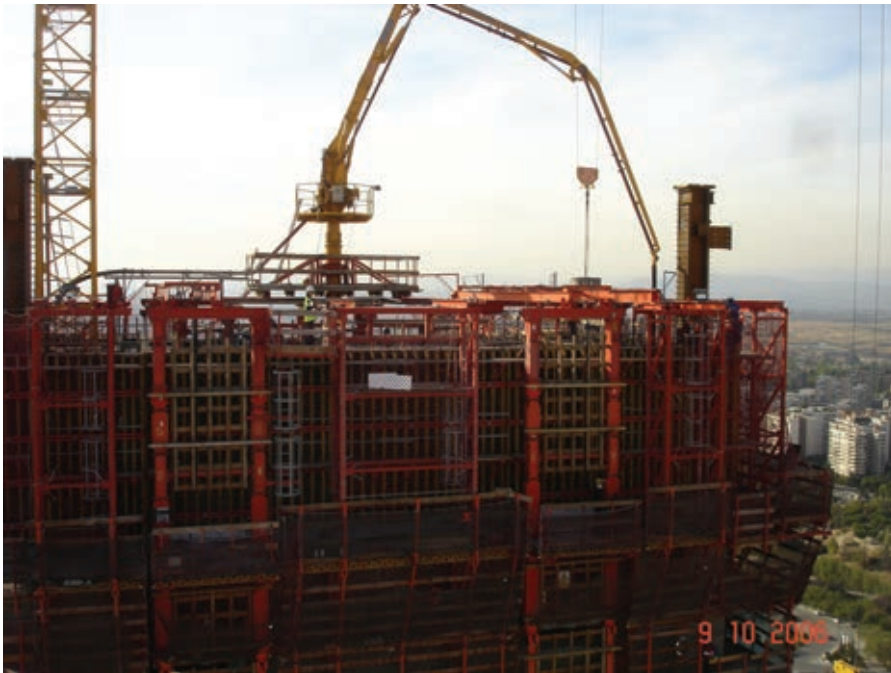
Figura 7. Distribuidor de hormigón. Figure 7. Concrete distributor.
