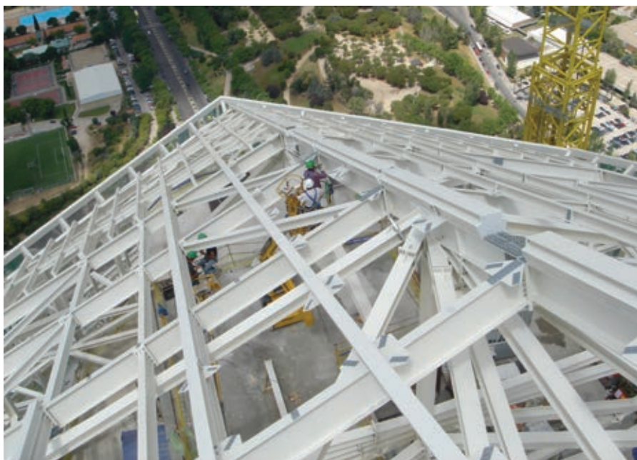
Figura 27. Vista superior de la Cubierta. Figure 27. Upper view of the roof.
