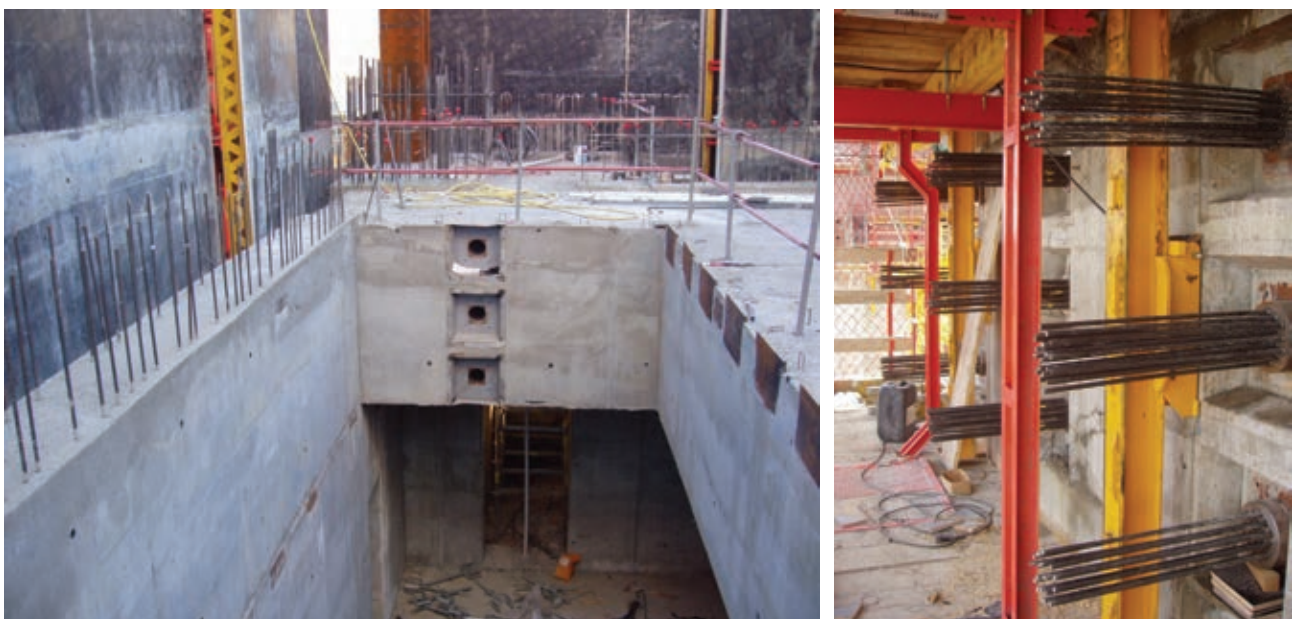
Figura 18. Losa desencofrada. Vista antes y después del tesado de cables. Figure 18. Stripped slab. View before and after cable tensioning.
