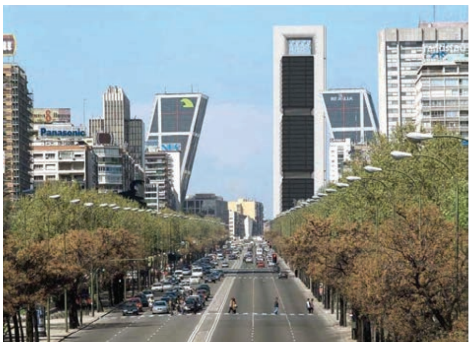
Figura 4 Vista del edificio desde el Paseo de la Castellana (Sur). Figure 4. View of the building from Paseo de la Castellana (South).
