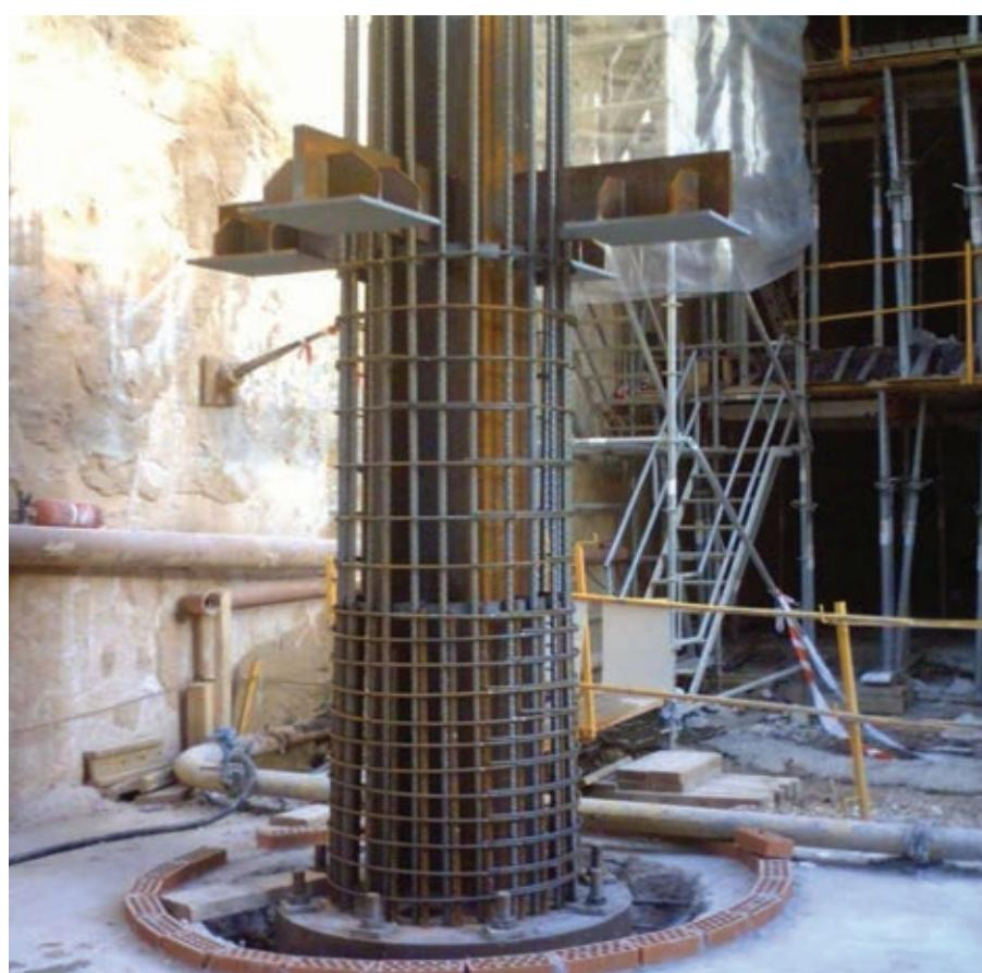
Figura 16. Detalle del pilar mixto en el arranque.
