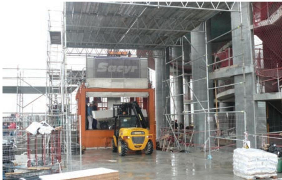
Figura 18. Muelle de carga de los montacargas.
