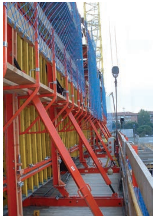
Figura 9. Encofrado autotrepante. Figure 9. Slipforms.
