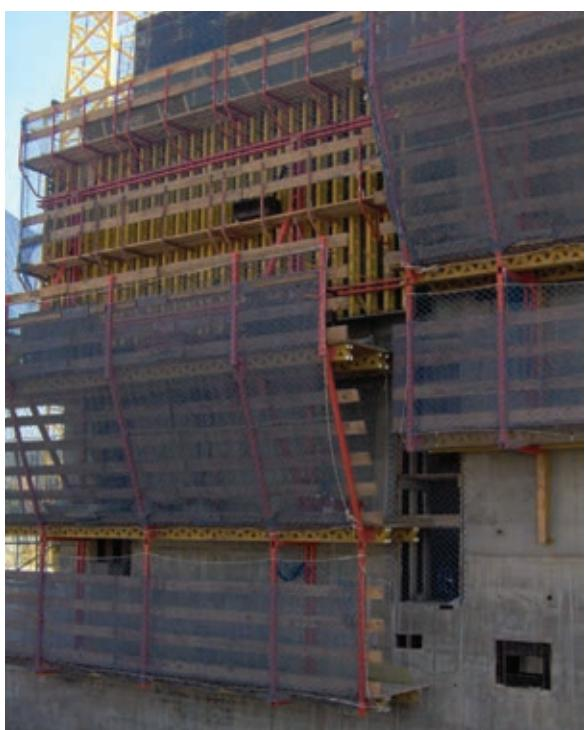
Figura 8. Encofrado autotrepante.
