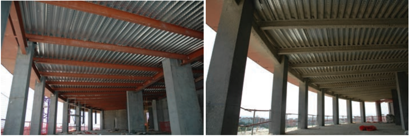
Figura 28. Vista inferior de un forjado tipo antes y después de aplicar la protección ignífuga a las vigas y viguetas. Figure 28. Bottom view of a standard slab before and after the application of the fire protection on the beams and joists.
