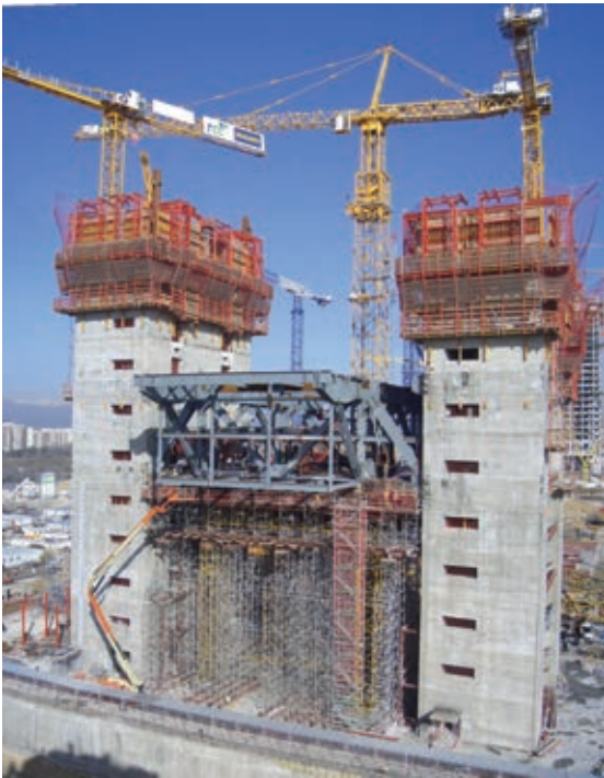
Figura 23. Cercha de transferencia del primer nivel próxima a su finalización. Figure 23. First transfer truss level nears completion.
