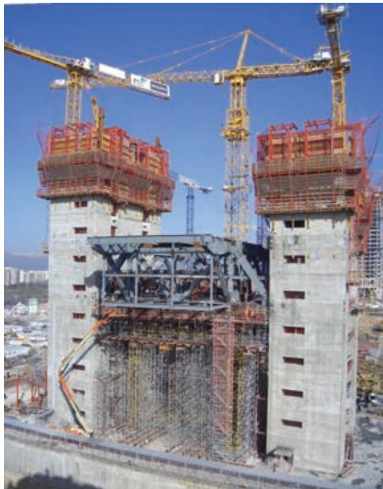
Figura 23. Cercha de transferencia del primer nivel próxima a su finalización.
