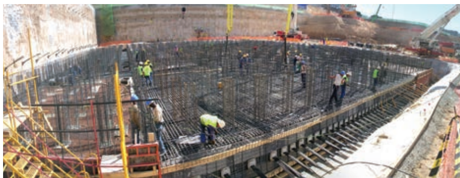
Figura 4. Imagen general de la losa de cimentación con los grupos de armadura de cortante y los anclajes de pretensado.
