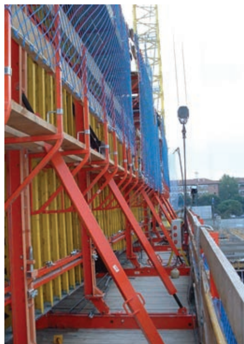
Figura 9. Encofrado autotrepante. Figure 9. Slipforms.
