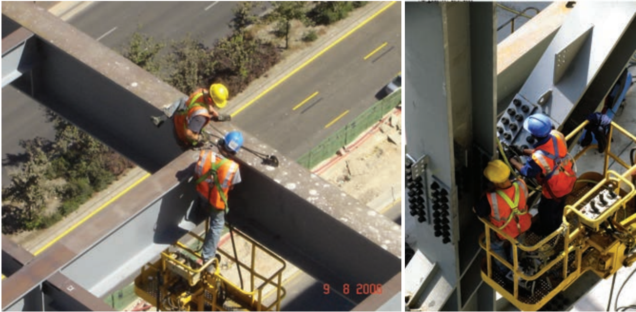
Figura 21. Apriete de uniones atornilladas. Figure 21. Tightening bolted joints.
