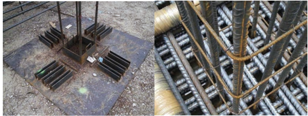
Figura 2. Disposición de armado de torretas de cortante y plantilla de armado. Detalle de paso de armado longitudinal inferior entre las barras verticales de las torretas de cortante, en zona de solapo.
