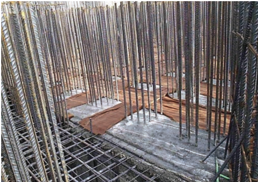
Figura 7. Vista de mantas húmedas para el curado de la losa de cimentación. Figure 7. View of the damp burlap for the curing of the basemat.
