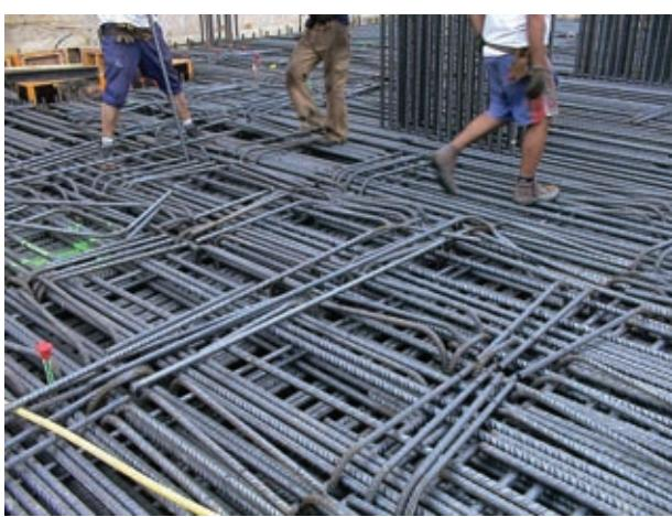
Figura 8. Arranque de soportes de torre y cierre de torretas de cortante.
