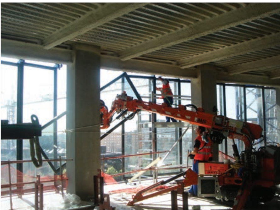
Figura 14. Montaje de los paneles de la fachada desde el interior del edificio. Figure 14. Assembly of the façade panels from the inside of the building.
