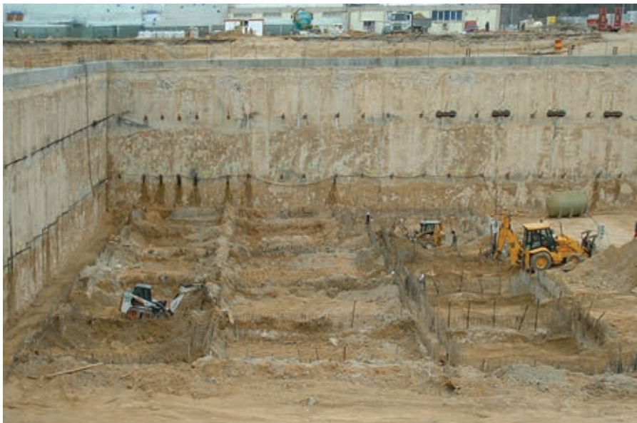
Figura 2. Excavación y muro pantalla. Figure 2. Excavation and diaphragm wall.
