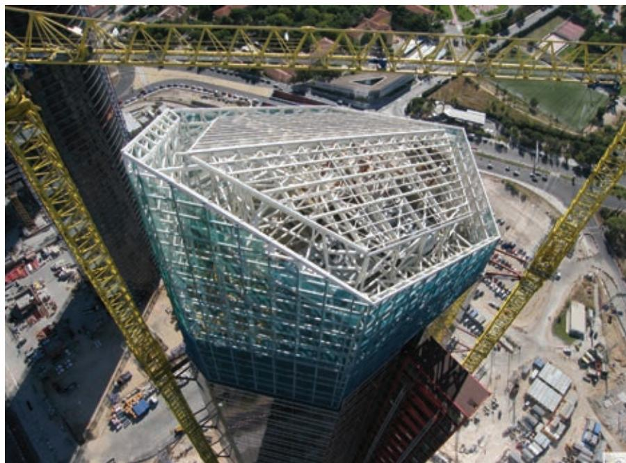
Figura 13. Estructura metálica de coronación.
