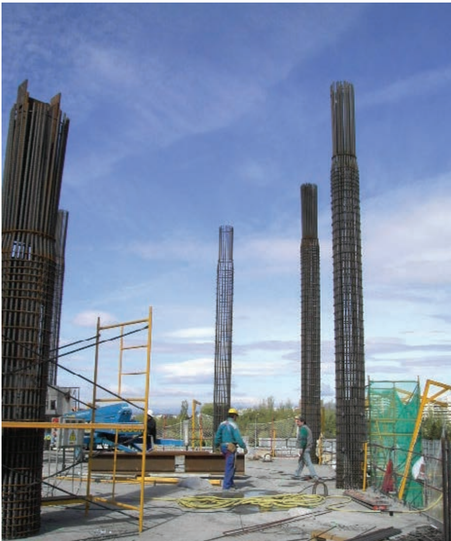
Figura 4. Montaje de armadura de pilares en entreplanta 2, Torre Espacio. Figure 4. Assembling pillar reinforcement in mezzanine 2, Torre Espacio.
