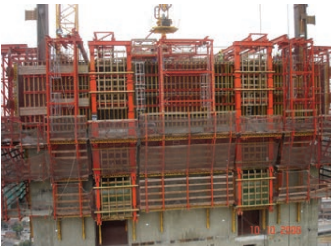
Figura 12. Estructura del encofrado autotrepante Figure 12. Slipform structure.
