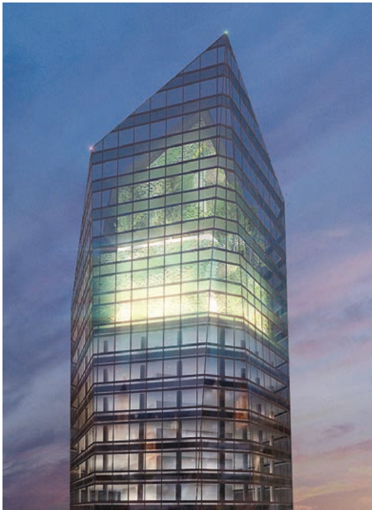
Figura 3. Aspecto exterior del jardín de invierno. Figure 3. Winter garden exterior aspect.
