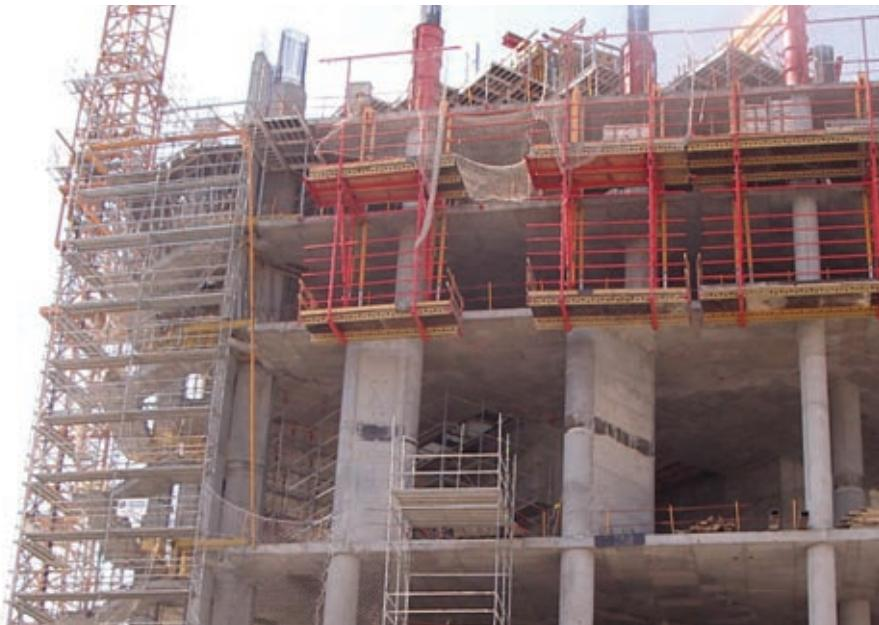
Figura 20. Bloques de desvío de soportes.
