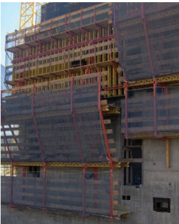
Figura 8. Encofrado autotrepante. Figure 8. Slipforms.
