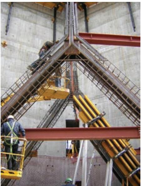
Figura 14. Montaje de la triangulación de la estructura de apeo de soportes.
