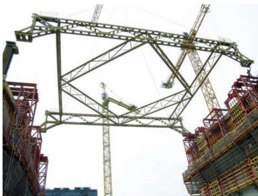
Figura 23. Escantillón para replanteo de pilares embebidos.
