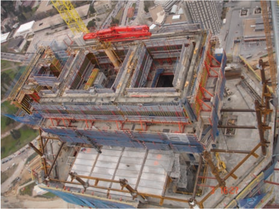
Figura 10. Vista general de núcleo y forjados de oficinas. Figure 10. General view of core and office floor slabs.
