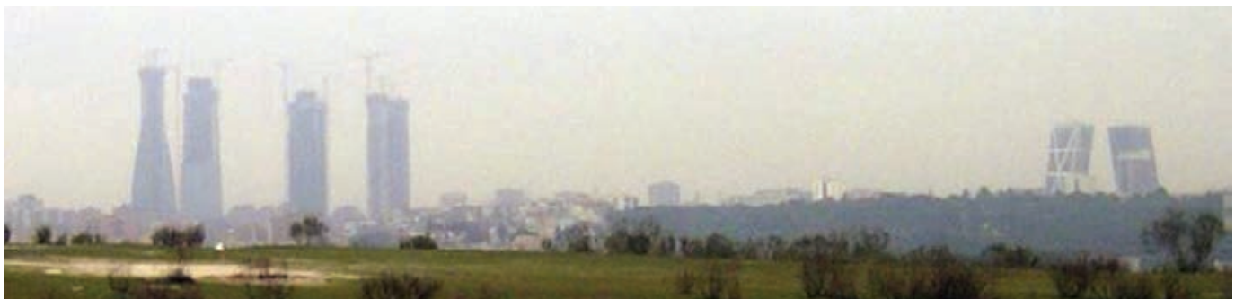
Figura 3. Imagen del avance de la construcción y su irrupción progresiva en el "skyline" de la ciudad. Figure 3. Image of the progress of the work and its growing presence in the city's skyline.
