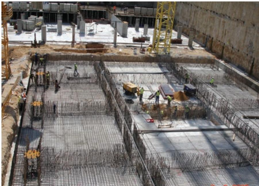
Figura 7. Armado de la losa de cimentación.
