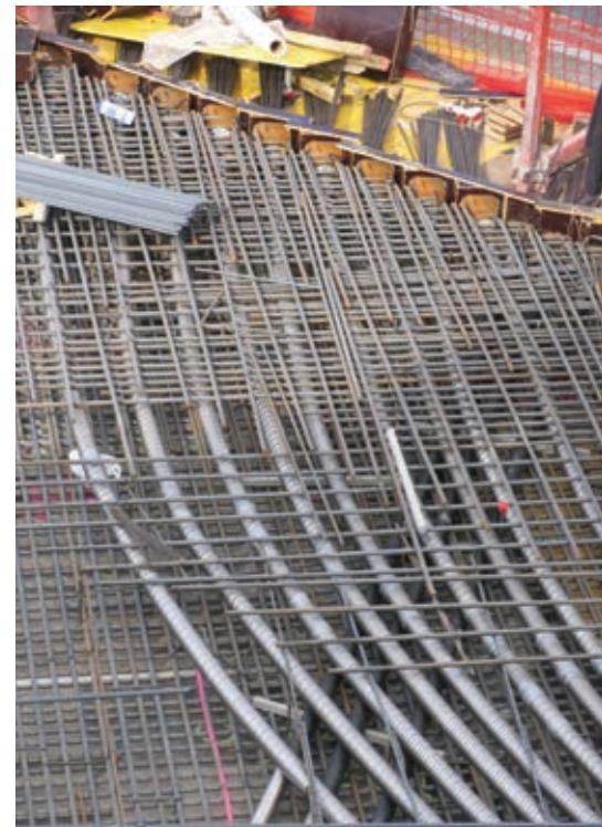
Figura 11. Distribución de cables de pretensado en los forjados del cinturón de rigidez, incluyendo los cables necesarios para los desvíos de soportes (izqda.); detalle con la colocación de los cables y sus anclajes en el forjado (dcha.)
