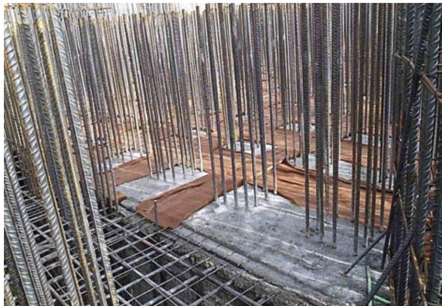
Figura 7. Vista de mantas húmedas para el curado de la losa de cimentación.
