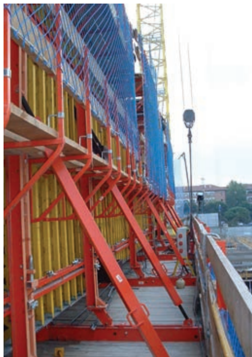
Figura 9. Encofrado autotrepante. Figure 9. Slipforms.
