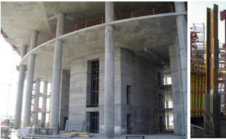
Figura 17. Inclinación de soportes de fachada en la zona media del edificio. Figure 17 . Inclinación of façade supports in the building's mid area
