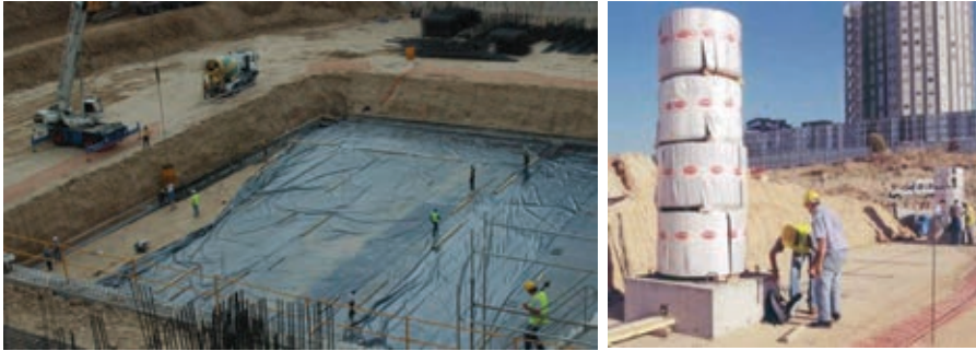
Figura 6. Dispositivos para reducir el rozamiento entre el terreno y la losa de cimentación: colocación de la doble lámina de polietileno (izqda.) y ensayo en verdadera magnitud de su eficacia (dcha.)
