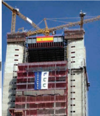
Figura 32. Vistas del arco ya izado a su posición definitiva. Figure 32. Arch in permanent position.
