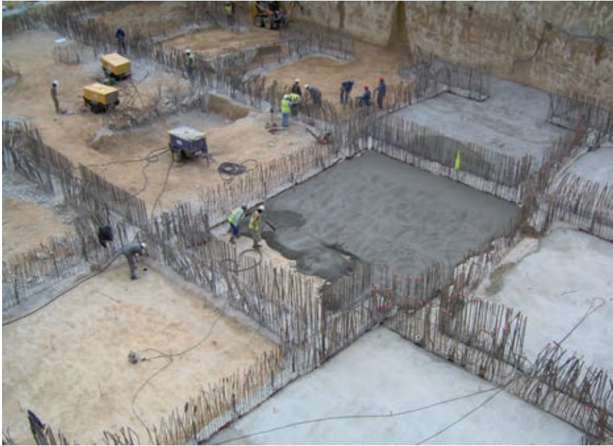
Figura 8. Cimentación. Vista general. Figure 8. Foundations. Overview.
