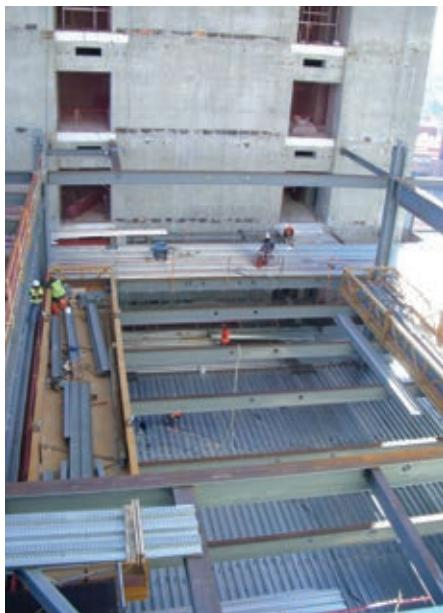
Figura 24. Batea de acopio intermedio en montaje de estructura de plantas.
