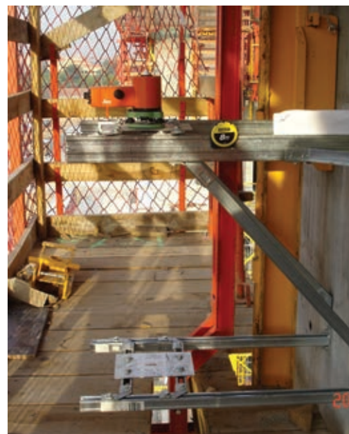
Figura 3. Bases fijas de replanteo. Posición y detalle. Figure 3. Fixed stakes. Position and detail.
