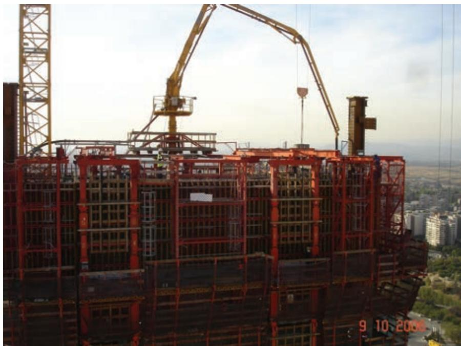
Figura 7. Distribuidor de hormigón.
