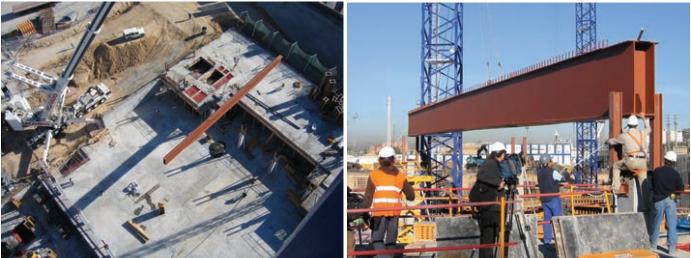
Figura 26. Montaje de las vigas metálicas para el cubrimiento del salón de convenciones. Figure 26. Erection of the steel beams to cover the convention centre.
