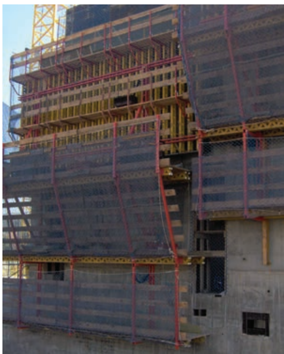
Figura 8. Encofrado autotrepante. Figure 8. Slipforms.
