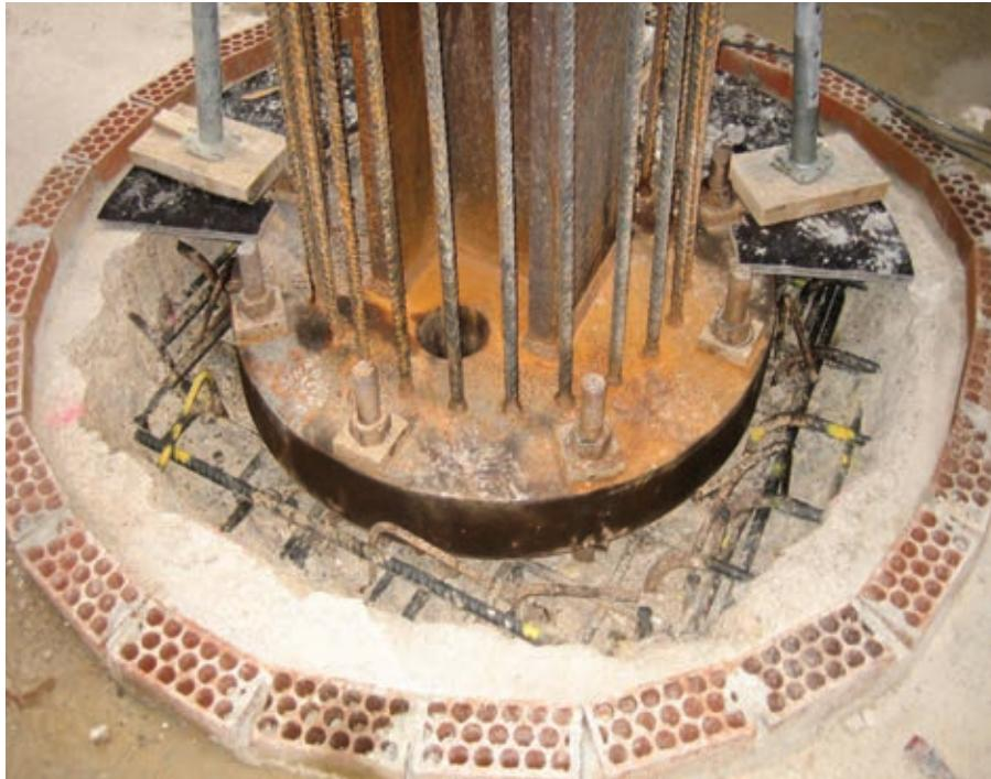
Figura 15. Detalle de la zona a hormigonar bajo placa.
