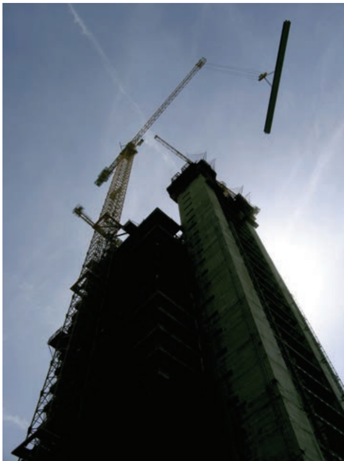
Figura 1. Vista general de construcción Figure 1. General view
