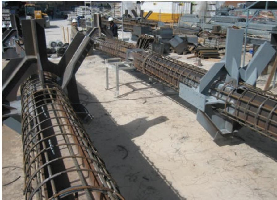
Figura 12. Pilares mixtos farrallados en zona de acopio
