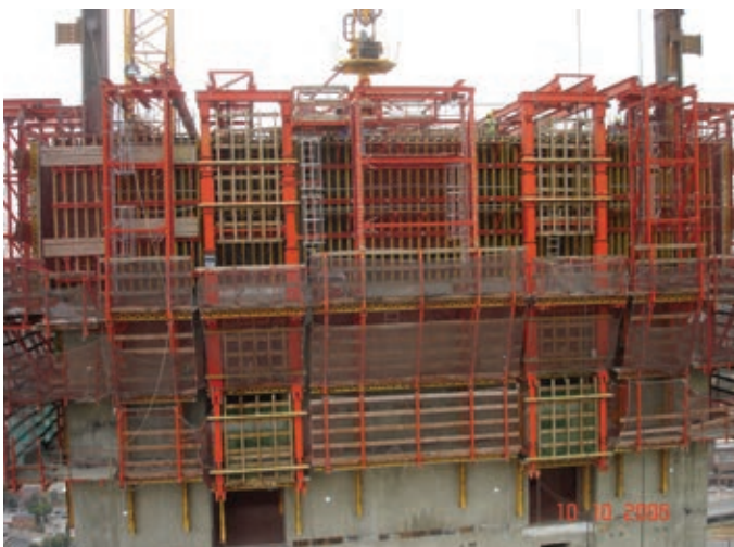
Figura 12. Estructura del encofrado autotrepante Figure 12. Slipform structure.
