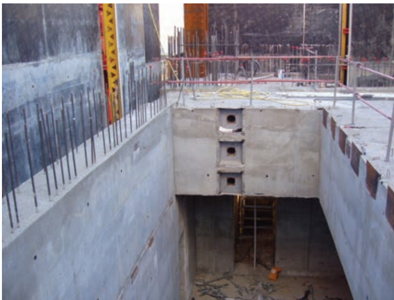
Figura 18. Losa desencofrada. Vista antes y después del tesado de cables. Figure 18. Stripped slab. View before and after cable tensioning.
