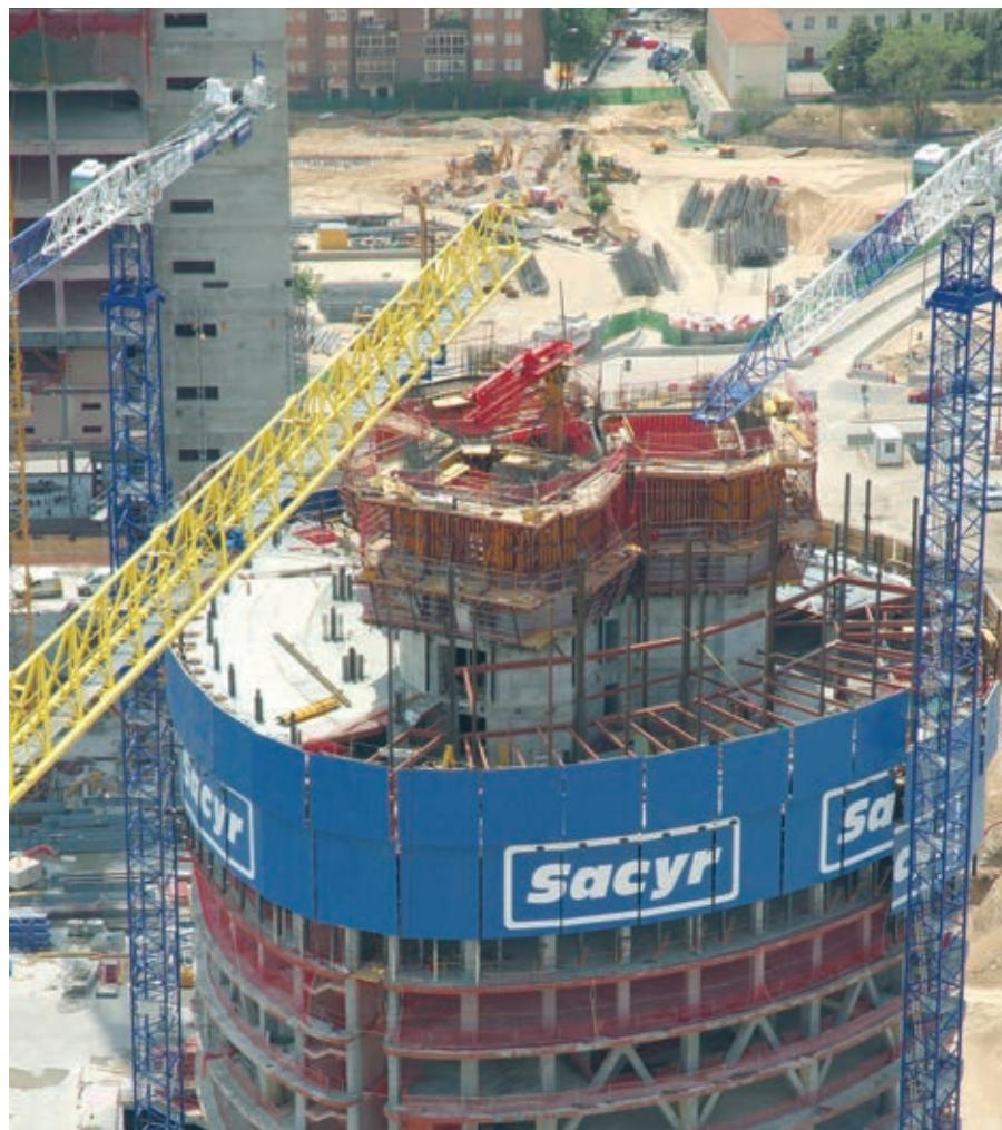
Figura 24. Vista general de la obra en una de las plantas tipo en la que se muestra la superposición de las actividades de construcción del núcleo mediante autorepresa y de la estructura metálica de la planta.
