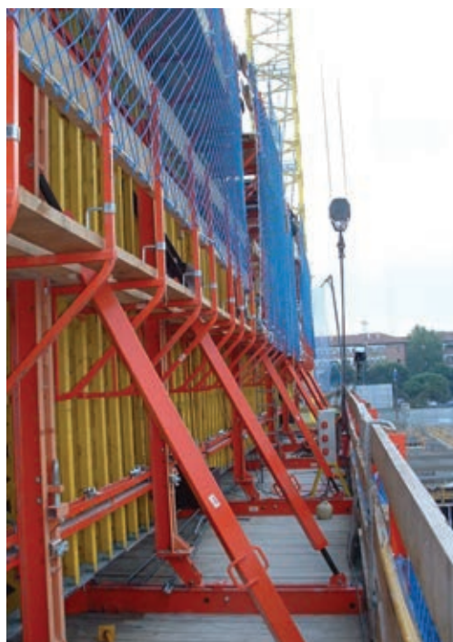
Figura 9. Encofrado autotrepante. Figure 9. Slipforms.
