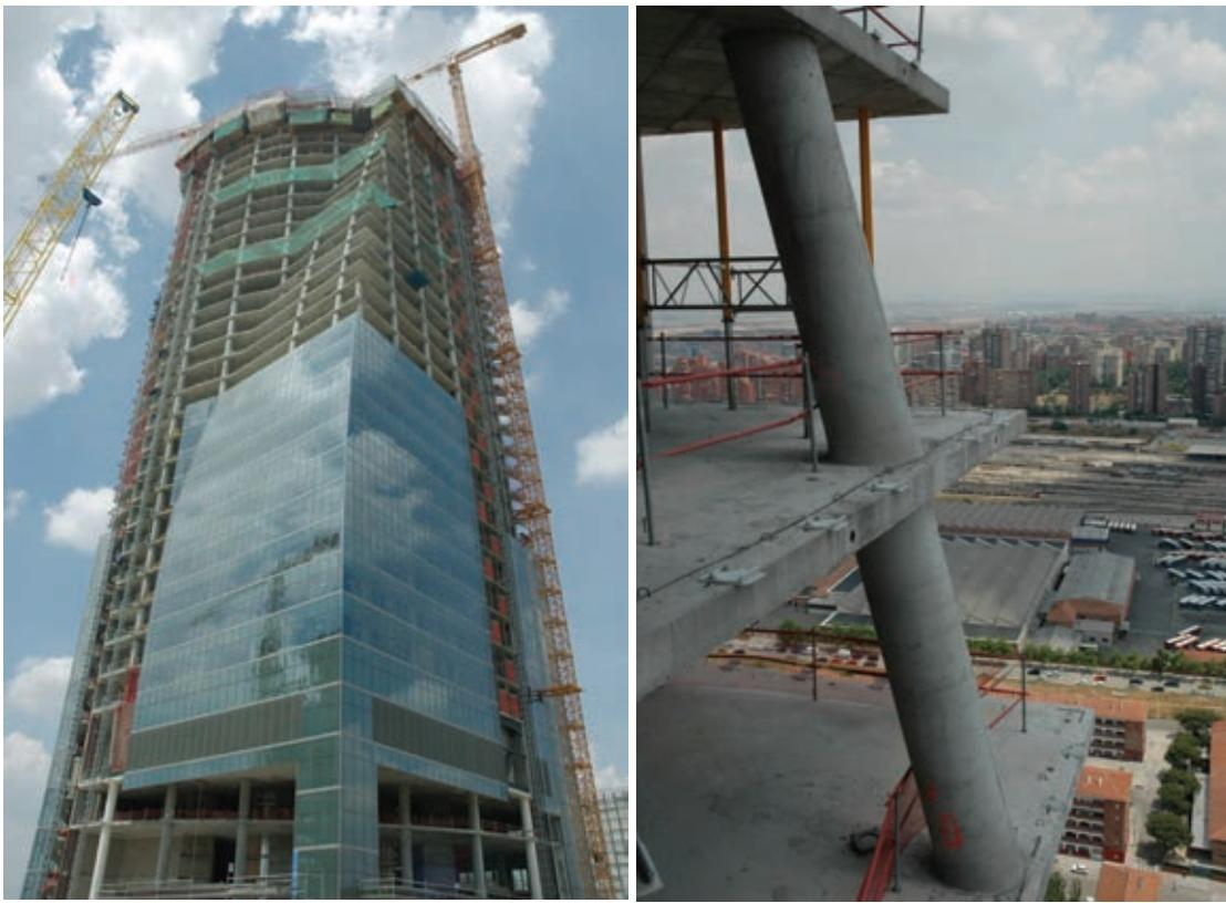
Figura 17. Inclinación de soportes de fachada en la zona media del edificio.
