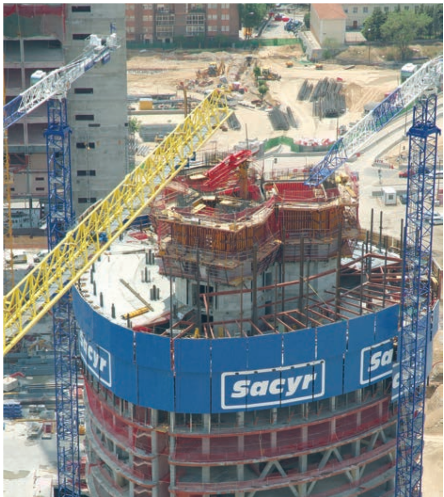
Figura 24. Vista general de la obra en una de las plantas tipo en la que se muestra la superposición de las actividades de construcción del núcleo mediante autotropa y de la estructura metálica de la planta.
