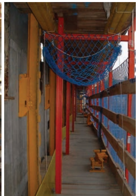
Figuras 12 y 13. Encofrado Autoretente. Figures 12 and 13. Slipforms.
