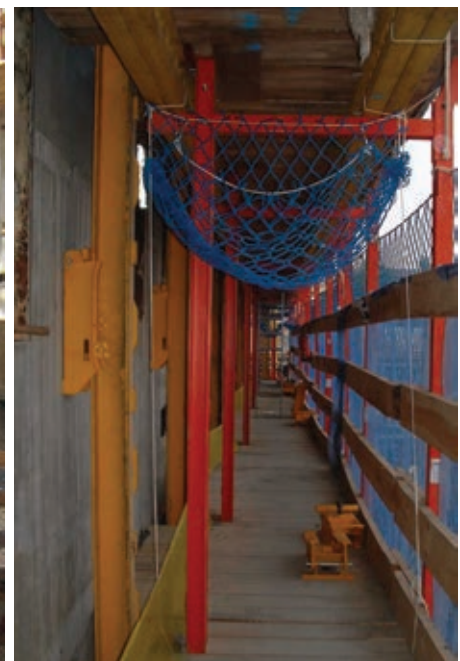
Figuras 12 y 13. Encofrado Autoretrostante. Figures 12 and 13. Slipforms.
