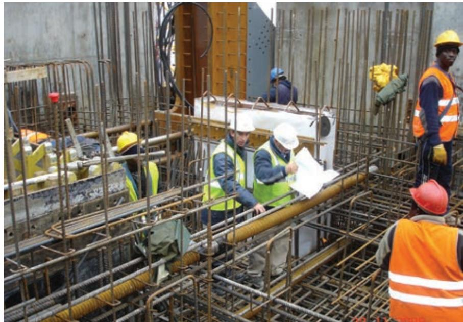
Figura 17. Armadura y vainas de postesado en losa de 1,90 m.
