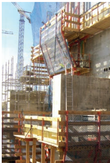
Figuras 12 y 13. Encofrado Autoretrostante. Figures 12 and 13. Slipforms.
