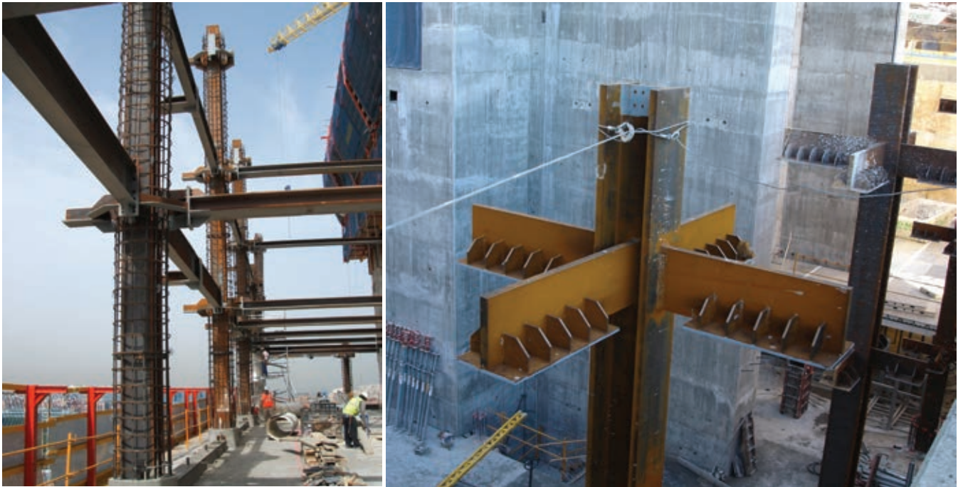
Figuras 14 y 15. Pilares metálicos. Figures 14 and 15. Steel columns.
