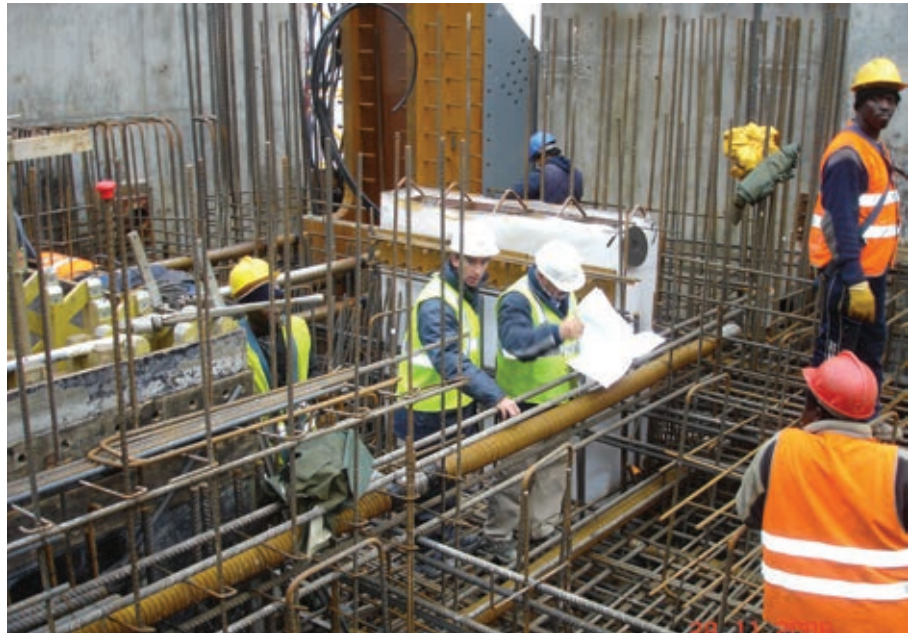
Figura 17. Armadura y vainas de postesado en losa de 1,90 m. Figure 17. Post-tensioned rebar and sheaths in the 1.90-m slab.
