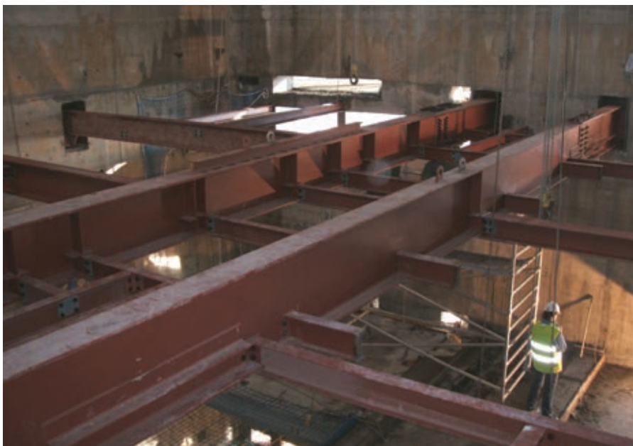
Figura 23. Estructura Interior del núcleo Figure 23. Structure inside the core.
