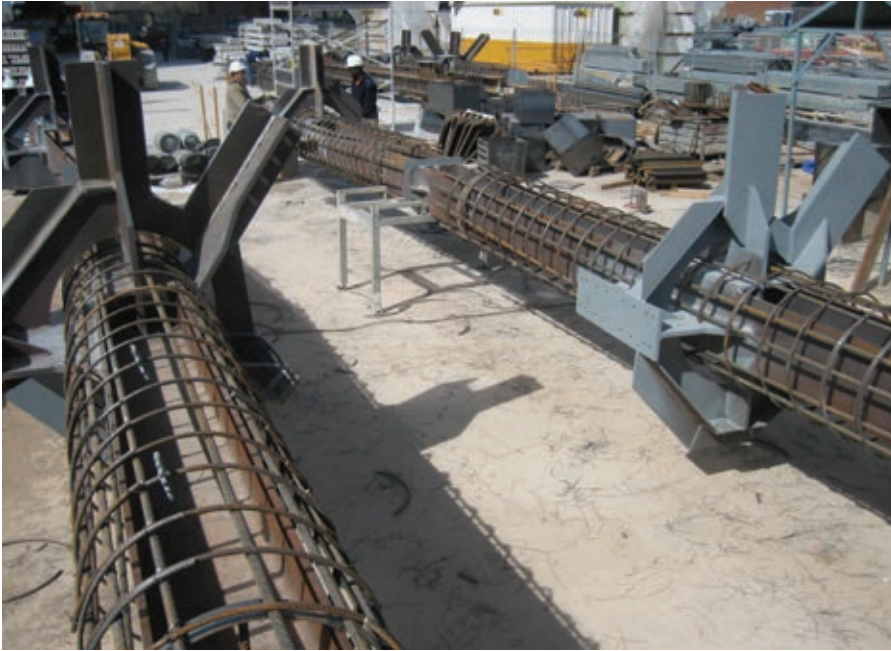
Figura 12. Pilares mixtos ferrallados en zona de acopio Figure 12. Composite columns wrapped in reinforcing steel.
