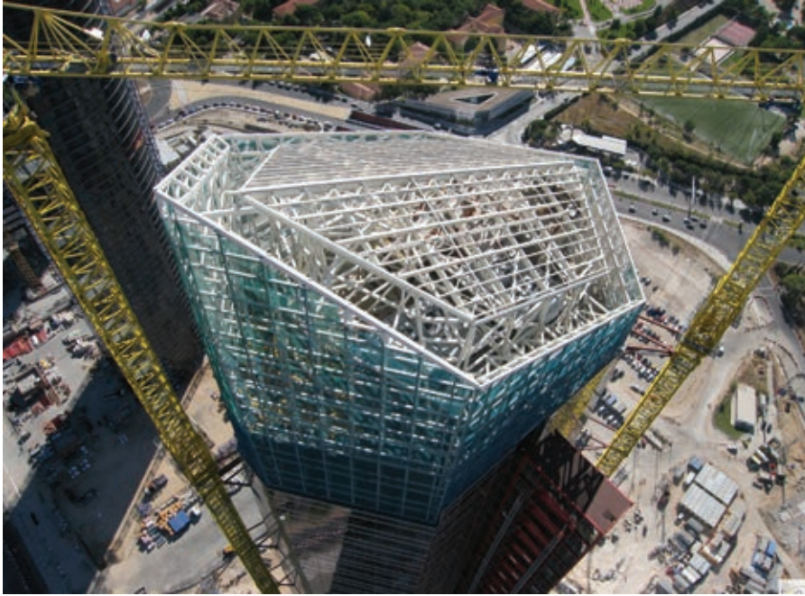
Figura 13. Estructura metálica de coronación. Figure 13. Steel crown structure.
