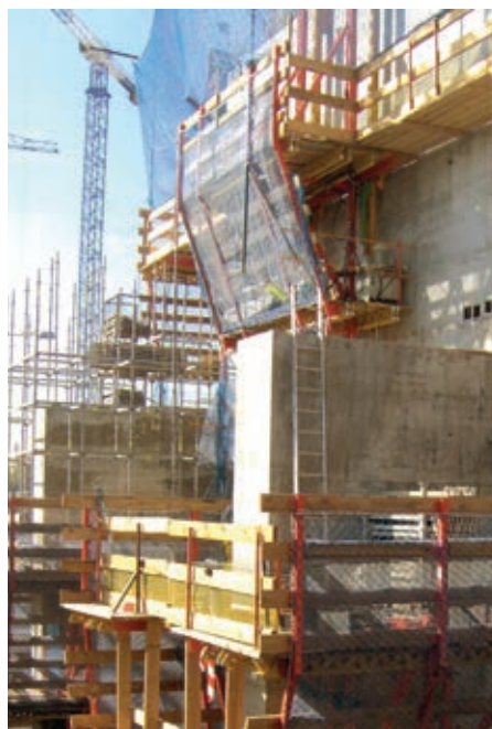
Figuras 12 y 13. Encofrado Autoretente. Figures 12 and 13. Slipforms.
