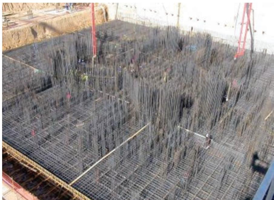
Figura 1. Vista general del ferrallado de la primera tongada.
