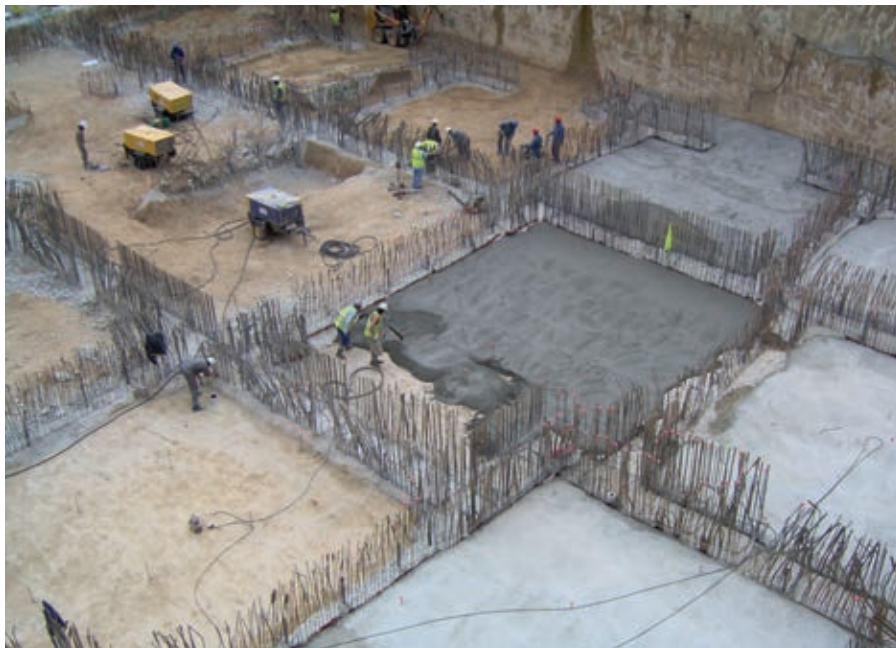
Figura 8. Cimentación. Vista general. Figure 8. Foundations. Overview.
