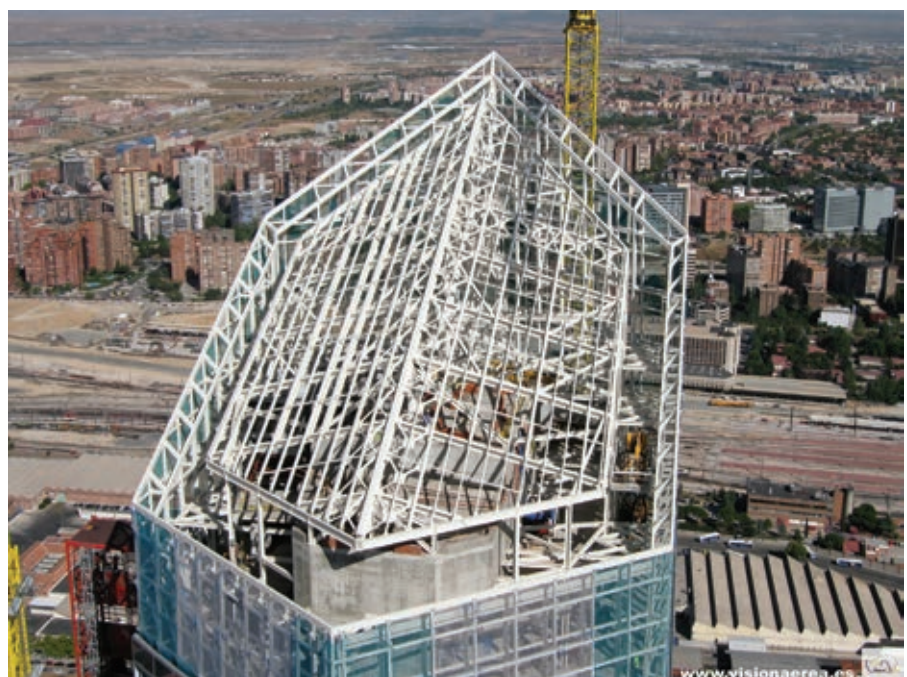
Figura 25. Cubierta. Vista general. Figure 25. Roof. Overview.
