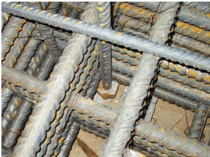
Figura 10. Terminal mecánico de anclaje en barra de cortante.
