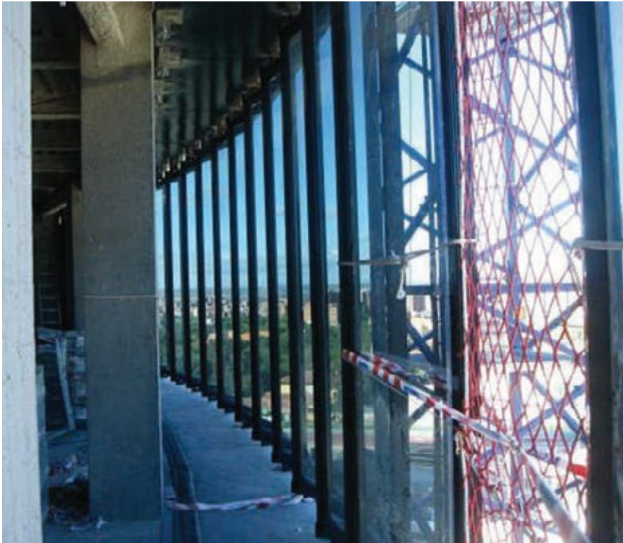
Figura 12. Espacio comprendido entre las fachadas interior y exterior. Figure 12. Gap between the inner and outer façades.
