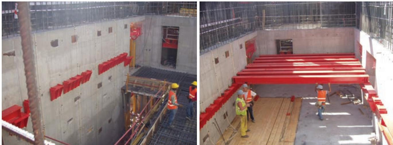
Figura 15. Estructura soporte del encofrado de losa de 1,90 m.
