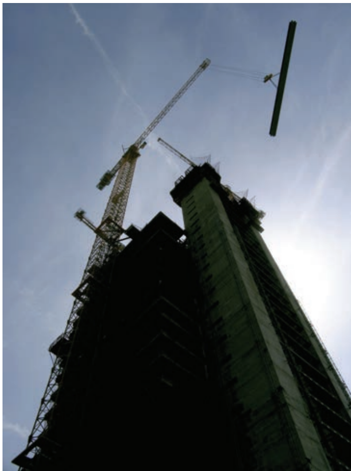
Figura 1. Vista general de construcción Figure 1. General view
