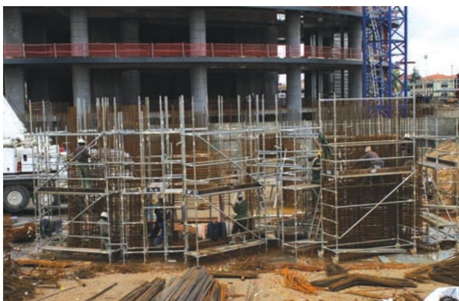
Figura 11. Vista de taller de ferralla con despiece de armado de núcleos.
