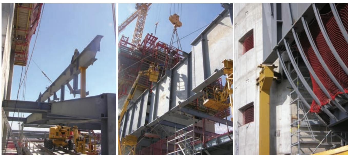
Figura 25. Fases de montaje de las jácenas y la estructura del arco.
