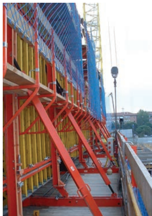
Figura 9. Encofrado autotrepante. Figure 9. Slipforms.
