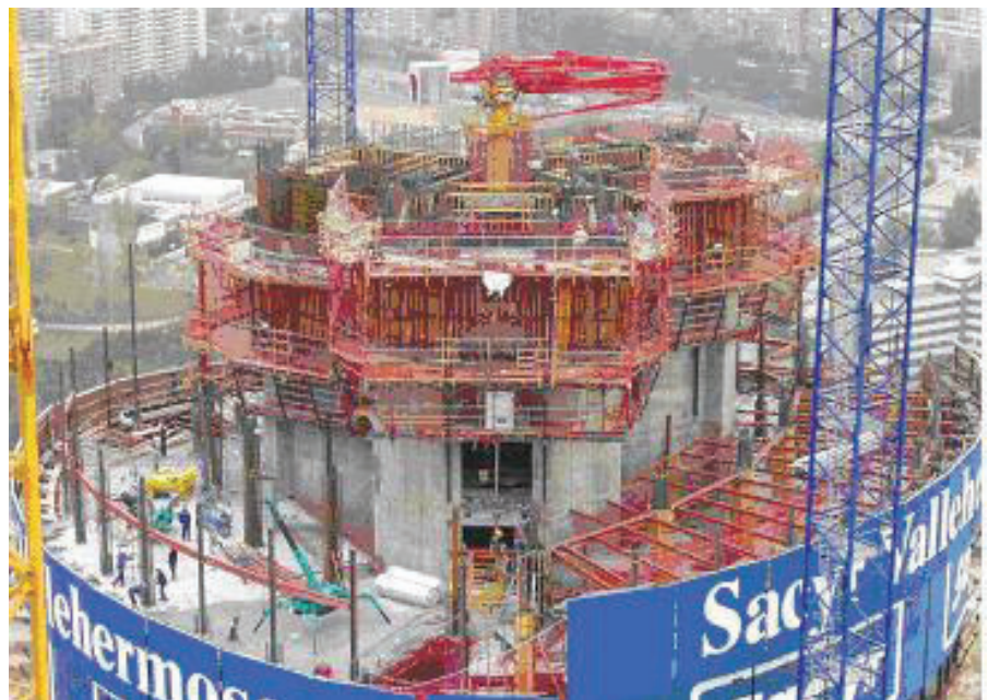
Figura 21. Ejecución de los forjados. Figure 21. Execution of the slabs.
