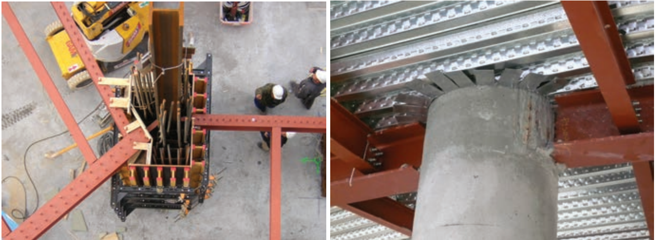
Figura 20. Preparación de las cabezas de encofrados para salvar las vigas. Figure 20. Preparation of the formwork caps to avoid the beams.
