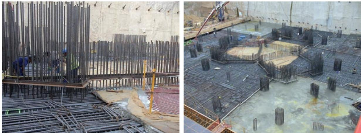
Figura 9. Plantilla de colocación de armado de núcleo y vista general del hormigonado de la segunda tongada de losa.
