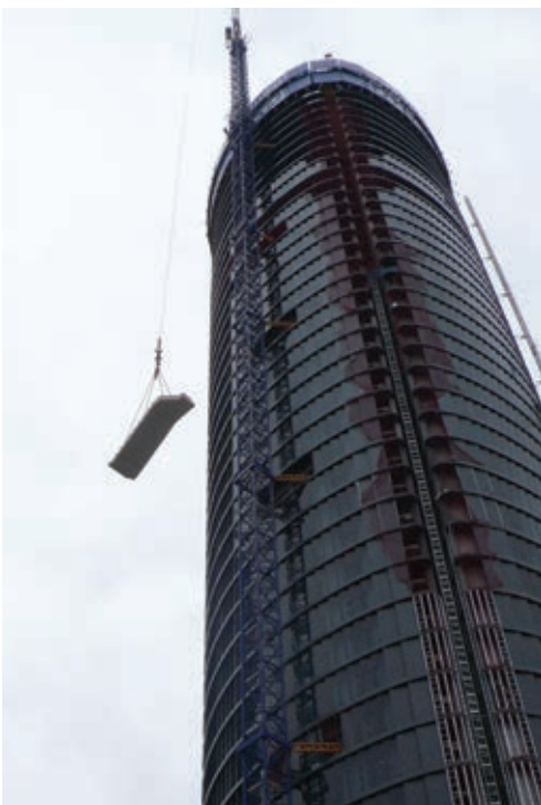
Figura 17. Grúa torre montando escaleras. Figure 17 Tower crane assembling staircases.
