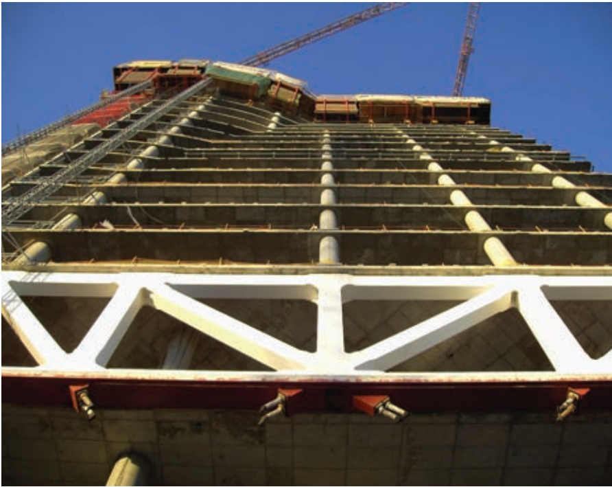
Figura 6. Viga cargadero 2 (fachada sur) de Torre Espacio. Figure 6. Torre Espacio's load bearing beam 2 (south façade).
