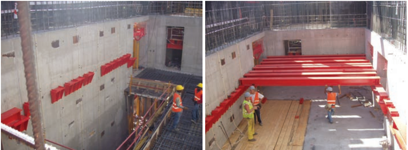
Figura 15. Estructura soporte del encofrado de losa de 1,90 m. Figure 15. Shoring for the 1.90-slab formwork.
