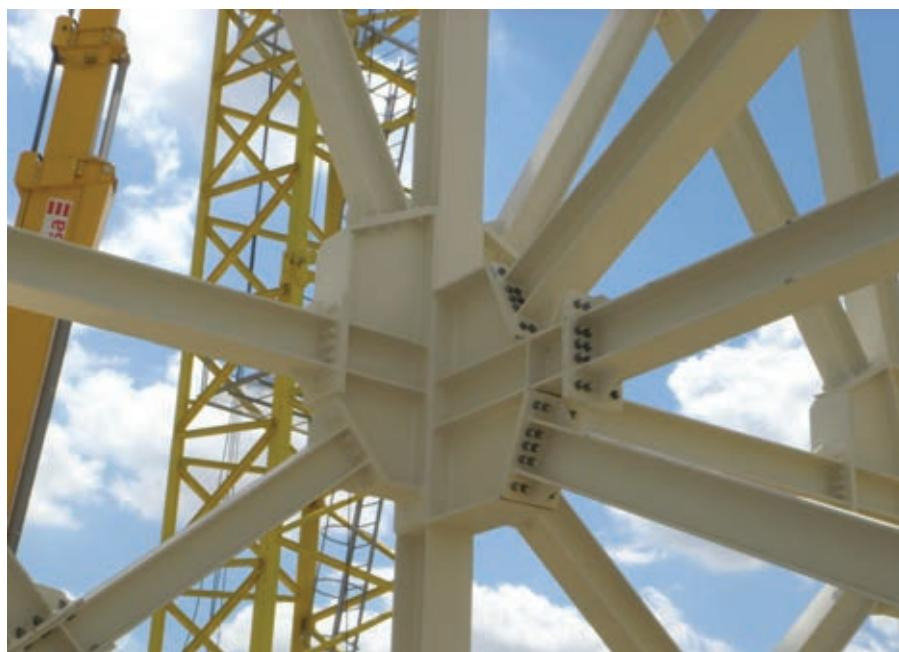
Figura 14. Nudo atornillado en la estructura de coronación.
