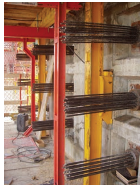
Figura 18. Losa desencofrada. Vista antes y después del tesado de cables. Figure 18. Stripped slab. View before and after cable tensioning.
