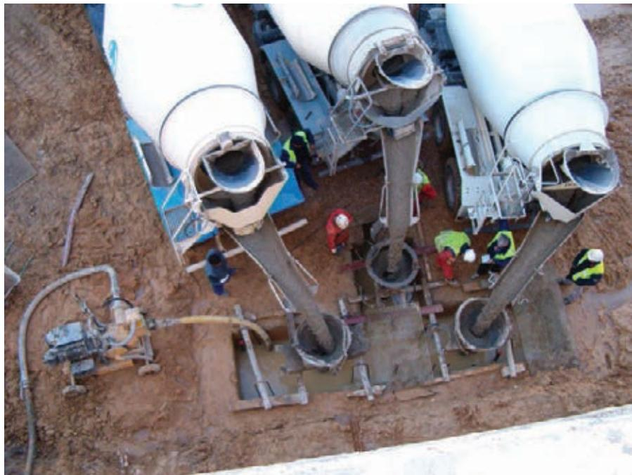
Figura 6. Hormigonado de pantallas con tubo tremi y tres camiones hormigonera.
