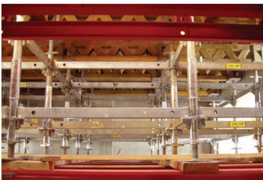
Figura 16. Cimbra de apoyo del encofrado.
