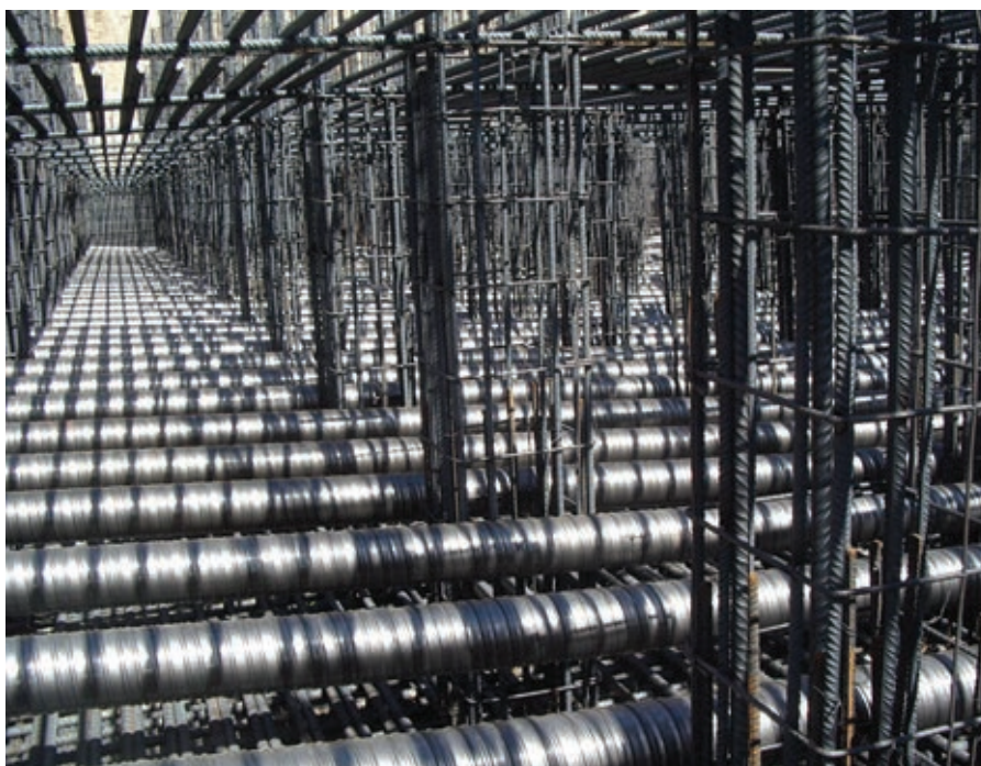
Figura 2. Tendones de postensado en losa de cimentación de Torre Espacio. Figure 2. Post-stressing tendons in the Torre Espacio foundation slab.
