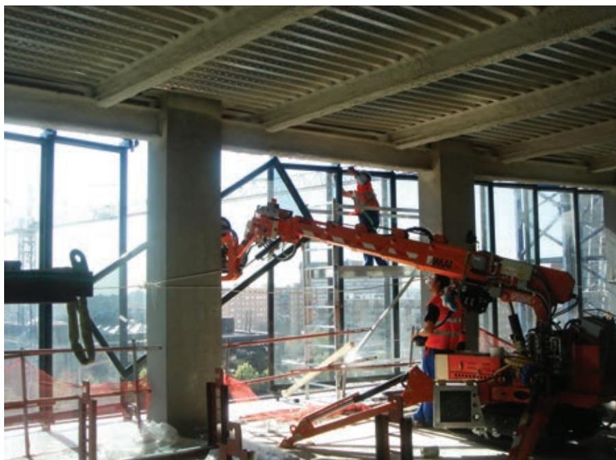
Figura 14. Montaje de los paneles de la fachada desde el interior del edificio.
