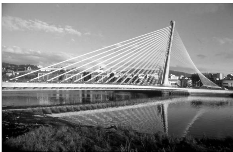
Puente del Léz (Pontevedra).
