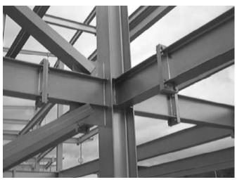
Figura 6. Detalles de las conexiones.
