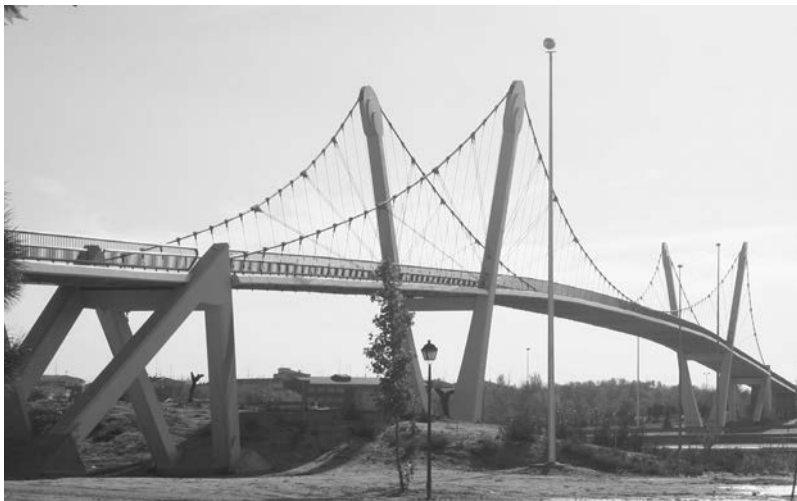
Puente colgante sobre la R-3 (Madrid).
