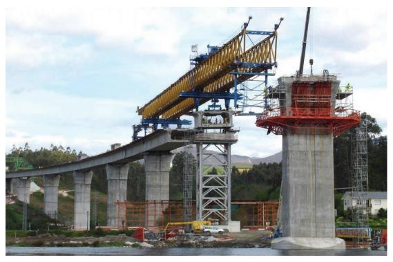
Figura 17. Montaje de dovelas. Figure 17. Segment assembly.
