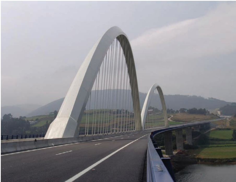
Figura 24. Viaducto terminado. Figure 24. Finished viaduct.
