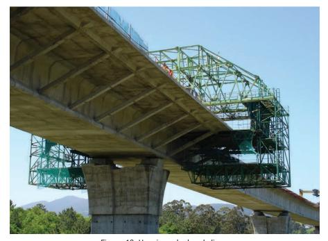
Figura. 18. Hormigonado de voladizos. *Figure 18. Cantilever casting.*
