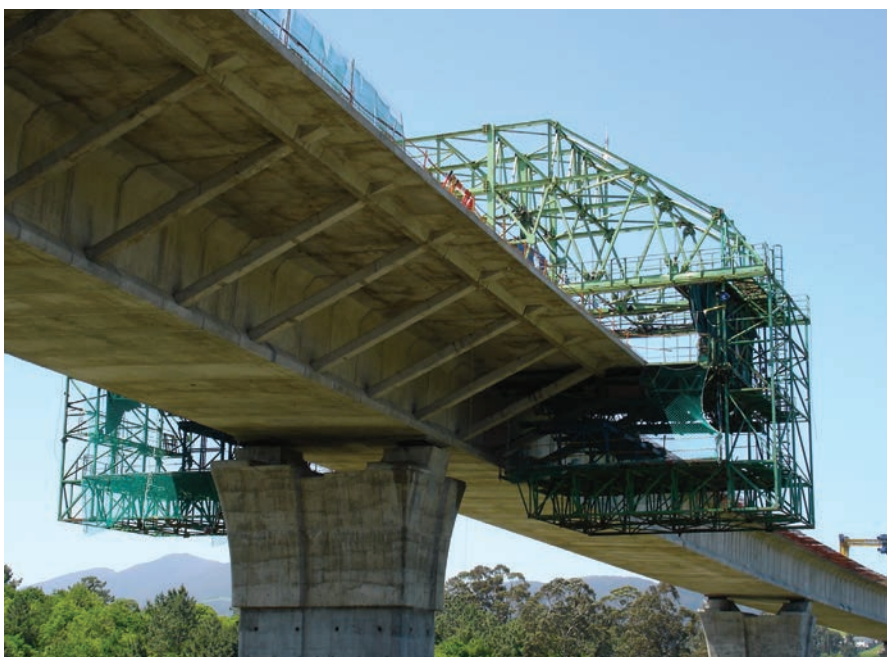
Figura 18. Hormigonado de voladizos. Figure 18. Cantilever casting.
