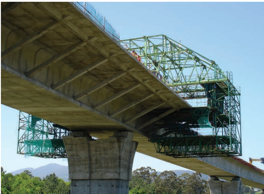
Figura 18. Hormigonado de voladizos. Figure 18. Cantilever casting.
