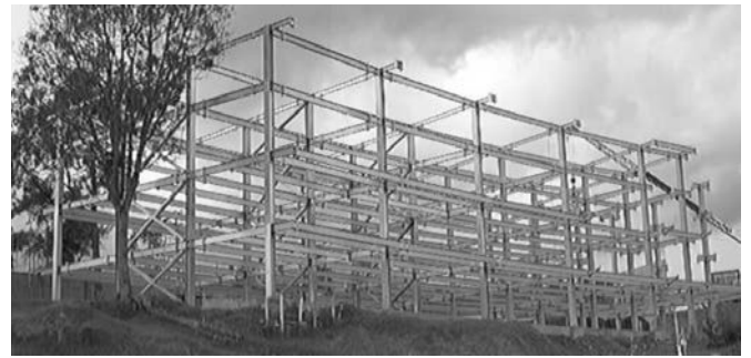
Figura 4. Edificio en etapa de construcción.
