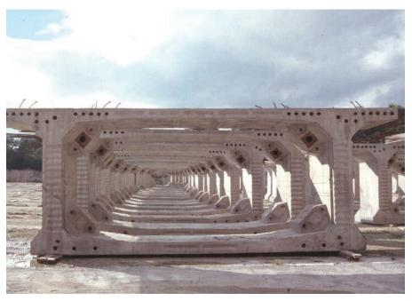
Figura 8. Dovela vanos acceso. Figure 8. Approach span segments.
