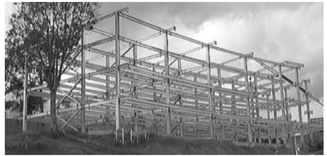
Figura 4. Edificio en etapa de construcción.
