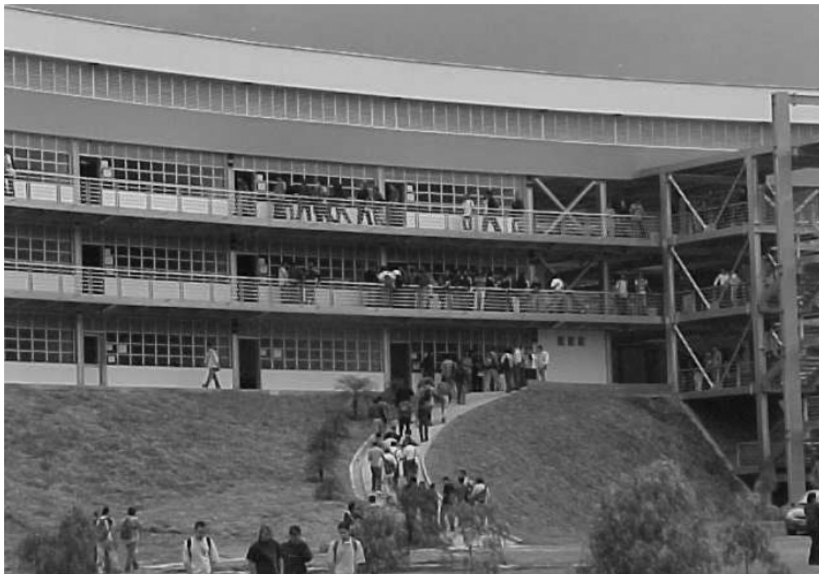
Figura 7. Edificio de aulas de la Universidad Nacional de Colombia, sede Manizales.
