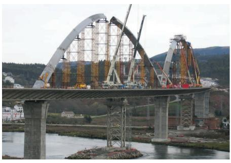
Figura 19. Montaje de arcos. *Figure 19. Arch assembly.*
