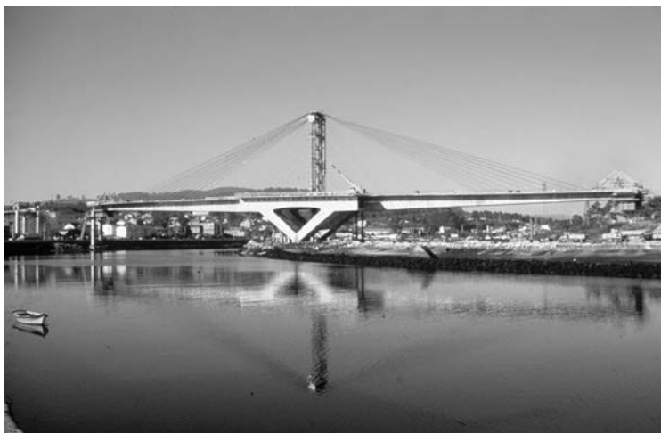
Puente de la Autopista del Atlántico sobre la ría de Pontevedra en construcción.
