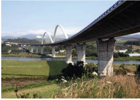
Foto de portada: Viaducto de Navia.
