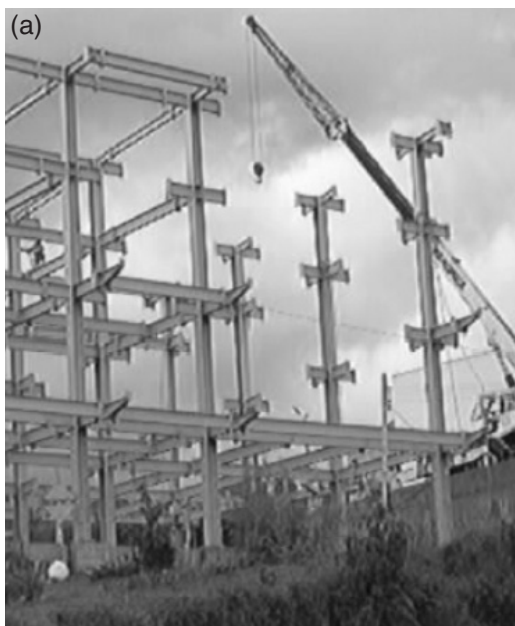
Figura 5. Aspecto del montaje del edificio y detalle de las columnas.
