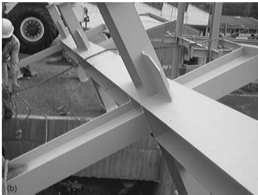
Figura 5. Aspecto del montaje del edificio y detalle de las columnas.
