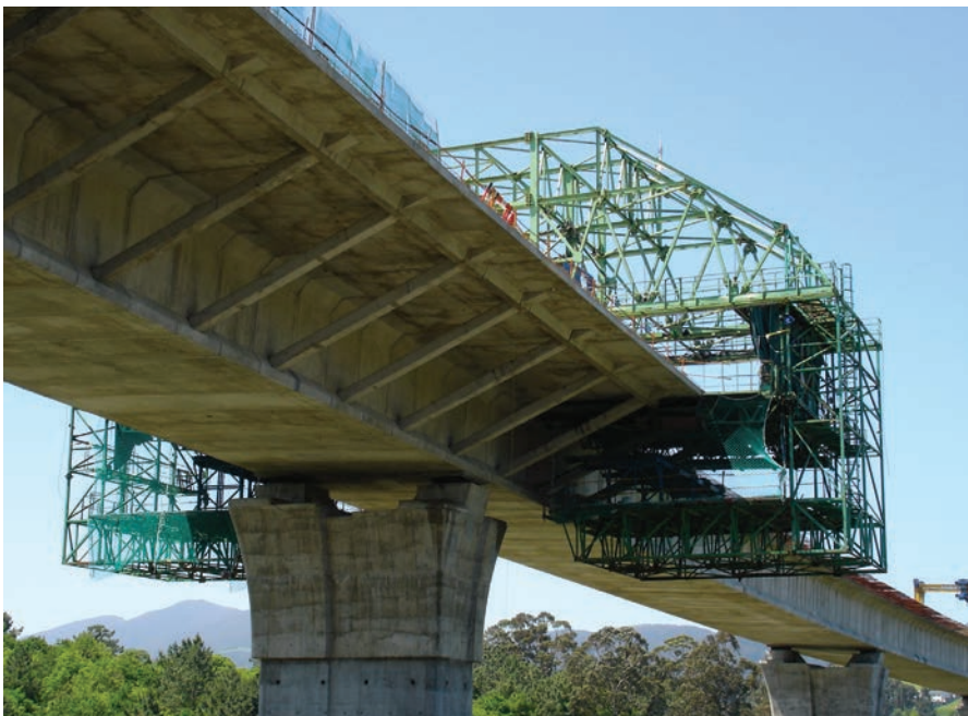
Figura 18. Hormigonado de voladizos. Figure 18. Cantilever casting.
