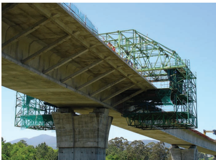
Figura. 18. Hormigonado de voladizos. Figure 18. Cantilever casting.
