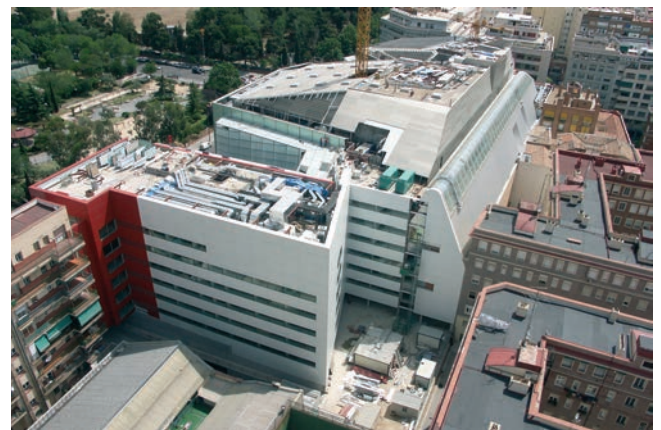
Figura 43. Vista lateral del edificio. Figure 43. Lateral view.
