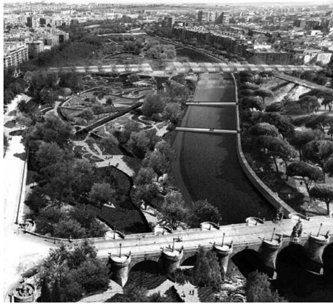
Dominique Perrault-MC2. Pasarela de la Arganzuela . Madrid.
