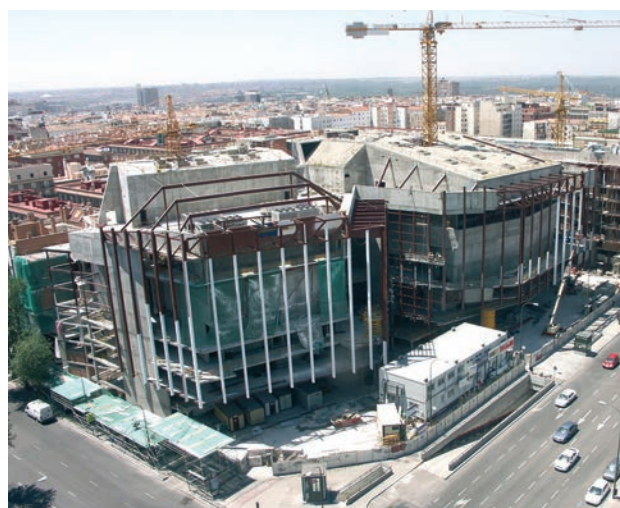
Figura 36. Construcción de la estructura de fachadas. Figure 36. Façade structure construction.
