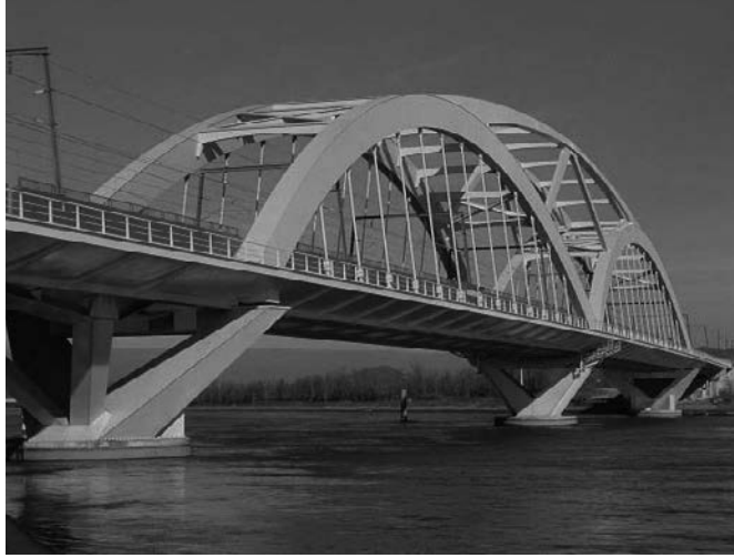
Marc Minram (Arq) Bureau Greisch. Puente de Garde-Adhemar. TGV Sud. Francia, 2000.
