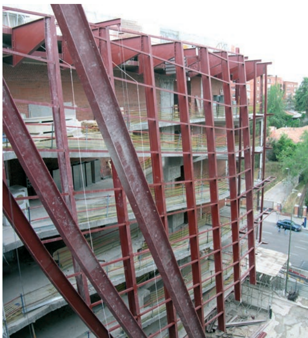
Figura 28. Estructura metálica de fachada colgada desde ménsulas en el espacio entre el Centro Coreográfico y el Teatro Principal. Figure 28. Upper façades steel structure hung from cantilevers between the Choreographic Centre and the Main Theatre.
