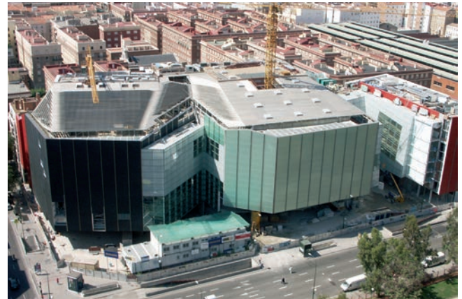
Figura 42. Vista frontal del edificio en sus últimas fases de construcción Figure 42. Frontal view of the building in its final phase of construction.
