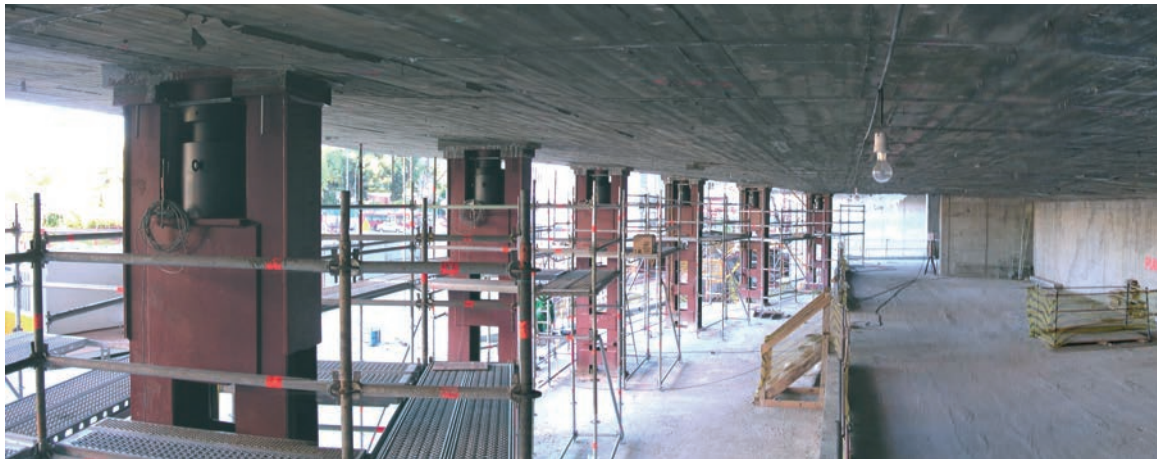
Figura 38. Apeos del Teatro principal con los gatos de desapeo colocados.
