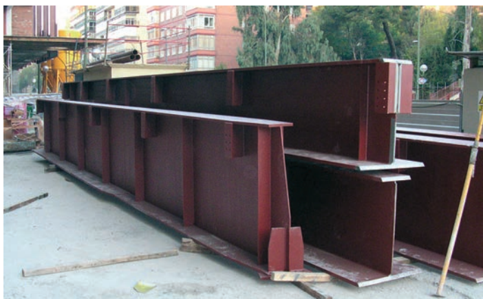
Figura 14. Vista de las vigas previamente al montaje y colocadas en su posición definitiva. Figure 14. View of the steel beams previously to assembling and in their definitive position.
