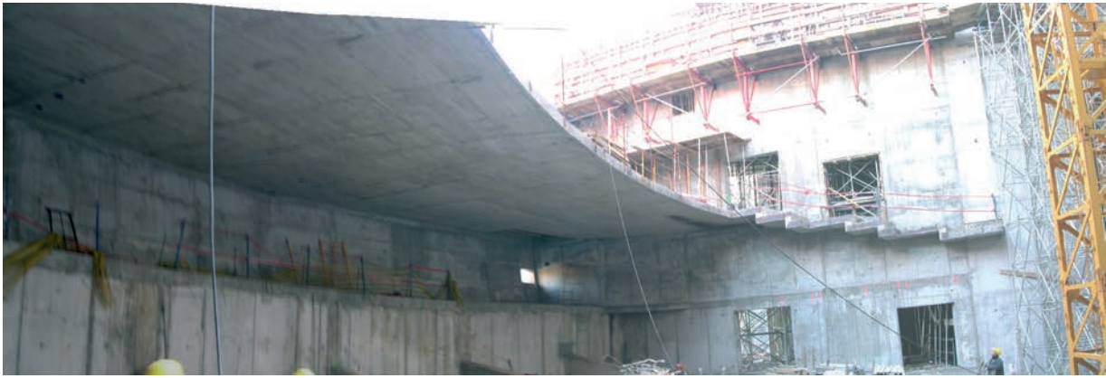
Figura 12. Vista inferior del sistema estructural que conforma el anfiteatro Figure 12. Amphitheatre structure lower view.
