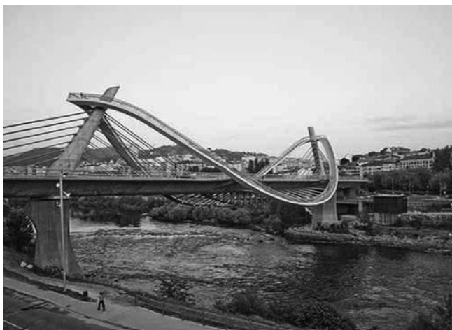
Álvaro Varela de Ugarte (Arq.) Puente del Milenio. Orense, 2001.
