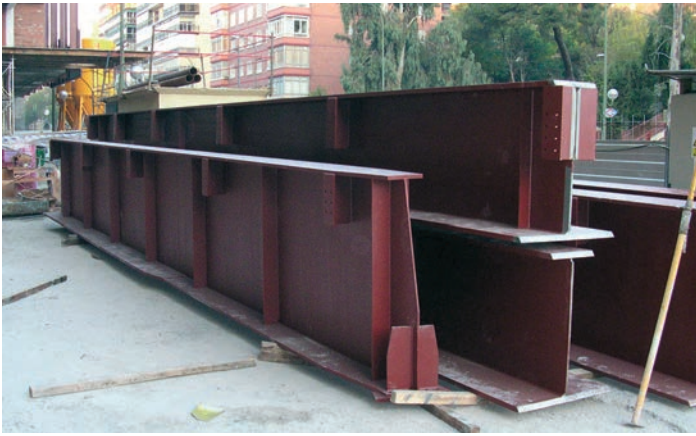
Figura 14. Vista de las vigas previamente al montaje y colocadas en su posición definitiva. Figure 14. View of the steel beams previously to assembling and in their definitive position.
