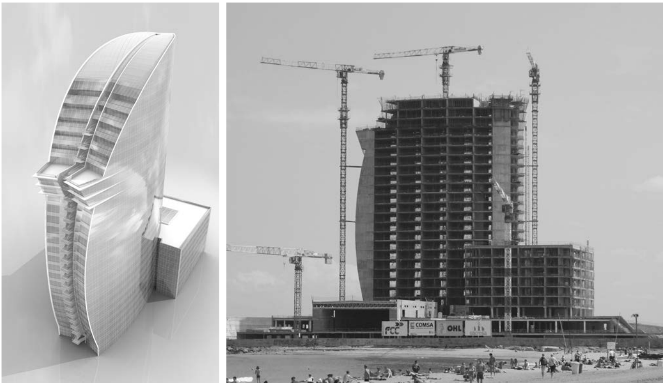
Figuras 13a y 13b. Fotomontaje, y vista del Hotel Vela en construcción.
