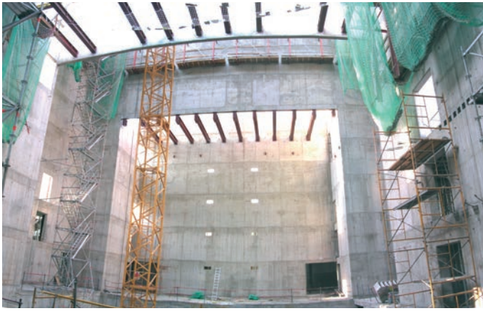
Figura 19. Interior de la caja escénica del Teatro Configurable. Estructuras mixtas. Figure 19. Composite structures inside the Configurable Theatre stage house.
