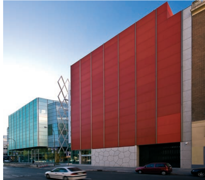
Figura 45. Vista del edificio terminado. Figure 45. Finished building view.
