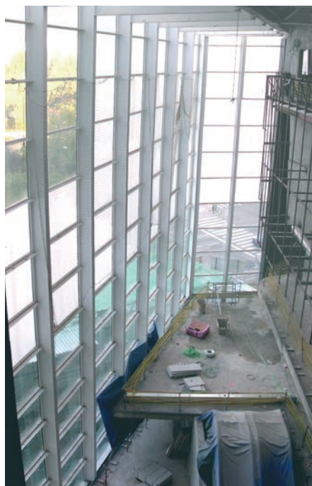
Figura 28. Estructura metálica de fachada colgada desde ménsulas en el espacio entre el Centro Coreográfico y el Teatro Principal. Figure 28. Upper façades steel structure hung from cantilevers between the Choreographic Centre and the Main Theatre.
