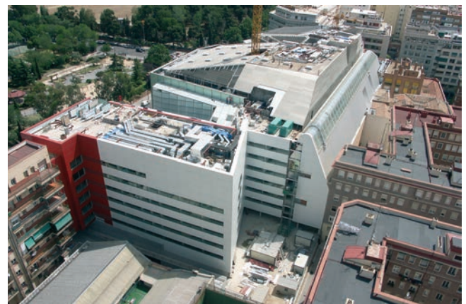
Figura 43. Vista lateral del edificio. Figure 43. Lateral view.
