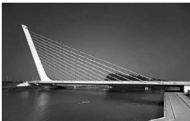
Santiago Calabrava. Puente del Alamillo . Sevilla, 1992.
