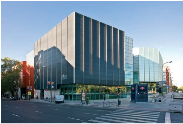
Figura 44. Vista del edificio terminado. Figure 44. Finished building view.
