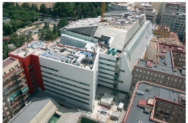
Figura 43. Vista lateral del edificio. Figure 43. Lateral view.
