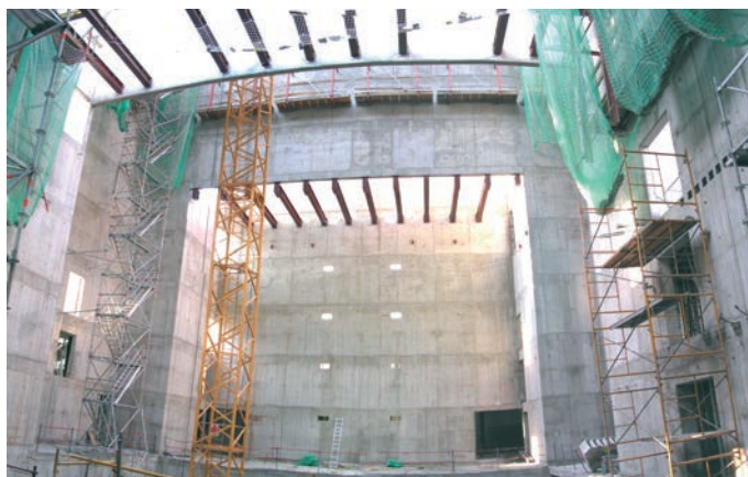
Figura 19. Interior de la caja escénica del Teatro Configurable. Estructuras mixtas.
