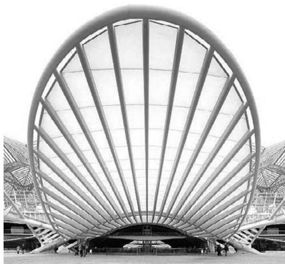
Santiago Calatrava. Estación de Oriente , Lisboa, 1998.
