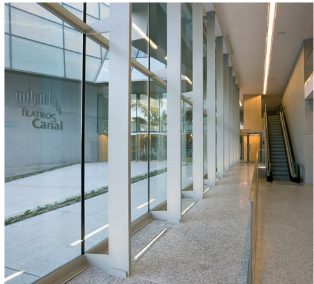
Figura 30. Fachadas inferiores terminadas.
