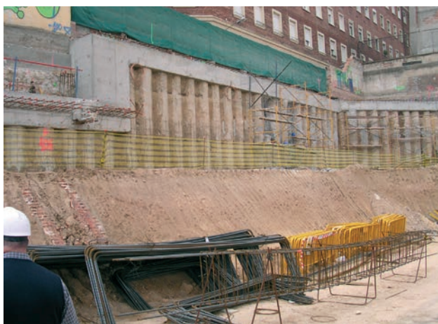
Figura 31. Contención perimetral del solar.
