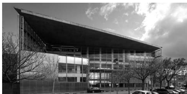
Figura 10. Nuevo edificio de Juzgados de Ciudad Real.
