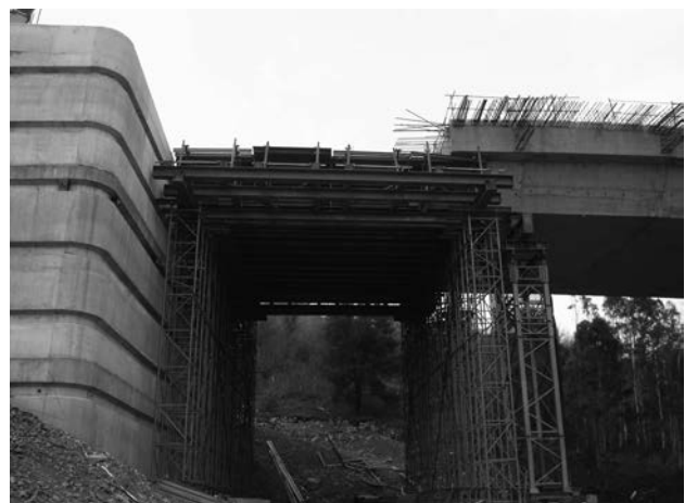
Figura 7. Cimbra fase lateral vano 5.
