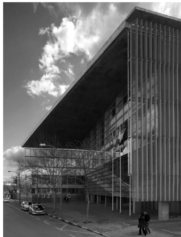
Figura 13. Vista lateral del voladizo de cubierta.
