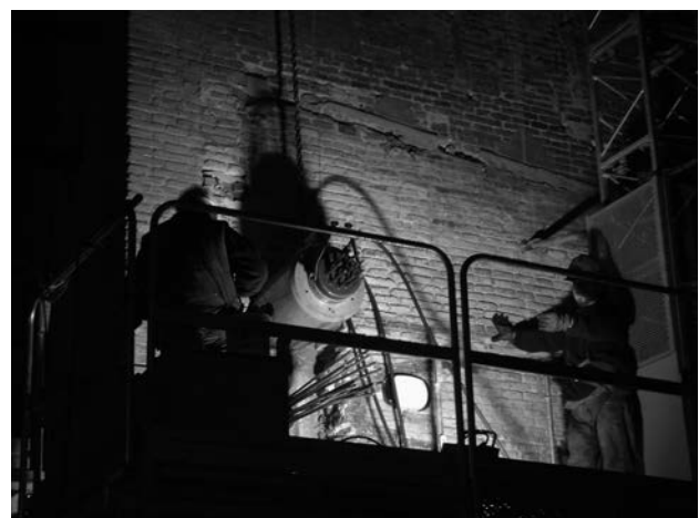
Figura 28. Ejecución del tesado del muro perimetral.
