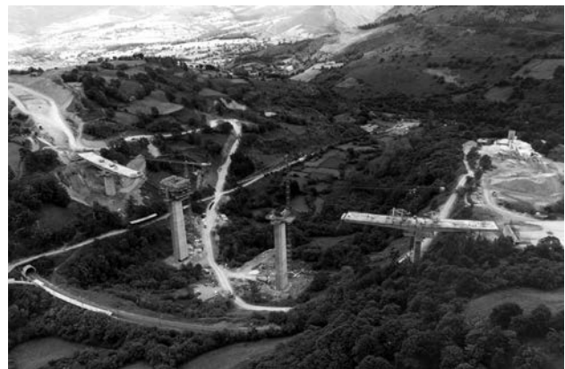
Figura 6. Construcción de la T de la pila 2.
