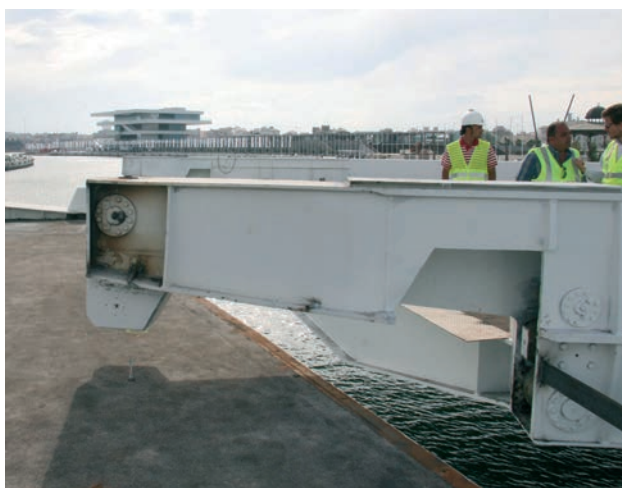
Figura 16. Hoja 2 "barriendo" en el giro por encima de la hoja 1 basculada. Figure 16. Leaf 2 clearing tilted leaf 1.
