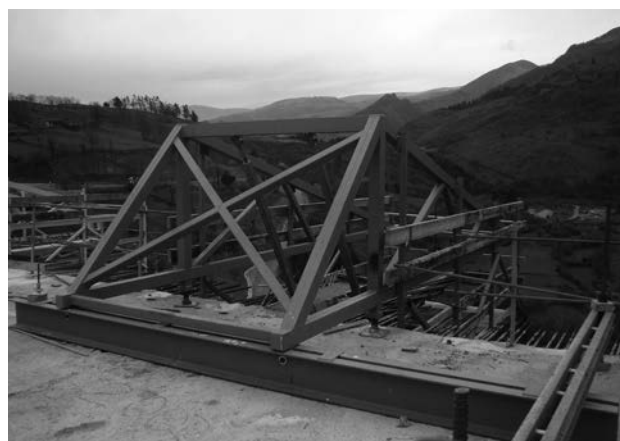
Figura 10. Carro para hormigonado de nervios laterales.
