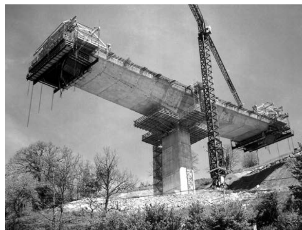
Figura 15. Construcción de la T de la pila 1.
