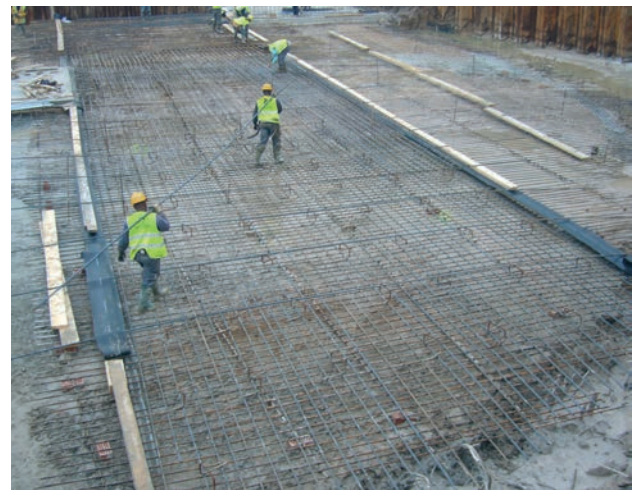
Figura 24. Ejecución de losas de solera. Figure 24. Slab construction.
