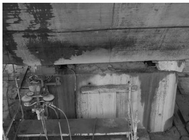
Figura 9. Corte de bloqueo provisional de pila.
