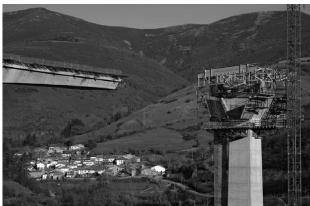
Figura 5. Montaje de carros de avance sobre dovela 0.
