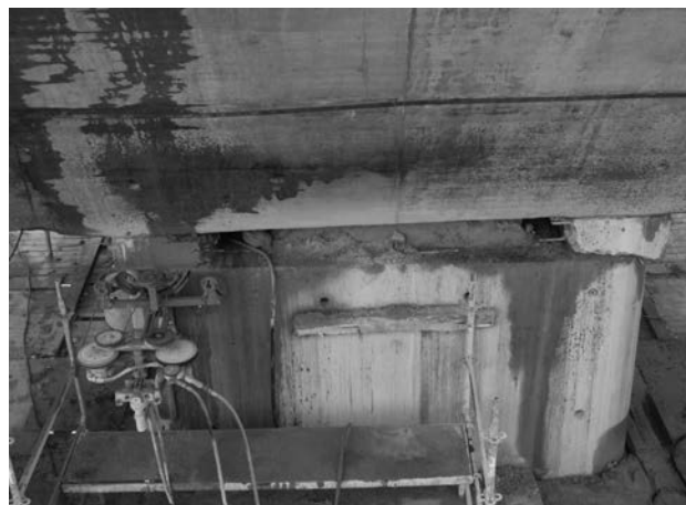
Figura 9. Corte de bloqueo provisional de pila.
