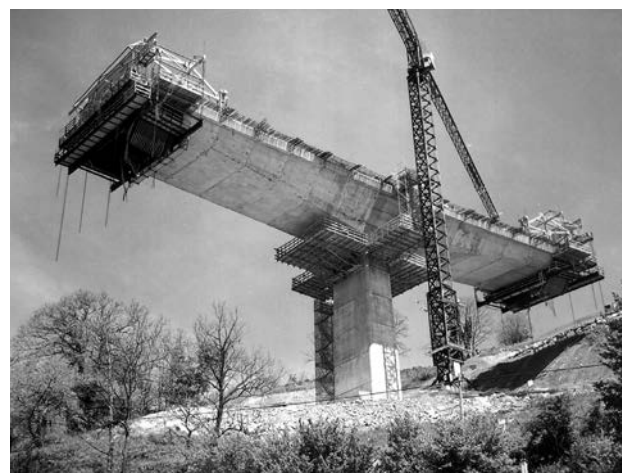
Figura 15. Construcción de la T de la pila 1.
