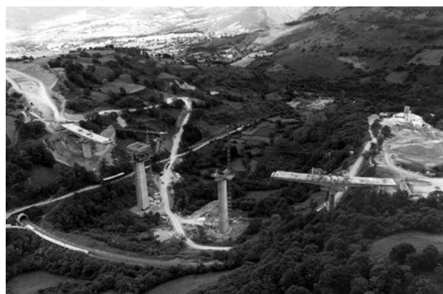
Figura 6. Construcción de la T de la pila 2.
