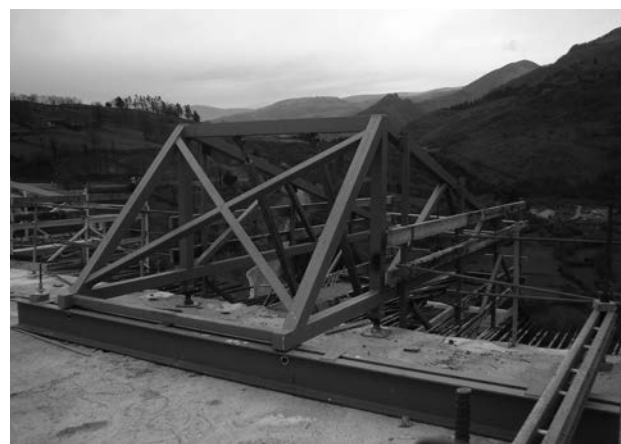
Figura 10. Carro para hormigonado de nervios laterales.
