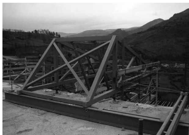
Figura 10. Carro para hormigonado de nervios laterales.
