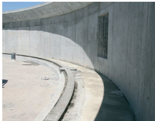
Figura 19. Carril de rodadura. Figure 19. Roller tracks.
