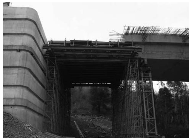
Figura 7. Cimbra fase lateral vano 5.
