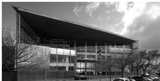
Figura 10. Nuevo edificio de Juzgados de Ciudad Real.
