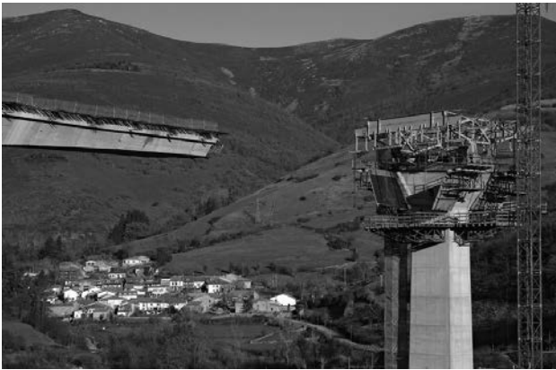
Figura 5. Montaje de carros de avance sobre dovela 0.
