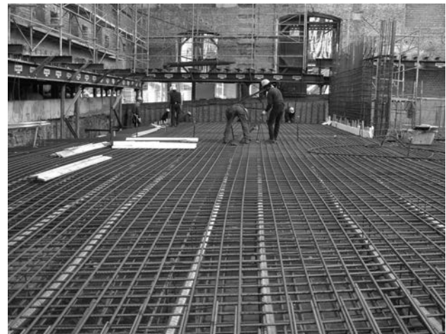
Figura 21. Losa postesada sobre auditorio. Disposición de las vainas y armado.
