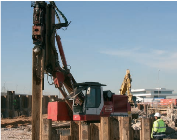
Figura 21. Hinca de tablestacas alrededor de cada recinto. Figure 21. Driving sheet piles around each pit.
