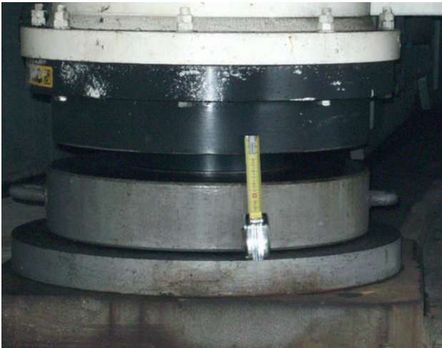
Figura 14. Pata de apoyo dorsal del puente. Figure 14. Rear support leg.
