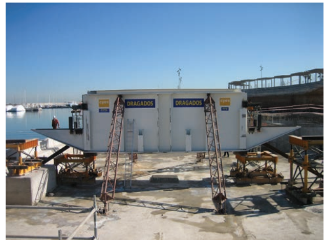
Figura 7. Gran viga de rótula a la espera de recibir a las vigas principales.
