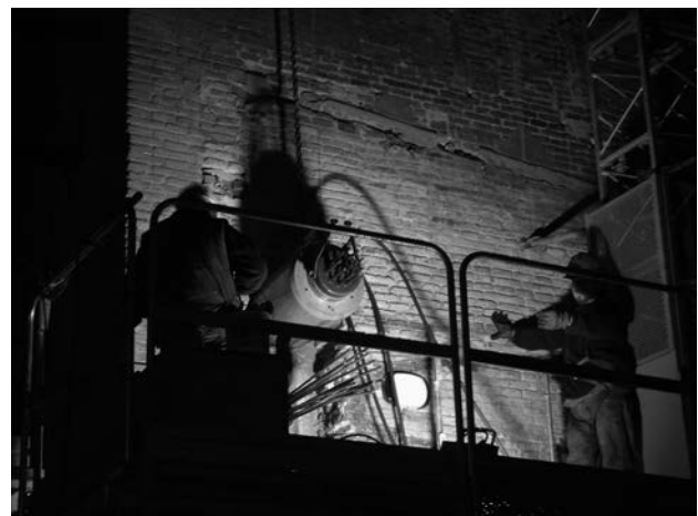
Figura 28. Ejecución del tesado del muro perimetral.
