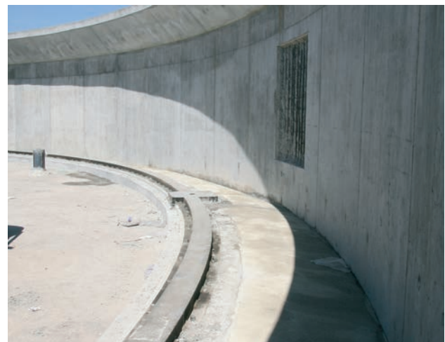
Figura 19. Carril de rodadura. Figure 19. Roller tracks.
