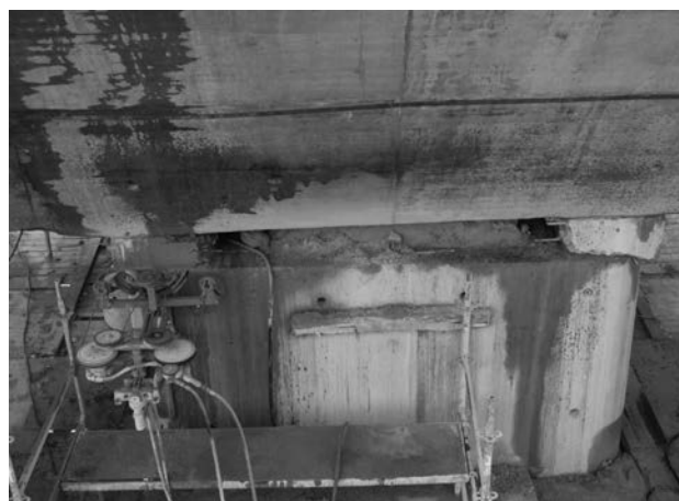
Figura 9. Corte de bloqueo provisional de pila.
