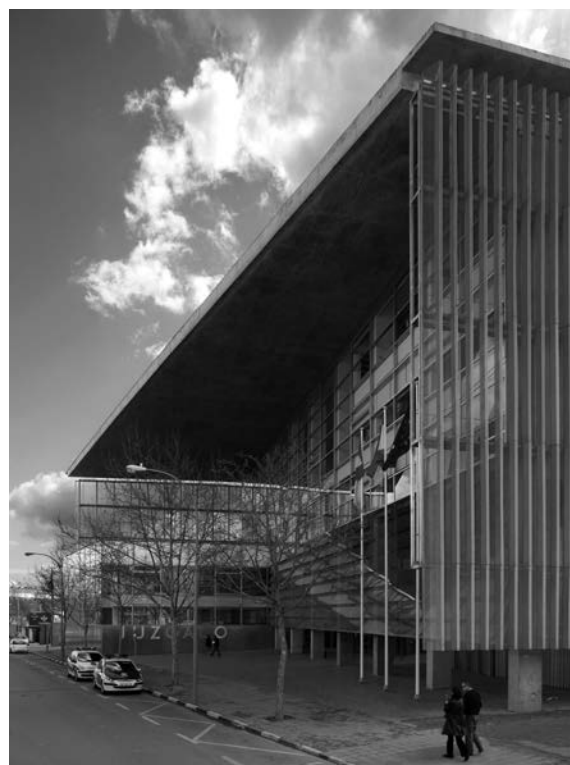
Figura 13. Vista lateral del voladizo de cubierta.
