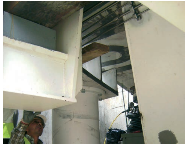
Figura 39. Colocación de patas de apoyo. Figure 39. Support leg assembly.
