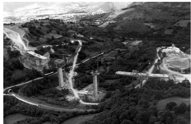
Figura 6. Construcción de la T de la pila 2.
