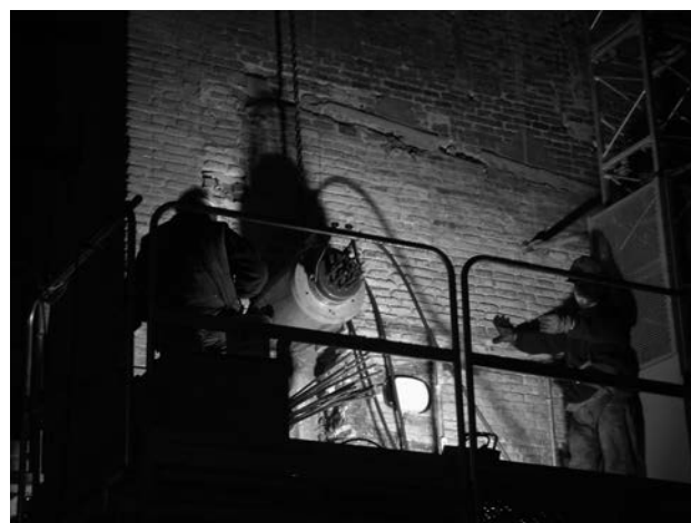
Figura 28. Ejecución del tesado del muro perimetral.
