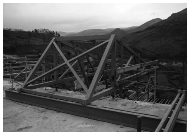
Figura 10. Carro para hormigonado de nervios laterales.
