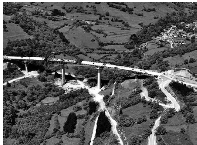
Figura 20. Vista aérea del viaducto durante su construcción.
