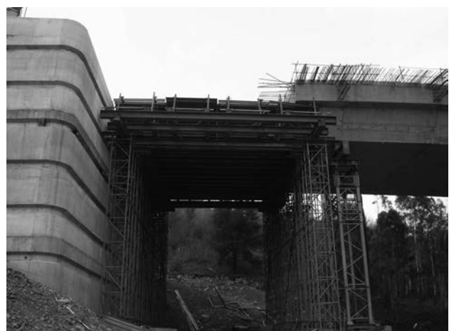
Figura 7. Cimbra fase lateral vano 5.
