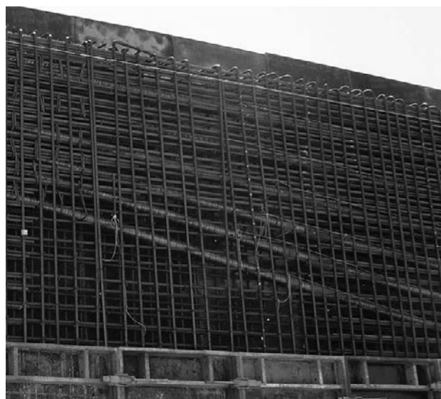
Figura 9. Vainas y armadura del muro lateral.
