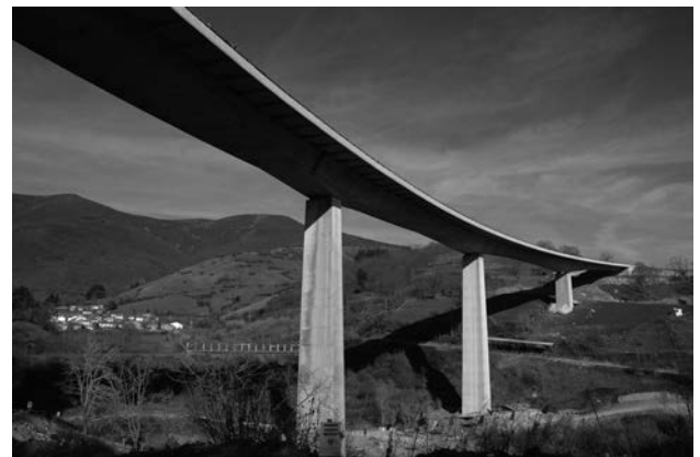
Figura 22. Vista lateral del viaducto una vez terminado.
