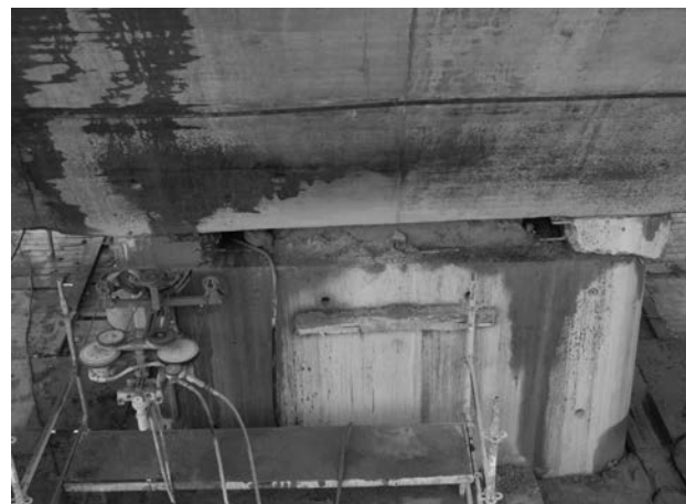
Figura 9. Corte de bloqueo provisional de pila.
