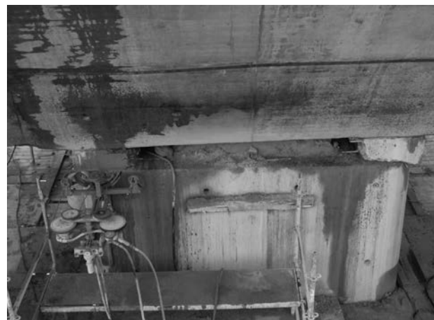
Figura 9. Corte de bloqueo provisional de pila.
