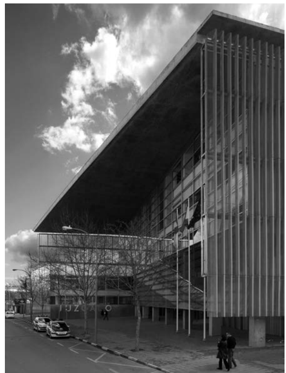
Figura 13. Vista lateral del voladizo de cubierta.
