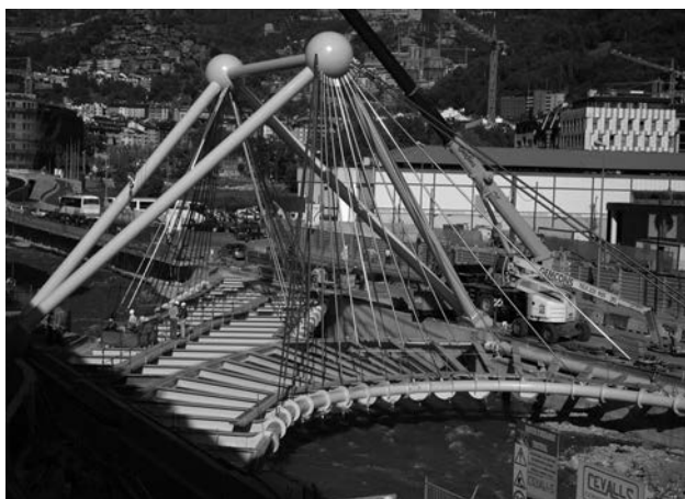
Figura 9. Estructura del tablero del puente de París.
