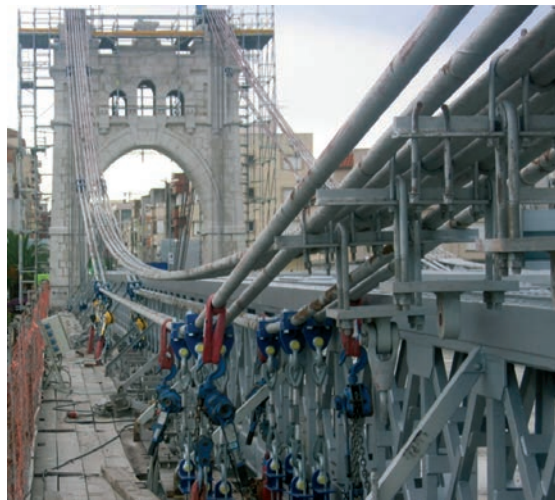
Figura 14. Retirada de péndolas con eslingas y polipastos.
