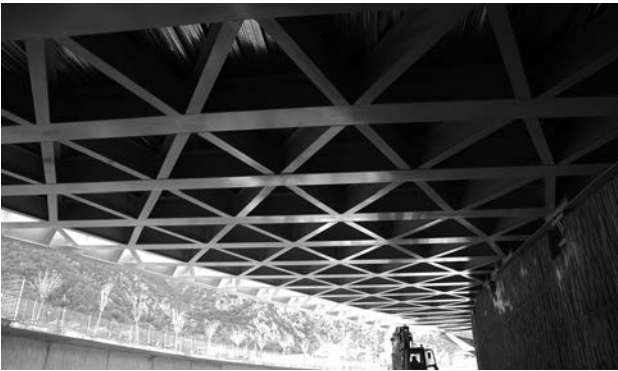
Figura 16. Vista inferior del tablero.
