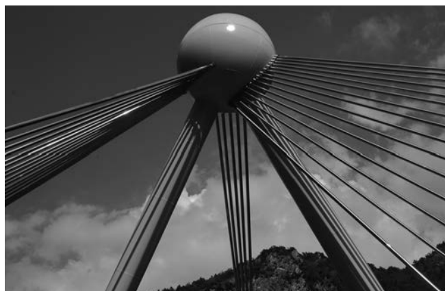
Figuras 4a y 4b. Esferas de anclajes de los tirantes de los dos puentes.
