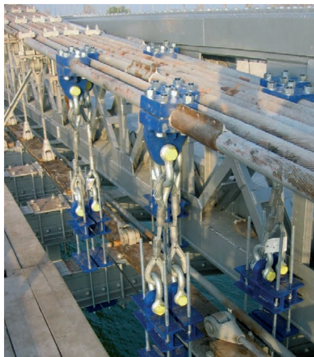
Figura 8. Péndolas provisionales cortas. Figure 8. Provisional short suspenders.
