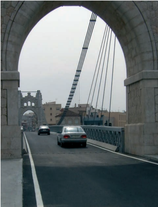
Figura 39. Tablero terminado. Figure 39. Finished deck.
