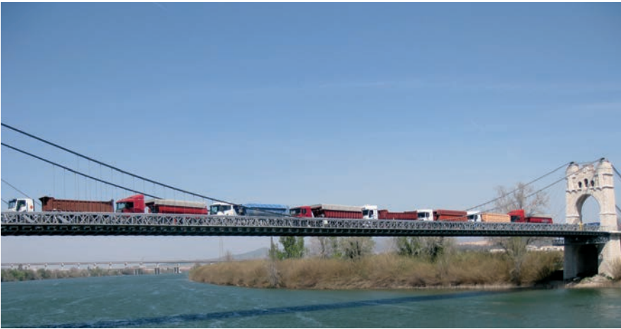
Figura 38. Prueba de carga. Figure 38. Load test.
