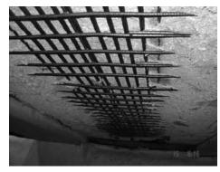
Figura 37. Spalling en la cara inferior.
