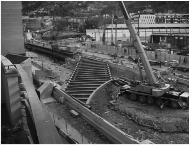
Figura 10. Montaje de la primera fase del tablero.
