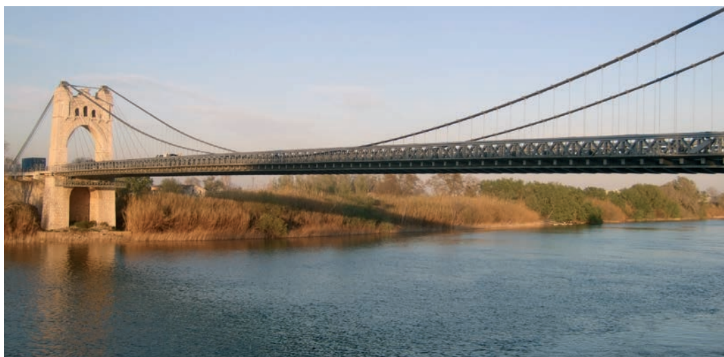
Figura 41. Sistema de cables definitivo. Figure 41. Permanent cable system.
