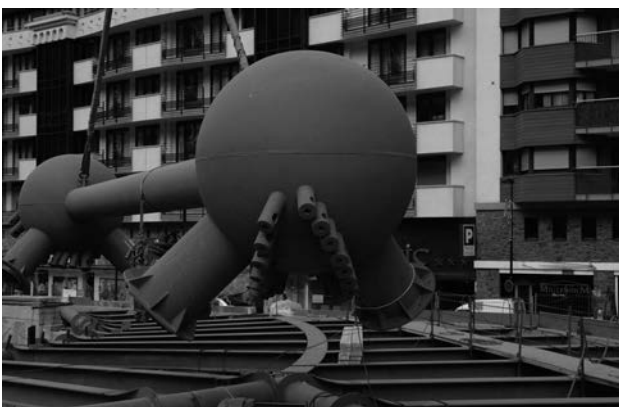
Figura 11. Montaje de la pieza superior de la estructura.
