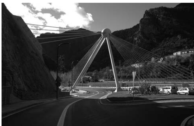
Figura 13. Puente de Madrid.
