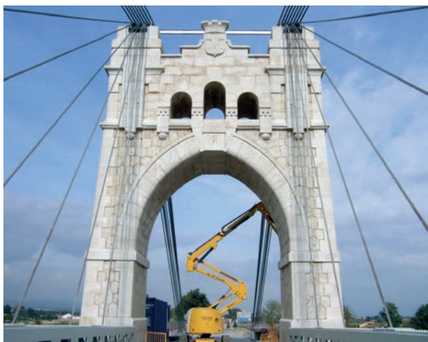
Figura 34. Pilono una vez rehabilitado. Figure 34. Rehabilitated pier.
