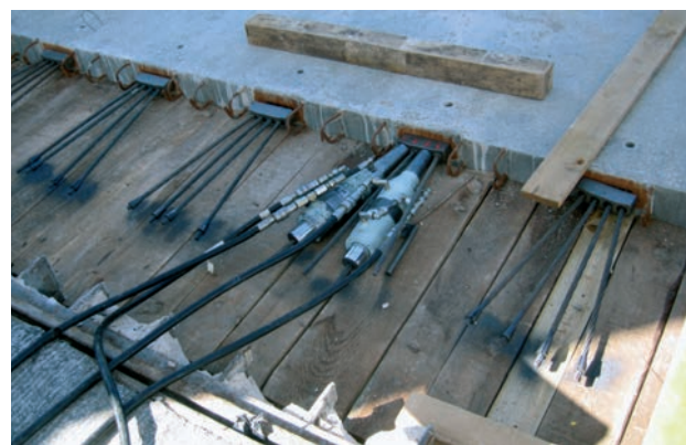
Figura 5. Tesado de la losa de calzada con juntas entre tramos prefabricados ya hormigonadas.
