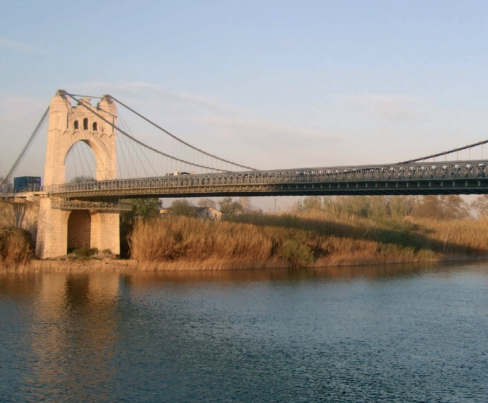
Puente de Amposta
