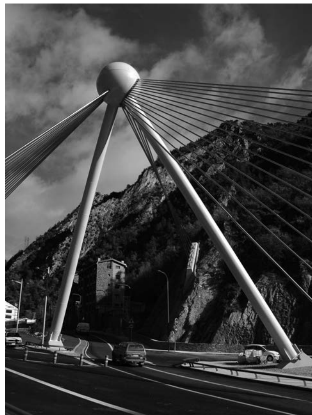
Figura 14. Bípode de apoyo de la esfera.
