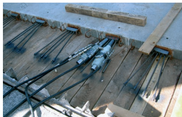
Figura 5. Tesado de la losa de calzada con juntas entre tramos prefabricados ya hormigonados.
