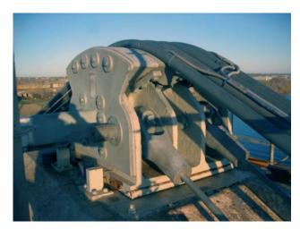
Figura 28. Una de las sillas rehabilitada, mostrando la cara de los terminales de cables de retenida. Figure 28. Rehabilitated saddle: guyline side.
