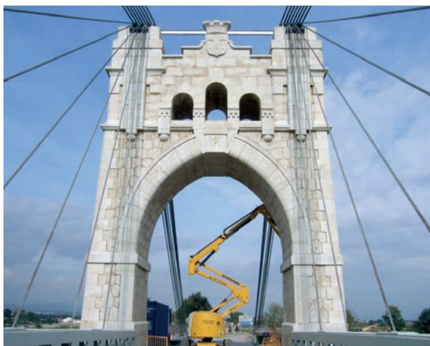
Figura 34. Pilono una vez rehabilitado. Figure 34. Rehabilitated pier.
