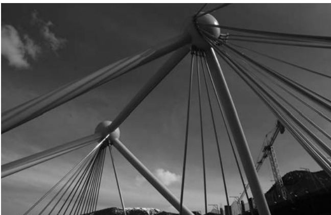
Figuras 4a y 4b. Esferas de anclajes de los tirantes de los dos puentes.
