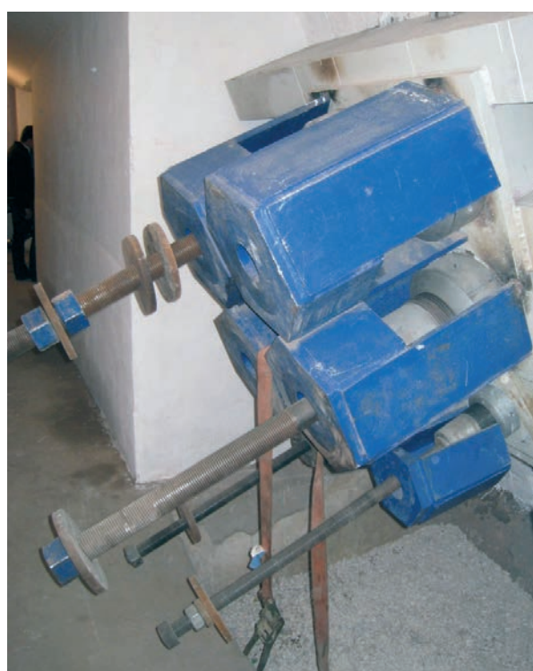
Figura 33. Interior de las cámaras de anclaje rehabilitadas. Figure 33. Rehabilitated anchorage chamber interiors.
