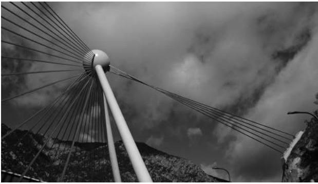
Figura 15. Tirantes anclados en la roca.
