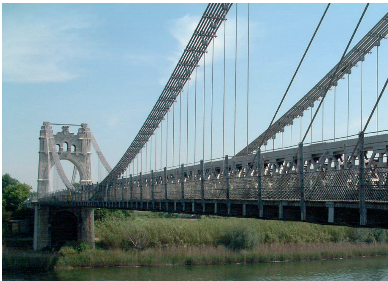
Figura 1. Estado del puente antes de los trabajos de rehabilitación. Figure 1. Bridge prior to rehabilitation works.
