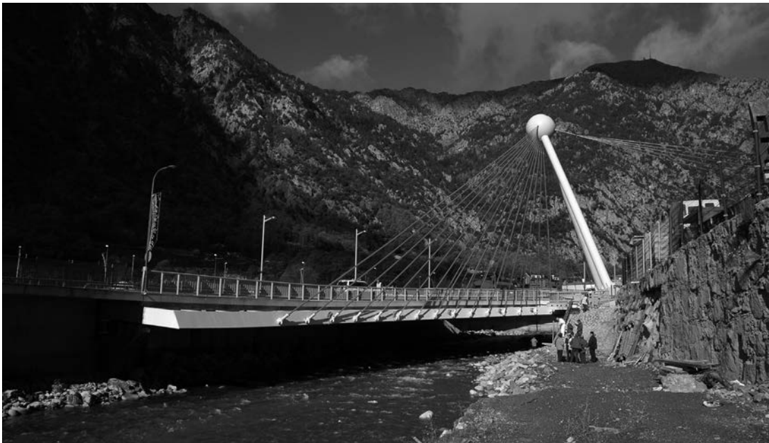
Figura 24. El puente de Madrid terminado.
