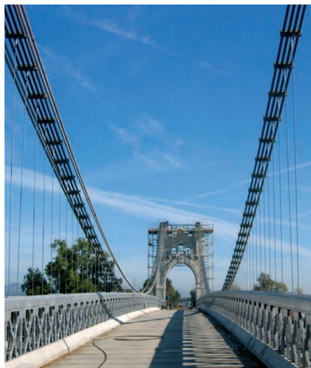
Figura 25. Cables nuevos finalizada la transferencia de carga. Figure 25. New cables after load transfer.
