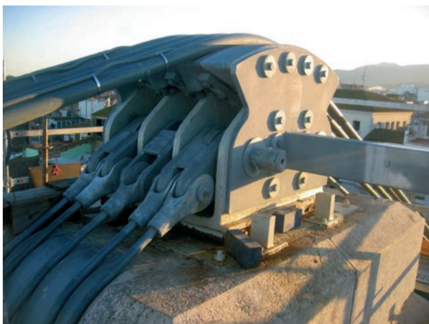
Figura 27. Una de las sillas rehabilitada, mostrando la cara de los terminales de tirantes.
