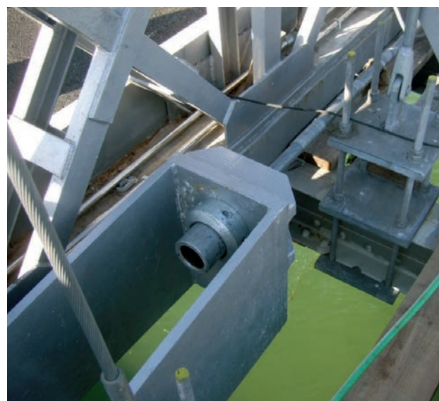
Figura 29. Nuevo cable horizontal y su terminal activo.
