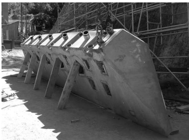
Figuras 21a y 21b. Macizo de anclaje de los tirantes de compensación. a) El anclaje en el suelo. b) El anclaje en su posición definitiva.
