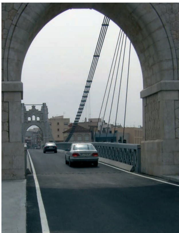
Figura 39. Tablero terminado. Figure 39. Finished deck.
