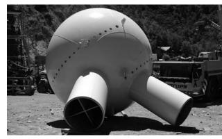
Figuras 19a y 19b. Las semiesferas del puente de Madrid antes del montaje.
