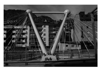
La canalización del río en la zona del puente tiene un ancho entre los muros verticales de 22,6 m. Esta luz es la que debe salvar el ramal semicircular, y también el ramal oblicuo que da lugar a una luz real de 44,3 m.
