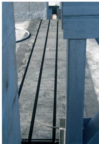
Figura 37. Junta de la calzada. Figure 37. Carriageway joint.
