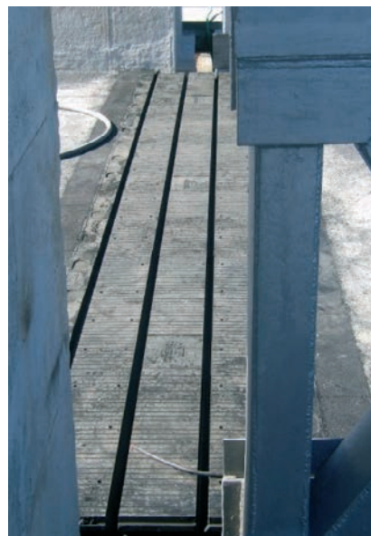
Figura 37. Junta de la calzada. Figure 37. Carriageway joint.
