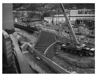
Figura 10. Montaje de la primera fase del tablero.
