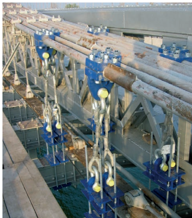
Figura 8. Péndolas provisionales cortas. Figure 8. Provisional short suspenders.
