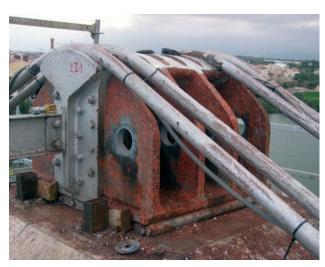
Figura 17. Una de las sillas durante la rehabilitación. Figure 17. Saddle during rehabilitation.
