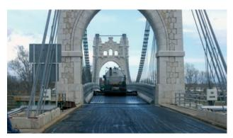
Figura 35. Trabajos de pavimentación. Figure 35. Paving operations.
