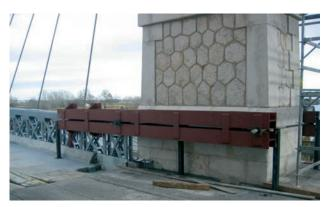
Figura 7. Sistema de bloqueo del tablero. Figure 7. Deck blocking system.
