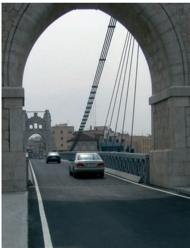
Figura 39. Tablero terminado. Figure 39. Finished deck.
