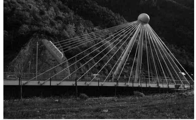
Figura 2. Puente de Madrid.
