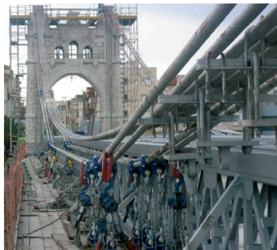
Figura 14. Retirada de péndolas con eslingas y polipastos.
