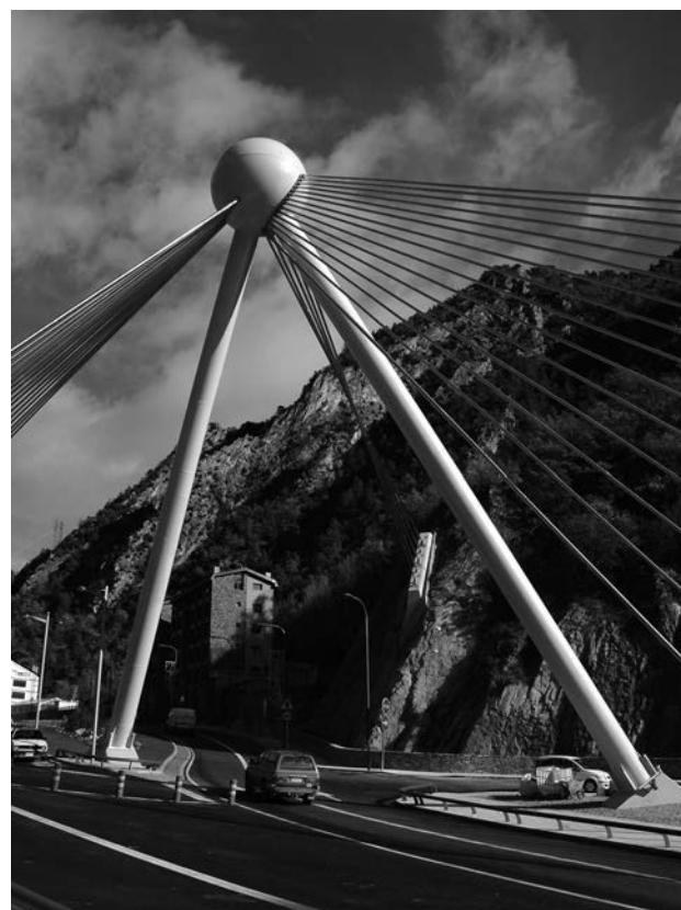
Figura 14. Bípode de apoyo de la esfera.
