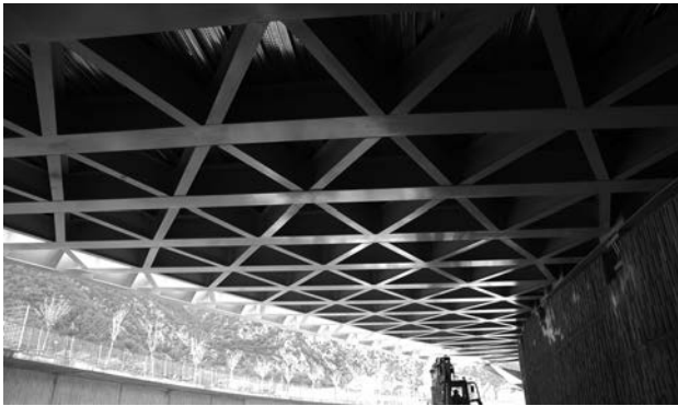
Figura 16. Vista inferior del tablero.
