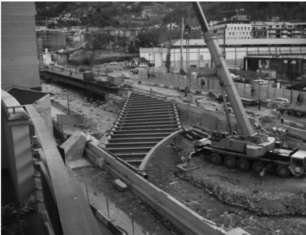
Figura 10. Montaje de la primera fase del tablero.
