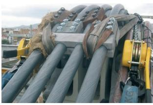
Figura 18. Sistema antideslizante de los cables principales nuevos. Figure 18. Anti-slip system for new main cables.
