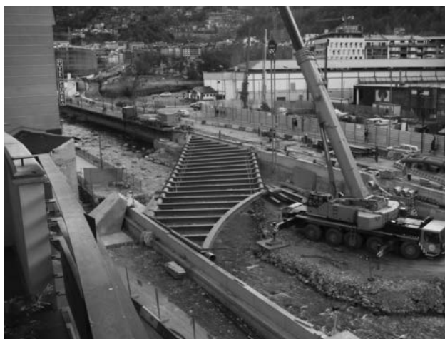
Figura 10. Montaje de la primera fase del tablero.
