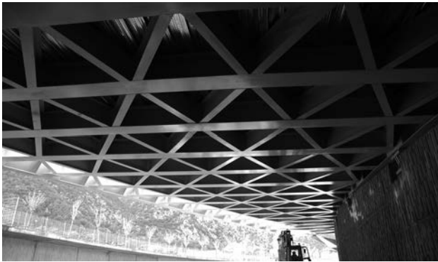
Figura 16. Vista inferior del tablero.
