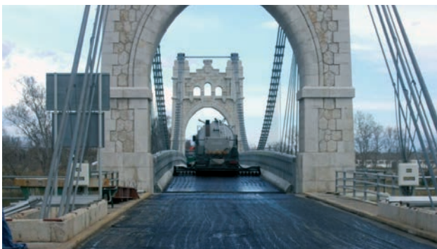
Figura 35. Trabajos de pavimentación. Figure 35. Paving operations.
