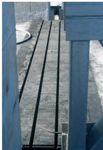
Figura 37. Junta de la calzada. Figure 37. Carriageway joint.
