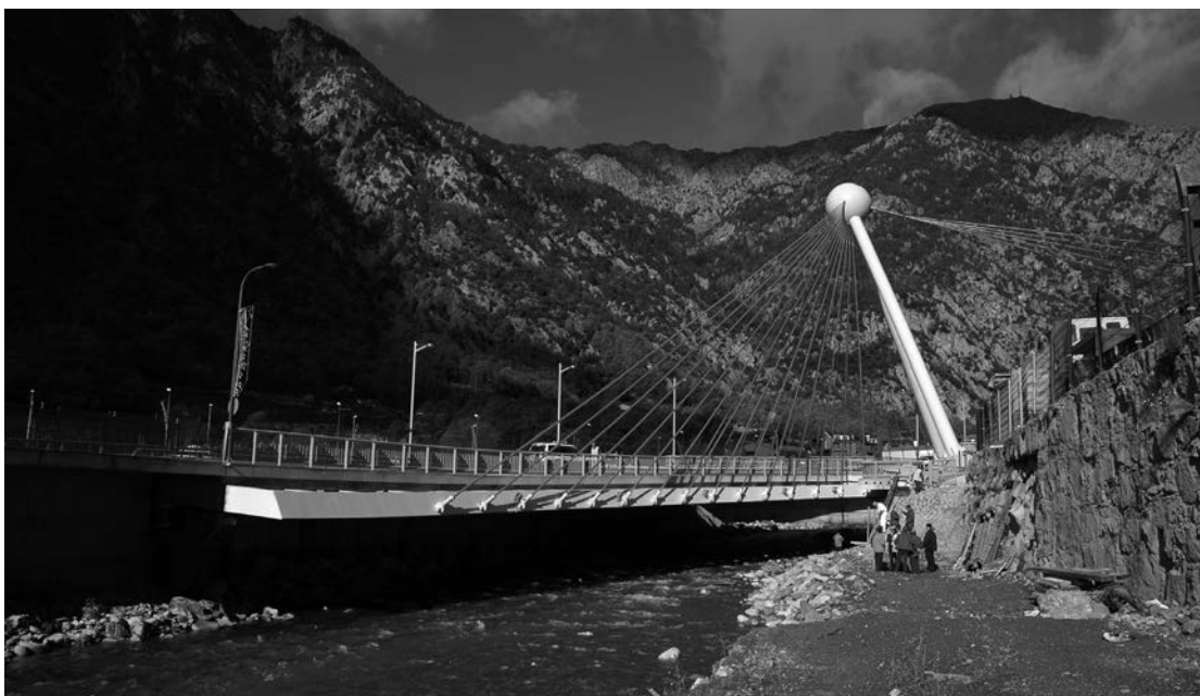
Figura 24. El puente de Madrid terminado.
