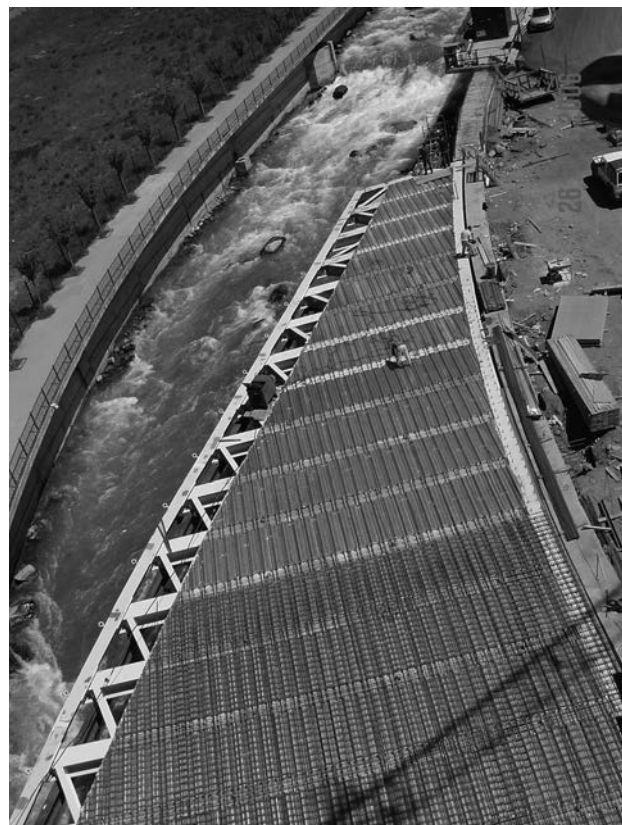
Figura 23. Construcción de la losa de hormigón del tablero.
