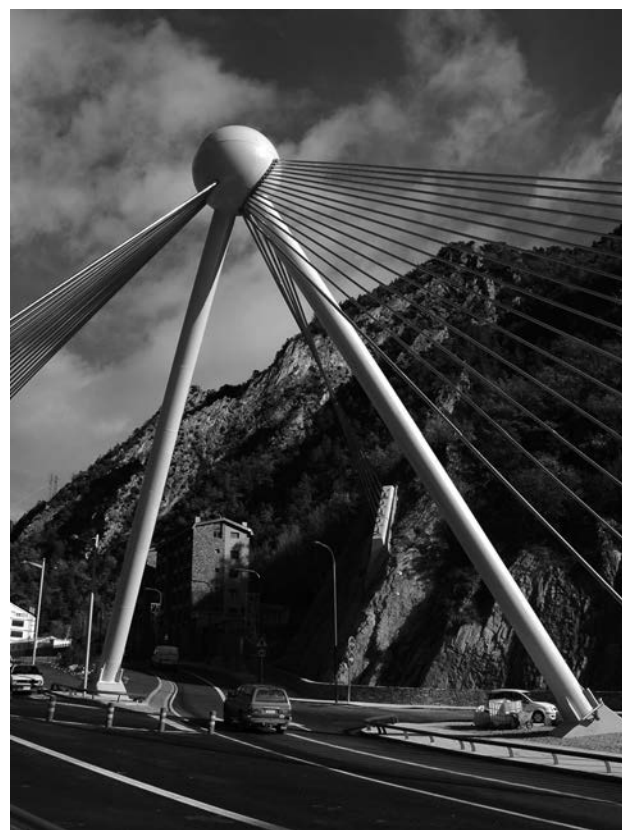
Figura 14. Bípode de apoyo de la esfera.
