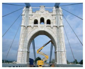
Figura 34. Pilono una vez rehabilitado. Figure 34. Rehabilitated pier.
