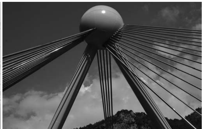
Figuras 4a y 4b. Esferas de anclajes de los tirantes de los dos puentes.
