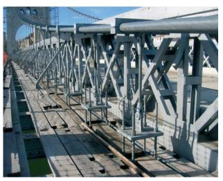
Figura 24. Nuevas péndolas y sus sistemas de unión. Figure 24. New suspenders and joining systems.
