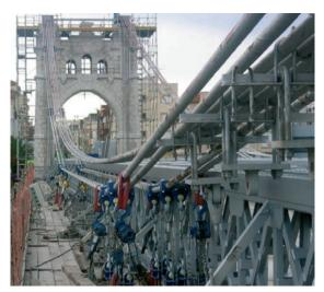
Figura 14. Retirada de péndolas con eslingas y polipastos. Figure 14. Suspender removal with slings and chain blocks.
