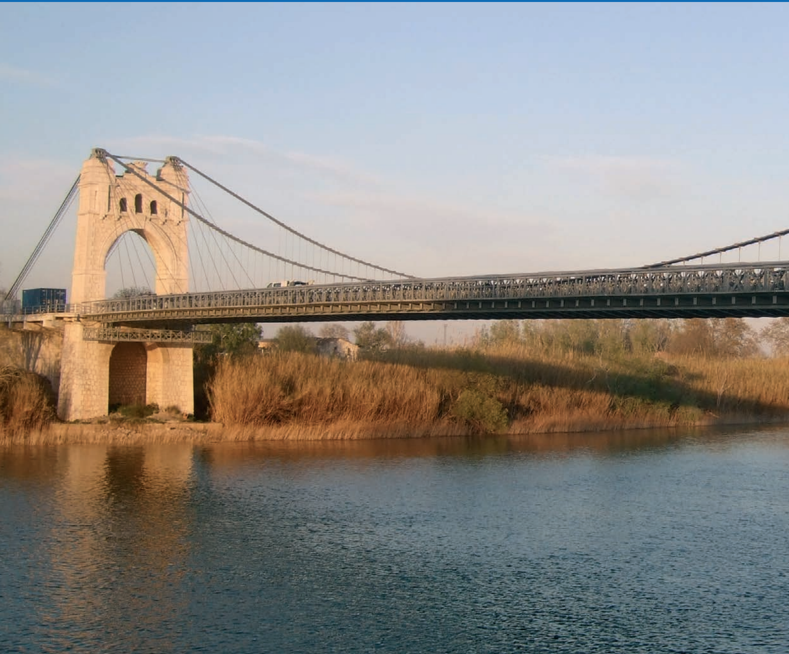
Puente de Amposta
