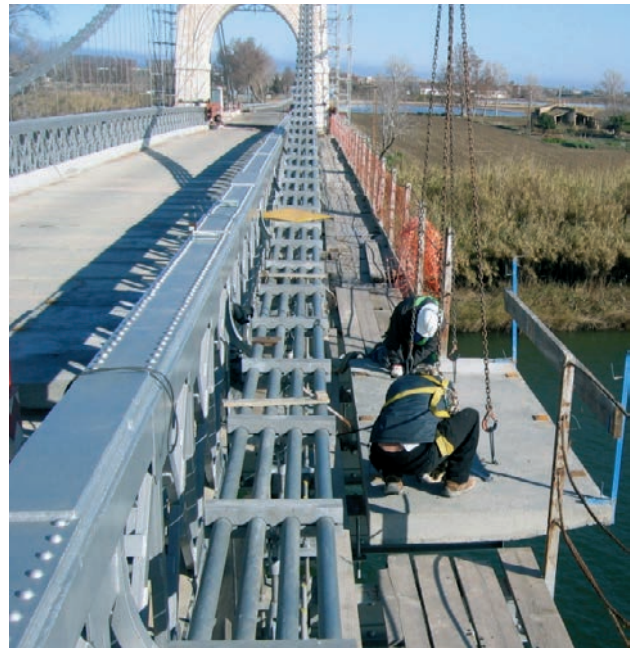
Figura 6. Trabajos de colocación de las aceras prefabricadas. Figure 6. Laying precast walkway slabs.
