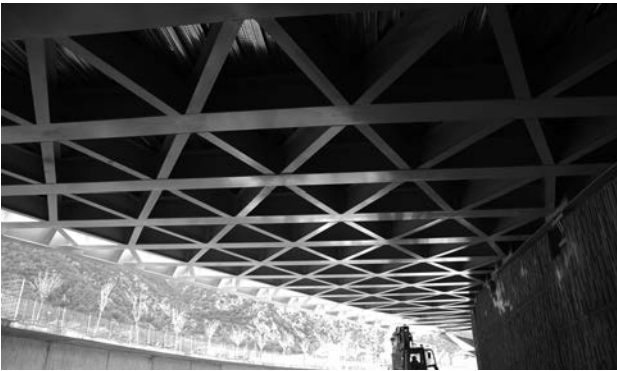
Figura 16. Vista inferior del tablero.
