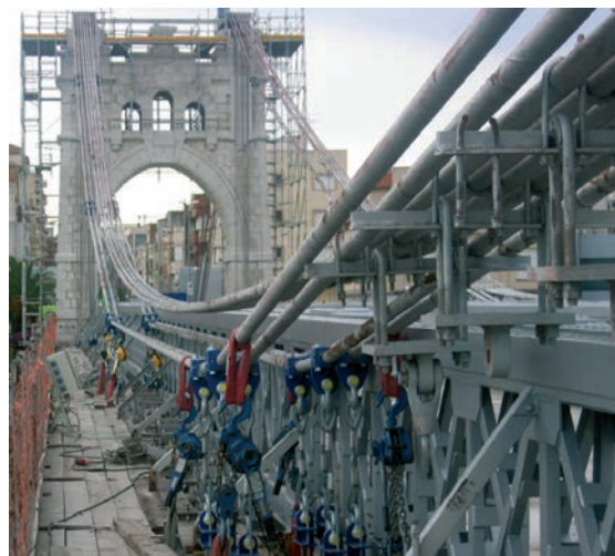
Figura 14. Retirada de péndolas con eslingas y polipastos.
