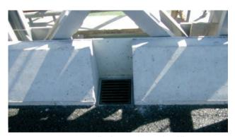
Figura 36. Detalle de sumideros y bordillo. Figure 36. Detail of sump and kerb.
