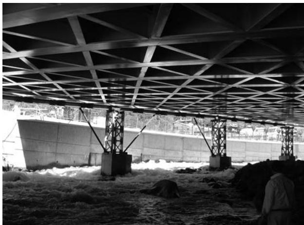
Figuras 22a y 22b. Construcción del tablero. Apoyos provisionales para el montaje.
