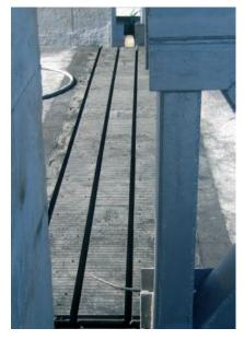
Figura 37. Junta de la calzada. *Figure 37. Carriageway joint.*
