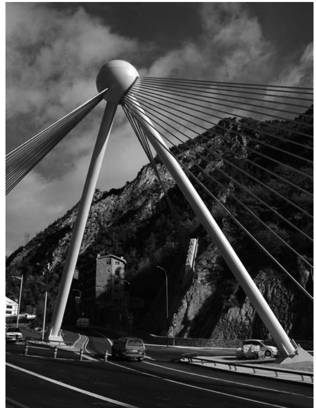
Figura 14. Bípode de apoyo de la esfera.
