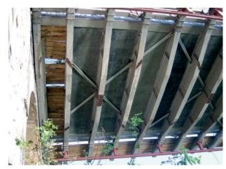
Figura 3. Colocación de nuevas Cruces de San Andrés sustitutas de las antiguas. Figure 3. Erection of new wind braces to replace the initial members.
