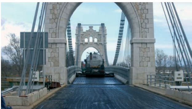
Figura 35. Trabajos de pavimentación. Figure 35. Paving operations.
