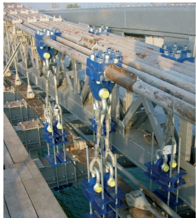
Figura 8. Péndolas provisionales cortas. Figure 8. Provisional short suspenders.
