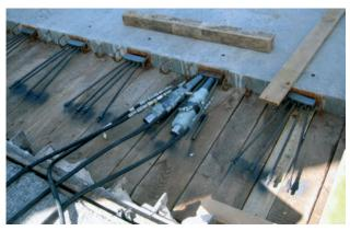
Figura 5. Tesado de la losa de calzada con juntas entre tramos prefabricados ya hormigonadas.
