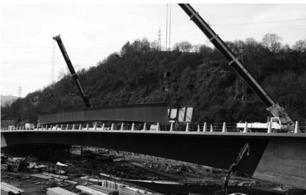
Figura 26. Transporte del tramo central del segundo viaducto sobre el primer puente ya concluido.
