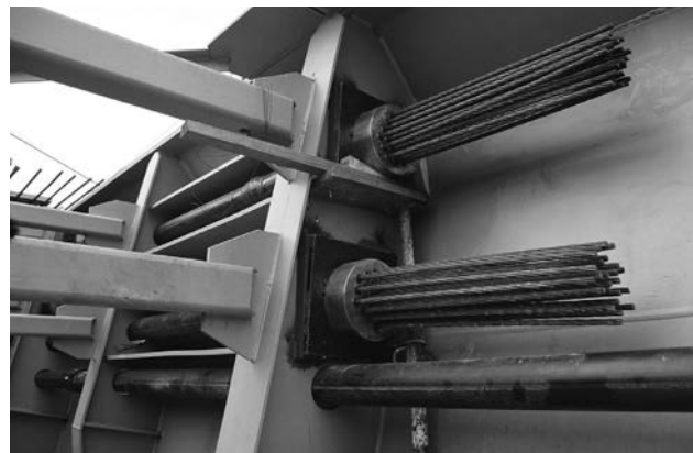
Figura 34. Detalle de anclajes de pretensado, y tubos de arriostramiento.
