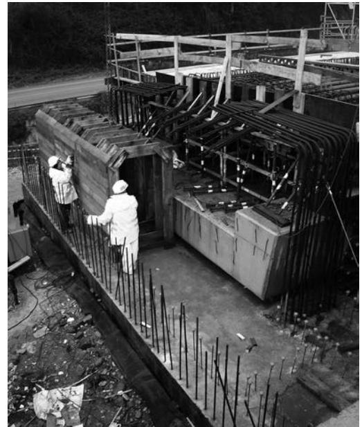
Figura 10 b. Ejecución de estribo, con galería para inspección de apoyos inversos.
