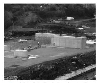
Figura 11. Vista de las pilas y la primera fase de estribos ejecutada e inicios de colocación de la cimbra del cajón de hormigón.
