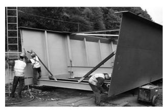
Figura 20. Corte de demasías en el tramo central.
