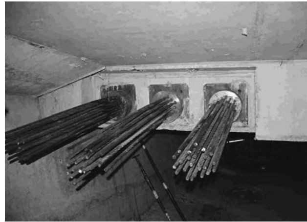
Figura 7. Vista de anclajes de pretensado en cuñas
