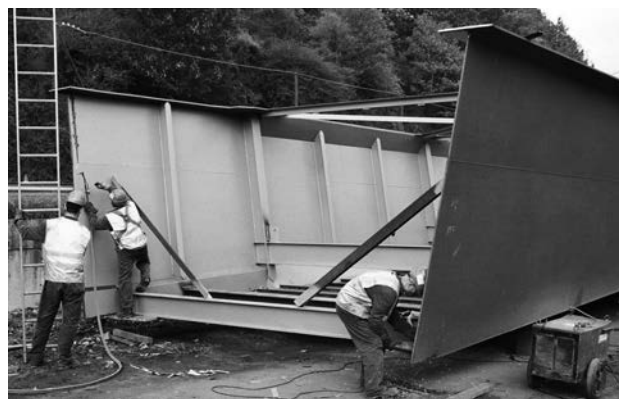
Figura 20. Corte de demasías en el tramo central.
