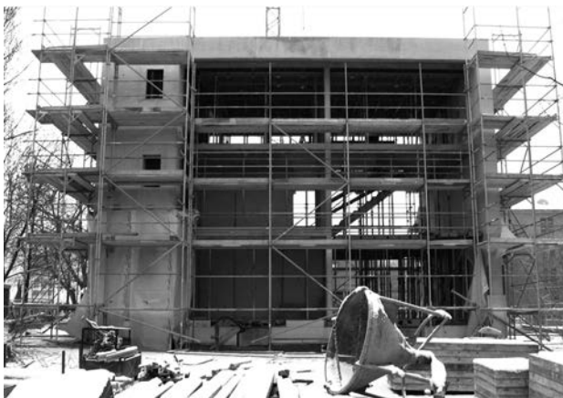
Figura 24. Fachada norte en construcción.
