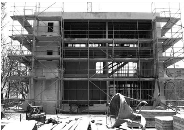
Figura 24. Fachada norte en construcción.
