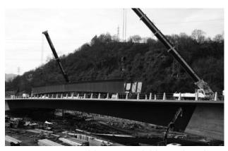
Figura 26. Transporte del tramo central del segundo viaducto sobre el primer puente ya concluido.
