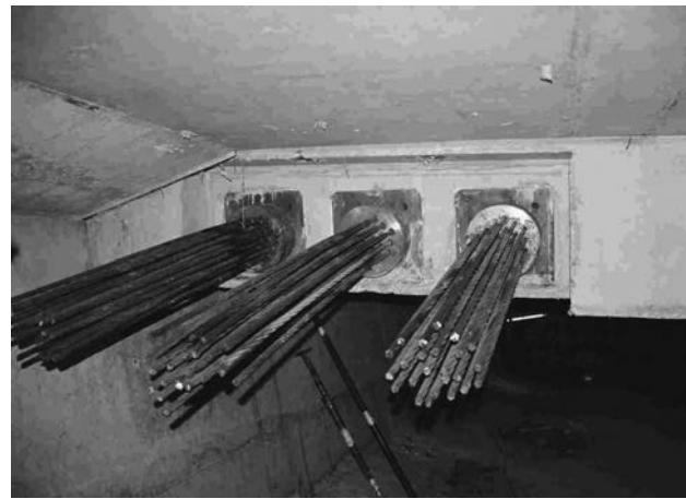
Figura 7. Vista de anclajes de pretensado en cuñas
