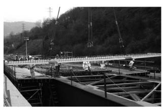
Figura 23. Colocación de prelosas prefabricadas.
