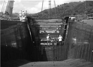
Figuras 14a y 14b. Izado y colocación del primer tramo metálico.
