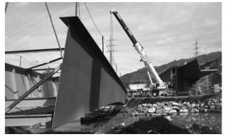
Figura 19. Izado del tramo central metálico.
