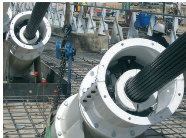
Figura 34. Amortiguador ya montado. Figure 34. Damper on site.
