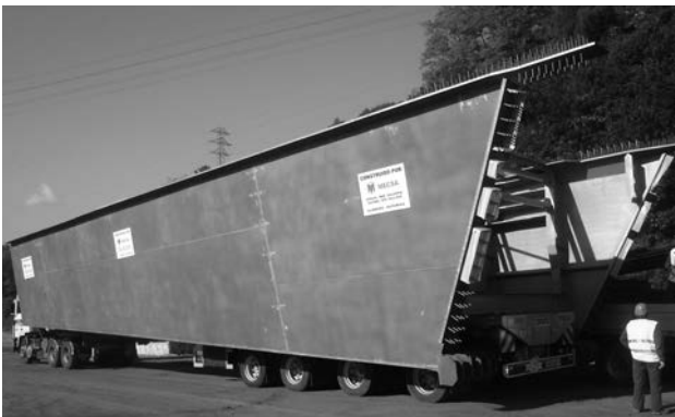
Figura 13. Transporte del primer tramo metálico.
