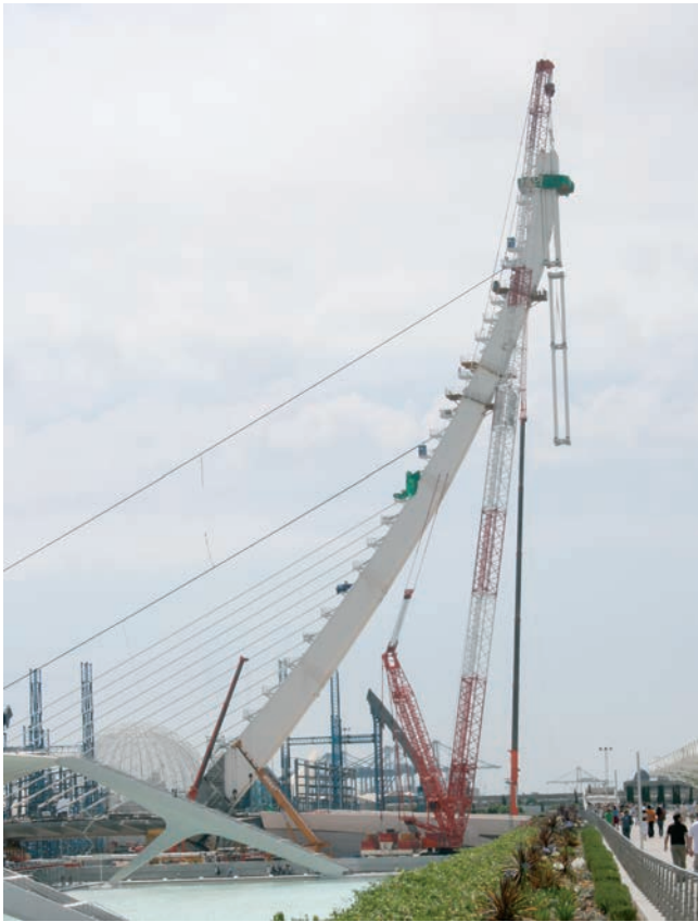
Figura 28. Montaje de tubos de retenida. Figure 28. Erection of back stay steel tubes.
