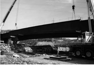
Figuras 27a y 27b. Izado y colocación del tramo central del segundo viaducto.
