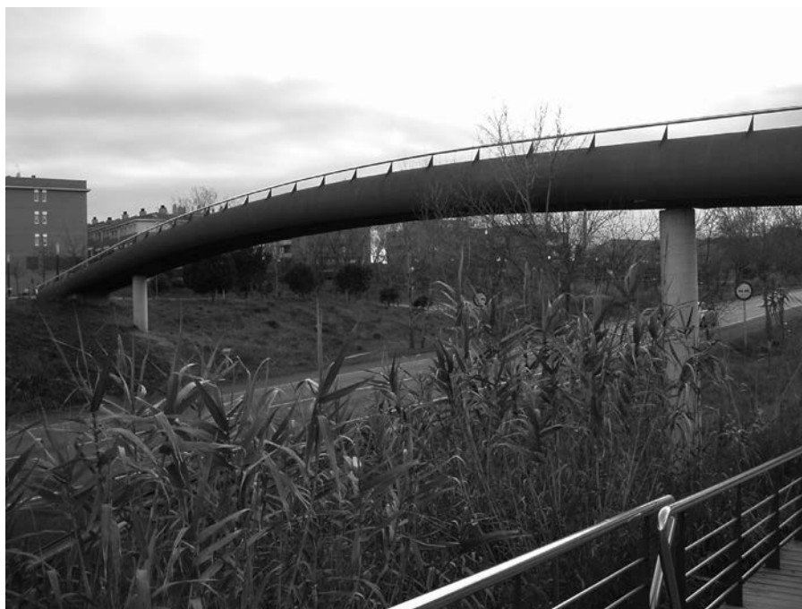
Figura 4. Pasarela del Gat Cendrer: tramo sobre la carretera BV-2244.
