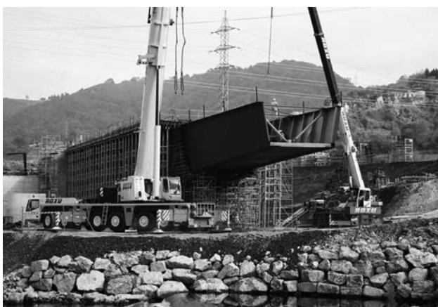
Figura 17. Vista del voladizo pretensado y desapeado.
