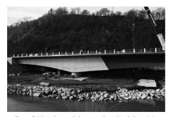
Figura 5. Vista de uno de los vanos laterales de hormigón con 27,5 m de luz.
