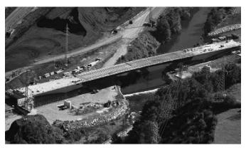
Figura 24. Vista aérea del primer viaducto con todas las prelosas ya colocadas.
