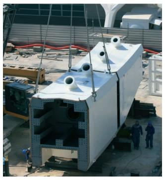
Figura 25. Dovela de pilono. Figure 25. Pylon erection unit.
