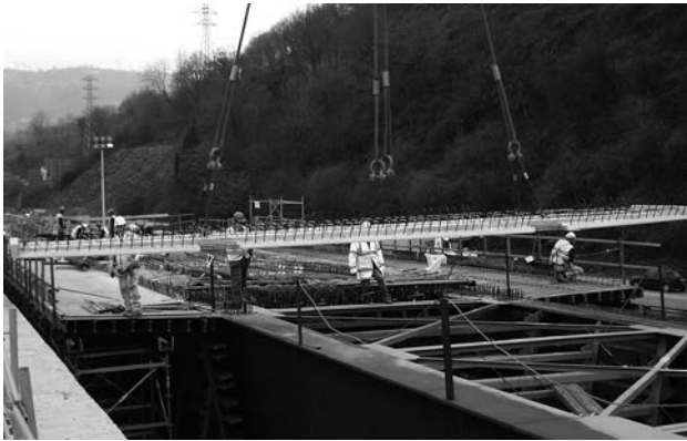
Figura 23. Colocación de prelosas prefabricadas.
