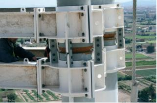
Figura 29. Unión para posicionado y soldadura de tubos de retenida. Figure 29. Connection for geometrical reference prior to welding of back stay tubes.
