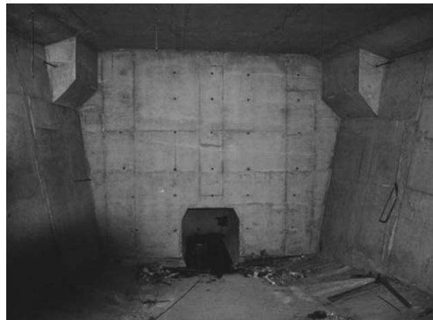
Figura 8. Vista interior del mamparo de pila con paso de hombre.
