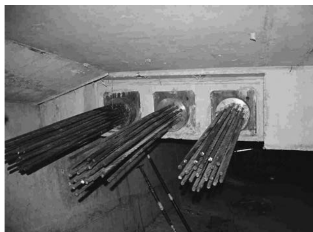
Figura 7. Vista de anclajes de pretensado en cuñas
