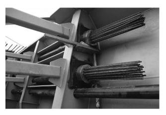
Figura 34. Detalle de anclajes de pretensado, y tubos de arriostramiento.
