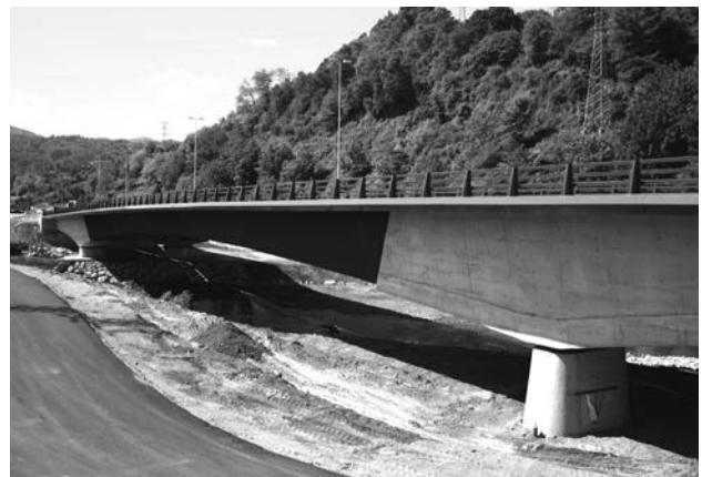
Figura 29. Vista lateral de los dos viaductos concluidos.
