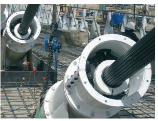
Figura 34. Amortiguador ya montado. Figura 34. Dumper on site.
