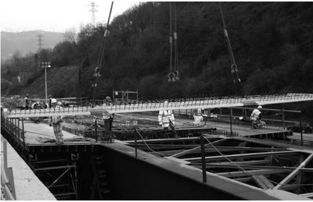
Figura 23. Colocación de prelosas prefabricadas.
