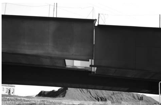
Figura 21. Detalle del momento de colocación del tramo central
