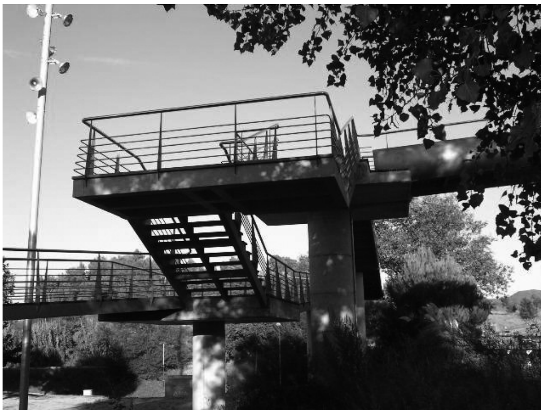
Figura 7. Pasarela de La Triola: detalle de la escalera en voladizo entre las pilas 2 y 6.
