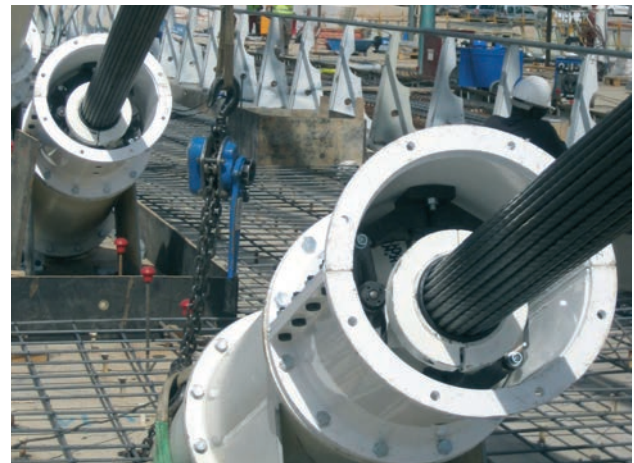
Figura 34. Amortiguador ya montado. Figure 34. Damper on site.
