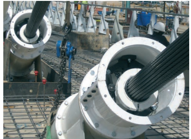
Figura 34. Amortiguador ya montado. Figure 34. Damper on site.
