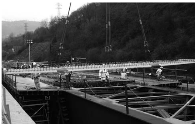
Figura 23. Colocación de prelosas prefabricadas.
