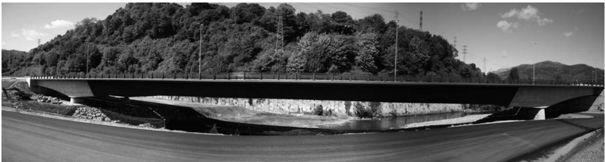
Figuras 1a y 1b. Alzado del Viaducto sobre el Río Nalón.
