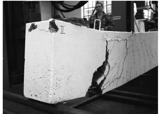
Figura 10. Ensayo con una viga de hormigón infraligero.
