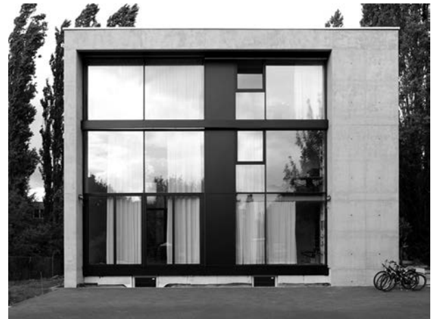
Figura 26. Vivienda terminada, fachada sur.
