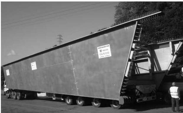
Figura 13. Transporte del primer tramo metálico.
