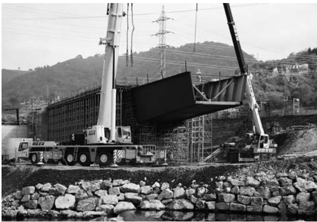
Figura 17. Vista del voladizo pretensado y desapeado.
