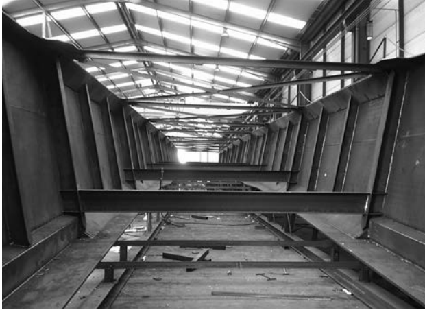
Figura 4. Vista interior de la sección metálica en taller.
