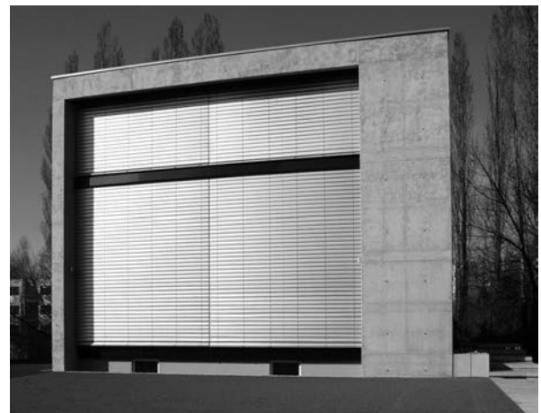
Figura 27. Vivienda terminada con persianas.
