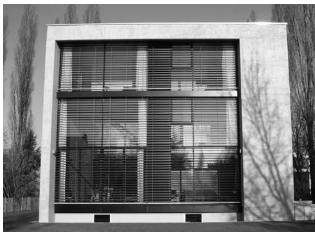
Figura 2. Vivienda unifamiliar con muros exteriores de hormigón infraligero.
