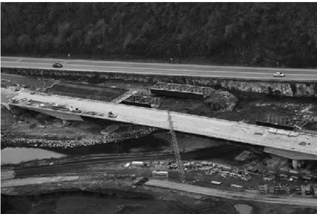
Figura 25. Vista del primer viaducto concluido, y del segundo en fase de ejecución.
