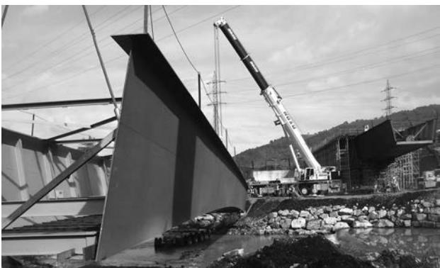
Figura 19. Izado del tramo central metálico.
