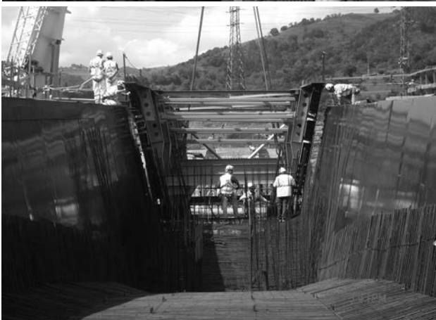
Figuras 14a y 14b. Izado y colocación del primer tramo metálico.
