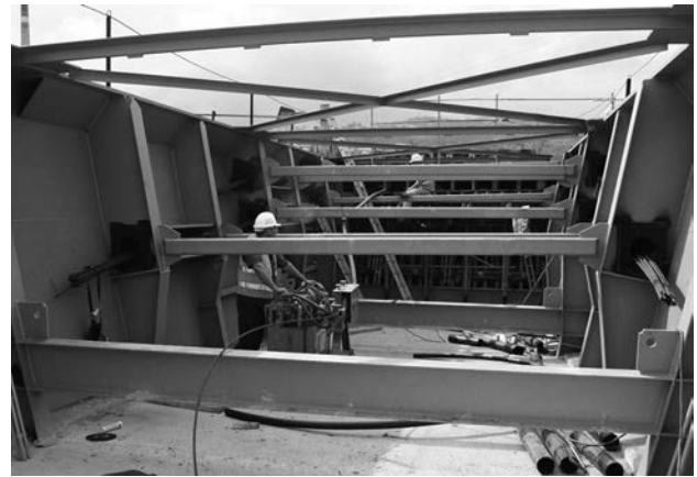
Figura 33. Vista interior de los anclajes de pretensado con los tubos de arriostramiento de rigidizadores.
