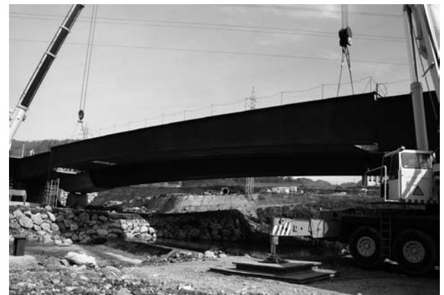
Figuras 27a y 27b. Izado y colocación del tramo central del segundo viaducto.
