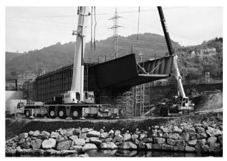
Figura 17. Vista del voladizo pretensado y desapeado.
