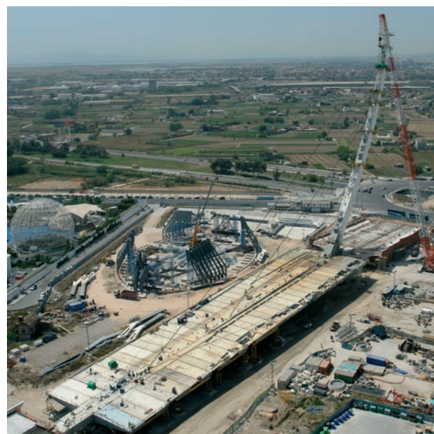
Figura 27. Situación de montaje con los tres tirantes provisionales. Figure 27. Erection stage with three provisional stays.
