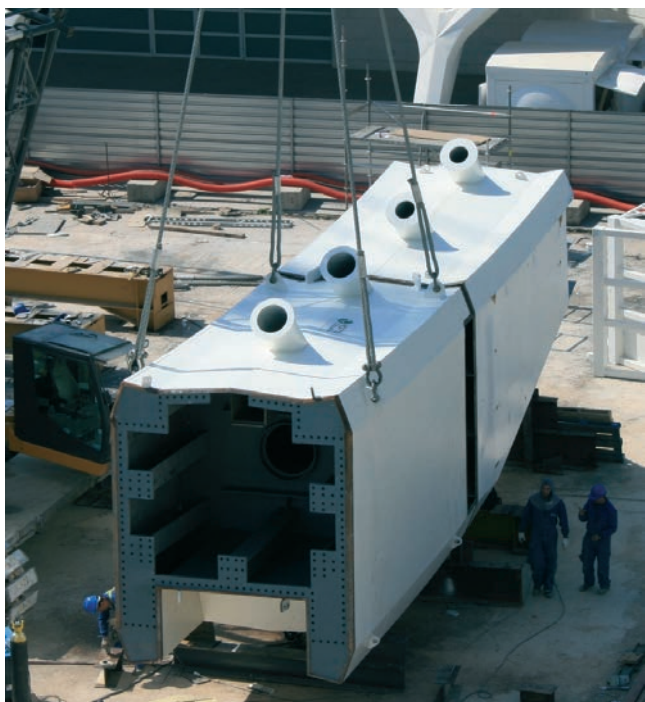
Figura 25. Dovela de pilono. Figure 25. Pylon erection unit.
