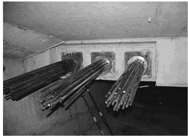
Figura 7. Vista de anclajes de pretensado en cuñas
