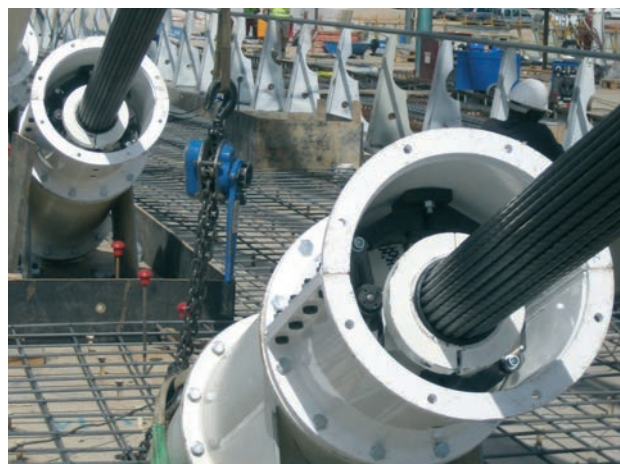
Figura 34. Amortiguador ya montado. Figure 34. Damper on site.
