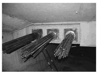
Figura 7. Vista de anclajes de pretensado en cuñas
