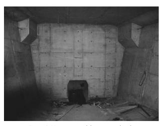
Figura 8. Vista interior del mamparo de pila con paso de hombre.
