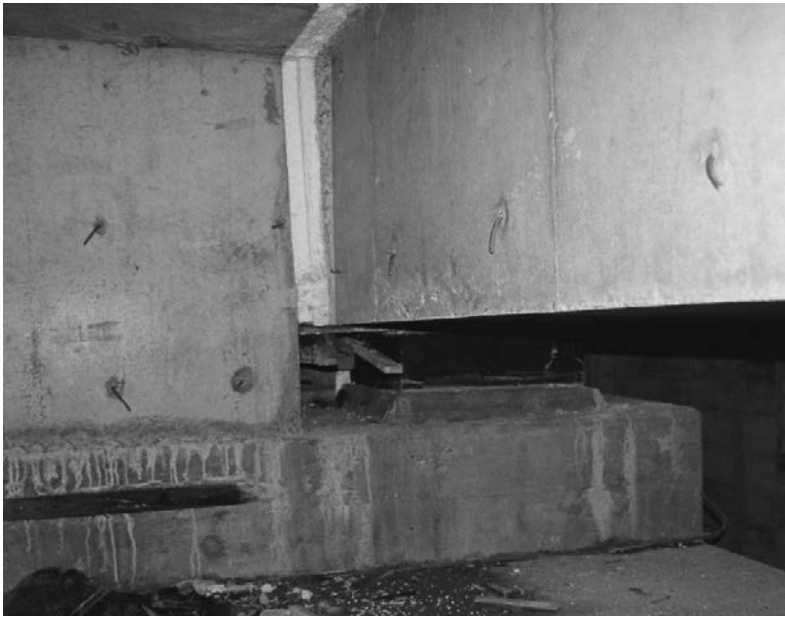
Figura 10 a. Vista de uno de los apoyos inversos desde el interior del cajón de hormigón.
