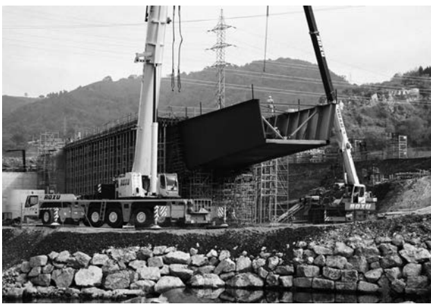
Figura 17. Vista del voladizo pretensado y desapeado.
