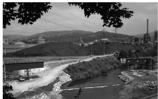
Figura 15. Vista de los 2 tramos laterales metálicos apeados.
