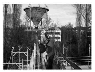
Figura 18. Hormigonado con cuba y tubería.
