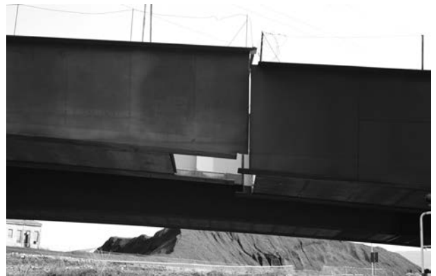
Figura 21. Detalle del momento de colocación del tramo central
