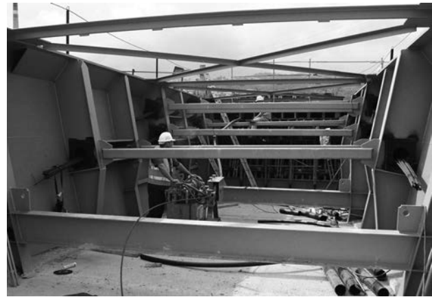
Figura 33. Vista interior de los anclajes de pretensado con los tubos de arriostramiento de rigidizadores.
