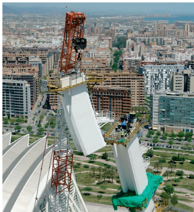
Figura 26. Montaje de dovela de pilono. Figure 26. Erection of pylon unit
