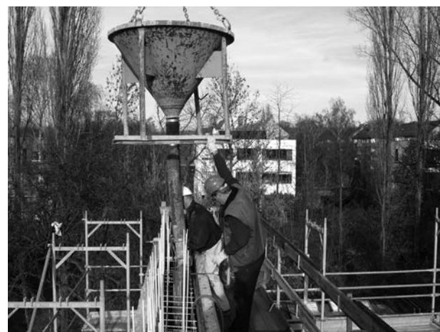
Figura 18. Hormigonado con cuba y tubería.
