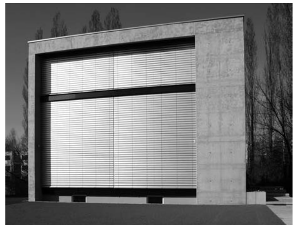
Figura 27. Vivienda terminada con persianas.
