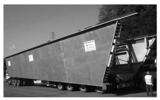
Figura 13. Transporte del primer tramo metálico.
