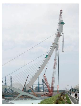
Figura 28. Montaje de tubos de retenida. Figure 28. Erection of back stay steel tubes.
