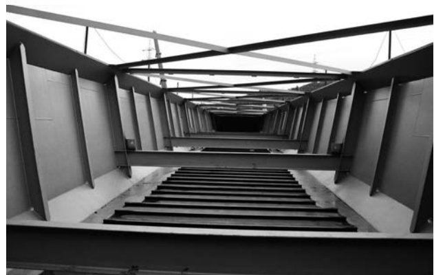
Figura 22. Vista interior del centro de vano.
