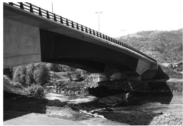
Figura 28. Vista inferior de los dos viaductos concluidos.
