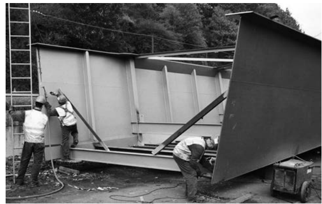
Figura 20. Corte de demasías en el tramo central.
