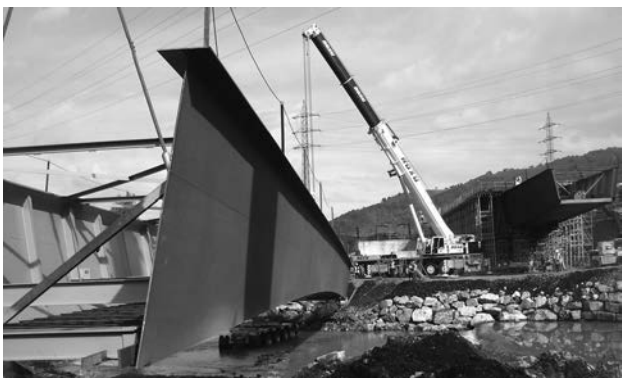
Figura 19. Izado del tramo central metálico.
