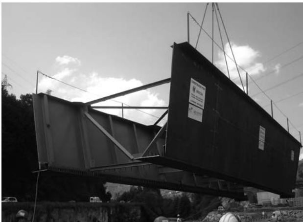
Figura 13. Transporte del primer tramo metálico.
