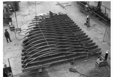
Cubierta del Ayuntamiento de Cabanillas (Madrid)
