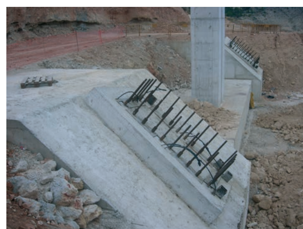
Figura 11. Cimentación de los arcos Figure 11. Arch foundations
