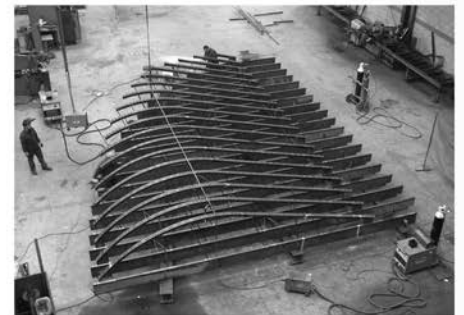
Cubierta del Ayuntamiento de Cabanillas (Madrid)
