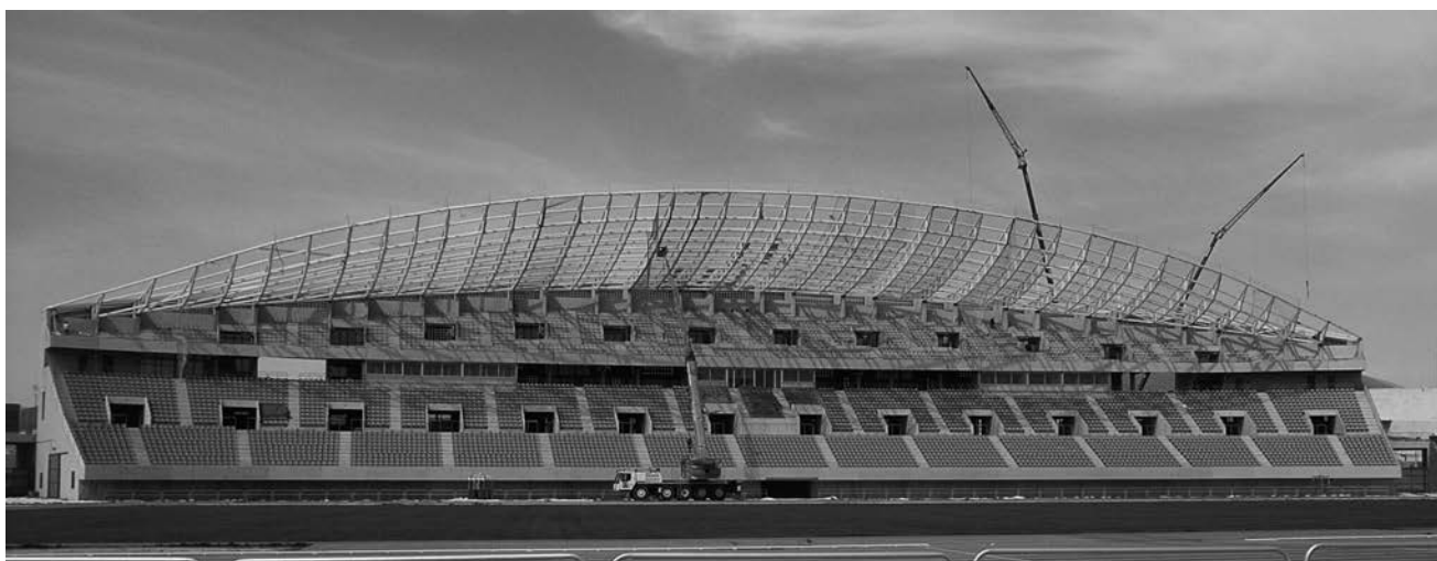
Figure 27. Aspecto de conjunto de la malla terminada
