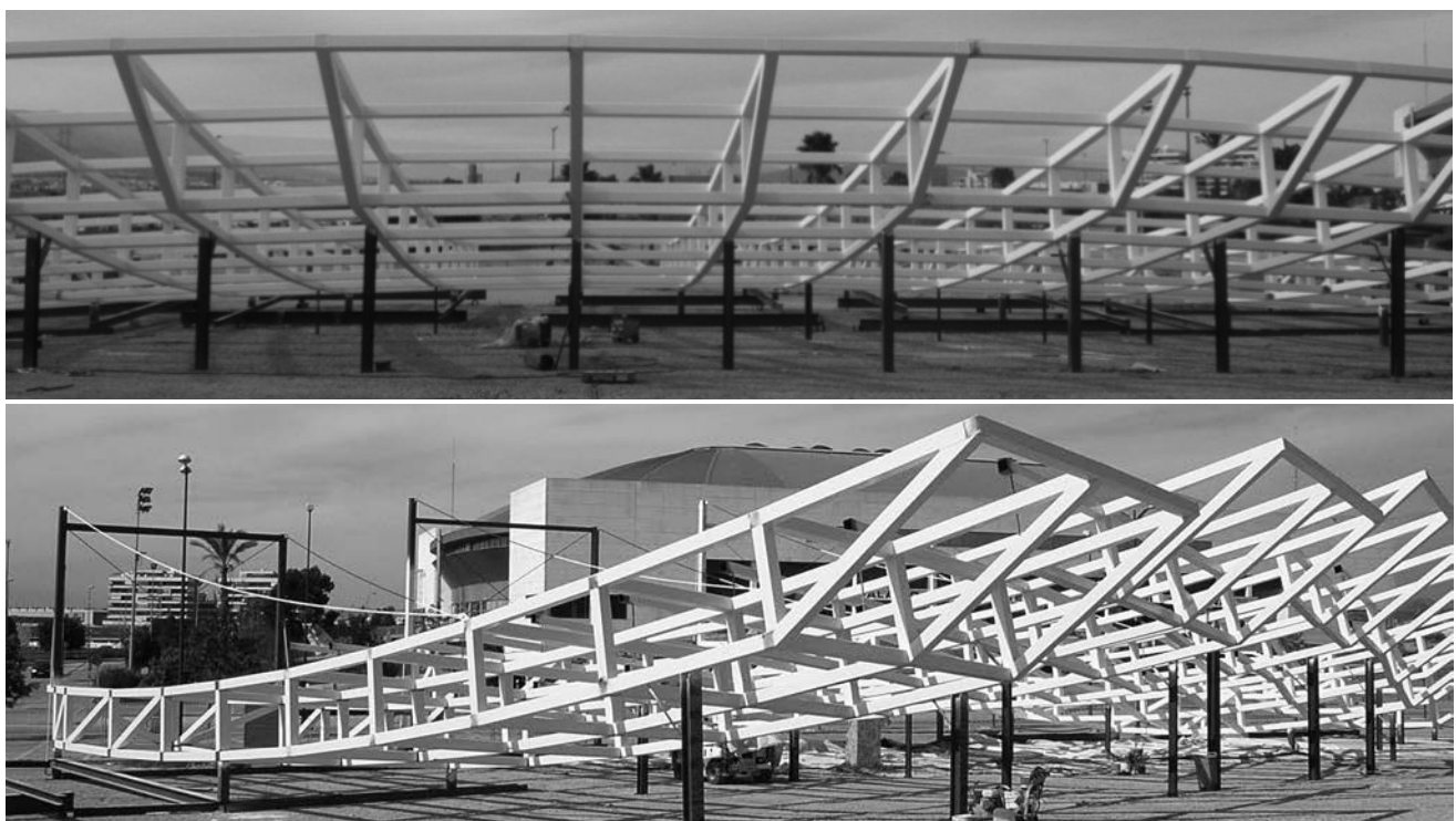
Figura 16. Premontaje por módulos de la estructura en la explanada delantera
