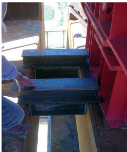
Figura 22. Topes de junta después izado Figure 22. Joint stops after hoisting
