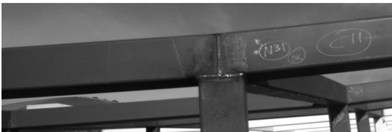
Figura 24. Control de las soldaduras en nudos
