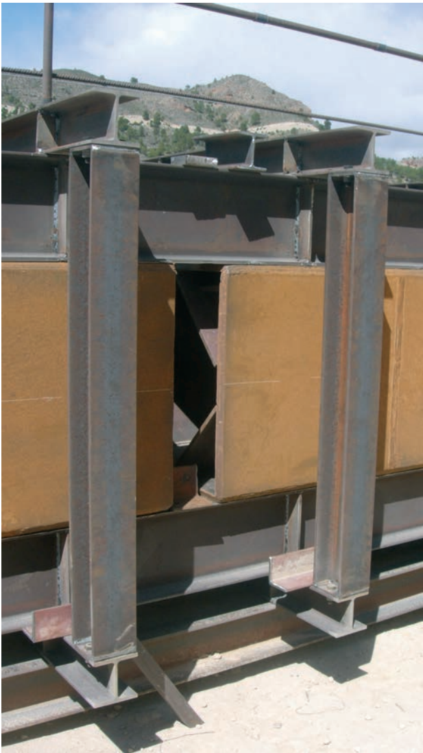
Figura 51. Apertura de riostra Figure 51. Gap in brace
