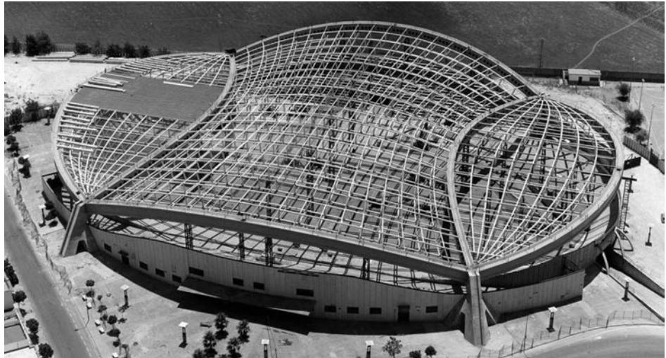
Figure 4. Malla Vierendeel de dos direcciones para cubrir el Velódromo de Dos Hermanas
