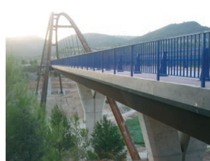
Figura 30. Imposta metálica Figure 30. Steel railing
