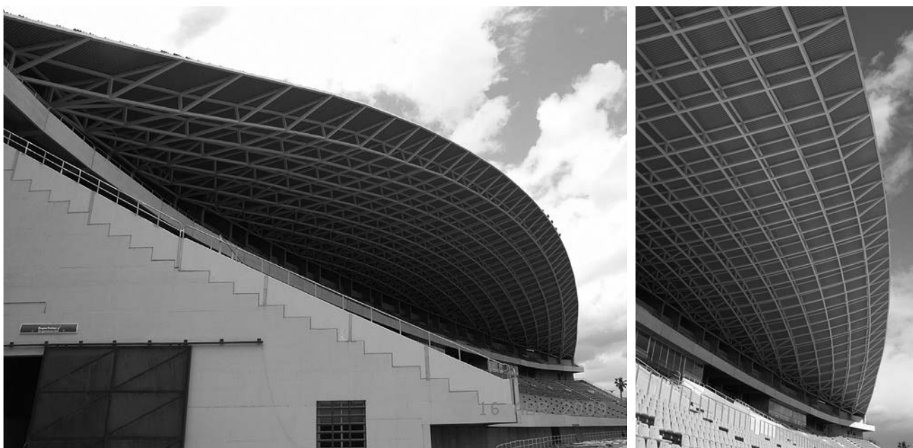
Figuras 30 y 31. Vistas de detalle de la cubierta terminada
