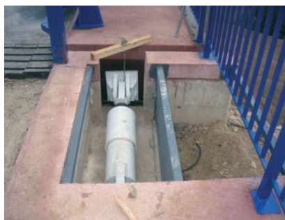
Figura 29. Amortiguador Figure 29. Damper
