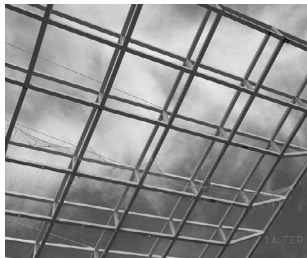
Figura 23. Aspecto flotante de la malla durante el montaje
