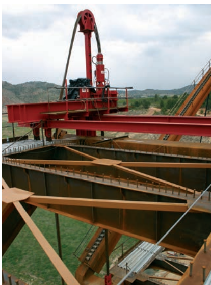
Figura 19. Gatos de izado Figure 19. Hoisting jacks
