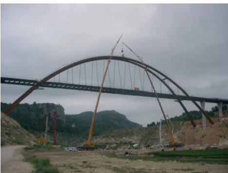
Figura 25. Hormigonado de una fase del arco Figure 25. Concrete casting in the arch
