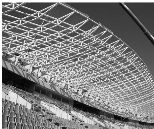
Figura 26. Conjunto casi acabado de la malla de cubierta
