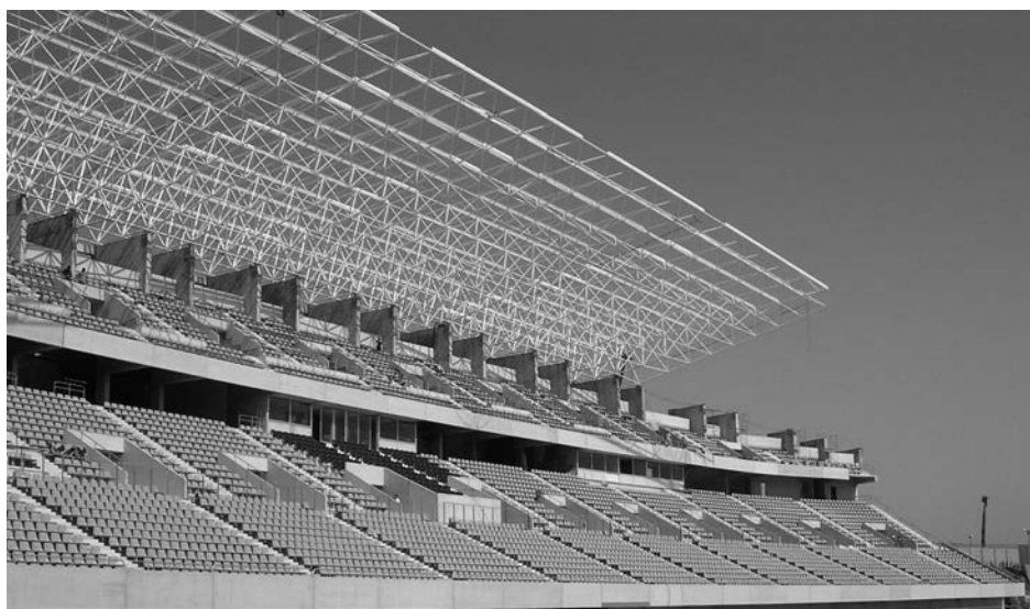
Figura 2. Estructura anterior apoyada sobre pantallas radiales
