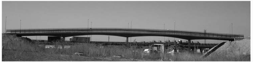
Pasarela peatonal en Alcorcón (Madrid)
