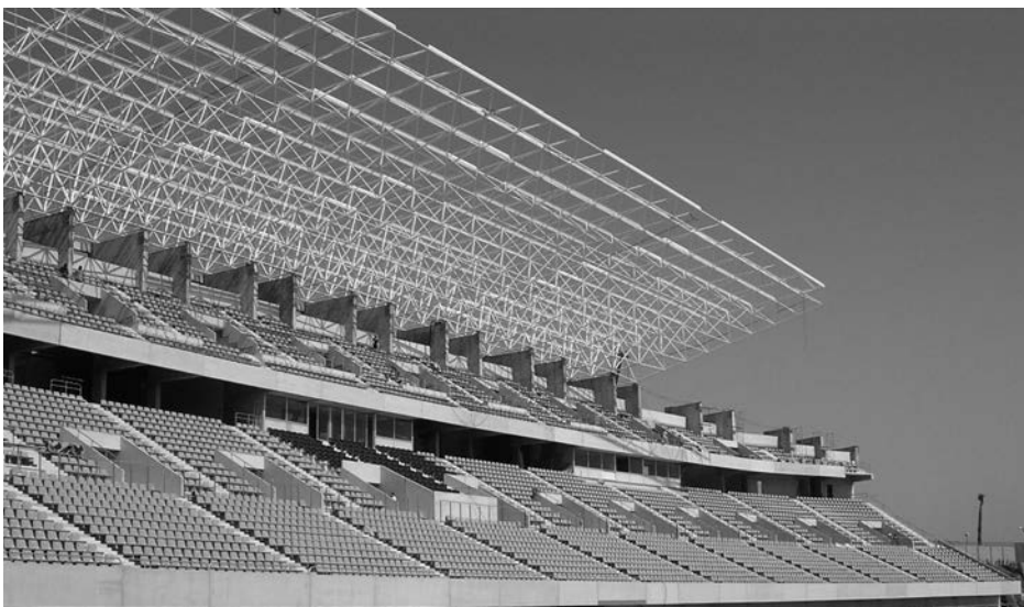
Figura 2. Estructura anterior apoyada sobre pantallas radiales
