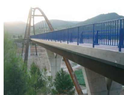
Figura 30. Imposta metálica Figure 30. Steel railing
