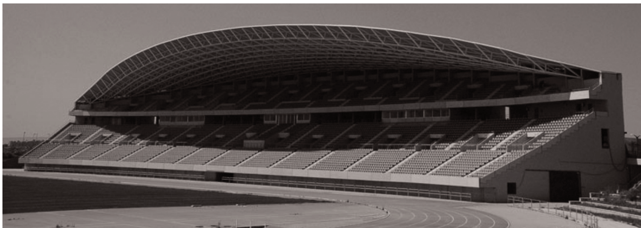
Figura 29. Vista en escorzo de la cubierta terminada
