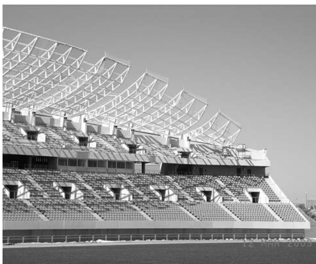
Figura 22. Grupos aislados de módulos durante el montaje, todos estabilizados desde atrás
