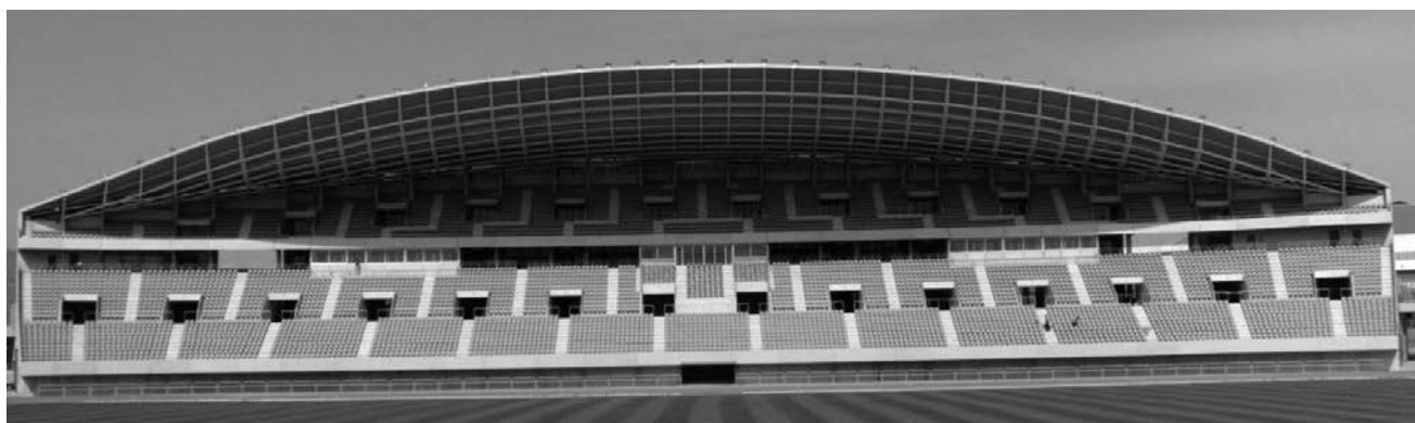
Figura 28. Vista general de la cubierta terminada con los focos instalados en el borde
