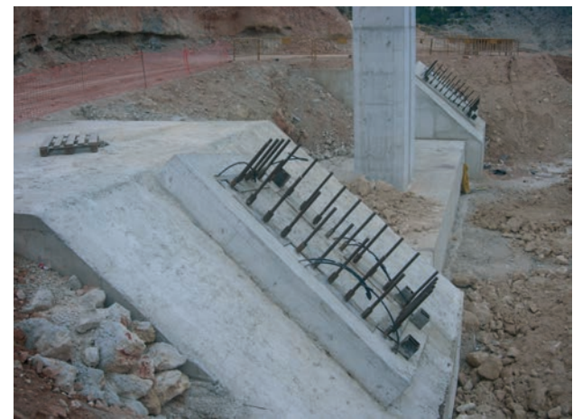
Figura 11. Cimentación de los arcos Figure 11. Arch foundations
