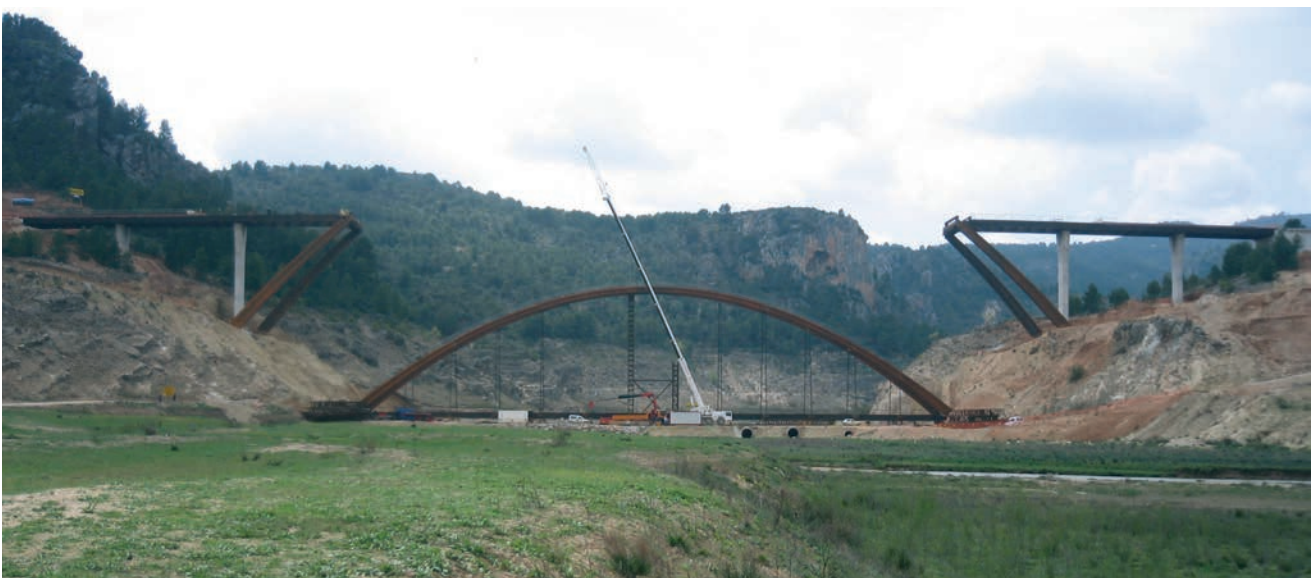
Figura 12. Montaje de la estructura metálica, con el bowstring y los voladizos laterales Figure 12. Steel structure assembly: bowstring and side cantilevers
