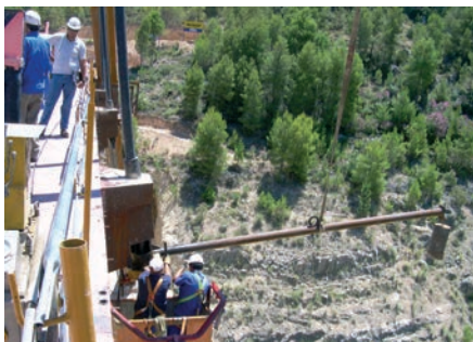
Figura 28. Control de carga en las péndolas Figure 28. Monitoring load on hangers
