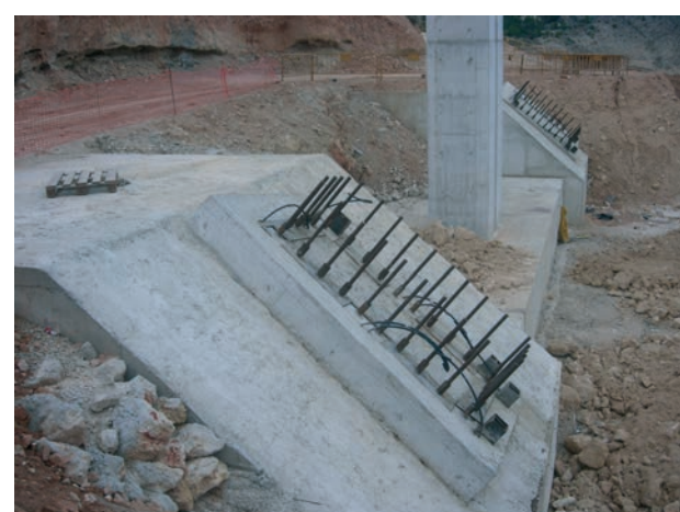
Figura 11. Cimentación de los arcos Figure 11. Arch foundations
