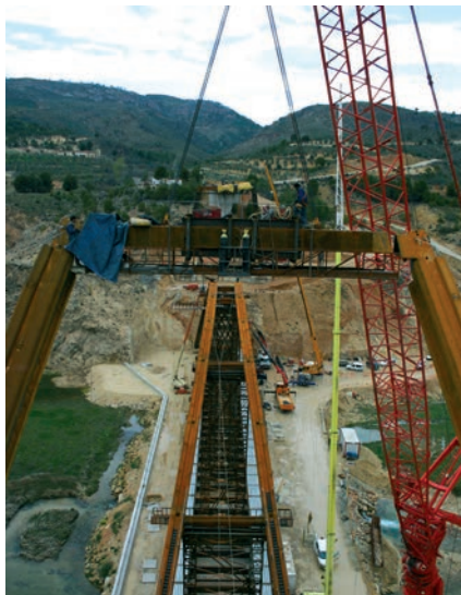
Figura 17. Voladizo (II). Riostra de voladizo Figure 17. Cantilever (II). Cantilever brace
