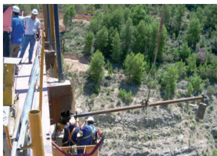
Figura 28. Control de carga en las péndolas Figure 28. Monitoring load on hangers
