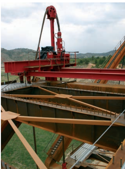
Figura 19. Gatos de izado Figure 19. Hoisting jacks
