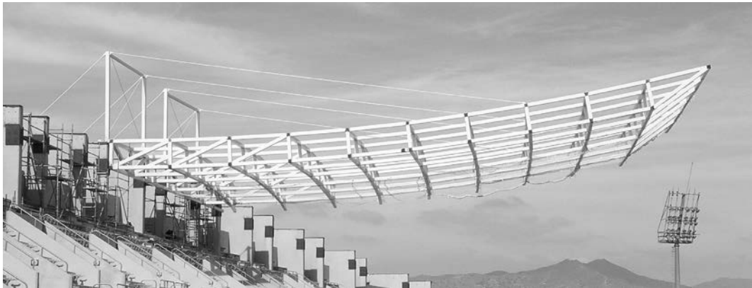
Figura 18. Cubierta durante su fase de trabajo en ménsula durante el montaje, mediante atirantamiento trasero
