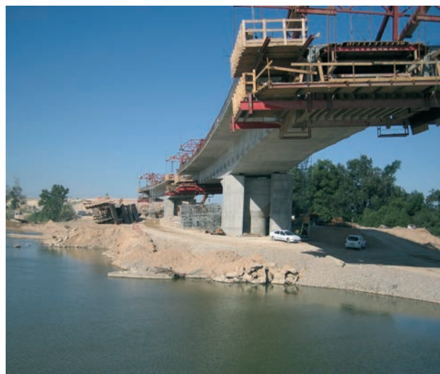
Figura 22. Avance en voladizo
