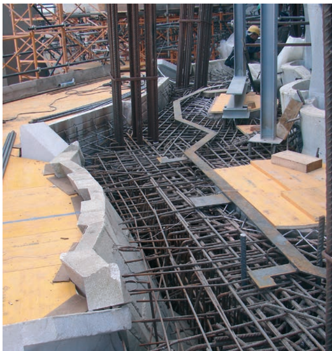
Figura 29. Ábside: a) armado de la base y b) armado del paramento Figure 29. Concrete placement in apse: a) base and b) wall reinforcement
