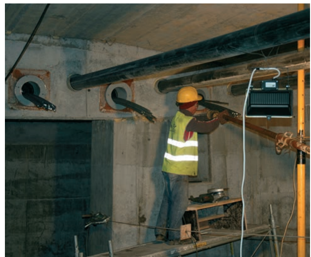
Figura 32. Enfilado de pretensado exterior
