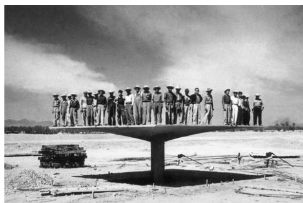
Figura 3. Prototipo experimental de "Paraguas" Las Aduanas, México 1953.
