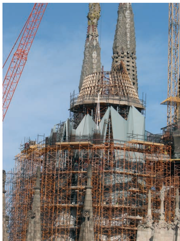
Figura 23. Construcción del ábside: a) primeros pisos y b) cimbra del hiperboloide central ya colocada Figure 23. Apse construction: a) first storeys and b) hyperboloid formwork in place
