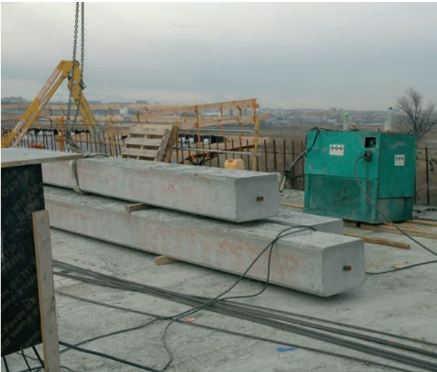
Figura 28. Jabalcones acopiados sobre el tablero
