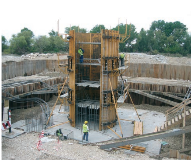
Figura 19. Encofrado de fuste
