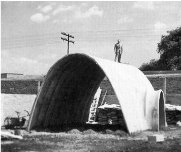
Figura 1. Bóveda Ctesiphon. San Bartolo. México 1949
