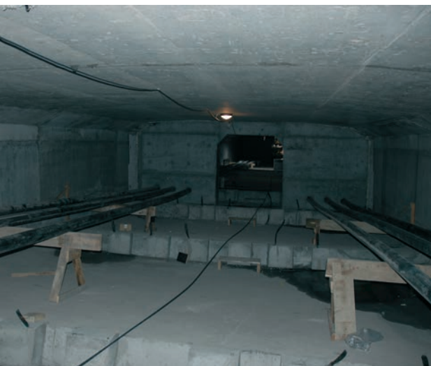
Figura 31. Montaje de vainas de pretensado exterior
