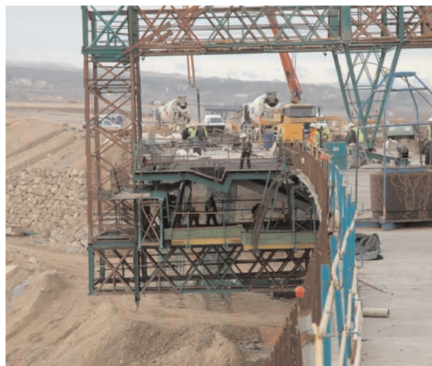
Figura 26. Detalle de brazo de encofrado 2ª fase
