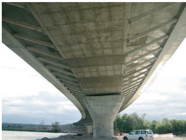
Figura 9. Tablero. Vista inferior
