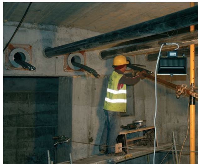
Figura 32. Enfilado de pretensado exterior
