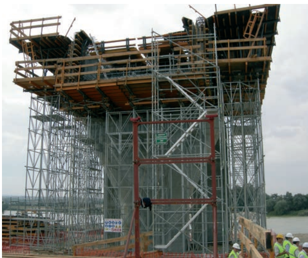
Figura 21. Cimbra de dovela 0
