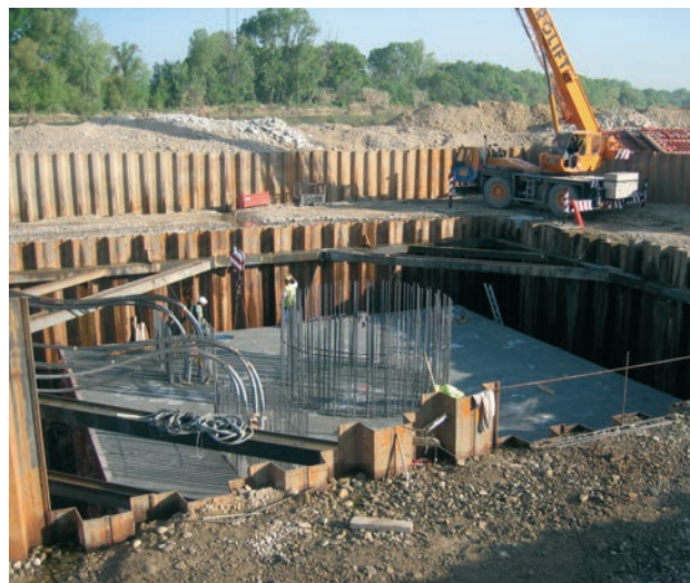
Figura 18. Encepado de pilas
