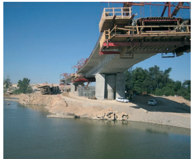
Figura 22. Avance en voladizo
