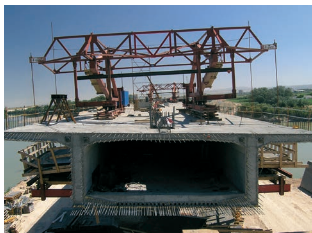
Figura 24. Vista del núcleo en 1ª fase
