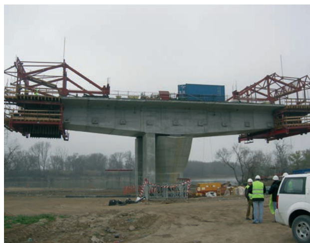
Figura 23. Avance en voladizo simétrico
