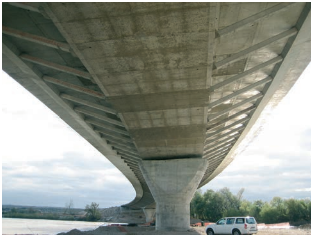
Figura 9. Tablero. Vista inferior
