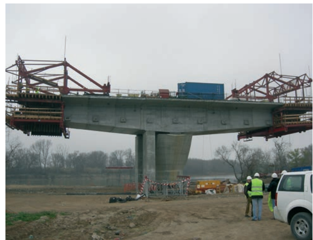
Figura 23. Avance en voladizo simétrico
