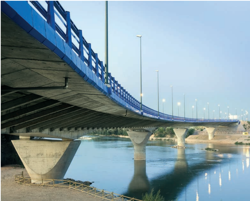
Figura 37. Vista del viaducto terminado
