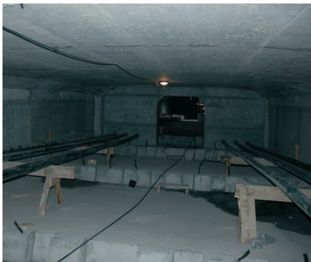
Figura 31. Montaje de vainas de pretensado exterior
