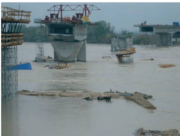
Figura 35. Riada durante construcción
