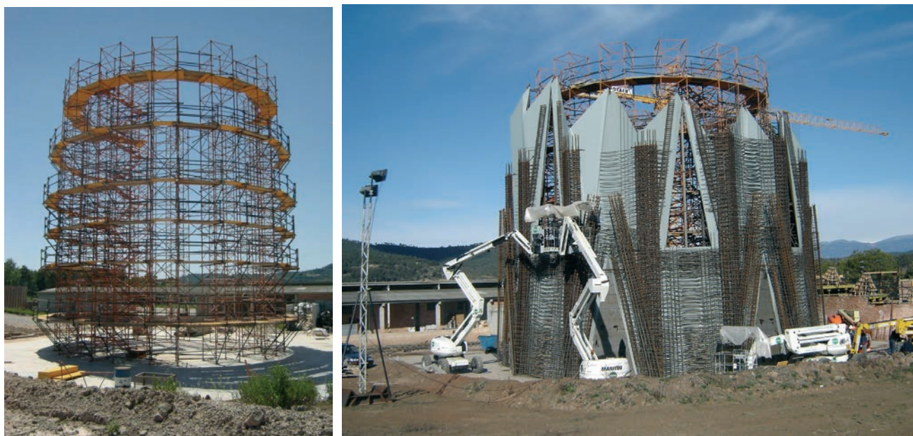
Figura 26. a) Estructura auxiliar de soporte y b) colocación del armado de los muros del ábside. Fuente: ATESF Figure 26. a) Ancillary support structure and b) placement of the reinforcement for the apse walls. Source: ATESF
