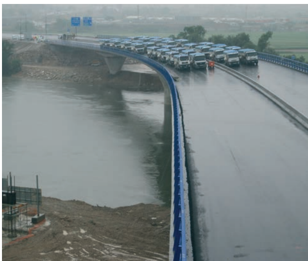
Figura 33. Prueba de carga
