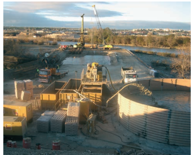
Figura 16. Balsa de lodos para ejecución de pilotes
