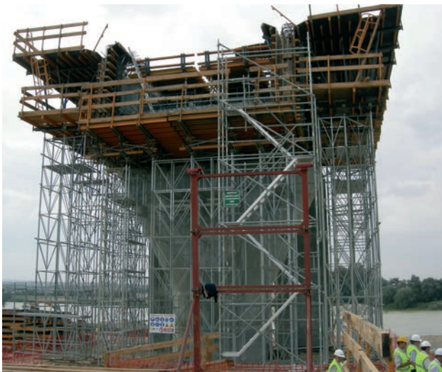
Figura 21. Cimbra de dovela 0
