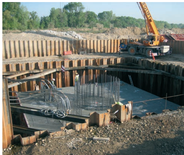
Figura 18. Encepado de pilas
