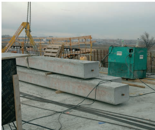
Figura 28. Jabalcones acopiados sobre el tablero
