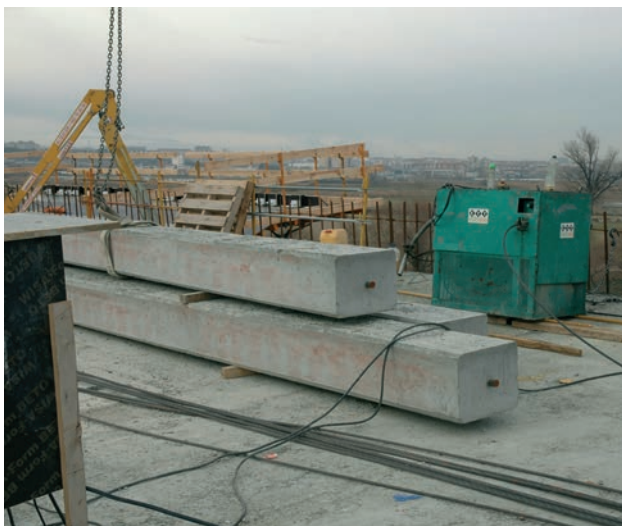
Figura 28. Jabalcones acopiados sobre el tablero
