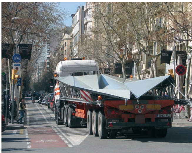
Figura 28. Armado y encofrado: a) transporte y b) colocación. Fuente ATESF Figure 28. Reinforcement and formwork: a) transport and b) placement. Source: ATESF
