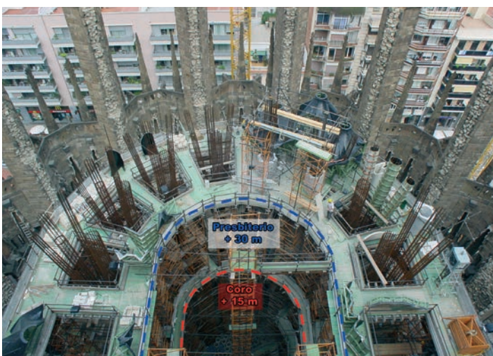
Figura 23. Construcción del ábside: a) primeros pisos y b) cimbra del hiperboloide central ya colocada Figure 23. Apse construction: a) first storeys and b) hyperboloid formwork in place
