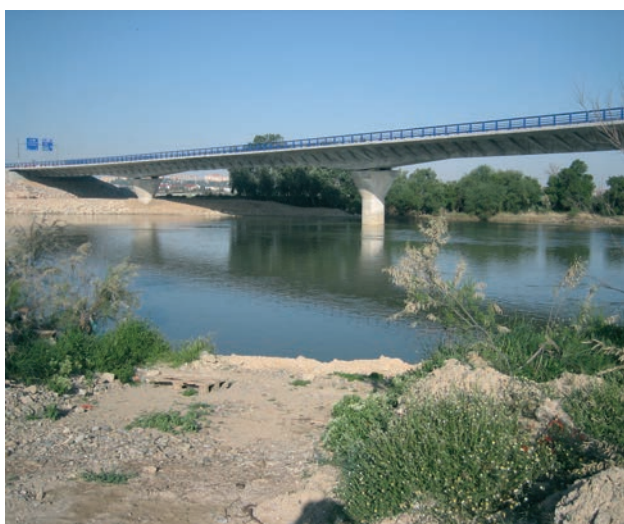
Figura 36. Vista del viaducto terminado
