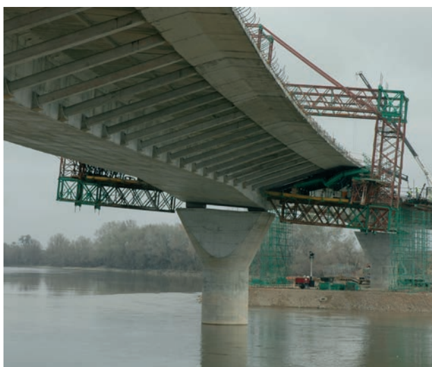
Figura 27. Vista inferior del tablero durante la ejecución de los voladizos laterales
