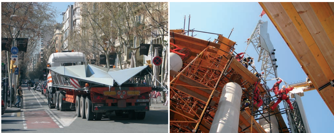
Figura 28. Armado y encofrado: a) transporte y b) colocación. Fuente ATESF Figure 28. Reinforcement and formwork: a) transport and b) placement. Source: ATESF
