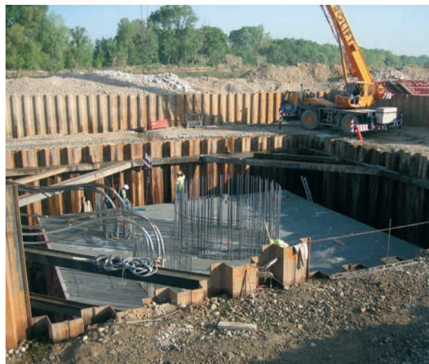
Figura 18. Encepado de pilas
