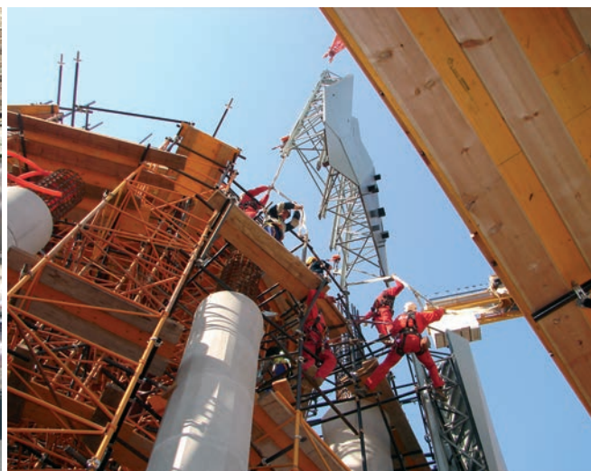
Figura 28. Armado y encofrado: a) transporte y b) colocación. Fuente ATESF Figure 28. Reinforcement and formwork: a) transport and b) placement. Source: ATESF
