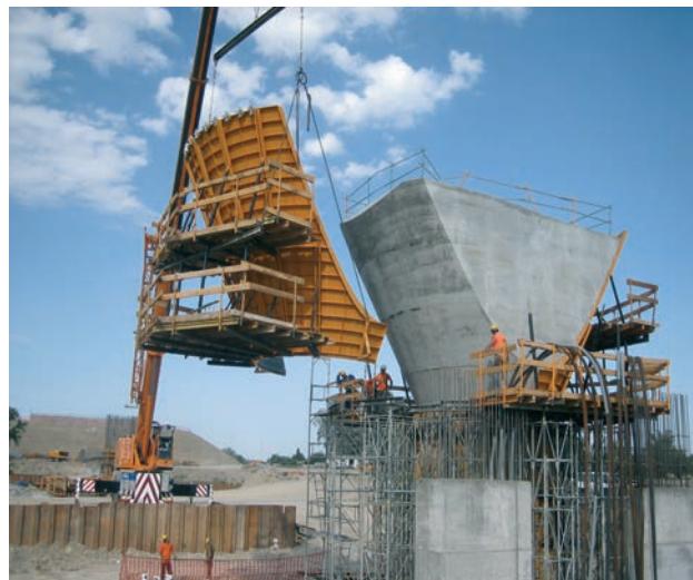
Figura 20. Encofrado de capitel
