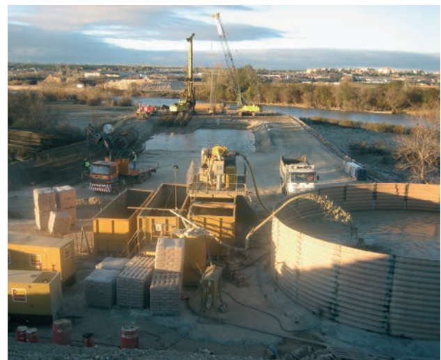
Figura 16. Balsa de lodos para ejecución de pilotes
