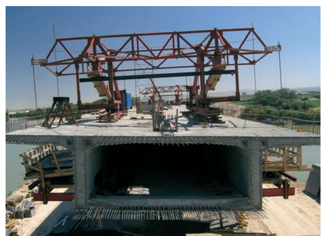
Figura 24. Vista del núcleo en 1ª fase
