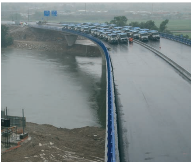
Figura 33. Prueba de carga
