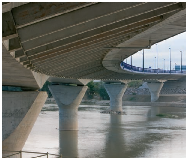
Figura 34. Vista inferior de tablero con drenaje
