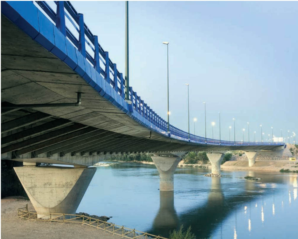
Figura 37. Vista del viaducto terminado
