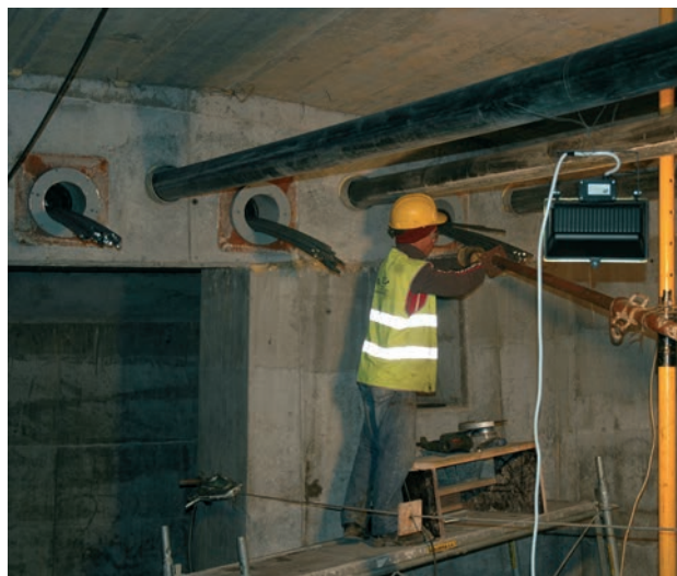
Figura 32. Enfilado de pretensado exterior
