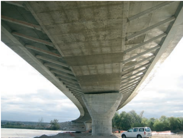
Figura 9. Tablero. Vista inferior
