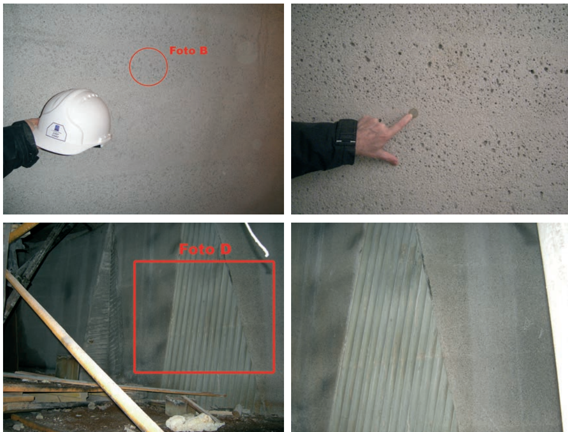
Figura 21. Pruebas de acabado: a y b) de HAC y c y d) HAR. Fuente propia Figure 21. Finishing tests: a) and b) SCC finishing and c) and d) HSC finishing. Source: authors
