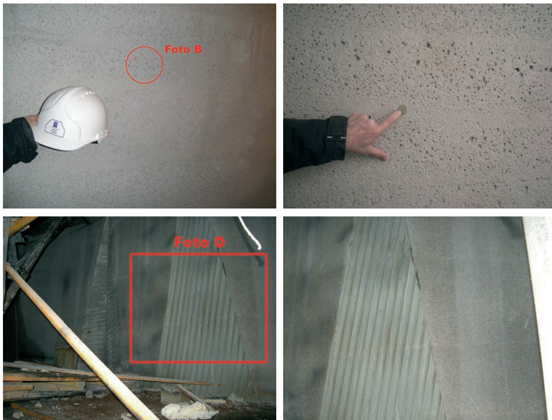
Figura 21. Pruebas de acabado: a y b) de HAC y c y d) HAR. Fuente propia Figure 21. Finishing tests: a) and b) SCC finishing and c) and d) HSC finishing. Source: authors
