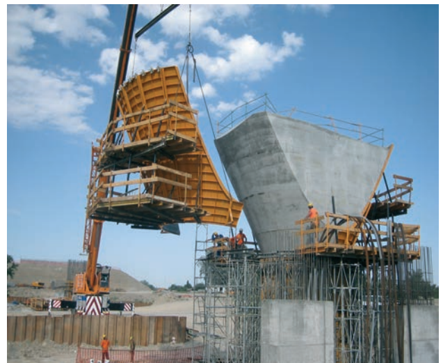
Figura 20. Encofrado de capitel
