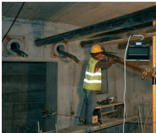
Figura 32. Enfilado de pretensado exterior
