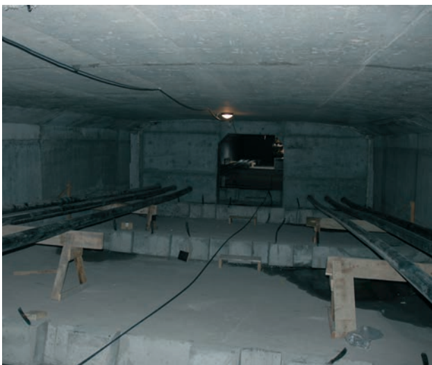
Figura 31. Montaje de vainas de pretensado exterior
