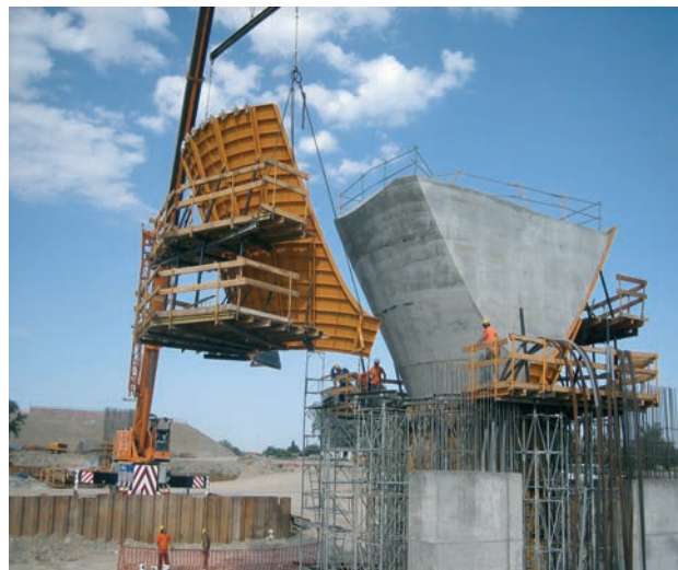
Figura 20. Encofrado de capitel
