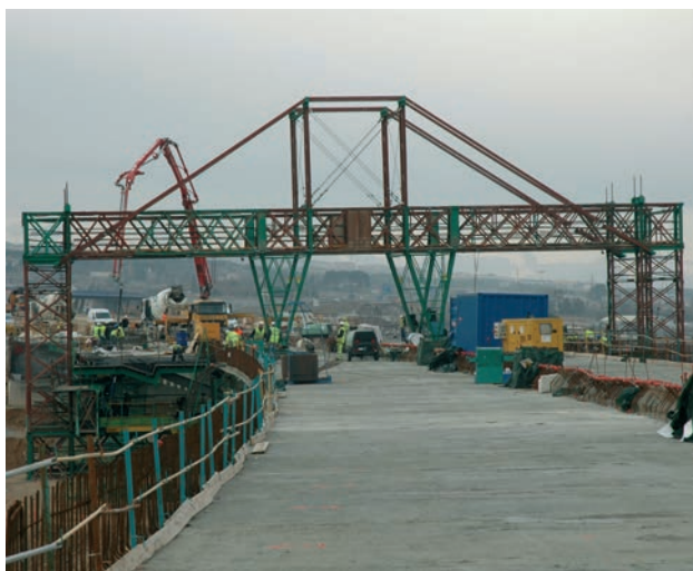
Figura 25. Carro de encofrado de voladizos
