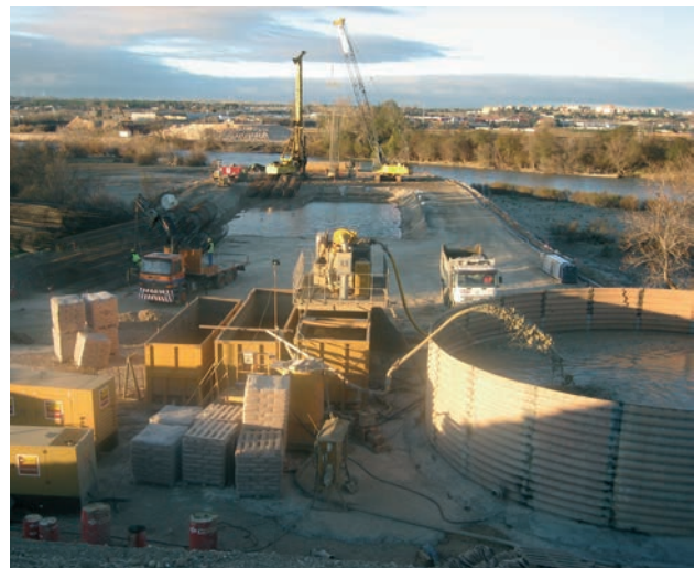
Figura 16. Balsa de lodos para ejecución de pilotes
