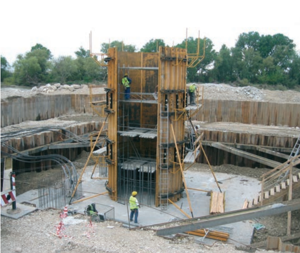
Figura 19. Encofrado de fuste
