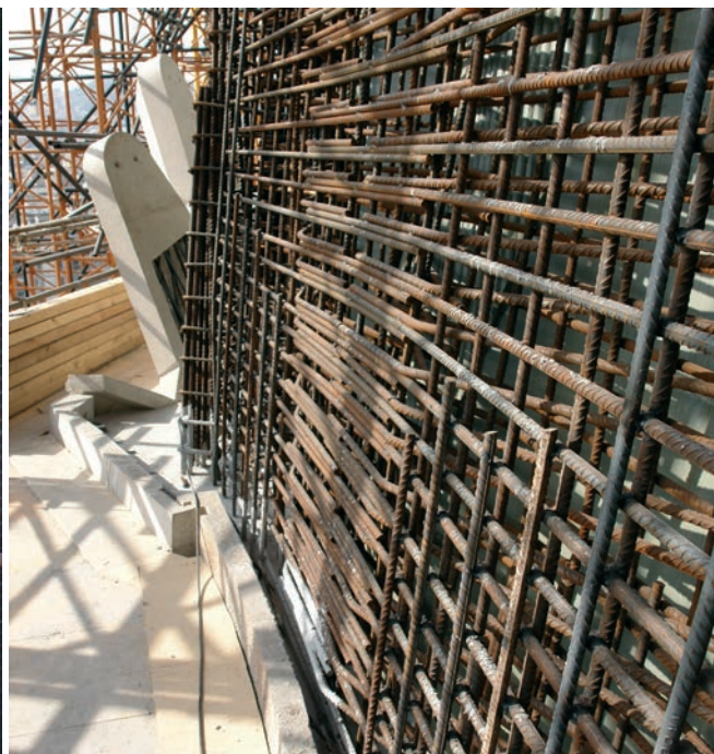
Figura 29. Ábside: a) armado de la base y b) armado del paramento Figure 29. Concrete placement in apse: a) base and b) wall reinforcement
