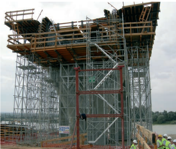
Figura 21. Cimbra de dovela 0
