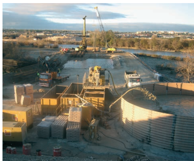
Figura 16. Balsa de lodos para ejecución de pilotes
