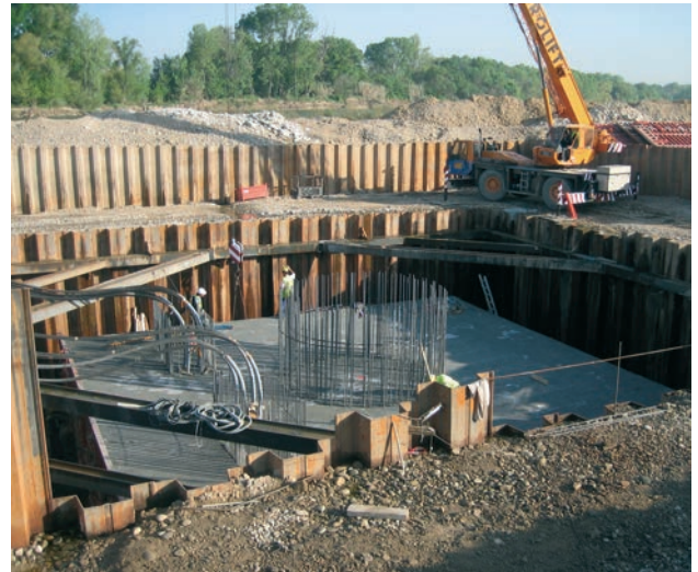
Figura 18. Encepado de pilas
