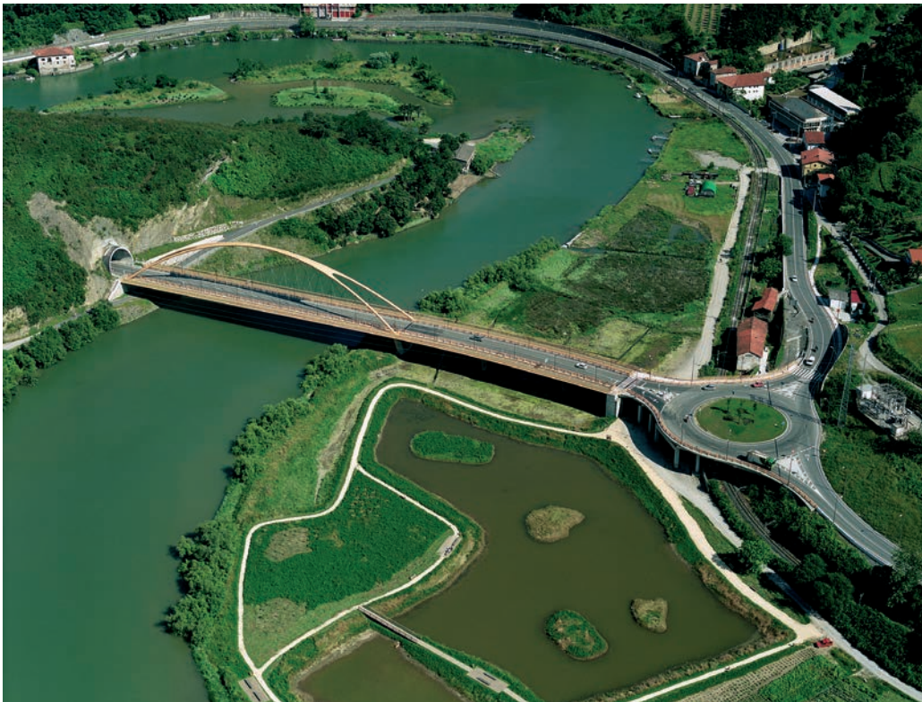
Figura 8. Vista aérea del puente y del viaducto de acceso Figure 8. Bird's eye view of the bridge and the access viaduct
