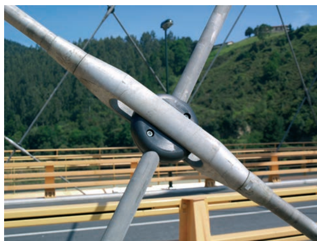
Figura 21b. Detalle de dispositivo de cruce de péndolas Figure 21b. Hanger crossing device close-up
