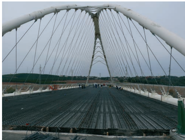
Figuras 42a y 42b. Vista durante las operaciones de colocación de prelosas en el tablero y con el tablero ferrallado Figures 42a and 42b. Views of the precast slabs placing and of the deck alter the reinforcement being assembled
