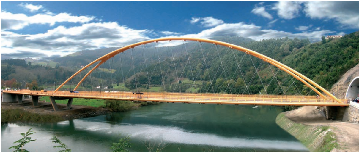
Figura 11. Vista desde aguas abajo Figure 11. Downstream view
