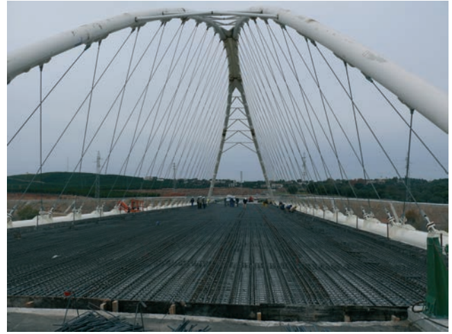
Figuras 42a y 42b. Vista durante las operaciones de colocación de prelasas en el tablero y con el tablero ferrallado Figures 42a and 42b. Views of the precast slabs placing and of the deck alter the reinforcement being assembled
