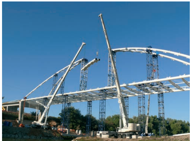
Figuras 41a y 41b. Vista durante las operaciones de izado de los arcos, y fase de cierre en clave de los arcos Figures 41a and 41b. Views of arch segments erection and arch crown closure
