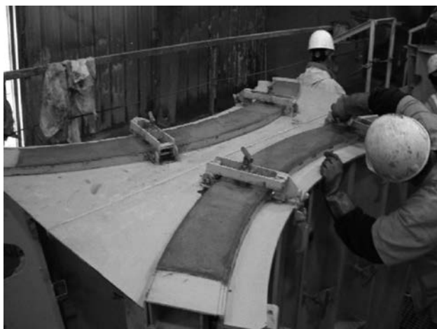
Figura 6. Detalle del acabado superficial superior
