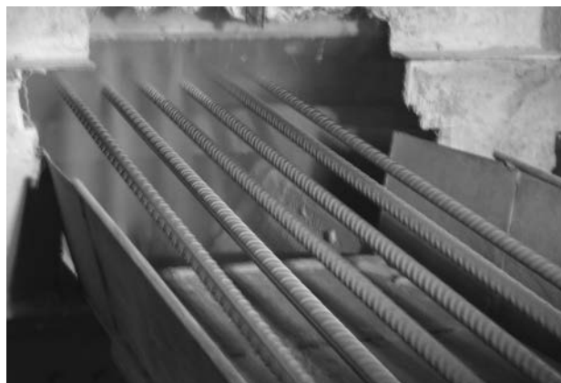
Figura 2. Proceso de recubrimiento de las armaduras mediante aplicación de un spray cargado electrostáticamente
