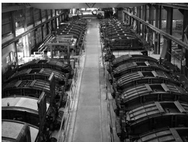
Figura 3. Vista general de la planta
