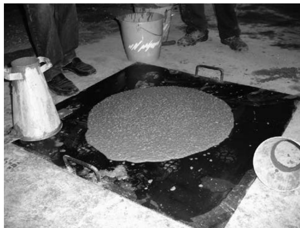
Figura 7. Dosificación 1: vista general del ensayo de extensión de flujo
