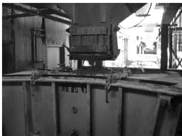
Figura 5. Detalle del hormigonado con molde vertical
