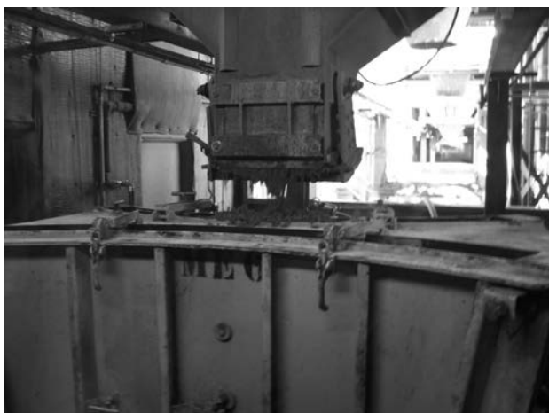
Figura 5. Detalle del hormigonado con molde vertical
