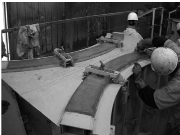
Figura 6. Detalle del acabado superficial superior
