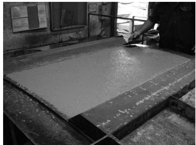
Figura 14. Enrasado de una de las dovelas producidas con la dosificación 3
