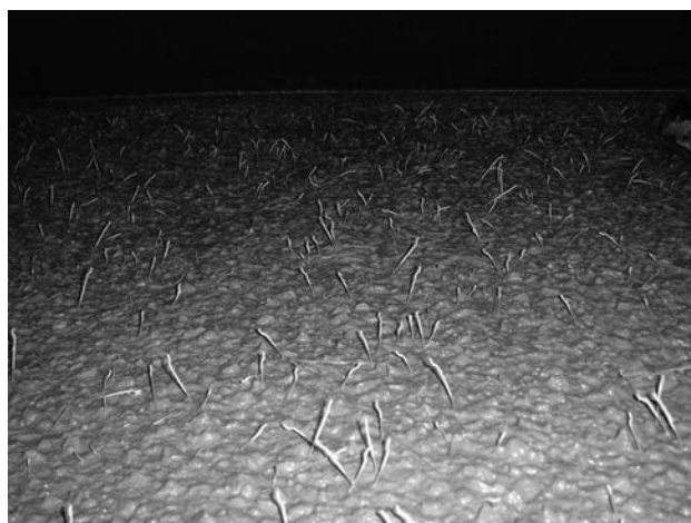
Figura 12. Distribución de las fibras en el hormigón en el interior del molde
