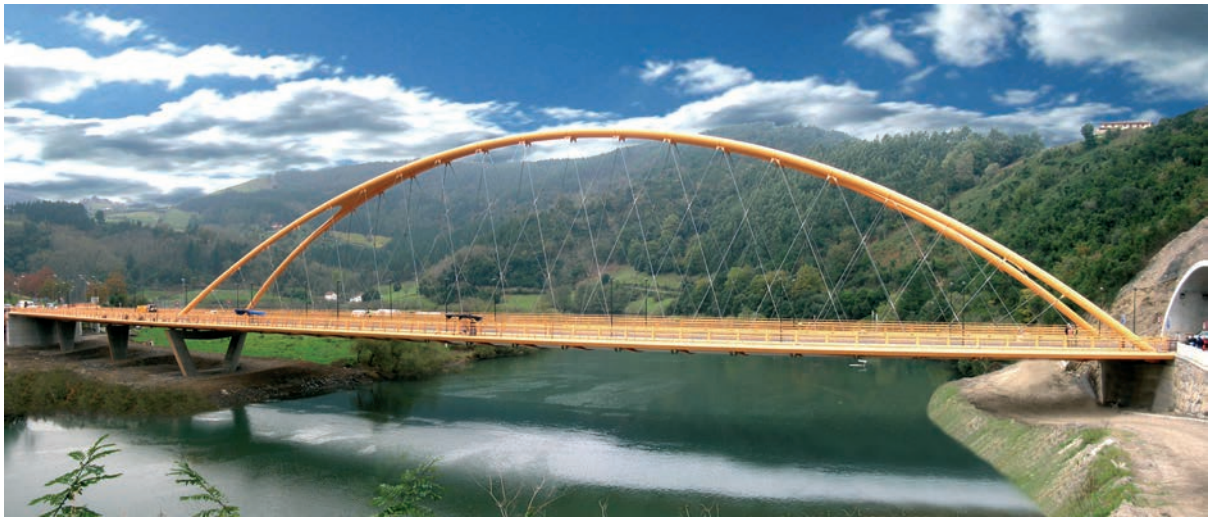
Figura 11. Vista desde aguas abajo Figure 11. Downstream view
