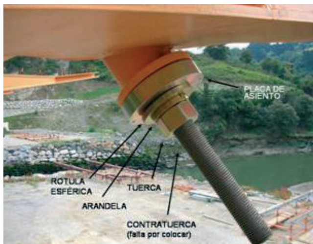
Figura 23. Anclaje inferior de las péndolas a las costillas transversales del tablero Figure 23. Lower (hanger-deck rib) anchorage
