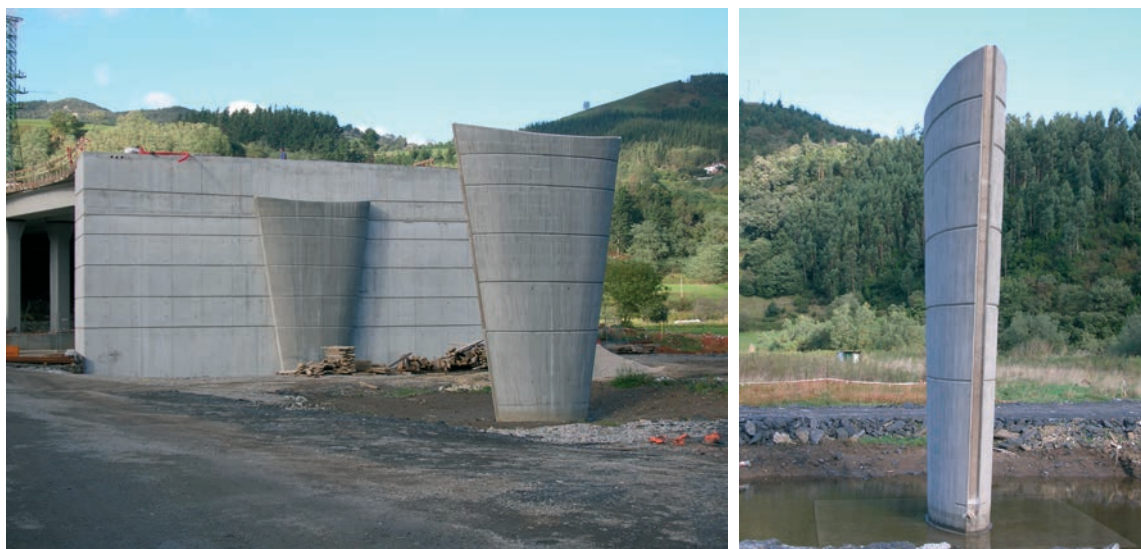
Figuras 24a y 24b. Pilas de los vanos de acceso (estribo 1 al fondo) Figures 24a and 24b. Access viaduct piers (abutment 1 on the background)
