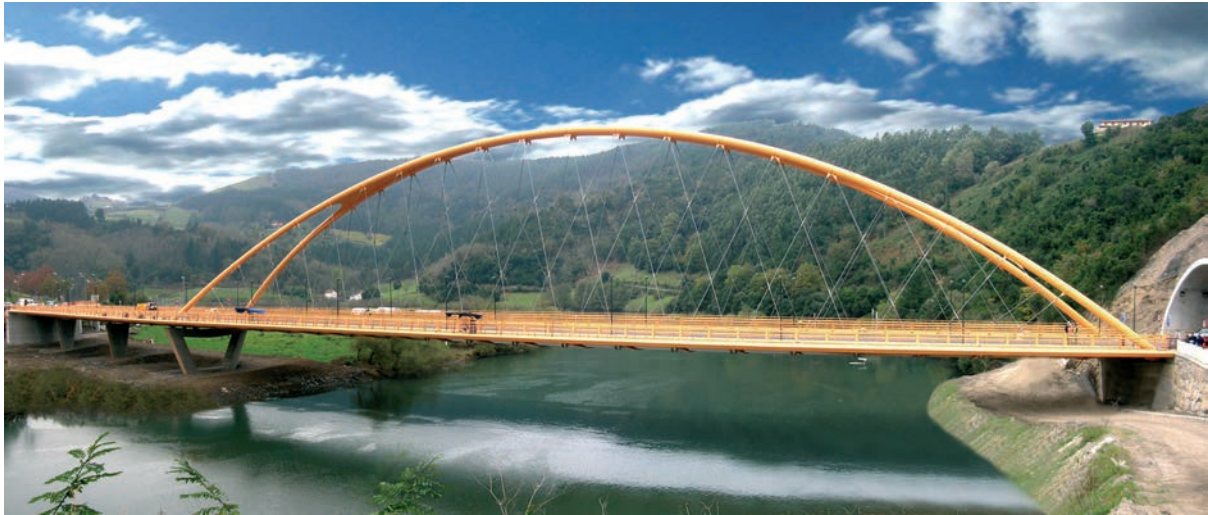
Figura 11. Vista desde aguas abajo Figure 11. Downstream view
