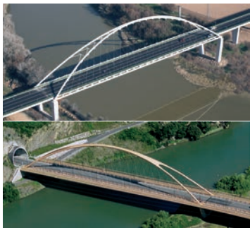
Foto de portada: Puente de Palma de Río (superior) Puente de Deba (inferior)
