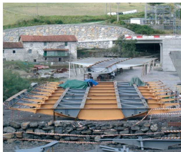
Figura 16. Vista del tablero del puente arco, en primer término, y del tablero del viaducto de acceso al fondo, previa a su colocación
