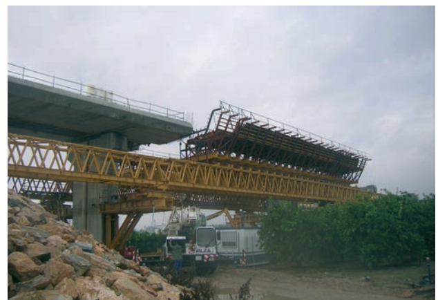
Figuras 30a y 30b. Sección transversal de la losa ampliada y vista durante la ejecución con autocimbra Figures 30a y 30b. Slab cross-section after widening and view of erection with falsework
