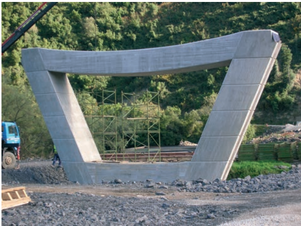
Figura 25. Pila de apoyo de los vanos de acceso y el arco Figure 25. Common pier for access viaduct and arch bridge
