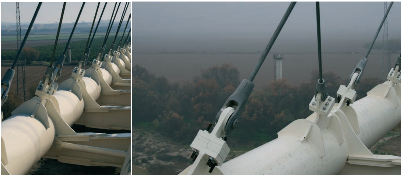
Figuras 33a y 33b. Detalles de anclajes de péndolas inferiores y arranques de vigas transversales dispuestas cada 5 m en el tablero Figures 33a and 33b. Details of hanger anchorage and transverse girders ends at 5 m intervals along the bridge
