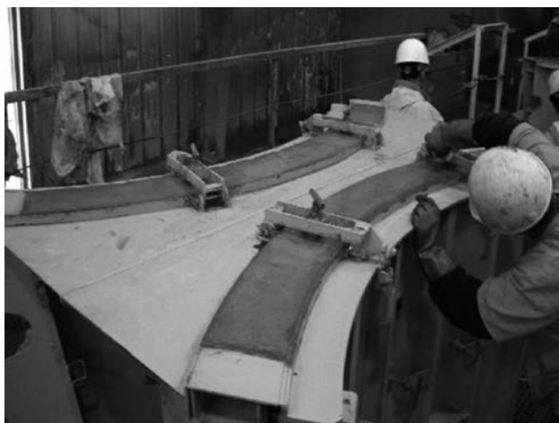
Figura 6. Detalle del acabado superficial superior
