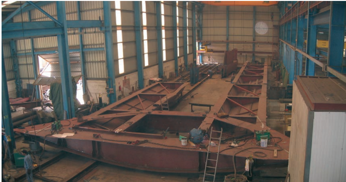
Figura 17a. Fabricación en taller de la riostra extrema del tablero Figure 17a. Deck's end diaphragm assembly at the steelworks
