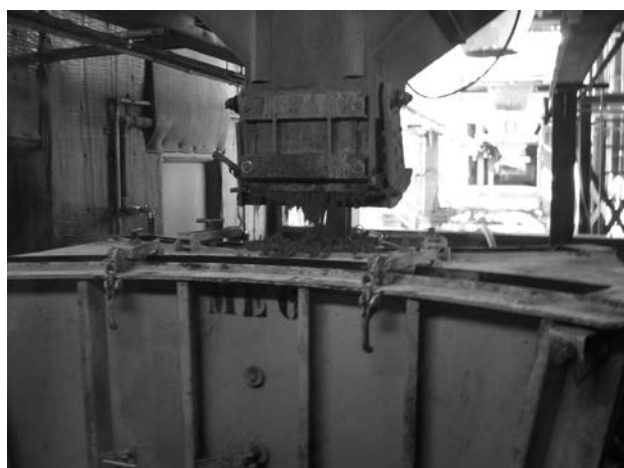
Figura 5. Detalle del hormigonado con molde vertical
