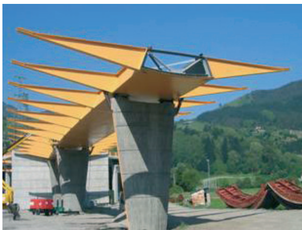
Figura 15. Estructura metálica del viaducto de acceso en ejecución
