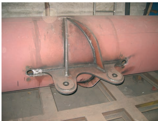
Figura 20. Detalle de las cartelas de unión superior de las péndolas con los tubos de los arcos
