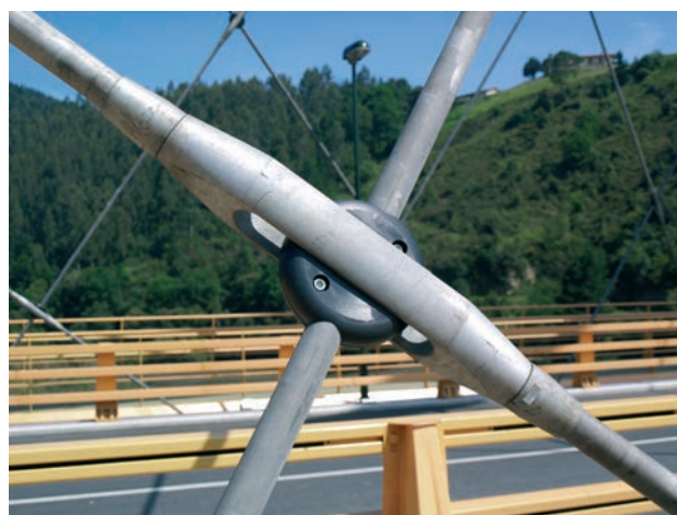
Figura 21b. Detalle de dispositivo de cruce de péndolas Figure 21b. Hanger crossing device close-up
