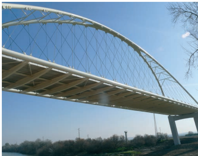
Figuras 45a y 45b. Vistas del sistema de arriostramiento de los arcos en el puente de Palma del Río.
