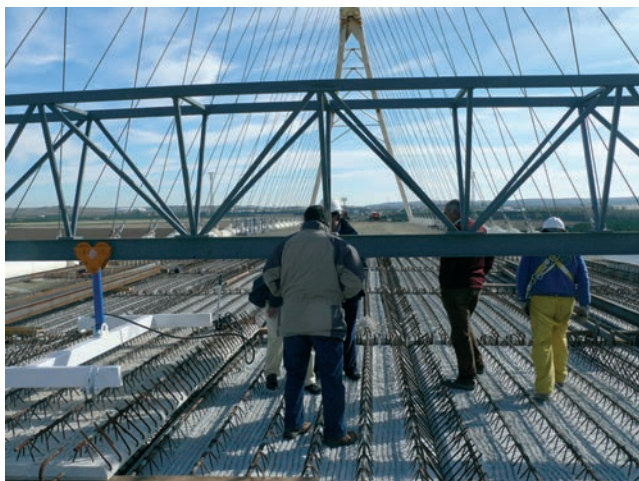
Figuras 42a y 42b. Vista durante las operaciones de colocación de prelosas en el tablero y con el tablero ferrallado Figures 42a and 42b. Views of the precast slabs placing and of the deck alter the reinforcement being assembled
