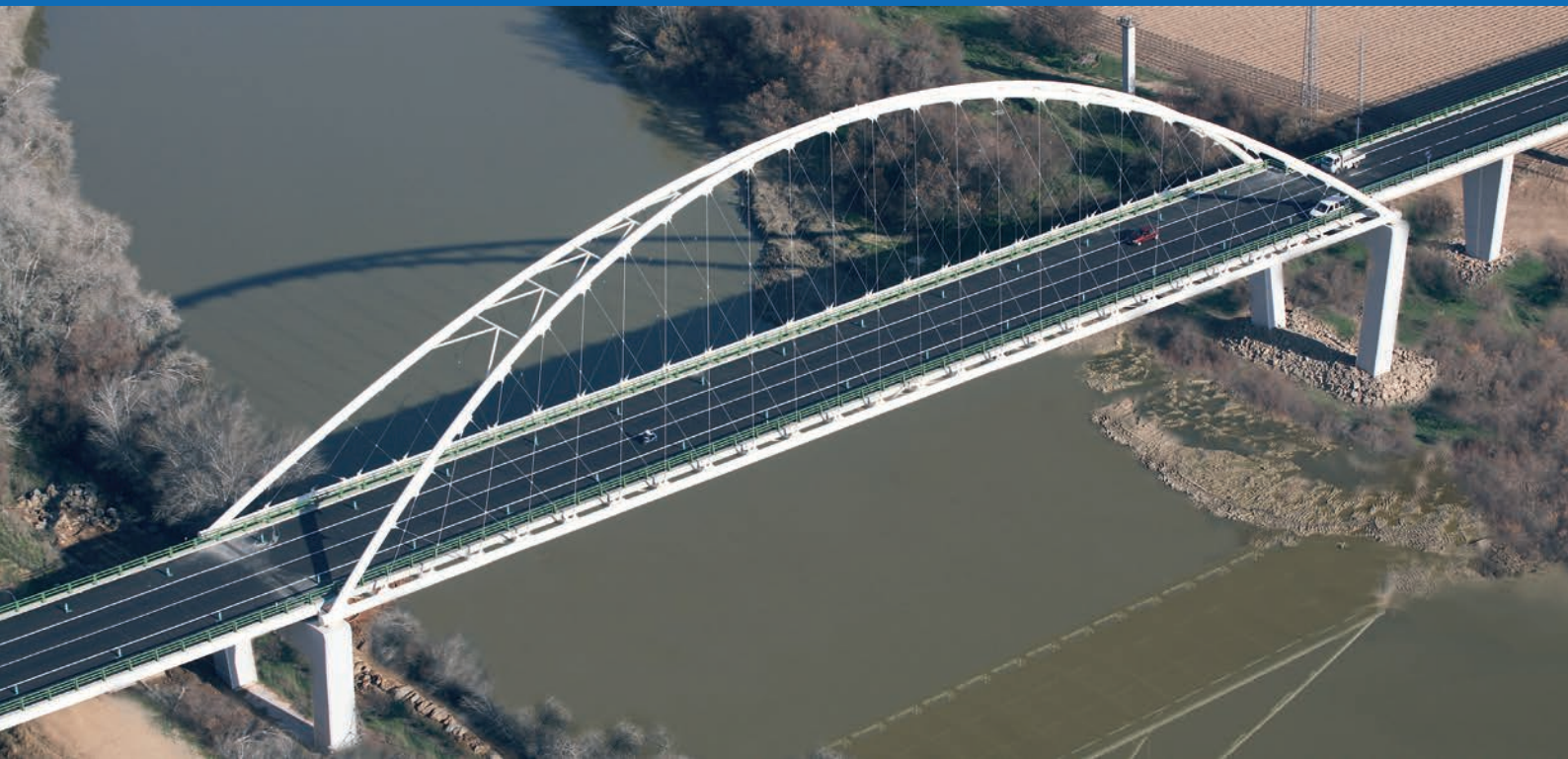
Puente de Palma del Río | Córdoba
