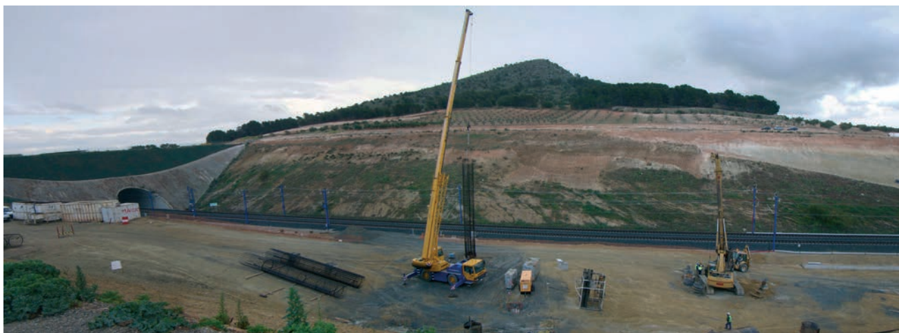
Figura 7. Ejecución de pilotes de cimentación de pilas del vano central en obra
