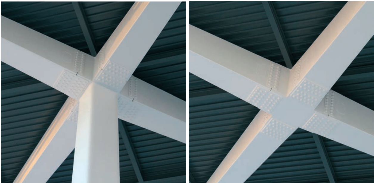
Figuras 12 y 13. Detalle del nudo del módulo sin pilar y del módulo con pilar
