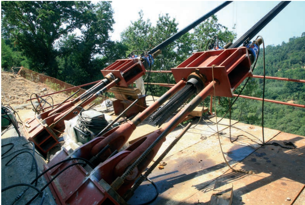
Figura 22. Estructura de transferencia en anclaje de retenida
