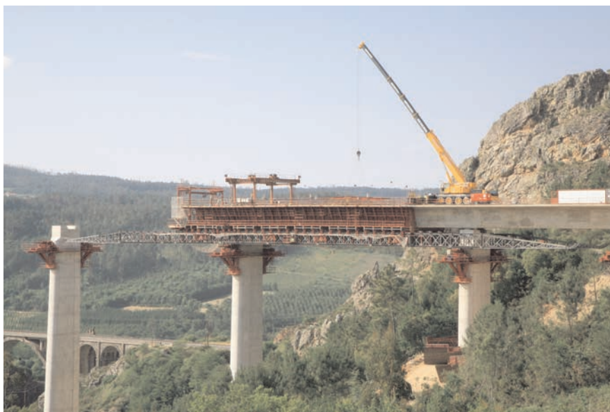
Figura 11. Ejecución del tablero con cimbra autolanzable
