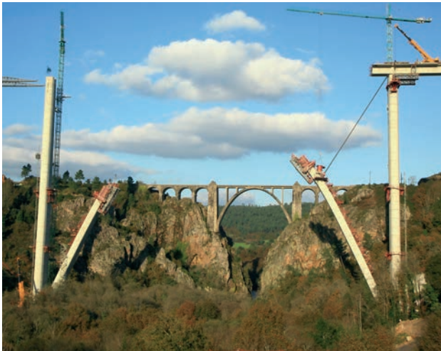
Figura 8. Alzado del arco en construcción
