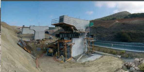
Estribo 1, pila 1 y pila 2 del viaducto Santa Ana a su paso sobre la L.A.V. Córdoba - Málaga
