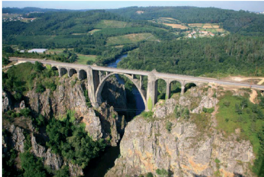
Figura 3. Viaducto de Gundían, situado inmediatamente aguas arriba del nuevo viaducto sobre el río Ulla
