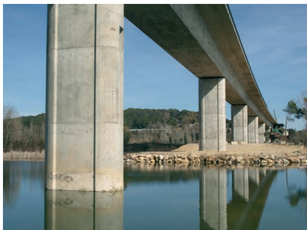
Figura 12. Viaducto sobre el río Fluvià
