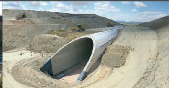
Emboquille de Falso Túnel (256 m.) del E.F.T.A.
