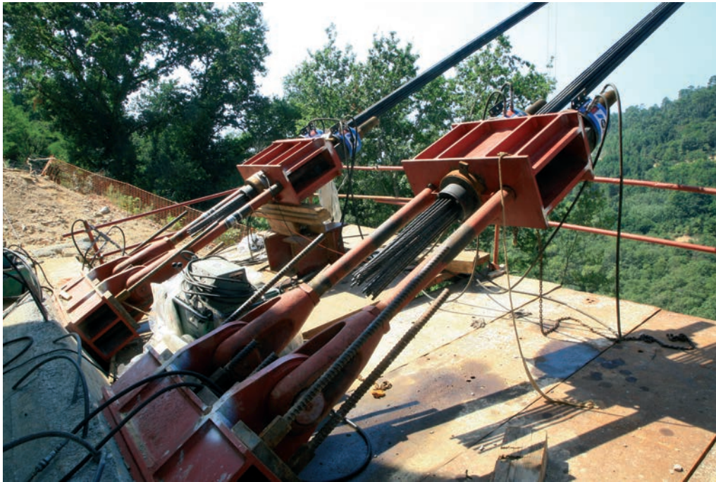
Figura 22. Estructura de transferencia en anclaje de retenida
