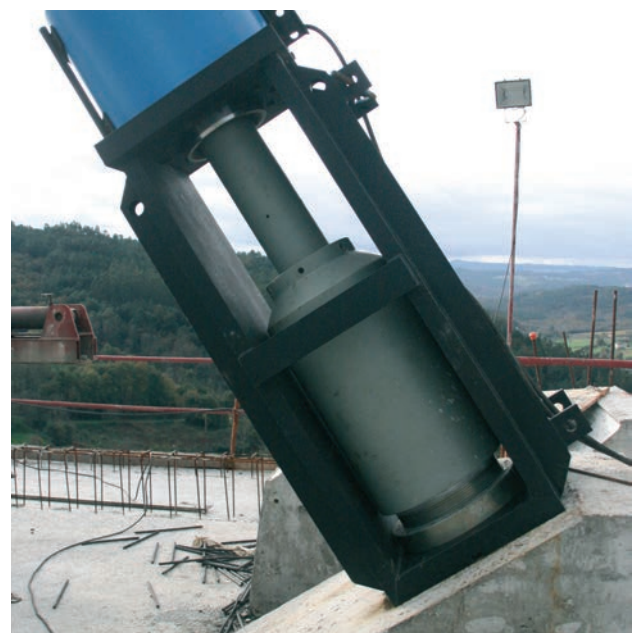
Figura 23. Gatos de tesado de tirantes con puente
