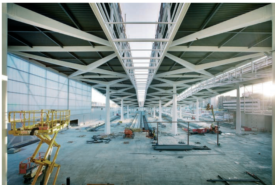
Figura 8. Vista interior desde el vestíbulo hacia andenes
