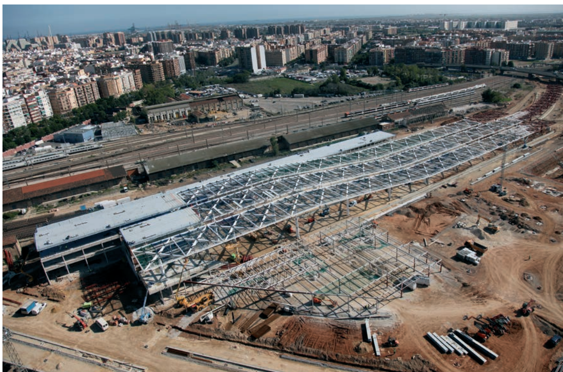
Figura 7. Vista aérea de la estructura en construcción, noviembre de 2009
