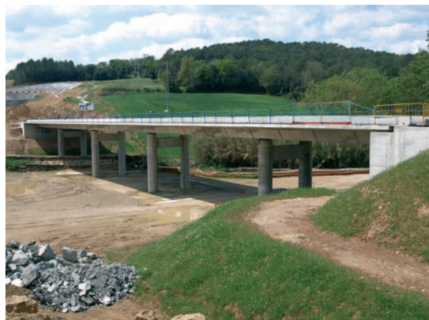
Figura 14. Viaducto sobre la riera de Casinyola
