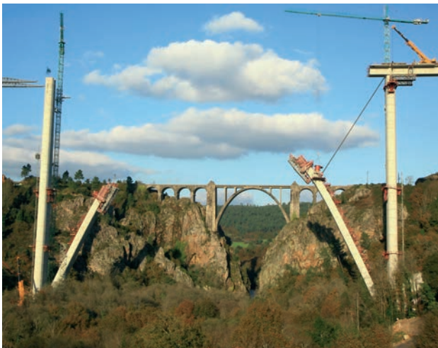
Figura 8. Alzado del arco en construcción
