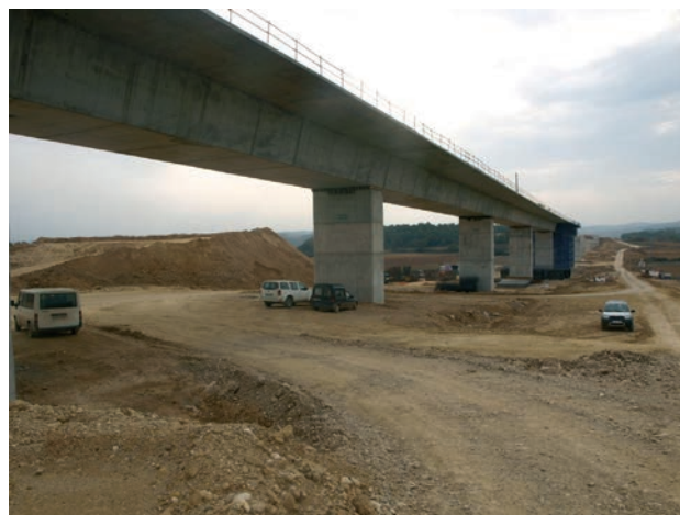
Figura 13. Viaducto sobre el Pla dels Caboters
