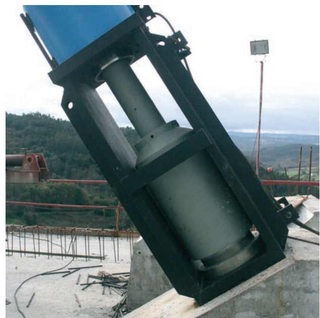
Figura 23. Gatos de tesado de tirantes con puente
