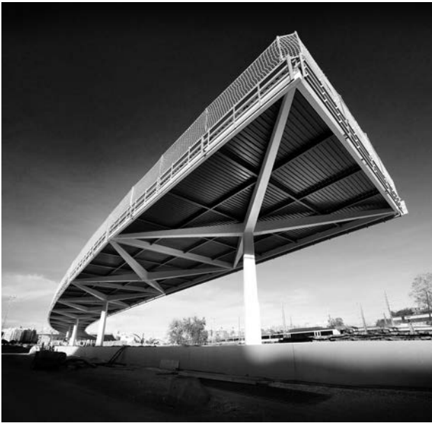
Figura 9. Extremo de la marquesina del andén curvo
