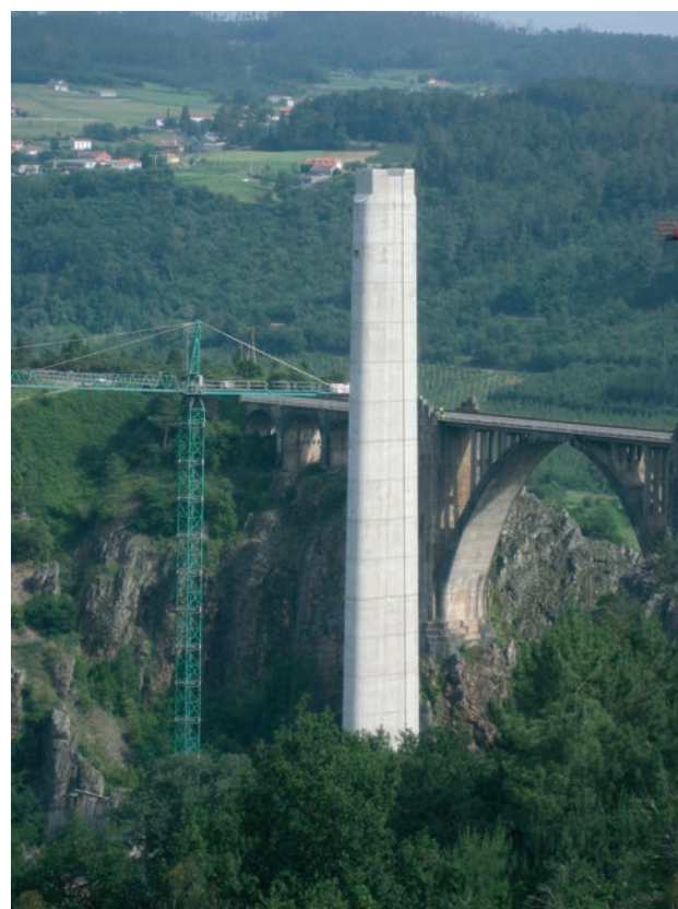
Figura 12. Fustes de pilas de tramos de acceso
