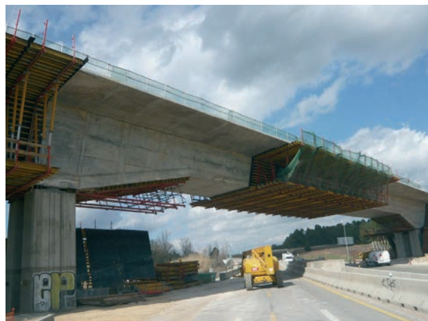
Figura 15. Viaducto sobre la carretera C-66
