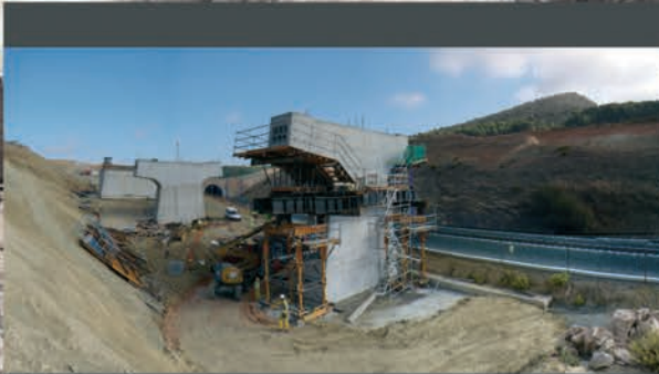
Estribo 1, pila 1 y pila 2 del viaducto Santa Ana a su paso sobre la L.A.V. Córdoba - Málaga
