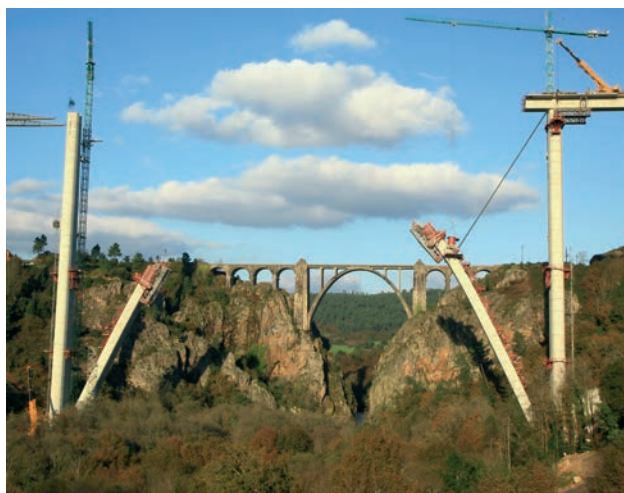
Figura 8. Alzado del arco en construcción
