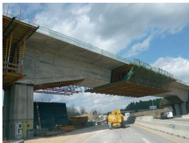
Figura 15. Viaducto sobre la carretera C-66
