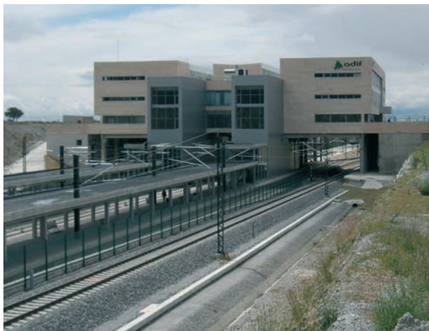
Figura 1. Situación actual de la estación Segovia Guiomar
