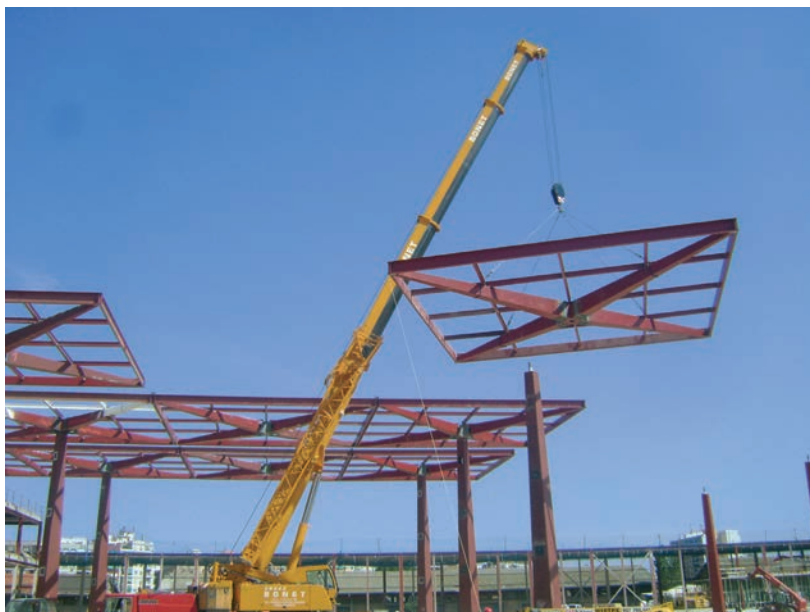
Figura 14. Montaje de un módulo mediante grúa
