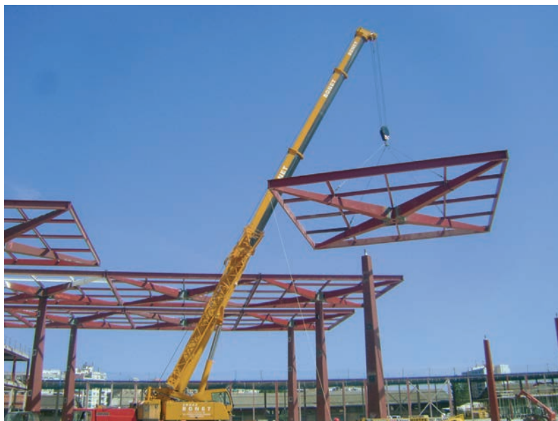
Figura 14. Montaje de un módulo mediante grúa
