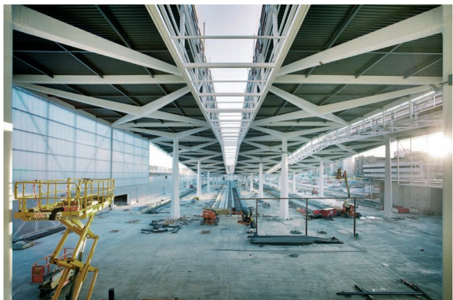
Figura 8. Vista interior desde el vestíbulo hacia andenes
