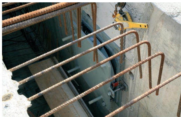
Figura 26. Apoyo POT instrumentado en estribo E1
