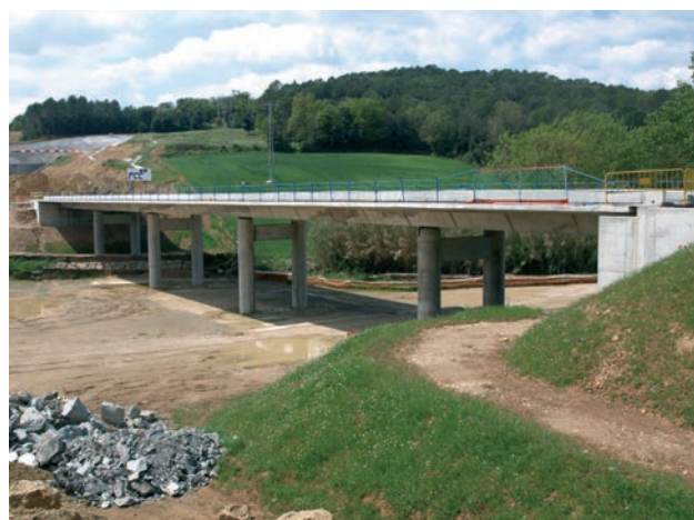
Figura 14. Viaducto sobre la riera de Casinyola
