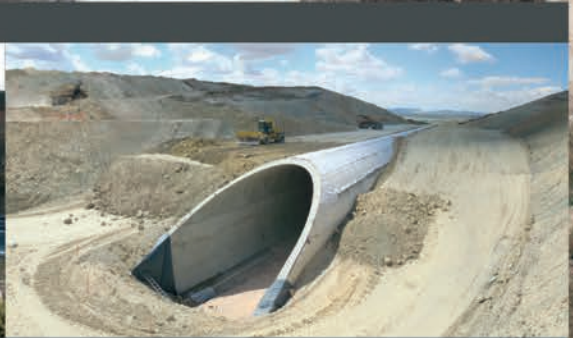
Emboquille de Falso Túnel (256 m.) del E.F.T.A.
