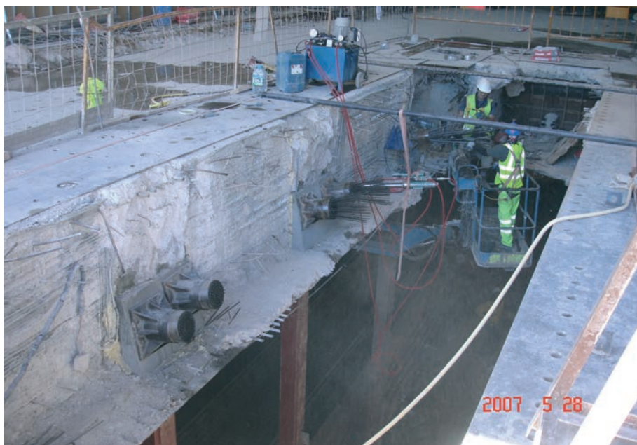
Figura 10. Retesado de los tendones de pretensado
