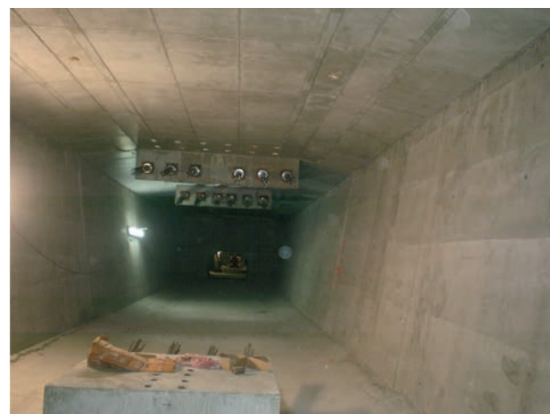
Figura 16. Pretensado de continuidad
