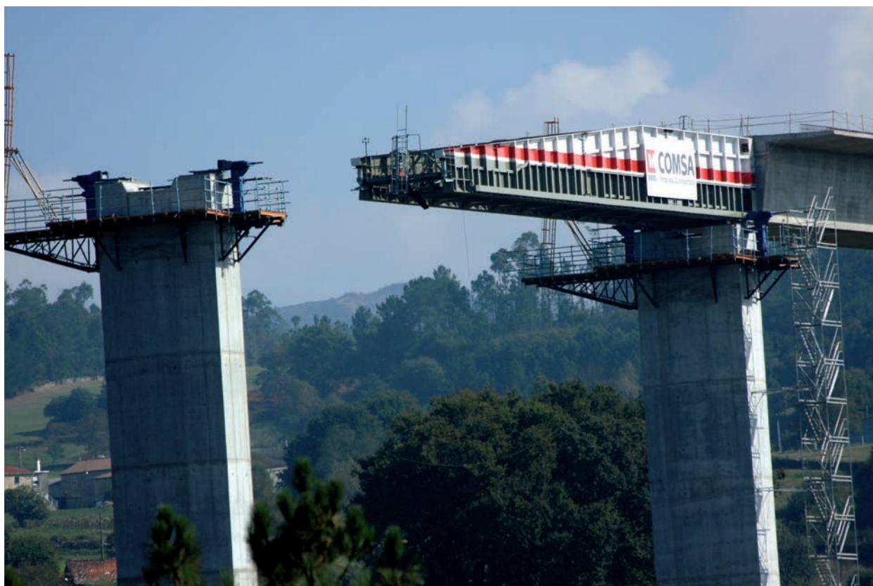
Figura 23. Empuje del viaducto sobre Río Deza
