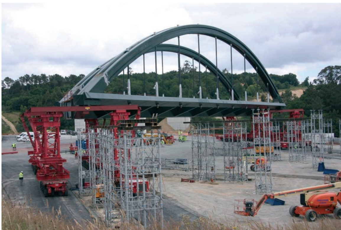
Figura 13. Puesta en carga de los carretones. Inicio del traslado
