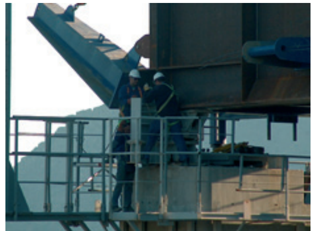
Figura 14. Operación de paso de pila y repliegue de patines
