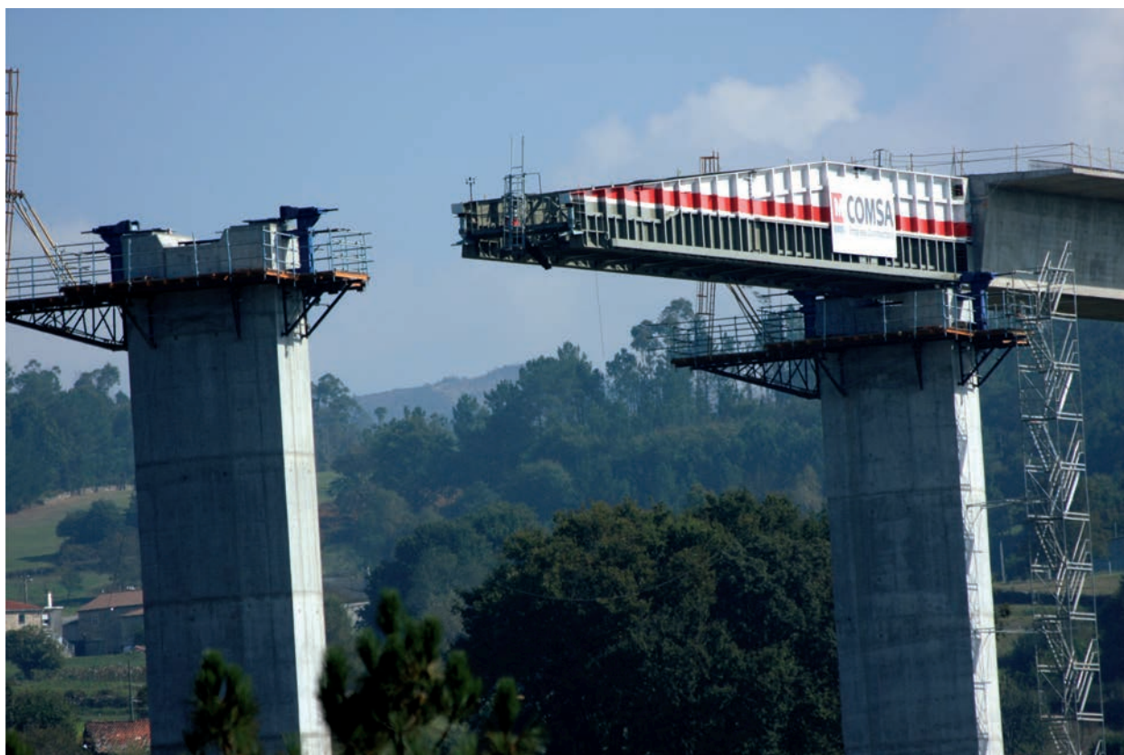
Figura 23. Empuje del viaducto sobre Río Deza
