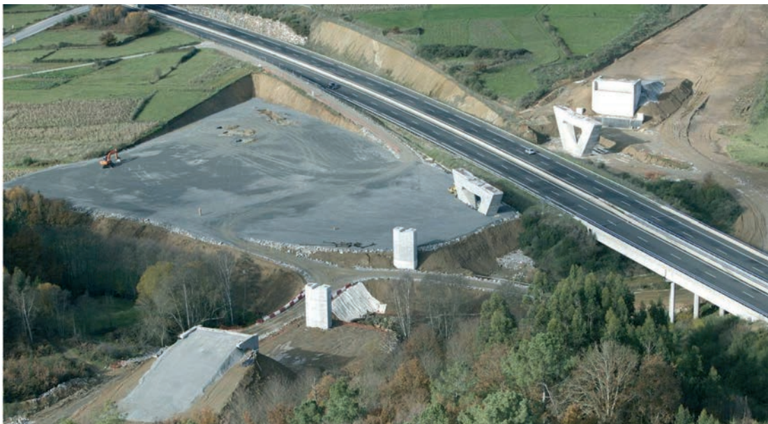
Figura 9. Vista de la formación de explanada para montaje y traslado del vano del arco
