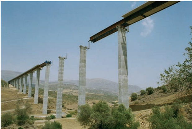
Figura 12. Vista inferior del viaducto durante el empuje
