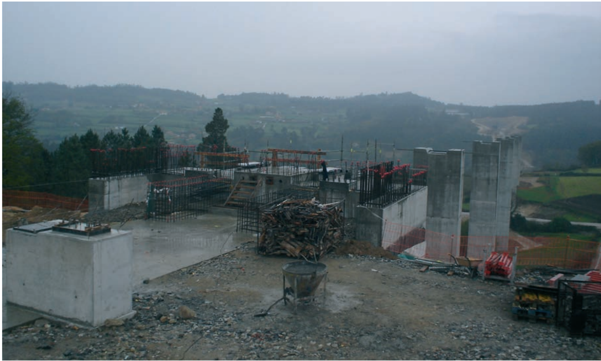
Figura 7. Estribo 1 viaducto sobre Río Deza
