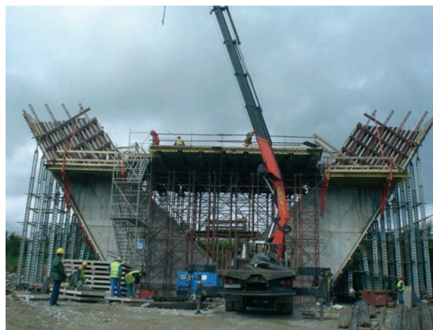
Figura 7. Pila 3 durante la construcción
