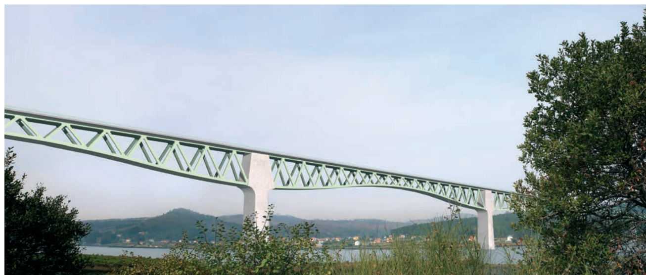
Figura 27. Vista lateral del vano principal del Viaducto sobre el río Ulla
