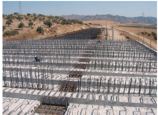
Figura 10. Vista de prelasas superiores
