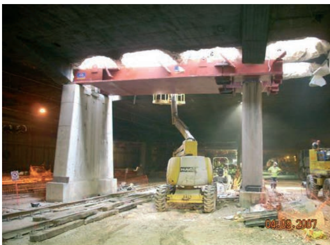
Figuras 23 y 24. Montaje de pórticos de cabecera a través de la losa nervada
