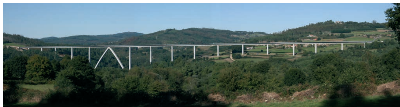
Figura 2. Viaducto sobre Río Deza
