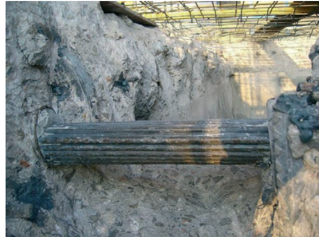
Figura 9. Pretensado de losa al descubierto
