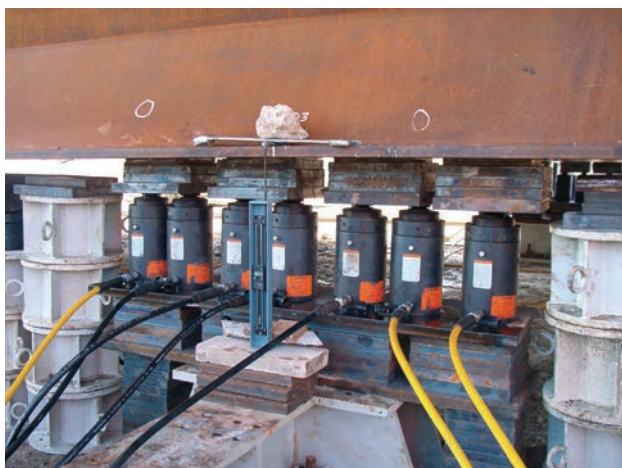
Figura 16. Aplicación de reacción localizada con gatos
