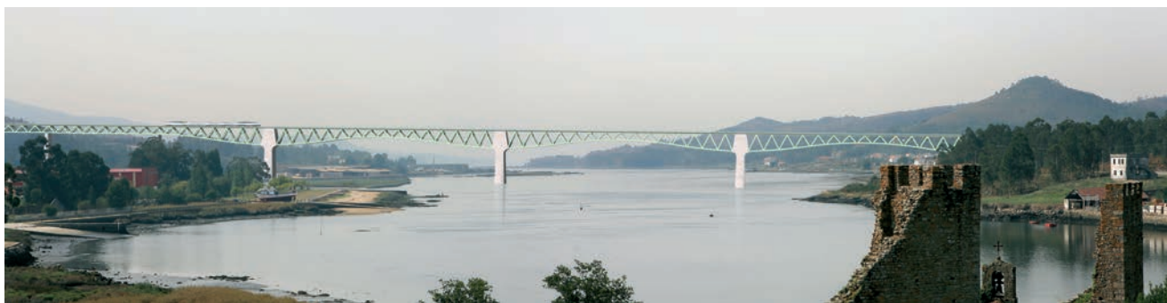
Figura 26. Vista del Viaducto sobre el río Ulla
