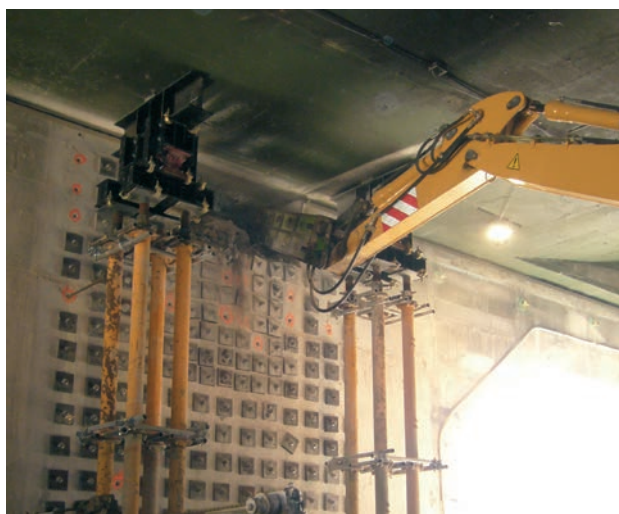
Figura 30. Refuerzo de muro
