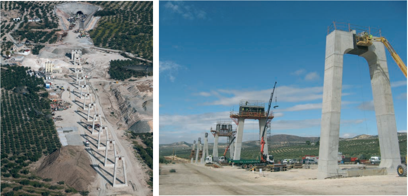
Figura 19. Vista de las pilas durante la ejecución
