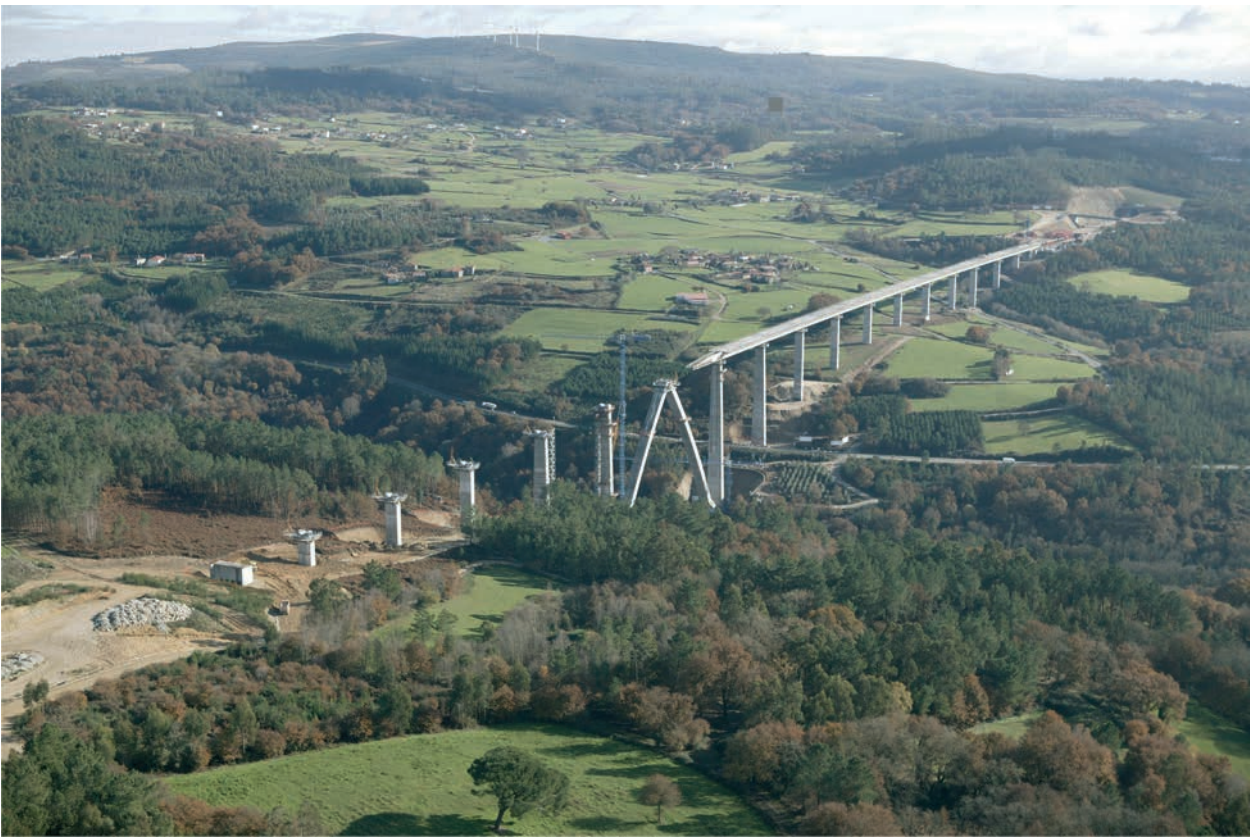
Figura 22. El arco cerrado a la espera del empuje del tablero sobre la clave
