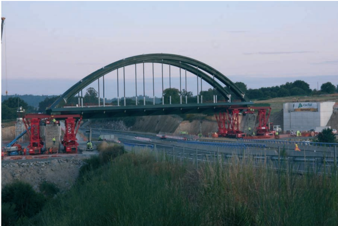
Figura 15. Ubicación del vano en su posición definitiva
