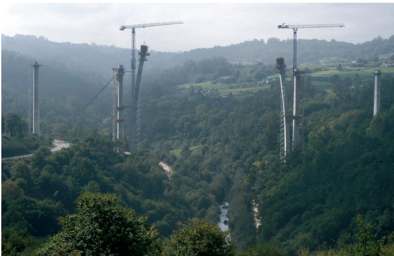
Figura 20. Los semiarcos en posición vertical antes de comenzar el abatimiento
