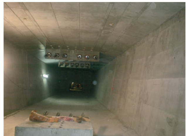
Figura 16. Pretensado de continuidad
