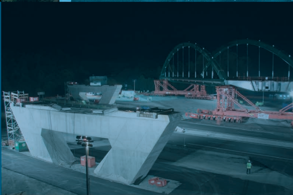
Viaducto sobre Rego Das Lamas Corredor Norte-Noroeste de Alta Velocidad. Eje: Ourense-Santiago. Tramo: Lalín-Santiago
