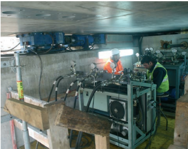
Figura 24. Gatos de fricción
