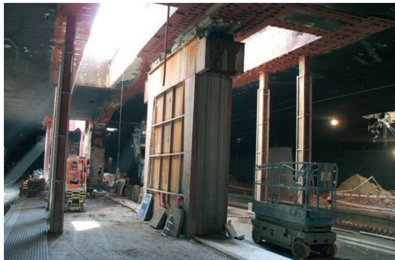
Figuras 16 y 17. Sustitución de aparatos de apoyo
