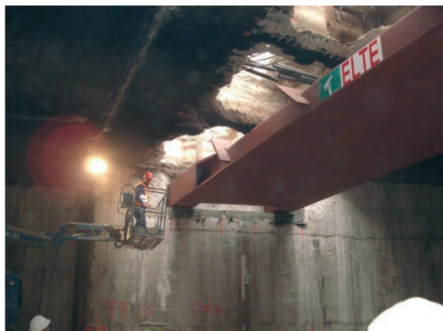
Figuras 23 y 24. Montaje de pórticos de cabecera a través de la losa nervada
