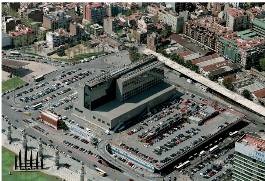
Figura 1. Vista general de la Estación de Sants
