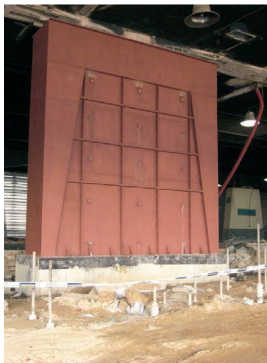
Figuras 13 y 14. Refuerzo de pilares
