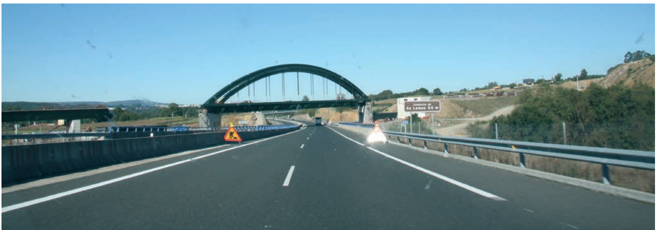
Figura 5. Vista del arco esviado desde la autopista
