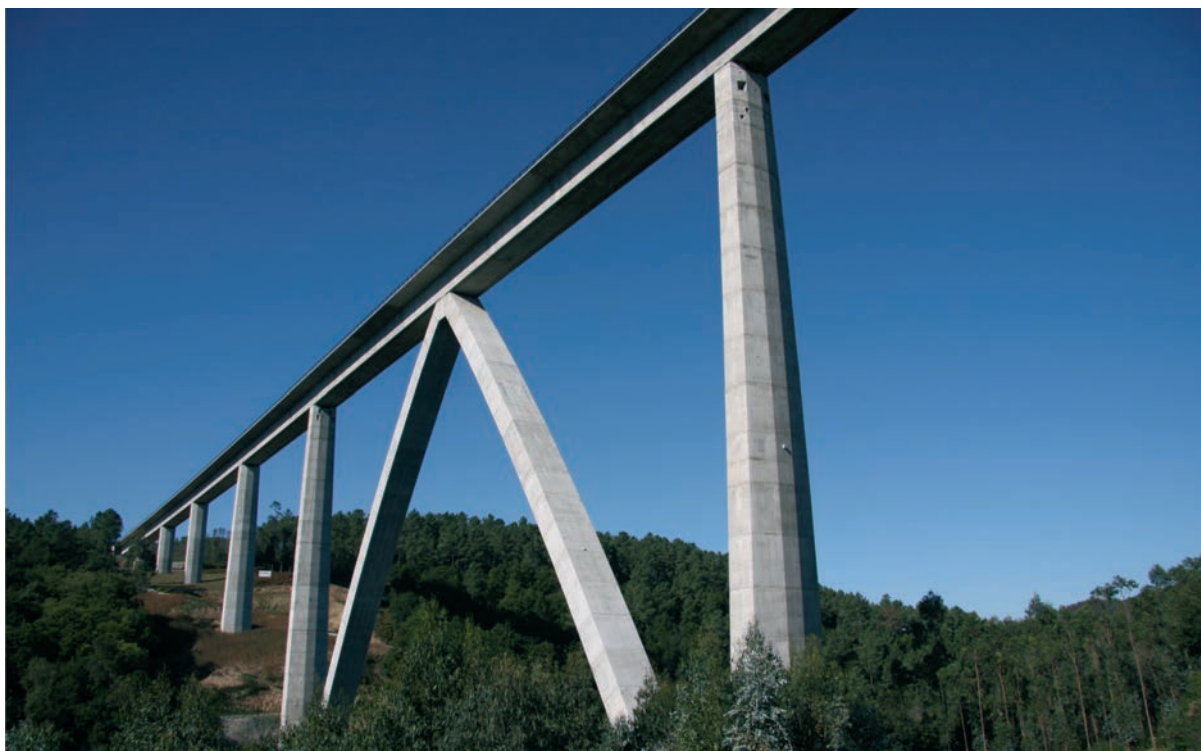
Figura 10. Arco del viaducto sobre Río Deza
