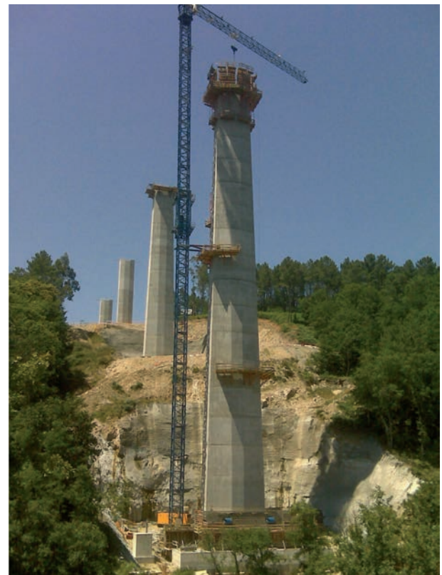
Figura 5. Construcción de la pila 12 del viaducto sobre Río Deza, de 96,50 m de altura
