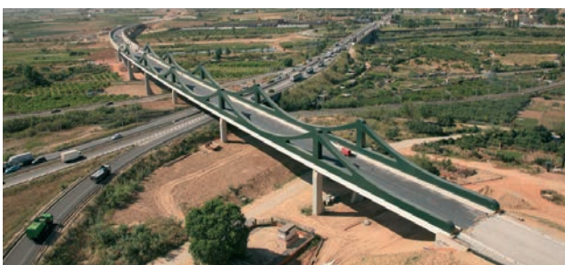
Figura 7. Puente de Sant Boi
