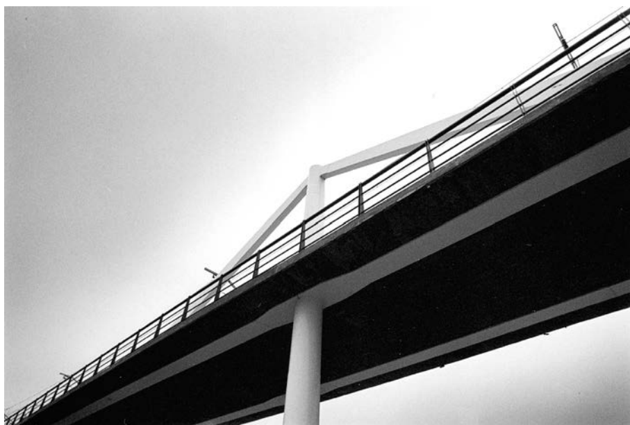
Figura 10. Vista inferior del tablero con la intersección viga-fuste de pila
