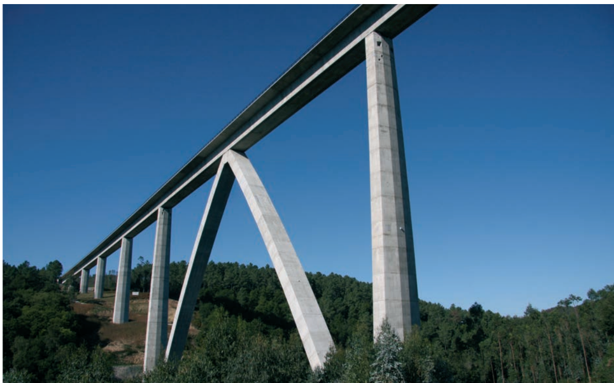
Figura 10. Arco del viaducto sobre Río Deza
