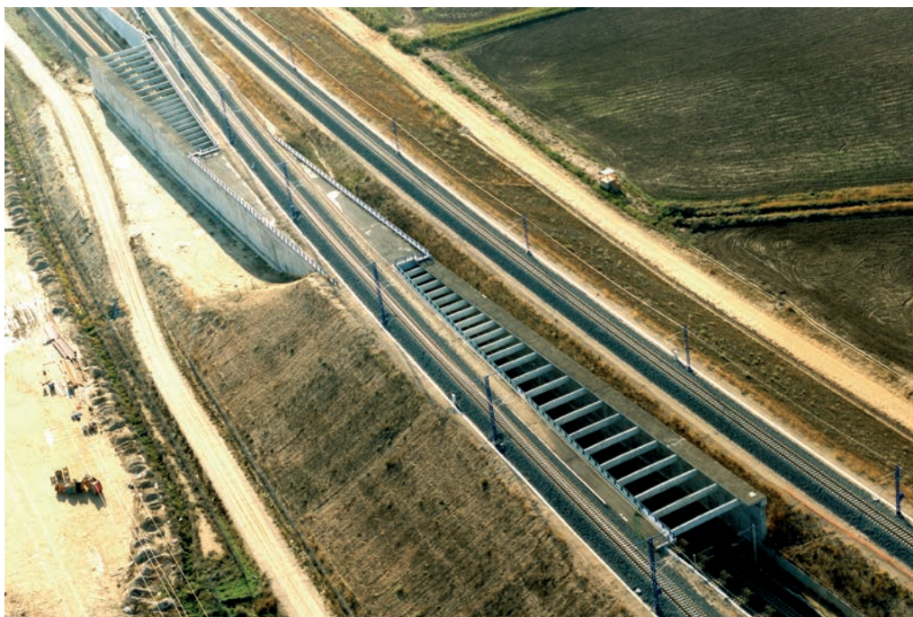
Figura 4. Vista general de la pérgola en la L.A.V. Madrid-Toledo en Alameda de la Sagra
