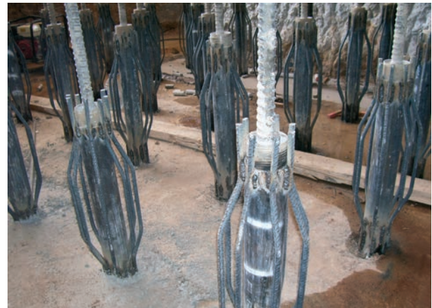
Figura 35. Ejemplo de conexión micropilote-estructura
