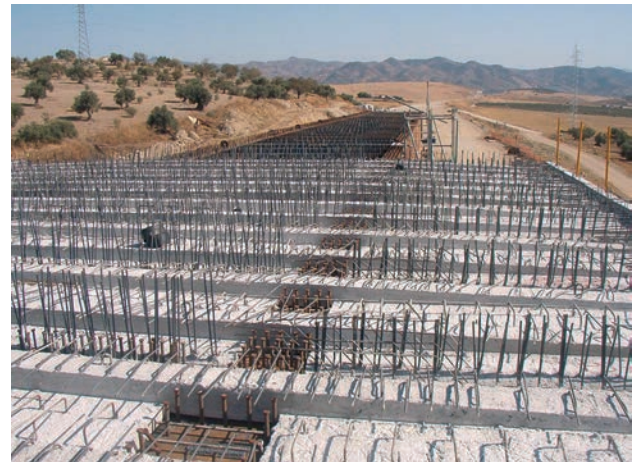
Figura 10. Vista de prelasas superiores
