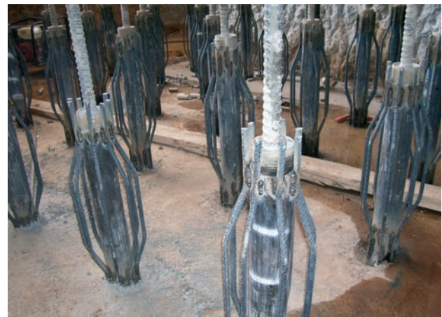
Figura 35. Ejemplo de conexión micropilote-estructura
