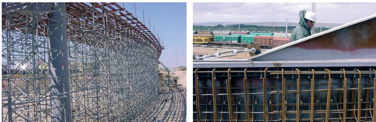
Figura 13. Proceso constructivo; a) Cimbra; b) Armadura de la viga en la zona de unión viga-tirante
