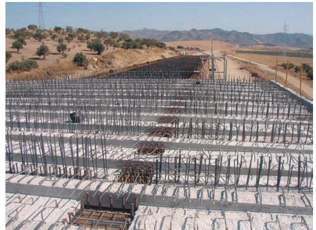
Figura 10. Vista de prelasas superiores
