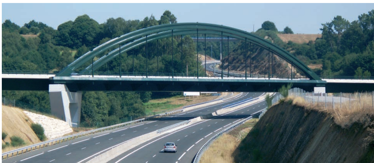
Figura 2. Vista del viaducto sobre la autopista
