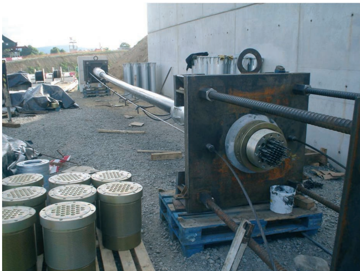
Figura 11. Bancada para tesado de péndolas
