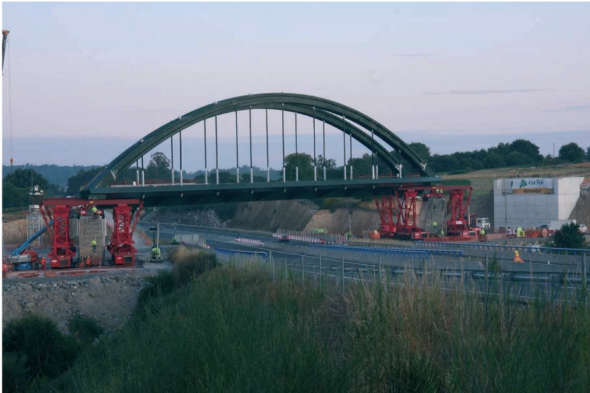
Figura 15. Ubicación del vano en su posición definitiva
