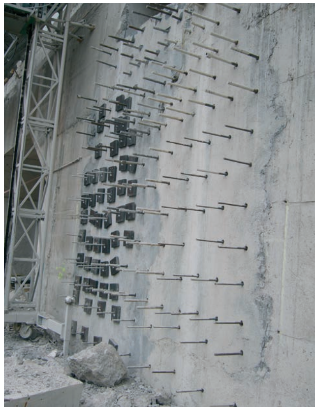
Figura 29. Refuerzo de muro
