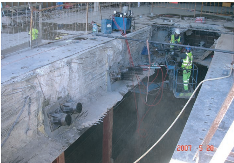
Figura 10. Retesado de los tendones de pretensado
