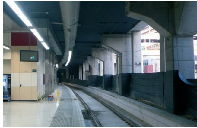
Figura 40. Vista pilares ménsula y andén
