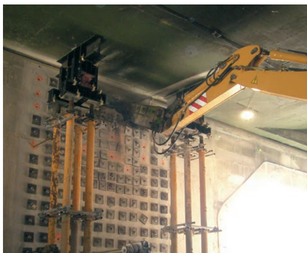
Figura 30. Refuerzo de muro
