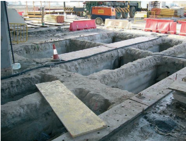
Figura 8. Refuerzo de hueco de losa
