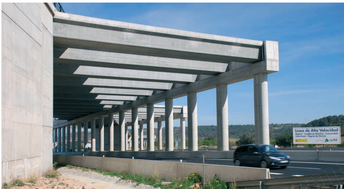
Figura 1. Tramo Buñol-Cheste del nuevo acceso ferroviario de alta velocidad a Levante.
