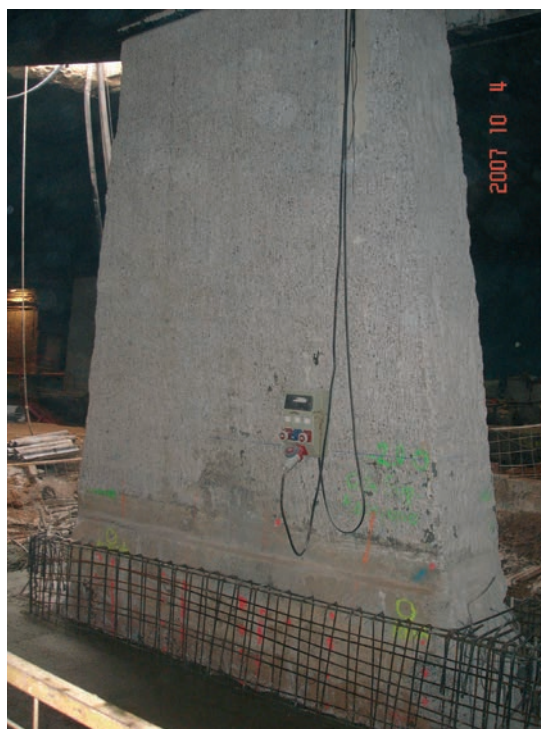
Figuras 13 y 14. Refuerzo de pilares
