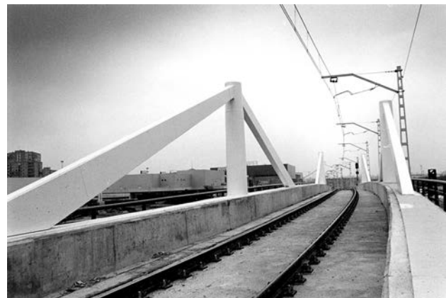
Figura 4. Vista superior del puente
