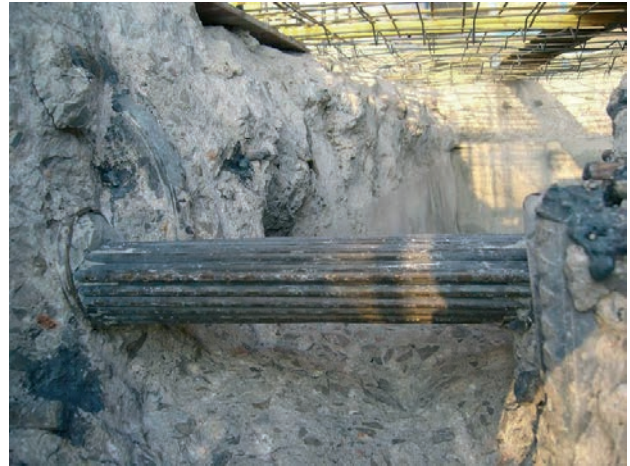
Figura 9. Pretensado de losa al descubierto
