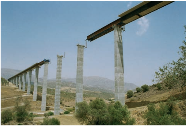
Figura 12. Vista inferior del viaducto durante el empuje
