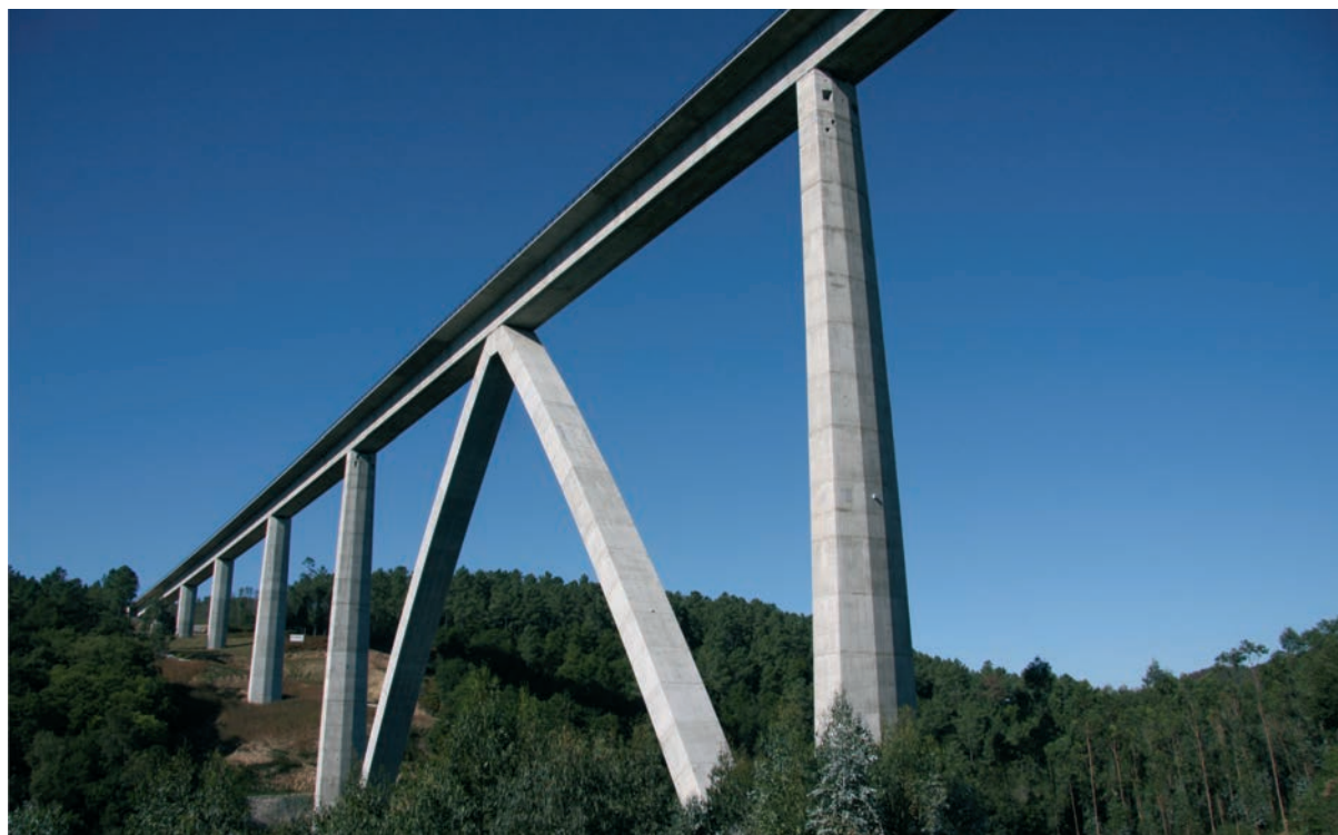
Figura 10. Arco del viaducto sobre Río Deza
