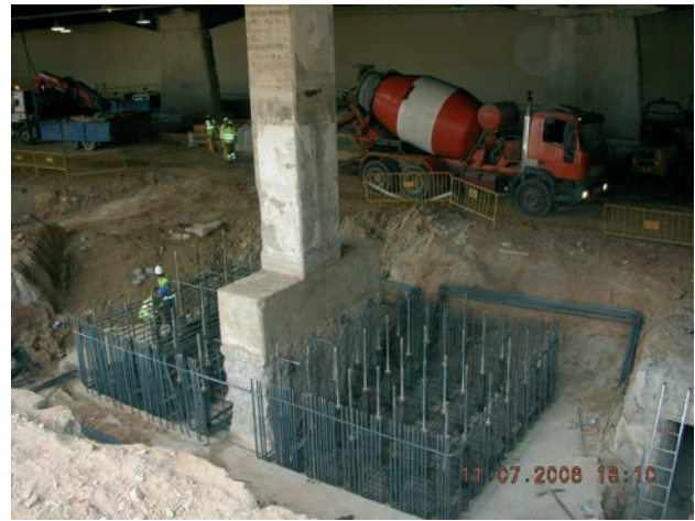
Figura 34. Ejemplo de recalce de un pilar de la estación
