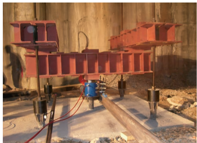
Figura 36. Prueba de carga de micropilote
