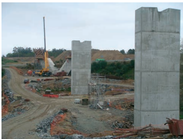
Figura 6. Pilas 1 y 2 durante la construcción
