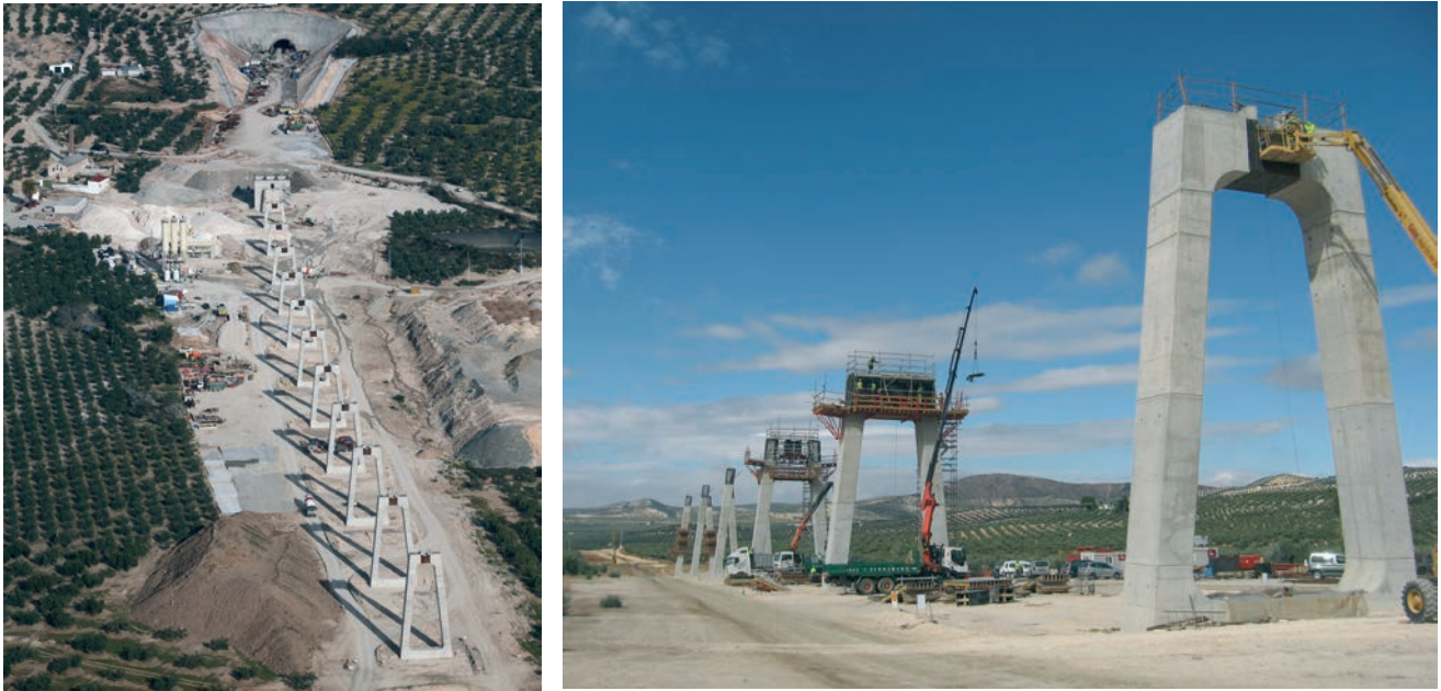
Figura 19. Vista de las pilas durante la ejecución
