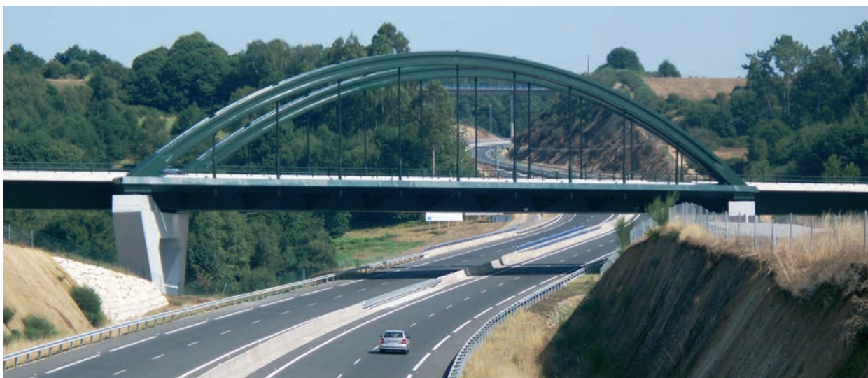
Figura 2. Vista del viaducto sobre la autopista
