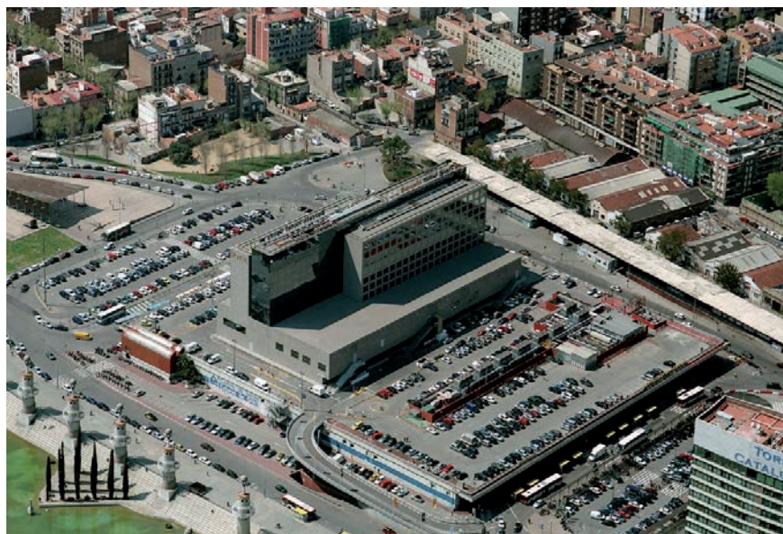
Figura 1. Vista general de la Estación de Sants
