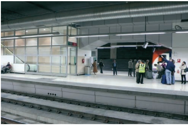
Figura 39. Aspecto final hueco y andén
