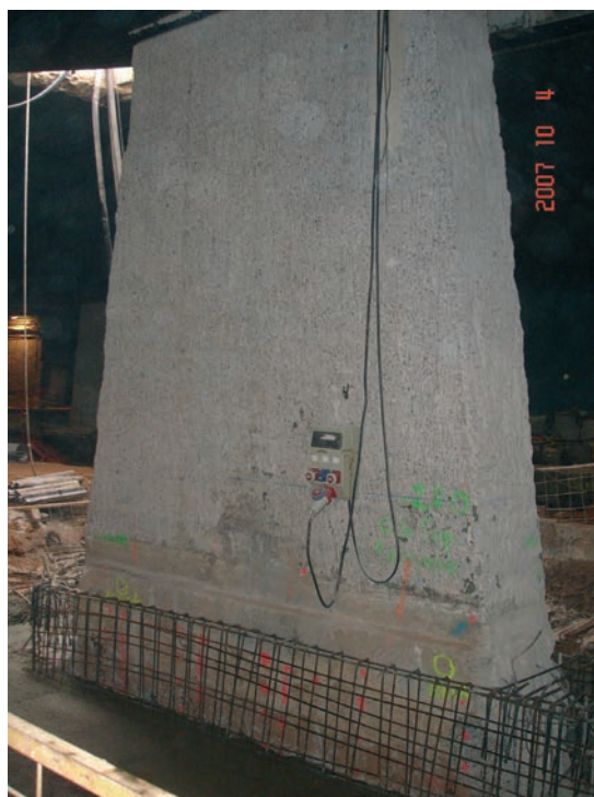
Figuras 13 y 14. Refuerzo de pilares
