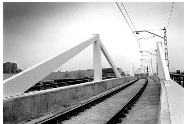
Figura 4. Vista superior del puente
