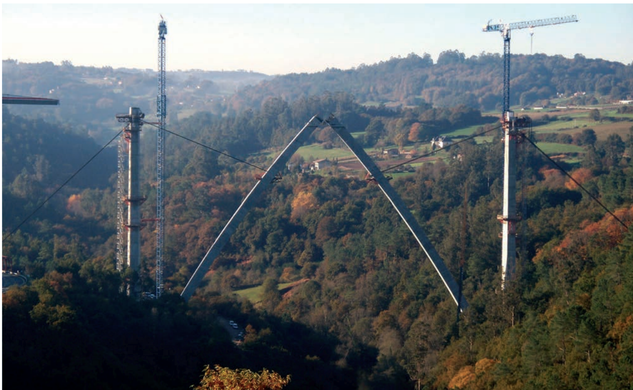
Figura 21. Los semiarcos abatidos antes de hormigonar la clave
