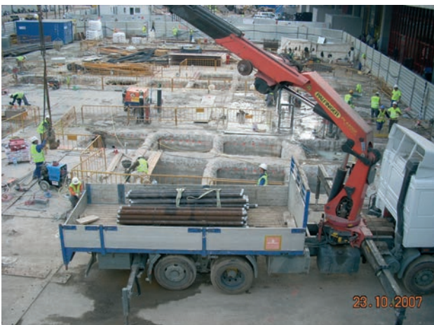
Figura 4. Huecos en la losa vista superior
