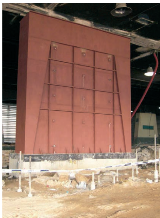
Figuras 13 y 14. Refuerzo de pilares
