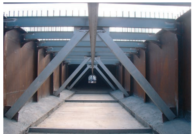
Figura 11. Vista de prelasas inferiores y hormigón de fondo
