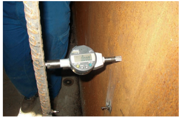
Figura 17. Control de deformaciones transversales en el alma
