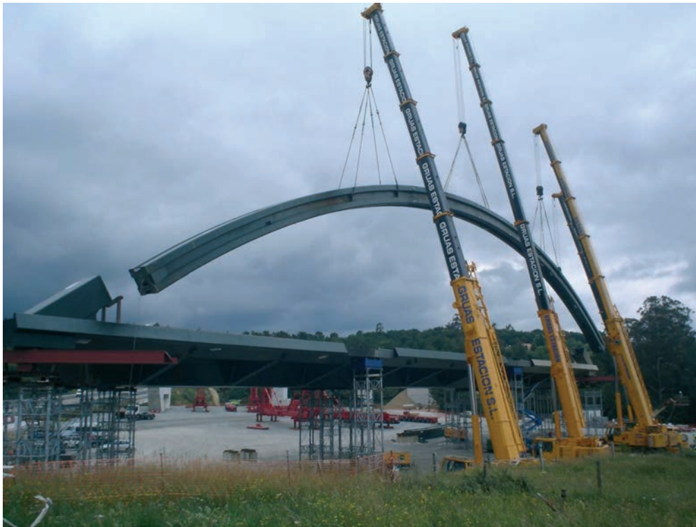
Figura 10. Vista del tablero sobre cimbras y montaje de un arco
