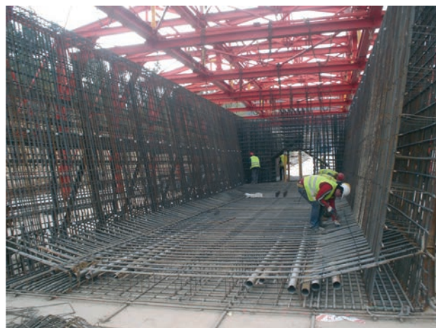
Figura 12. Ferrallado de una de las dovelas
