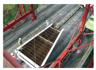
Figura 33. Colocación de un tramo de núcleo Figure 33. Assembly of a section of the composite box section
