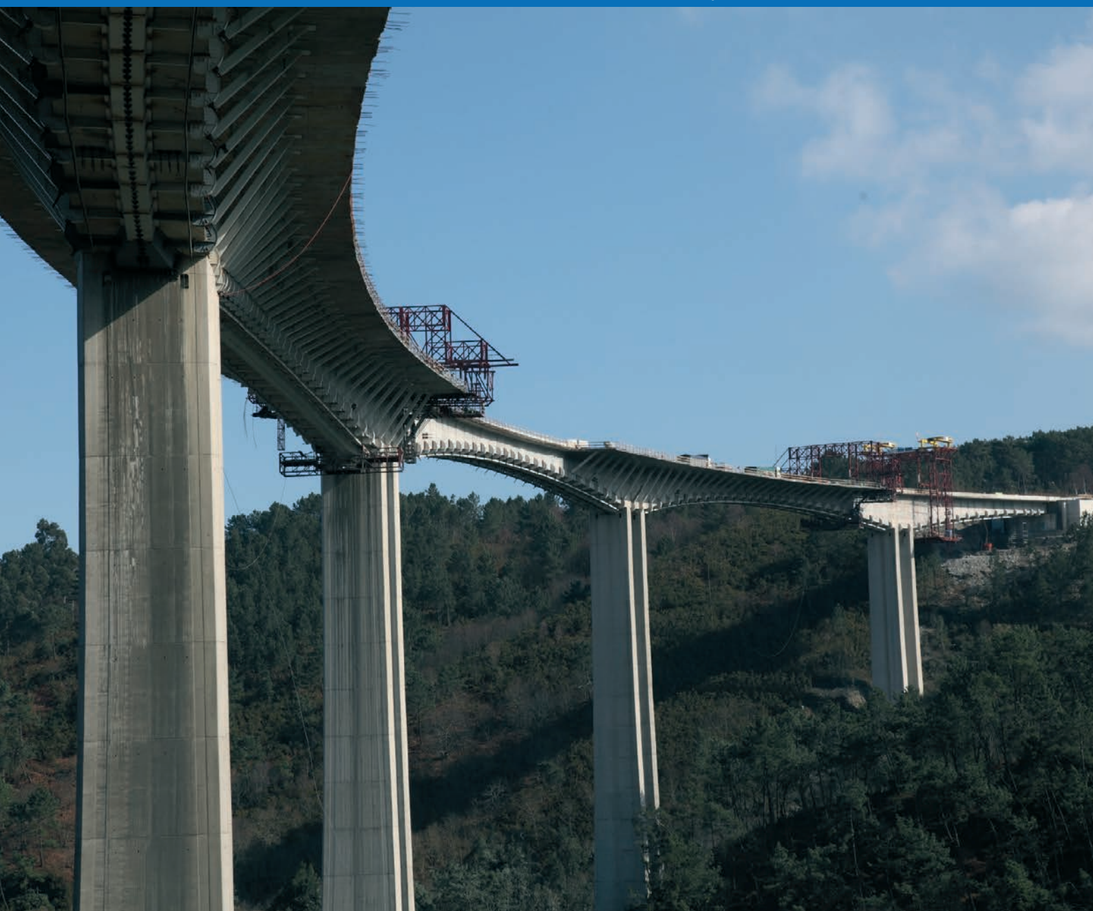
Viaducto de San Pedro de la Ribera | Asturias
