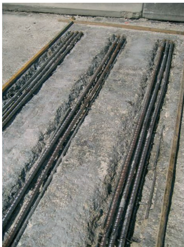
Figura 29. Disposición de monotorones en forjado superior Figure 29. Distribution of the strands of the prestressing of the upper slab
