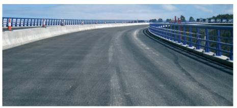
Figura 40. Realización de acabados: pretiles, barrera central y pavimentación Figure 40. Finishing of the deck: quardrails, central barrier and surfacing
