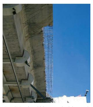
Figure 37. Demolición del último metro de voladizo original Figure 37. Demolishing of the edge of the existing transverse cantilever
