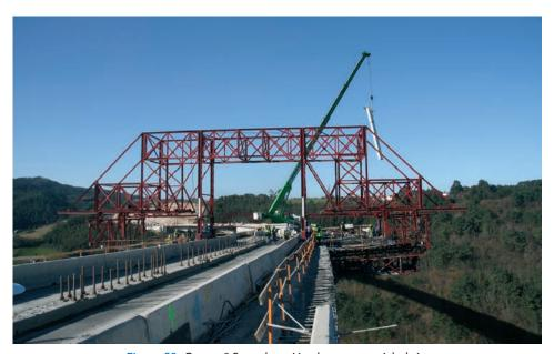
Figura 38. Carro nº 3 y colocación de un nuevo jabalcón Figure 38. Movable scafdolding n. 3 assembling a steel strut
