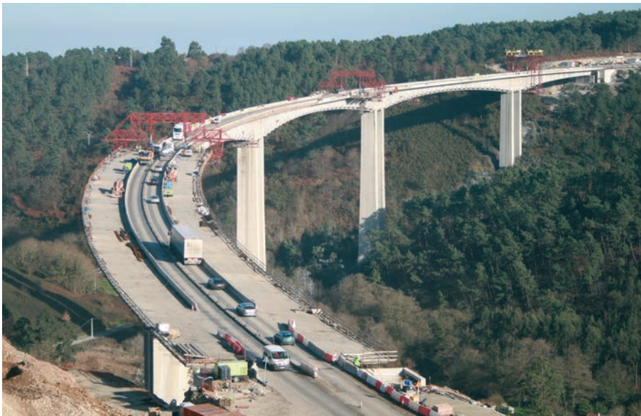
Figura 26. Vista aérea con 5 carros en el puente: carro n°1 (más lejano), 2 carros n°2 (por debajo del tablero) y 2 carros n°3 (que realizan el nuevo forjado)
