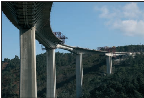
Foto de portada: Viaducto de San Pedro de la Ribera (Asturias)
