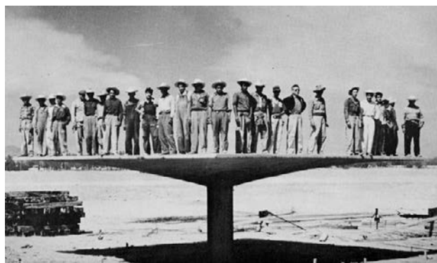
Figura 7. Modelo experimental de un paraguas (1953)
