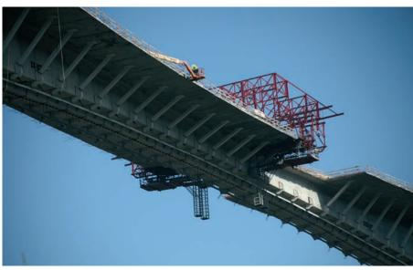
Figura 39. Ejecución del último tramo de ampliación Figure 39. Construction of the last section of the widened transverse cantilever
