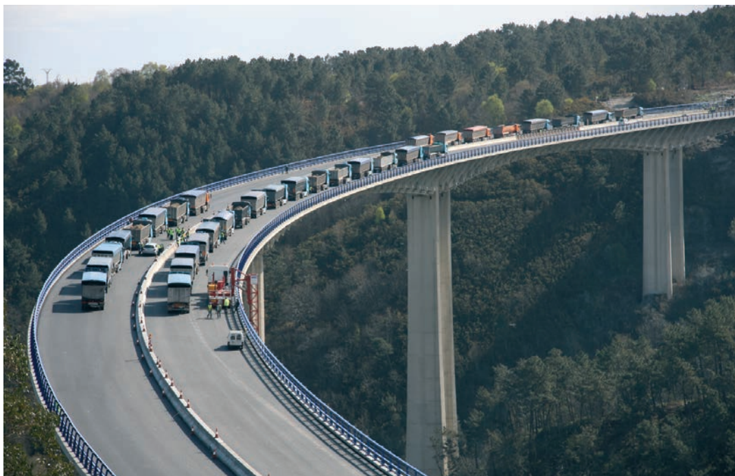
Figura 41. Realización de la prueba de carga Figure 41. Load test of the bridge
