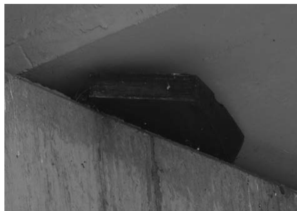
Figura 9. La artesa queda apoyada en un solo lado de la línea
