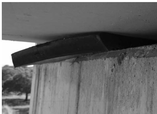
Figura 8. Apoyo totalmente fuera de la meseta
