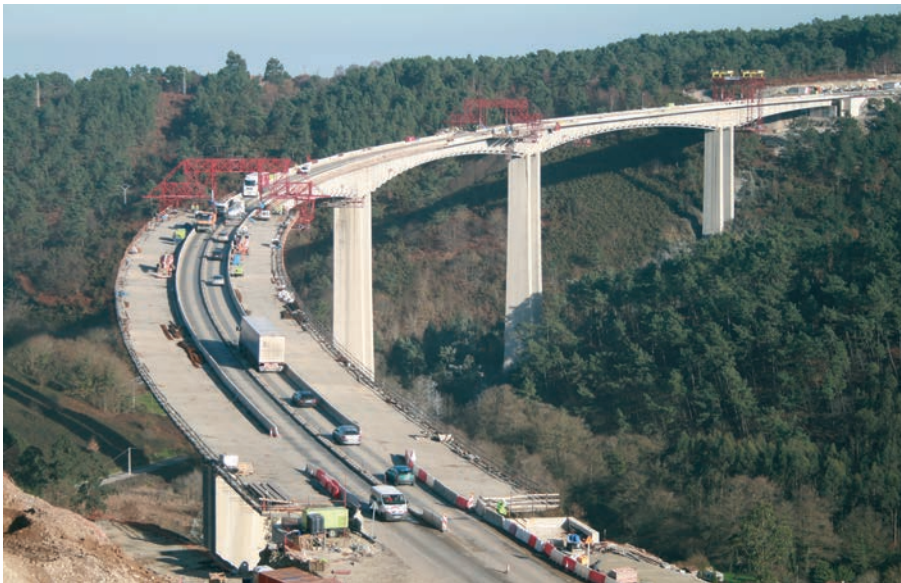
Figura 26. Vista aérea con 5 carros en el puente: carro n.º1 (más lejano), 2 carros n.º2 (por debajo del tablero) y 2 carros n.º3 (que realizan el nuevo forjado)
