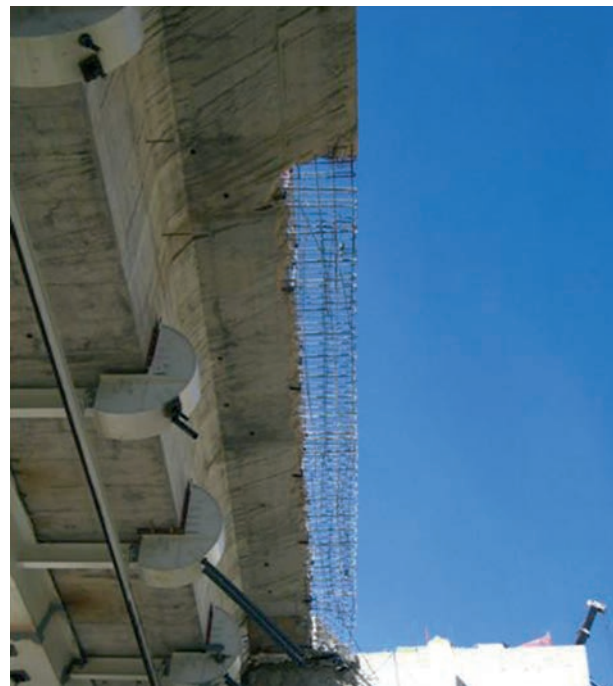
Figura 37. Demolición del último metro de voladizo original
