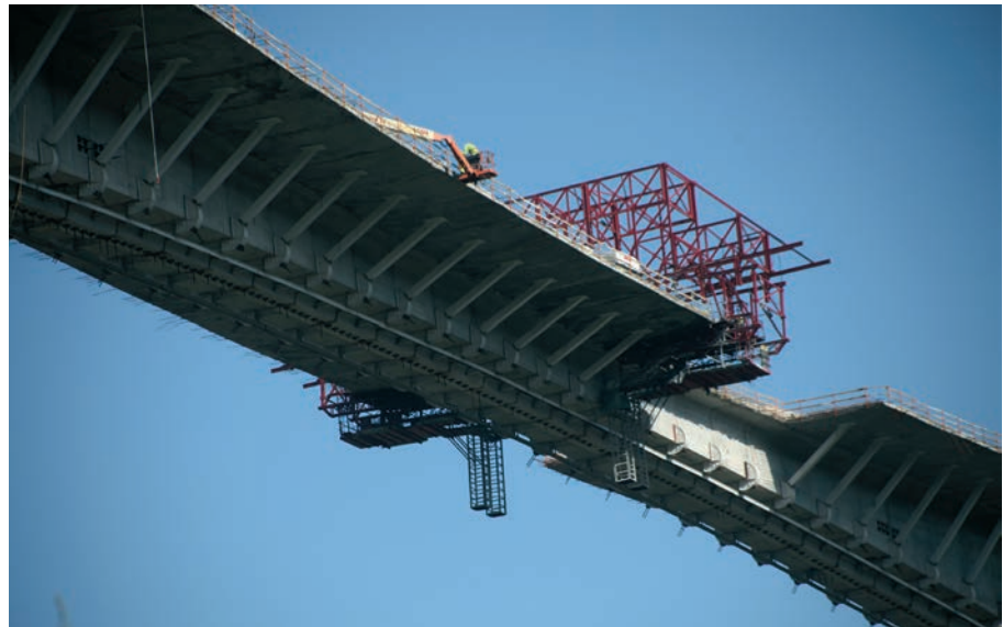
Figura 39. Ejecución del último tramo de ampliación Figure 39. Construction of the last section of the widened transverse cantilever
