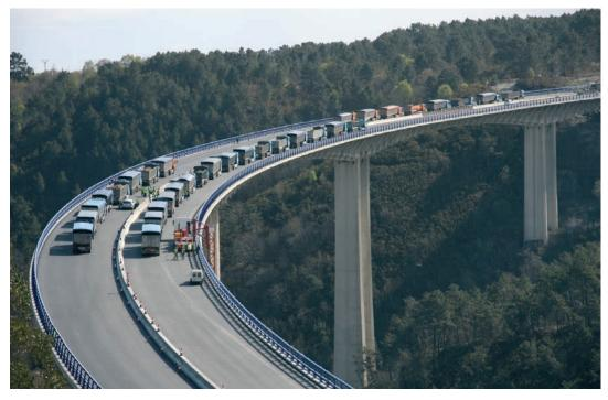
Figura 41. Realización de la prueba de carga Figure 41. Load test of the bridge
