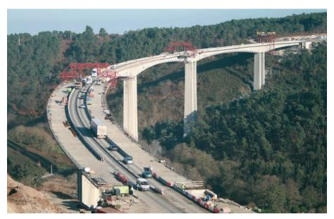
Figura 26. Vista aérea con 5 carros en el puente: carro n°1 (más lejano), 2 carros n°2 (por debajo del tablero) y 2 carros n°3 (que realizan el nuevo forjado)
