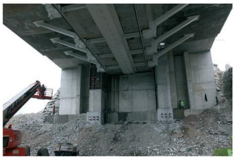
Figure 28. Vista general del estribo una vez reforzado
