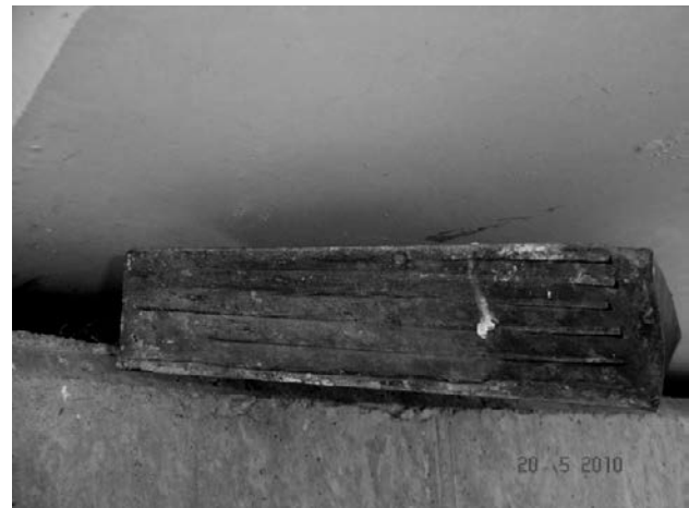
Figura 1. Chapas a la vista y goma retraída
