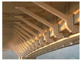
Figura 19. Jabalcones, nudos metálicos y forjados de ampliación Figure 19. Inclined struts, steel connections and upper widened slab
