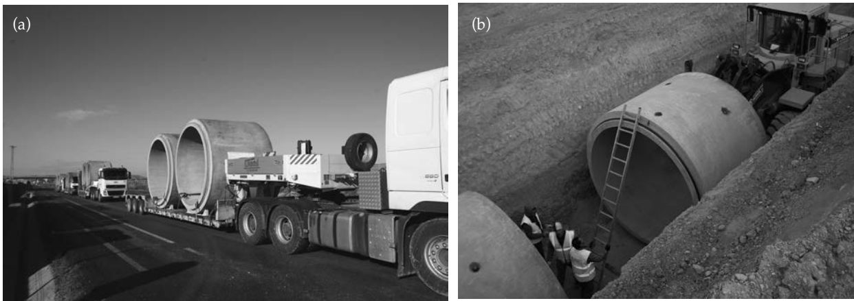
Figura 10. a) Transporte y b) colocación de los tubos. Cortesía de PREFRAGA
