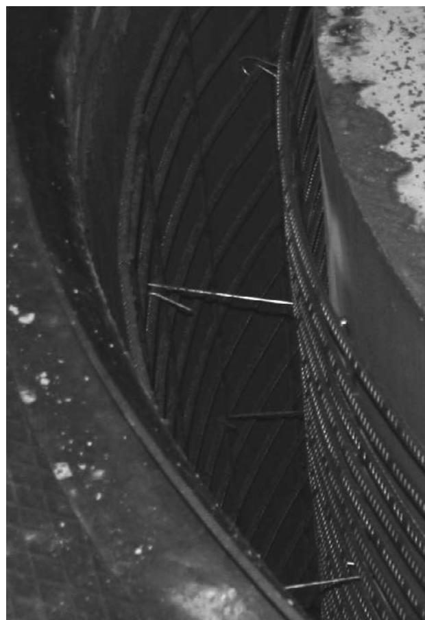
Figura 14. Estrategia empleada para garantizar la rigidez de las jaulas y los recubrimientos. Cortesía de PREFRAGA
