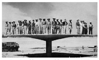
Figura 7. Modelo experimental de un paraguas (1953)
