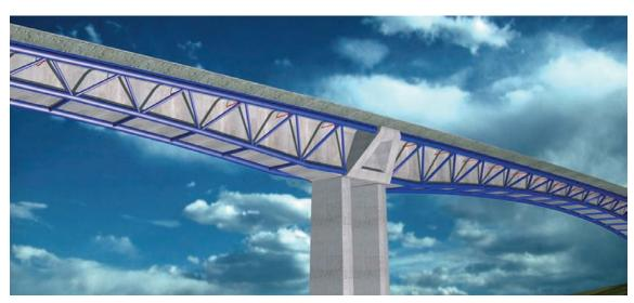
Figura 5. Solución I. Ampliación mediante celosías metálicas Figure 5. Solution I. Widening the deck using steel trusses
