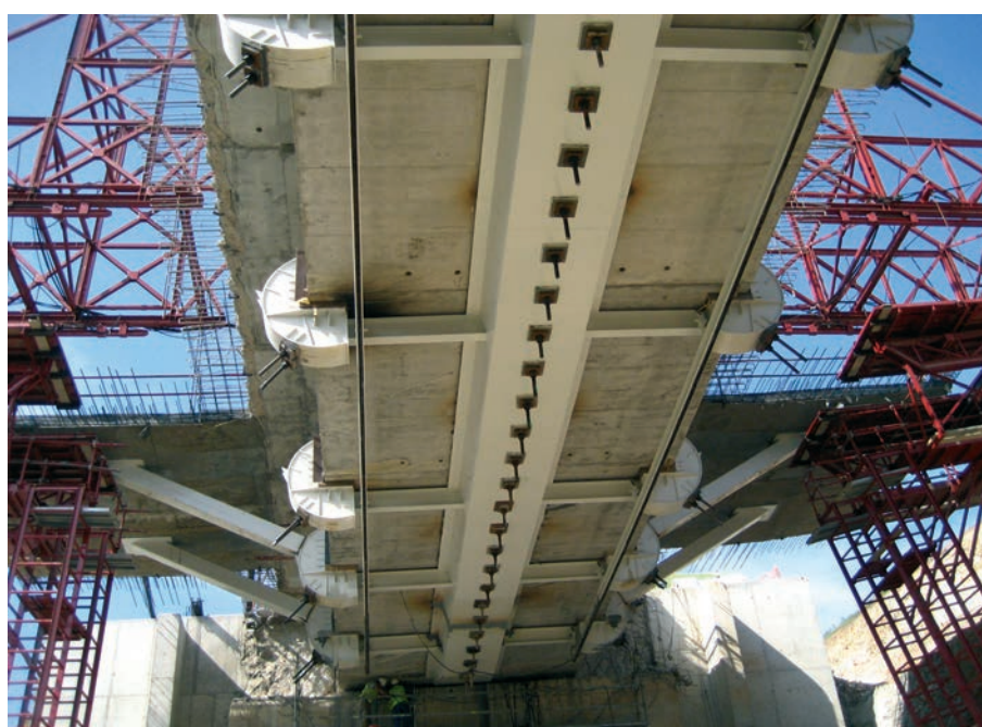
Figura 16. Refuerzo de tablero: núcleo mixto, travesaños, nudos, jabalones y nuevo forjado de ampliación
