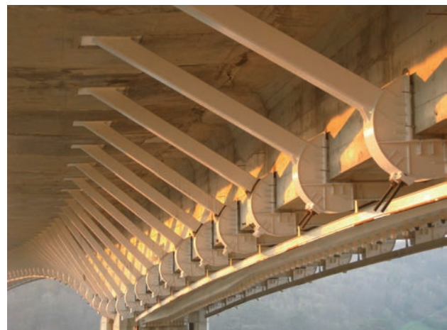
Figura 19. Jabalcones, nudos metálicos y forjados de ampliación Figure 19. Inclined struts, steel connections and upper widened slab
