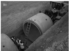
Figura 10. a) Transporte y b) colocación de los tubos. Cortesía de PREFRAGA
