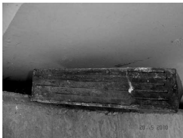
Figura 1. Chapas a la vista y goma retraída
