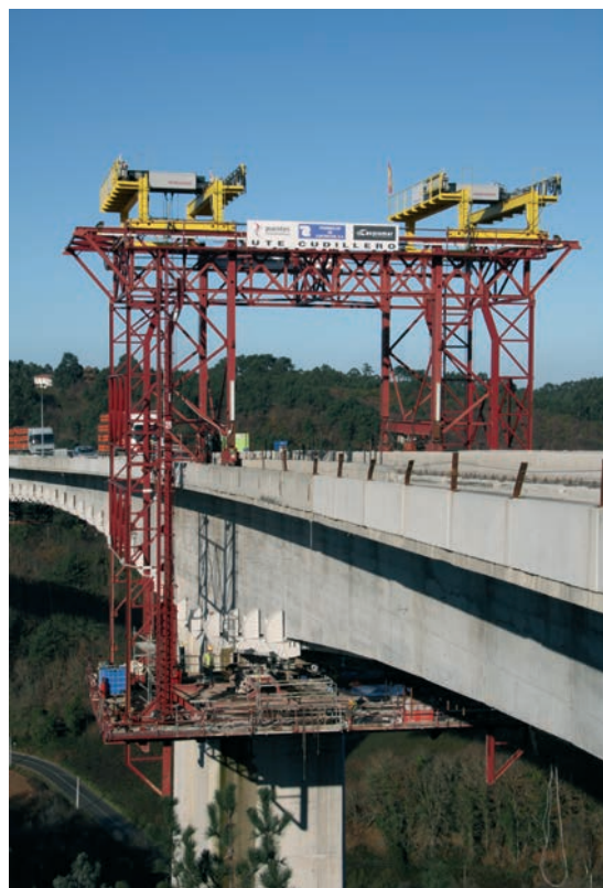
Figura 32. Carro n°1 Figure 32. Movable scaffolding n. 1
