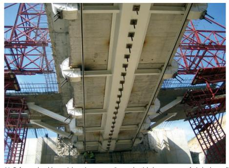
Figura 16. Refuerzo de tablero: núcleo mixto, travesaños, nudos, jabalcones y nuevo forjado de ampliación Figure 16. Reinforcing of the deck: composite box section, transverse beams, steel struts and new transvers cantilever slab
