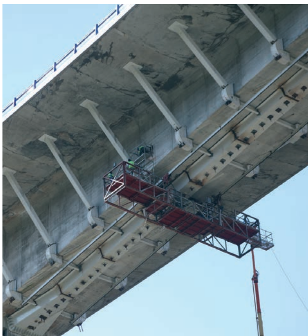
Figura 36. Vista de carro nº2 Figure 36. General view of movable scaffolding n. 2
