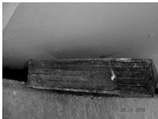
Figura 1. Chapas a la vista y goma retraída
