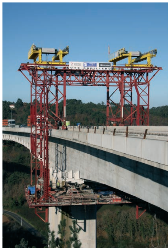
Figura 32. Carro n.º1 Figure 32. Movable scaffolding n. 1
