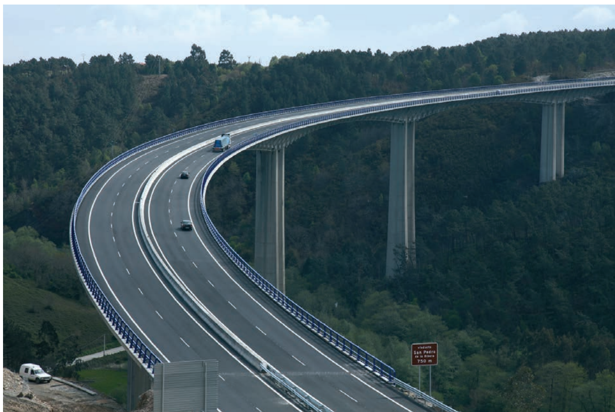
Figura 44. Viaducto de San Pedro en servicio una vez ampliado Figure 44. The Bridge of San Pedro de la Ribera once it has been widened
