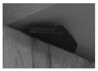
Figura 9. La artesa queda apoyada en un solo lado de la línea
