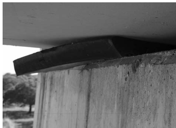
Figura 8. Apoyo totalmente fuera de la meseta
