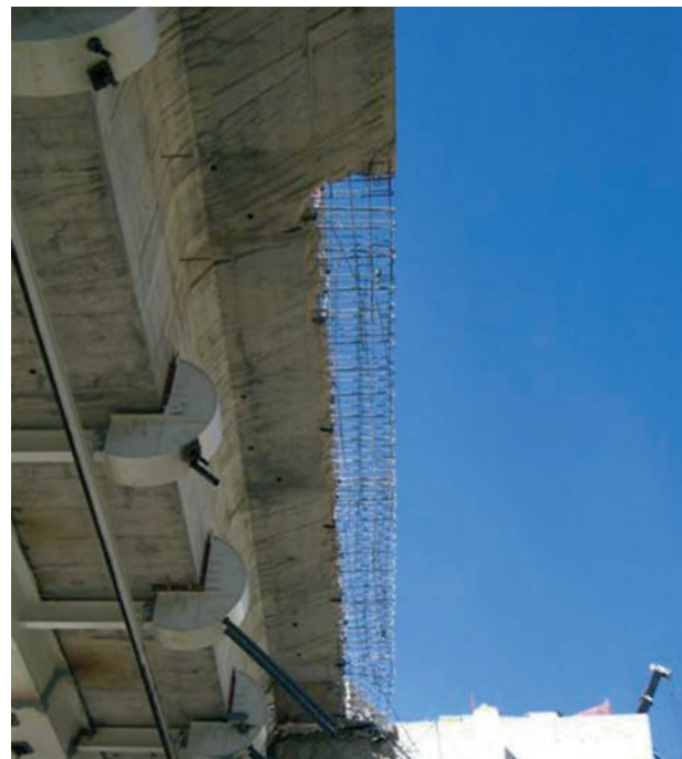
Figura 37. Demolición del último metro de voladizo original
