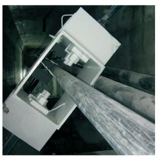
Figure 35. Puente especial para interferencias entre diagonales y pretensado exterior
