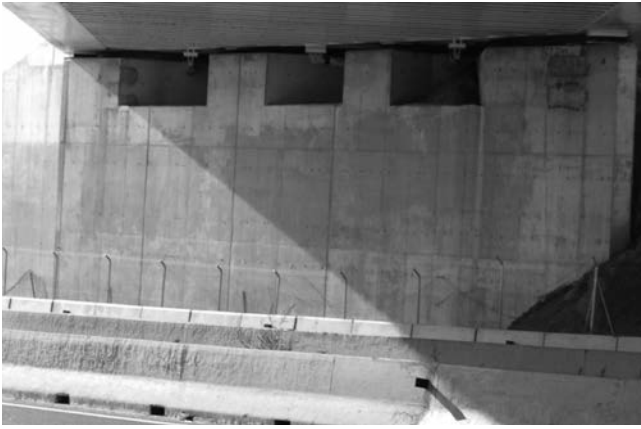
Figura 11. Vista del alzado de un estribo
