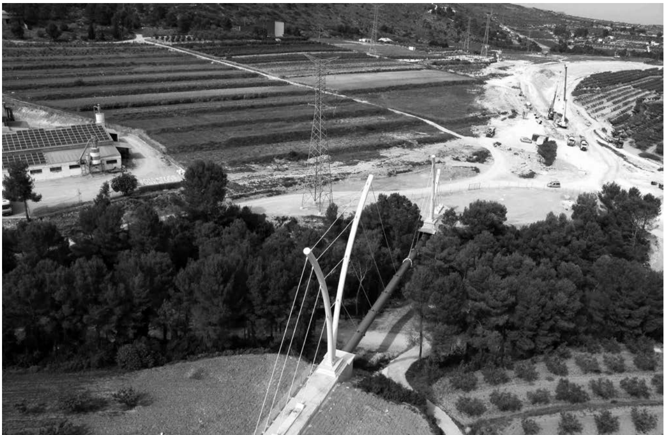
Figura 11. Vista aérea de la estructura terminada
