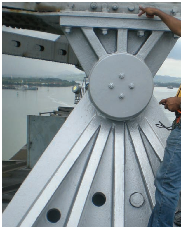
Figura 19. Apoyo piramidal reparado con rodillo inferior en P6 Figure 19. Pyramidal bearing repaired with bottom roller in P6
