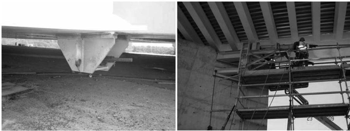
Figura 22. Disposición de las barras de tiro
