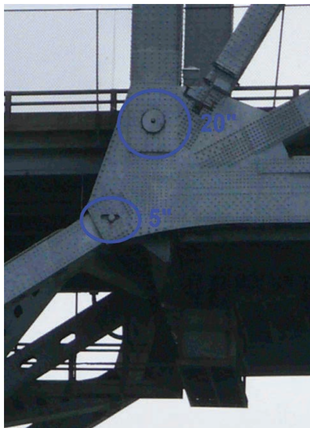
Figura 14. Bulones inferiores de 5" y 20" Figure 14. 5" and 20" pins
