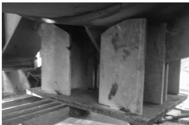
Figura 8. Gatos hidráulicos para izado de la estructura
