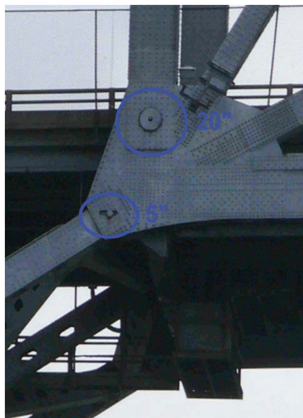
Figura 14. Bulones inferiores de 5" y 20" Figure 14. 5" and 20" pins
