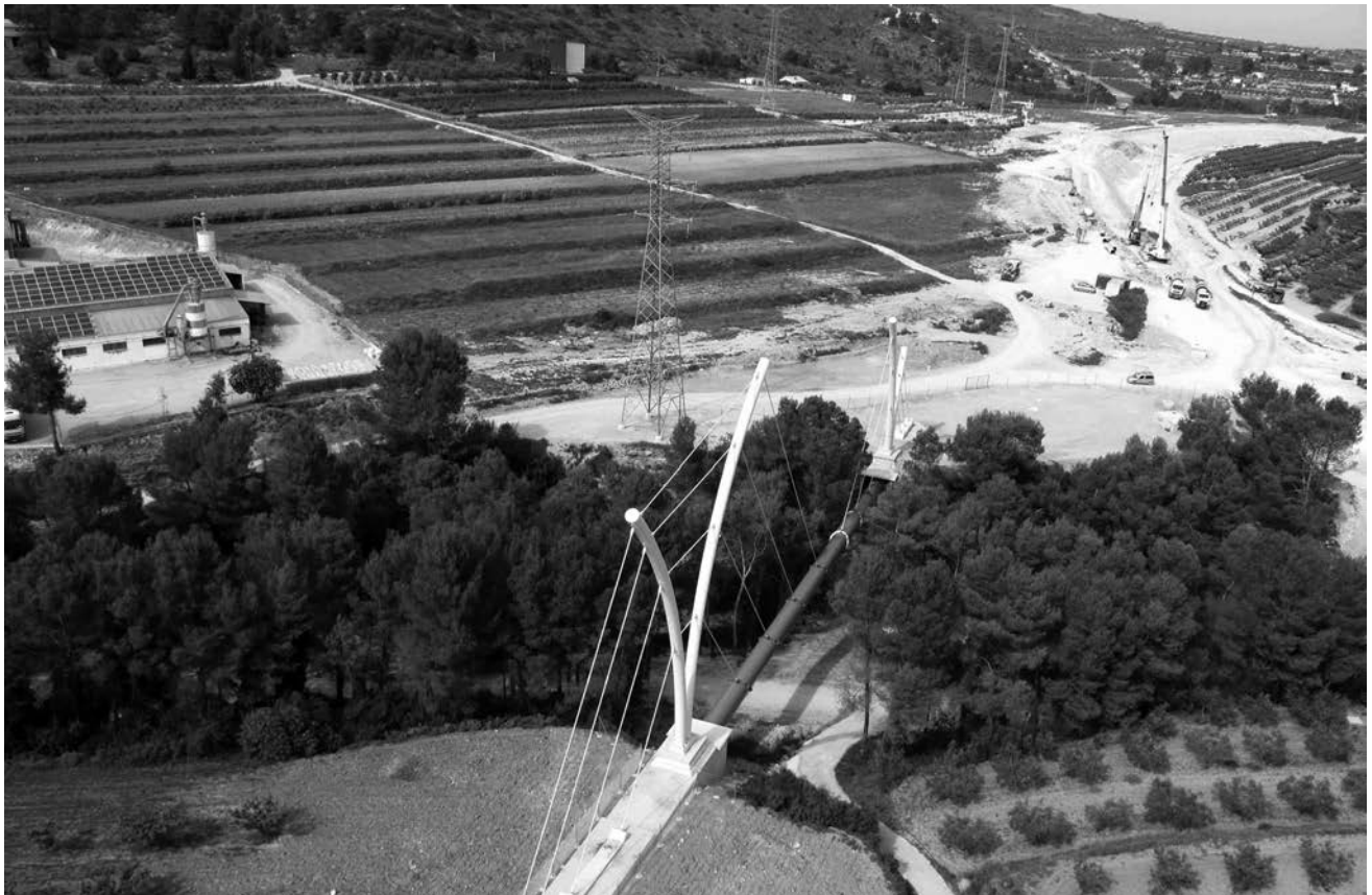
Figura 11. Vista aérea de la estructura terminada
