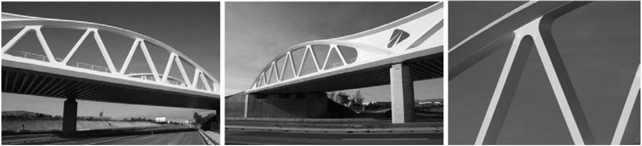
Figura 3. Vistas del puente
