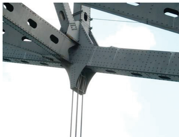
Figura 23. Péndola antigua y su conexión superior a la superestructura
