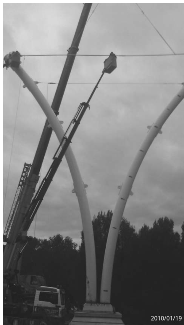
Figura 7. Colocación barras
