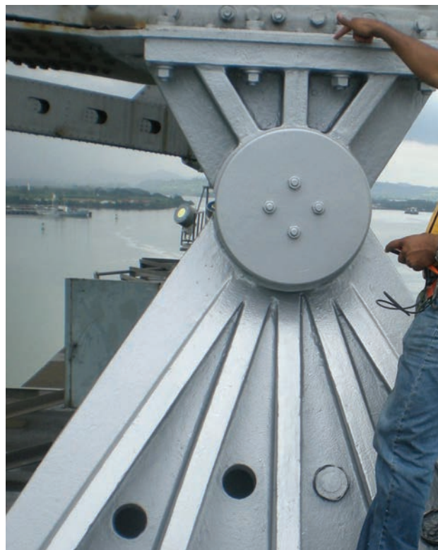
Figura 19. Apoyo piramidal reparado con rodillo inferior en P6 Figure 19. Pyramidal bearing repaired with bottom roller in P6
