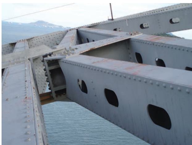
Figura 12. Guía deslizadora en plano superior de celosía Figure 12. Slide guide on upper truss
