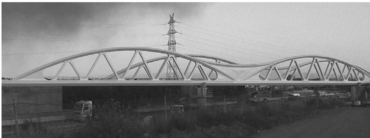
Figura 1. Vista del paso
