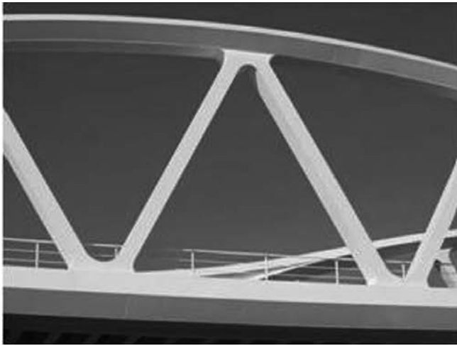
Figura 13. Vista de una de las celosías longitudinales
