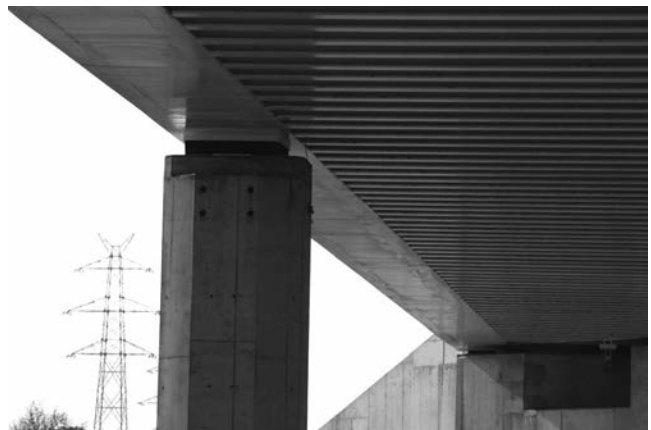
Figura 12. Vista de una de las pilas
