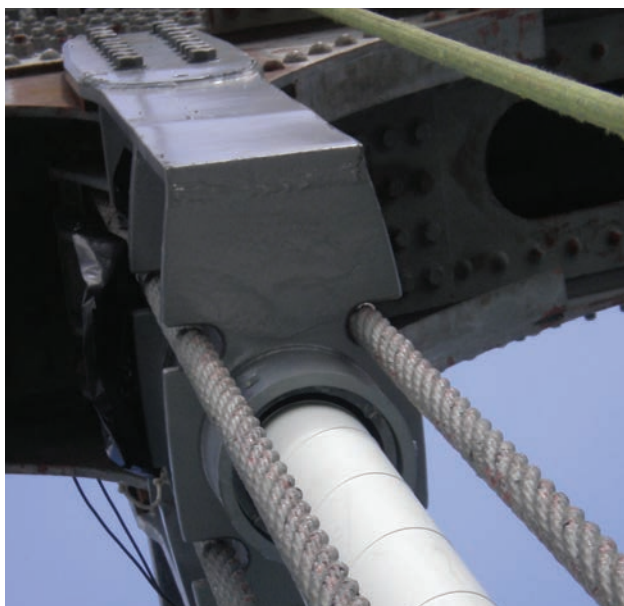
Figura 36. Nueva péndola colocada en la horquilla entre los cables originales
