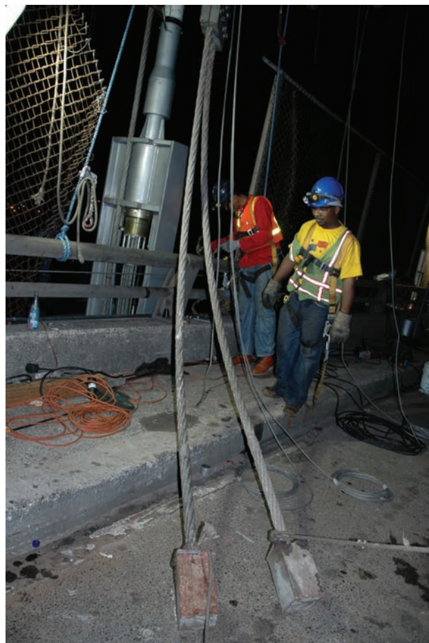
Figura 40. Retirada del sistema de cables originales Figure 40. Removing the original cable system
