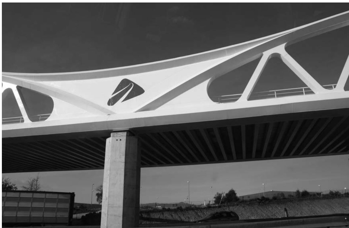
Figura 16. Zona de apoyo en pila
