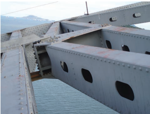
Figura 12. Guía deslizadora en plano superior de celosía Figure 12. Slide guide on upper truss
