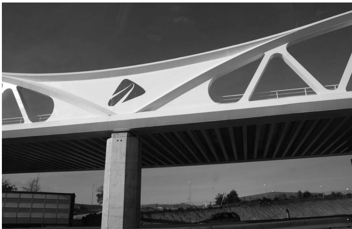
Figura 16. Zona de apoyo en pila
