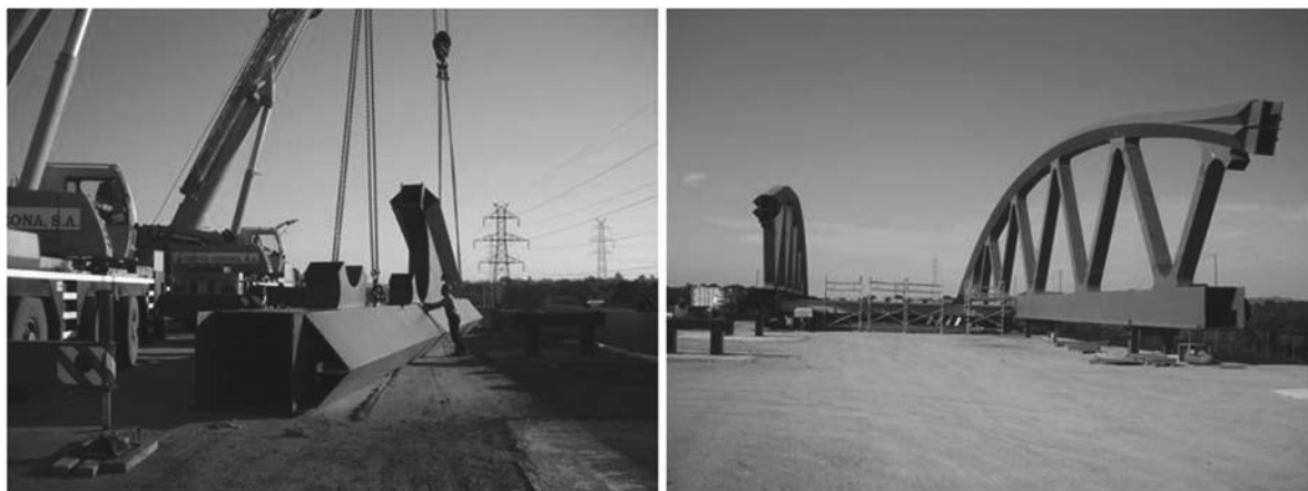
Figura 19. Ensamblaje de las celosías en obra
