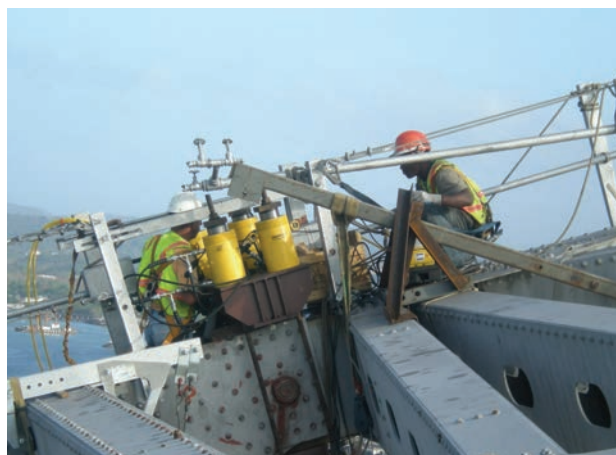
Figura 16. Proceso de sustitución de bulones Figure 16. Process to replace the pins
