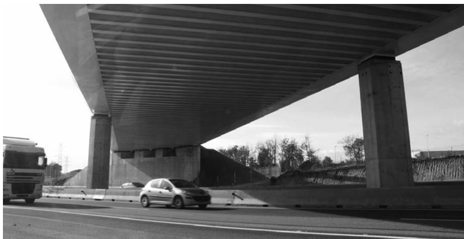
Figura 7. Vista inferior del paso
