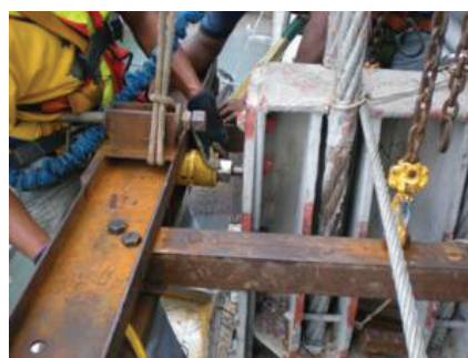
Figura 32. Proceso de sustitución de roblones Figure 32. Rivets replacement process
