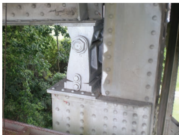
Figura 20. Estado final de los apoyos móviles Figure 20. Expansion bearing after repair
