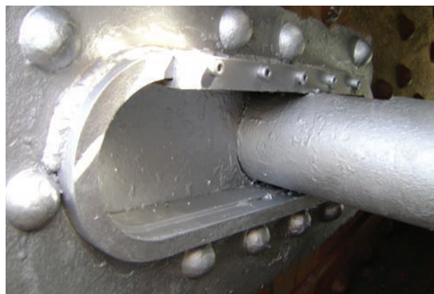
Figura 18. Nuevos bulones con guías y pista de desgaste Figure 18. New pins in slotted holes
