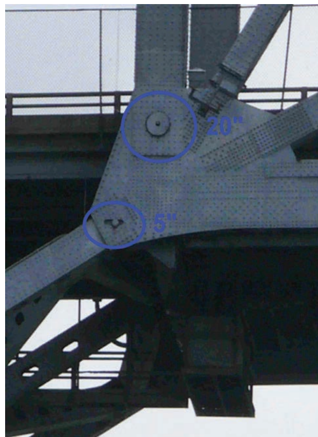
Figura 14. Bulones inferiores de 5" y 20" Figure 14. 5" and 20" pins
