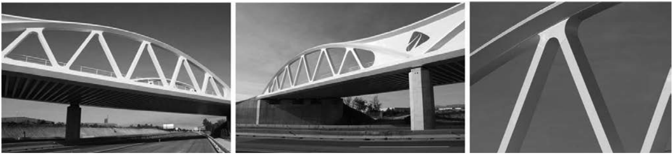
Figura 3. Vistas del puente
