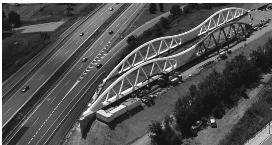
Figura 20. Vista de la estructura preparada para el empuje
