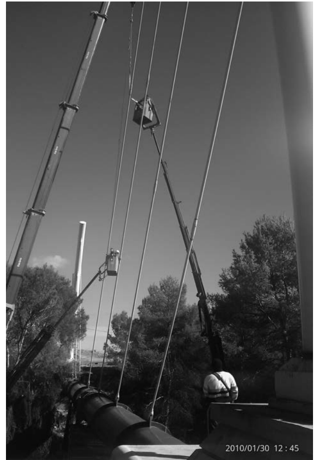
Figura 10. Roscado de las barras
