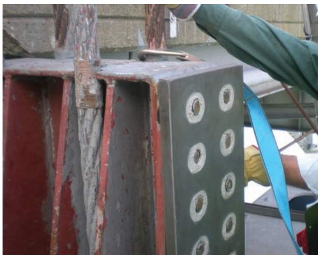
Figura 34. Unión calce y estructura preparada para la colocación de las nuevas horquillas
