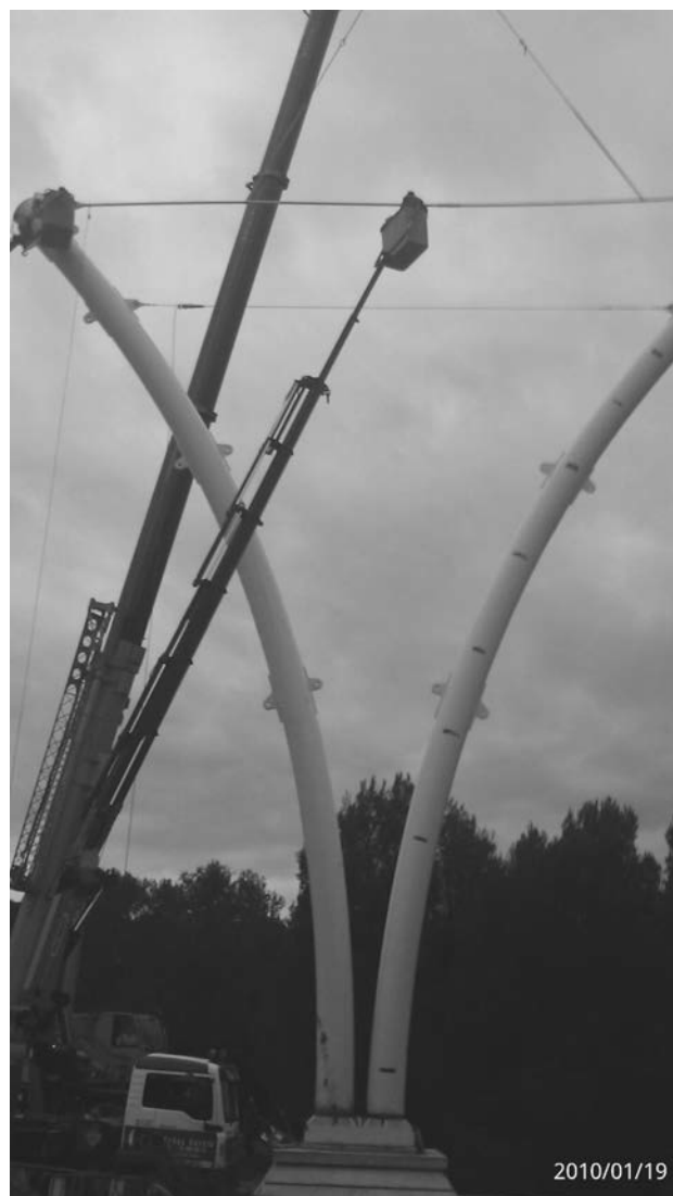
Figura 7. Colocación barras
