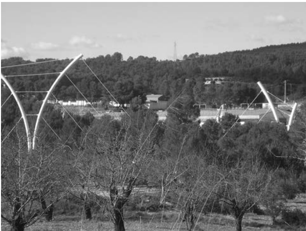
Figura 9. Perfil de la estructura terminada
