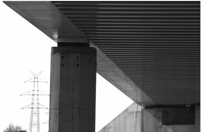
Figura 12. Vista de una de las pilas
