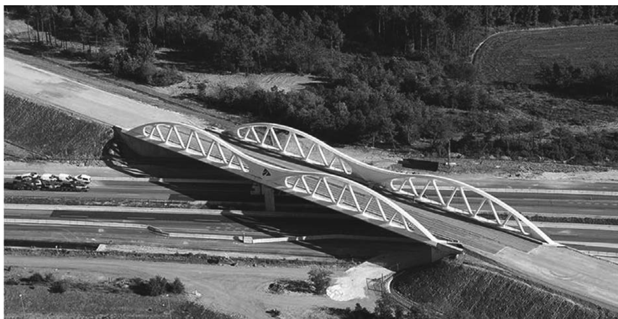
Figura 26. Vista del puente terminado
