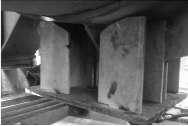
Figura 8. Gatos hidráulicos para izado de la estructura
