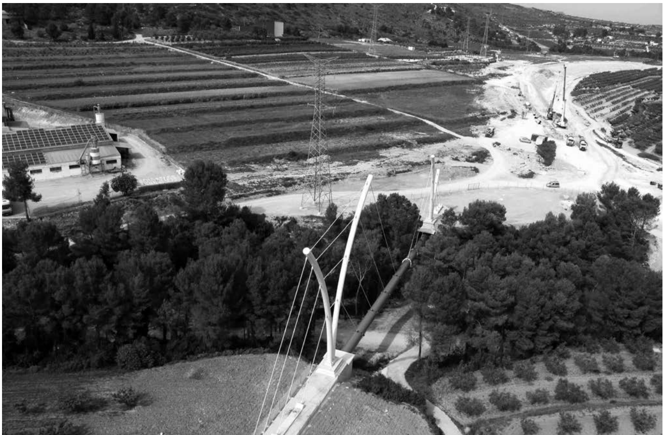
Figura 11. Vista aérea de la estructura terminada
