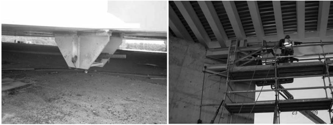
Figura 22. Disposición de las barras de tiro
