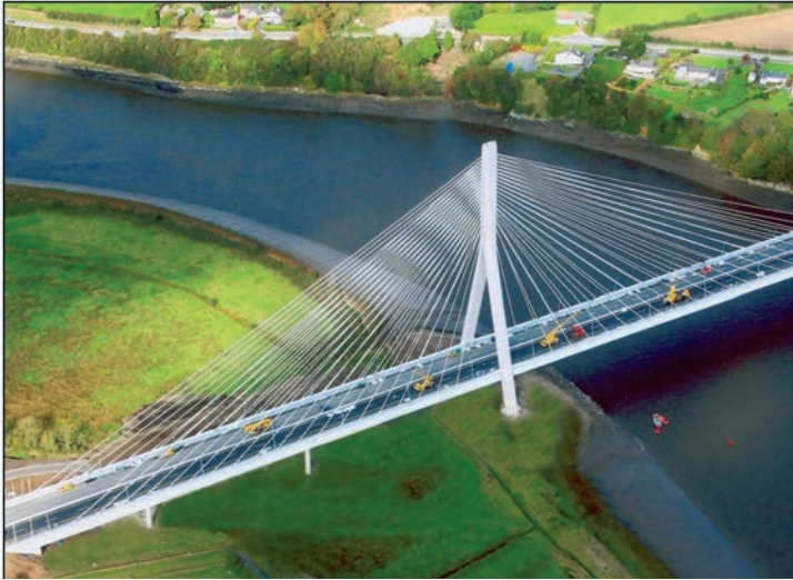
Vista aérea del Puente de Waterford (Irlanda)
