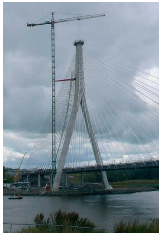
Pilono del Puente de Waterford (Irlanda) en construcción
