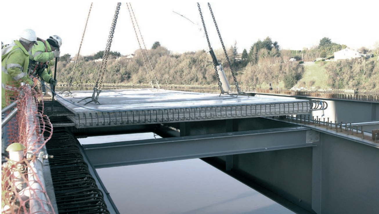
Figura 38. Colocación de losas prefabricadas Figure 38. Installation of precast slabs
