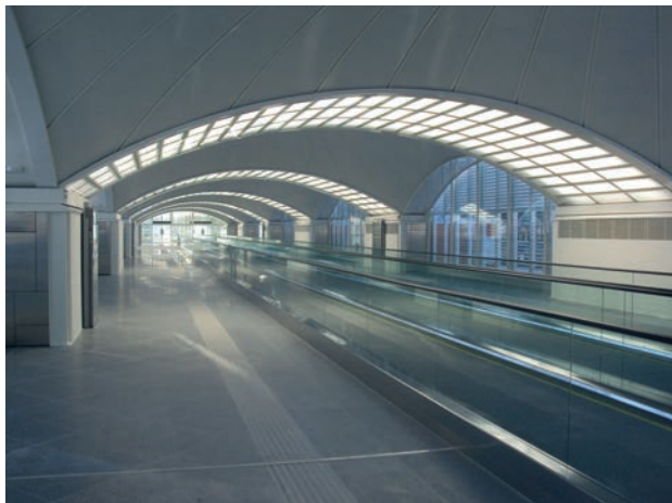
Pasillo rodante de la ampliación del Complejo de Atocha (Madrid)
