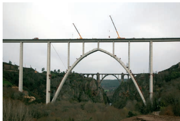
Arco principal del Viaducto sobre el río Ulla (Galicia) en construcción. Al fondo se aprecia el viaducto de la línea de ancho ibérico (siglo XIX)
