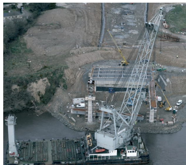
Figura 39. Colocación del tramo de espera mediante grúa flotante
