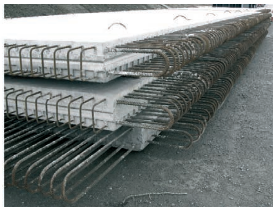
Figura 24. Junta transversal en el tablero y lazos de armadura de conexión Figure 24. Transverse joint in the deck and connecting rebar loops
