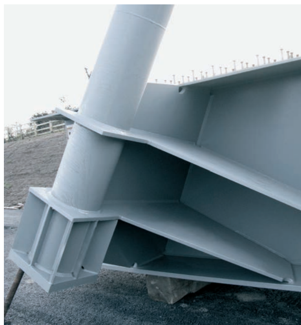
Figura 20. Anclaje de un tirante en el tablero Figure 20. Deck anchorage of a cable
