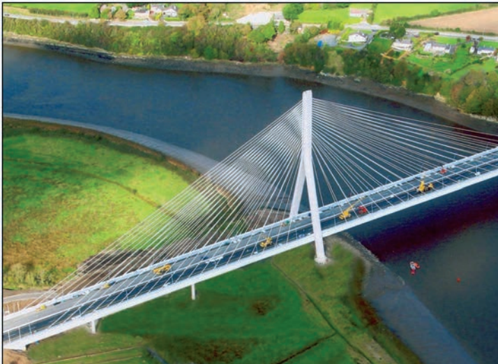
Vista aérea del Puente de Waterford (Irlanda)
