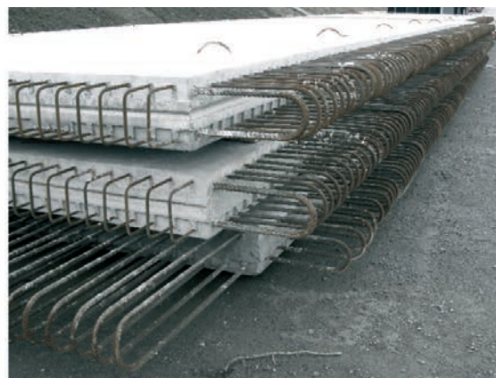
Figura 24. Junta transversal en el tablero y lazos de armadura de conexión Figure 24. Transverse joint in the deck and connecting rebar loops
