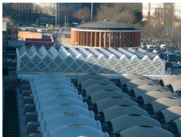
Vista aérea de la cubierta triangulada de la ampliación del Complejo de Atocha (Madrid)
