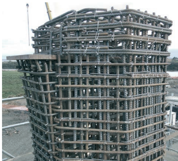
Figura 15. Armado de la cabeza de una pila Figure 15. Reinforcement of one pier
