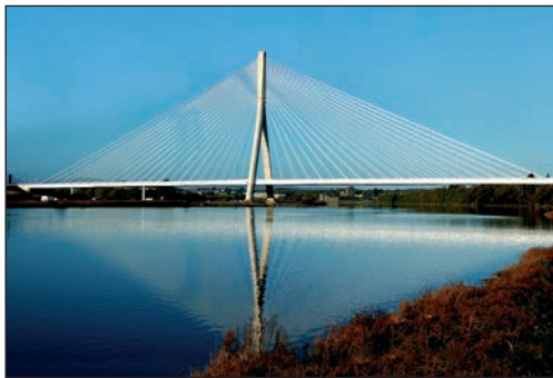
Foto de portada: Puente de Waterford, Irlanda. (Cortesía de ACS)
