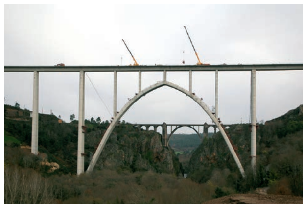
Arco principal del Viaducto sobre el río Ulla (Galicia) en construcción. Al fondo se aprecia el viaducto de la línea de ancho ibérico (siglo XIX)
