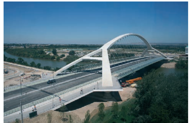
Vista general del Puente del Tercer Milenio (Zaragoza)
