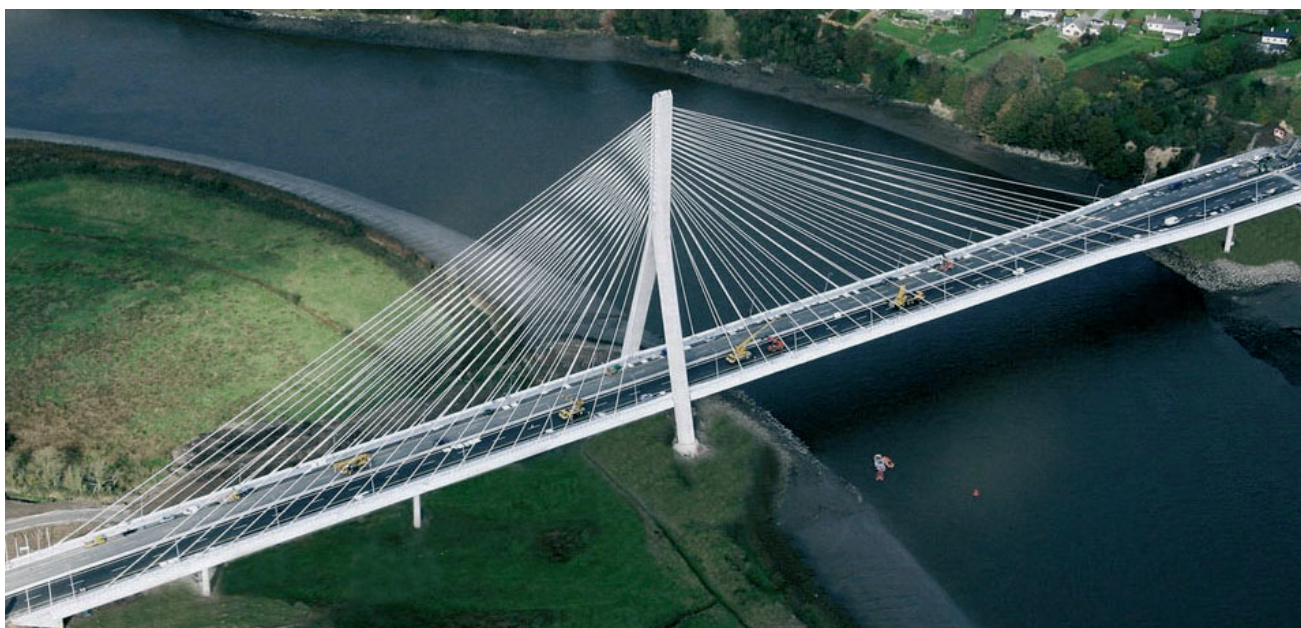
Figura 41. El puente sobre el río Suir terminado.
