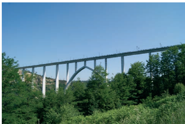
Vista general del Viaducto sobre el río Ulla (Galicia)
