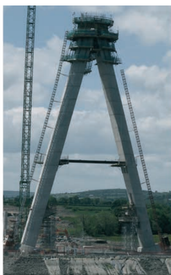
Figura 13. Distintas fases de construcción de la torre Figure 13. Different stages in the construction of the pylon
