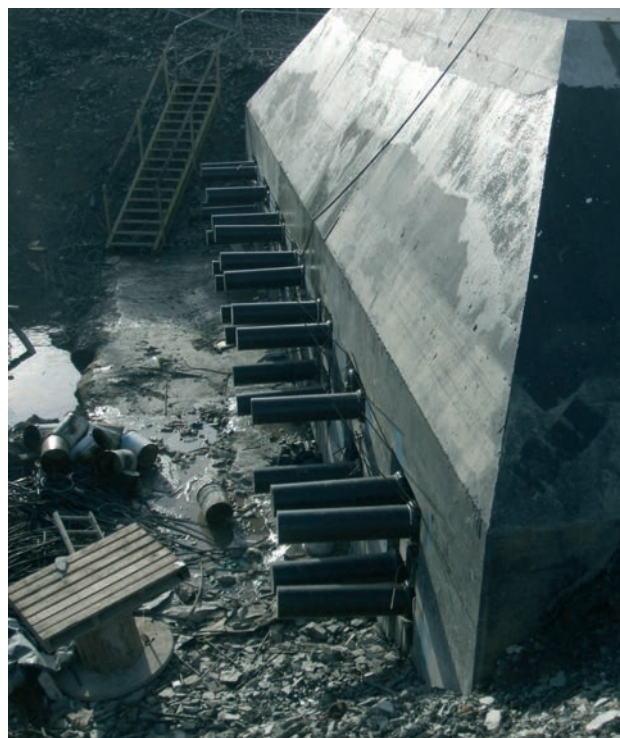
Figura 8. Anclajes del pretensado de la viga de atado Figure 8. Anchorages for the tie beam prestressing
