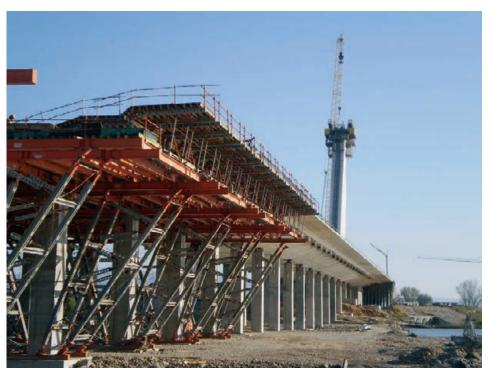
Figura 38. Frente de avance de tablero con ejecución simultánea de pilono Figure 38. Deck construction front and simultaneous erection of pylon
