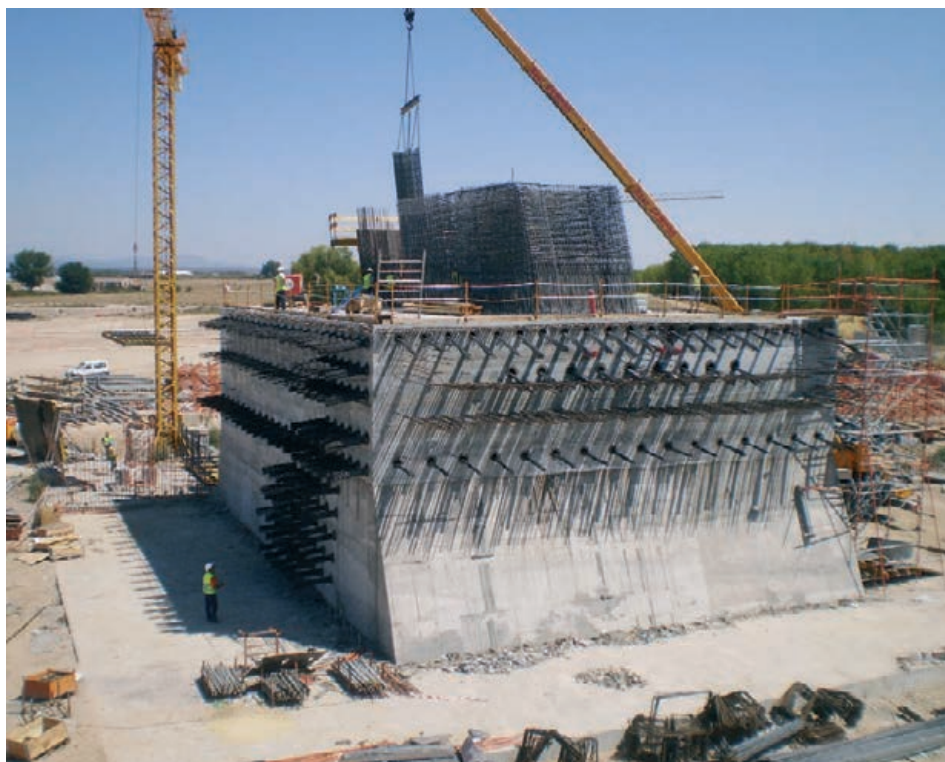
Figura 26. Mamparo en hormigón gris. Arranque de armado de pilono y pretensado transversal del mamparo Figure 26. Grey concrete bulkhead: pylon reinforcement springing and transverse prestressing in bulkhead
