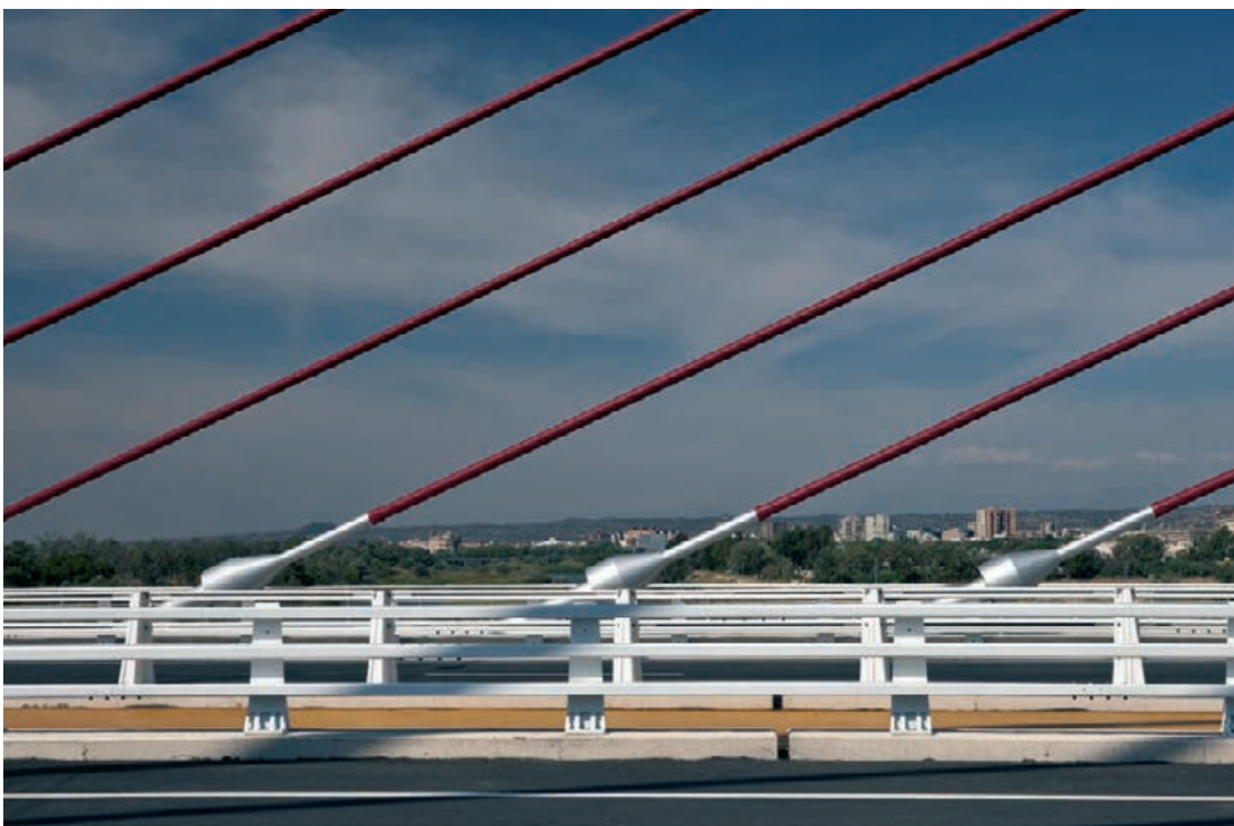
Figura 16. Tirantes separados longitudinalmente cada 7,00 metros en el tablero Figure 16. Stays spaced at 7.00 m longitudinally along the deck
