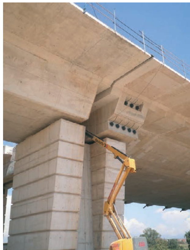
Figura 11. Pila P-1, P-2 y diafragma extremo. Unión del puente atirantado con el viaducto de acceso
