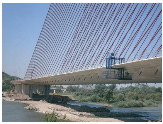
Figura 15. Cesta desde la que se realiza el tesado de los cables de sustentación Figure 15. Man lift for stressing the support cables
