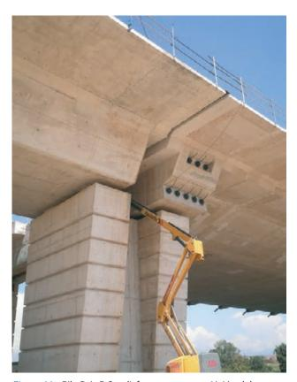
Figura 11. Pila P-1, P-2 y diafragma extremo. Unión del puente atirantado con el viaducto de acceso Figure 11. Piers P-1 and P-2 and end diaphragm. Abutment between cable-stayed bridge and approach viaduct
