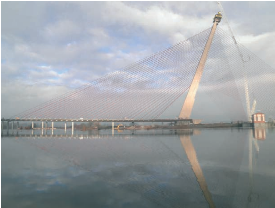
Figura 39. Construcción del pilono, tesado de cables y eliminación de pilas según avance del tesado Figure 39. Pylon construction, cable stressing and pier removal
