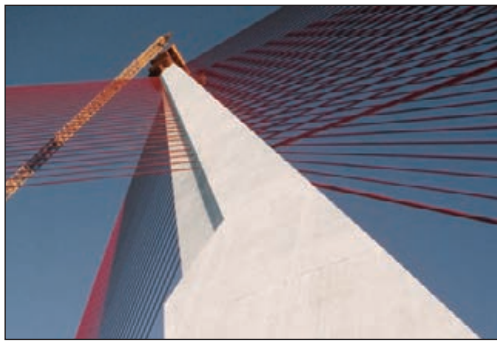
Foto de portada: Puente atirantado de Talavera de la Reina (Toledo)
