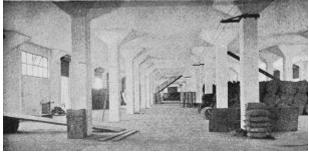
Figura 1. Primeras aplicaciones y desarrollos de losas planas sobre columnas con capiteles: (a) disposición de armaduras de flexión según el sistema de Maillart (izquierda) y de Turner (derecha) [4]; (b) ensayo de losa plana efectuado en 1908 por R. Maillart [4]; (c) depósito de Zürich-Giesshübel (ing. R. Maillart, 1910) [4,5]; y (d) depósito de mercancías del puerto de pasajes (Guipúzcoa, 1936, ing. C. Fernández Casado) [6]
