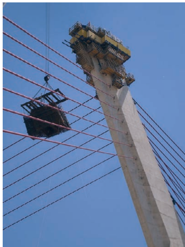
Figura 22. Izado de tramo de célula entre tirantes de retenida Figure 22. Hoisting section of cage between back stays
