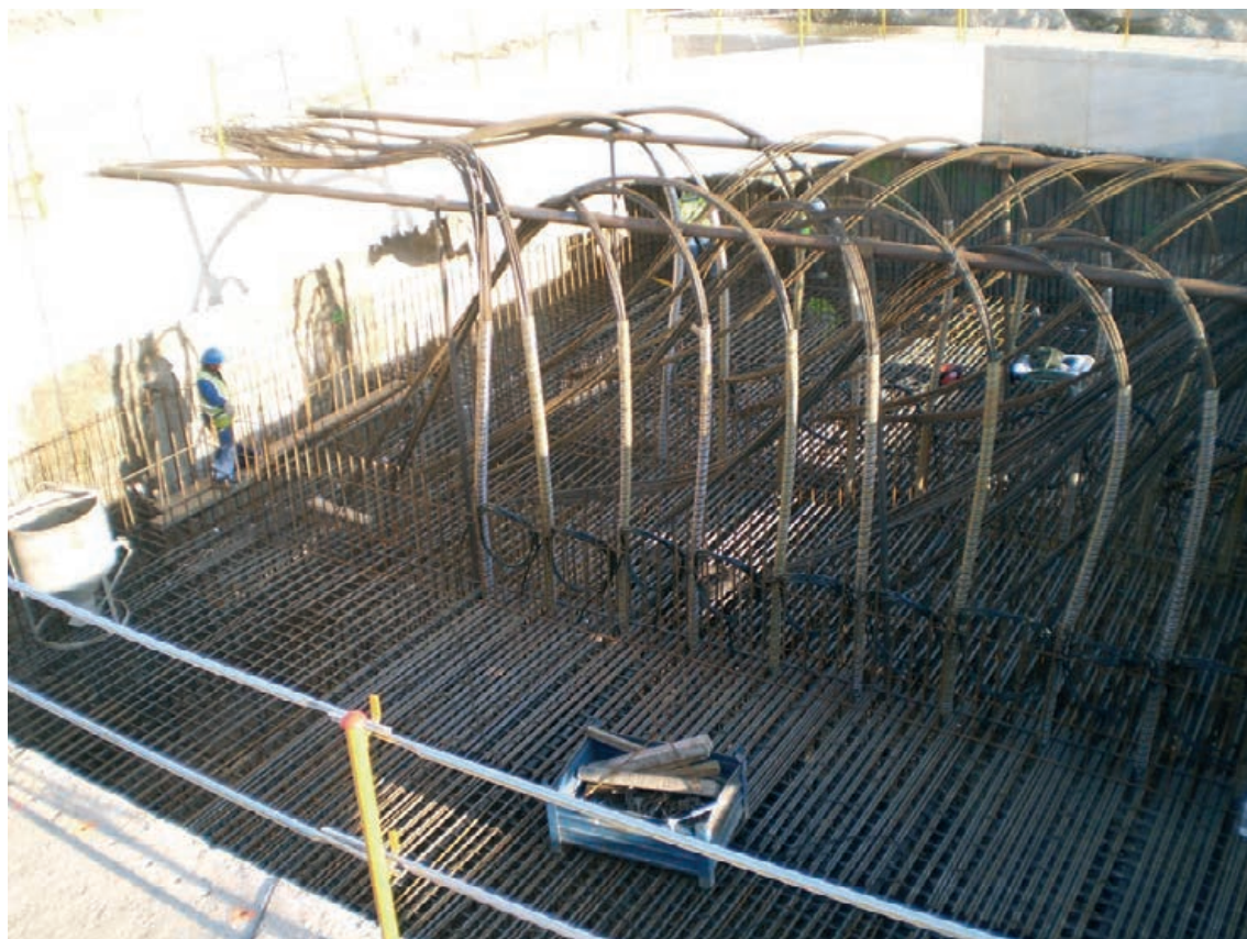
Figura 33. Muerto de anclaje. Armado de losa inferior y pretensados verticales Figure 33. Anchorage block: bottom slab reinforcement and vertical prestressing
