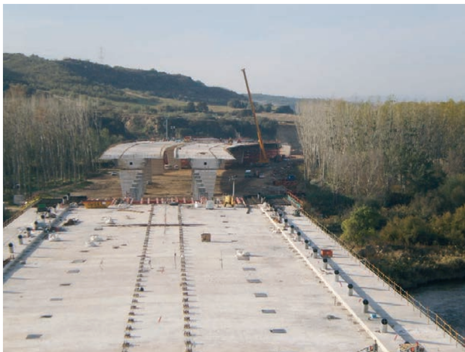
Figura 36. Avance del tablero del puente atirantado. Al fondo, los tableros del viaducto de acceso Figure 36. Cable-stayed bridge deck construction with the approach viaduct decks in the background
