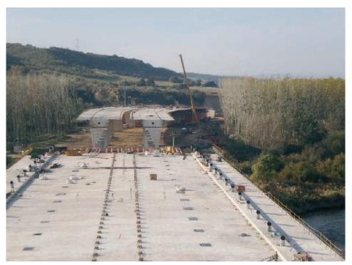
Figure 36. Avance del tablero del puente atirantado. Al fondo, los tableros del viaducto de acceso Figure 36. Cable-stayed bridge deck construction with the approach viaduct decks in the background
