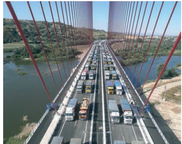
Figura 45. Fase de máxima carga en la prueba de carga Figure 45. Maximum load stage during load trial
