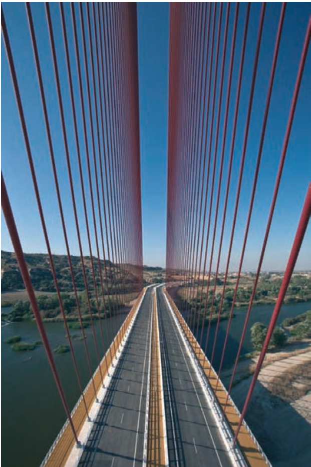
Figura 13. Tirantes de sustentación del tablero en dos planos de 38 cables cada uno
