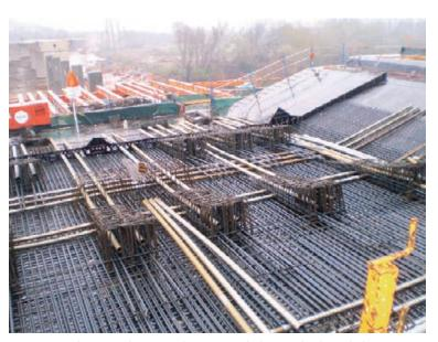
Figura 7. Colocación de vainas de pretesando longitudinal en el último tercio del tablero
