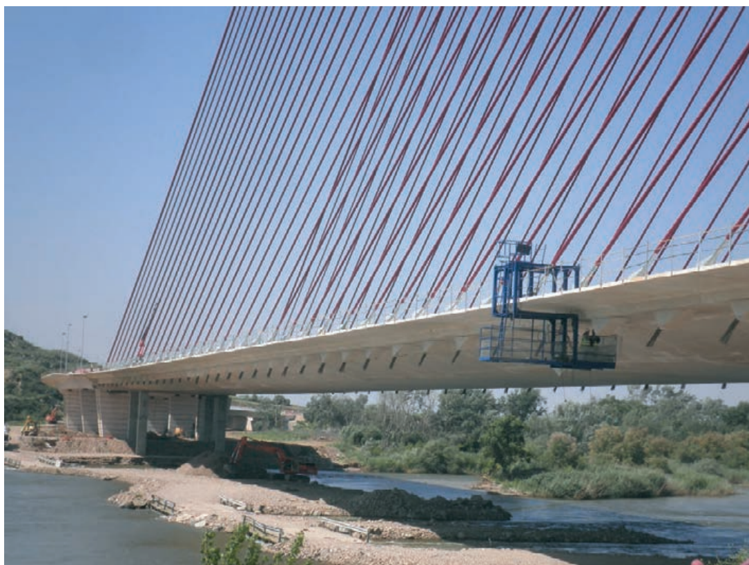
Figura 15. Cesta desde la que se realiza el tesado de los cables de sustentación Figure 15. Man lift for stressing the support cables
