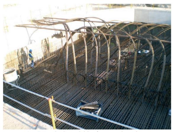
Figura 33. Muerto de anclaje. Armado de losa inferior y pretensados verticales Figure 33. Anchorage block: bottom slab reinforcement and vertical prestressing
