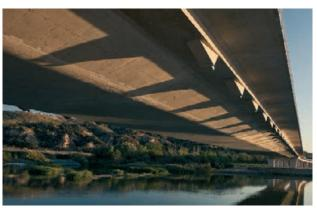
Figura 10. Vista inferior del tablero terminado. Al fondo, la pila P1 y el viaducto de acceso Figure 10. Finished bridge soffit with pier P-1 and the approach viaduct in the background
