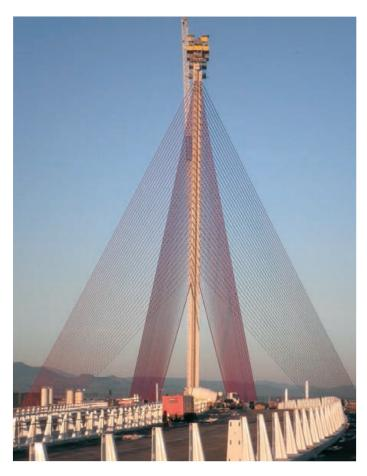
Figura 25. Pilono arriostrado por los planos de atirantamiento Figure 25. Pylon braced by the stay planes
