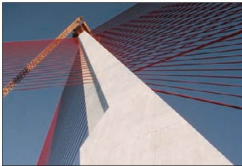
Foto de portada: Puente atirantado de Talavera de la Reina (Toledo)
