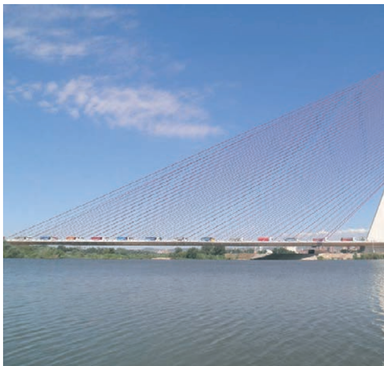
Figura 44. Prueba de carga Figure 44. Load trial
