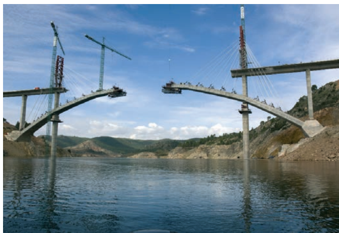
Figura 19. Construcción en avance en voladizo atirantado Figure 19. Cable-stayed free cantilever launching
