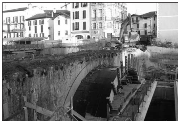
Figura 15. Montaje de la cimbra utilizada para la demolición del Pont-Vieux
