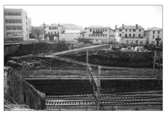
Figura 4. Ejecución de los taludes de acceso y desplazamiento del plano de la catenaria
