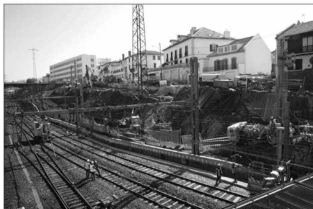
Figura 4. Ejecución de los taludes de acceso y desplazamiento del plano de la catenaria
