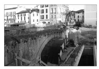
Figura 15. Montaje de la cimbra utilizada para la demolición del Pont-Vieux
