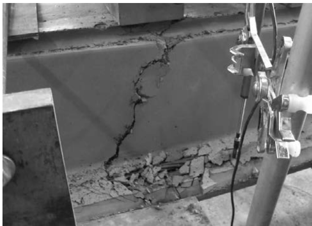
Figura 15. Fallo a flexión producido en una de las vigas ensayadas
