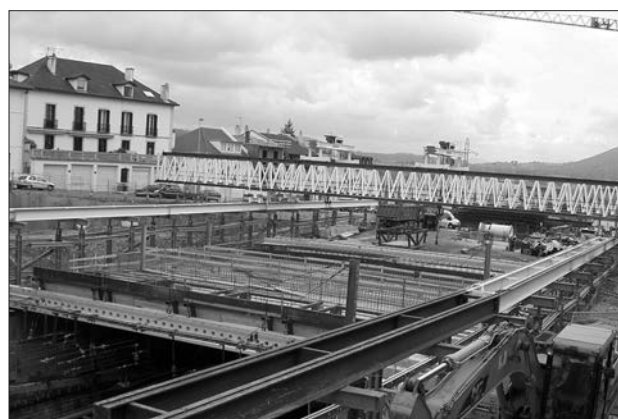
Figura 7. Losa 1 en ejecución: colocación de las primeras vigas de 40 m de luz
