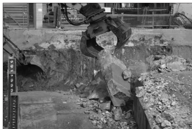
Figura 16. El Pont-Vieux en curso de demolición y desmontaje de la dovela de clave
