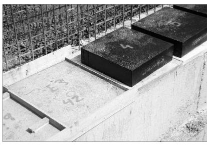
Figura 14. Aparatos de apoyo de neopreno zunchado
