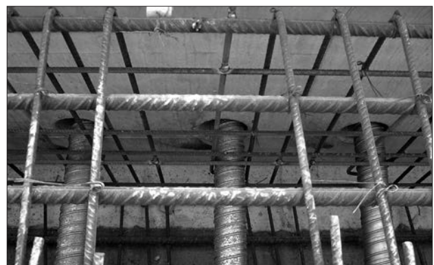
Figura 9. Armadura entre vigas y vainas del pretensado transversal
