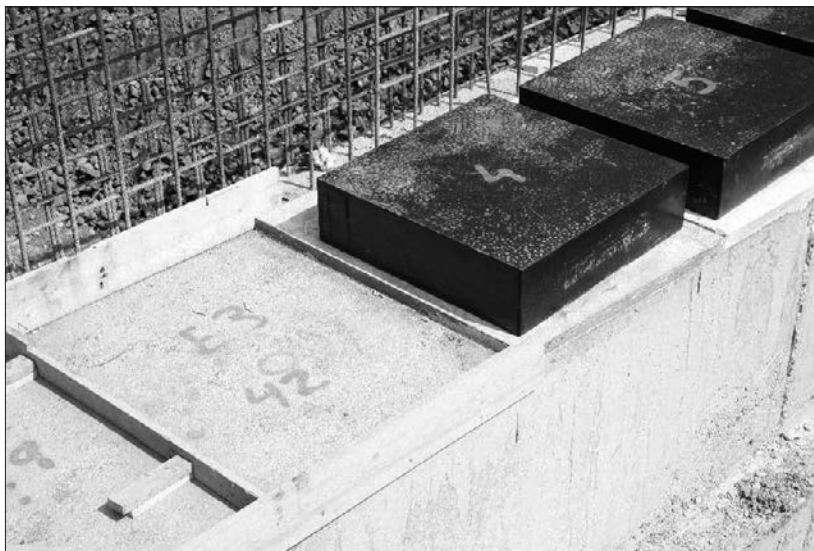
Figura 14. Aparatos de apoyo de neopreno zunchado
