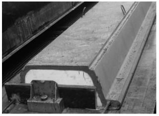
Figura 14. Sección del elemento pretensado, en la que se aprecia el poco recubrimiento del cordón en su parte superior
