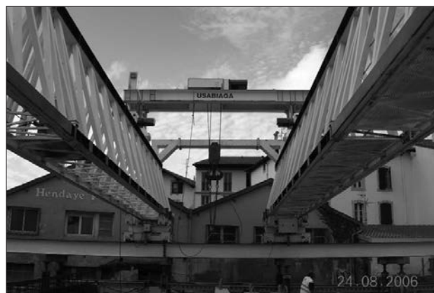
Figura 8. Pórtico lanzador de vigas en la losa tipo
