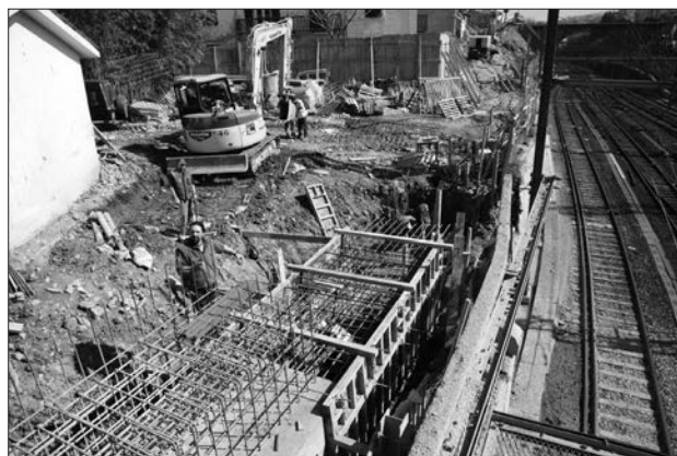
Figura 5. Anclajes provisionales en cabeza de talud y posterior ejecución del muro norte de apoyo de las vigas prefabricadas
