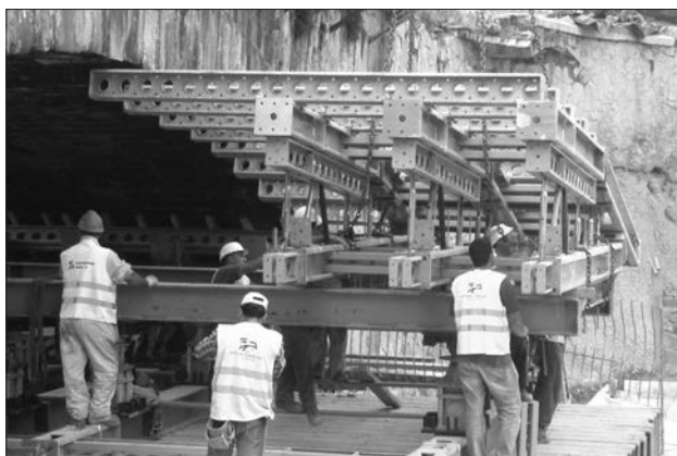
Figura 15. Montaje de la cimbra utilizada para la demolición del Pont-Vieux
