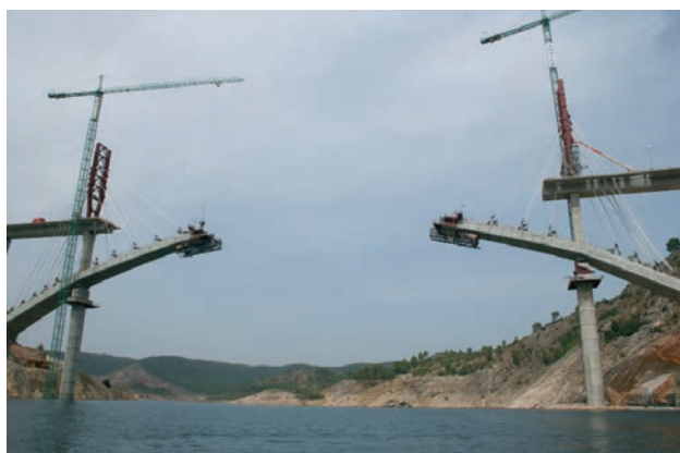
Figura 16. Construcción por avance en voladizo con atirantamiento sobre pila provisional Figure 16. Free cantilever launch with cable-staying on a temporary pier
