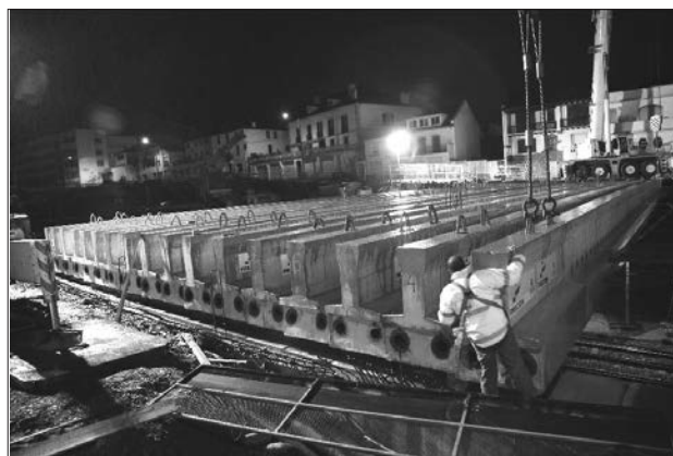
Figura 7. Losa 1 en ejecución: colocación de las primeras vigas de 40 m de luz
