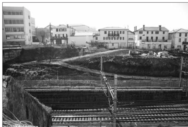
Figura 4. Ejecución de los taludes de acceso y desplazamiento del plano de la catenaria
