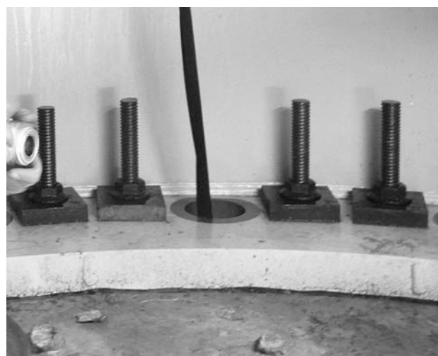
Figura 17. Torre de Hamina. Brida de conexión
