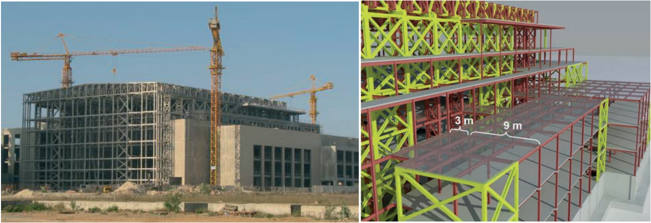
Figuras 25 y 26. Vista del edificio de oficinas a la derecha del auditorio (lado Oeste) y luces de vigas principales mixtas
