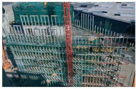
Figura 29. Construcción de la capa interior de fachada mediante módulos (vista desde el Hotel Diagonal Zero) Figure 29. Facade inner layer under construction through columns sets (view from the Hotel Diagonal Zero)
