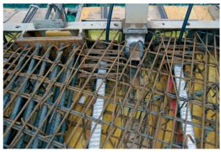
Figura 14. Apoyo de losa postesada en soportes mediante tubos
