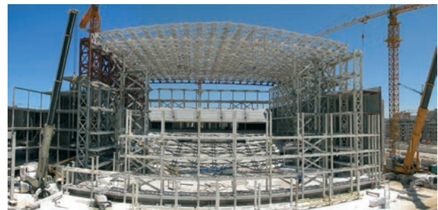
Figura 14. Vista de la estructura del auditorio durante su construcción
