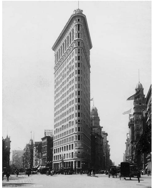
Figura 2. Vista del Edificio Flatiron desde la Avenida Broadway Figure 2. Flatiron building elevation from Broadway Avenue
