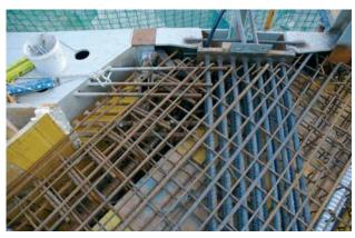
Figura 26. Detalle del encuentro entre viga descolgada postesada, viga de patio y cajetín de recepción de un bambú Figure 26. Intersection detail among post-tensioned downstand beam, patio beam and steel box for bamboo connection
