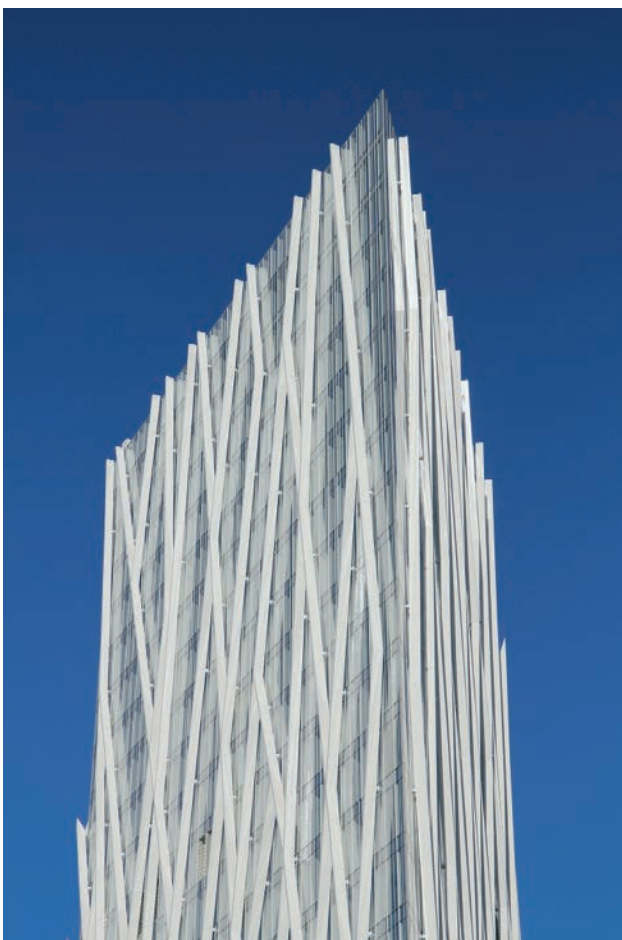
Figura 34. Edificio terminado. Vista de su coronación desde la Avenida Diagonal
