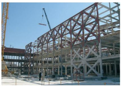
Figura 19. Vista de la estructura del pórtico de arriostamiento frente al sismo de la fachada de entrada del auditorio (eje 39)
