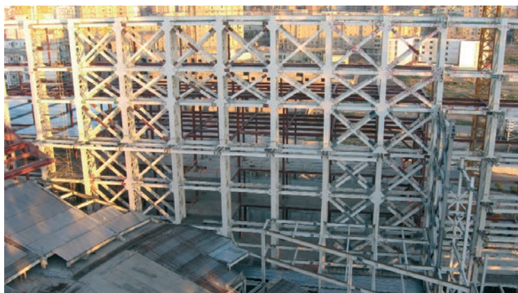
Figura 15. Vista del pórtico de arriostramiento del eje O
