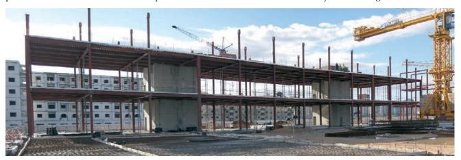
Figura 7. Vista del edificio de entrada apeado durante la ejecución. Forjados de niveles 1 y 2 ejeuctados
