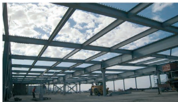
Figura 4. Vista de la estructura metálica de la cubierta del restaurante, apoyada en 6 pilares centrales
