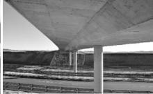
Figura 1. Puente integral monitorizado con tablero de hormigon postesado situado en la Provincia de Avila, España
