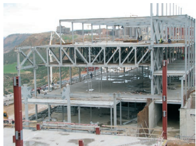
Figura 28. Vista del edificio de Jefes de Estado en ejecución
