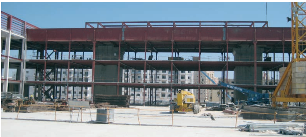
Figura 8. Vista del edificio de entrada apeado con las vigas de cuelgue del nivel 3 ejecutadas
