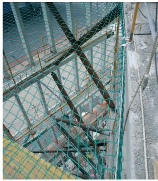
Figura 30. Arriostramiento provisional capa interior fachada en patio
