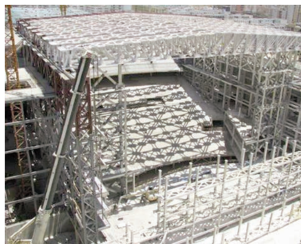
Figura 37. Vista de la cubierta prácticamente concluida
