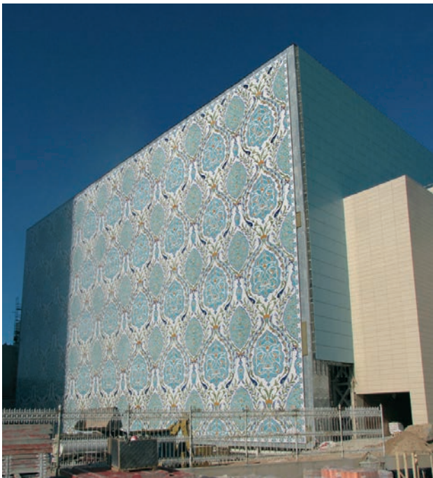
Figura 20. Vista en primer plano del mosaico de la fachada Oeste del auditorio
