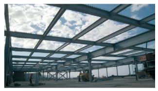
Figura 4. Vista de la estructra metálica de la cubierta del restaurante, apoyada en 6 pilares centrales
