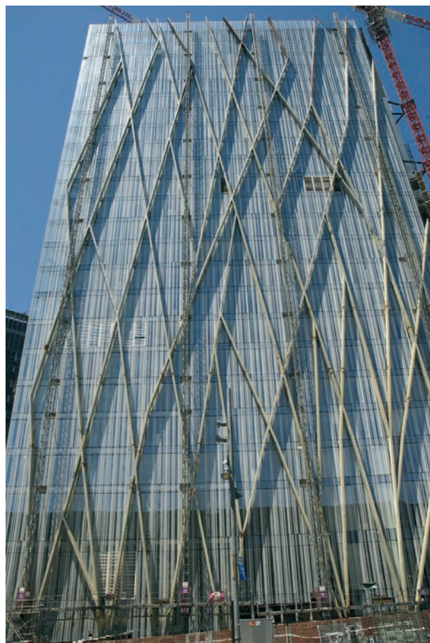
Figura 35. Edificio terminado. Vista desde el edificio Fórum
