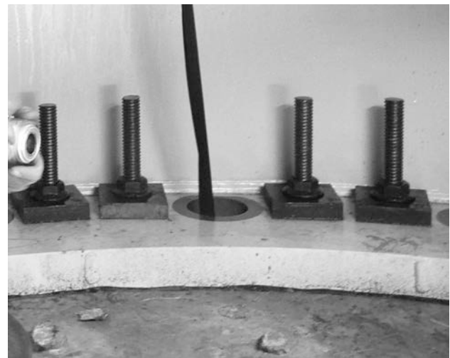
Figura 17. Torre de Hamina. Brida de conexión
