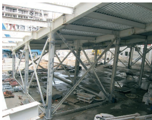
Figura 34. Vista de los arriostramientos durante la ejecución
