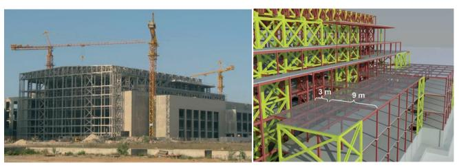
Figuras 25 y 26. Vista del edificio de oficinas a la derecha del auditorio (lado Oeste) y luces de vigas principales mixtas
