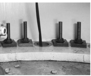
Figura 17. Torre de Hamina. Brida de conexión
