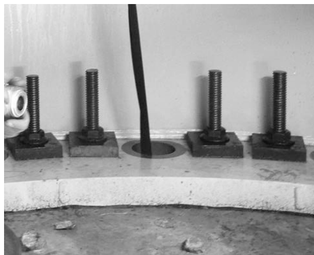
Figura 17. Torre de Hamina. Brida de conexión
