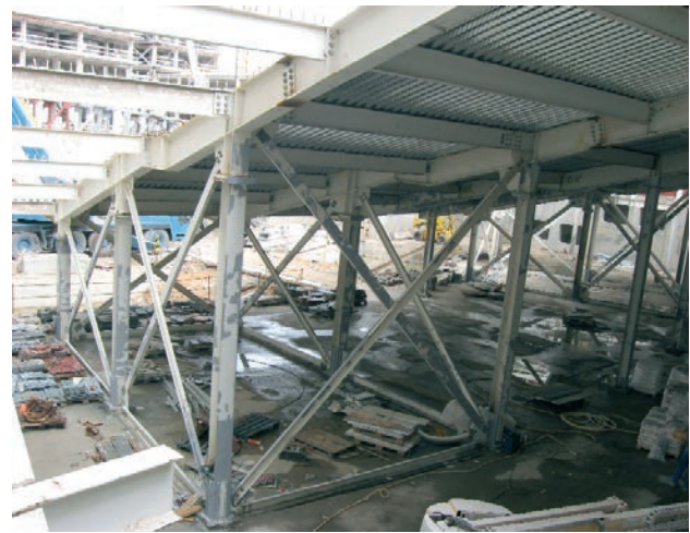
Figura 34. Vista de los arriostramientos durante la ejecución
