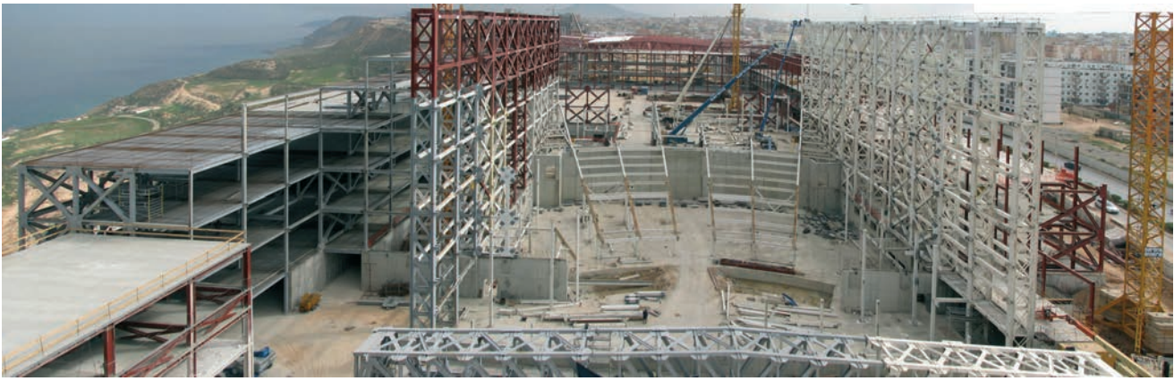
Figura 13. Vista de la caja central del auditorio durante la construcción
