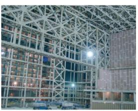
Figura 16. Vista del pórtico de arriostramiento del eje 26 sobre el escenario del auditorio
