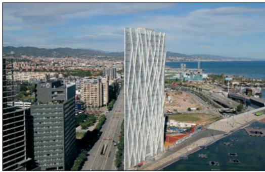
Foto de portada: Torre Diagonal ZeroZero, Barcelona
