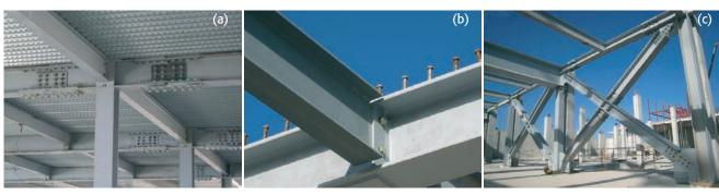
Figura 10. Detalle de uniones atornilladas en vigas principales (a), articulación de una correa en su extremo (b) y uniones atorniladas de arriostramientos sismicos (c)
