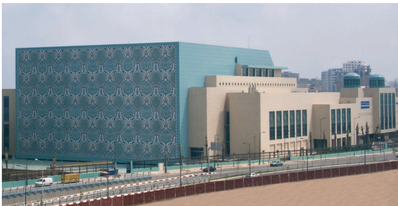
Figura 1. Vista del Palacio de Congresos de Orán concluido
