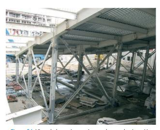
Figura 34. Vista de los arriostramientos durante la ejecución
