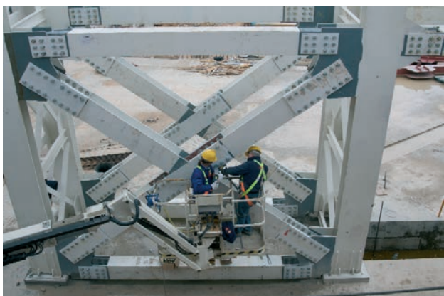
Figura 11. Imagen del apriete de una de las uniones atornilladas con T.A.R. pretensados mediante el empleo de arandelas D.T.I.
