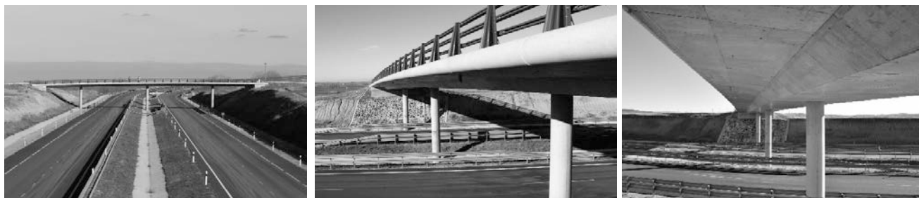
Figura 1. Puente integral monitorizado con tablero de hormigón postesado situado en la Provincia de Ávila, España
