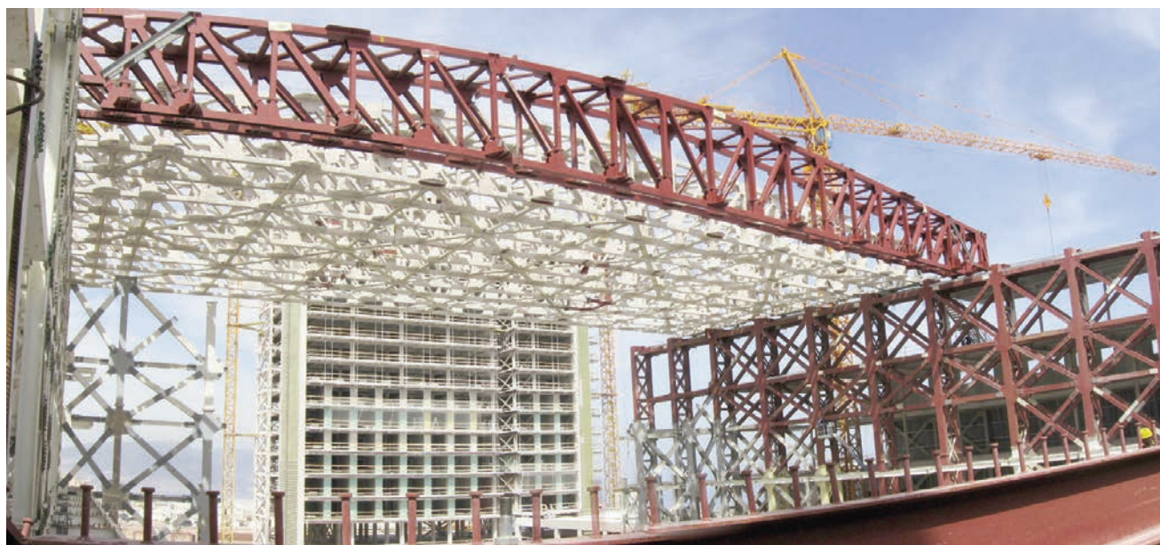
Figura 38. Vista de la cubierta durante la ejecución del ripado
