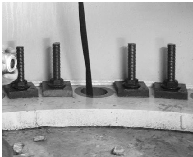
Figura 17. Torre de Hamina. Brida de conexión
