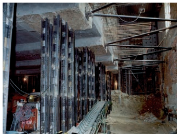
Figura 11. Refuerzo atornillado de micropilotes
