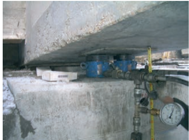
Figura 42. Gatos para la sustrucción de apoyos
