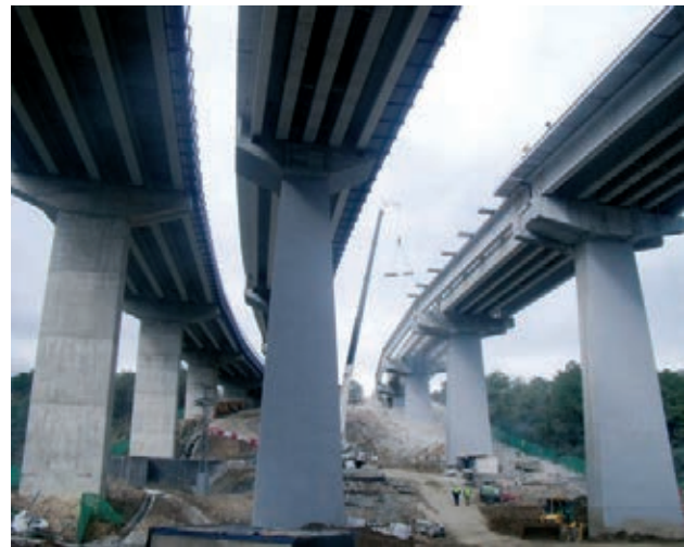
Figura 4. Viaductos de La Jarosa. De izquierda a derecha, calzada sentido Madrid, calzada reversible y calzada sentido La Coruña
