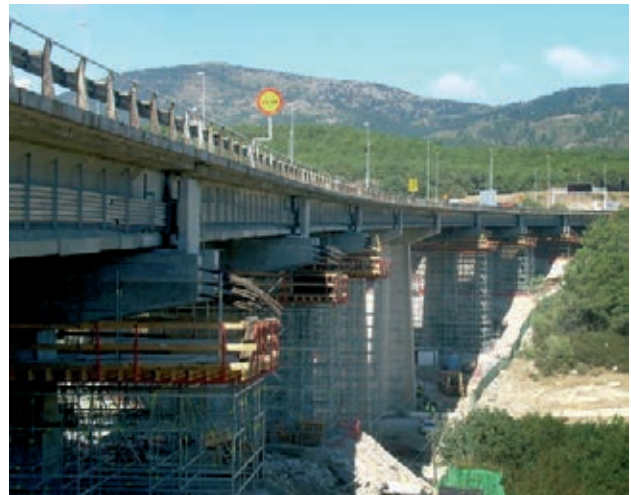
Figura 30. Vista general con las cimbras ya montadas
