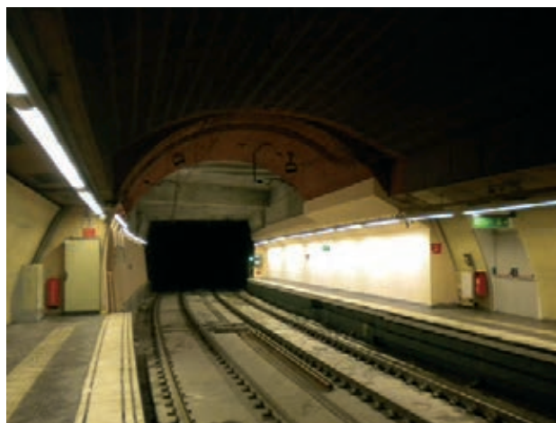
Figura 27. Aspecto de la obra terminada
