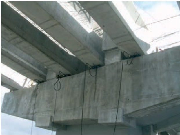
Figura 41. Sustrucción de apoyos existentes
