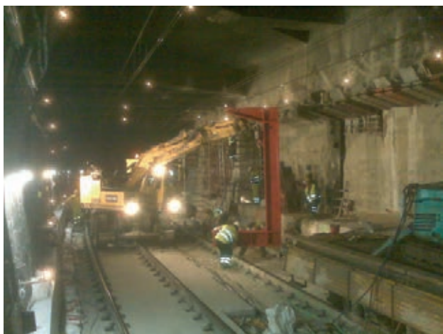
Figura 18. Colocación de la estructura metálica en C
