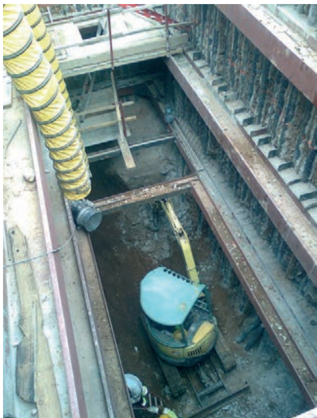
Figura 8. Excavación del pozo de ataque
