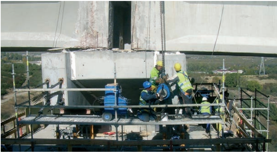
Figura 34. Pretensado de los nuevos dinteles
