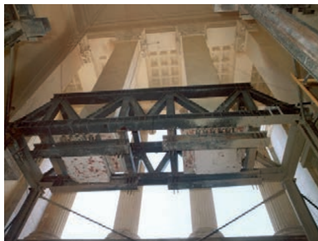
Figura 8. Recalce de la columnata interior de la fachada de Velázquez Bosco
