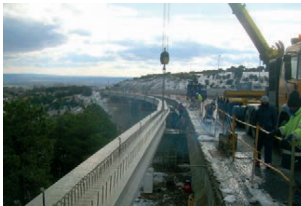
Figura 40. Colocación de vigas nuevas
