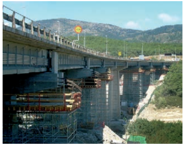
Figura 30. Vista general con las cimbras ya montadas
