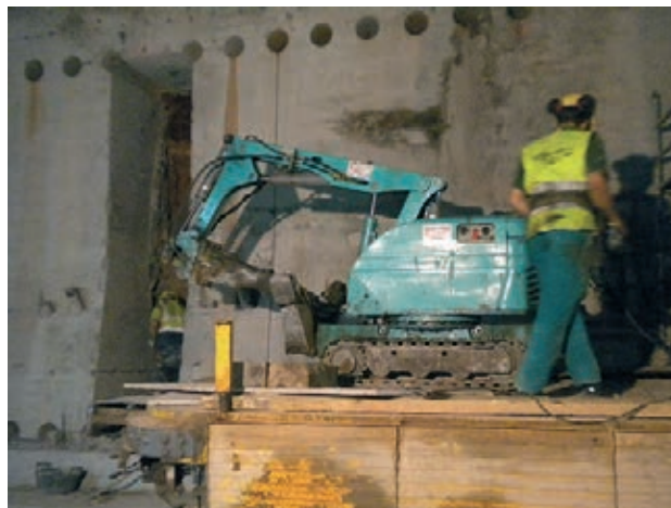
Figura 17. Demolición del hastial. Se aprecian las perforaciones y cortes verticales y horizontales
