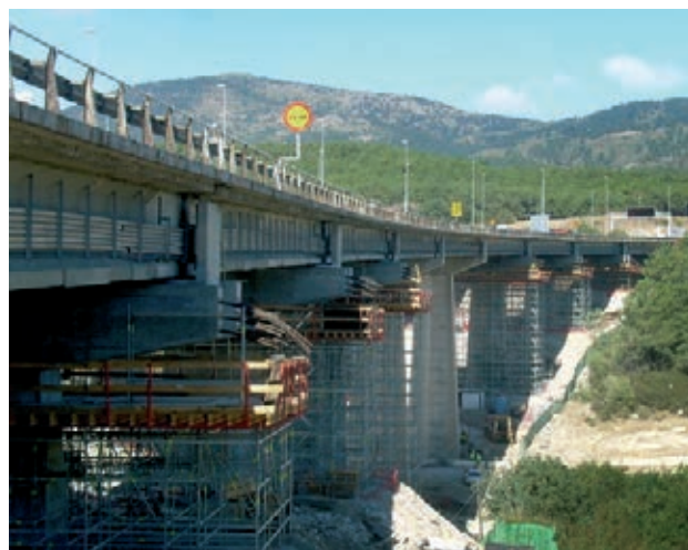
Figura 30. Vista general con las cimbras ya montadas
