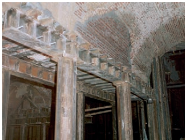
Figura 7. Muros sobre emparrillados metálicos
