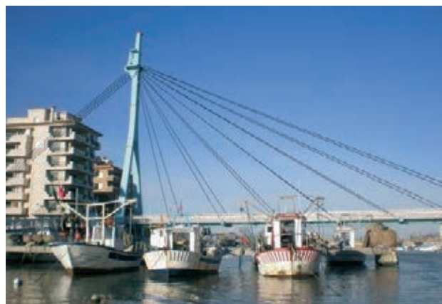
Figura 1. Vista general de la pasarela
