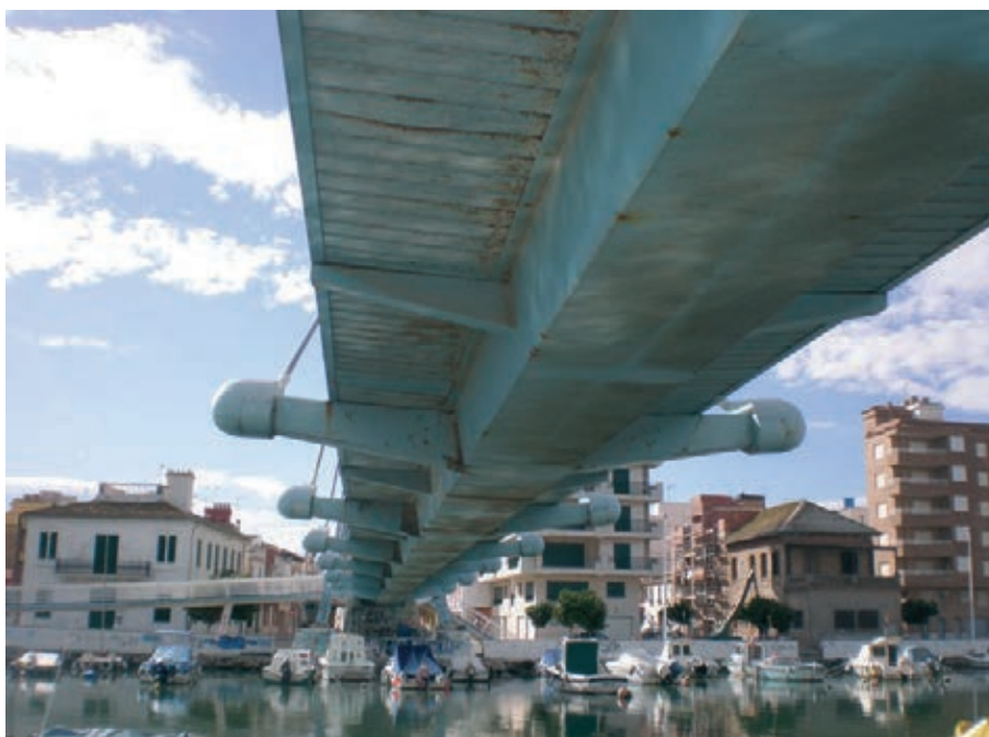
Figura 4. Aspecto en 2010 del tablero
