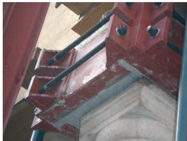
Figura 4. Planta de las columnas numeradas (el norte está en la parte superior) y vista del cimacio 5 una vez zunchado
