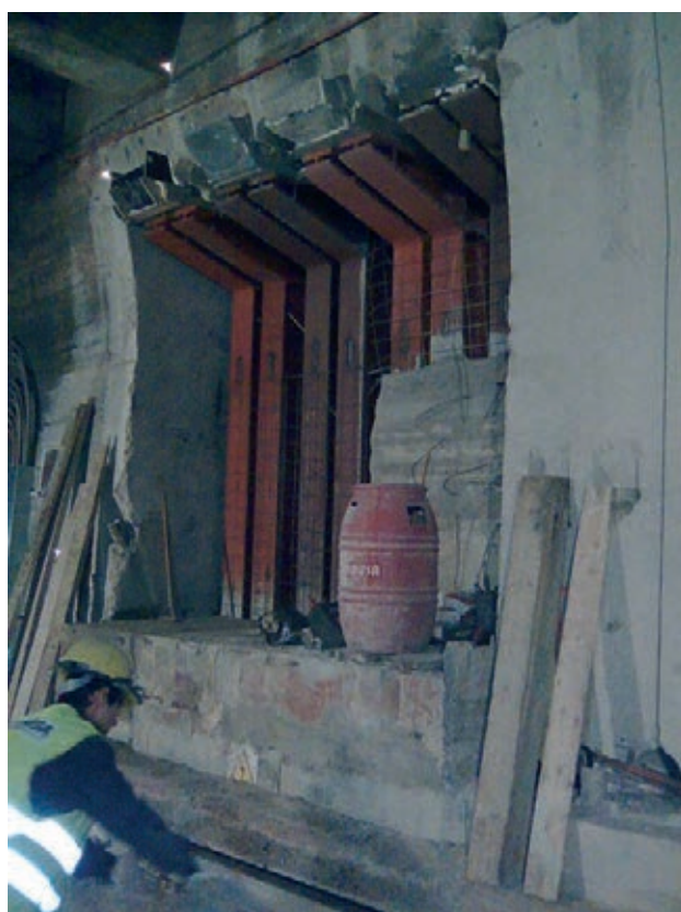
Figura 19. Hormigonado del hastial
