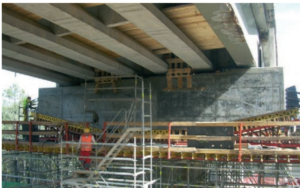
Figura 33. Hormigonado de dinteles y vigas de cuelgue
