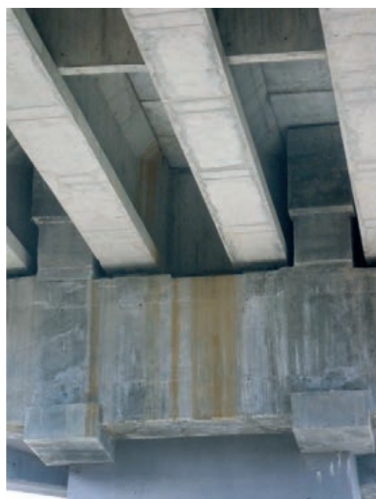
Figura 48. Vista de las vigas de cuelgue (entre las vigas del tablero) y la parte central del dintel nuevo. Se aprecian los regruessamientos correspondientes a los anclajes del pretensado
