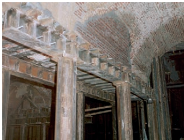
Figura 7. Muros sobre emparrillados metálicos
