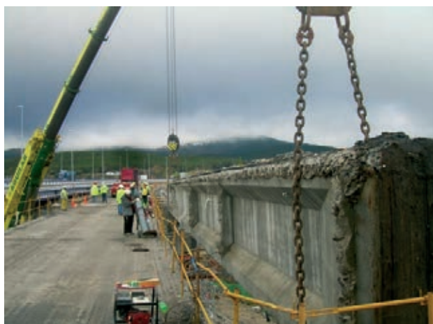
Figura 39. Retirada de vigas dañadas
