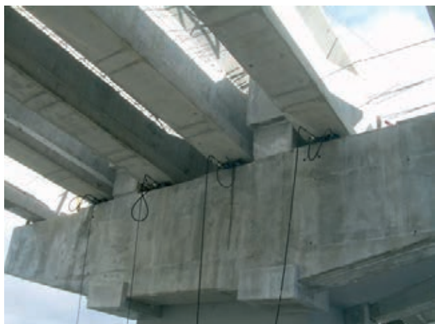
Figura 41. Sustitución de apoyos existentes
