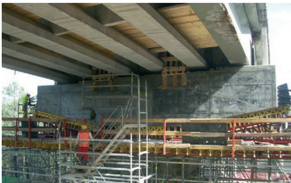
Figura 33. Hormigonado de dinteles y vigas de cuelgue
