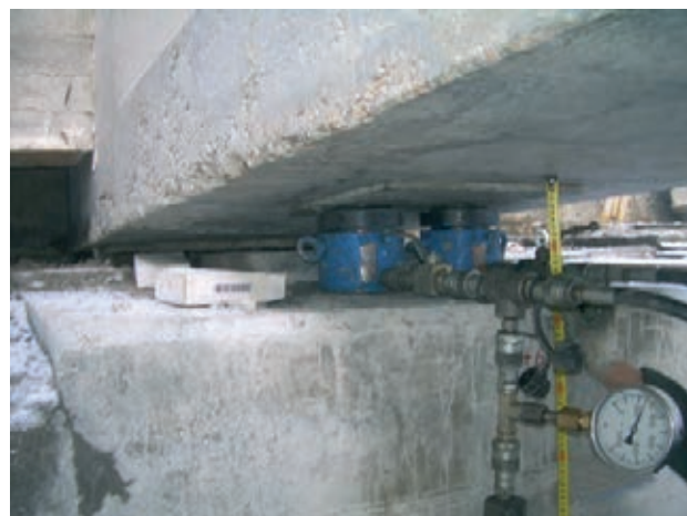
Figura 42. Gatos para la sustitución de apoyos
