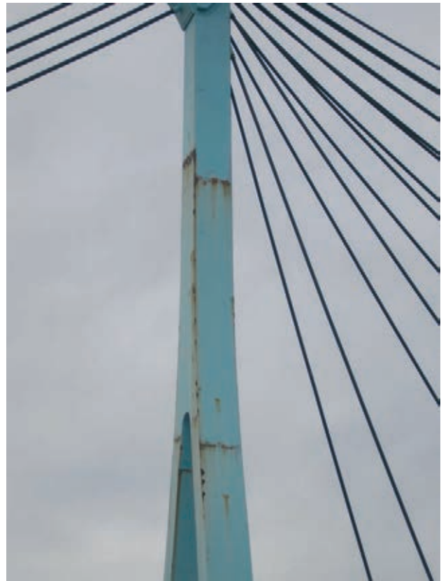
Figura 3. Aspecto en 2010 del pilono
