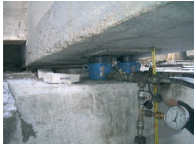
Figura 42. Gatos para la sustrucción de apoyos
