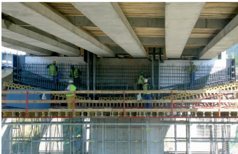
Figura 32. Ferrallado de nuevos dinteles
