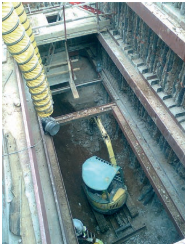
Figura 8. Excavación del pozo de ataque
