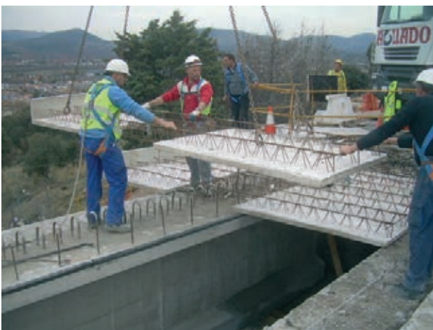
Figura 43. Colocación de prelosas: vista desde tablero
