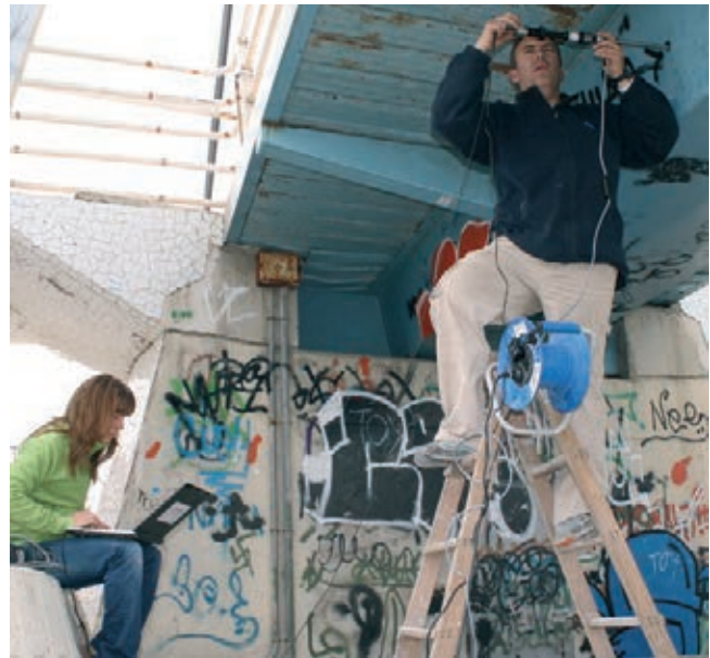
Figura 6. Introducción del boroscopio en el interior del tablero
