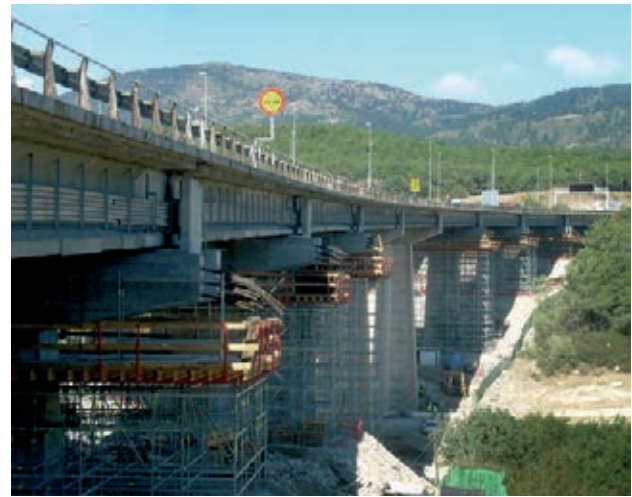
Figura 30. Vista general con las cimbras ya montadas
