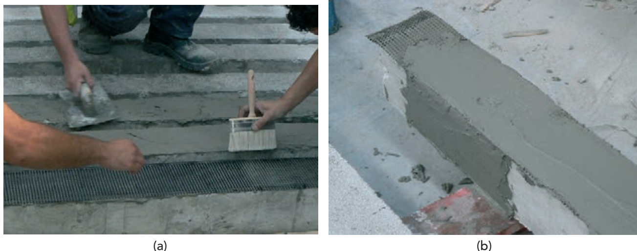
Figura 6. Aplicación de tejido de carbono como refuerzo interno del TRM y detalle de anclaje en forma de U
