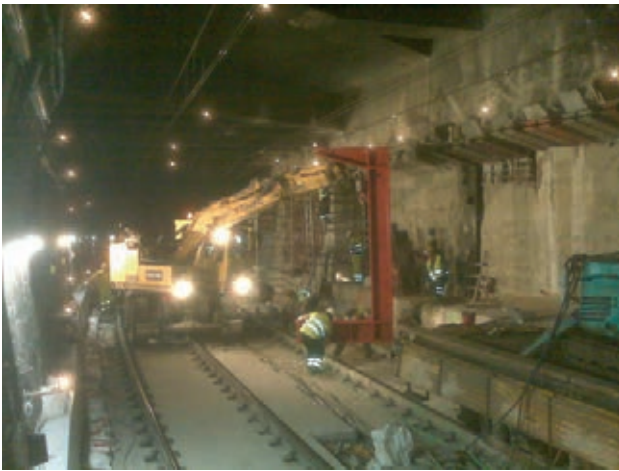
Figura 18. Colocación de la estructura metálica en C
