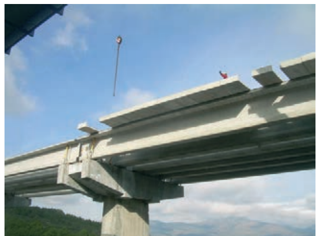
Figura 44. Colocación de prelosas: vista desde abajo
