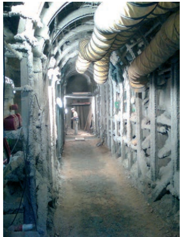
Figura 12. Vista de la galería antes de realizar la destroza
