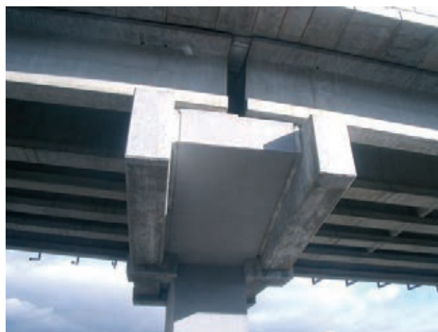
Figura 47. Vista lateral donde se aprecian los porexpanes de separación entre dintel antiguo y dinteles nuevos
