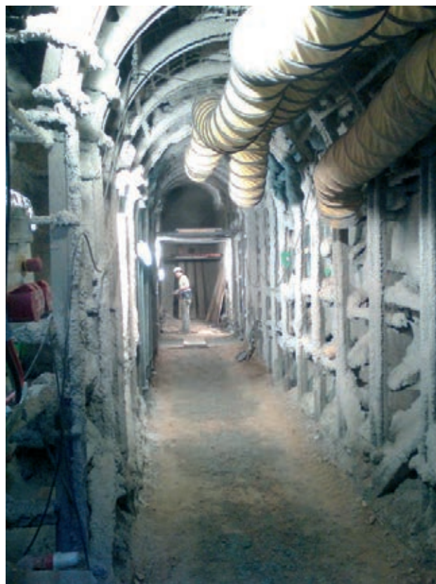
Figura 12. Vista de la galería antes de realizar la destroza
