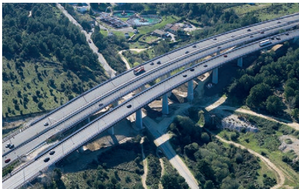
Figura 50. Vista aérea de los tres viaductos tras la actuación
