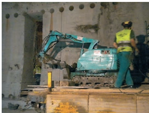
Figura 17. Demolición del hastial. Se aprecian las perforaciones y cortes verticales y horizontales
