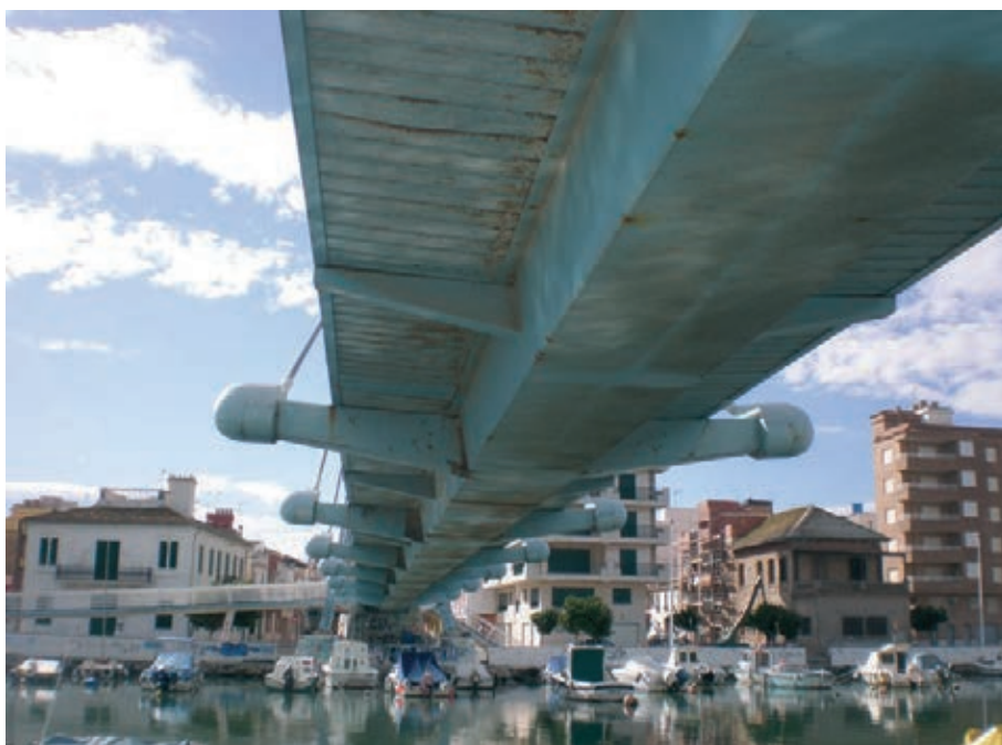
Figura 4. Aspecto en 2010 del tablero
