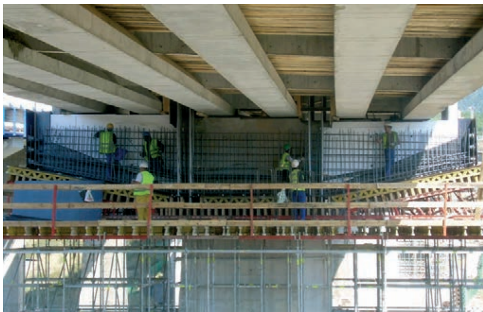
Figura 32. Ferrallado de nuevos dinteles
