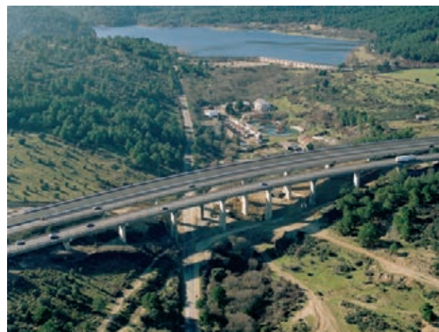
Figura 3. Viaductos de La Jarosa (3 calzadas separadas) antes de la intervención. De abajo a arriba: calzada sentido La Coruña, calzada reversible y calzada sentido Madrid
