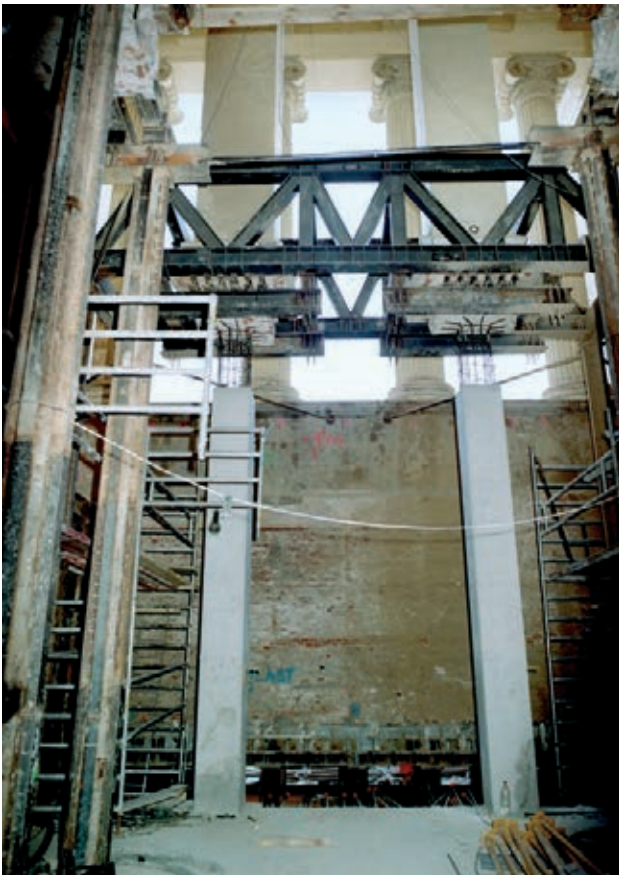
Figura 15. Estructura de recalde y definitiva. Columnata interior de la fachada de Velázquez Bosco
