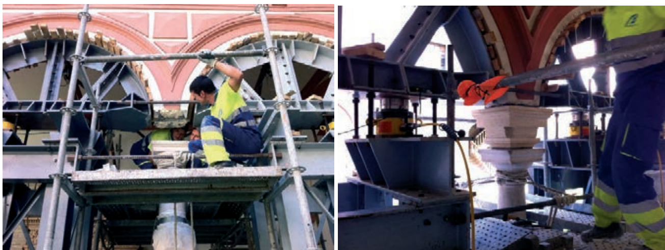
Figura 9. Momento en que se ha retirado el cimacio 19. A la derecha la pieza nueva en posición y aplomada.
