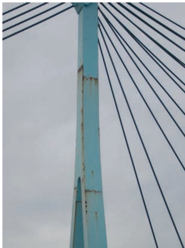
Figura 3. Aspecto en 2010 del pilono
