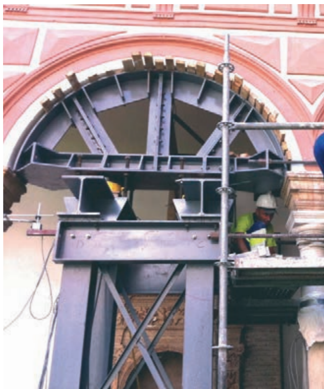
Figura 8. Detalle del doble apoyo con reparto y sobre neumáticos y detalle de las uniones atornilladas de la parte superior. También se aprecia parte de la instrumentación y la falta de acuíñado en el sector exterior.
