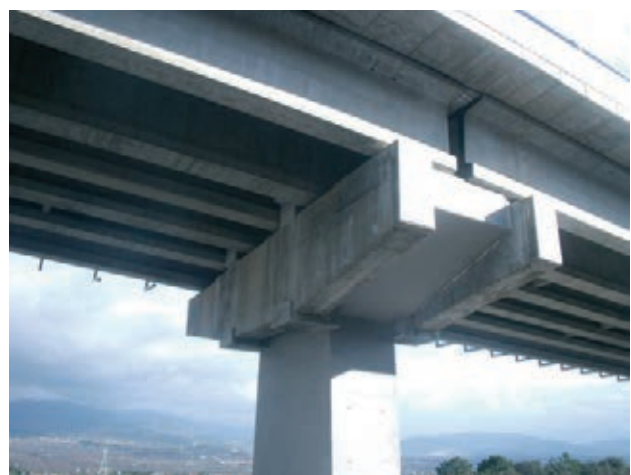
Figura 45. Dintel rehabilitado y ampliado, en servicio
