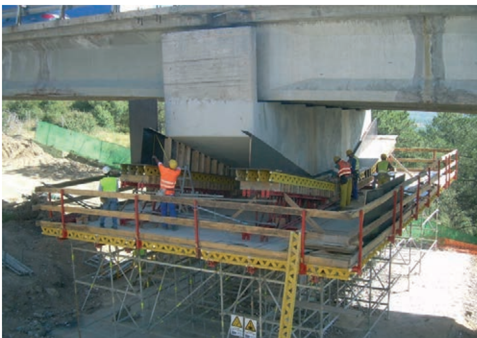
Figura 31. Encofrado de nuevos dinteles
