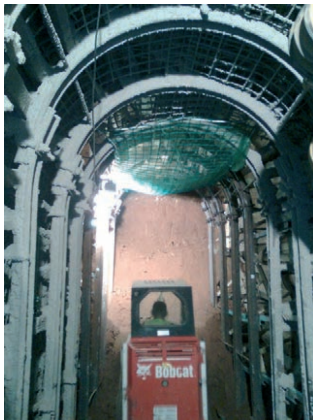
Figura 11. Ejecución de la galería
