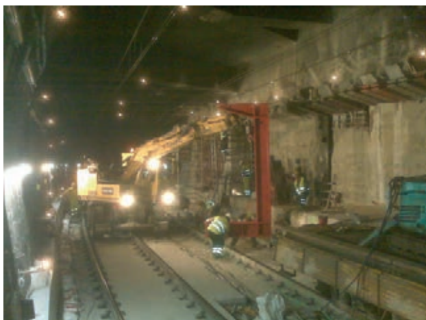
Figura 18. Colocación de la estructura metálica en C
