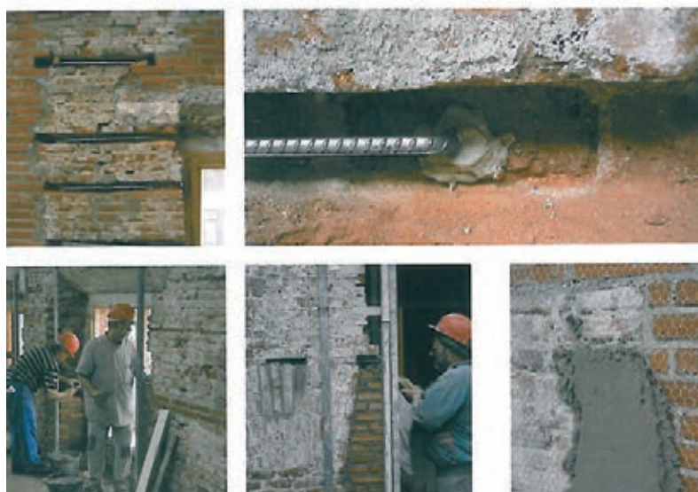
Figura 4. Consolidación de muros
