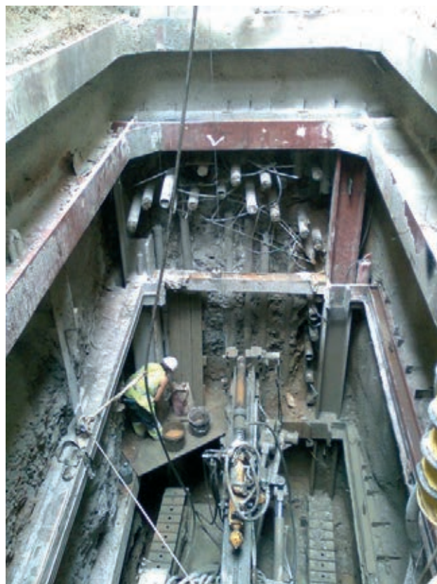
Figura 10. Ejecución del paraguas de micropilotes
