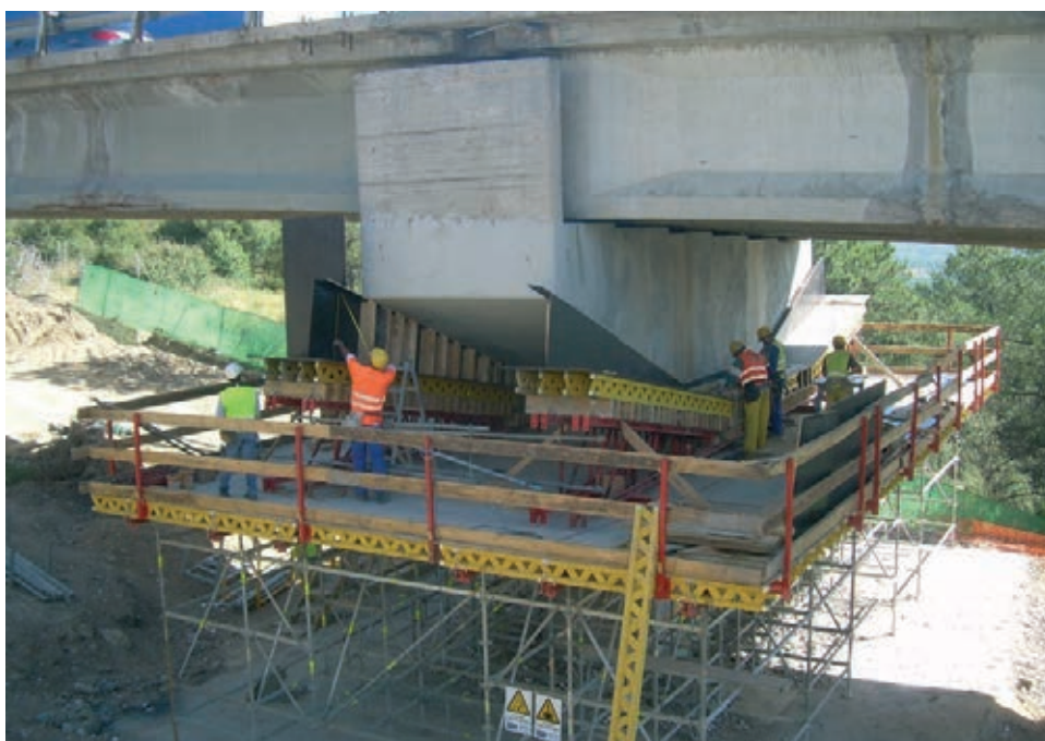
Figura 31. Encofrado de nuevos dinteles
