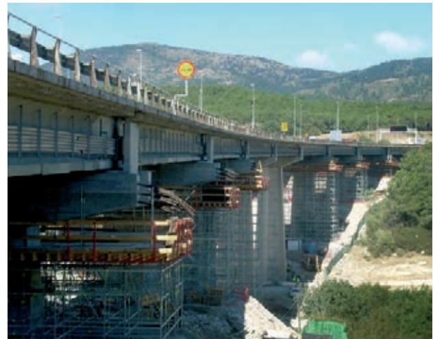
Figura 30. Vista general con las cimbras ya montadas
