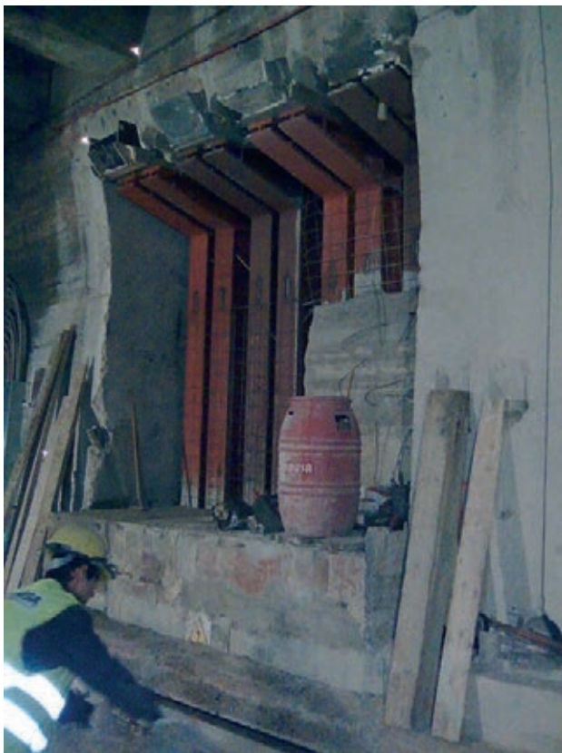
Figura 19. Hormigonado del hastial
