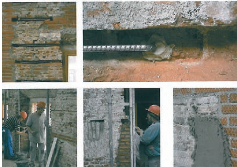
Figura 4. Consolidación de muros
