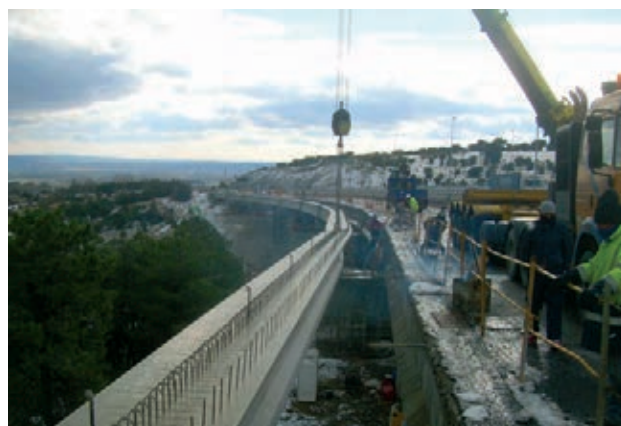
Figura 40. Colocación de vigas nuevas
