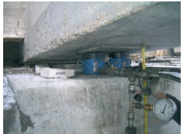
Figura 42. Gatos para la sustrucción de apoyos
