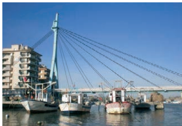
Figura 1. Vista general de la pasarela
