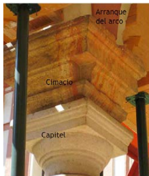
Figura 2. Principales dimensiones del alzado de la arquería y detalle del arranque de los arcos
