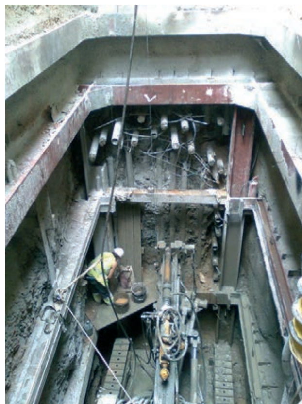
Figura 10. Ejecución del paraguas de micropilotes
