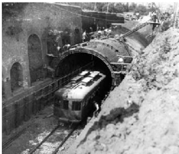
Figura 1. Obras originales de la cobertura de la línea entre 1920 y 1930 (Fuente: FGC)
