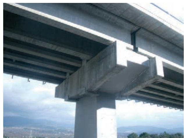
Figura 45. Dintel rehabilitado y ampliado, en servicio
