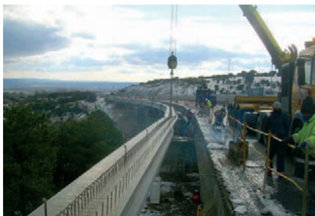
Figura 40. Colocación de vigas nuevas
