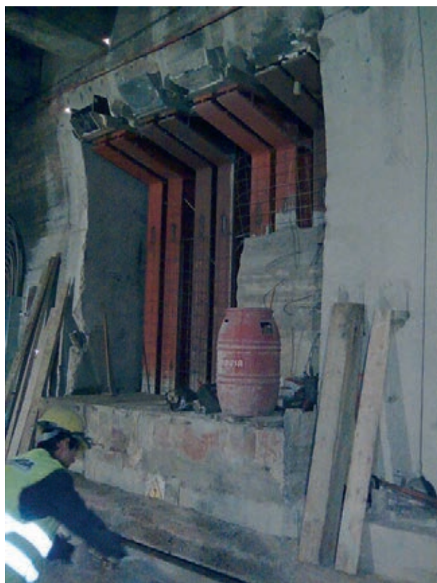
Figura 19. Hormigonado del hastial
