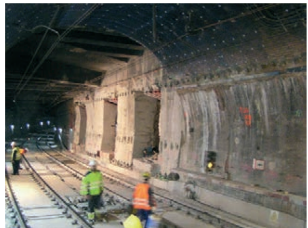
Figura 20. Ejecución de los bataches en la ampliación del lado Sur
