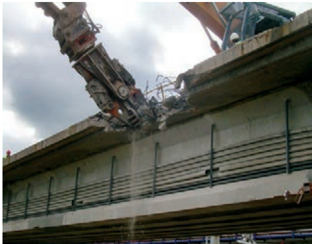
Figura 36. Demolición de losa existente: aceras y voladizos
