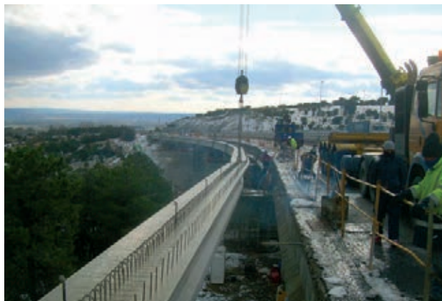
Figura 40. Colocación de vigas nuevas
