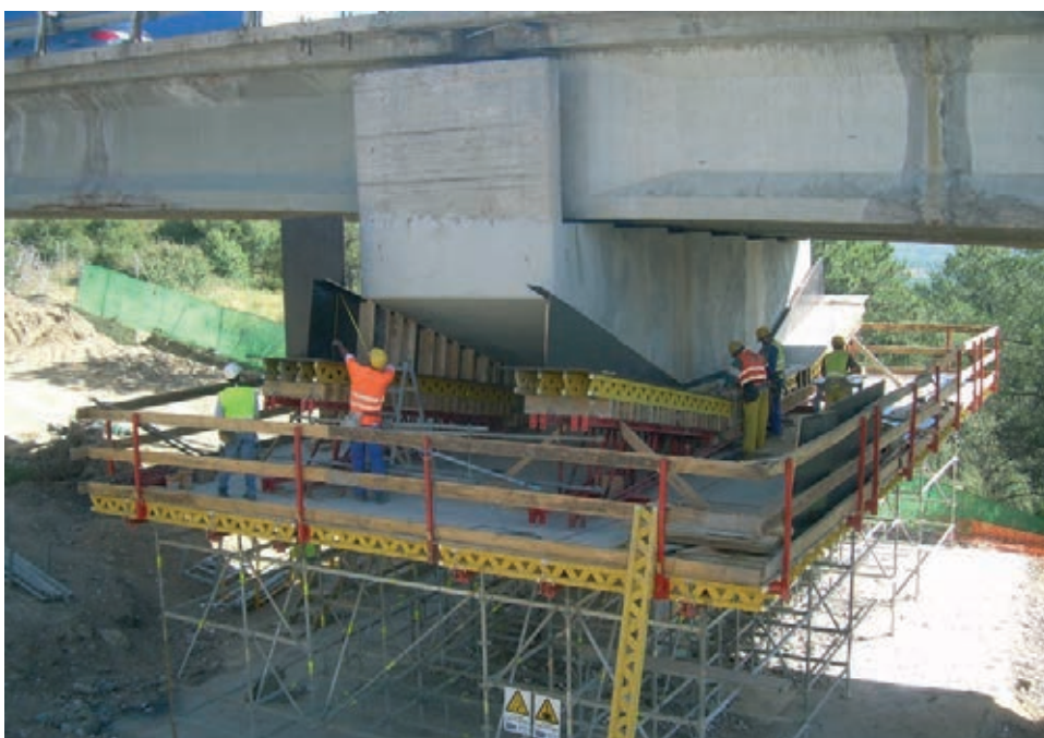
Figura 31. Encofrado de nuevos dinteles
