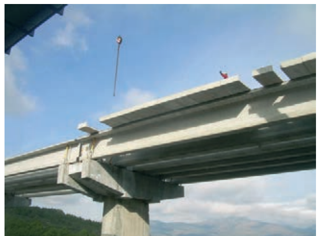
Figura 44. Colocación de prelasas: vista desde abajo
