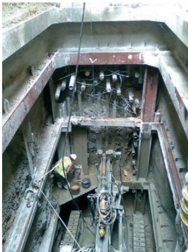
Figura 10. Ejecución del paraguas de micropilotes
