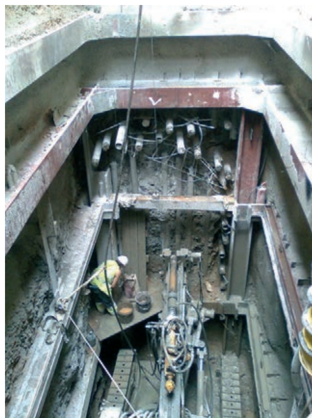
Figura 10. Ejecución del paraguas de micropilotes
