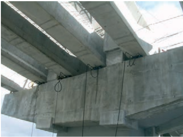
Figura 41. Sustrucción de apoyos existentes
