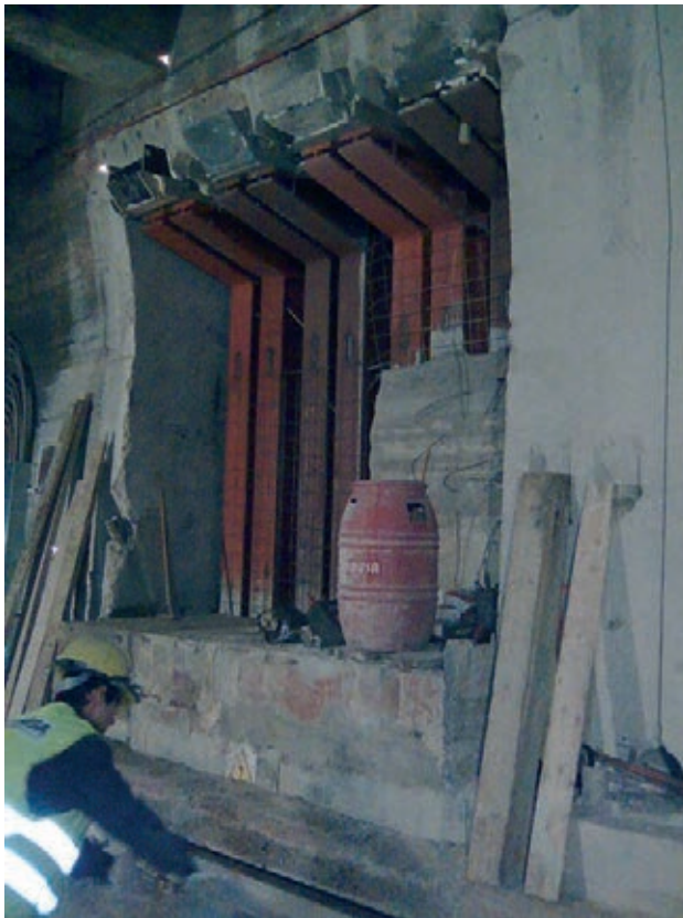
Figura 19. Hormigonado del hastial
