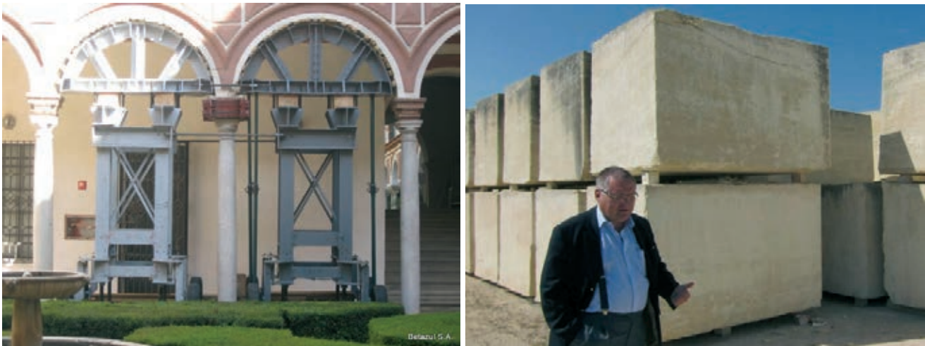
Figura 5. Cimbra móvil instalada y zunchado del cimacio fracturado. A la derecha visita a las canteras para la selección del material
