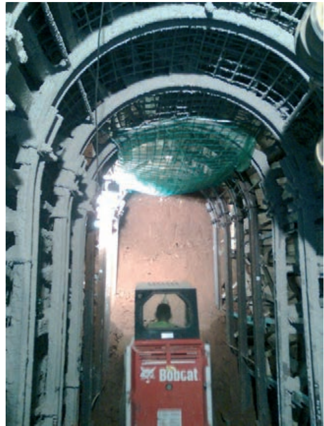
Figura 11. Ejecución de la galería
