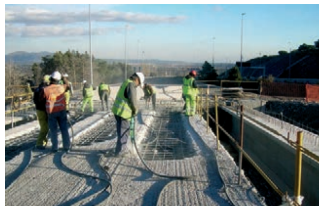
Figura 37. Demolición de losa existente: zona central
