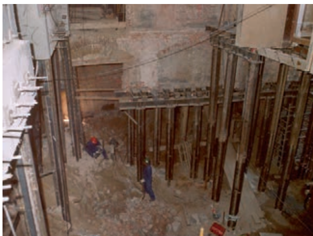
Figura 12. Recalce a distintos niveles, excavación y refuerzo de micropilotes
