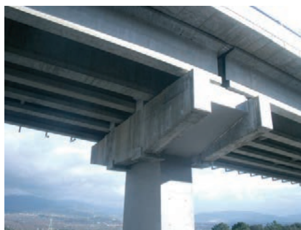
Figura 45. Dintel rehabilitado y ampliado, en servicio
