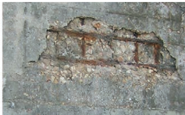
Figura 8. Viaducto de La Jarosa. Daños en armaduras por corrosión (sales fundentes)
