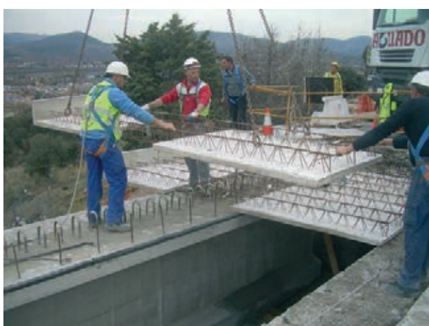
Figura 43. Colocación de prelosas: vista desde tablero
