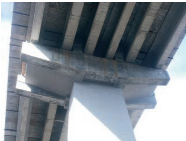
Figura 46. Vista inferior del dintel
