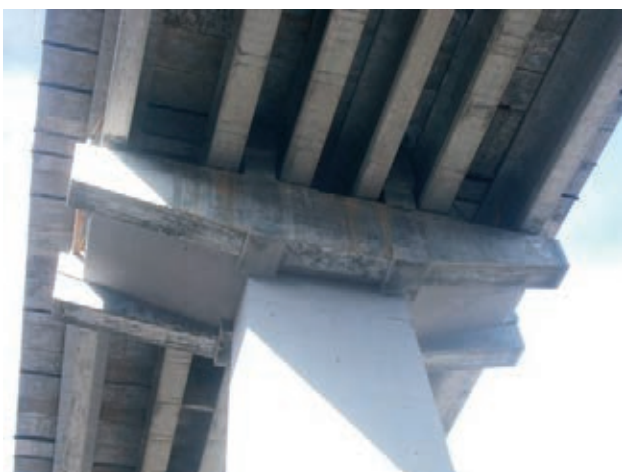
Figura 46. Vista inferior del dintel
