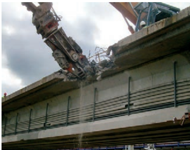
Figura 36. Demolición de losa existente: aceras y voladizos
