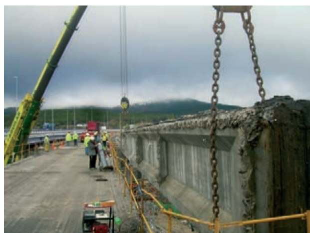
Figura 39. Retirada de vigas dañadas
