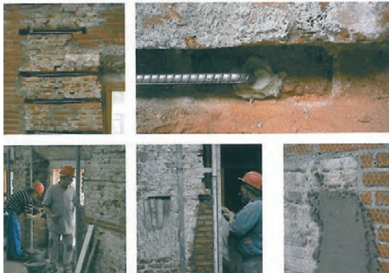
Figura 4. Consolidación de muros
