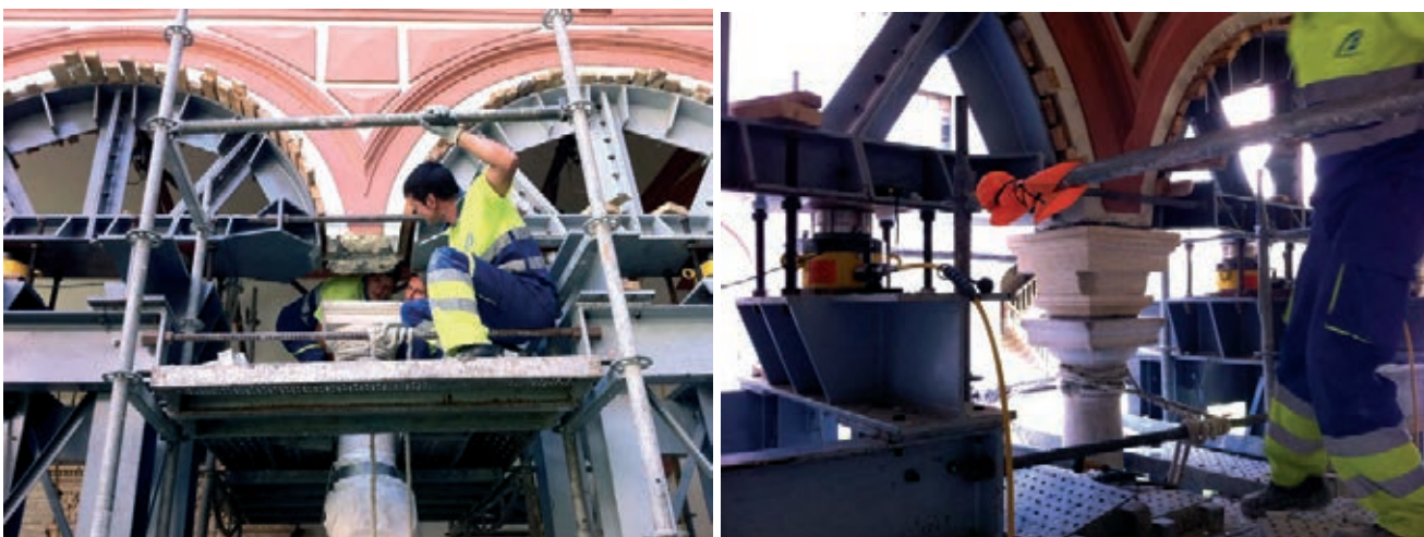
Figura 9. Momento en que se ha retirado el cimacio 19. A la derecha la pieza nueva en posición y aplomada.
