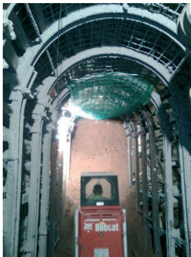
Figura 11. Ejecución de la galería
