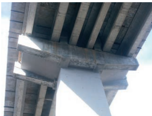
Figura 46. Vista inferior del dintel
