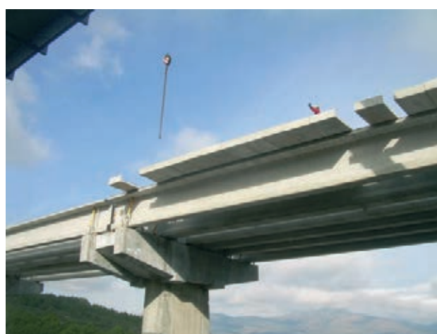
Figura 44. Colocación de prelosas: vista desde abajo
