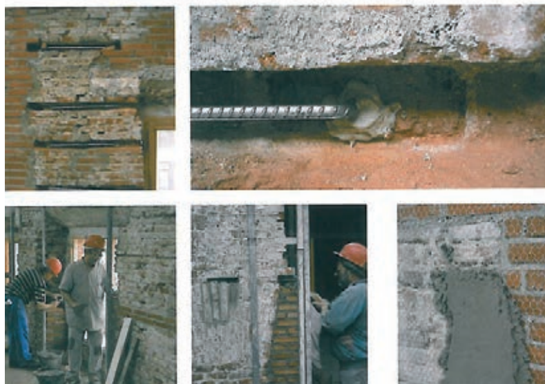
Figura 4. Consolidación de muros
