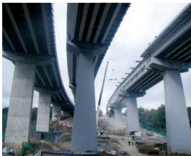
Figura 4. Viaductos de La Jarosa. De izquierda a derecha, calzada sentido Madrid, calzada reversible y calzada sentido La Coruña
