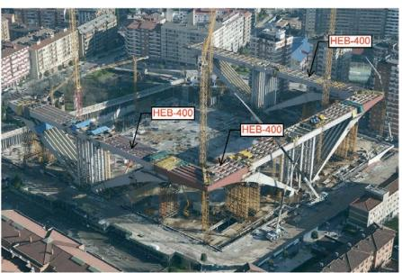
Figura 12. Vista aérea de los pórticos principales de los tres edificios con los arriostramientos mediante HEB-400 parcialmente ejecutados
