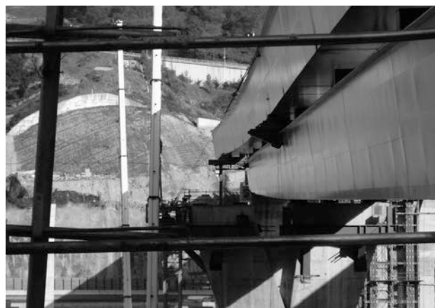
Figura 27C. Ripado, fase intermedia
