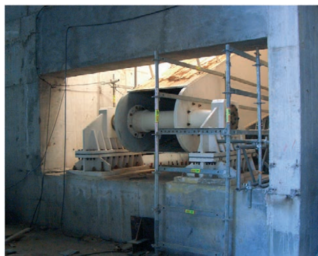
Figura 28. Cojinete principal ya instalado en el foso de mecanismos Figure 28. Main bearing already installed
