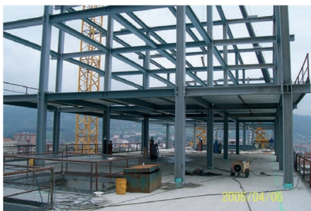
Figura 14. Entramado metálico de los edificios. Pórticos transversales unidos mediante vigas isostáticas
