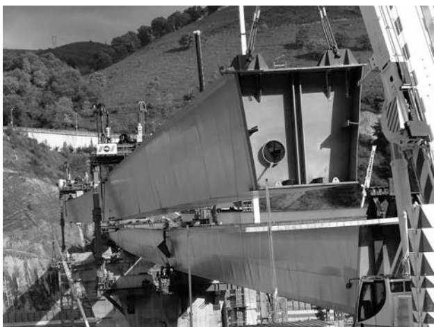
Figura 34A. Izado del viaducto V4 desde 3 puntos
