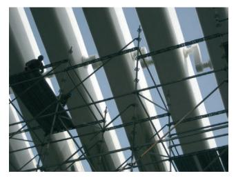
Figura 24. Barras de arriostramiento transversal de las costillas móviles durante su montaje
