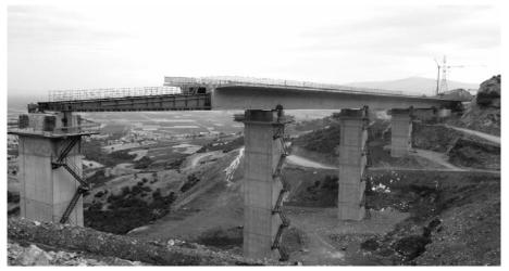
Figura 9. Empuje de la estructura SG25
