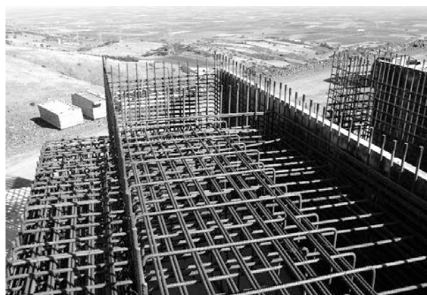
Figura 4. Ferralla del estribo A2 de la estructura SG25, con manguitos para conexión entre fases
