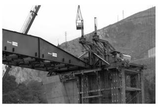
Figura 19. Recuperación de flecha con pórticos auxiliares
