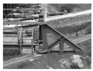
Figura 14. Detalle de la puertas ubicadas en la nariz de lanzamiento
