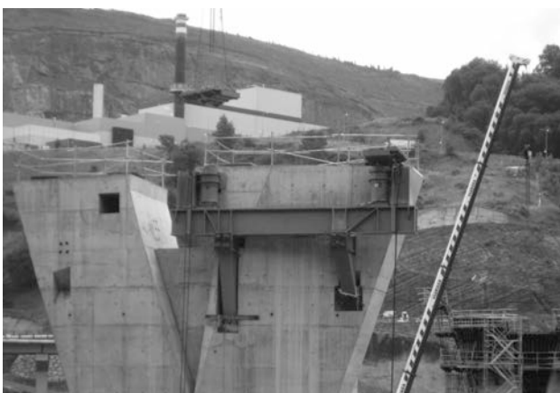
Figuras 11A y 11B. Detalle de ménsulas auxiliares para ubicación de gatos
