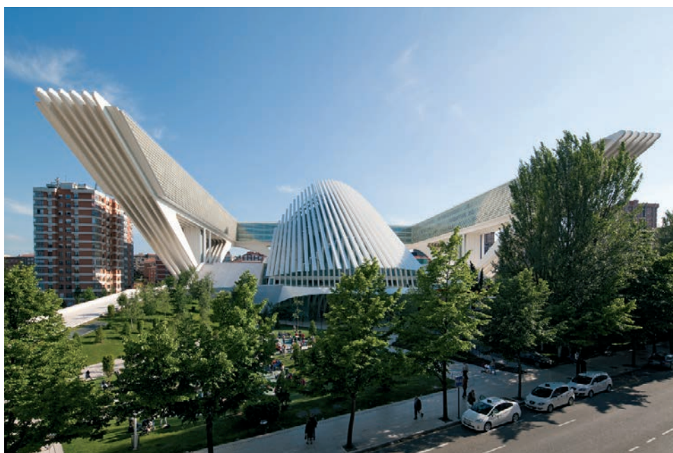
Figura 61. Conjunto de edificaciones Buenavista en la actualidad Figure 61. Buenavista Building Complex at present
