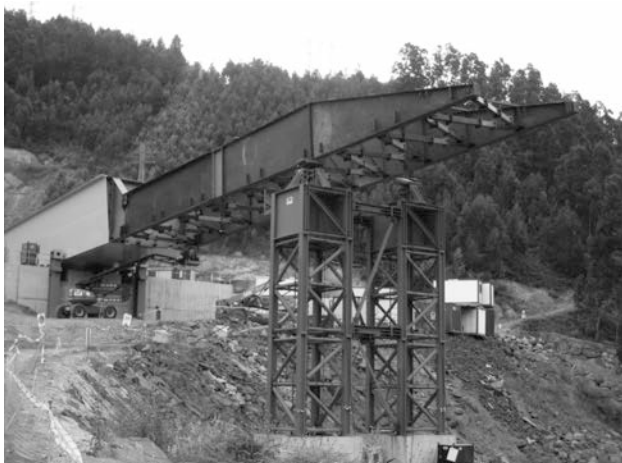
Figura 12. Montaje del primer tramo, nariz de lanzamiento sobre pilas auxiliares
