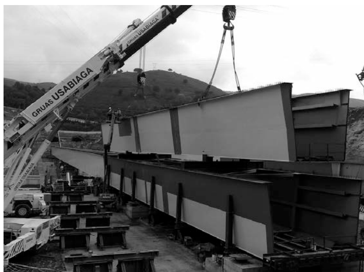
Figuras 21A y 21B. Colocación del viaducto V4 por encima del viaducto V1
