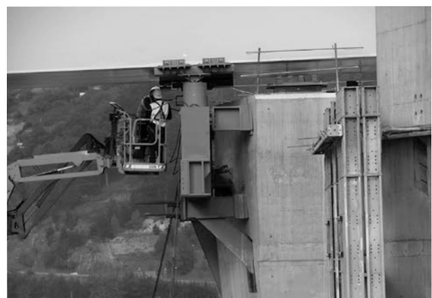
Figuras 11A y 11B. Detalle de ménsulas auxiliares para ubicación de gatos
