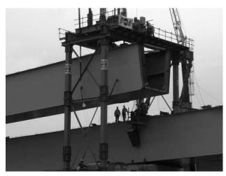
Figura 31B. Pórtico de izado (Vista 2)
