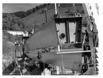
Figura 34A. Izado del viaducto V4 desde 3 puntos
