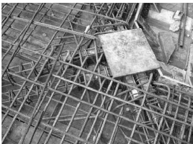
Figura 4. Fotos en obra del detalle de crucetas metálicas recortadas. Cortesía de MC2 Estudio de Ingeniería SL
