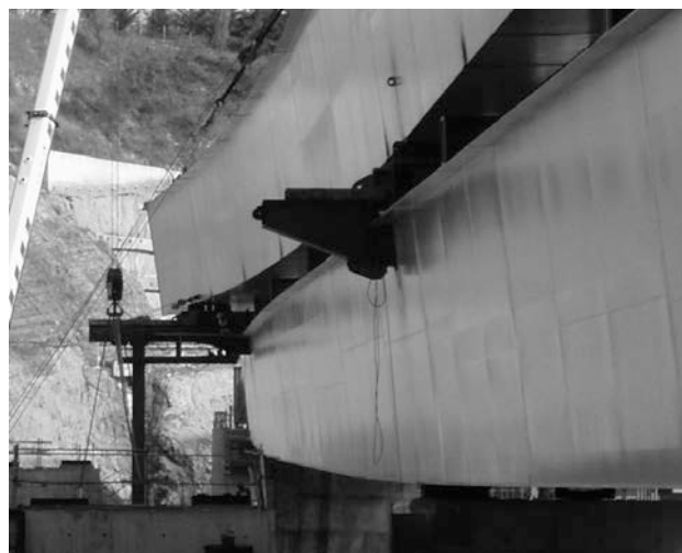
Figura 23. Ménsula y puntal para completar el ripado
