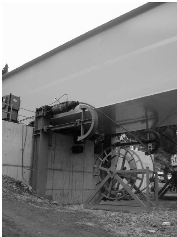
Figura 15. Sistema convencional de tiro en estribo E.1-1
