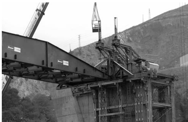
Figura 19. Recuperación de flecha con pórticos auxiliares
