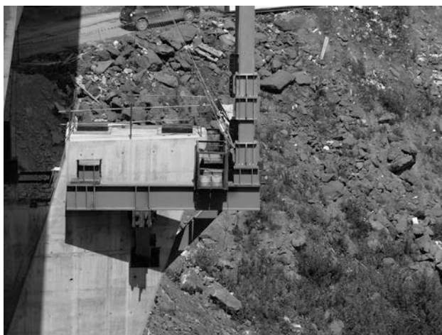
Figura 32. Ménsula de apoyo de la pata larga del pórtico
