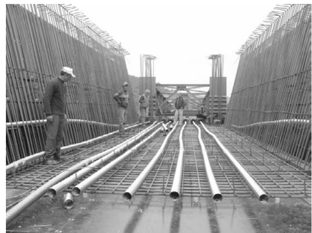
Figura 2. Vainas pretensado primer tramo
