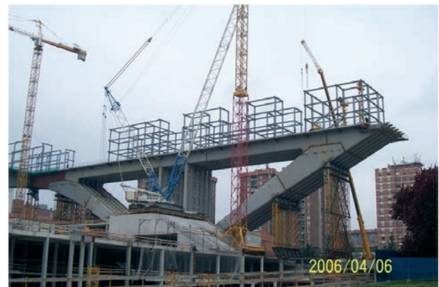
Figura 15. Vista general de la estructura de una de las consejerías con los pórticos principales finalizados y el entramado metálico superior en ejecución Figure 15. General view of one of the office buildings with the main portals already finished and the upper frames still in construction
