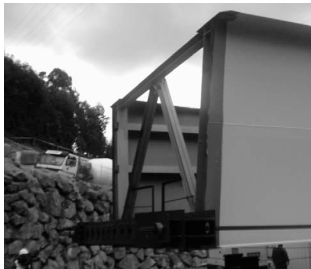
Figura 13. Detalle de la viga de tiro trasera
