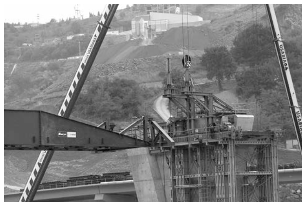
Figura 10. Torres para ubicación de gatos hidráulicos
