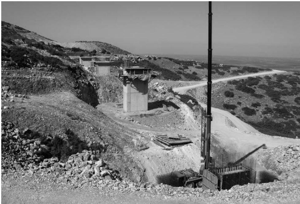
Figura 10. Pilas de la estructura SG27 en construcción
