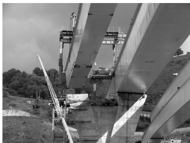
Figura 34B. Traslación del viaducto
