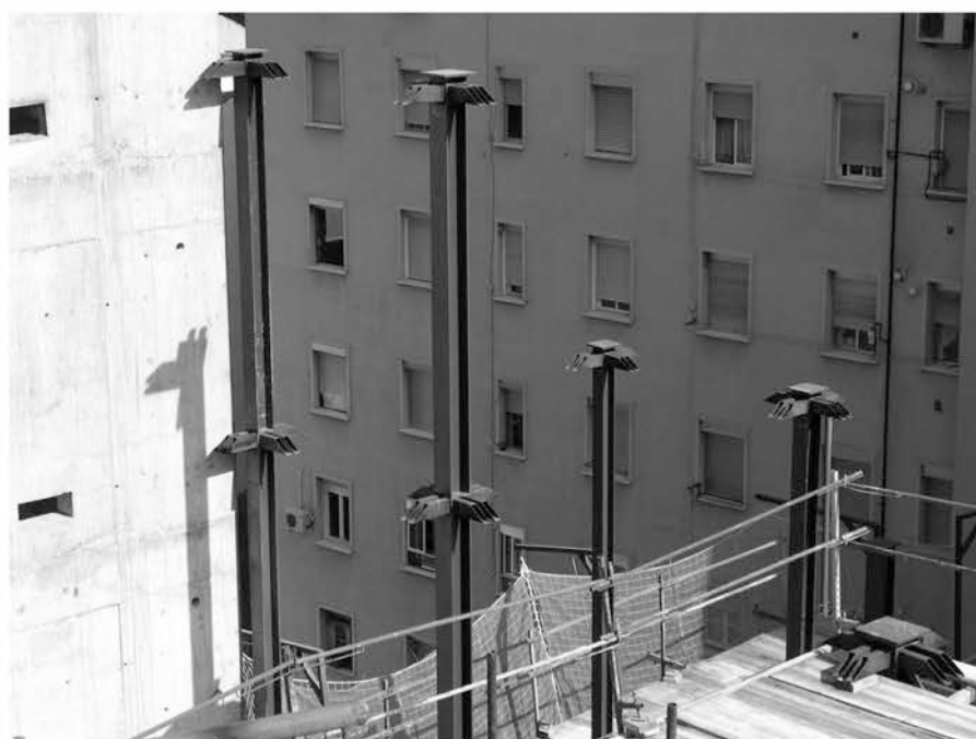
Figura 12. Esquema de protopropuesta de protocolo de ejecución en obra para el aplomado de soportes de tres o más plantas
