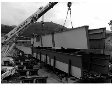
Figuras 21A y 21B. Colocación del viaducto V4 por encima del viaducto V1
