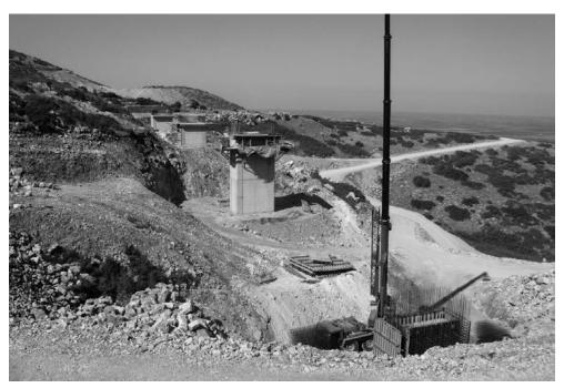
Figura 10. Pilas de la estructura SG27 en construcción
