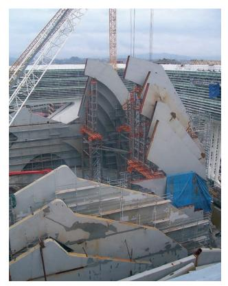
Figura 19. Montaje de las costillas fijas del P.E.C.
