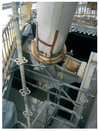
Figura 59. Conexión del extremo inferior del arco móvil a la palanca guiadora
