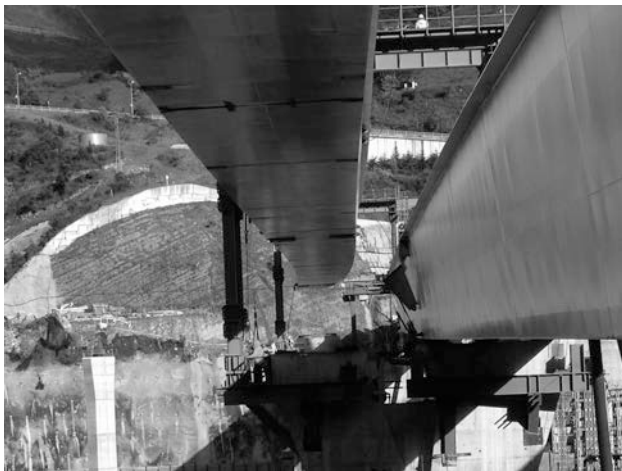
Figura 35A. Izado del viaducto V4 durante la translación vertical
