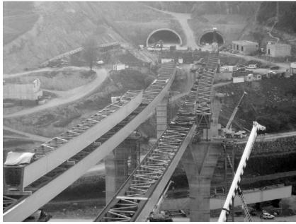
Figuras 29A y 29B. Posición relativa de los viaductos V1 y V4 antes y despues de realizar el ripado
