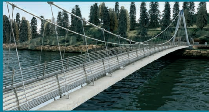
Pasarela colgada sobre el Esla en Sahechores (León), luz 75 m
