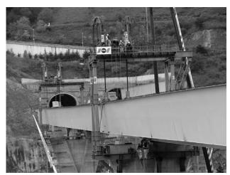
Figura 35B. Descenso del viaducto V4
