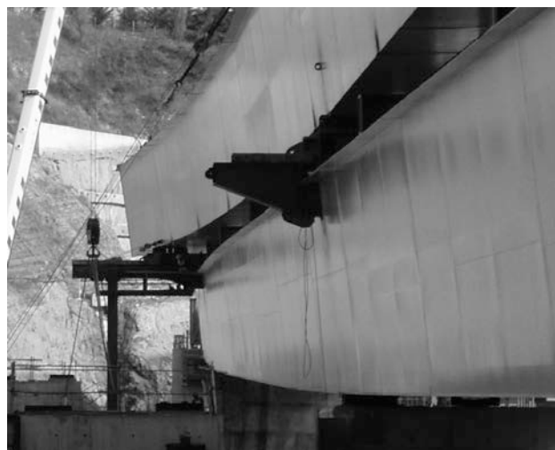
Figura 23. Ménsula y puntal para completar el ripado
