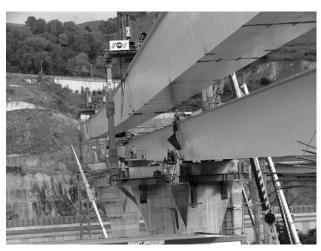
Figura 31A. Pórticos para izado (Vista 1)
