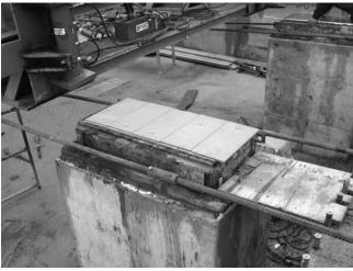
Figura 7. Estructura SG25. Gatos y teflones de lanzamiento en estribo
