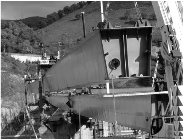
Figura 34A. Izado del viaducto V4 desde 3 puntos
