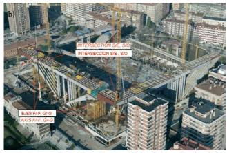
Figura 42. Situación de las torres de apeo: a) en los edificios de consejerías; b) en el edificio del hotel Figure 42. Location of the auxiliary structures: a) in the office buildings; b) in the hotel building in the office buildings
