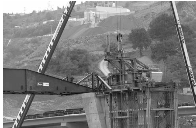
Figura 10. Torres para ubicación de gatos hidráulicos
