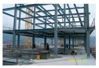
Figura 14. Entramado metálico de los edificios. Pórticos transversales unidos mediante vigas isostáticas
