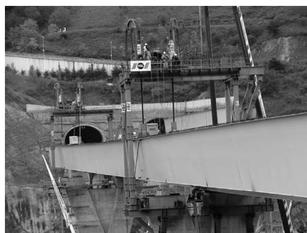
Figura 35B. Descenso del viaducto V4
