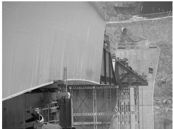
Figura 17. Lanzamiento viaducto V1 antes de llegar a la pila P.1-2
