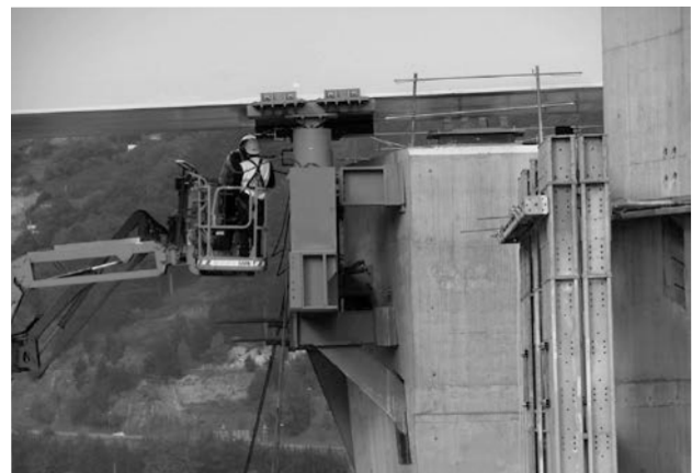
Figuras 11A y 11B. Detalle de ménsulas auxiliares para ubicación de gatos
