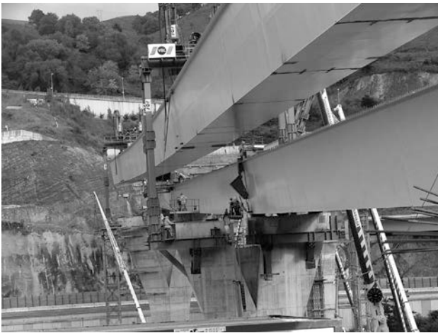
Figura 31A. Pórticos para izado (Vista 1)
