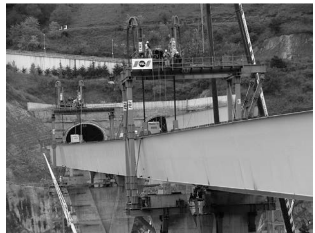
Figura 35B. Descenso del viaducto V4
