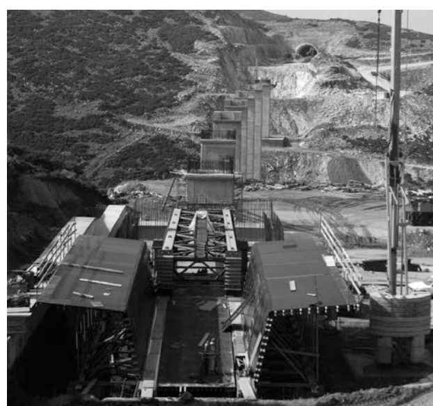
Figura 8. Estructura SG28 en construcción
