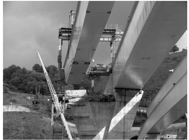
Figura 34B. Traslación del viaducto
