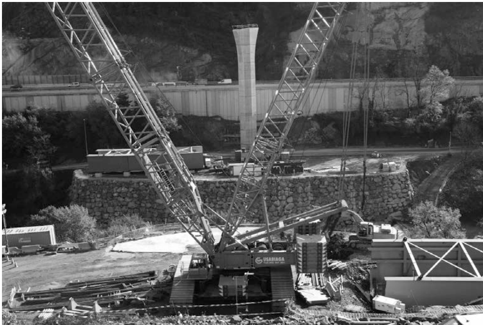
Figura 37. Vista en primer plano de la Plataforma 1 y la grúa de izado, al fondo la Plataforma 2
