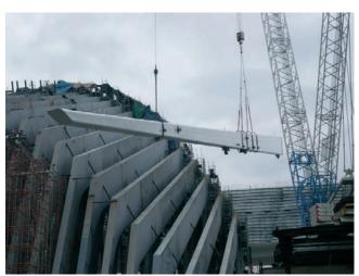
Figura 51. Izado del prearmado Norte (3+4+5) de la costilla móvil CM 1 Figure 51. Elevation of the North subset (3+4+5) of the moveable rib CM 1
