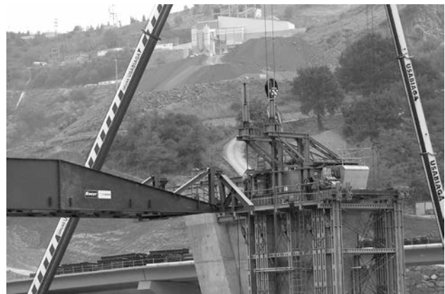
Figura 10. Torres para ubicación de gatos hidráulicos
