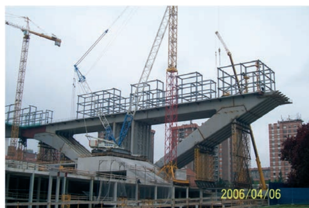
Figura 15. Vista general de la estructura de una de las consejerías con los pórticos principales finalizados y el entramado metálico superior en ejecución
