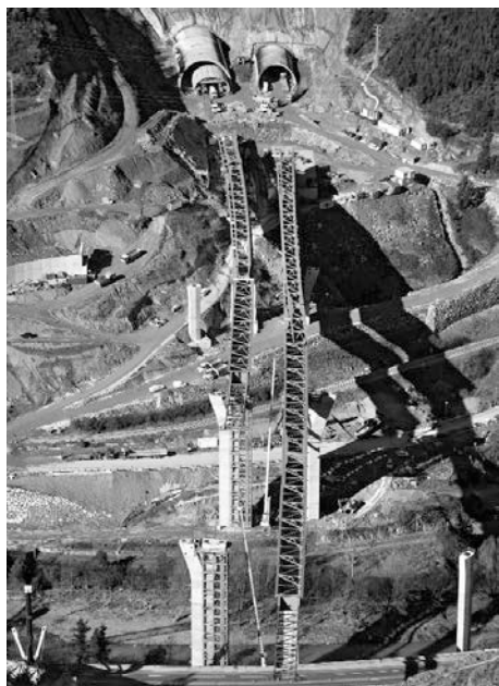
Figuras 29A y 29B. Posición relativa de los viaductos V1 y V4 antes y después de realizar el ripado
