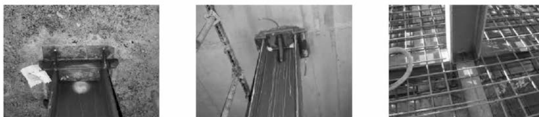
Figura 7. Detalle de punzonamiento mediante crucetas con base en ACI 318-99. Fotos cortesía de D. Rafael Fortézar. DRAGADOS.
