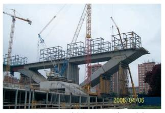
Figura 15. Vista general de la estructura de una de las consejerías con los pótticos principales finalizados y el entramado metálico superior en ejecución
