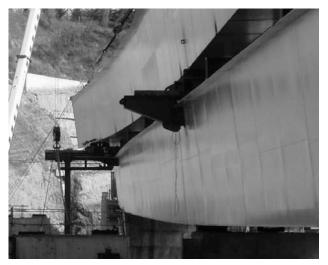
Figura 23. Ménsula y puntal para completar el ripado
