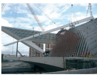
Figura 52. Prearmado Norte de la costilla móvil CM1 ya situado sobre los apoyos auxiliares de montaje Figure 52. North subset of the moveable rib CM 1 already mounted on the auxiliary supports
