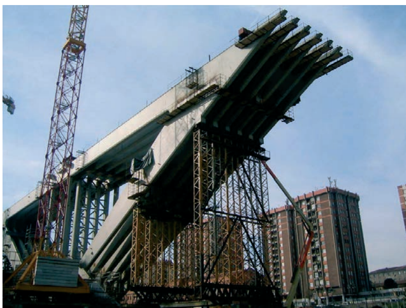
Figura 45. Apeos del edificio de la consejería este en los que se pueden ver las celosías inferiores a poyo
