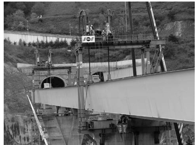
Figura 35B. Descenso del viaducto V4
