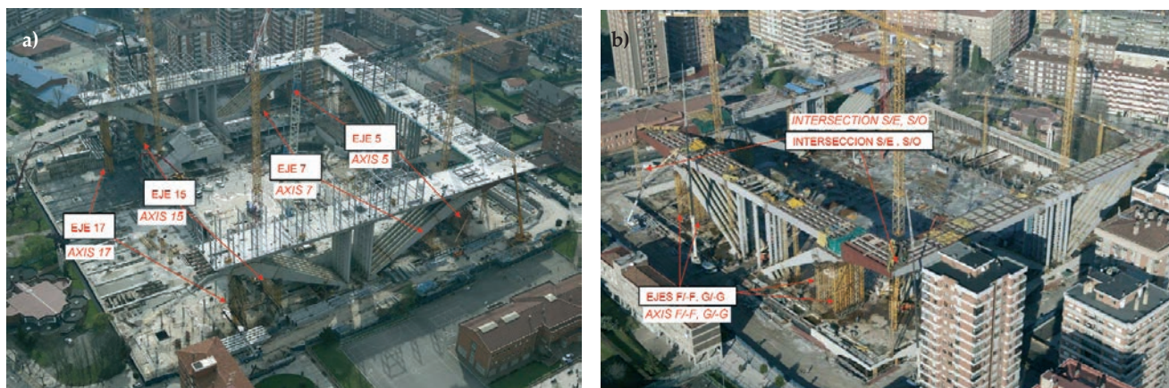
Figura 42. Situación de las torres de apeo: a) en los edificios de consejerías; b) en el edificio del hotel Figure 42. Location of the auxiliary structures: a) in the office buildings; b) in the hotel building in the office buildings
