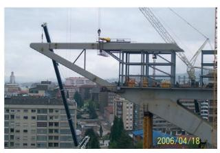
Figura 16. Voladizo Norte ya situado en su posición definitiva Figure 16. North cantilever already mounted in its final position
