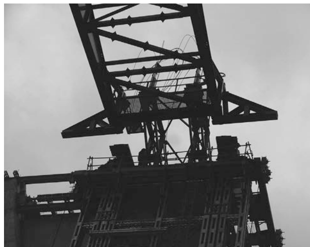
Figura 20A. Final de la recuperación de flecha con puertas abiertas
