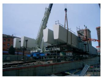
Figura 50. Bancadas de montaje de las costillas móviles Figure 50. Mounting rigs for the moveable ribs
