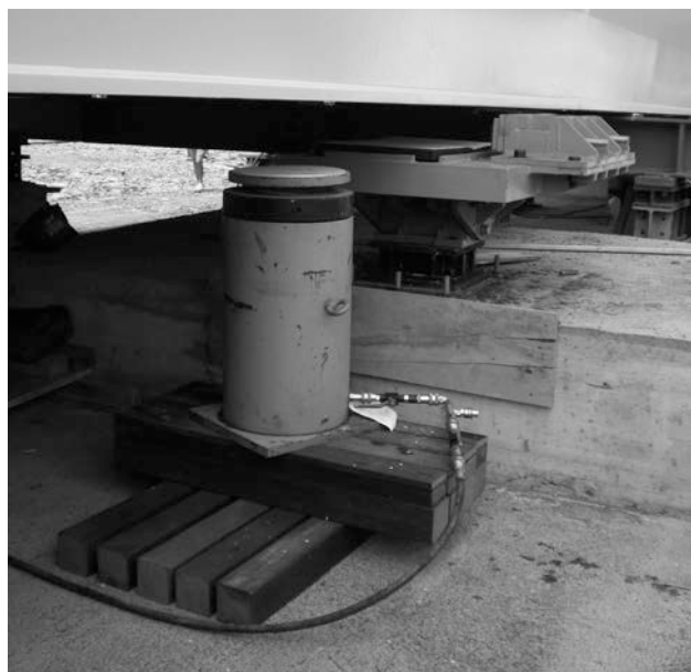
Figura 9. Sistema de deslizamiento en apoyos deslizantes y gato de desapeo
