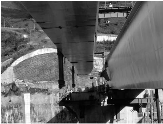
Figura 35A. Izado del viaducto V4 durante la translación vertical
