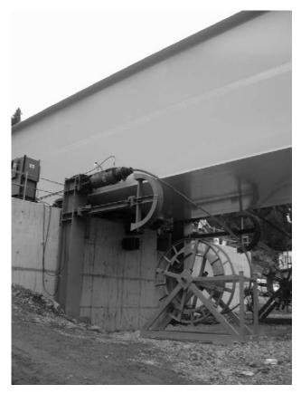
Figura 15. Sistema convencional de tiro en estribo E.1-1
