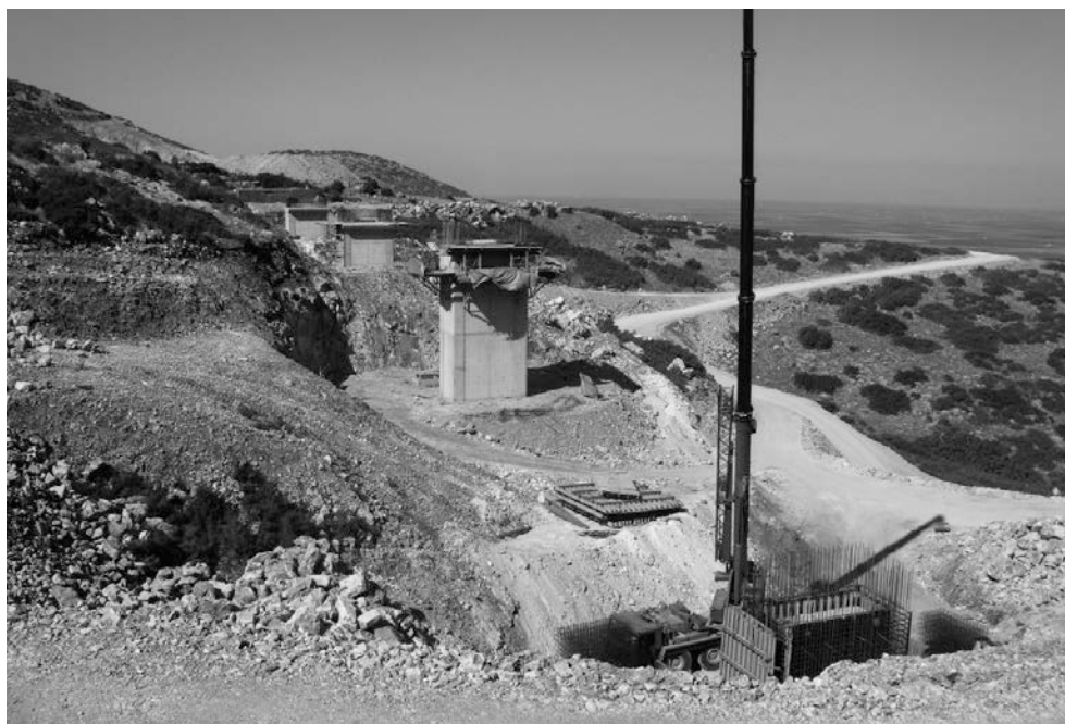
Figura 10. Pilas de la estructura SG27 en construcción
