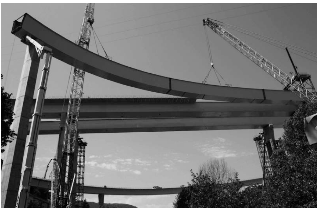
Figura 36. Montaje con grúa del resto del viaducto V4
