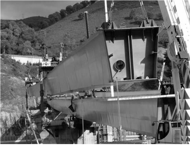
Figura 34A. Izado del viaducto V4 desde 3 puntos
