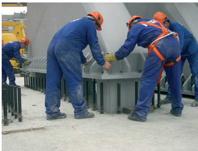
Figura 35. Proceso de montaje de una de las bases de los pórticos principales Figure 35. Mounting work of one of the bases of the main portals
