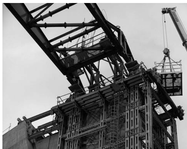
Figura 20C. Cierre de 2ª puerta y apoyo en gatos hidráulicos
