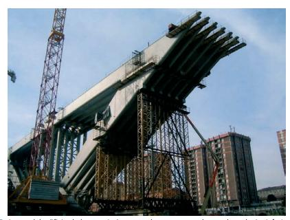
Figura 45. Apeos del edificio de la consejería este en los que se pueden ver las celosías inferiores a poyo Figure 45. Auxiliary supports of the East office building. In the bottom of the sets you can see the lower supporting trusses
