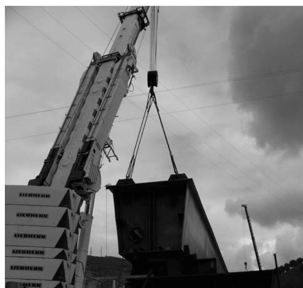
Figura 25. Grúa de apoyo en estribo
