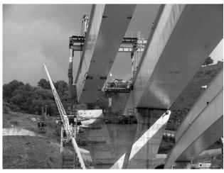
Figura 34B. Traslación del viaducto
