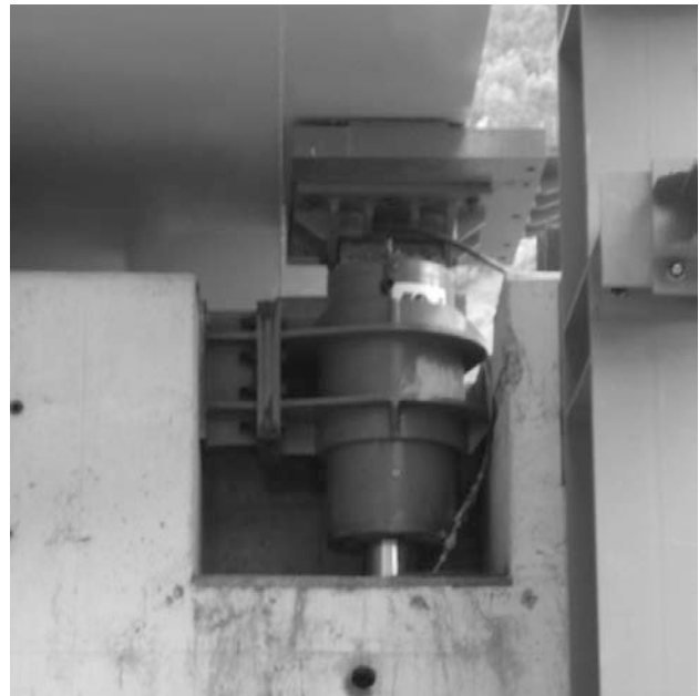
Figura 8. Sistema de deslizamiento en estribo
