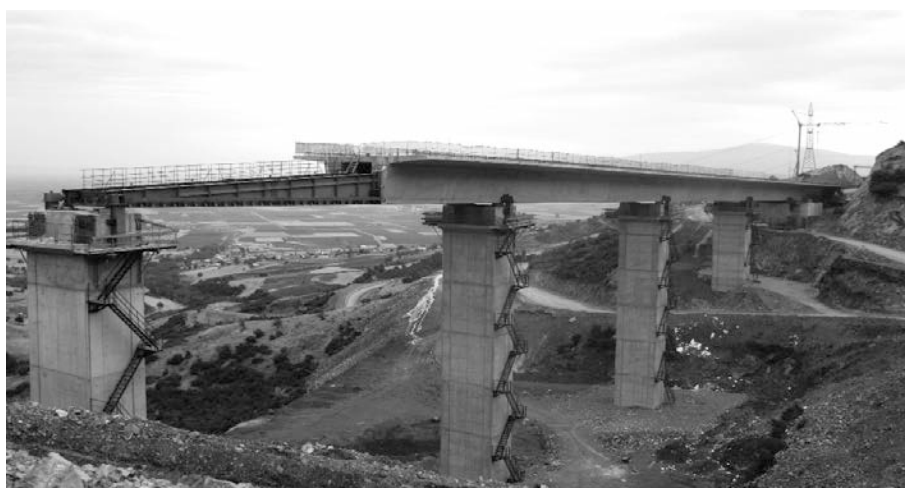
Figura 9. Empuje de la estructura SG25
