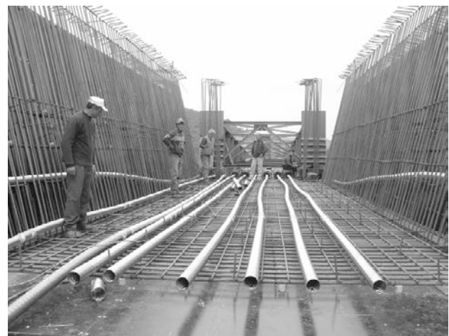
Figura 2. Vainas pretensado primer tramo
