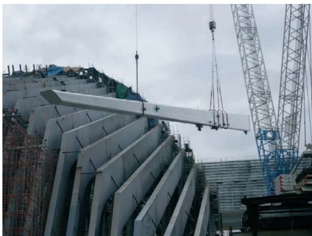
Figura 51. Izado del prearmado Norte (3+4+5) de la costilla móvil CM 1
