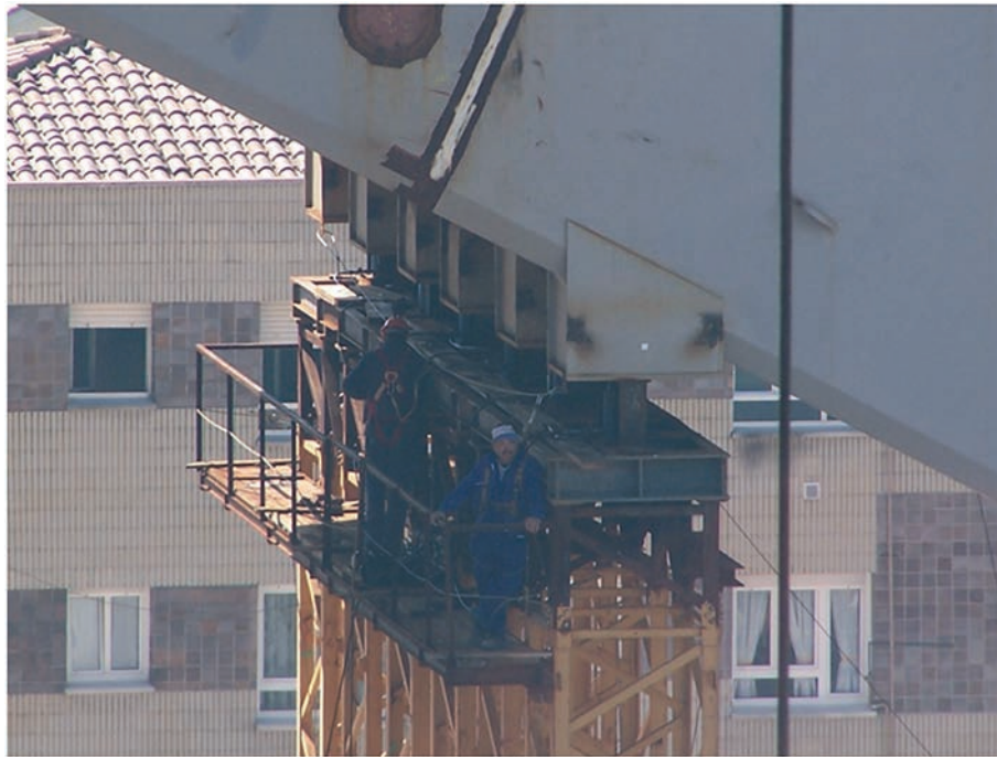
Figura 46. Detalle del apoyo superior de los apeos con alojamiento para los gatos hidráulicos de desapeo Figure 46. Detail of the upper support belonging to the auxiliary structures with housings for the hydraulic jacks
