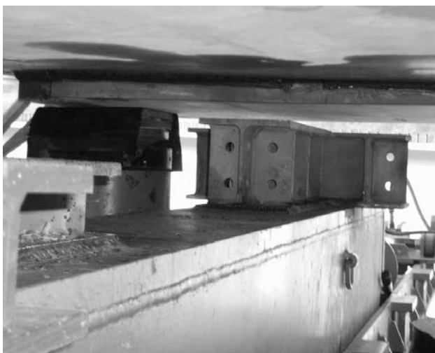
Figura 22. Carriles para el ripado
