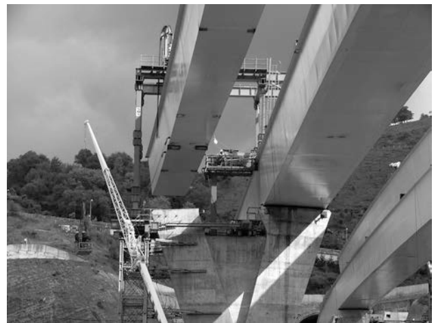
Figura 34B. Traslación del viaducto
