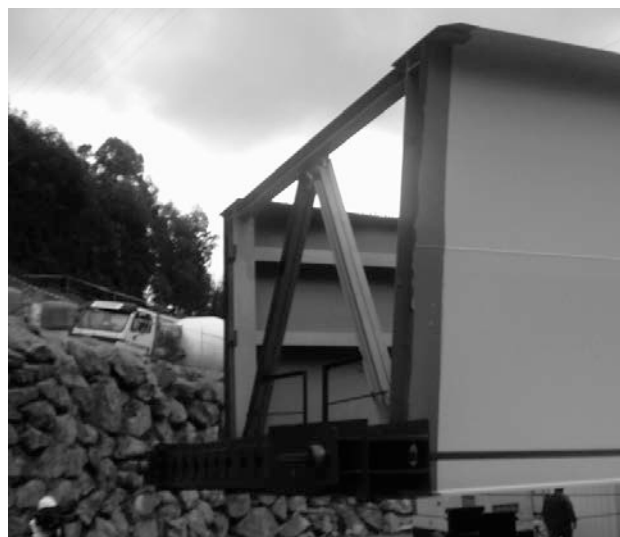
Figura 13. Detalle de la viga de tiro trasera
