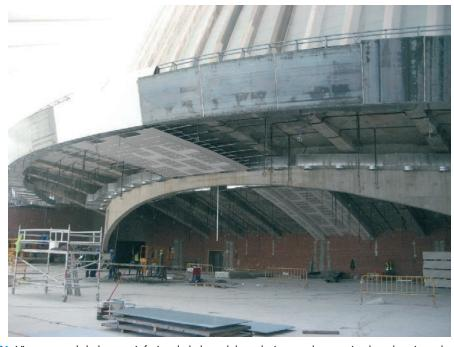
Figura 31. Vista general de la zona inferior de la losa del graderío con el muro circular y las vigas descolgadas Figure 31. General view of the lower surface of the grandstand slab with the circular wall and the downstand beams
