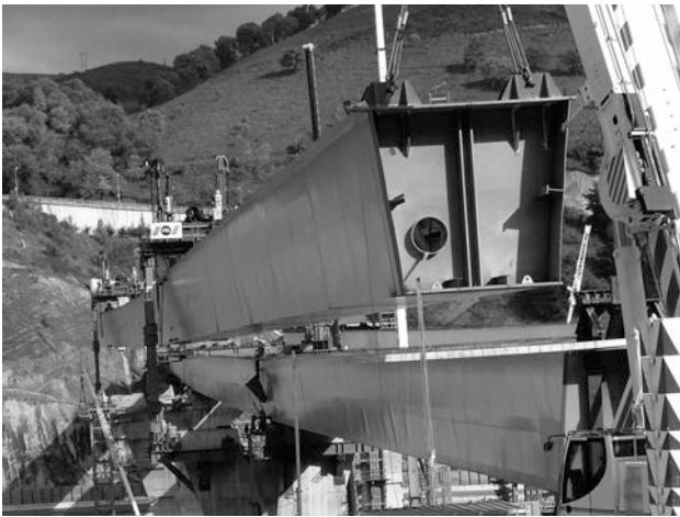
Figura 34A. Izado del viaducto V4 desde 3 puntos
