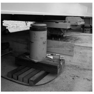
Figura 9. Sistema de deslizamiento en apoyos deslizantes y gato de desapeo
