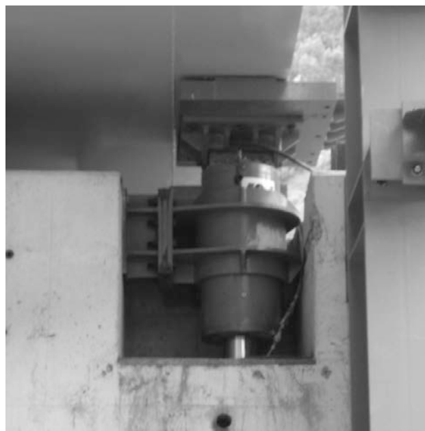
Figura 8. Sistema de deslizamiento en estribo
