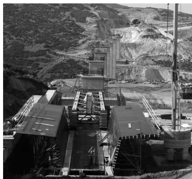
Figura 8. Estructura SG28 en construcción
