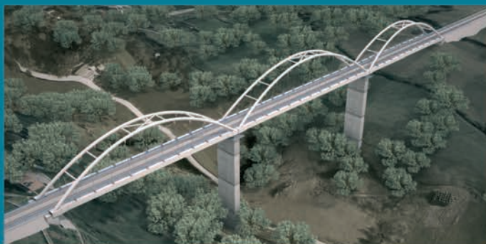
Viaducto SG-26 en la LAV Atenas-Tesalónica, luz máxima 150 m
