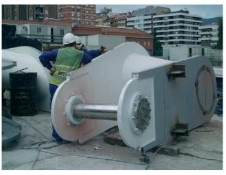
Figura 55. Tramo de arco móvil incluyendo las orejetas de unión a las costillas antes de ser izado y montado
