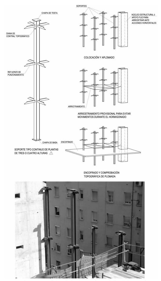
Figura 12. Esquema de protopropuesta de protocolo de ejecución en obra para el aplomado de soportes de tres o más plantas
