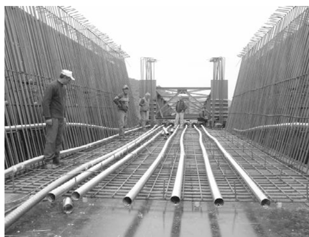
Figura 2. Vainas pretensado primer tramo
