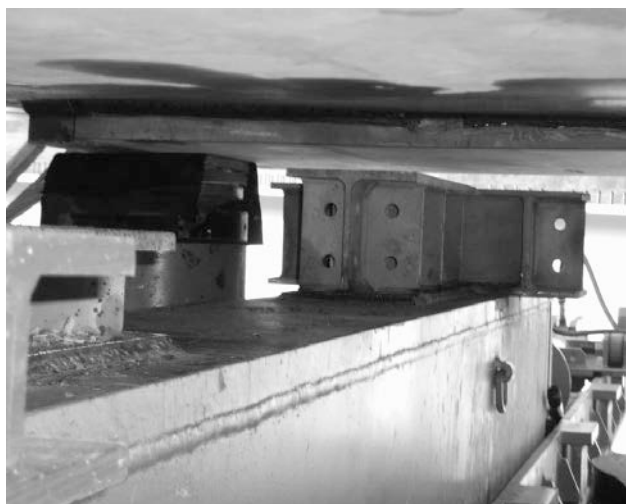
Figura 22. Carriles para el ripado
