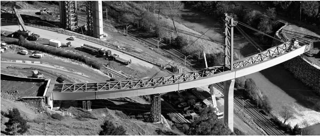
Figura 41. Montaje del viaducto V3 después de la colocación del tramo cinco
