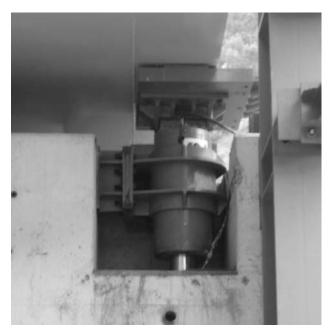
Figura 8. Sistema de deslizamiento en estribo
