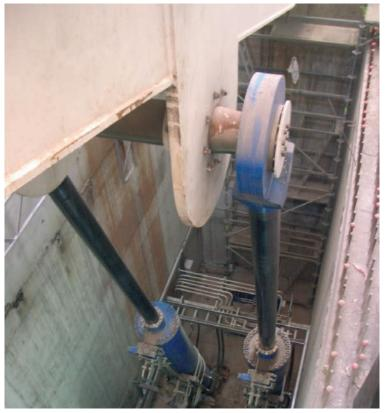
Figura 60. Conexión de la palanca guiadora a los cilindros de accionamiento Figure 60. Connection of the lever arm to the hydraullic cylinders
