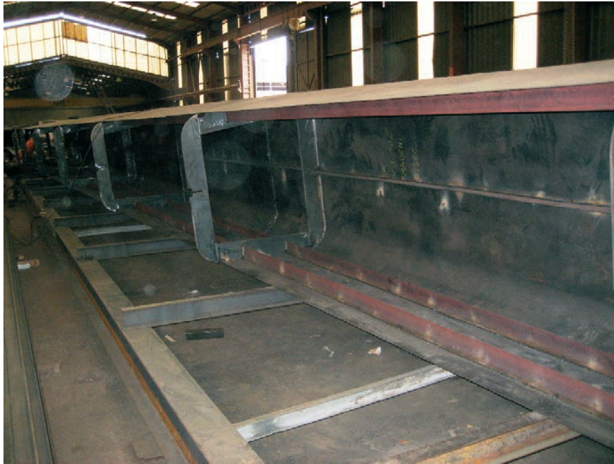
Figura 22. Costilla móvil durante su fabricación en el taller Figure 22. Shop fabrication of one of the moveable ribs
