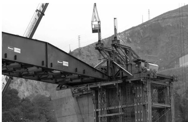
Figura 19. Recuperación de flecha con pórticos auxiliares
