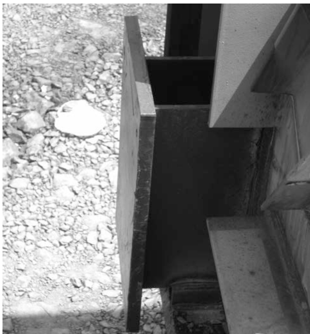
Figura 16. Detalle de chapas para acoplar la viga de tiro
