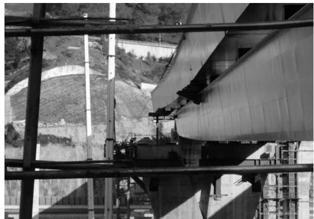
Figura 27C. Ripado, fase intermedia
