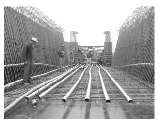
Figura 2. Vainas pretensado primer tramo
