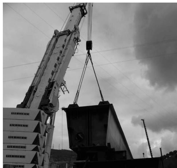
Figura 25. Grúa de apoyo en estribo
