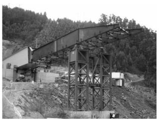
Figura 12. Montaje del primer tramo, nariz de lanzamiento sobre pilas auxiliares
