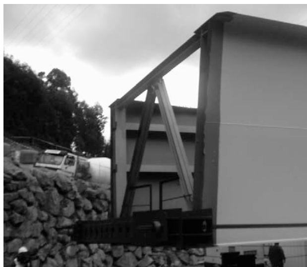
Figura 13. Detalle de la viga de tiro trasera
