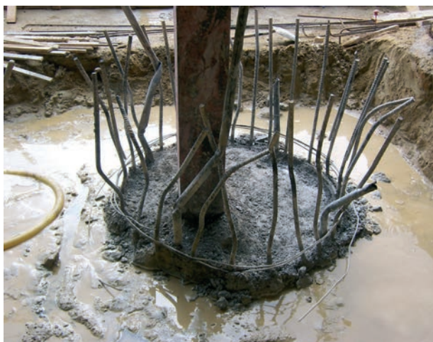
Figuras 31 y 32. Detalle de cabeza de pilote y arranque de pilar, y croquis de encepado
