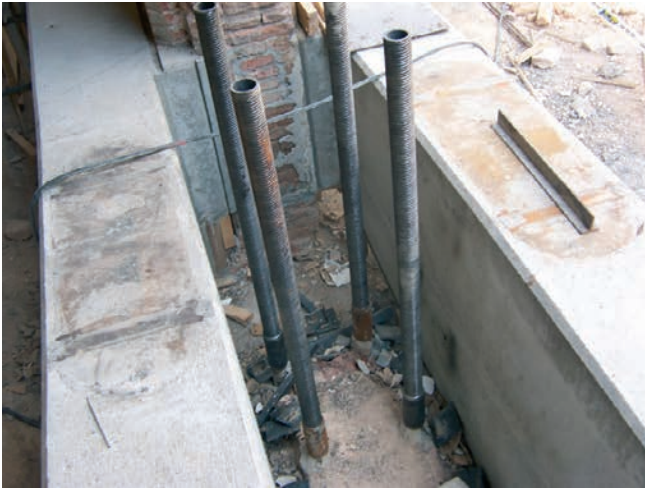
Figuras 16 y 17. Micropilotes y estructura de suspensión entre vigas-arco Figures 16 & 17. Minipiles and suspension structure between arch beams
