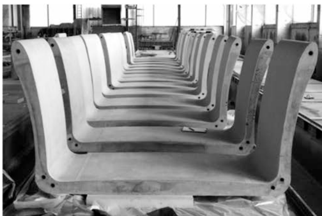
Figura 20. Pasarela de hormigón armado con textiles – dovelas antes del ensamblaje y posición final [11], [56] Figure 20. Textile Reinforced Concrete footbridge – segments before clamping together and in final position [11], [56]
