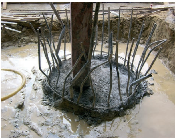
Figuras 31 y 32. Detalle de cabeza de pilote y arranque de pilar, y croquis de encepado Figures 31 & 32. Detail of pile cap and support base, and diagram of pile cap
