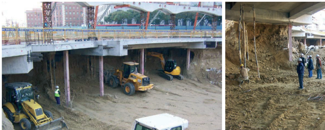
Figuras 26 y 27. Vistas de la excavación bajo la estructura de planta baja
