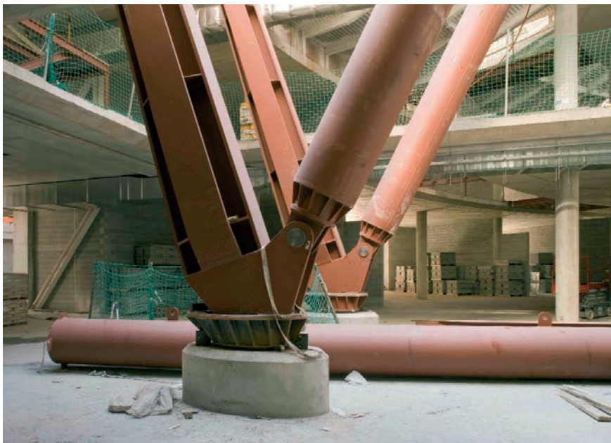
Figuras 47 y 48. Montaje de los fustes exteriores y detalle de arranque de fuste Figures 47 & 48. Erection of exterior shafts and details of base of shafts.
