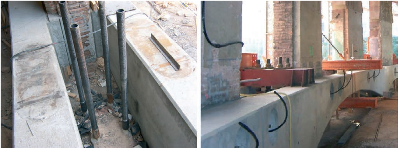
Figuras 16 y 17. Micropilotes y estructura de suspensión entre vigas-arco Figures 16 & 17. Minipiles and suspension structure between arch beams
