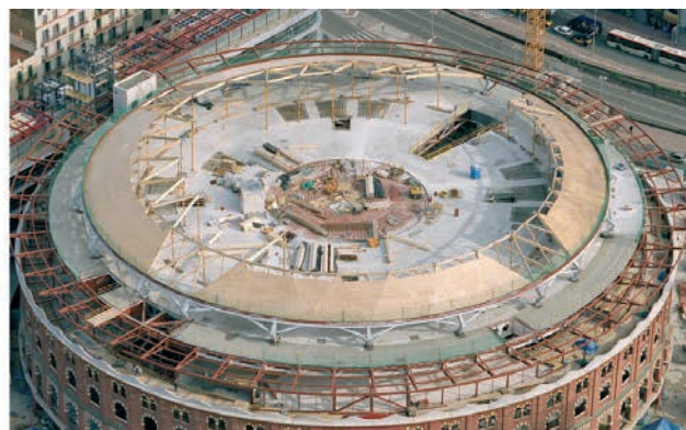
Figura 59. Vistas de la fase de montaje de la cúpula de madera Figure 59. Views of the wooden-dome erection stage
