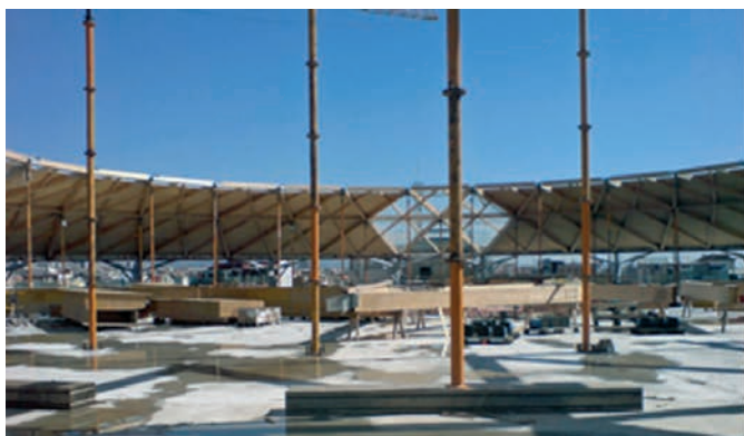
Figura 59. Vistas de la fase de montaje de la cúpula de madera Figure 59. Views of the wooden-dome erection stage
