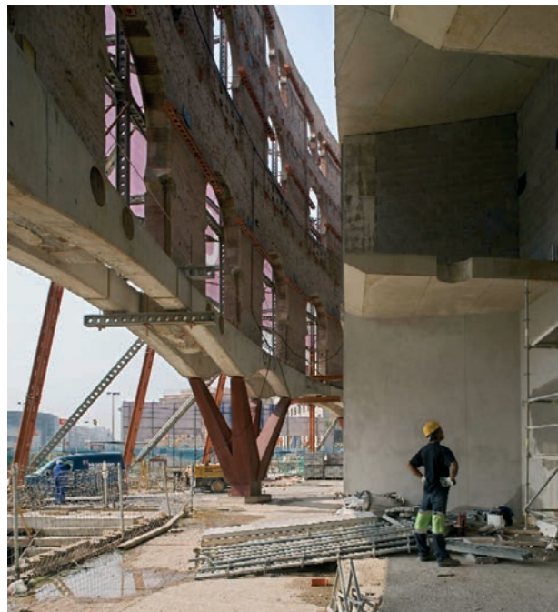
Figuras 42 y 43. Imagen 3D y vista real de pilar tipo para apoyo de fachada Figures 42 & 43. 3D and real-life image of standard façade support
