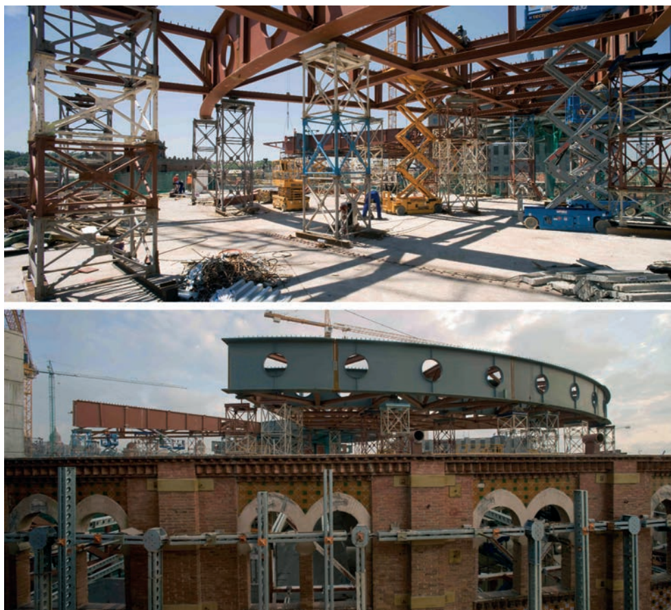
Figura 54. Montaje de platea mediante torre central y de vigas radiales y circunferenciales sobre cimbra Figure 54. Assembly of disc with central tower and radial and circumferential beams on falsework
