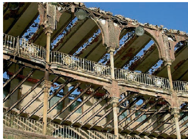
Figura 8. Deconstrucción manteniendo la estructura del anillo adosado a la fachada
