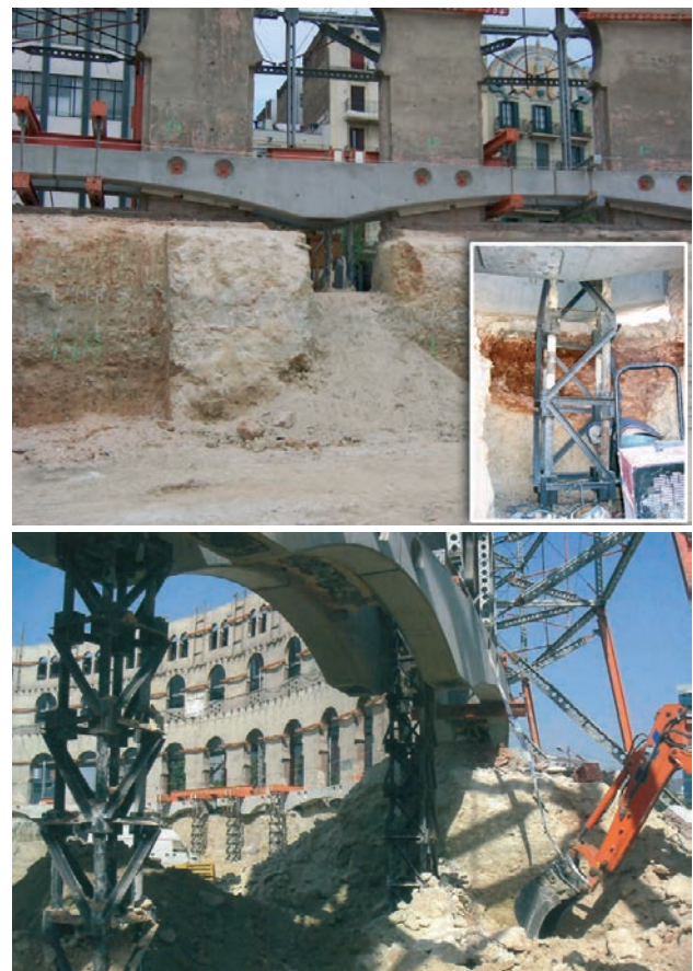
Figuras 22 y 23. Excavación del caballón y arriostramiento de los micropilotes
