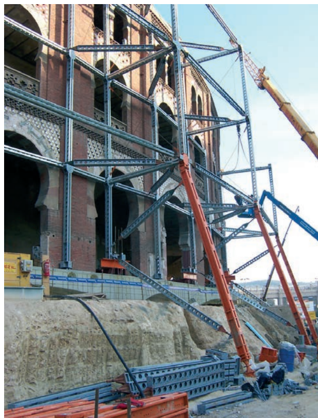
Figura 20. Estabilizador exterior de fachada Figure 20. Exterior façade stabiliser
