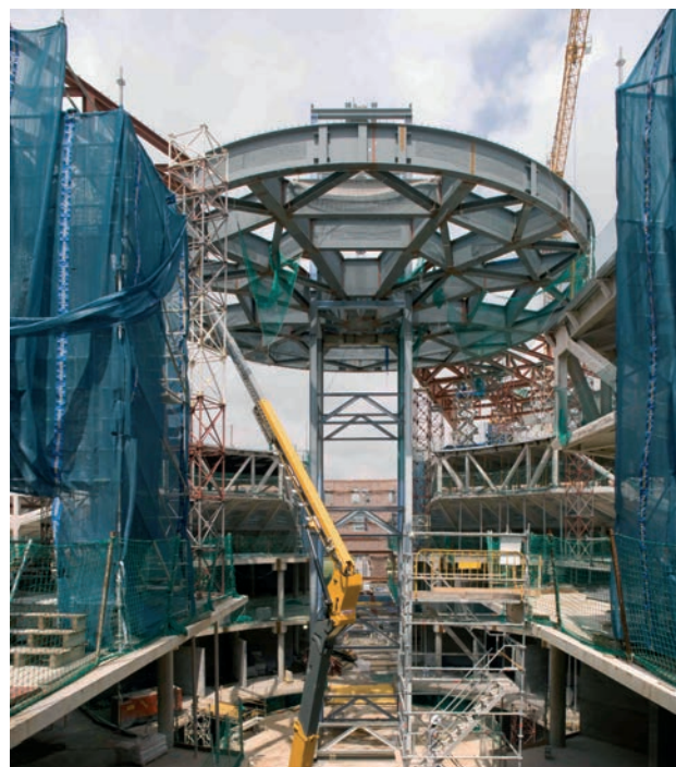
Figuras 53. Montaje de platea mediante torre central y de vigas radiales y circunferenciales sobre cimbra
