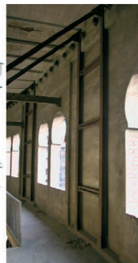
Figuras 4 y 5. Deformaciones y grietas históricas y refuerzos de las pilastras superiores de la fachada Figures 4 & 5. Historical deformation and cracking and reinforcement of the upper supports of the façade
