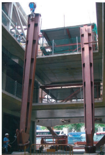
Figuras 47 y 48. Montaje de los fustes exteriores y detalle de arranque de fuste Figures 47 & 48. Erection of exterior shafts and details of base of shafts.
