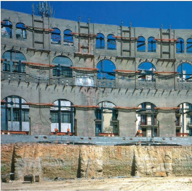
Figura 21. Caballón de apoyo de la fachada (vista desde el interior)
