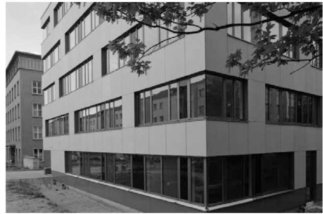
Figura 22. Placas de fachada de hormigón armado con textiles en el campus de la TU Dresden [11]
