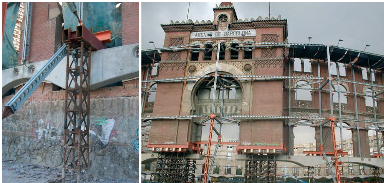
Figuras 18 y 19. Castilletes, exterior en calle Diputació, y bajo la puerta principal Figures 18 & 19. Turrets, exterior on Diputació street, and beneath the main entrance
