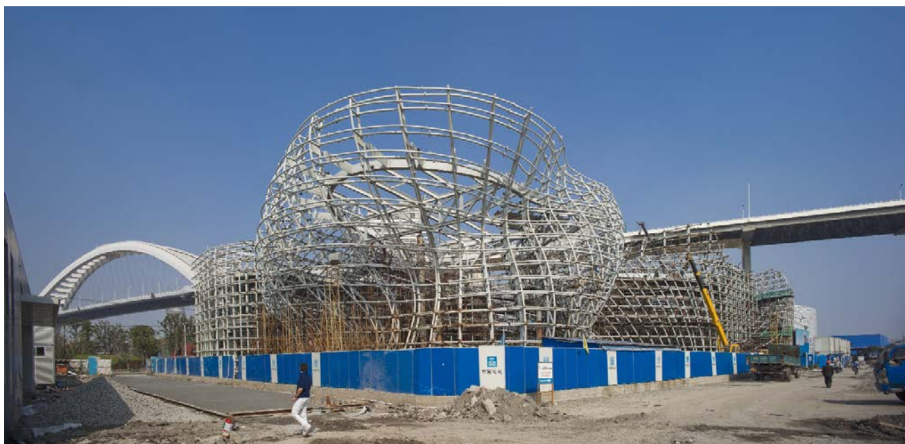
Figura 4. Perspectiva general del pabellón en construcción, con el Puente Lupu de fondo Figure 4. General perspective of the pavilion under construction, with Lupu Bridge in the background
