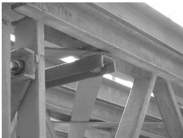
Figura 9. Cordón reforzado de las celosías
