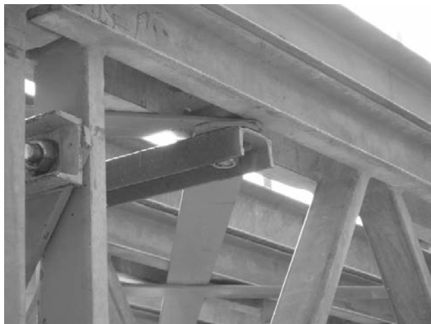
Figura 9. Cordón reforzado de las celosías
