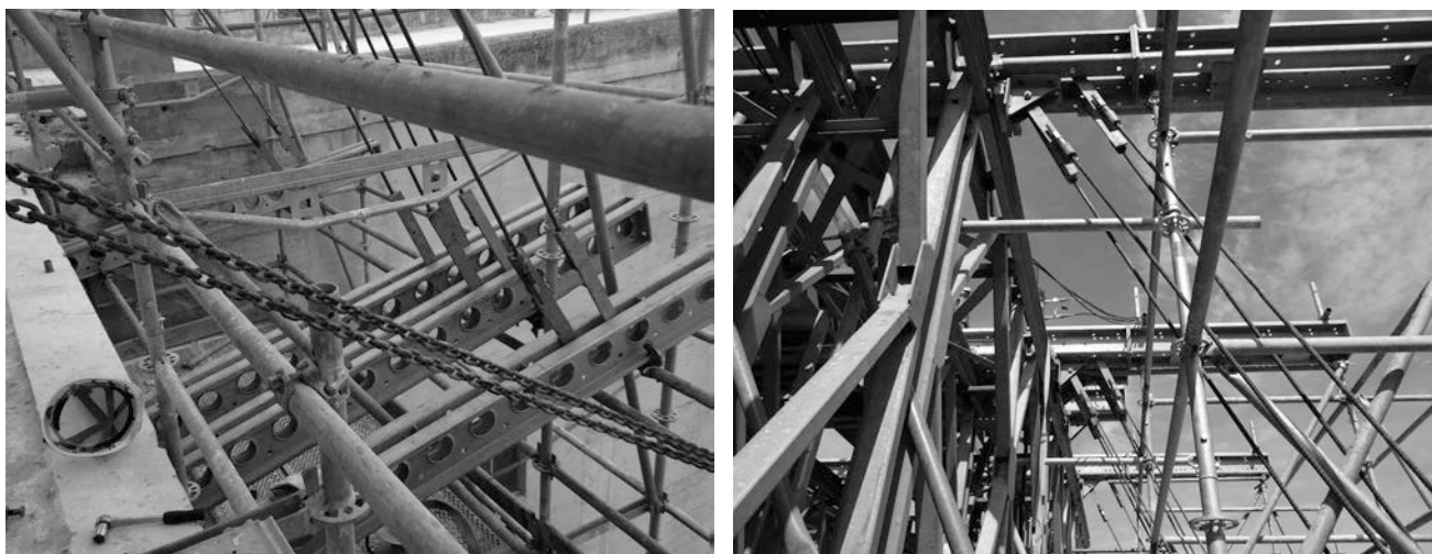
Figura 14. Ménsulas para soportar el encofrado del ensanche del tablero
