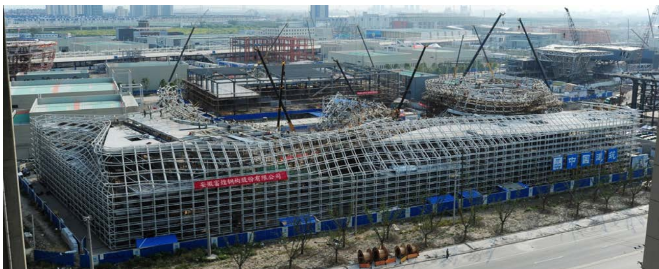
Figura 37. Vista general del pabellón en construcción, tomada desde el Puente Lupu Figure 37. General view of the pavilion under construction, taken from the Lupu Bridge
