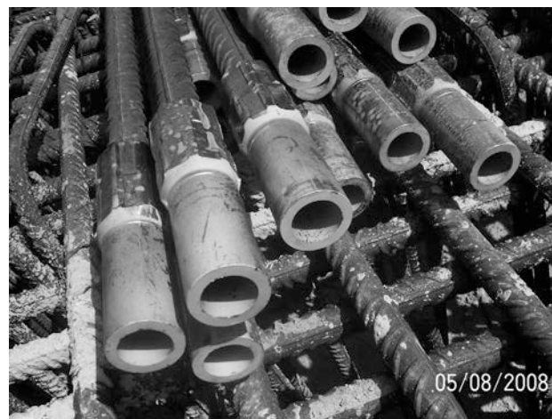
Figura 16. Empalmes mecánicos de la armadura vertical
