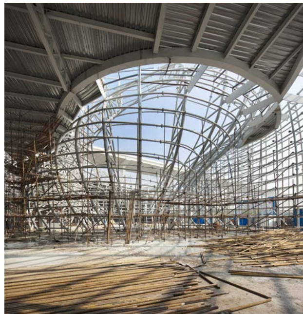
Figura 21. Vista desde la que se puede apreciar la esbeltez de las vigas triangulares
