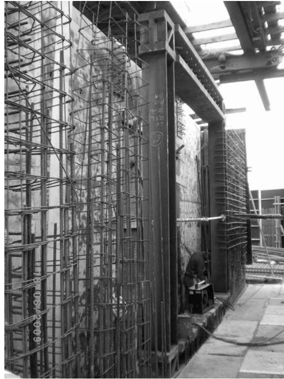
Figura 18. Dinteles metálicos embebidos en los huecos del núcleo
