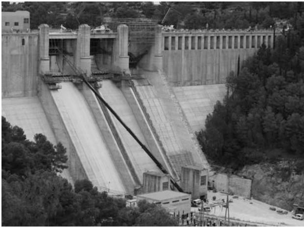
Figura 6. Vista general de la presa. Trabajos con apeo en tercer vano y con grúa en las compuertas del primer vano
