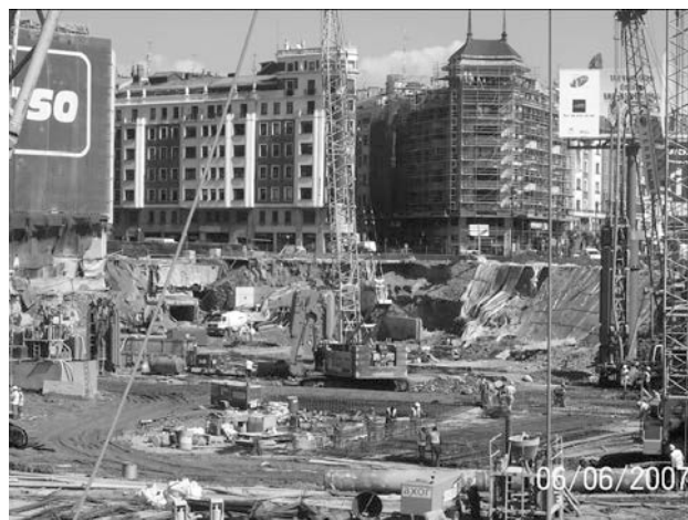
Figura 10. Estado general de la parcela durante la fase inicial del vaciado
