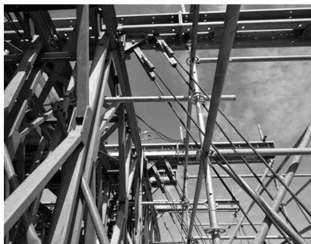
Figura 14. Ménsulas para soportar el encofrado del ensanche del tablero
