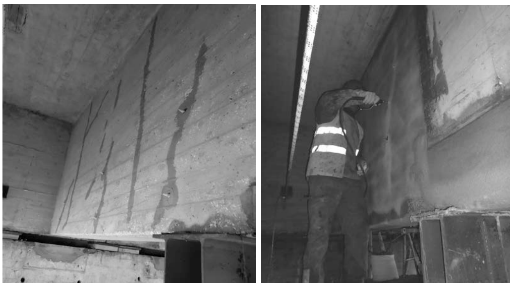
Figura 16. Distintas tareas en la ejecución de la inyección de fisuras
