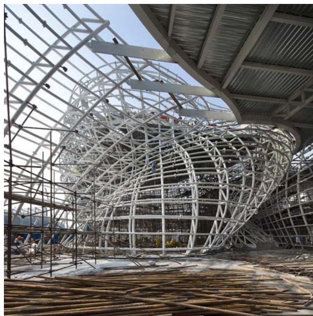
Figura 6. Sala Expositiva 3. La fuertemente curvada fachada estructural soporta la cubierta sin columnas interiores. La cubierta está compuesta por vigas triangulares, cajón perimetral, celosías y forjado mixto
