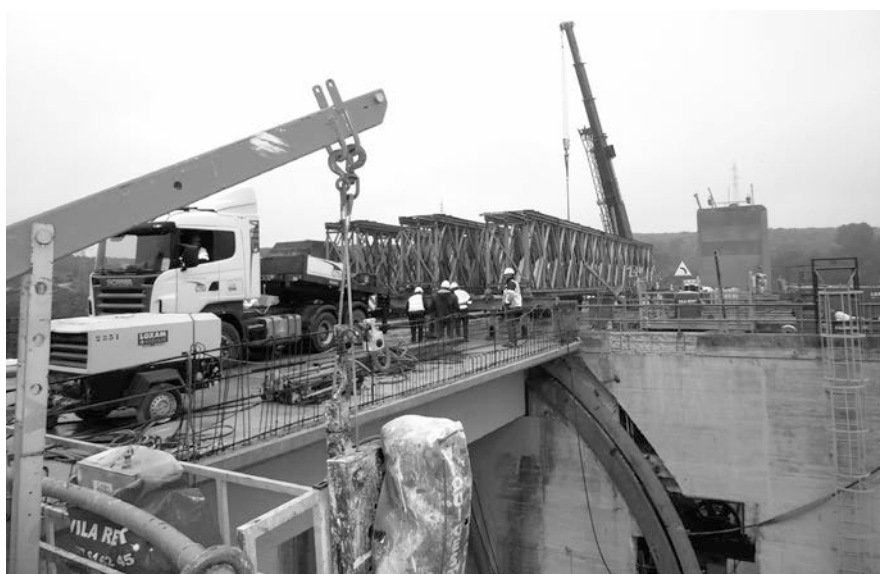
Figura 24. Transporte de celosía con grúa y camión
