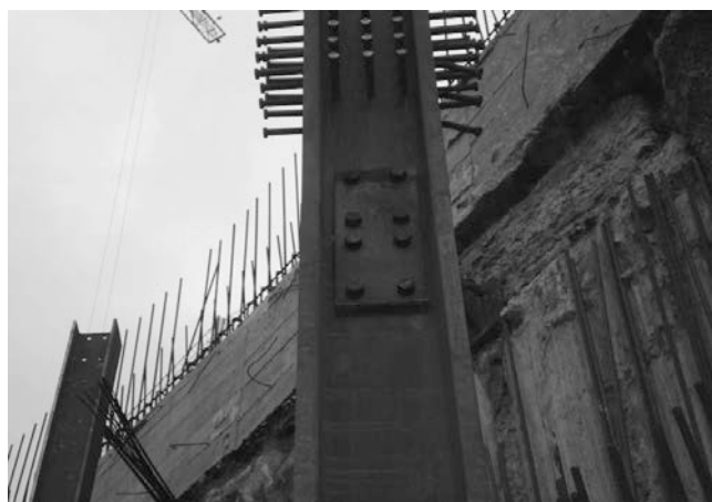
Figura 21. Pilares mixtos. Conexión entre tramos consecutivos
