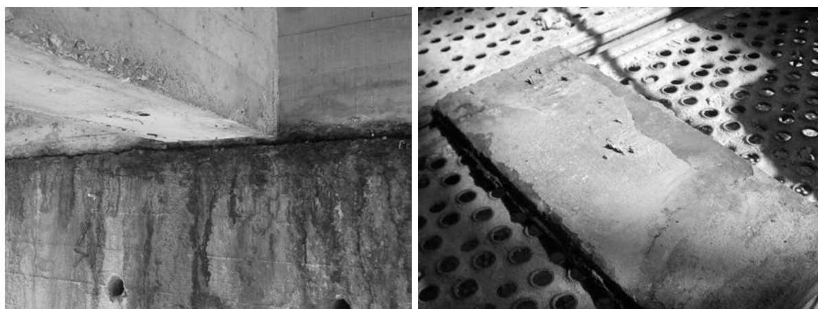
Figura 21. Estado de conservación de los apoyos de plomo
