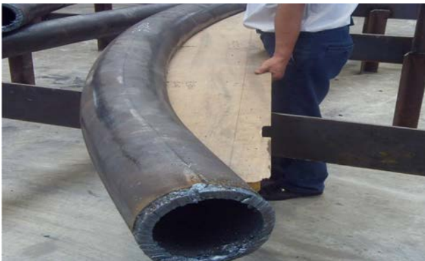
Figura 32. Comparación de tubo curvado con una plantilla de madera Figure 32. Curved tubes being checked against a wood template
