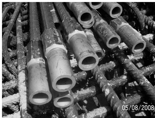
Figura 16. Empalmes mecánicos de la armadura vertical
