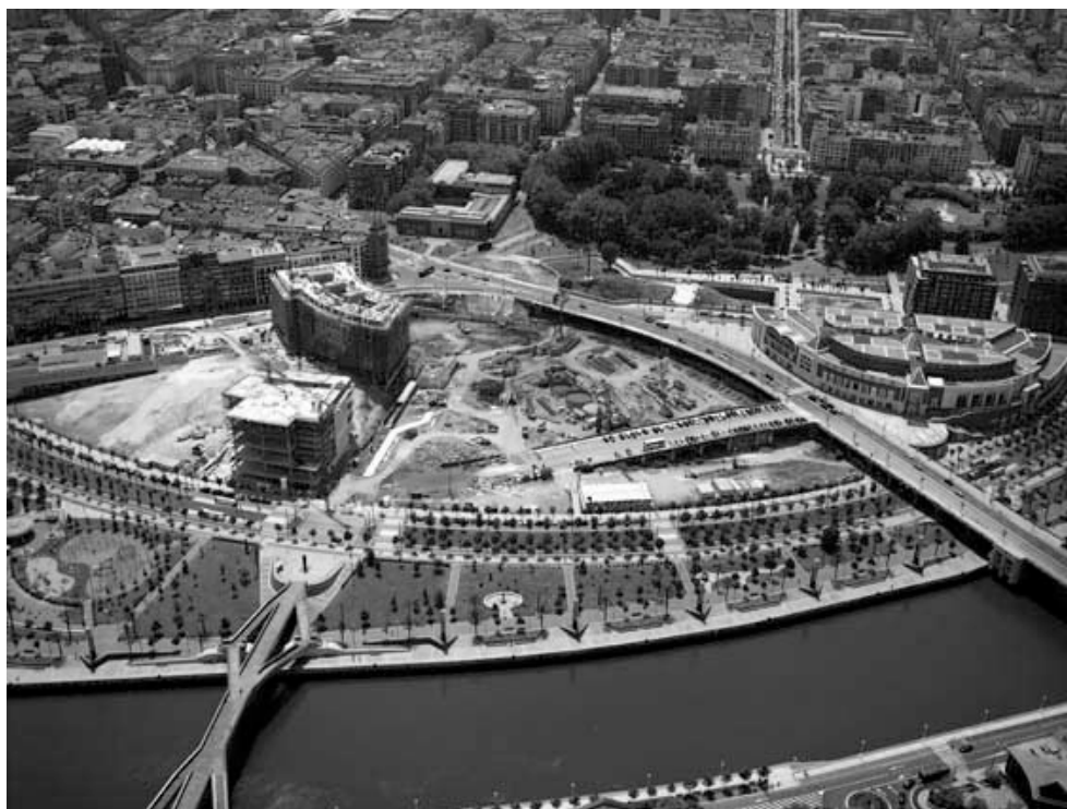
Figura 5. Estado de la parcela al inicio de las obras
