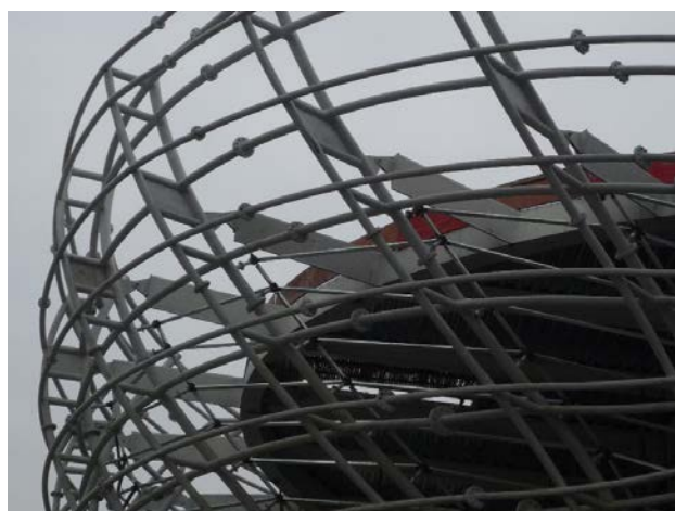
Figura 20. Detalle de la cubierta de la Sala Expositiva 2. Las vigas triangulares se unen por medio de bulones a la fachada, rigidizada por paneles en esa zona
