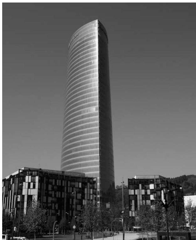
Figura 22. Torre y edificios de viviendas tras las finalización de su construcción
