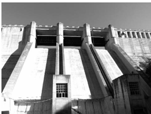
Figura 1. Vista general de la presa
