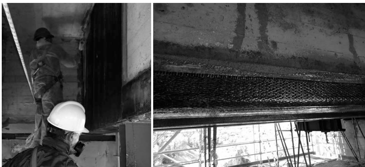
Figura 17. Refuerzos a cortante y flexión con Foreva® TFC
