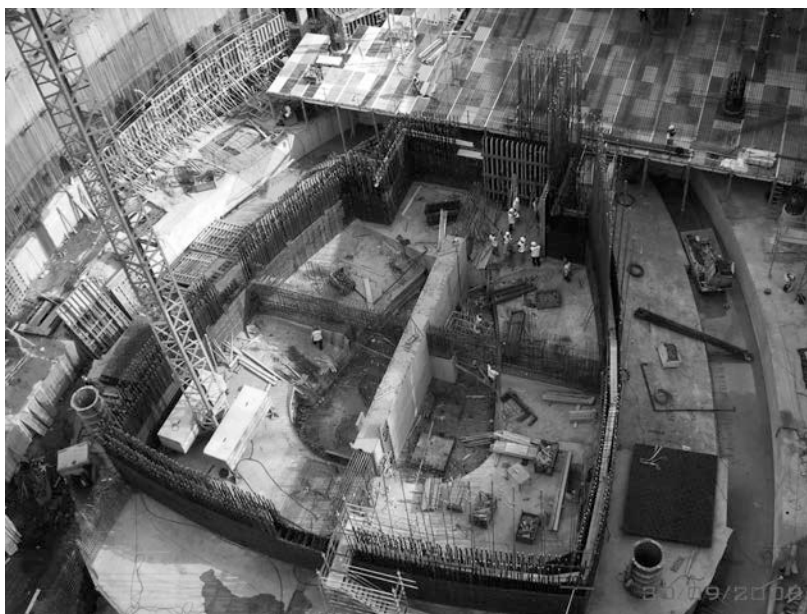
Figura 12. Vista general de la cimentación de la torre
