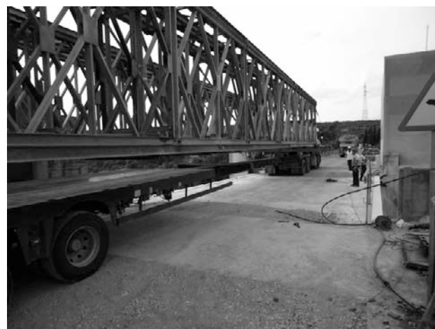
Figura 15. Movimiento de viga principal entre tableros
