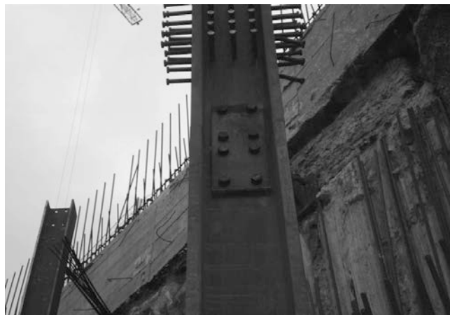
Figura 21. Pilares mixtos. Conexión entre tramos consecutivos
