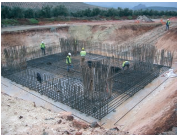
Figura 15. Montaje de la ferralla de los encepados de las pilas tipo Figure 15. Reinforcement assembling at the pilecaps of typical piers
