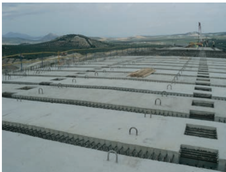
Figura 9. Losa prefabricada a sección completa en zona de positivos y prelosas nervadas en zona de negativos Figure 9. Full cross section precast slab at sagging moments zone and ribbed preslabs at hogging moments zone
