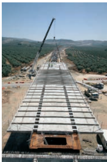
Figura 9. Losa prefabricada a sección completa en zona de positivos y prelosas nervadas en zona de negativos Figure 9. Full cross section precast slab at sagging moments zone and ribbed preslabs at hogging moments zone
