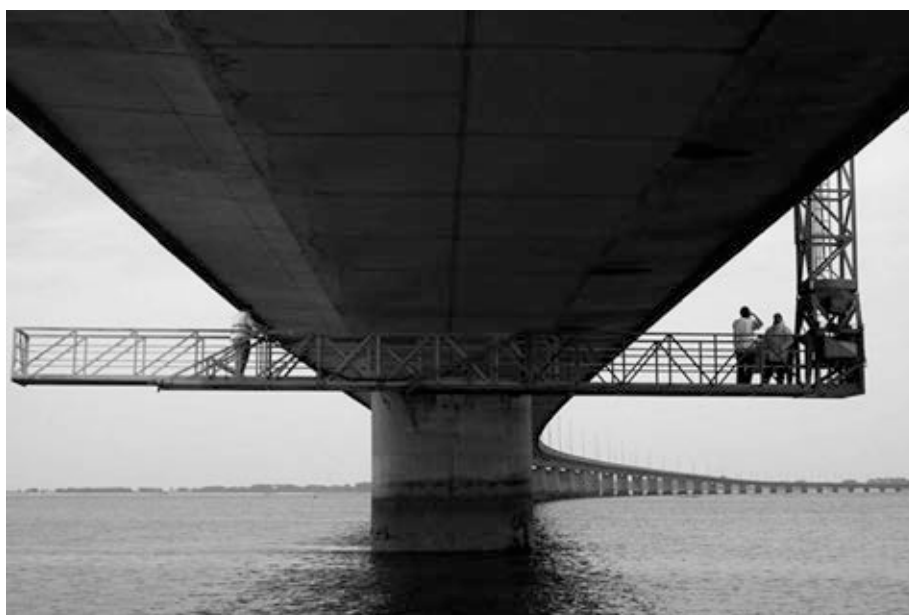
Figura 5. Plataforma de inspección en el puente
