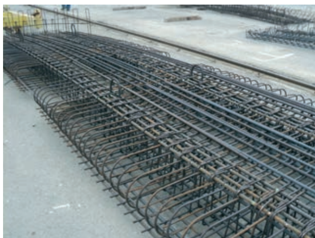
Figura 26. Losa prefabricada de positivos en la planta durante su fabricación Figure 26. Sagging zone precast slab at the shop during fabrication
