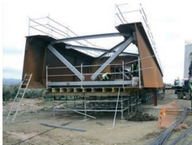
Figura 22. Encofrado de fondo para la ejecución parcial de la losa inferior del tablero Figure 22. Bottom formwork to partially execute deck bottom slab
