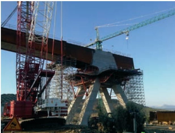
Figura 20. Montaje de los tramos de cierre del tablero y vista de la Pila Central del viaducto ejecutada Figure 20. Assembling of deck closing segments and view of the Central Pier of the viaduct once finished
