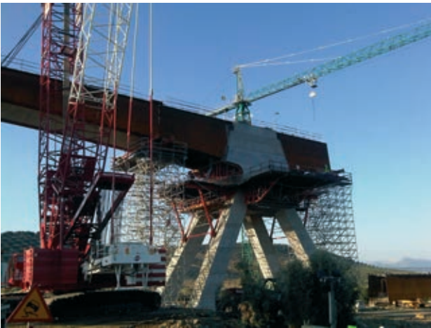
Figura 20. Montaje de los tramos de cierre del tablero y vista de la Pila Central del viaducto ejecutada Figure 20. Assembling of deck closing segments and view of the Central Pier of the viaduct once finished
