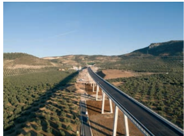
Figura 28. Vista durante la prueba de carga y tras ejecutar los acabados Figure 28. View during load test and after finishing deck works
