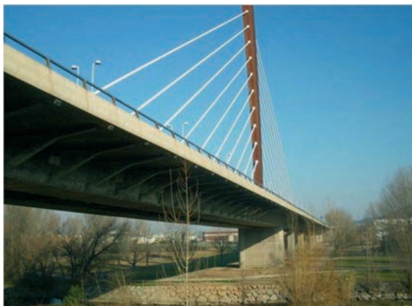
Figura 1. Vista del tablero del puente sobre el río Iregua en Logroño
