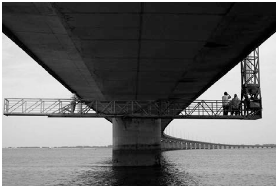
Figura 5. Plataforma de inspección en el puente
