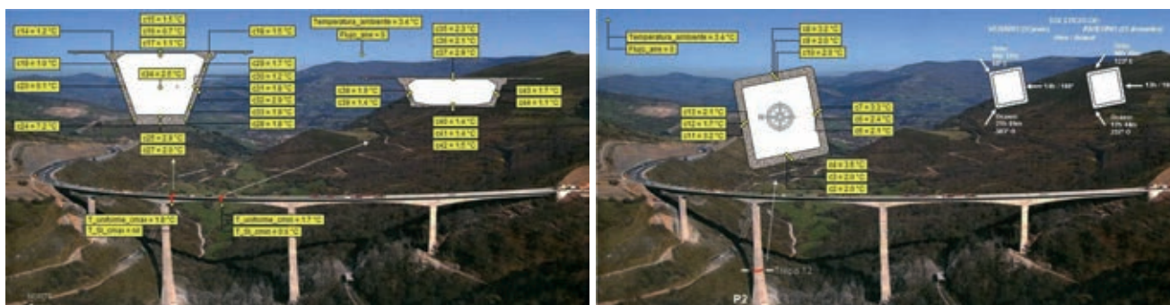
Figuras 22a y 22b. Infogramas con instrumentación térmica del tablero del viaducto y una de las secciones de una pila
