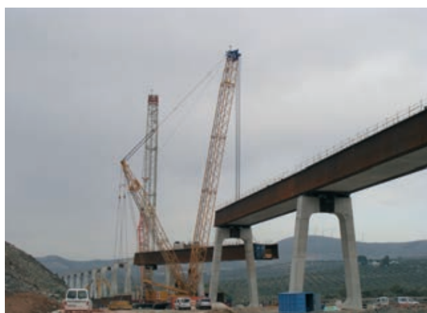
Figura 22. Encofrado de fondo para la ejecución parcial de la losa inferior del tablero Figure 22. Bottom formwork to partially execute deck bottom slab
