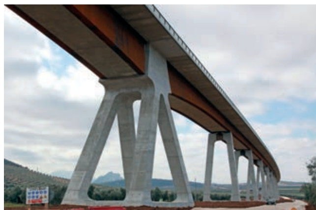
Figura 11. Espectro de respuesta de la estructura y Punto Fijo Central del viaduct Figure 11. Structure response spectrum and Fixed Central Pier of the viaduct
