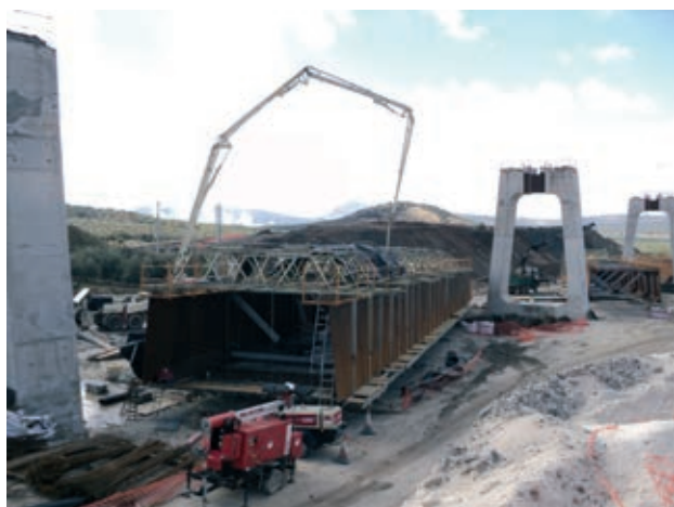
Figura 22. Encofrado de fondo para la ejecución parcial de la losa inferior del tablero Figure 22. Bottom formwork to partially execute deck bottom slab
