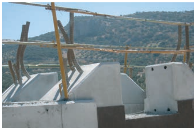
Figura 12. Vista del sistema de tope fijo en cabeza de pila y en mamparo de dovela metálica Figure 12. View of the shearkey at pierhead and at the diaphragm of the steel segment
