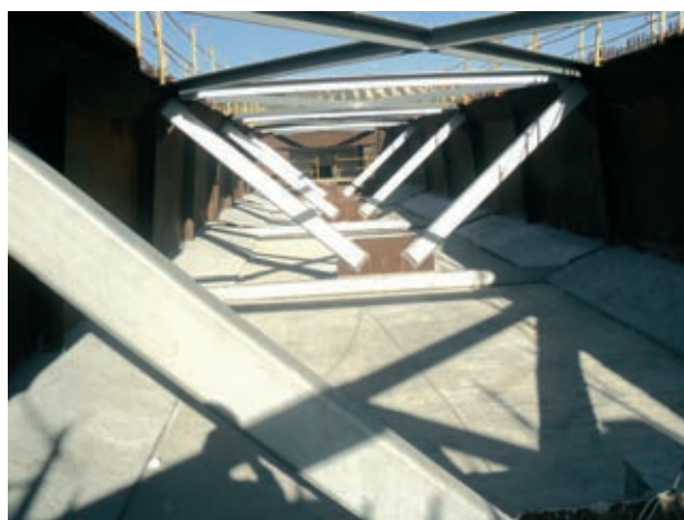
Figura 25. Vista del hormigón de fondo en negativos y zunchos antes de hormigonar, y del fondo de cajón tras ser terminado Figure 25. View of bottom concrete slab at hogging zone, and of deck bottom once finished
