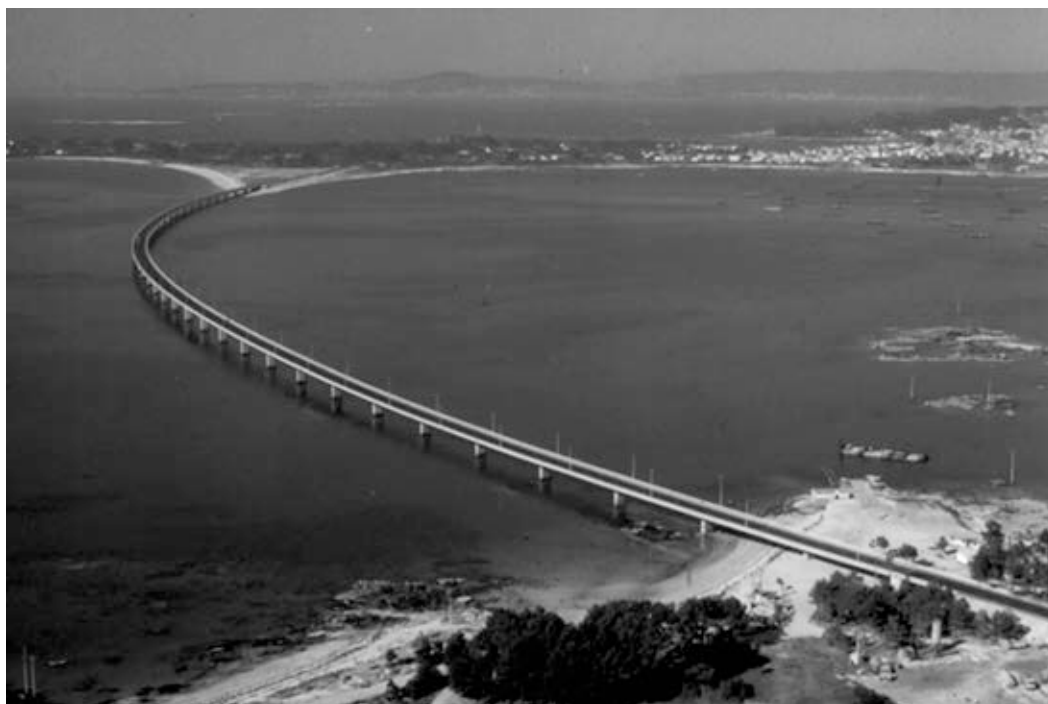
Figura 1. Vista general del puente y de la isla de Arosa, al fondo. Cortesía de Santiago Pérez-Fadón (Ferroviario)
