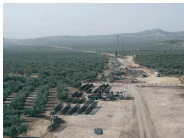
Figura 14. Vista general del acopio de los tramos de ferralla prefabricados a lo largo de la traza y ejecución de los pilotes Figure 14. General view of the stock of precast rebar modules along the profile and piles execution
