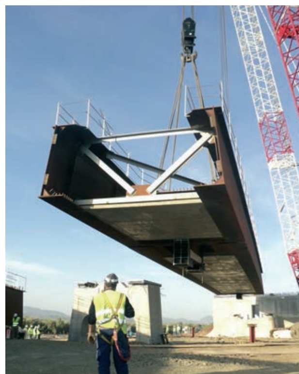
Figura 23. Izado de piezas tras la ejecución parcial de la losa inferior del tablero
