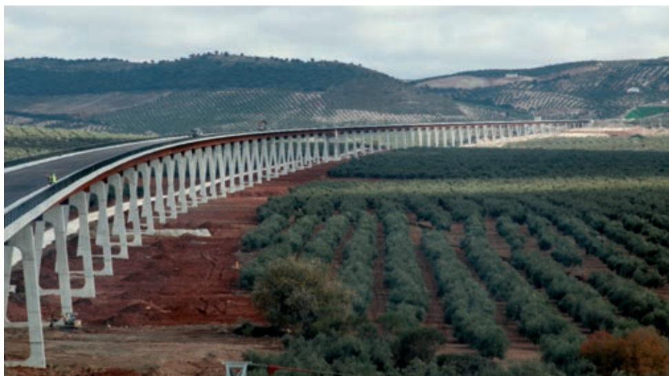
Figura 5. Vista del viaducto mixto de Archidona concluido
