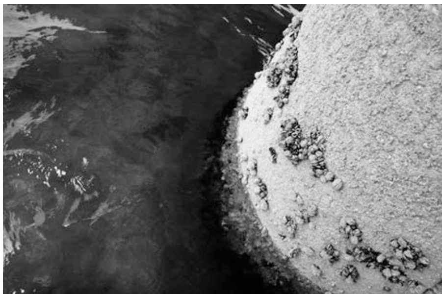
Figura 11. Biocolonias en la zona de carrera de marea de las pilas
