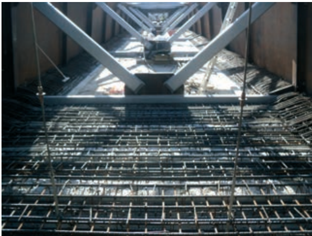
Figura 25. Vista del hormigón de fondo en negativos y zunchos antes de hormigonar, y del fondo de cajón tras ser terminado Figure 25. View of bottom concrete slab at hogging zone, and of deck bottom once finished
