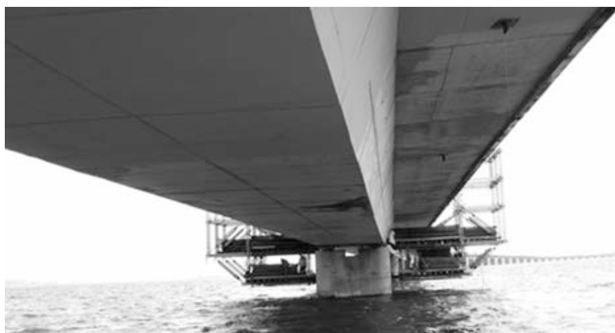
Figura 17. Carros-pórtico en acción
