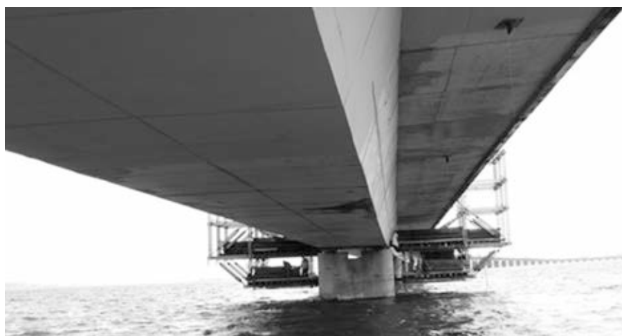
Figura 17. Carros-pórtico en acción
