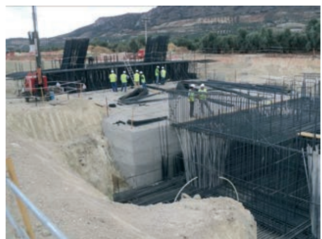
Figura 16. Ejecución por fases del encepado de la Pila Central del viaducto Figure 16. Staggered execution of the Central Pier pilecap of the viaduct
