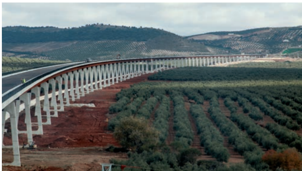
Figura 5. Vista del viaducto mixto de Archidona concluido
