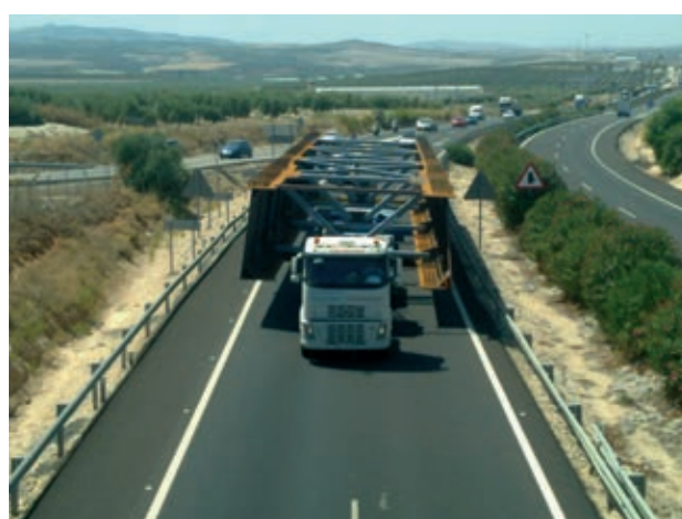
Figura 21. Fabricación en taller y transporte a obra de dovelas metálicas del tablero Figure 21. Fabrication at Shop and transport of steel deck segments to the site
