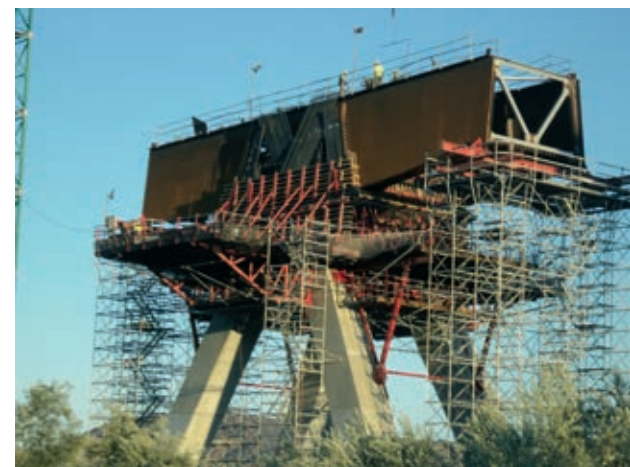
Figura 18. Ejecución de los cuatro fustes y de la cabeza de la Pila Central del viaducto
