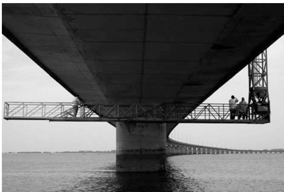
Figura 5. Plataforma de inspección en el puente
