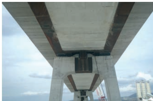
Figura 12. Vista del sistema de tope fijo en cabeza de pila y en mamparo de dovela metálica Figure 12. View of the shearkey at pierhead and at the diaphragm of the steel segment
