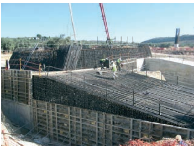
Figura 16. Ejecución por fases del encepado de la Pila Central del viaducto Figure 16. Staggered execution of the Central Pier pilecap of the viaduct
