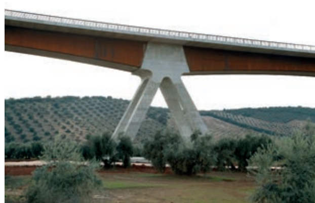
Figura 20. Montaje de los tramos de cierre del tablero y vista de la Pila Central del viaducto ejecutada Figure 20. Assembling of deck closing segments and view of the Central Pier of the viaduct once finished
