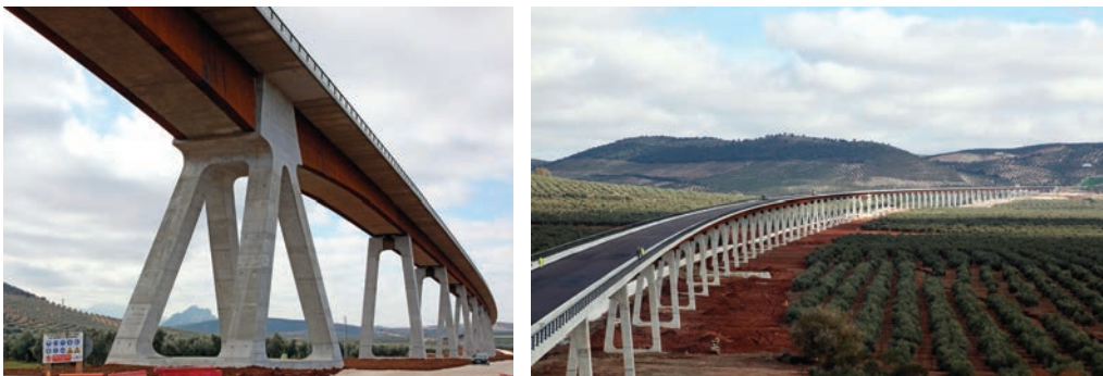
Viaducto de Archidona (Málaga).
