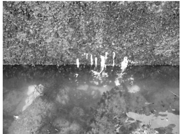
Figura 13. Resina inyectada en las zapatas saliendo por oquedades del hormigón.
