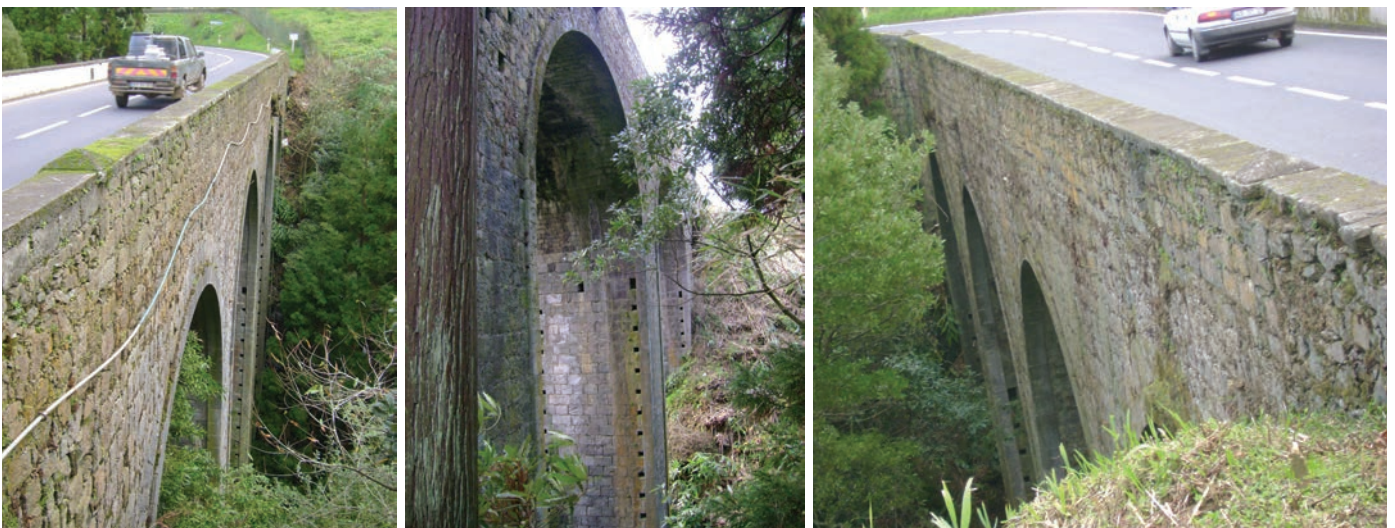
Figura 2. Detalle de la plataforma, tímpanos, pilas, boquilla y cañón de la bóveda, antes de la intervención.
