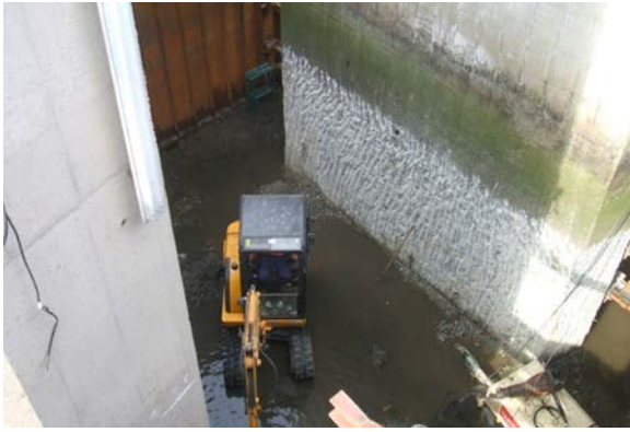
Figura 12. Vista del espacio entre fustes de la pila. Se distingue la superficie rugosa.
