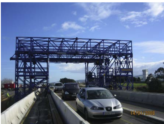
Figura 25. Cimbra móvil para montaje de vigas transversales y cajón longitudinal metálico.
