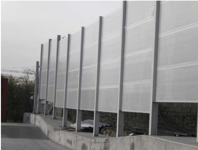
Figura 39. Pantallas antirruido.
