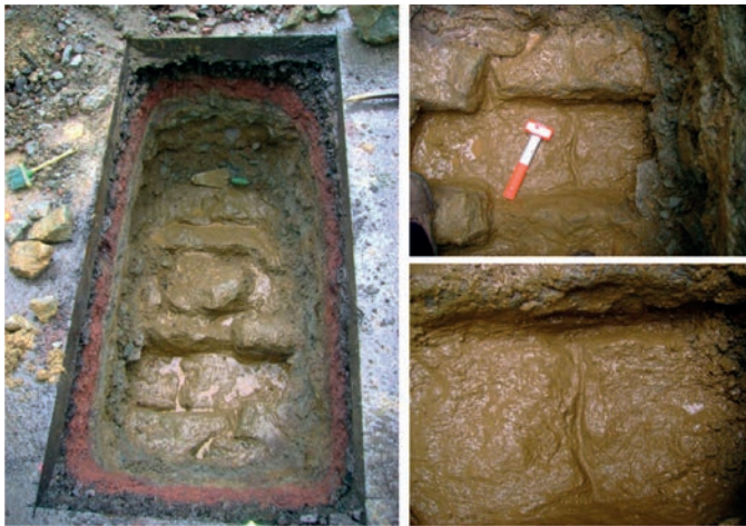
Figura 3. Cata y detalles de la calidad del aparejo, tamaño de bloques y espesores de juntas.
