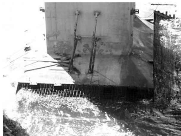
Figura 18. Construcción del zuncho perimetral de pila 4.
