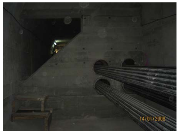
Figura 29. Vista del pretensado exterior dentro del cajón atravesando un rigidizador transversal dispuesto solo para limitar la distorsión del tablero.
