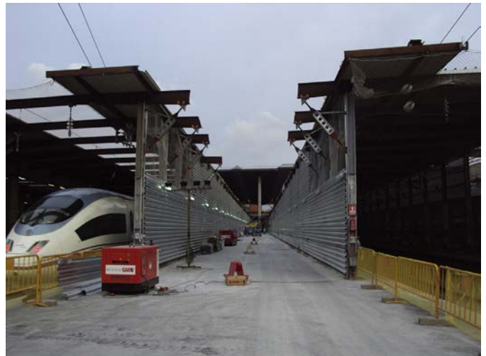
Figura 36. Túneles provisionales para la protección de vías.
