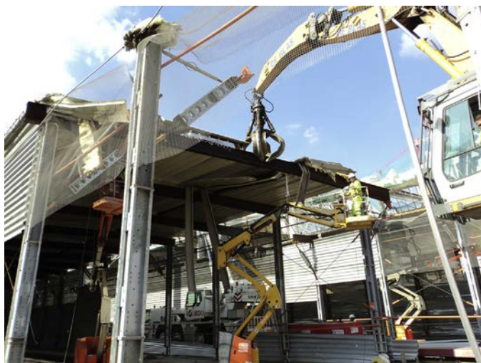
Figura 44. Demolición de los túneles provisionales.
