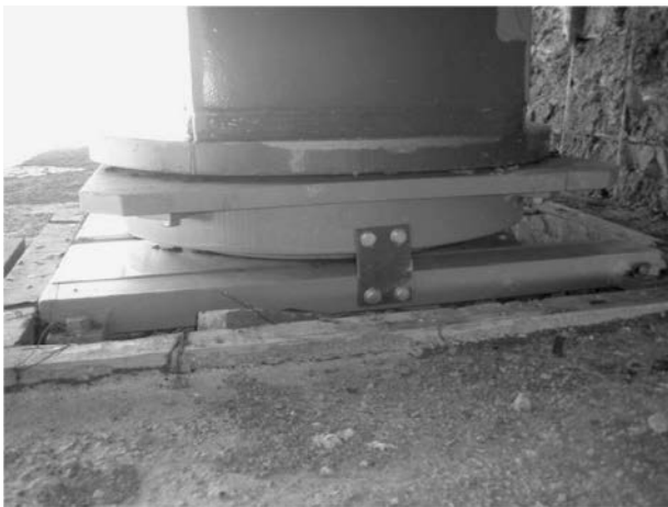
Figura 42. Aparatos de apoyo tipo POT. Puede observarse que, contrariamente a lo habitual, la placa de deslizamiento se dispuso debajo del apoyo para facilitar el centrado del apoyo en la pata metálica.
