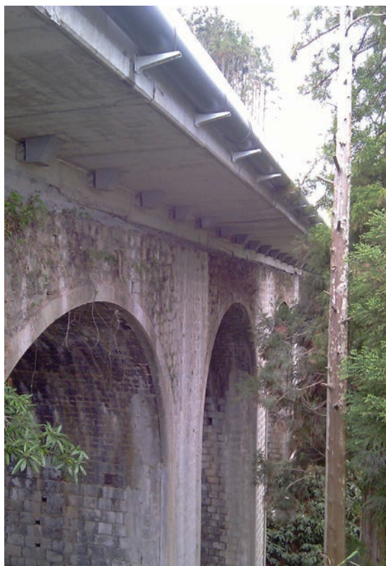
Figura 17. Vista parcial de la estructura terminada.
