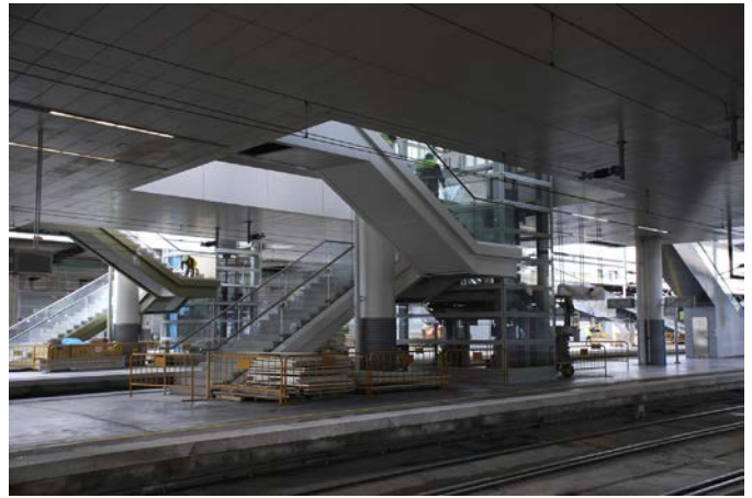
Figura 6. Escalera de acceso.
