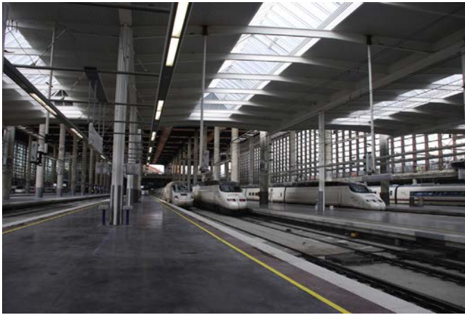
Figura 4. Cubierta baja norte.
