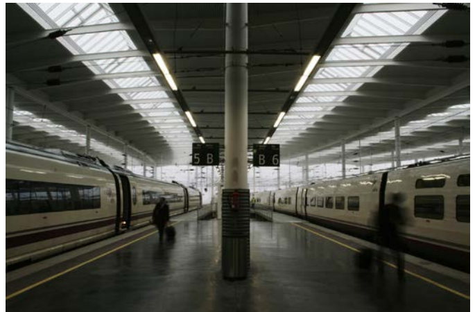
Figura 56. Aspecto terminado de marquesinas bajas.
