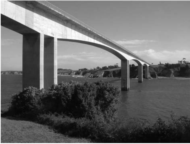
Figura 3. Fotografía previa a la ampliación del puente de Los Santos.
