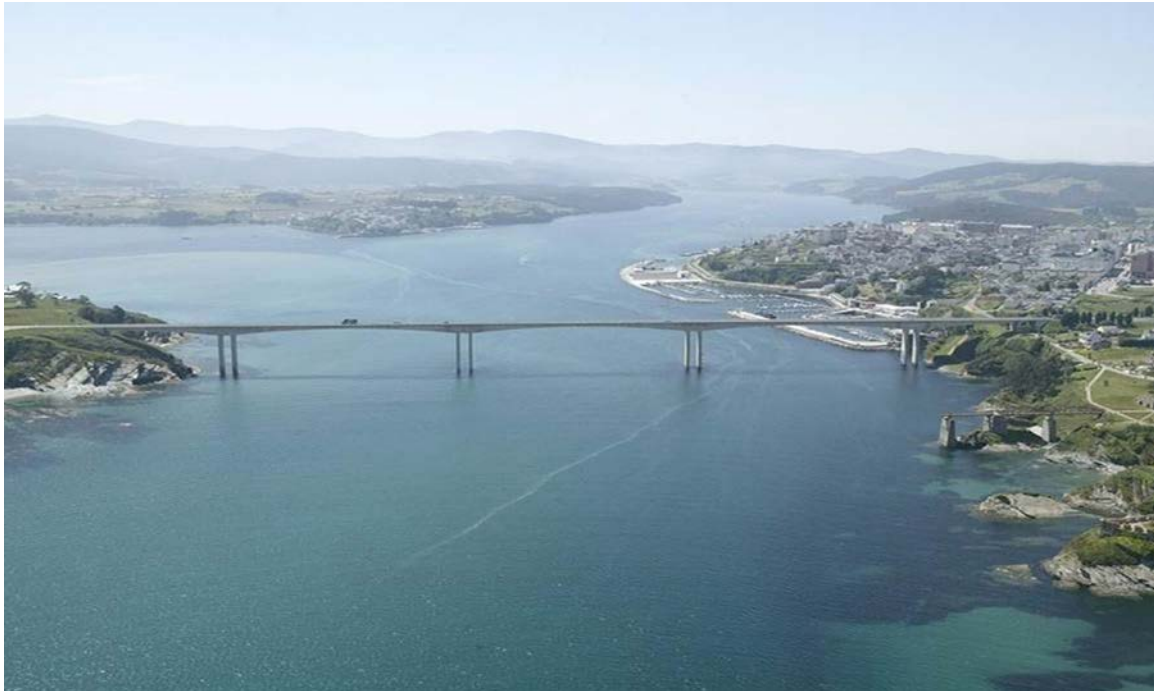
Figura 1. Vista general del puente de Los Santos antes del comienzo de los trabajos de ampliación.
