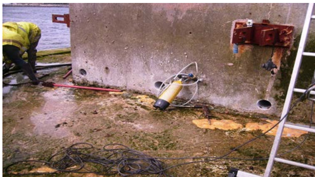
Figura 15. Refuerzo de la cimentación de las pilas laterales. Operaciones de perforación.
