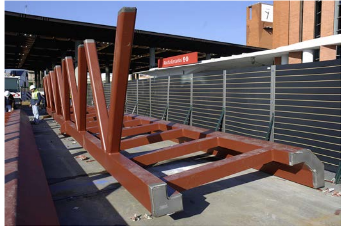
Figura 58. Módulo de cubierta a pie de obra.
