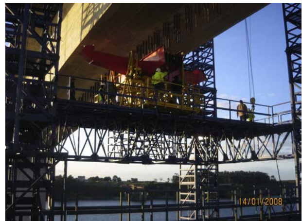
Figura 26. Colocación de un módulo en su emplazamiento definitivo.
