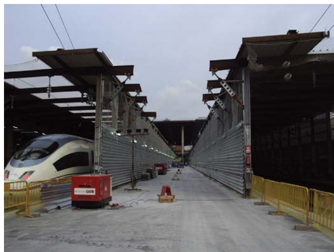
Figura 36. Túneles provisionales para la protección de vías.
