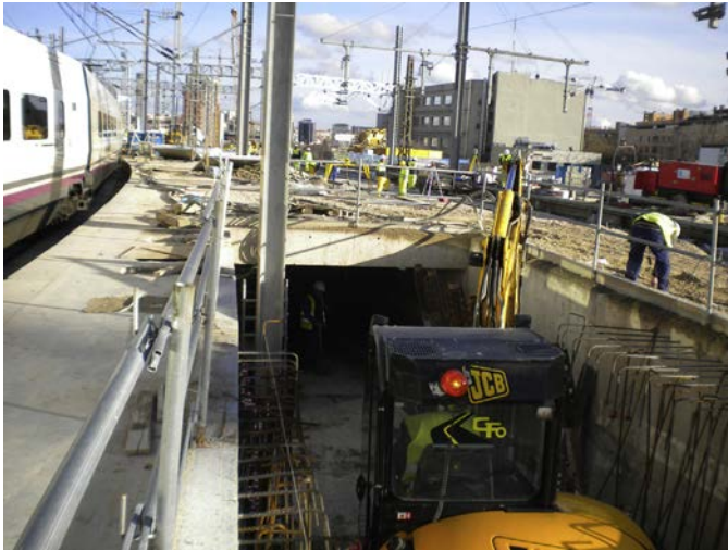
Figura 9. Rampas de catering durante la ejecución.
