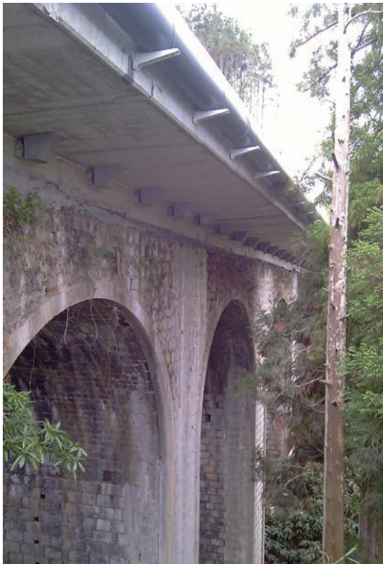
Figura 17. Vista parcial de la estructura terminada.
