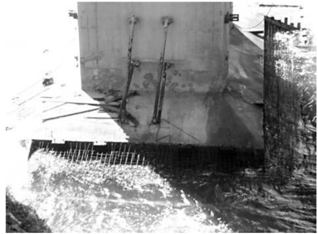
Figura 18. Construcción del zuncho perimetral de pila 4.
