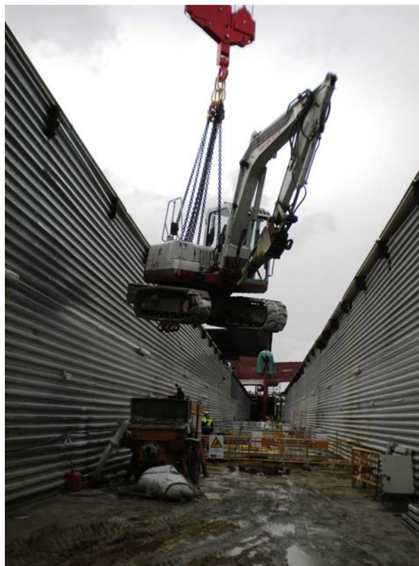
Figura 45. Acceso de maquinaria a los andenes.
