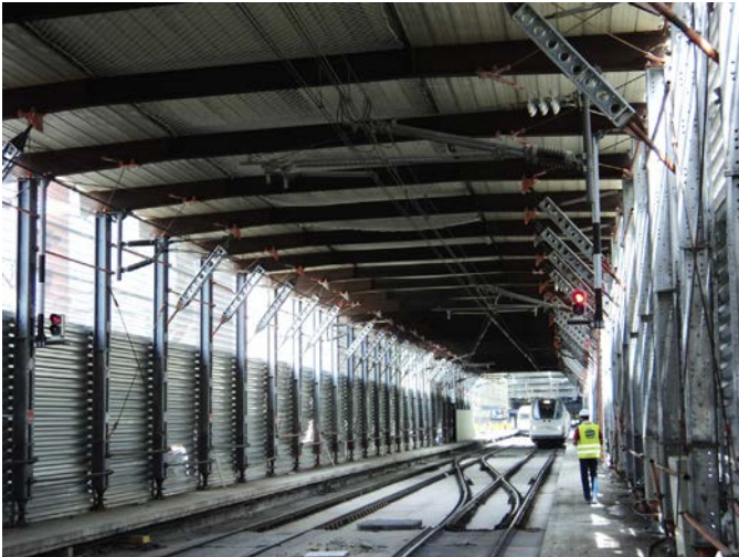
Figura 37. Vista de los túneles provisionales desde el interior.
