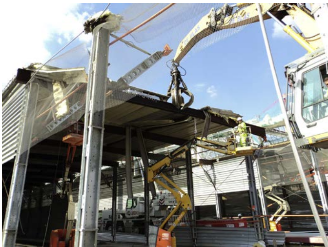
Figura 44. Demolición de los túneles provisionales.
