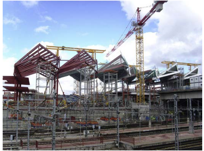
Figura 53. Torres de apeo sobre cercanías.
