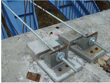
Figura 13. Viaducto principal. Tacos de sujeción en núcleo.
