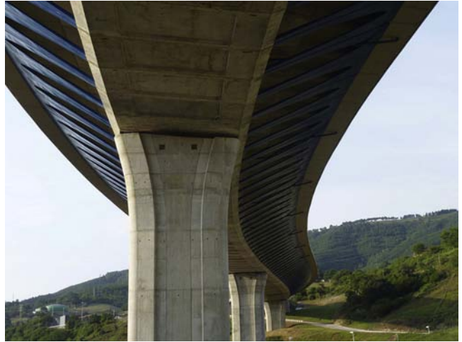
Figura 12. Viaducto principal. Vista inferior.
