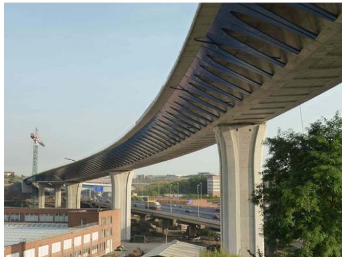
Figura 6. Vista general del viaducto principal.
