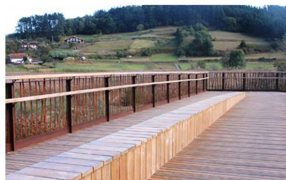
Figura 28. Vista del vano central desde el interior.
