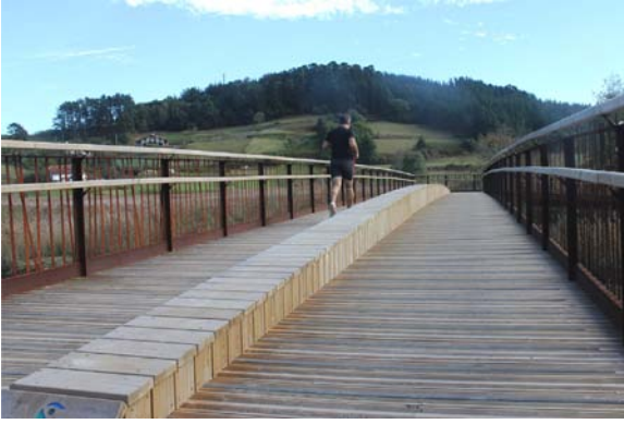
Figura 8. Un corredor atravesando la pasarela.
