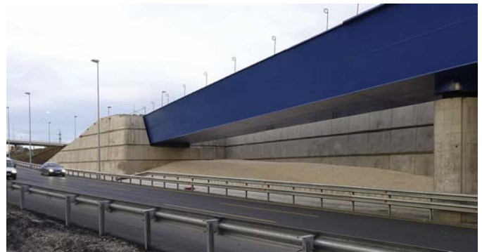
Figura 31. Vista de los estribos de los ramales de acceso.
