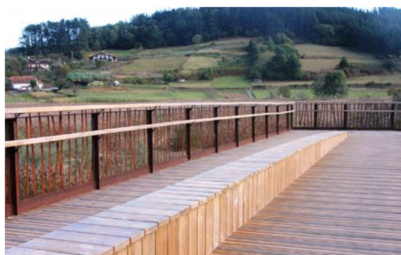
Figura 28. Vista del vano central desde el interior.
