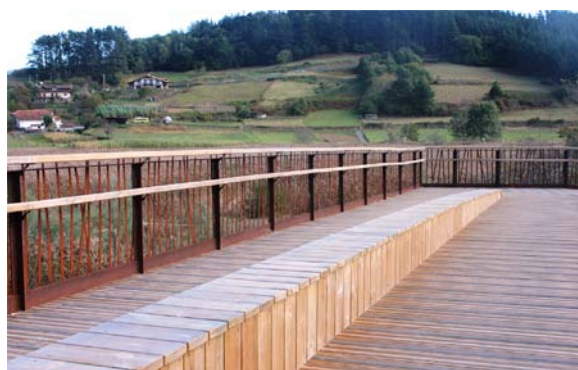
Figura 28. Vista del vano central desde el interior.
