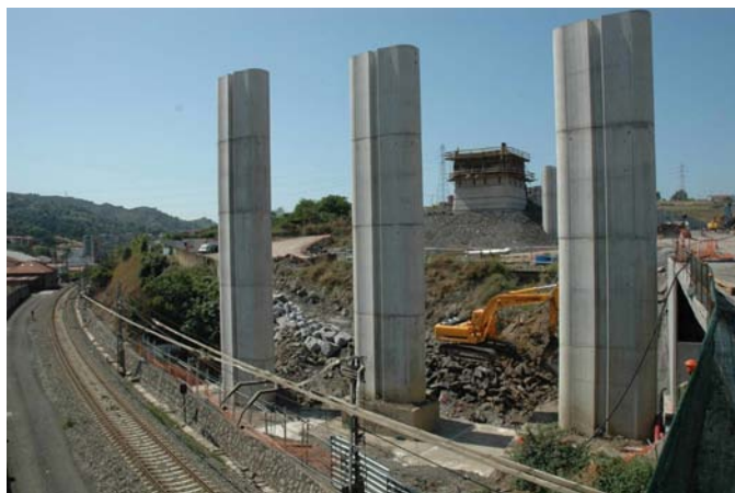
Figura 29. Pilas de la zona de transición.
