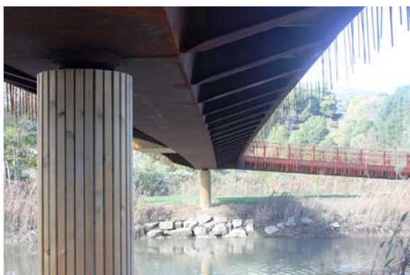
Figura 9. Vista inferior del vano central.
