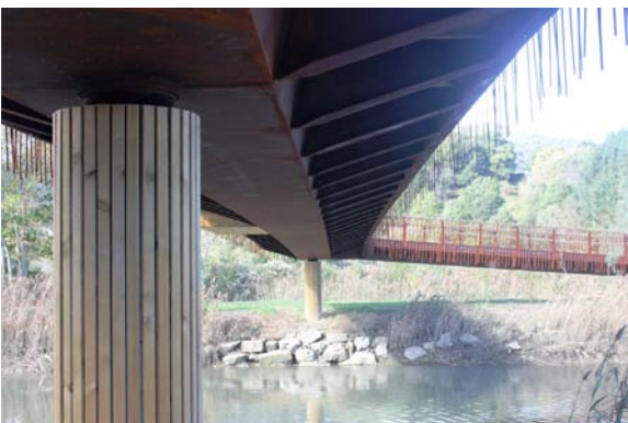
Figura 9. Vista inferior del vano central.
