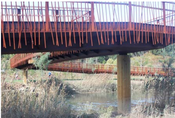
Figura 19. Vista lateral de la pasarela.
