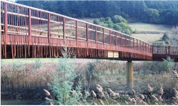
Figura 29. Vista lateral de la pasarela desde la margen izquierda.
