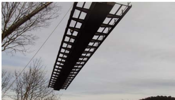
Figura 24. Izado del vano central.
