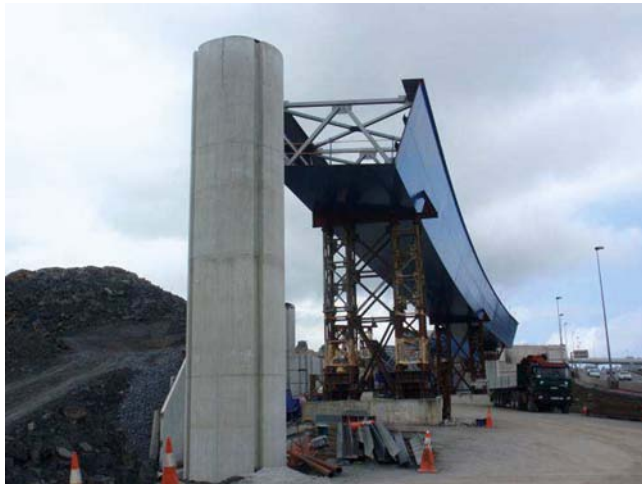
Figura 28. Pilas de los ramales de acceso.
