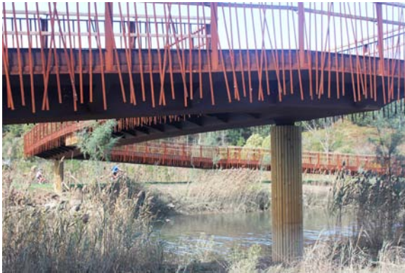
Figura 19. Vista lateral de la pasarela.
