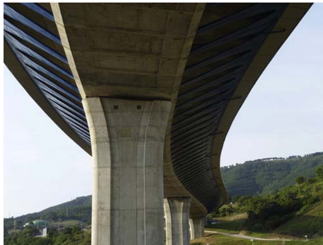
Figura 12. Viaducto principal. Vista inferior.
