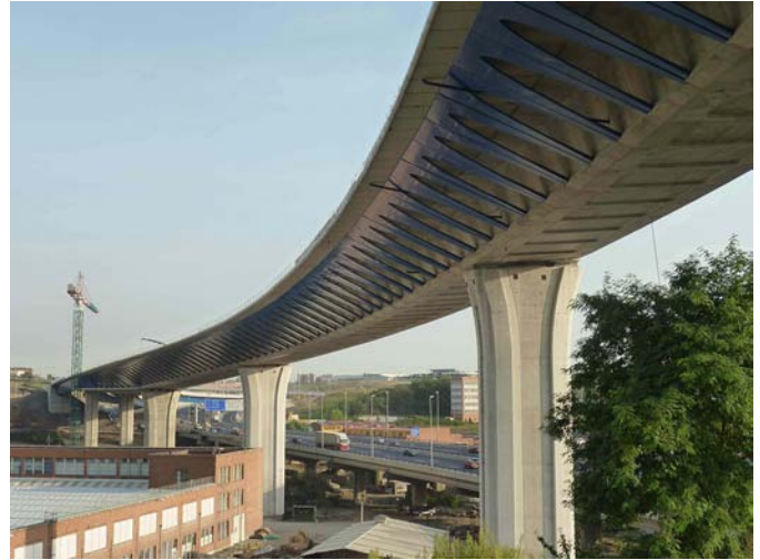
Figura 6. Vista general del viaducto principal.
