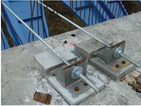
Figura 13. Viaducto principal. Tacos de sujeción en núcleo.
