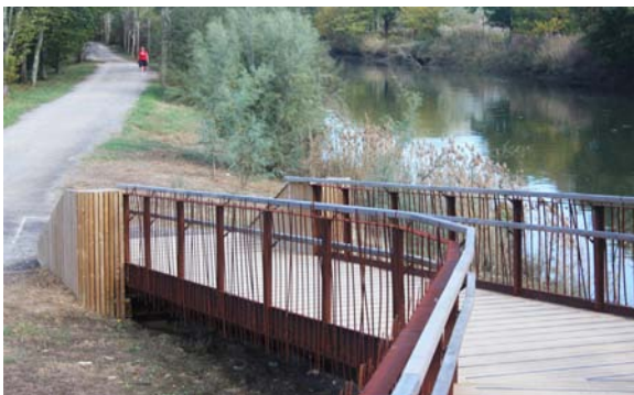
Figura 17. Acceso a la pasarela desde uno de los márgenes.
