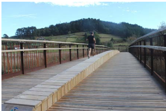
Figura 8. Un corredor atravesando la pasarela.
