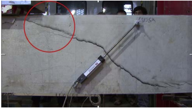
Figura 1. Fisura crítica. Con un círculo se señala la segunda rama de la fisura crítica.
