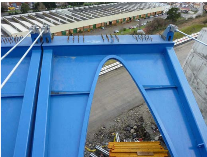
Figuras 10 y 11. Viaducto principal. Vista lateral y frontal de los jabalcones.
