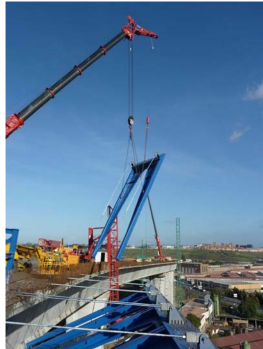
Figura 15. Viaducto principal. Montaje de jабalcones.
