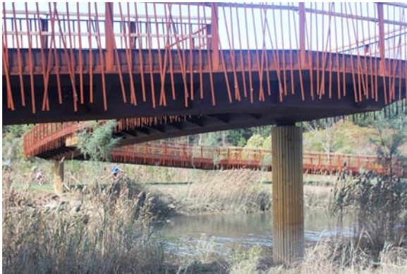
Figura 19. Vista lateral de la pasarela.
