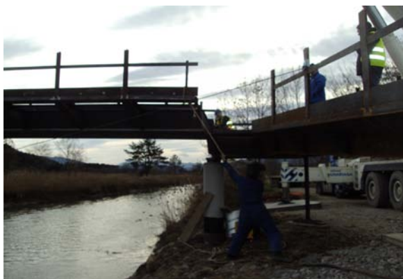
Figura 25. Colocación del vano central.
