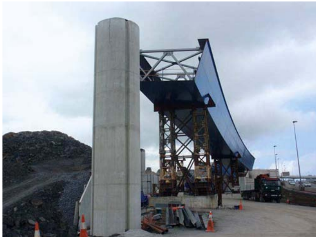
Figura 28. Pilas de los ramales de acceso.
