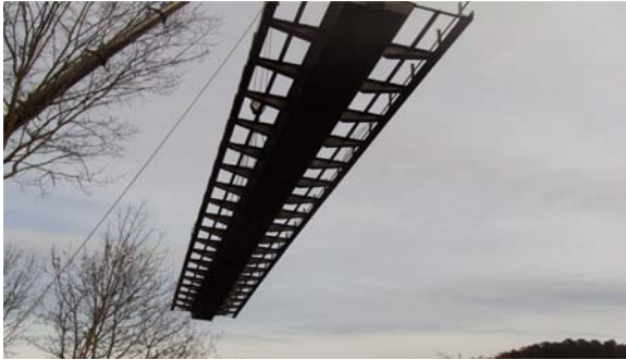
Figura 24. Izado del vano central.
