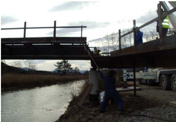
Figura 25. Colocación del vano central.
