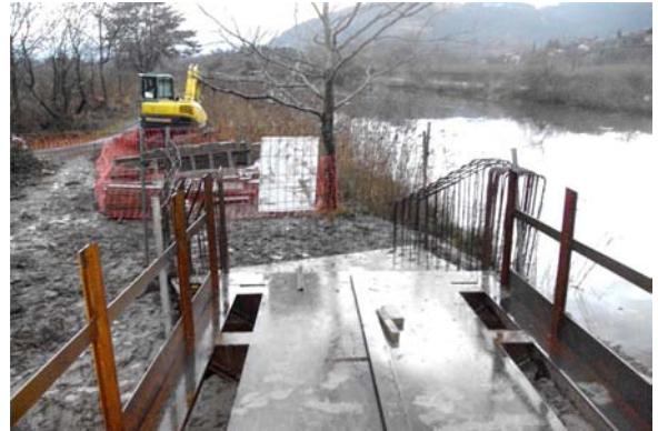
Figura 22. Preparación para hormigonado de estribos en segunda fase una vez colocado el primer vano.
