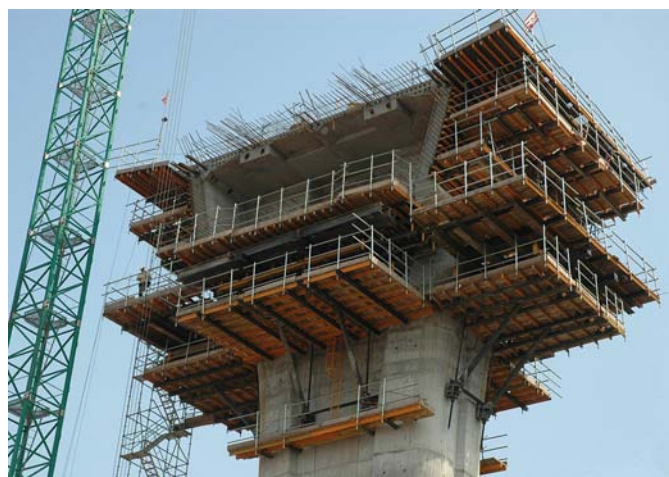
Figura 8. Plataformas de trabajo de dovela cero.
