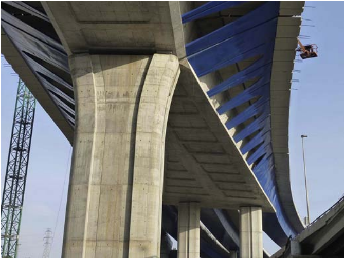
Figura 23. Vista inferior de la zona de transición.
