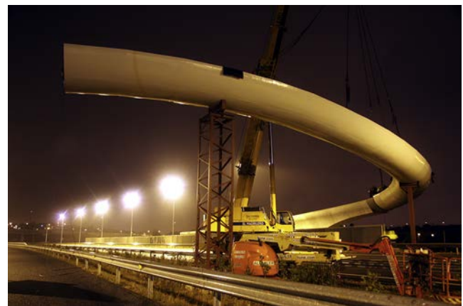
Figura 17. Colocación del tercer tramo metálico en estribo 2 [1].
