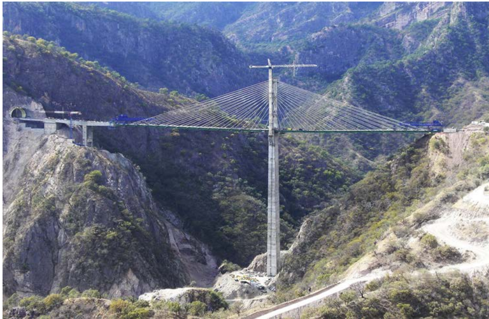
Figura 2. Vista general del puente y su entorno.
