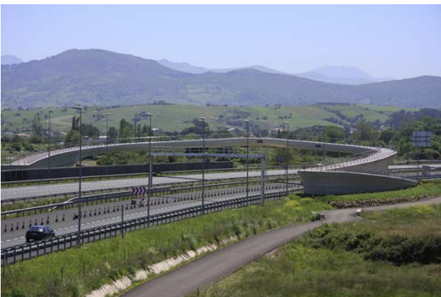
Figura 21. Vista dorsal de pasarela tras hormigonado de losa superior.
