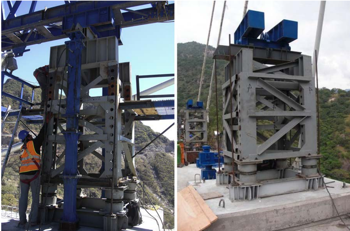
Figura 11. Apoyo telescópico de lanzadora durante cambio de cota. Apoyo cerrado.
