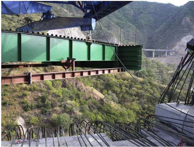
Figura 18. Dóvela con escantillón, orejetas y balancines.
