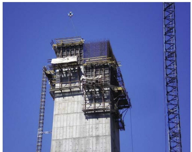
Figura 25. Encofrado trepante convencional en pilas 2, 3 y 5.
