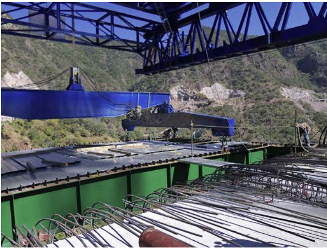
Figura 10. Balancines. Dispositivos para compensación de excentricidad de carga colgada.
