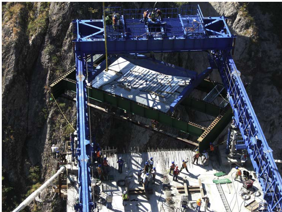
Figura 12. Giro de dovela en voladizo.
