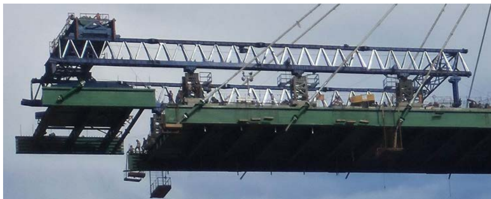
Figura 16. Disposición de apoyos de lanzadora sobre tablero.
