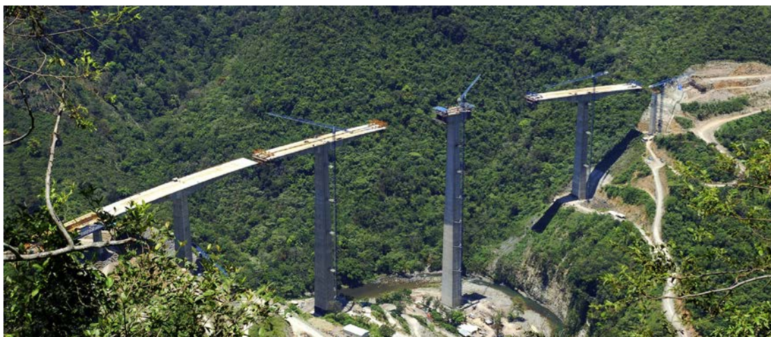
Figura 29. Trabajo simultáneo con 3 parejas de carros.
