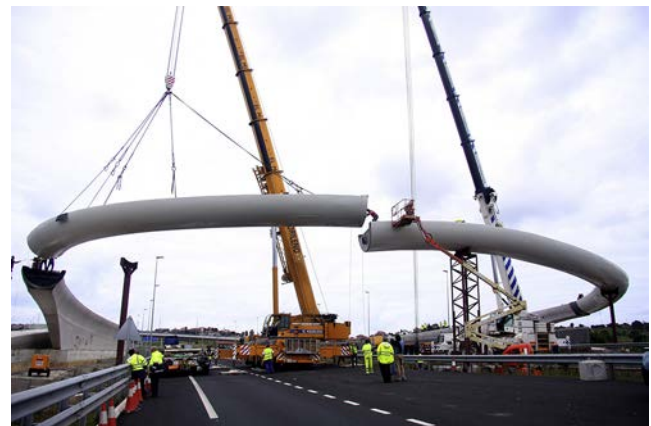
Figura 18. Colocación del cuarto tramo metálico mediante grúa en estribo 1 [1].
