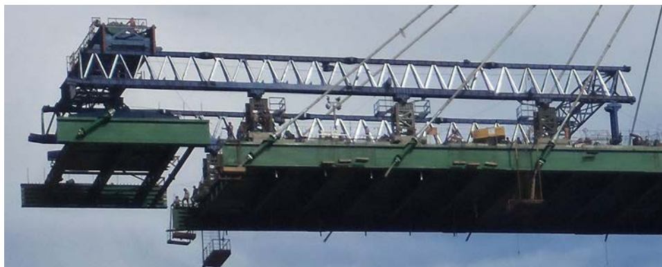
Figura 16. Disposición de apoyos de lanzadora sobre tablero.
