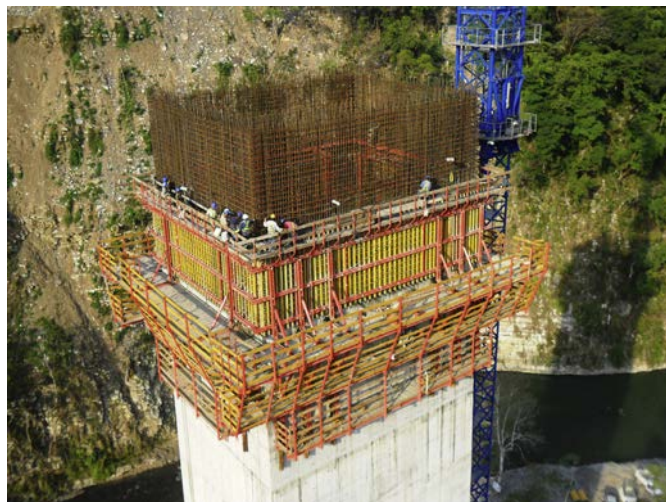
Figura 26. Encofrado autotrepante en pila 4.
