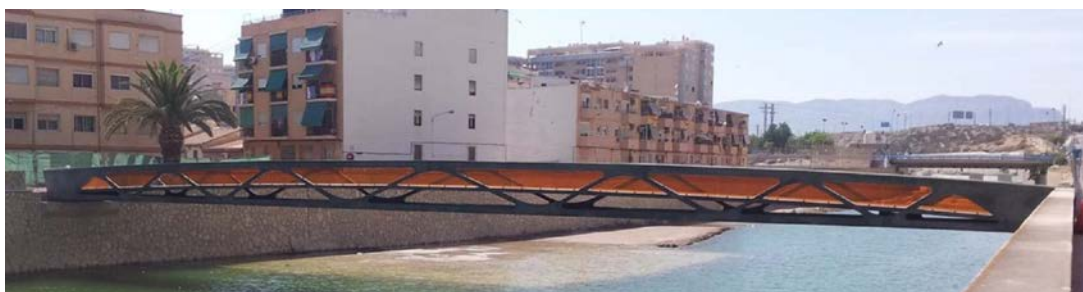
Figura 33. Pasarela de HMAR sobre el Barranco de las Ovejas.
