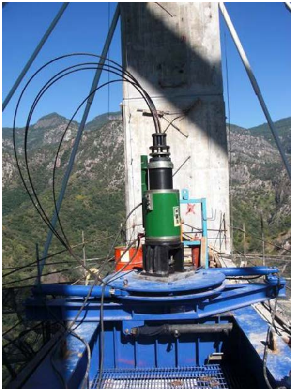
Figura 13. Mesa de giro con gato tragacables.
