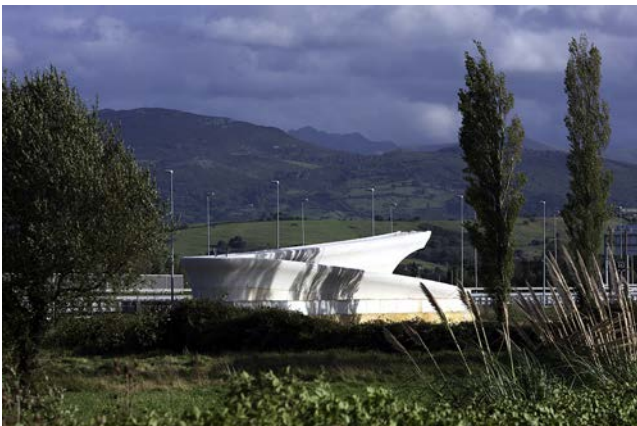
Figura 15. Vista de estribo 1 ejecutado.
