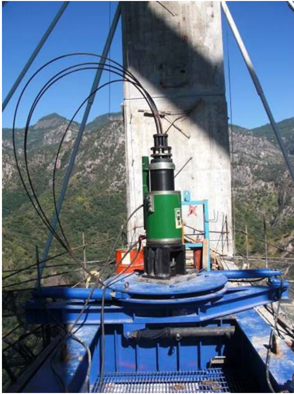
Figura 13. Mesa de giro con gato tragacables.
