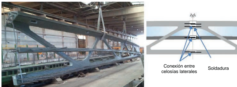
Figura 24. Transporte de una mitad de la celosía lateral (izquierda); conexión de ambas celosías (derecha).
