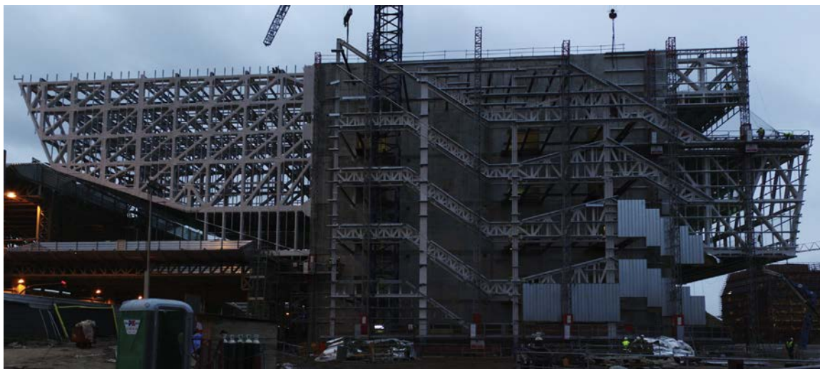
Figura 4. Vista general del bloque 2 en construcción.
