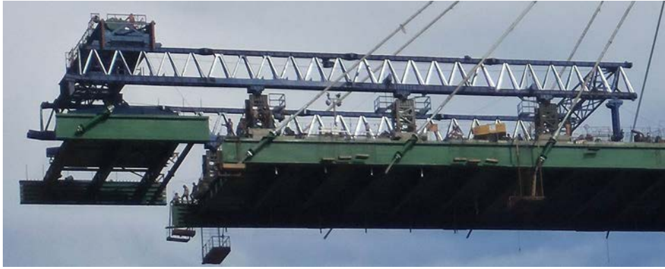
Figura 16. Disposición de apoyos de lanzadora sobre tablero.
