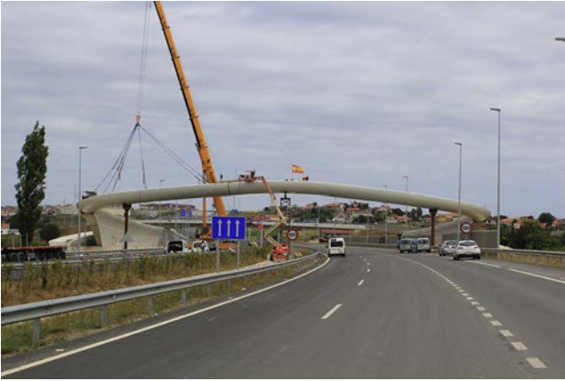
Figura 19. Vista frontal de viga balcón apoyada sobre torres provisionales.
