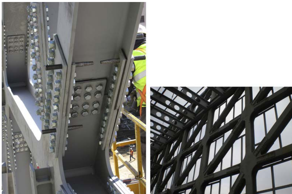
Figura 8. Acoplamiento de las uniones atornilladas y situación final de las mismas.
