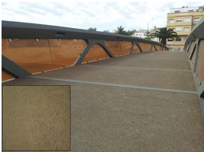
Figura 29. Textura de las losas superficiales.
