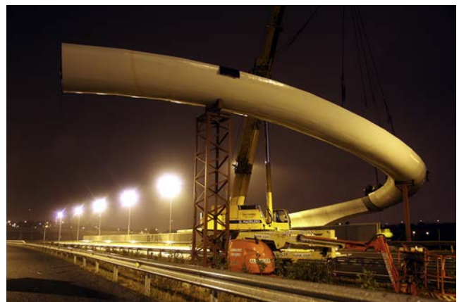
Figura 17. Colocación del tercer tramo metálico en estribo 2 [1].
