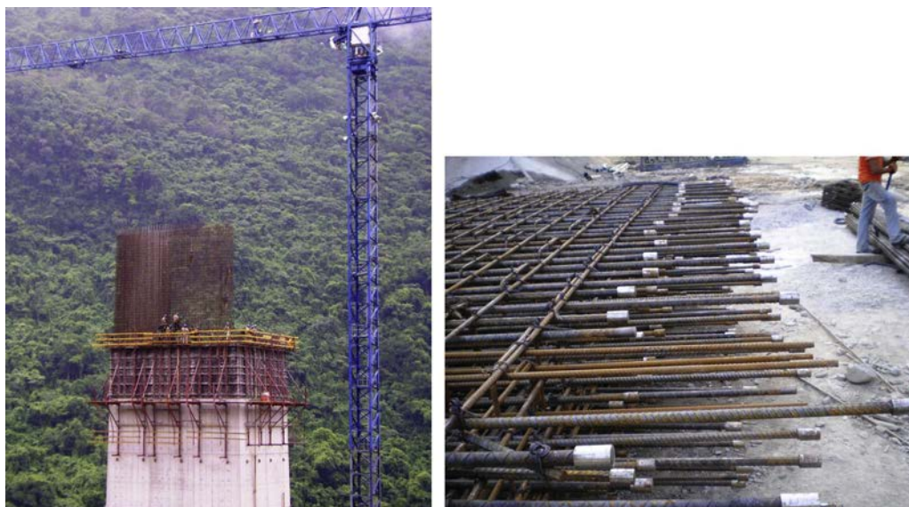
Figura 24. Premontaje de la armadura de las pilas.
