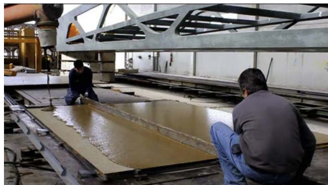
Figura 27. Fabricación de las losas con HMAR ocre.
