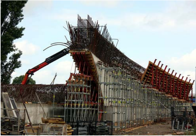
Figura 14. Vista de armadura de espera, encofrado y cimbra en estribo 1.
