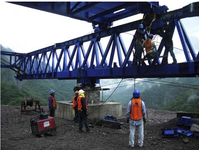
Figura 7. Pruebas de carga y funcionamiento de lanzadora completa a pie de pila.
