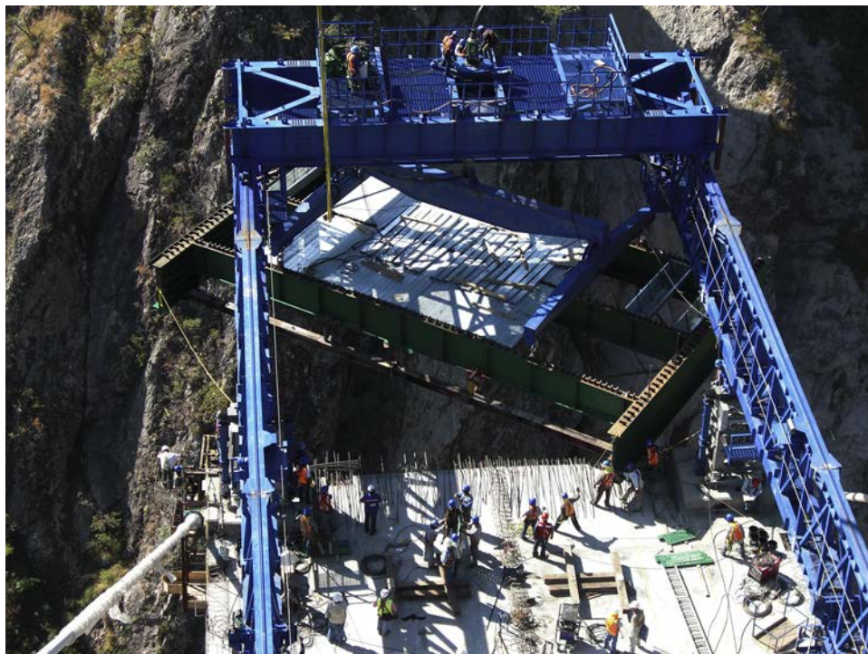
Figura 12. Giro de dovela en voladizo.
