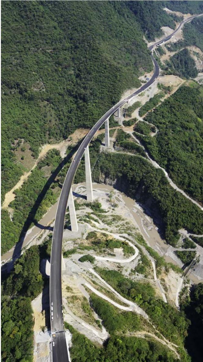
Figura 3. Vista general del puente.
