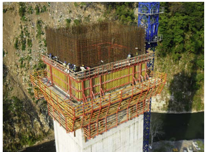
Figura 26. Encofrado autotrepante en pila 4.
