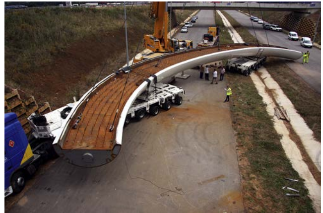
Figura 16. Colocación de un tramo metálico de viga balcón sobre dolly.
