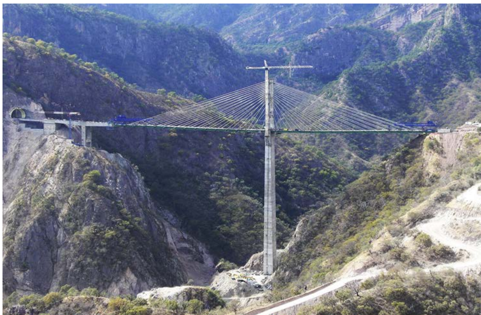
Figura 2. Vista general del puente y su entorno.
