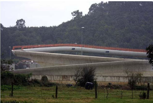
Figura 20. Vista lateral de pasarela.
