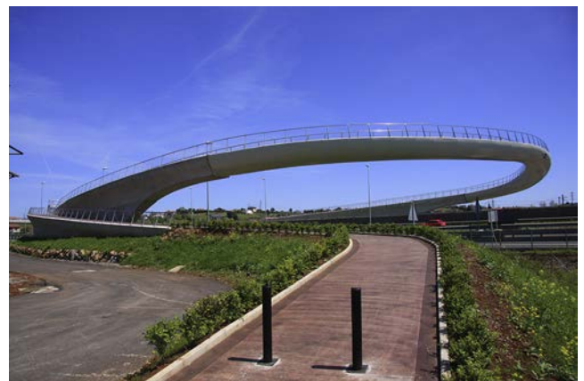
Figura 23. Vista lateral de pasarela desde estribo 1 [1].
