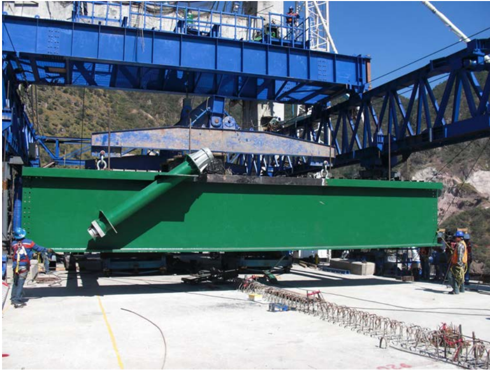
Figura 9. Dovela en elevación. Balancín con punto de cuelgue excéntrico.
