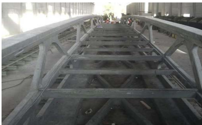
Figura 26. Pasarela tras la finalización de la cuarta fase de hormigonado.
