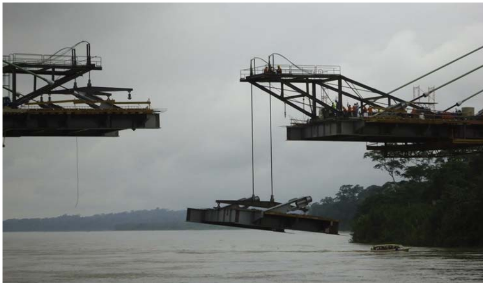
Figura 3. Construcción de tablero de dovelas con carro en voladizo (puente sobre el río Napo, Ecuador).
