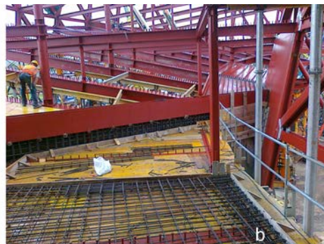
Figura 19. Refuerzo de chapa en el forjado de fondo. Imagen de la modelización 3D (a) y fotografía de la ejecución (b).
