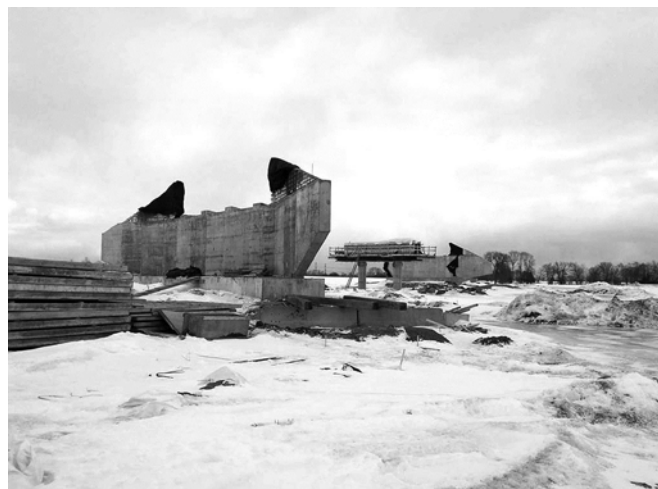
Figura 17. Estribo semintegral.
