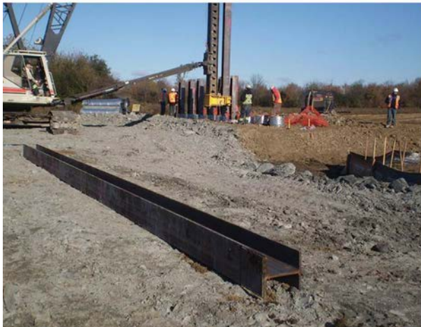
Figura 15. Hincia de pilotes metálicos.
