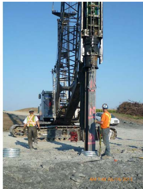
Figura 15. Hincia de pilotes metálicos.
