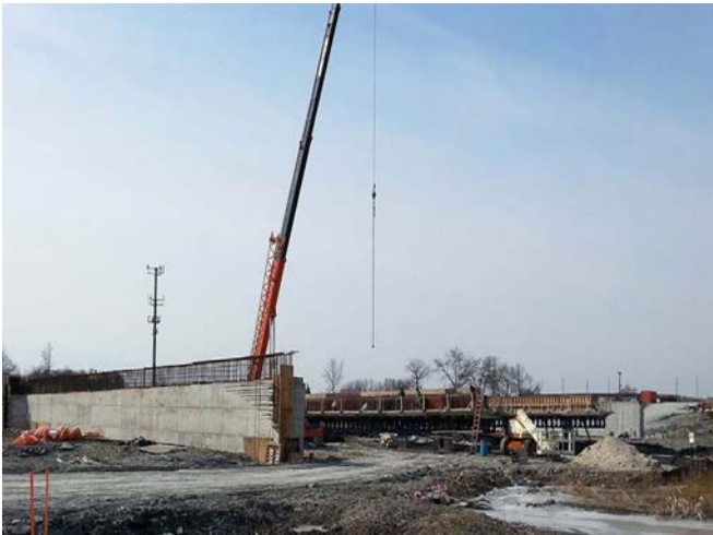
Figura 2. Construcción de estribo W6.
