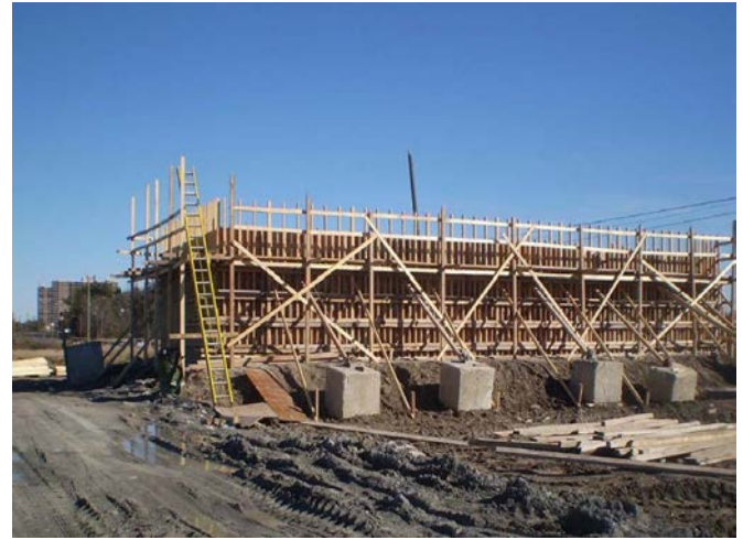
Figura 4. Encofrado de estribo este W12.
