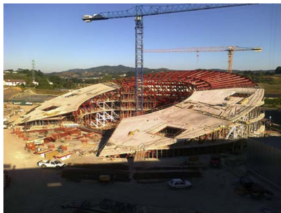
Figura 11. Ejecución del forjado de cubierta.
