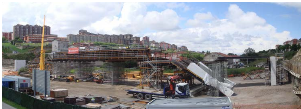
Figura 14. Vista de la cimbra porticada de cajón central de tablero y pies inclinados.
