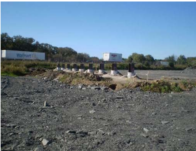
Figura 3. Cimentación de estribo W10.
