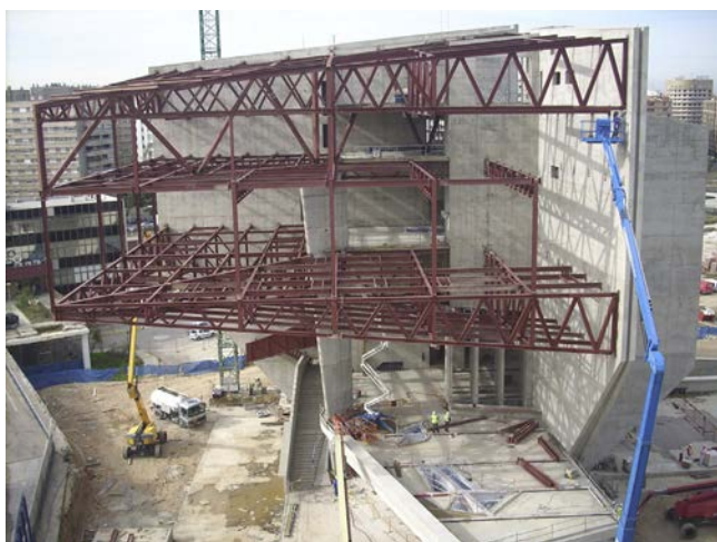
Figura 13. Vista de la viga diagonal VD.
