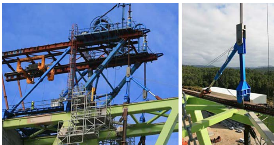
Figura 35. Izado de una dovela desde carro fijo y detalles de balancín de ajuste.
