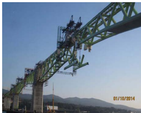
Figura 43. Izado de dovela de cierre del vano 8.
