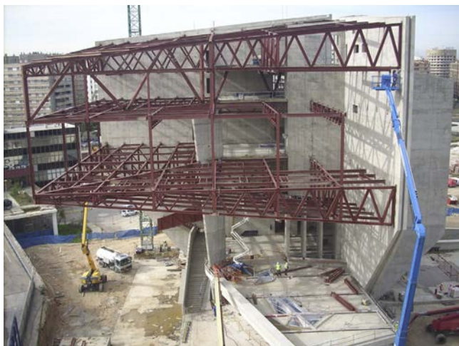
Figura 13. Vista de la viga diagonal VD.
