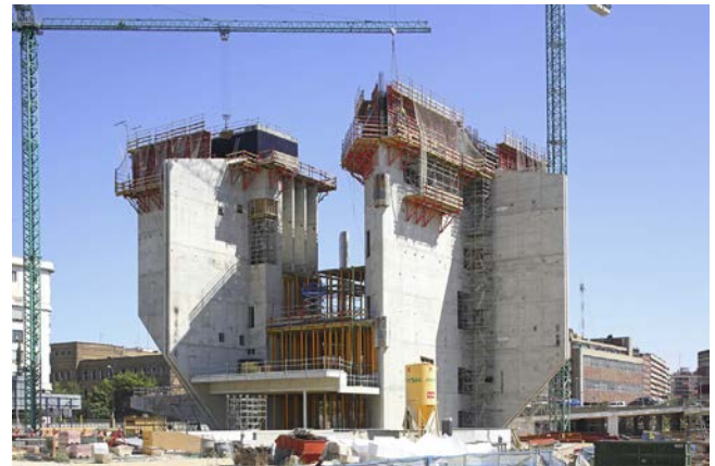
Figura 16. Encofrado trepante.
