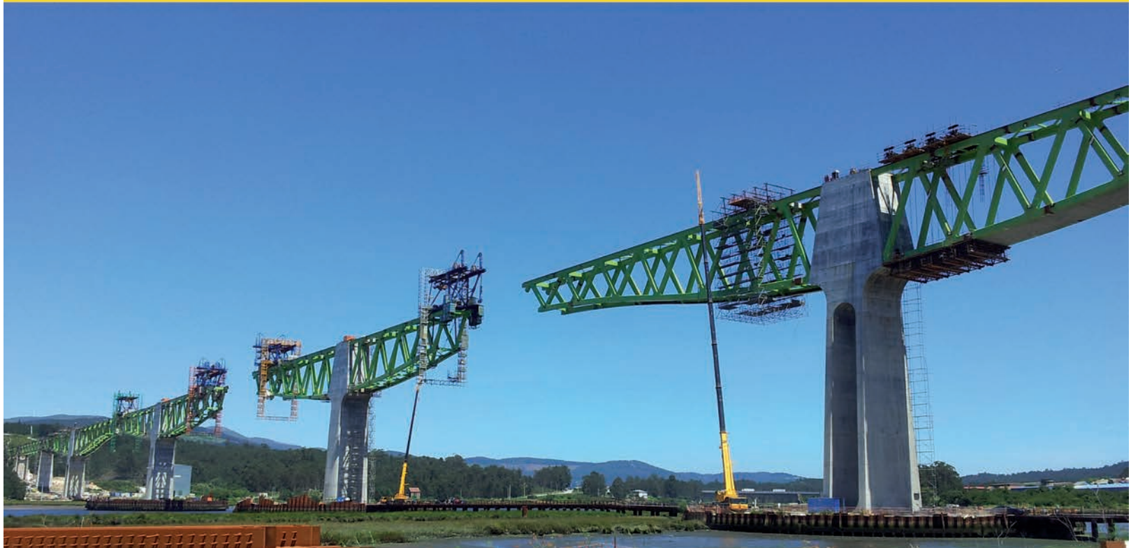
Viaducto sobre el río Ulla ▲
