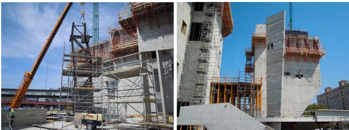
Figura 12. Montaje de la celosía metálica en el pilar mixto fusiforme. Vista del pilar hormigonado.
