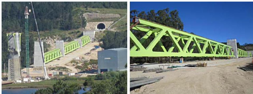
Figura 26. Tramos de los vanos 10 a 12 ejecutados en el suelo preparados para su izado.
