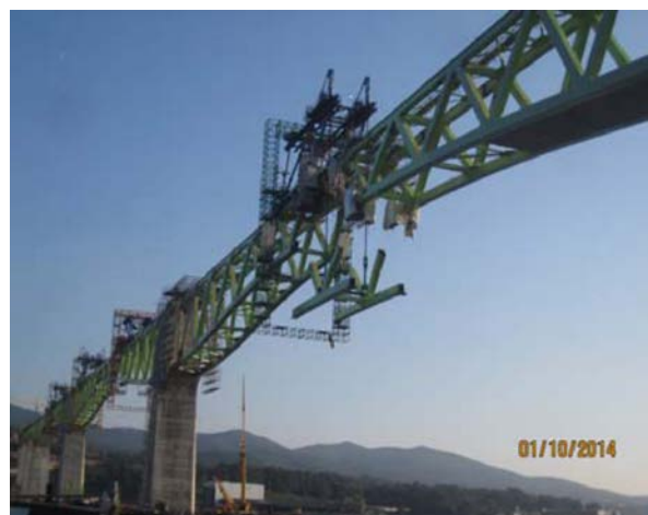
Figura 43. Izado de dovela de cierre del vano 8.
