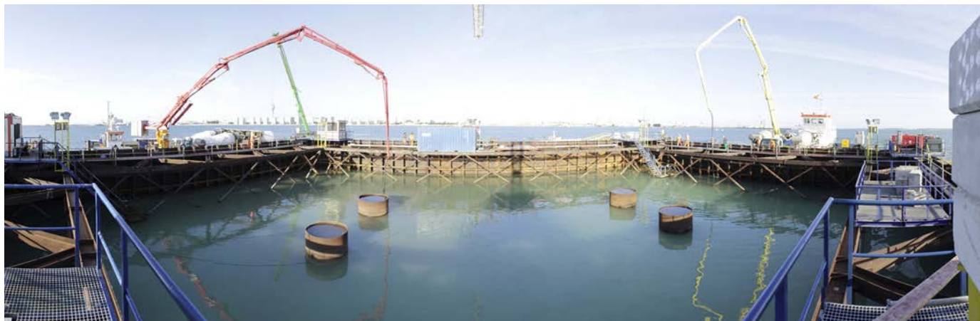
Figura 1. Hormigonado de losa sumergida en el nuevo puente sobre la bahía de Cádiz.
