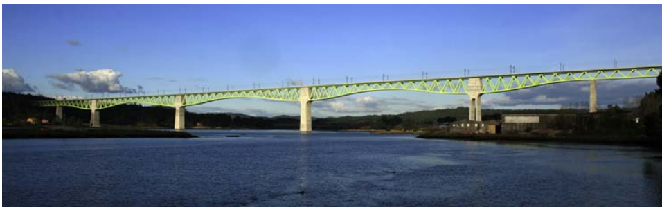
Figura 47. Vista del viaducto concluido.
