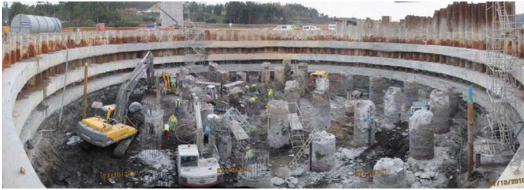
Figura 9. Descabezado de pilotes de la cimentación de P-5.
