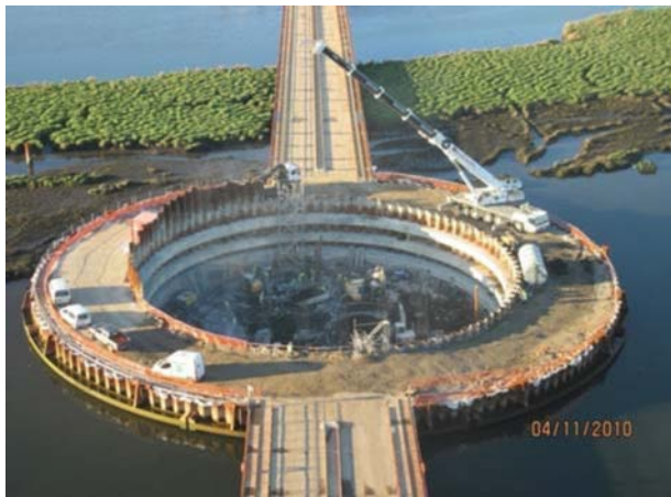
Figura 8. Excavación del interior del recinto de P-5.
