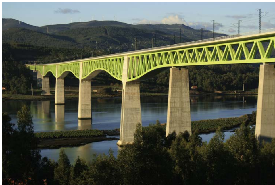
Figura 48. Vista lateral del viaducto concluido.
