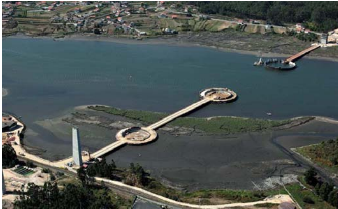
Figura 5. Vista del pantalán y los recintos de las cimentaciones de las pilas P-5, P-6 y P-7 en el cauce.
