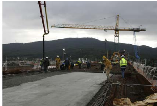
Figura 46. Colocación de prelas de todo el ancho en el tablero y hormigonado de losa superior.
