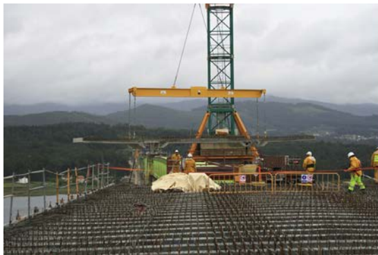
Figura 46. Colocación de prelas de todo el ancho en el tablero y hormigonado de losa superior.
