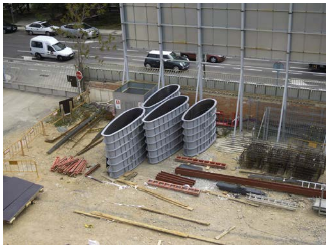
Figura 11. Encofrado metálico del pilar fusiforme.
