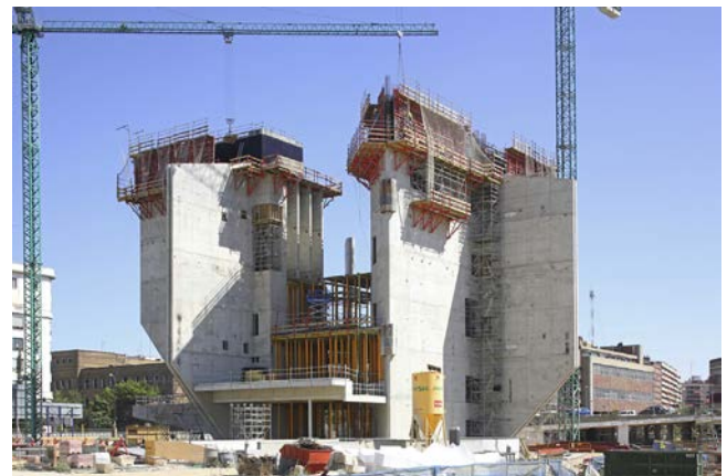
Figura 16. Encofrado trepante.
