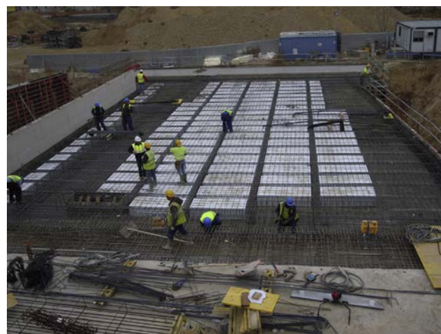
Figura 6. Montaje de aligeramientos en losa sándwich de cubierta del auditorio.
