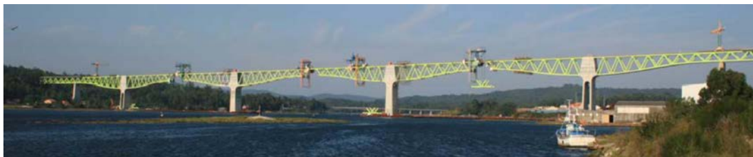
Figura 42. Izado de dovela de cierre del vano 6.
