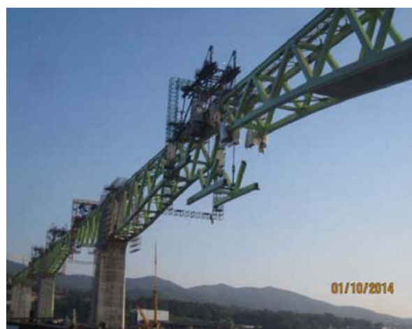
Figura 43. Izado de dovela de cierre del vano 8.
