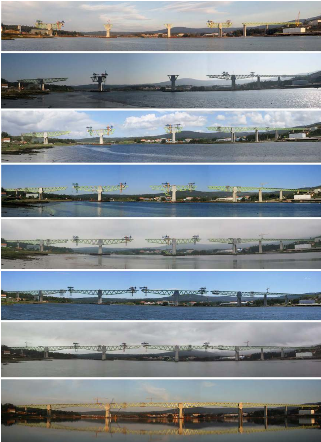
Figura 39. Avance por voladizos sucesivos desde P-5 (a la derecha) y P-8(a la izquierda) y posteriormente desde P-6 y P-7.
