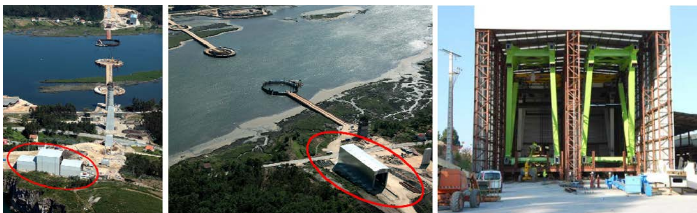
Figura 14. Talleres de obra para ensamblaje de dovelas.
