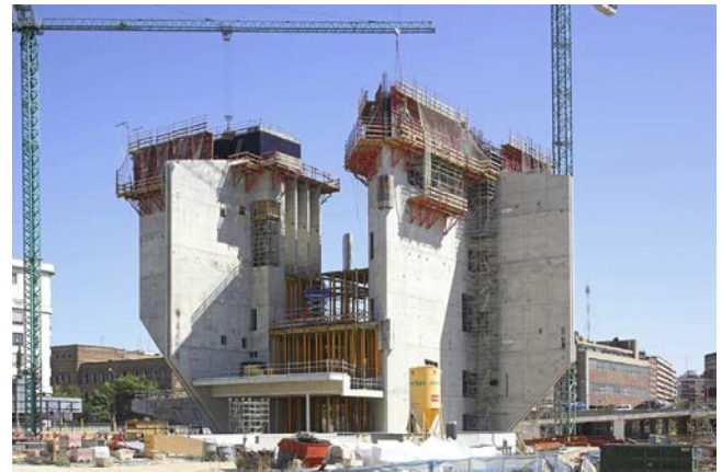
Figura 16. Encofrado trepante.
