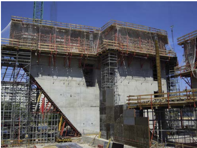
Figura 15. Cimbra de arranque de los muros en L.
