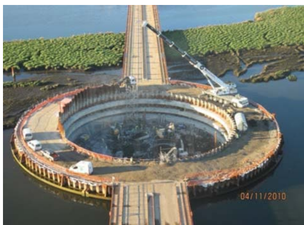
Figura 8. Excavación del interior del recinto de P-5.
