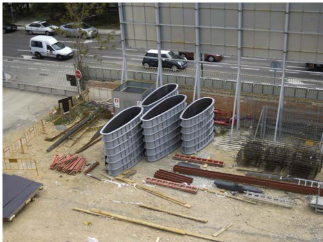
Figura 11. Encofrado metálico del pilar fusiforme.
