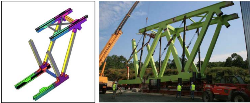
Figura 33. Despiece de elementos de una dovela e imagen de 2 dovelas montadas en blanco.
