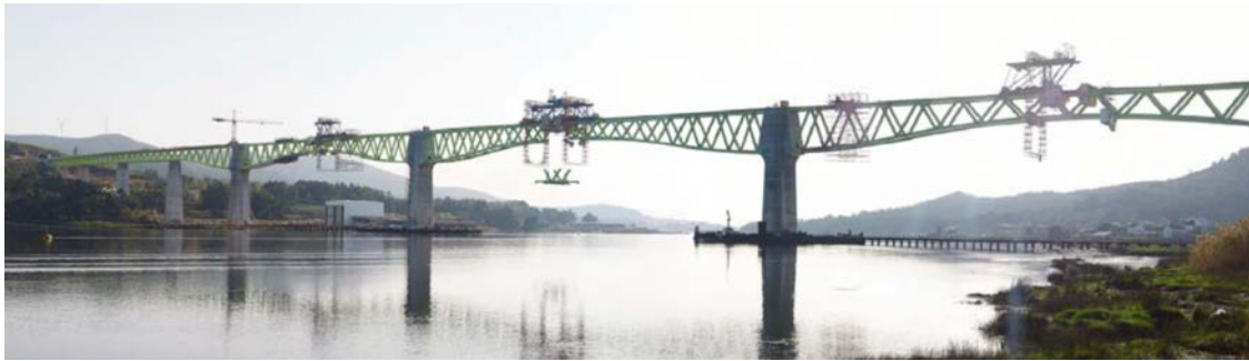
Figura 44. Izado de dovela de cierre del vano 7.
