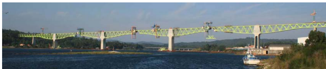
Figura 42. Izado de dovela de cierre del vano 6.
