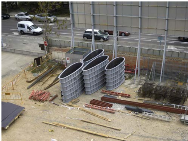
Figura 11. Encofrado metálico del pilar fusiforme.
