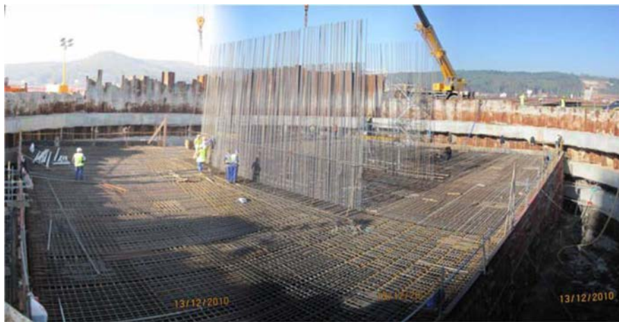
Figura 10. Vista de la ferralla del encepado de P-5 (30 × 24,5 × 4,5 m).
