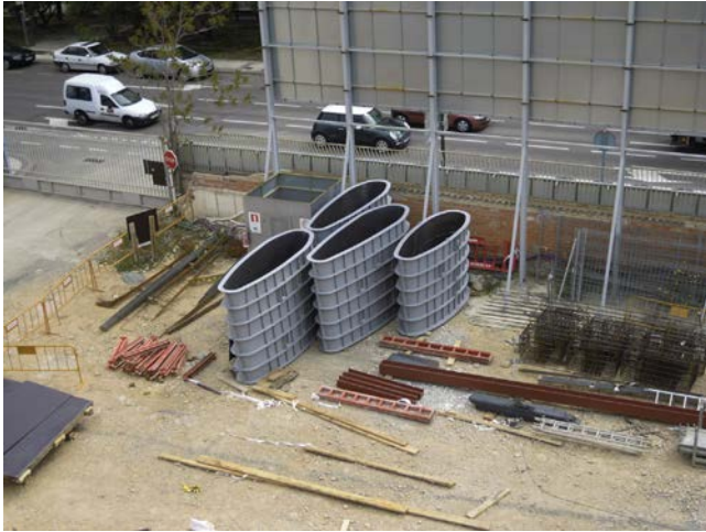
Figura 11. Encofrado metálico del pilar fusiforme.
