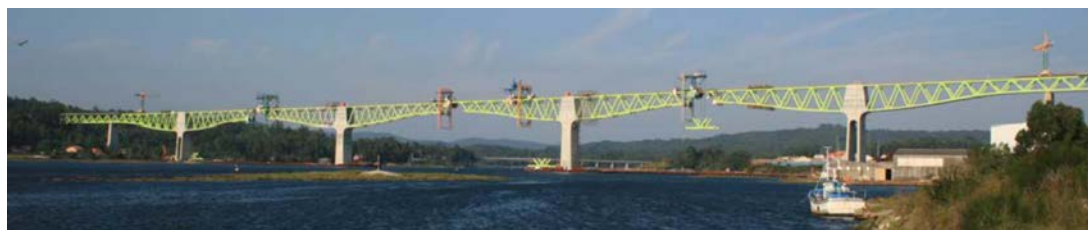
Figura 42. Izado de dovela de cierre del vano 6.
