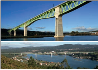
Foto de portada: Viaducto del río Ulla | Galicia
