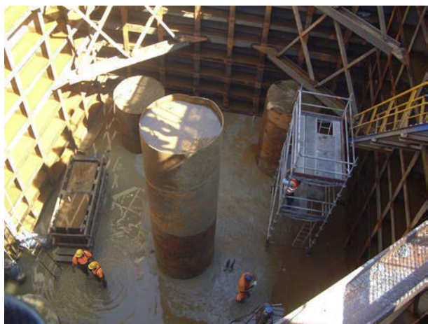
Figura 8. Recinto tras achicado, antes de descabezar pilotes.
