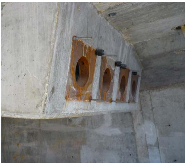
Figura 12. Anclajes pretensado en segunda fase.
