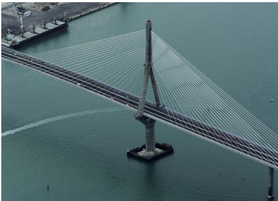
Figura 30. Vista final de la torre.
