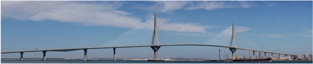
Figura 1. Vista panorámica del Puente de la Constitución de 1812.
