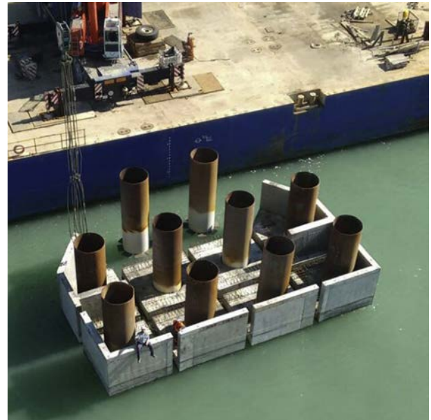
Figura 7. Colocación de elementos prefabricados.
