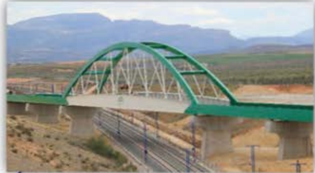
Viaducto de Santa Ana sobre la LAV Córdoba-Málaga Proyecto y Asistencia
