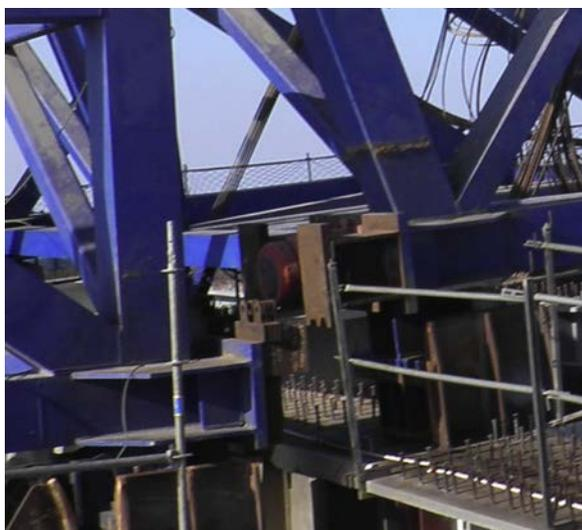
Figura 7. Pescante. Detalle gato y galgas inferiores.
