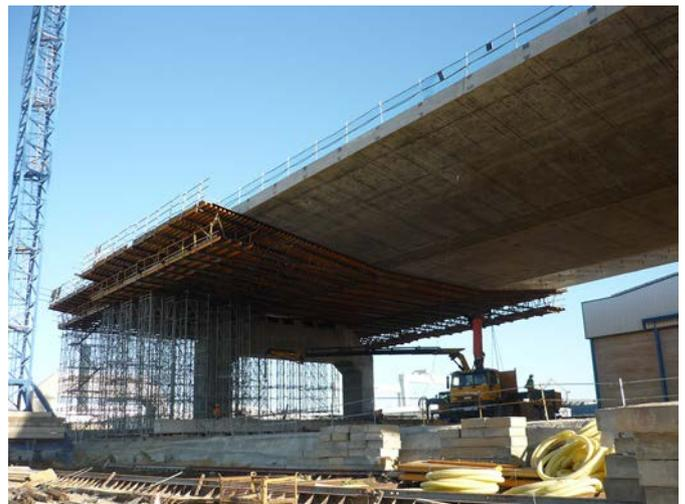
Figura 4. Descimbrando en fase de ejecución.
