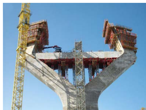
Figura 13. Desmontaje de riostra en torre de la bahía.
