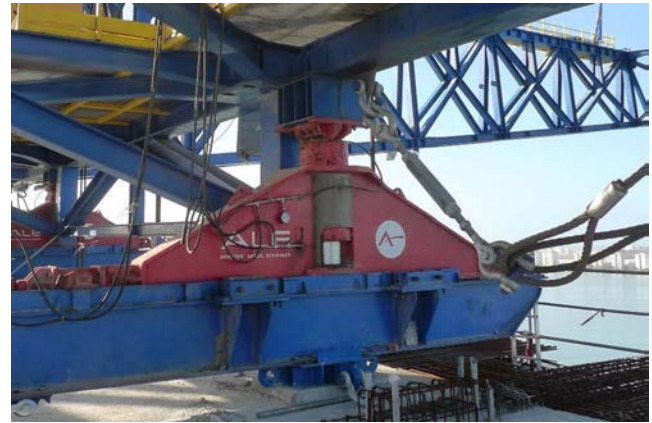
Figura 15. Patín de deslizamiento y viga carril.
