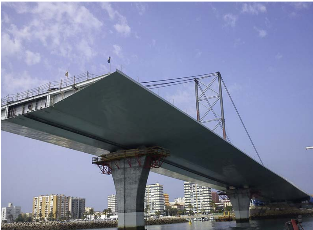
Figura 11. Vista inferior del tablero.
