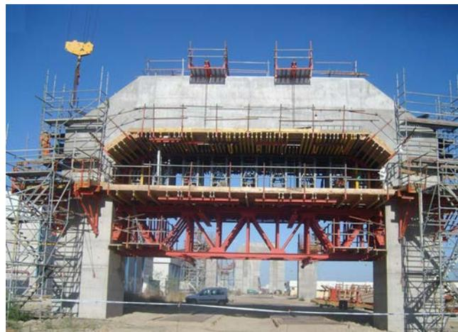
Figura 8. Construcción de pilas pórtico en tierra.
