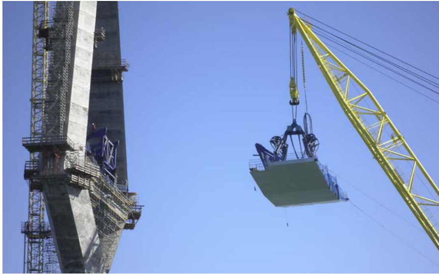
Figura 5. Aproximación con dispositivos de cuelgue en pila 12.
