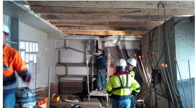
Figura 1. Unión interior de dovelas cubierta con techo. Taller situado a 70 m sobre el mar.
