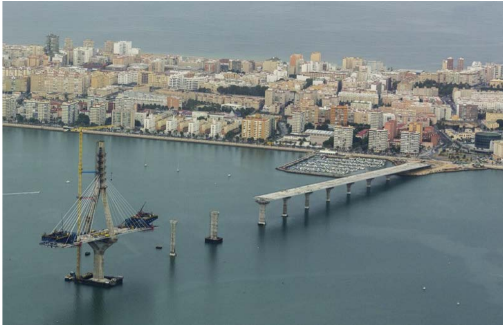
Figura 1. Vista general del tramo empujado.
