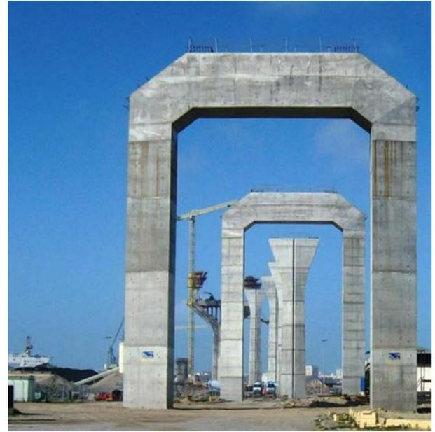
Figura 2. Pilas pórtico.
