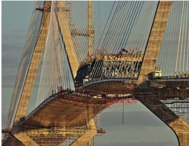
Figura 5. Vista del tablero durante la construcción.
