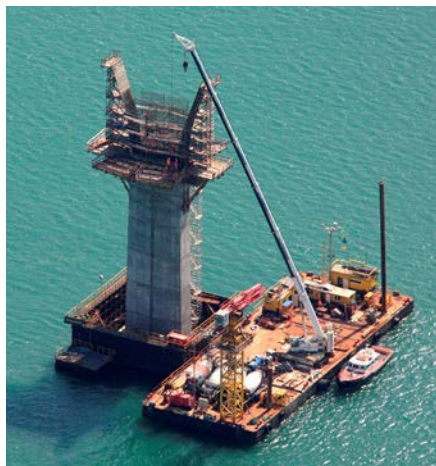
Figura 7. Construcción de pilas monofuste en mar.
