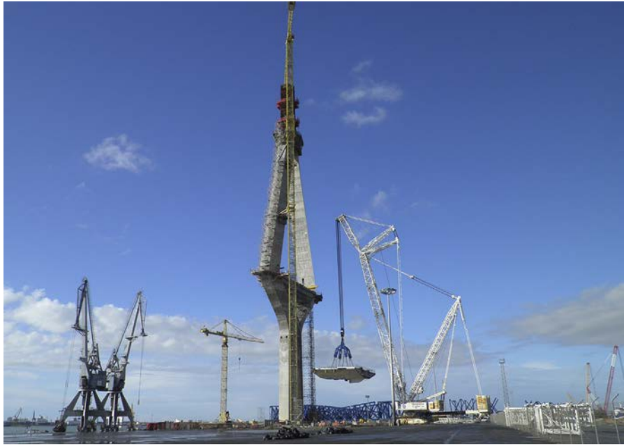
Figura 1. Izado de la dovela «0» de la pila 13.
