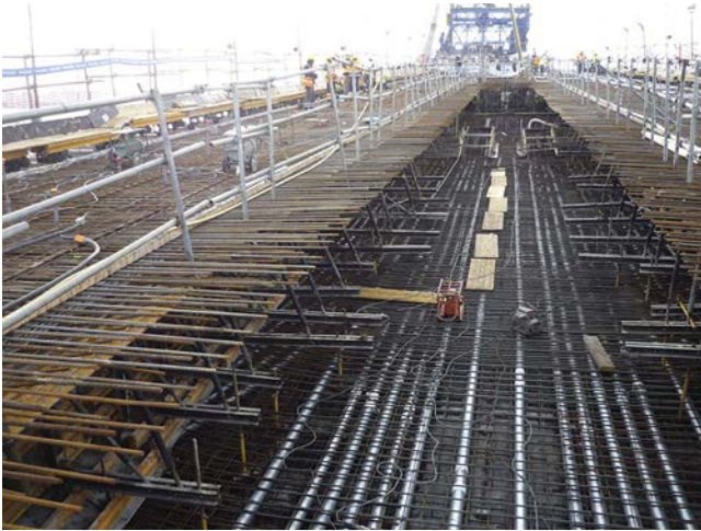
Figura 15. Detalle de ejecución del núcleo.
