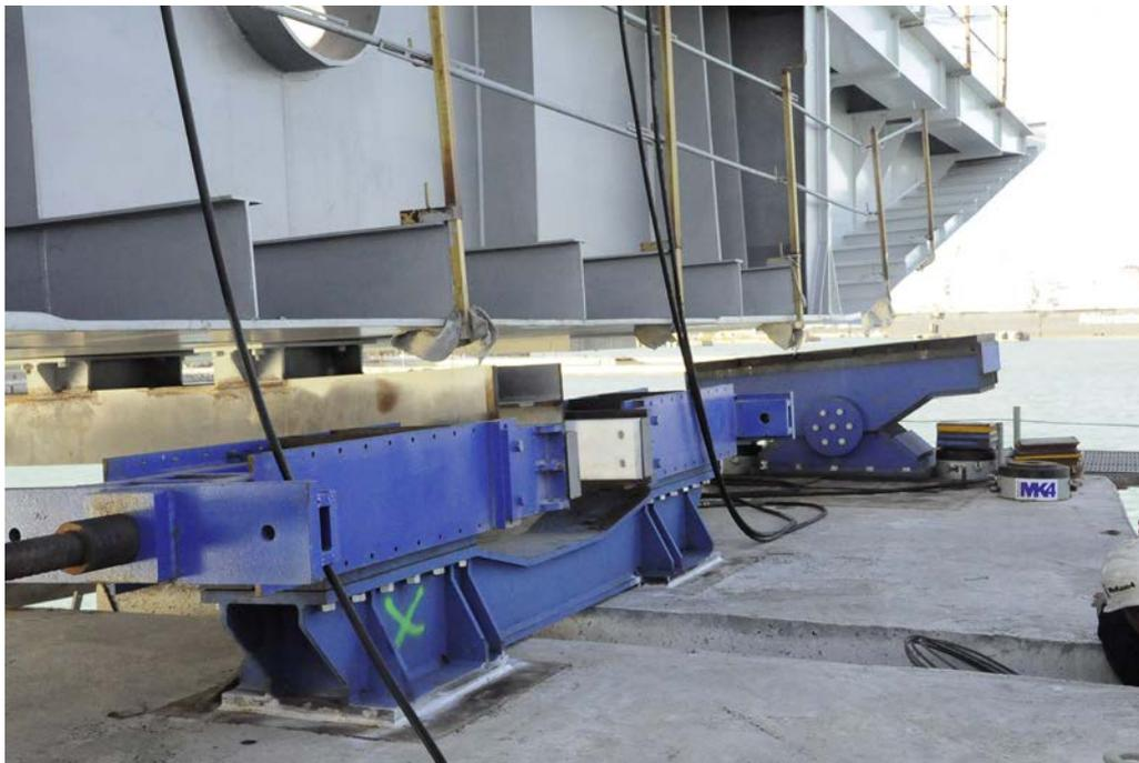
Figura 4. Detalle de guiadera longitudinal.
