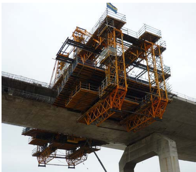
Figura 21. Vista inferior del carro de alas.
