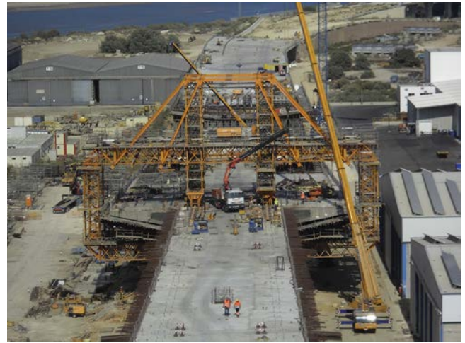
Figura 16. Vista aérea de la ejecución de los voladizos.
