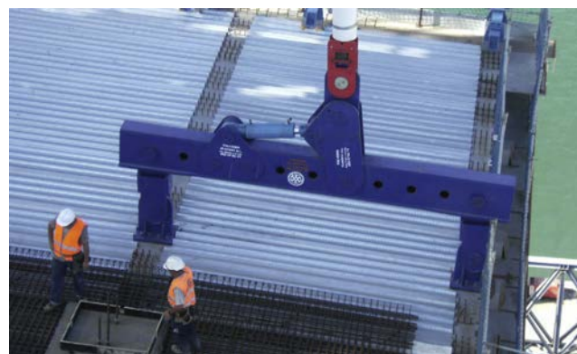
Figura 16. Balancín de regulación.
