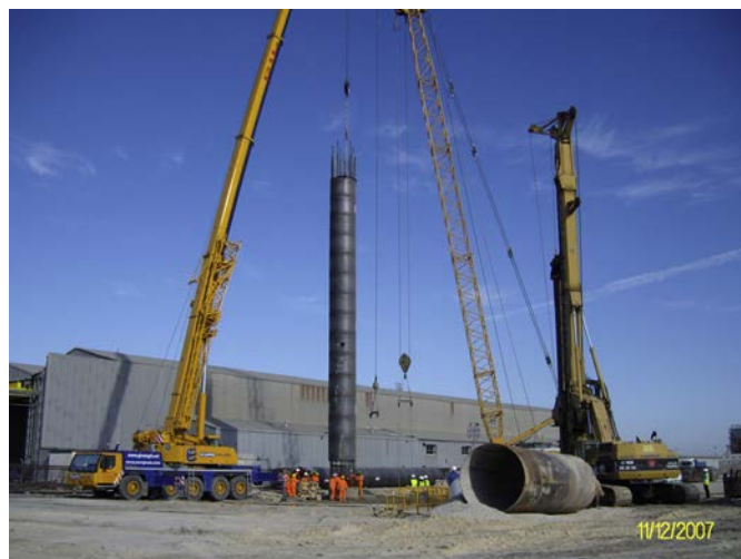
Figura 3. Introducción de la armadura y camisa perdida.
