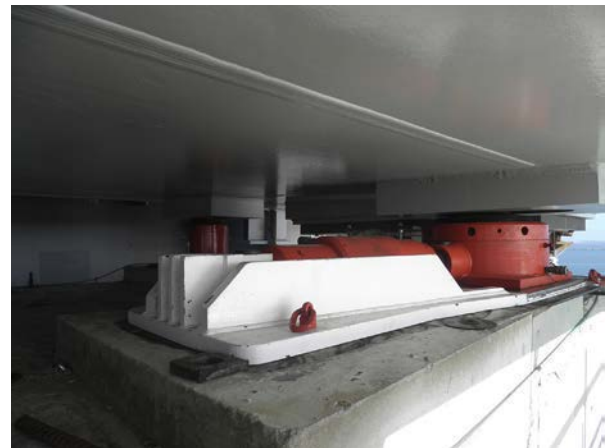
Figura 20. Gatos en lado derecho de pila 11.
