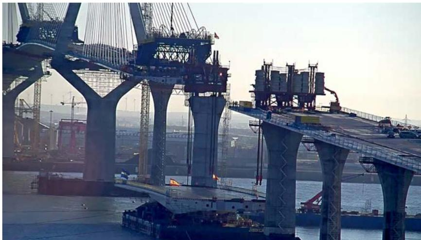
Figura 13. Posicionamiento del tramo desmontable entre pilas.
