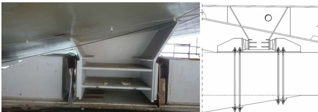
Figura 24. Topes transversales entre tablero y torres.
