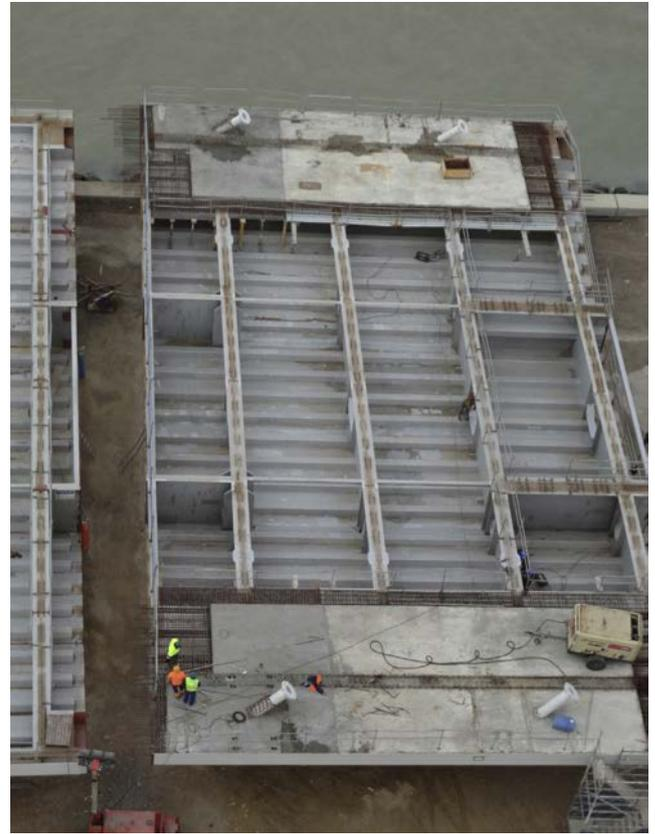
Figura 8. Dovelas en campo con las franjas laterales hormigonadas.
