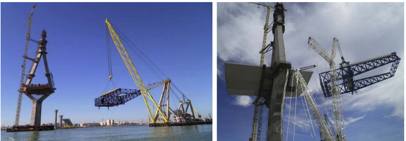
Figura 5. Colocación de los carros de izado sobre el tablero.
