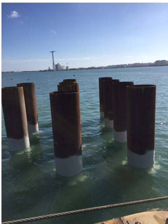
Figura 5. Ejecución de pilotes de cimentación para duque de alba.
