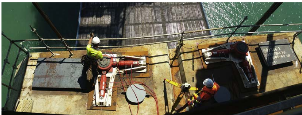
Figura 18. Gatos de posicionamiento en la pila 10.
