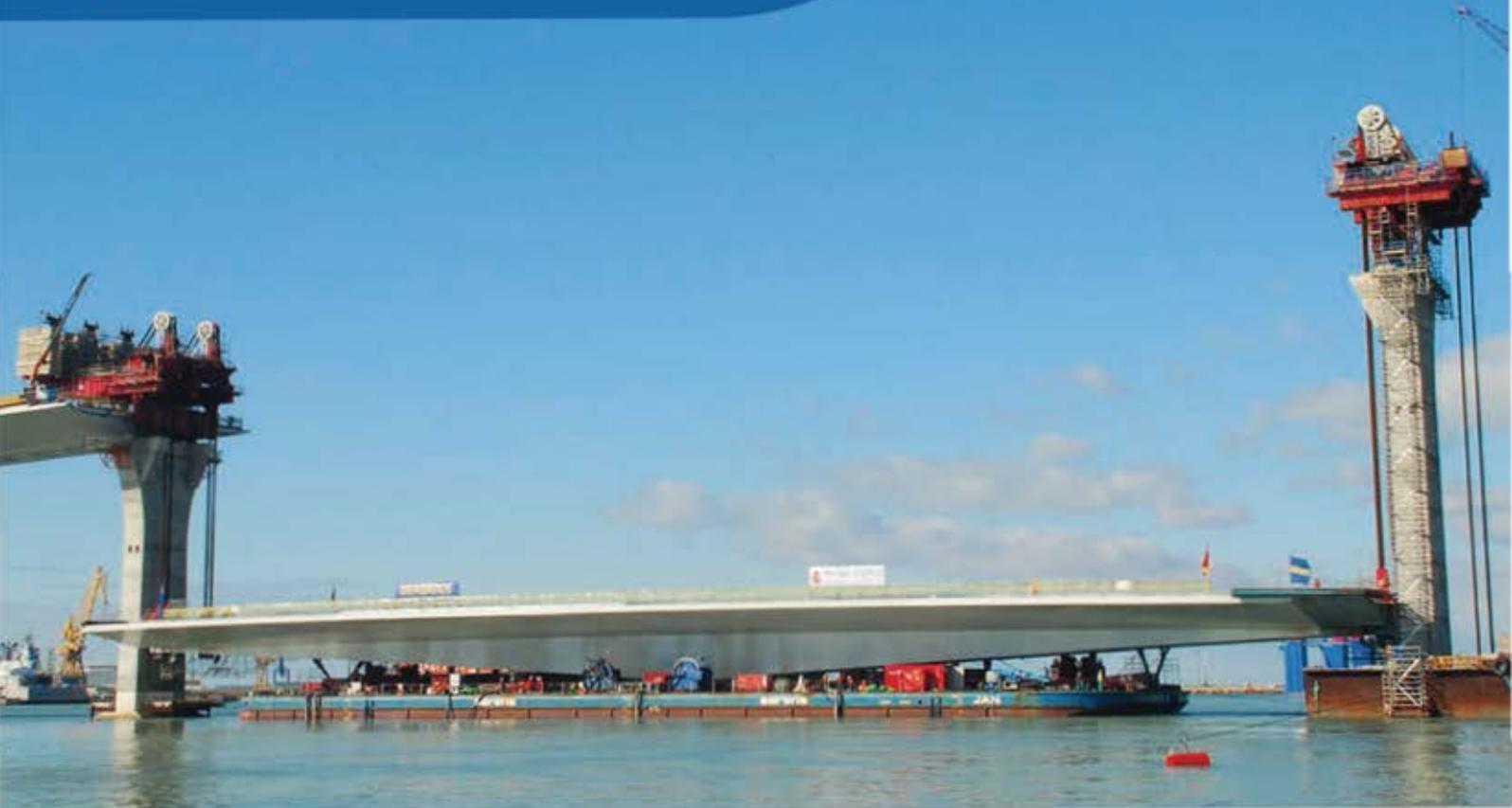
Puente La Pepa: Traslado marítimo tramo desmontable. Barcaza JAN (100x33x7,6 m) para 5.000 T incluyendo vano de 150 m, carros y vigas de transporte.
