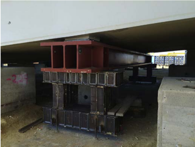
Figura 8. Apeos para pesaje del tramo desmontable.
