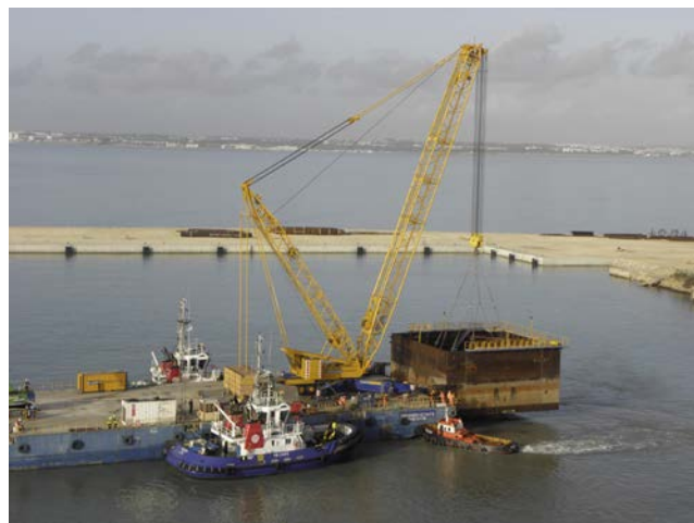
Figura 5. Transporte de los recintos tipo 1 a 3.
