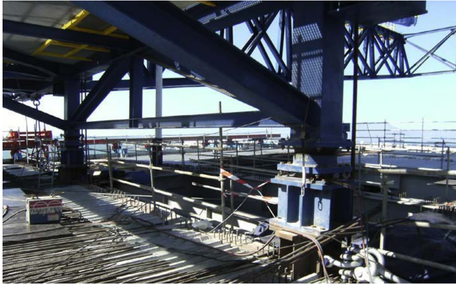
Figura 13. Patas y rótulas de apoyo del marco central.
