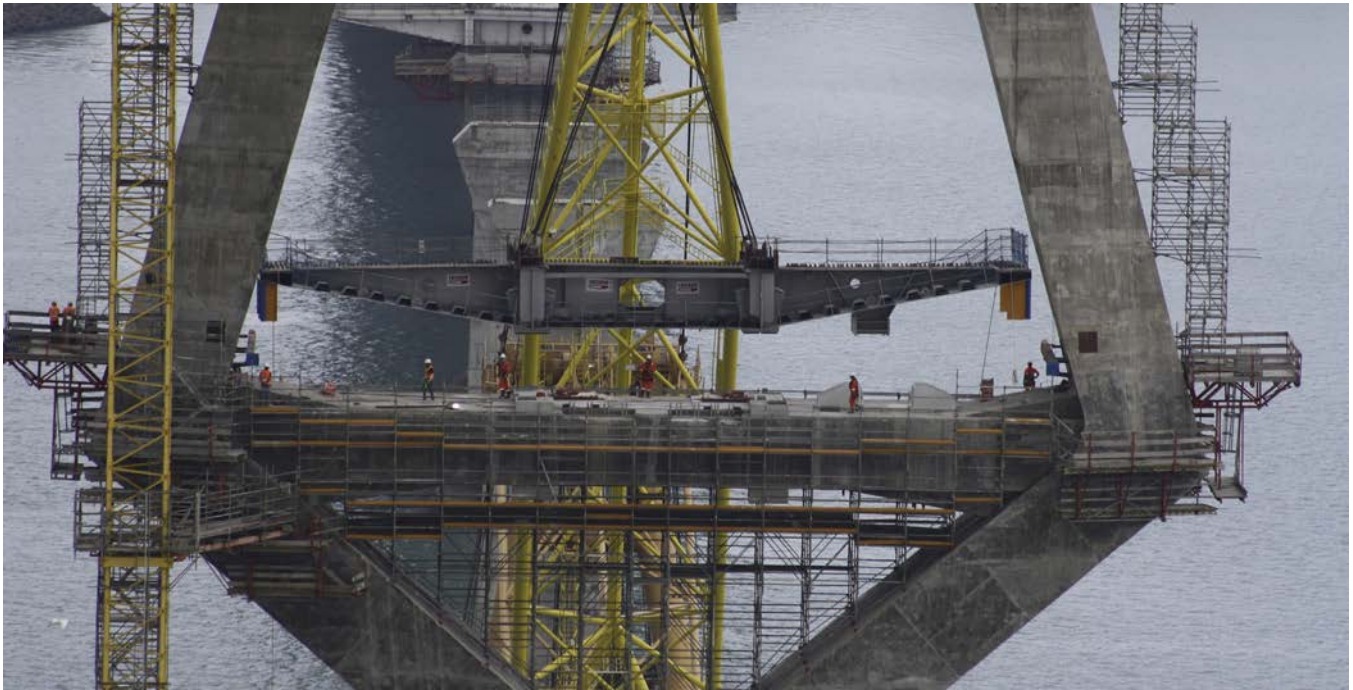
Figura 3. Colocación de la dovela 0P12.
