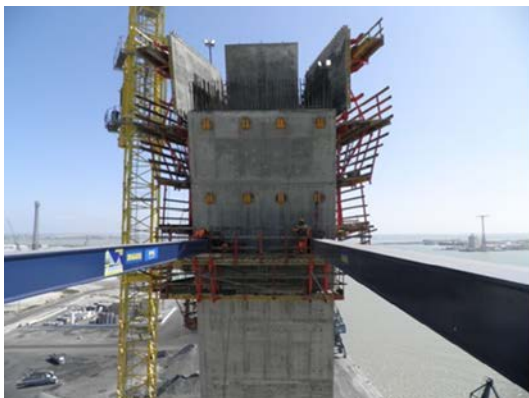
Figura 17. Puntales entre fustes inclinados superiores.
