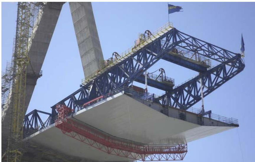
Figura 21. Carro de izado y plataforma de soldadura.
