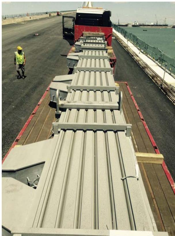
Figura 1. Junta de dilatación. Estribo 1.
