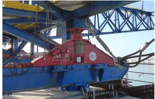
Figura 15. Patín de deslizamiento y viga carril.
