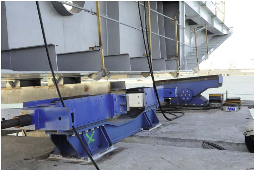
Figura 4. Detalle de guiadera longitudinal.
