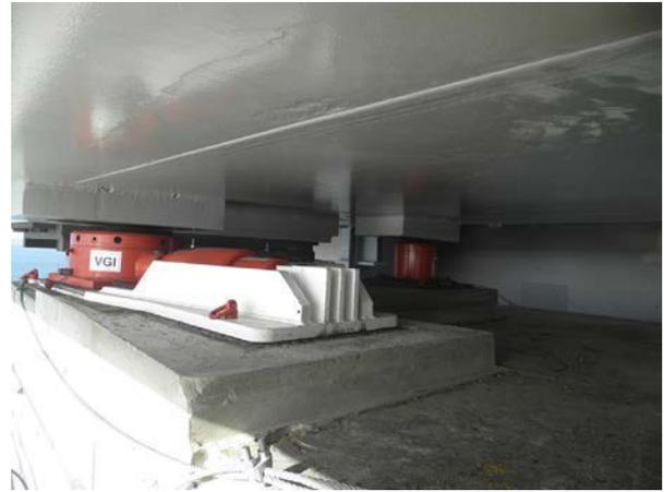
Figura 19. Gatos en lado izquierdo de pila 11.
