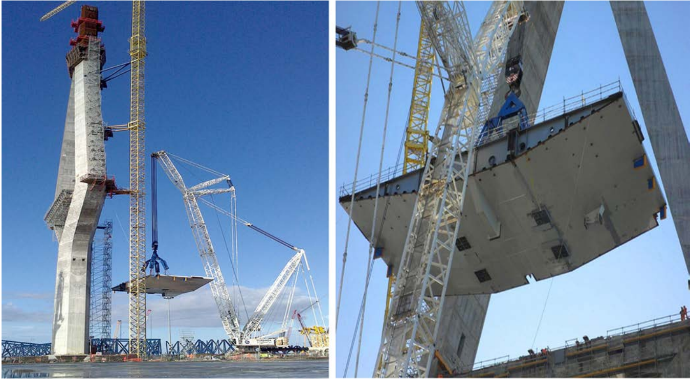
Figura 2. Izado de la dovela 0P13 con los neoprenos para el apoyo aprovisional.
