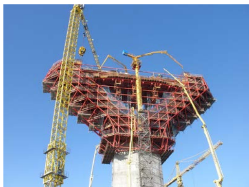
Figura 12. Cimbra de riostra.
