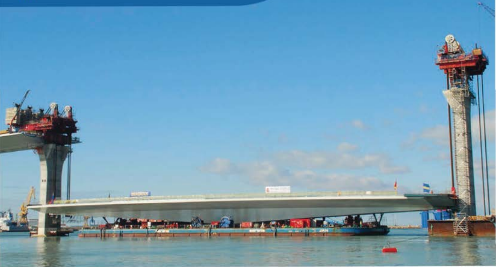
Puente La Pepa: Traslado marítimo tramo desmontable. Barcaza JAN (100x33x7,6 m) para 5.000 T incluyendo vano de 150 m, carros y vigas de transporte. La Pepa Bridge: Sailing of the removable span. Barge JAN (100x33x7,6 m) up to 5.000 T including 150 m span, SPMTs, and transport beams.
