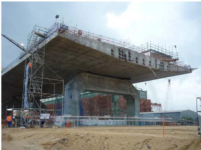
Figura 5. Frente de anclajes en cambio de fase.
