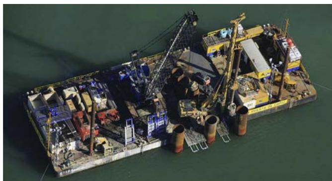
Figura 4. Ejecución de los pilotes desde pontona.
