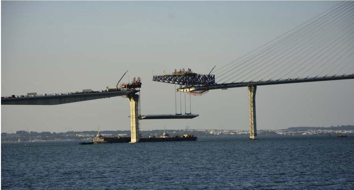
Figura 14. Izado de la dovela 16IP12.
