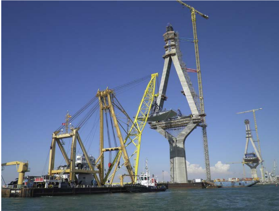
Figura 8. Colocación de dovelas de arranque sobre el pilono situado en el mar con la ayuda de una cabria.
