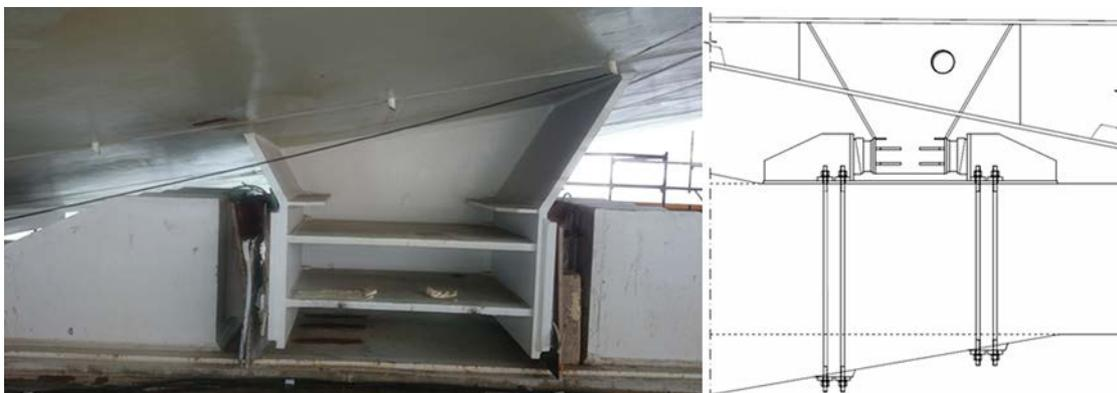
Figura 24. Topes transversales entre tablero y torres.
