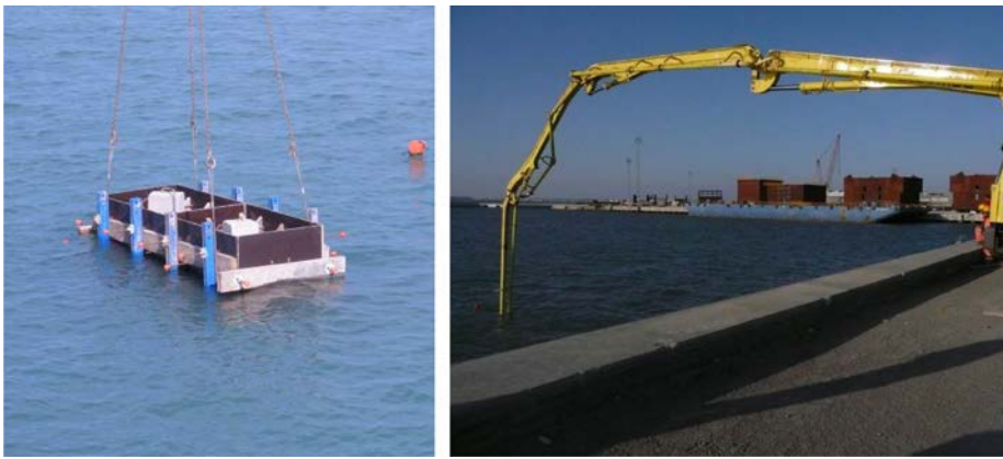
Figura 9. Llenado de molde sumergido.
