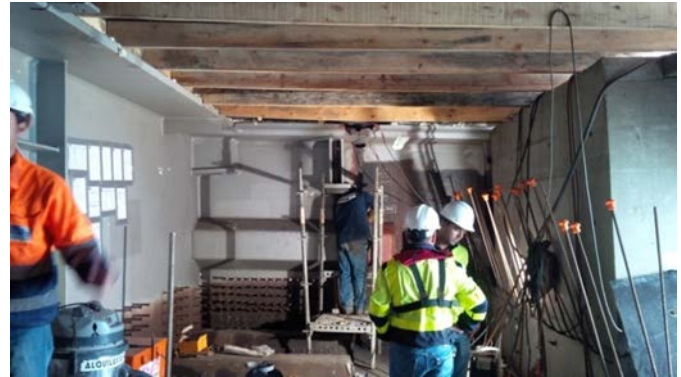
Figura 1. Unión interior de dovelas cubierta con techo. Taller situado a 70 m sobre el mar.
