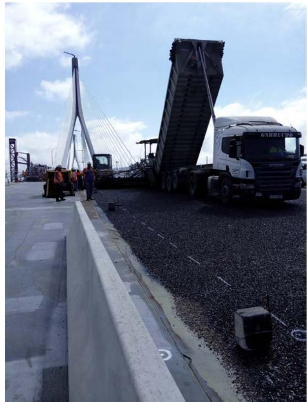
Figura 6. Extendido del firme del tramo desmontable.
