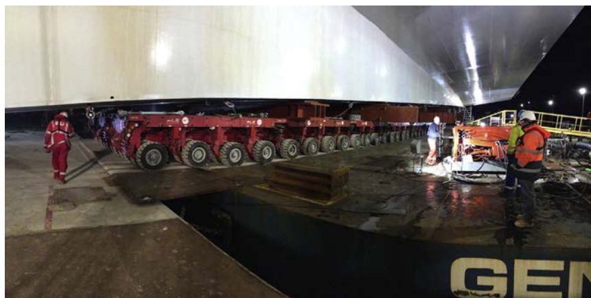
Figura 11. Embarque del tramo desmontable en la pontona.
