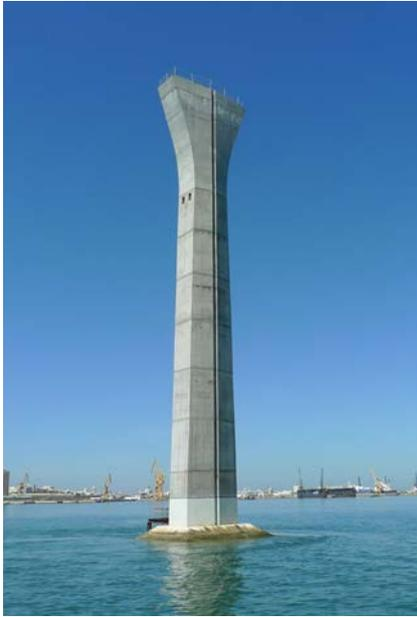
Figura 1. Pilas monofuste.
