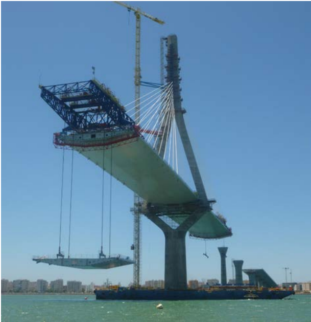
Figura 6. Operación de izado de una dovela típica.
