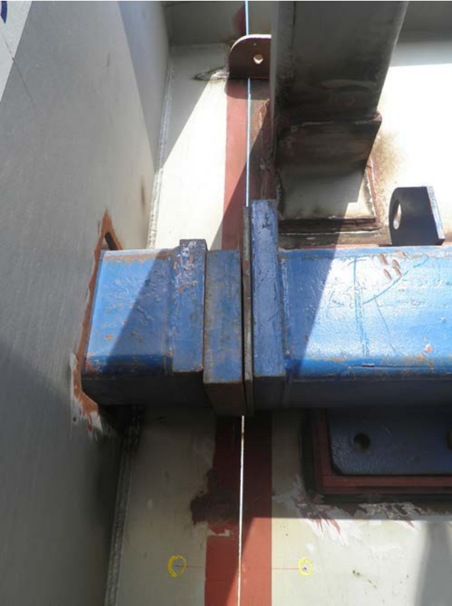
Figura 13. Sistema de acople de dovelas con la galga de corrección (en gris).
