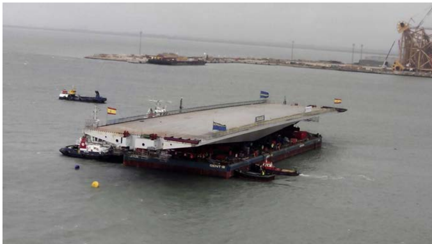
Figura 12. Transporte por mar del tramo desmontable.
