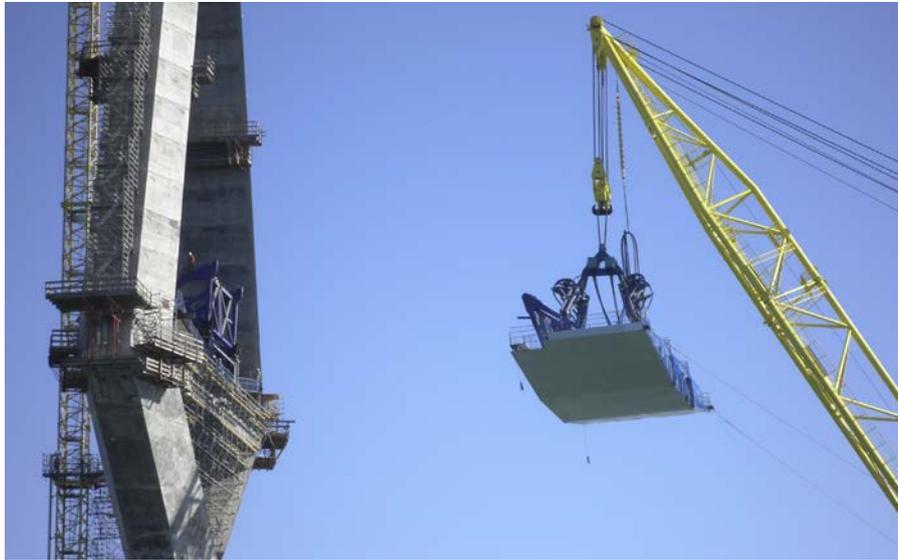
Figura 5. Aproximación con dispositivos de cuelgue en pila 12.
