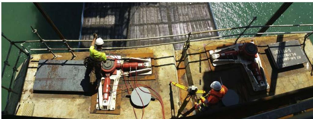
Figura 18. Gatos de posicionamiento en la pila 10.
