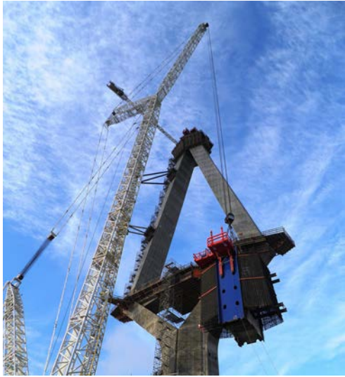
Figura 18. Izado de cajones con grúa sobre cadenas.
