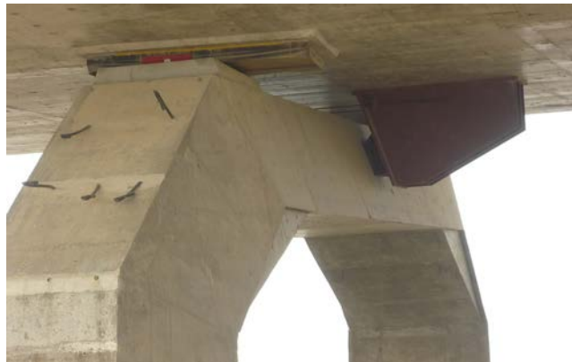
Figura 6. Detalle del tope longitudinal pila-tablero dispuesto.
