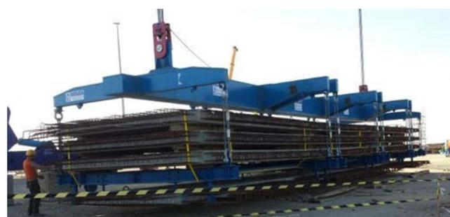
Figura 17. Paquete de losas y balancín de izado.
