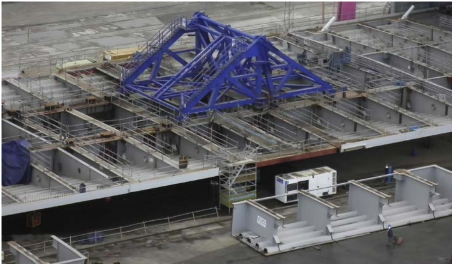
Figura 6. Dispositivos de cuelgue en montaje en blanco.
