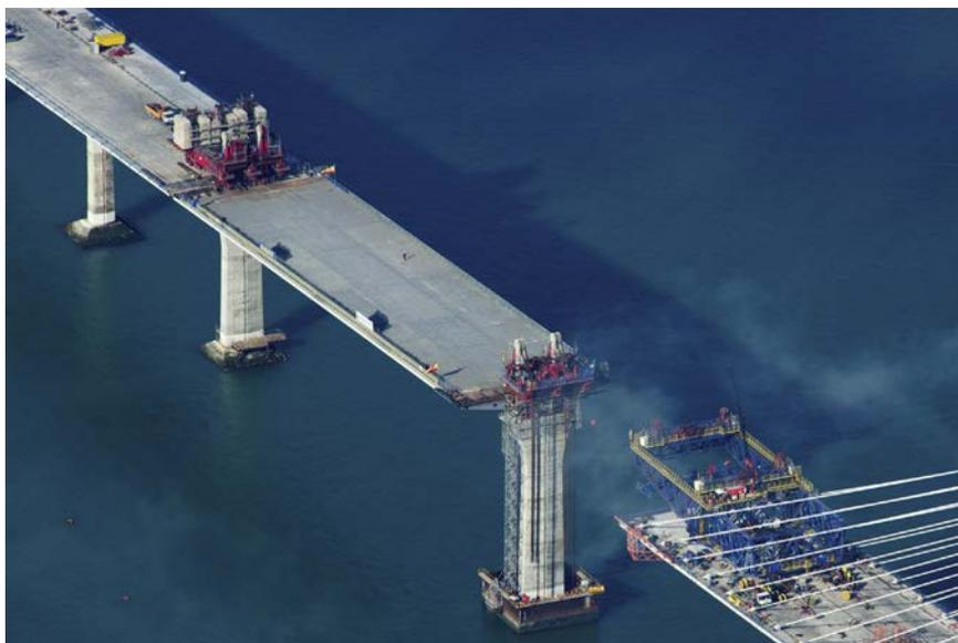
Figura 17. Vano desmontable apoyado en posición definitiva.
