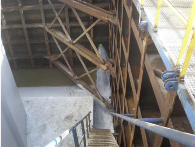
Figura 10. Inundación del recinto previa a desmontaje.
