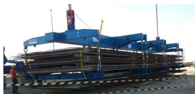
Figura 17. Paquete de losas y balancín de izado.
