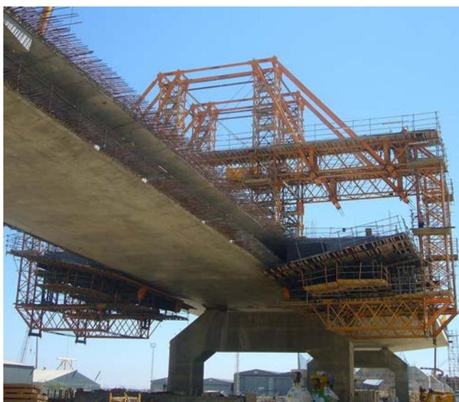
Figura 10. Voladizos exteriores ejecutados con carro.
