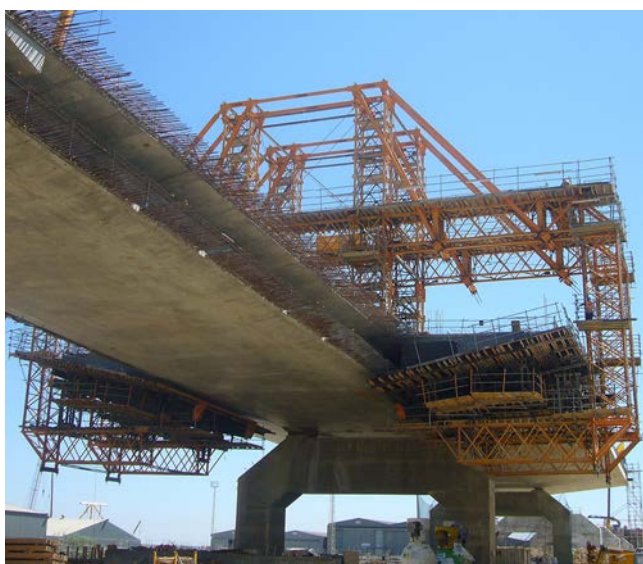
Figura 10. Voladizos exteriores ejecutados con carro.
