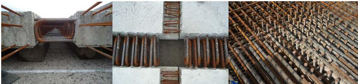
Figura 17. Detalle de armadura de solape en losas prefabricadas y conexión.
