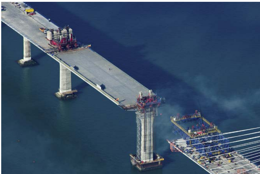
Figura 17. Vano desmontable apoyado en posición definitiva.
