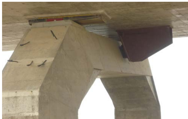
Figura 6. Detalle del tope longitudinal pila-tablero dispuesto.
