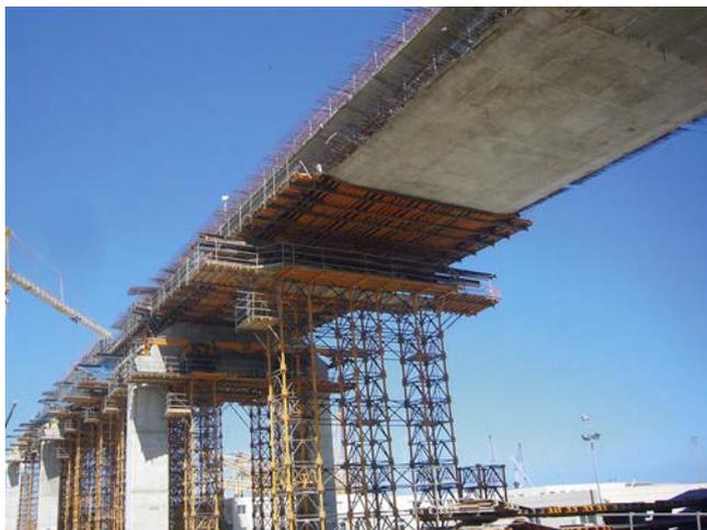
Figura 9. Núcleo cimbrado de la sección en ejecución.
