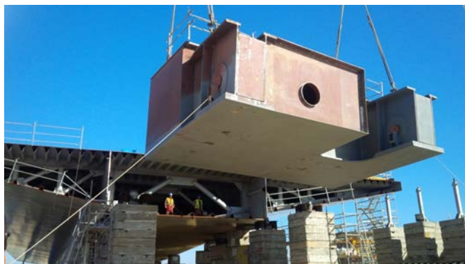
Figura 4. Ensamblado de mamparo de extremo en dovela tramo desmontable. Chapas de 200 mm de espesor y 500 t.
