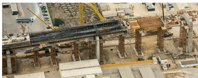
Figura 19. Cimbra porticada empleada para construcción de núcleo central de tablero.
