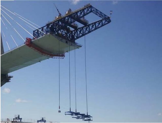
Figura 1. Control del viento en operación de izado de dovelas en Puente de la Constitución de 1812 sobre la Bahía de Cádiz.
