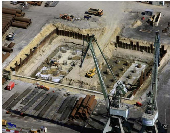
Figura 5. Imagen aérea de la excavación para la ejecución del encepado de la pila 13 (pilono principal en muelle de La Cabezuela).
