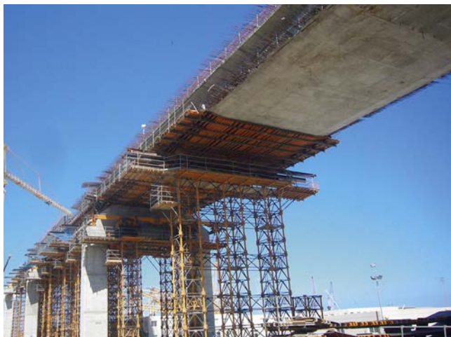
Figura 9. Núcleo cimbrado de la sección en ejecución.
