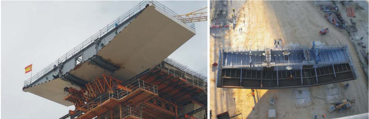
Figura 34. Dovela de conexión dintel mixto-dintel hormigón.
