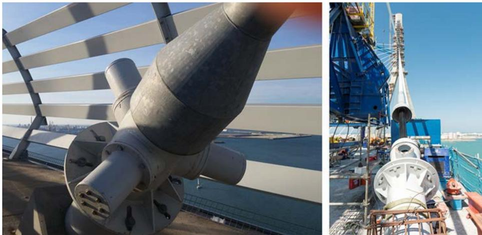
Figura 18. Componentes del tirante en el anclaje del tablero.
