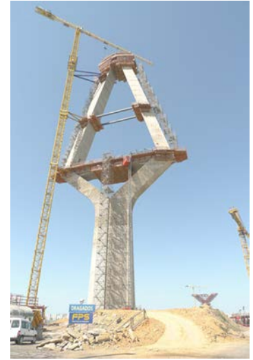
Figura 16. Encofrado autotrepante de fustes inclinados. Puntales entre fustes.
