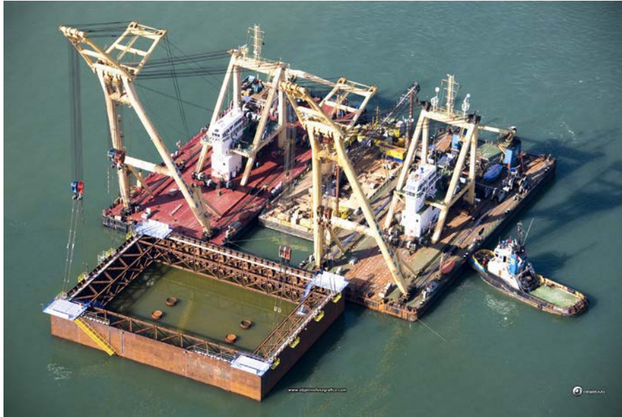
Figura 16. Colocación de los recintos de la torre de la bahía.
