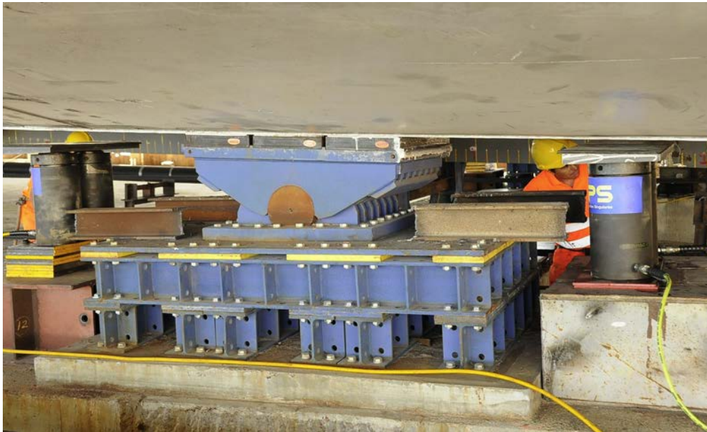
Figura 12. Castillete bajo balancín en pila provisional del parque de empuje.
