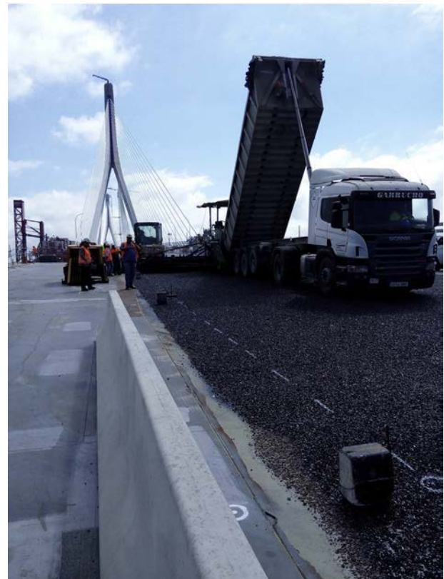
Figura 6. Extendido del firme del tramo desmontable.
