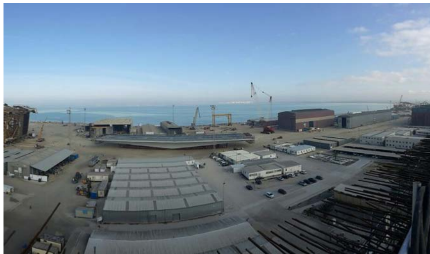
Figura 10. Traslado del tramo desmontable a través del yard de Dragados Offshore.
