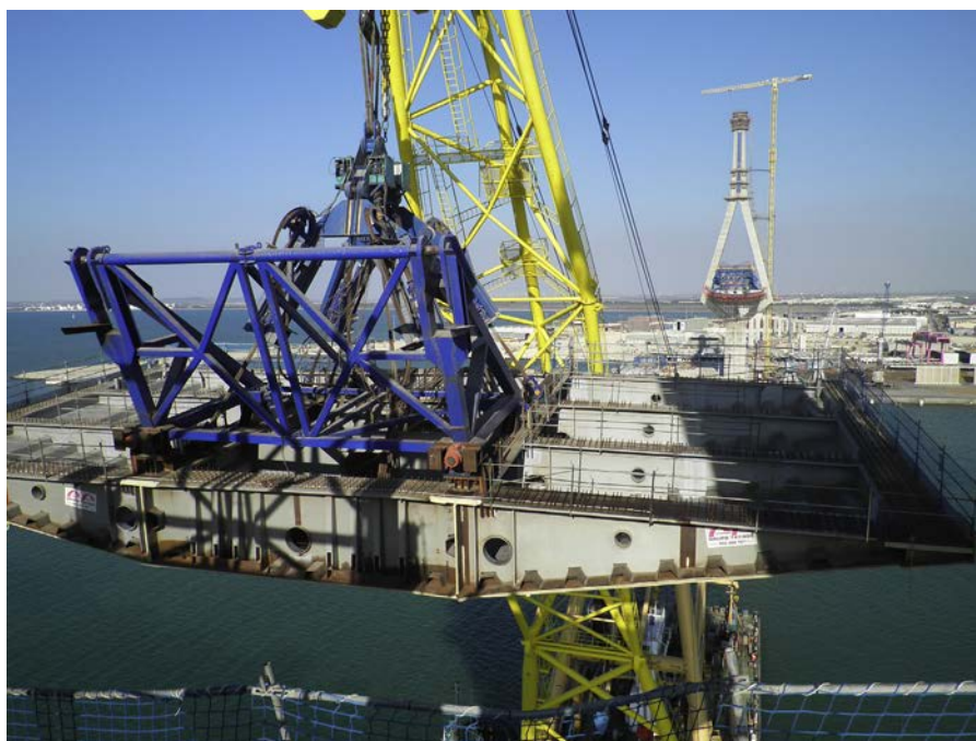
Figura 3. Izado con pescante y dispositivo de nivelación.
