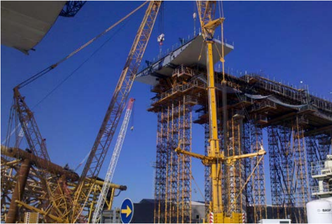
Figura 25. Izado y colocación de la dovela de transición (17DP13).
