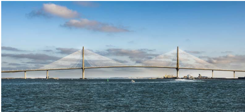
Figura 3. Vista parcial del puente.
