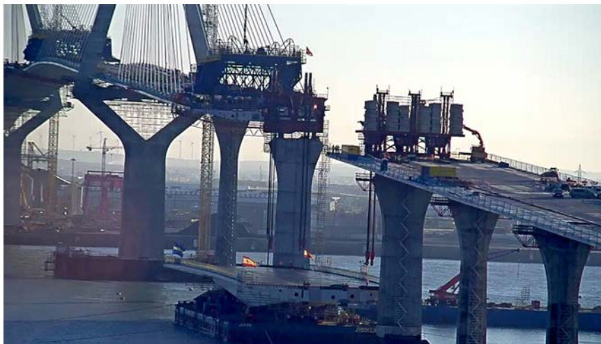
Figura 13. Posicionamiento del tramo desmontable entre pilas.
