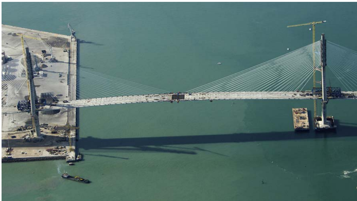
Figura 13. Situación del tablero en los momentos previos al cierre del vano central.
