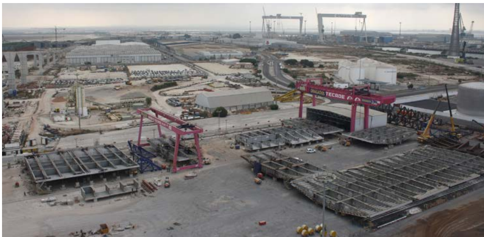
Figura 8. Campa con el montaje de dovelas en el muelle de la Cabezueta.
