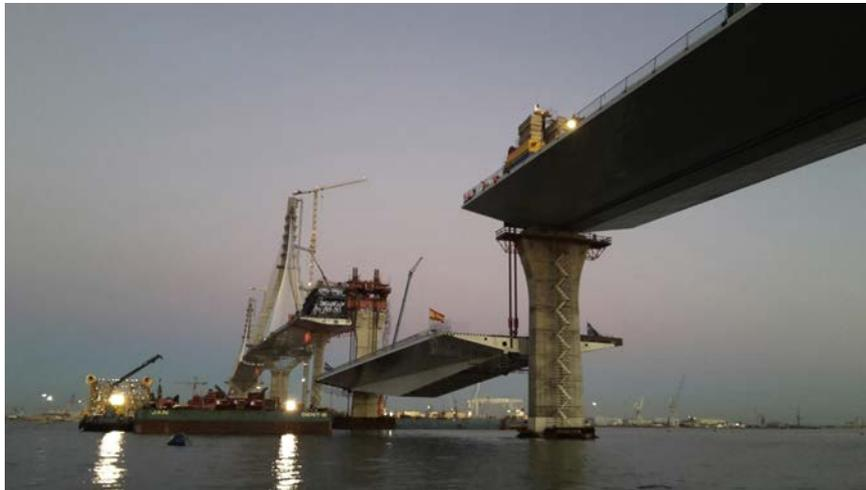
Figura 15. Izado del vano desmontable.
