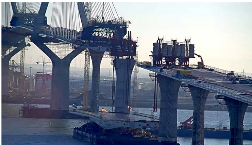
Figura 13. Posicionamiento del tramo desmontable entre pilas.
