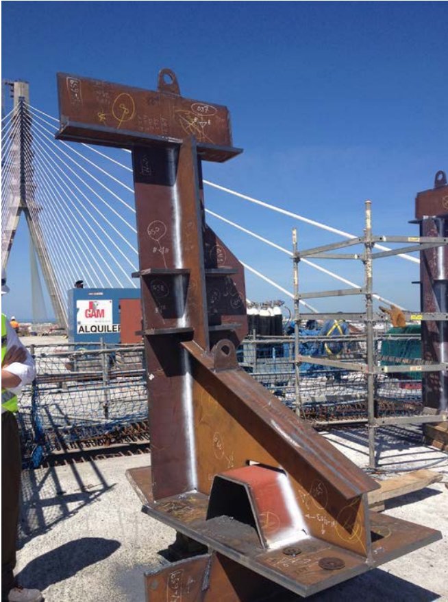
Figura 11. Pieza central del carrete de centro de vano.
