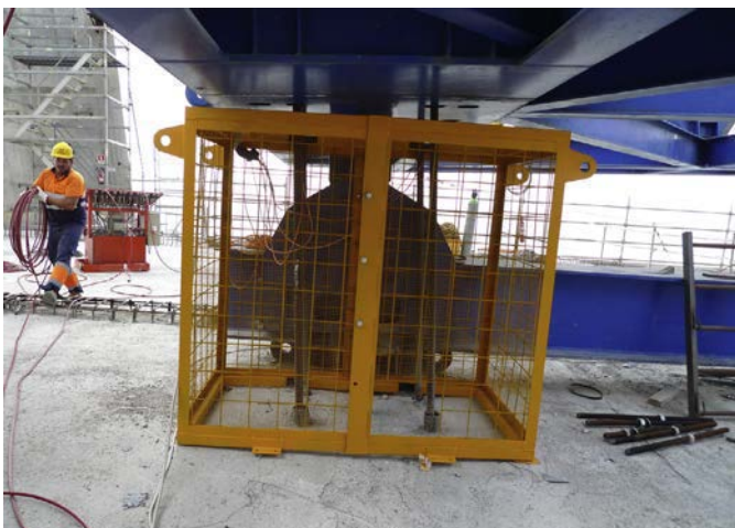
Figura 9. Barras empleadas en los anclajes traseros.
