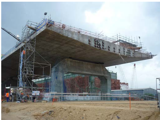
Figura 5. Frente de anclajes en cambio de fase.
