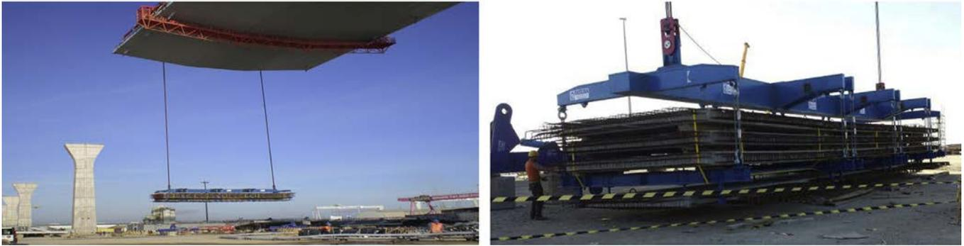
Figura 10. Izado del paquete de losas prefabricadas.
