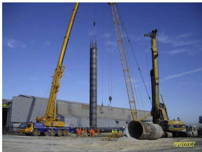
Figura 3. Introducción de la armadura y camisa perdida.
