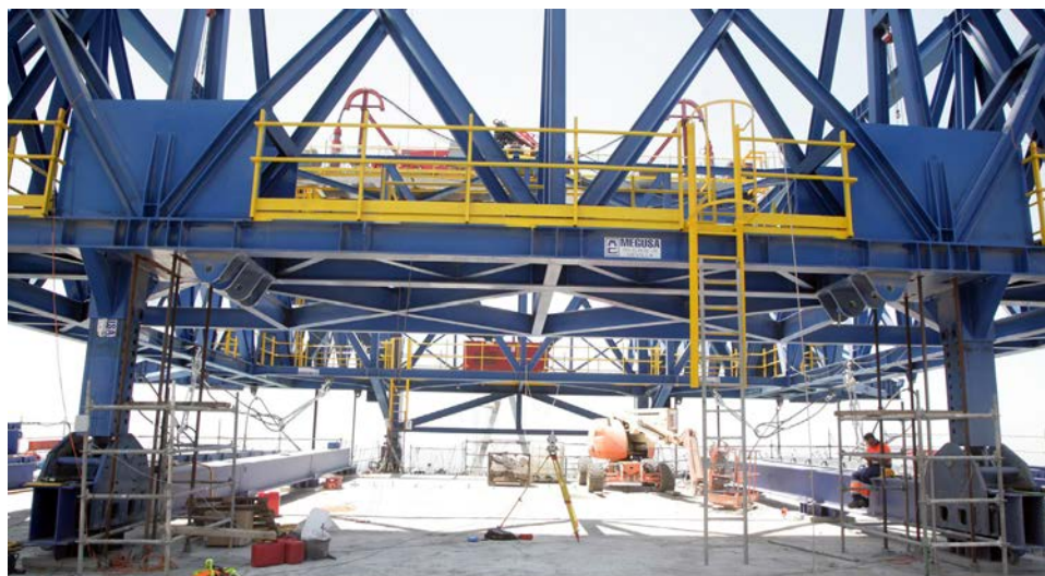
Figura 11. Apoyos y barras del marco trasero.
