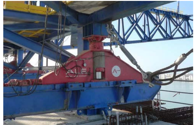
Figura 15. Patín de deslizamiento y viga carril.
