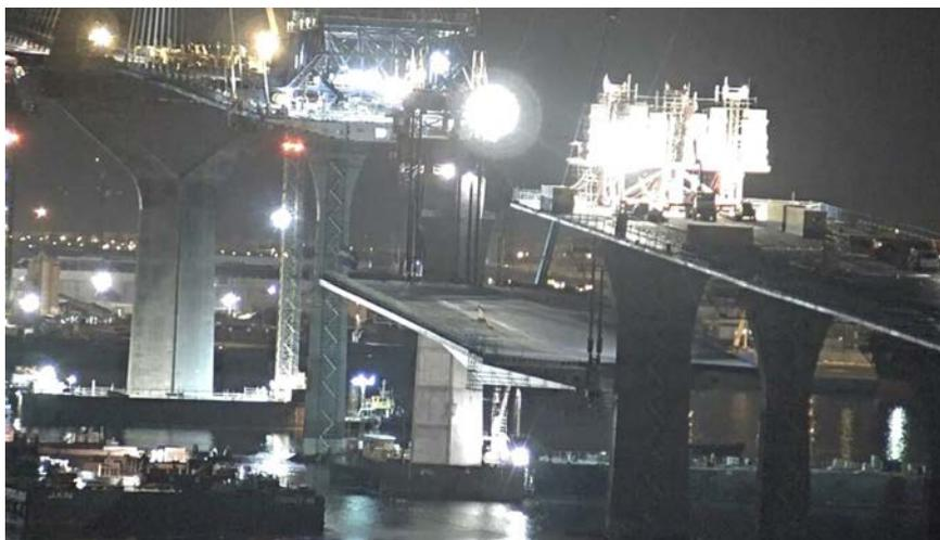
Figura 16. Giro del 5% del vano desmontable.
