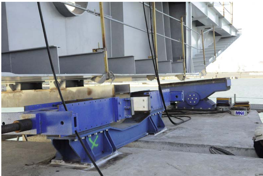
Figura 4. Detalle de guiadera longitudinal.
