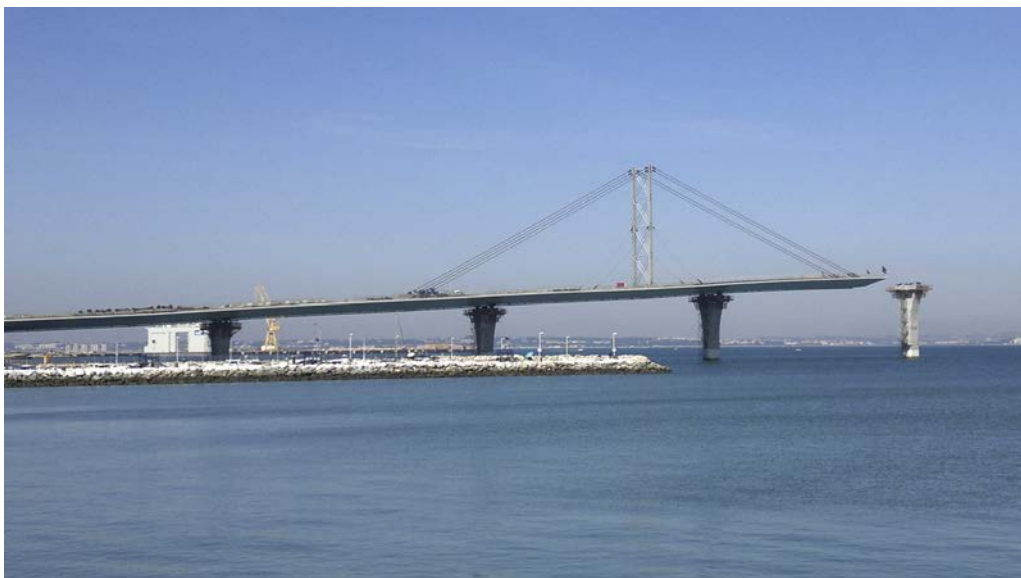
Figura 9. Sistema de atirantamiento provisional.
