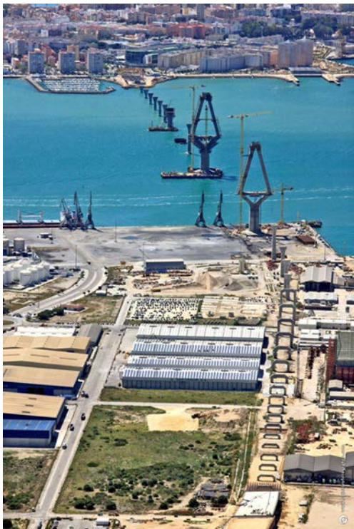
Figura 3. Vista general de pilas.
