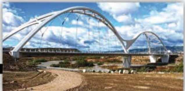
Puente arco de Ibn-Firnas sobre el Guadalquivir (Córdoba) Asistencia técnica en la ejecución
