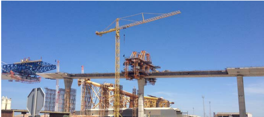
Figura 23. Carro de alas situado sobre la pila 16 para ejecutar los voladizos de la sección del vano 15-16.
