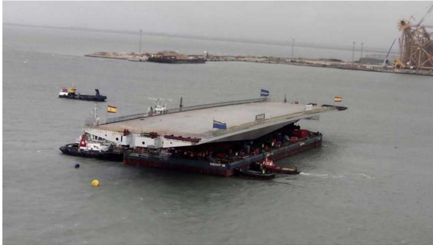
Figura 12. Transporte por mar del tramo desmontable.
