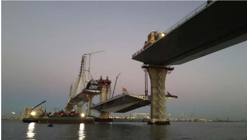
Figura 15. Izado del vano desmontable.
