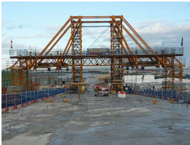
Figura 20. Vista superior del carro de alas.
