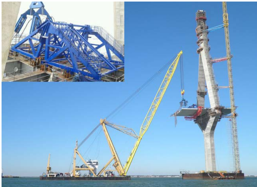
Figura 10. Elemento especial para colocación de dovelas iniciales.
