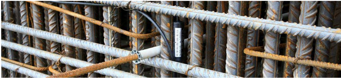
Figura 1. Extensómetro de armadura pasiva instalado en base de pila P12.
