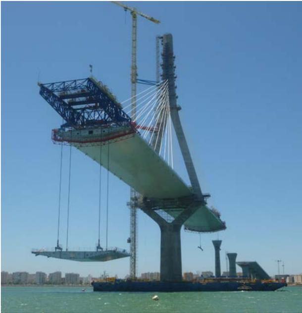
Figura 6. Operación de izado de una dovela típica.
