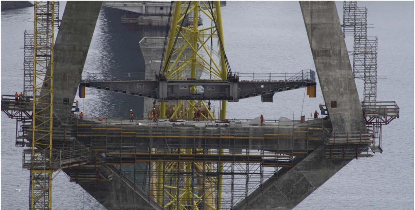
Figura 3. Colocación de la dovela 0P12.
