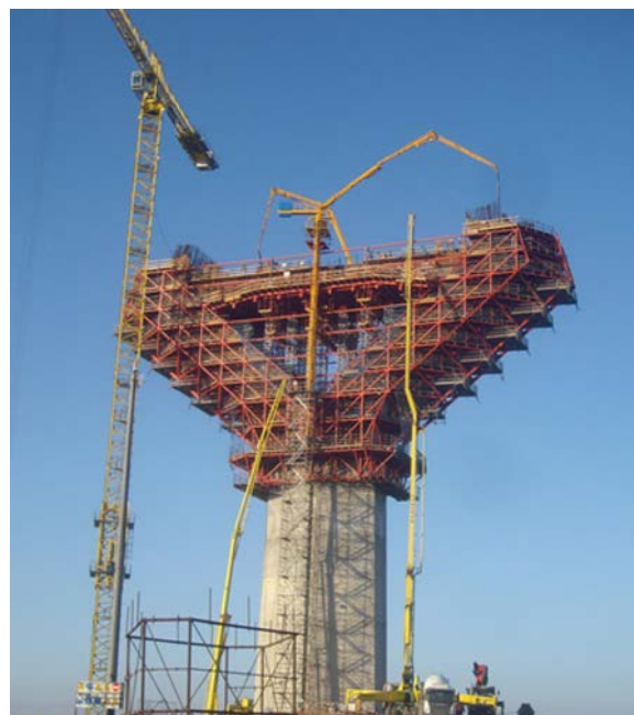
Figura 3. Hormigonado de riostra de torre 13.
