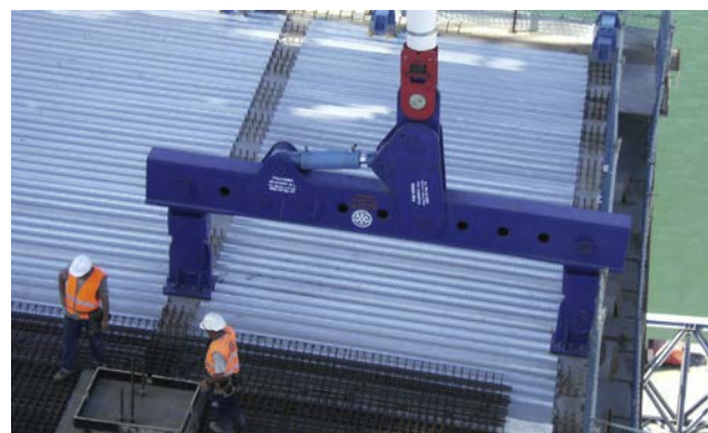
Figura 16. Balancín de regulación.
