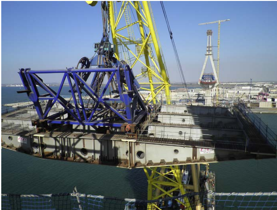
Figura 3. Izado con pescante y dispositivo de nivelación.
