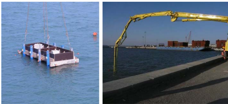
Figura 9. Llenado de molde sumergido.
