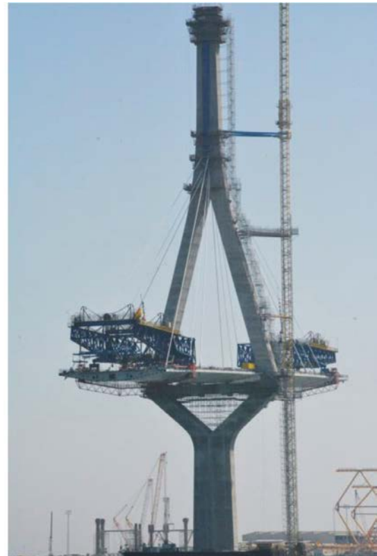
Figura 22. Definición torre de atirantamiento.
