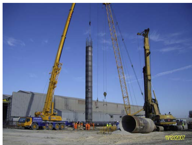
Figura 3. Introducción de la armadura y camisa perdida.
