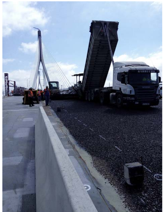
Figura 6. Extendido del firme del tramo desmontable.
