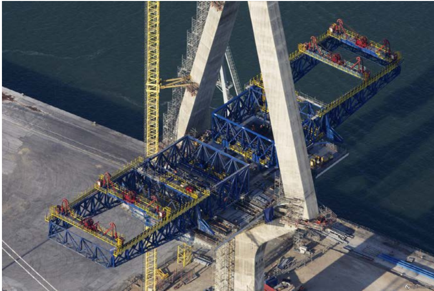
Figura 11. Carros de izado sobre el pilono situado en tierra.
