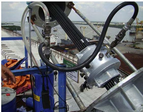
Figura 8. Montaje de los amortiguadores.
