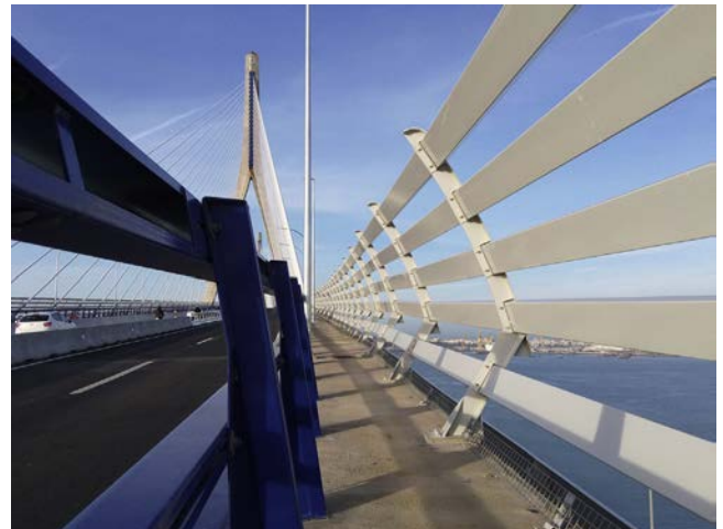
Figura 8. Pantallas antiviento en el tramo atirantado.
