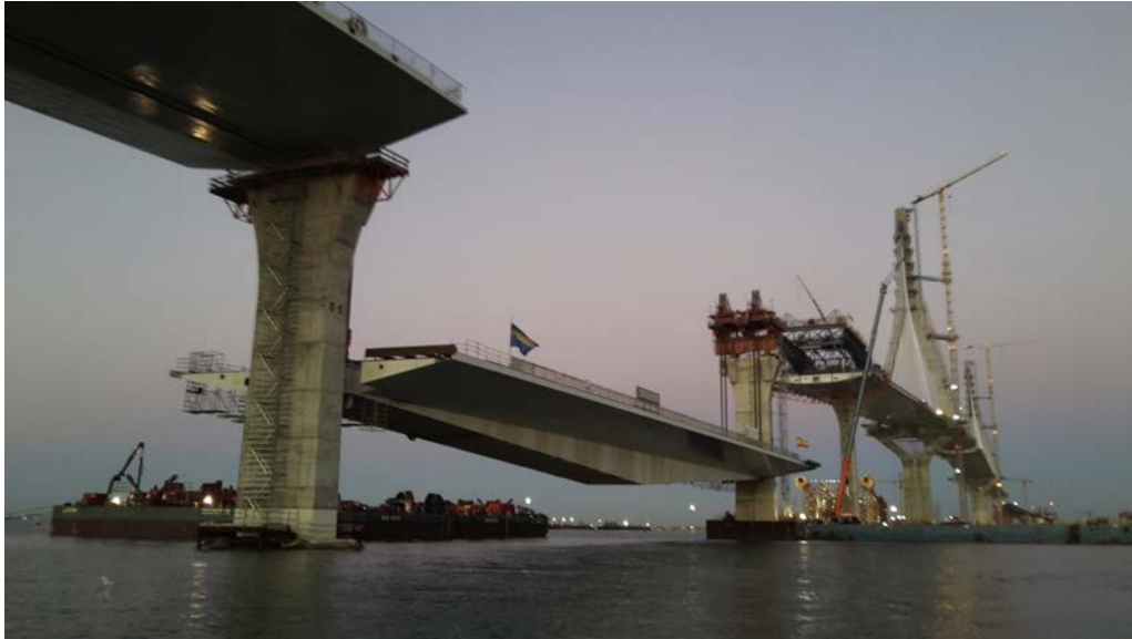
Figura 18. Izado del tramo desmontable.
