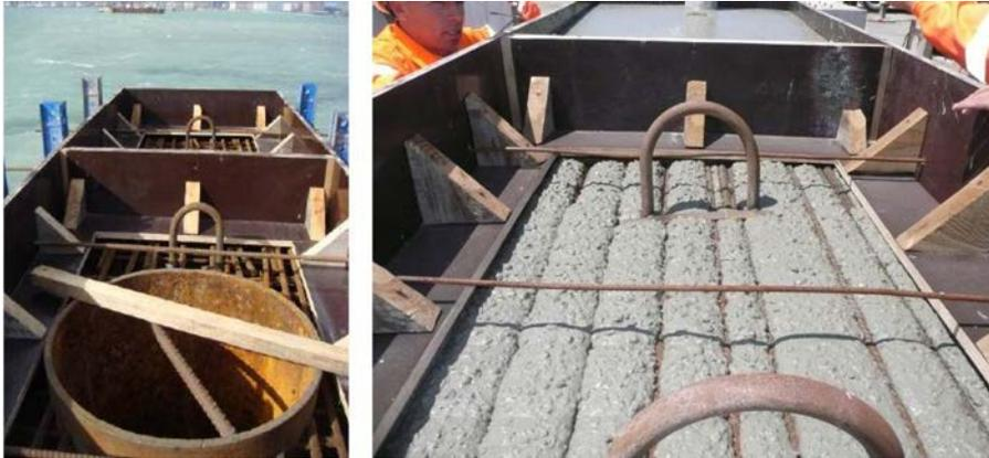
Figura 8. Llenado de molde en superficie.
