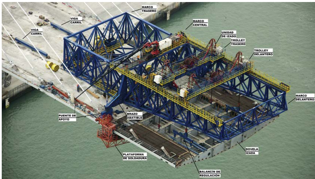
Figura 10. Frente de avance hacia el vano central en la pila 13.
