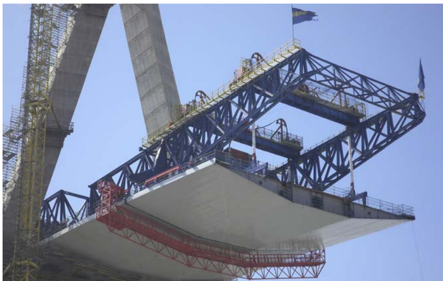
Figura 21. Carro de izado y plataforma de soldadura.
