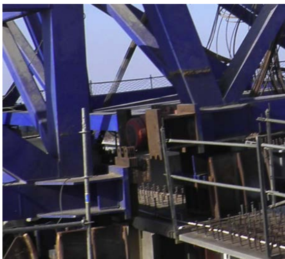
Figura 7. Pescante. Detalle gato y galgas inferiores.
