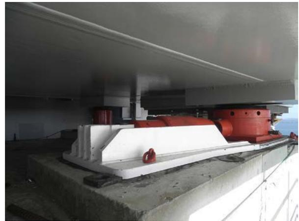
Figura 20. Gatos en lado derecho de pila 11.
