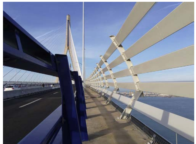
Figura 8. Pantallas antiviento en el tramo atirantado.
