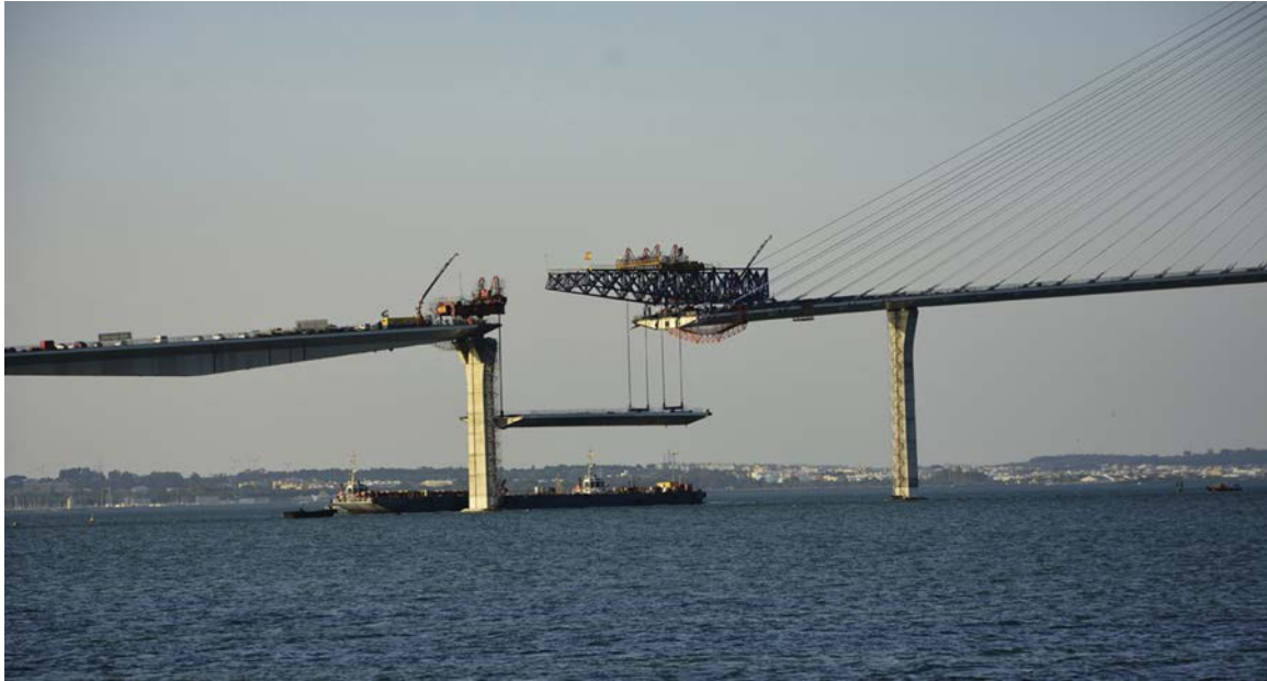
Figura 14. Izado de la dovela 16IP12.
