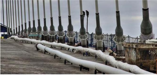
Figura 9. Vista de los amortiguadores durante la construcción.
