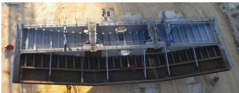
Figura 19. Dovela de transición (17DP13) en la campana.
