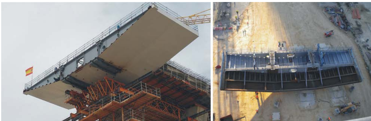
Figura 34. Dovela de conexión dintel mixto-dintel hormigón.
