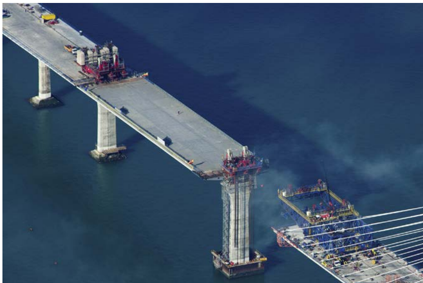
Figura 17. Vano desmontable apoyado en posición definitiva.
