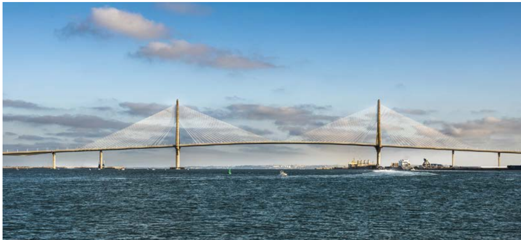
Figura 3. Vista parcial del puente.
