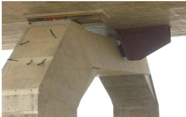
Figura 6. Detalle del tope longitudinal pila-tablero dispuesto.
