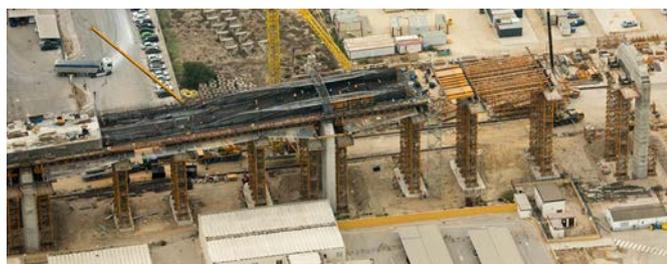
Figura 19. Cimbra porticada empleada para construcción de núcleo central de tablero.
