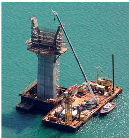
Figura 7. Construcción de pilas monofuste en mar.
