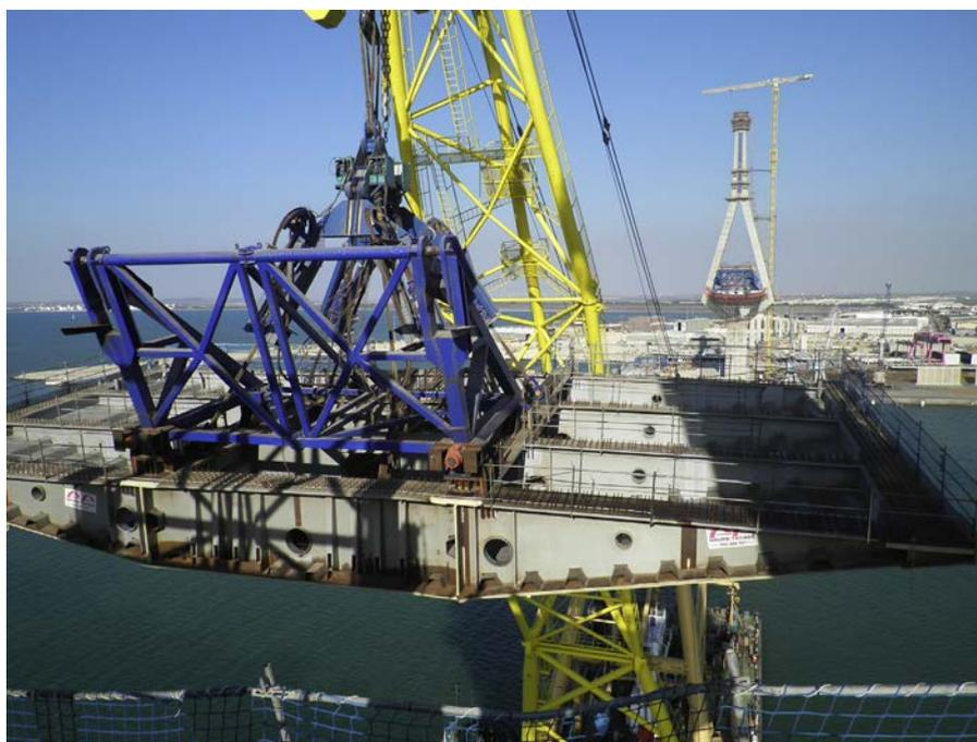
Figura 3. Izado con pescante y dispositivo de nivelación.
