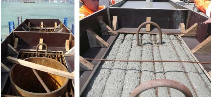
Figura 8. Llenado de molde en superficie.
