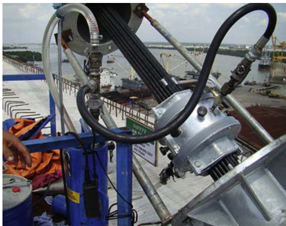
Figura 8. Montaje de los amortiguadores.
