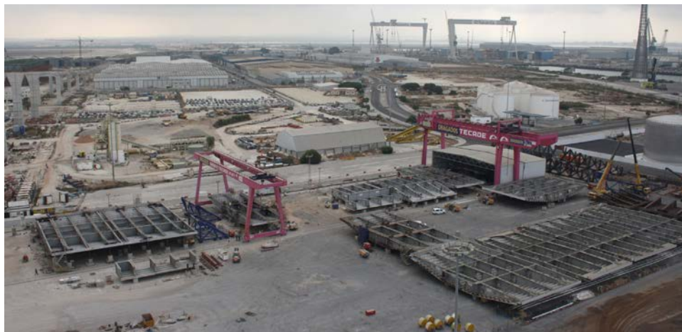
Figura 8. Campa con el montaje de dovelas en el muelle de la Cabezuela.
