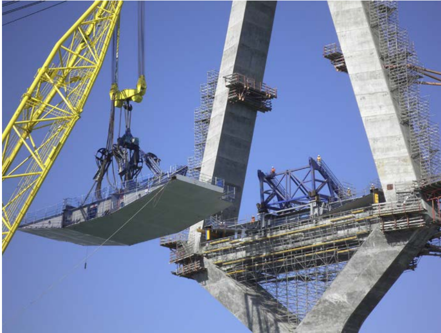
Figura 4. Colocación de dovela con cabria y empleando los dispositivos de cuelgue.
