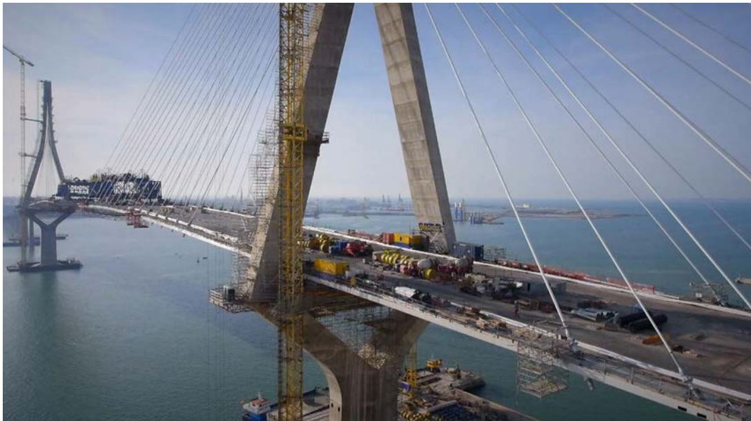
Figura 12. Ubicación de las cargas sobre el tablero durante el proceso de construcción.
