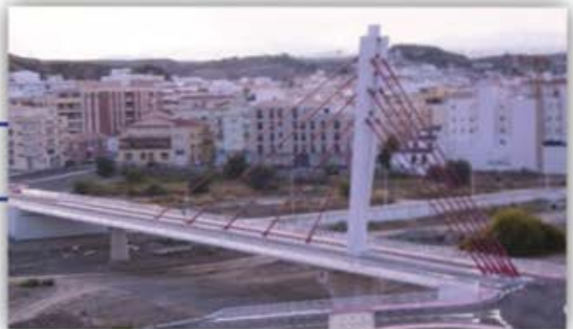
Puente atirantado sobre la Rambla de Albox (Almería) Proyecto y Asistencia
