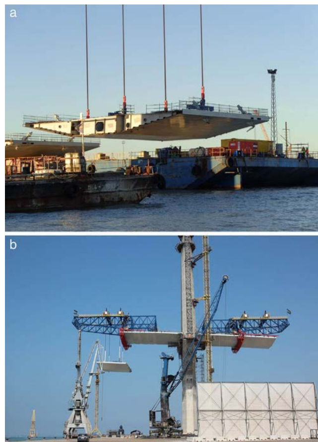
Figura 2. Izado y colocación de dovela.
