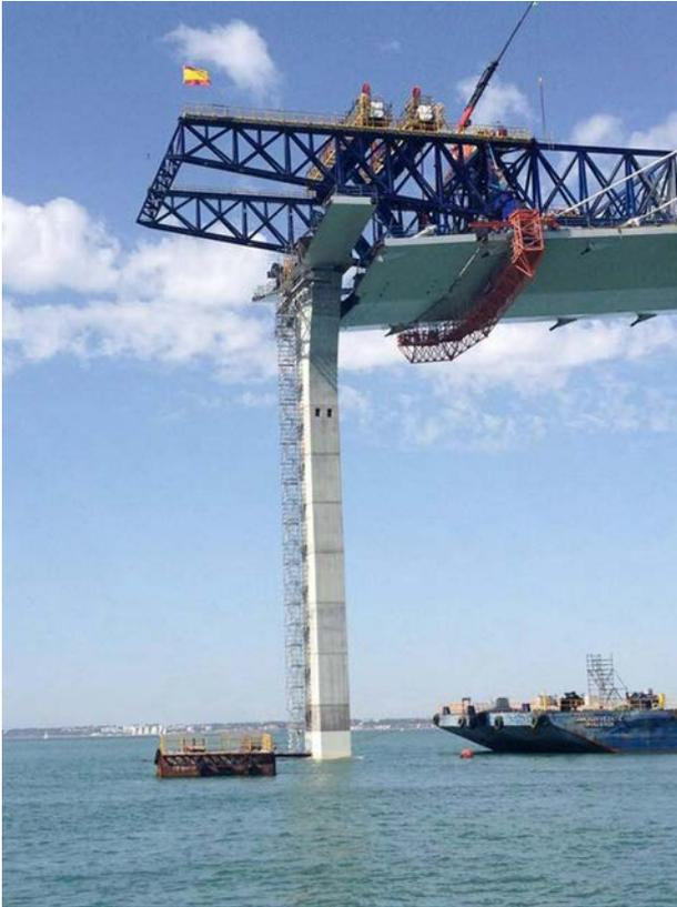
Figura 2. Desnivel entre dovelas de tablero a la llegada a la pila del vano de compensación.
