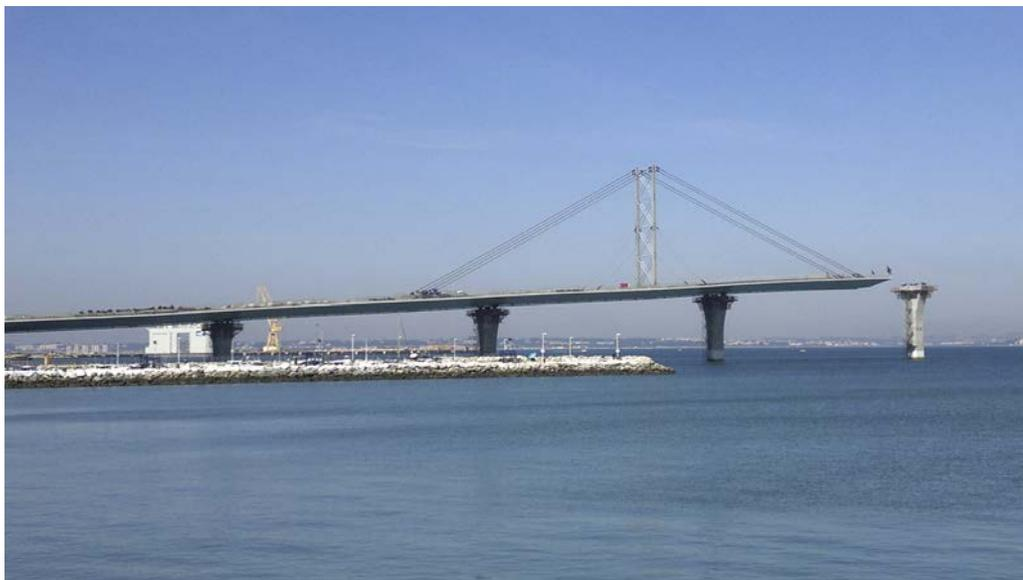
Figura 9. Sistema de atirantamiento provisional.
