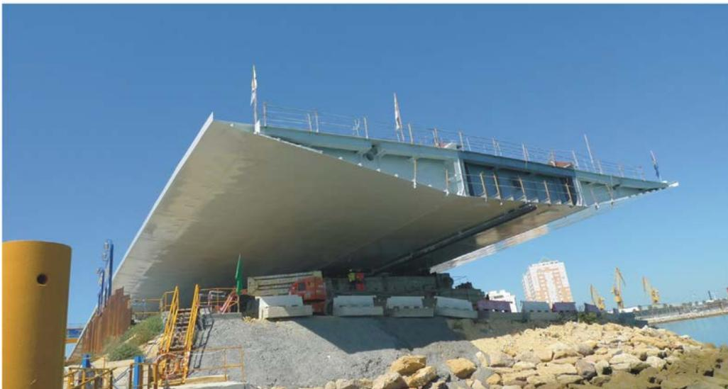
Figura 11. Sección transversal del viaducto de acceso al lado de Cádiz.
