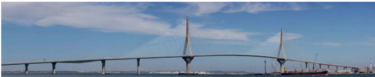
Figura 1. Vista panorámica del Puente de la Constitución de 1812.
