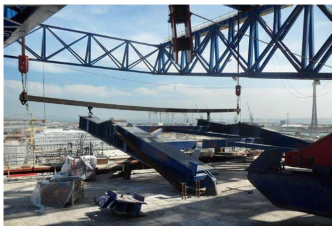
Figura 7. Pescante de bloqueo en el momento del abatimiento sobre la dovela de pila.
