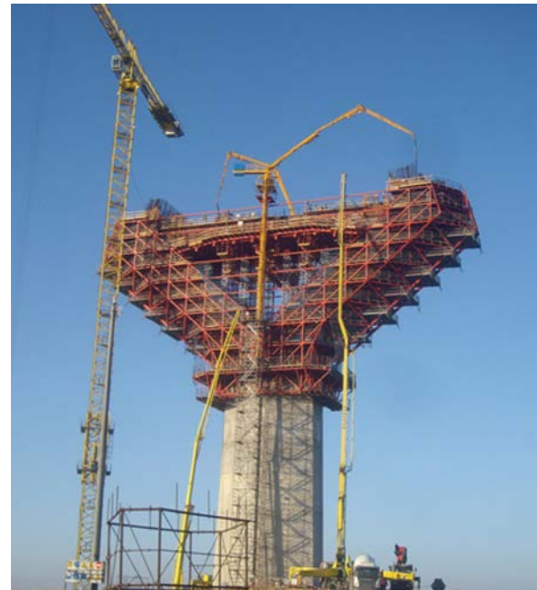
Figura 3. Hormigonado de riostra de torre 13.
