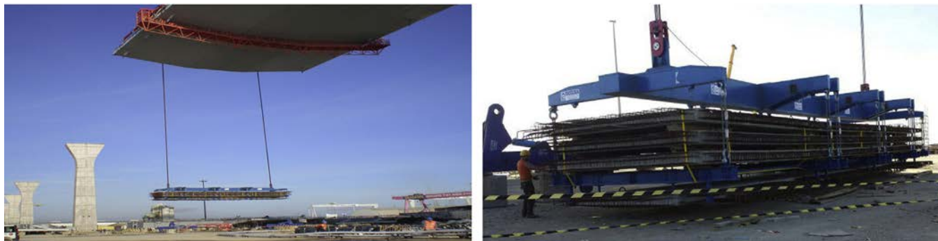
Figura 10. Izado del paquete de losas prefabricadas.
