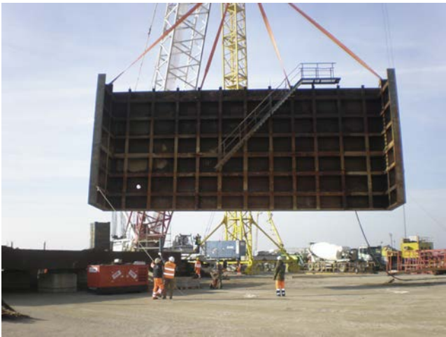
Figura 11. Descarga de un tramo de pared en muelle.
