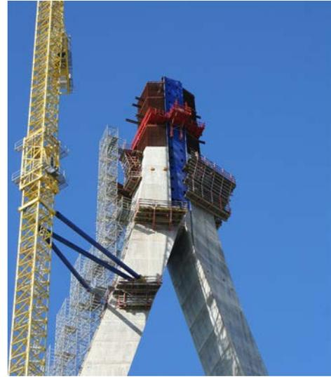
Figura 19. Montaje de cajones con grúa sobre cadenas.
