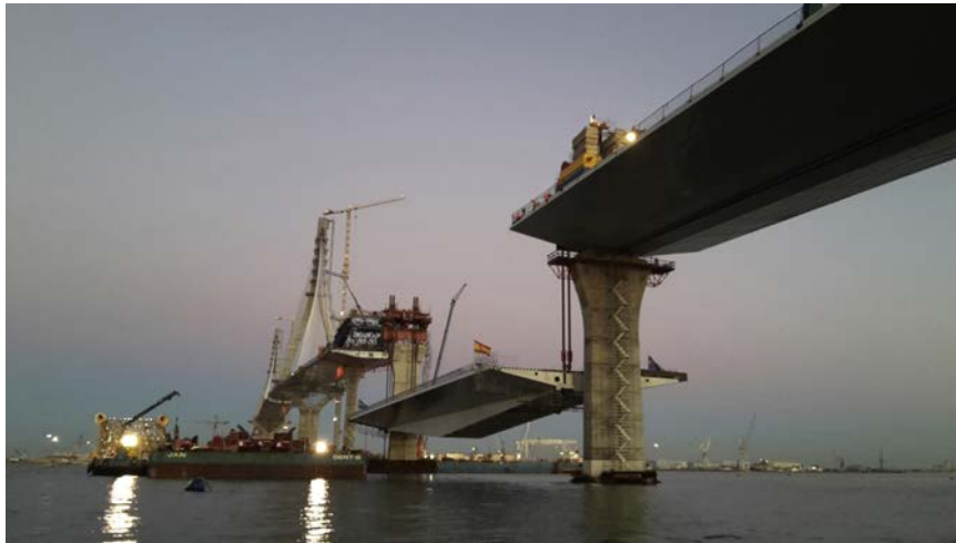
Figura 15. Izado del vano desmontable.
