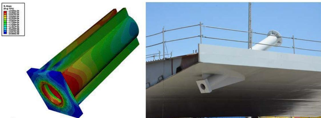
Figura 20. Detalle del anclaje del tirante al tablero.
