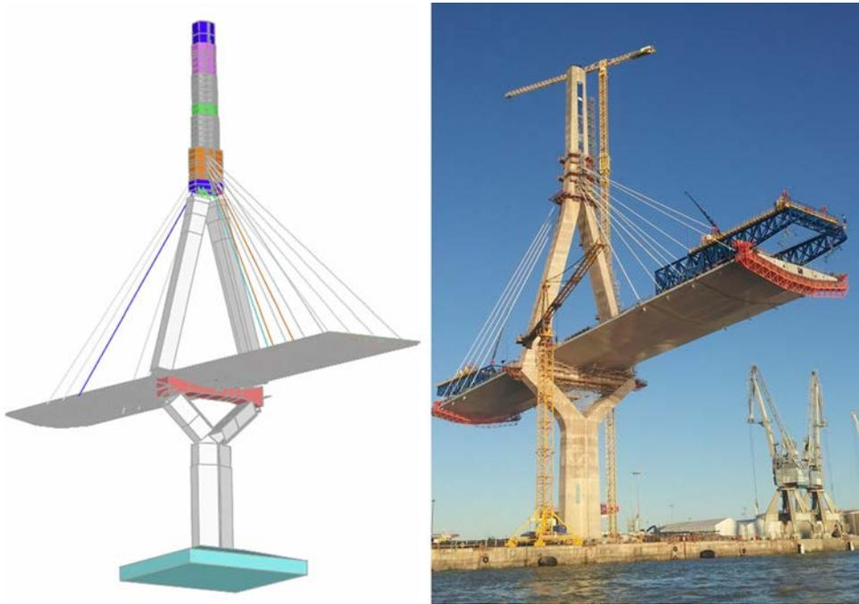
Figura 12. Modelo evolutivo de elementos finitos de contraste.
