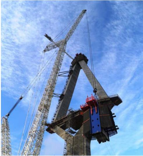
Figura 18. Izado de cajones con grúa sobre cadenas.
