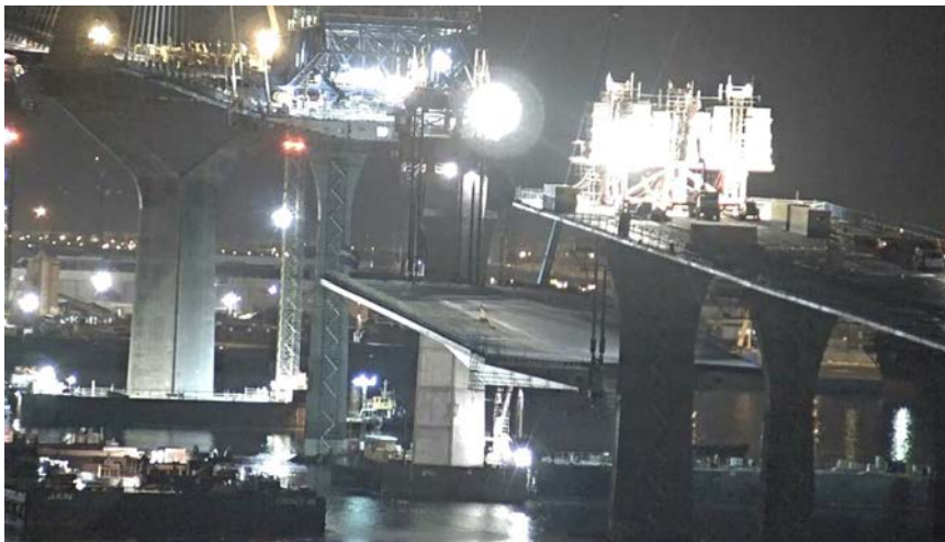
Figura 16. Giro del 5% del vano desmontable.
