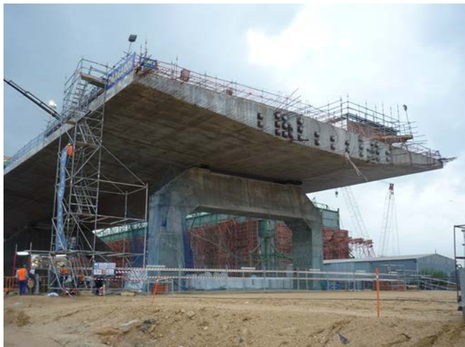
Figura 5. Frente de anclajes en cambio de fase.
