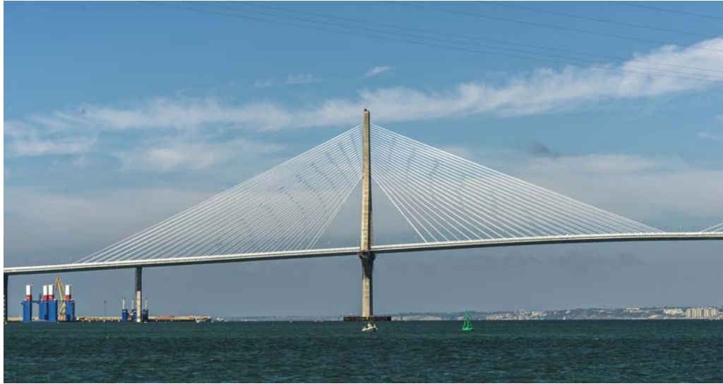
Figura 31. Vista lateral de la torre.
