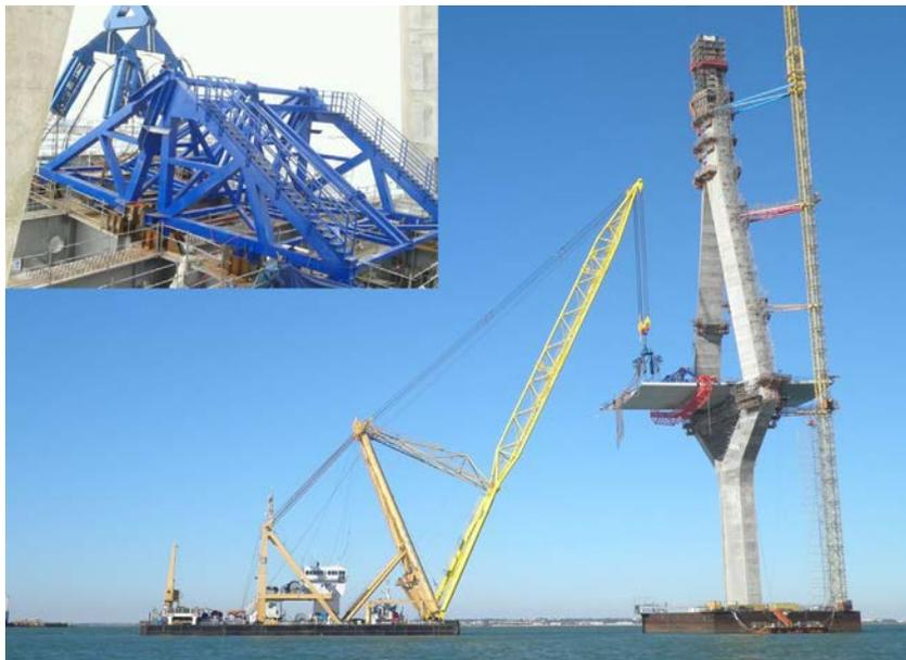
Figura 10. Elemento especial para colocación de dovelas iniciales.
