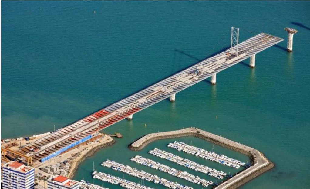
Figura 10. Vista aérea del tablero durante el empuje.
