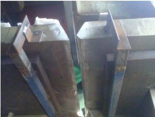
Figura 3. Maniobra de alineamiento de chapas en altura. Unión de dovelas. Espesores de 110 mm.
