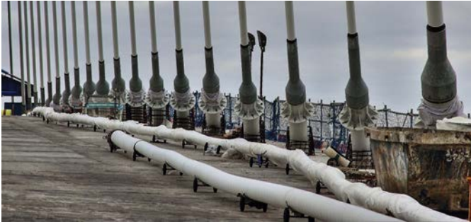
Figura 9. Vista de los amortiguadores durante la construcción.
