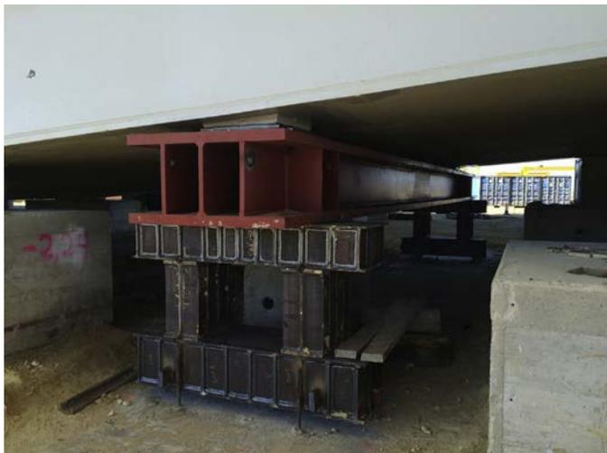
Figura 8. Apeos para pesaje del tramo desmontable.
