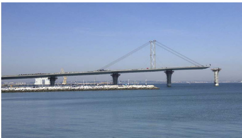
Figura 9. Sistema de atirantamiento provisional.
