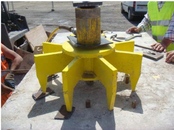
Figura 12. Ensayo de arrancamiento de perno conector en obra.
