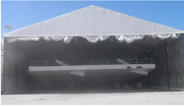
Figura 6. Instalaciones para chorro y pintura en la obra.
