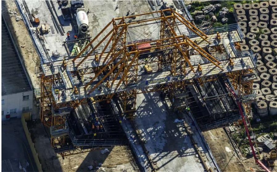
Figura 4. Tablero de hormigón. Carro de encofrado de segunda fase.
