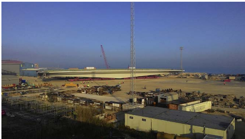
Figura 9. Transporte terrestre del tramo desmontable.
