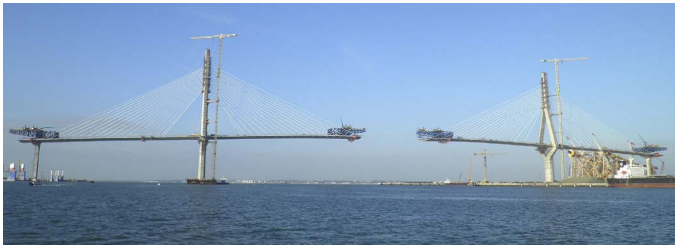
Figura 12. Fase constructiva con el tablero ya apoyado en las primeras pilas de retenida.
