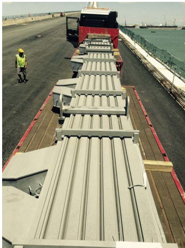
Figura 1. Junta de dilatación. Estribo 1.
