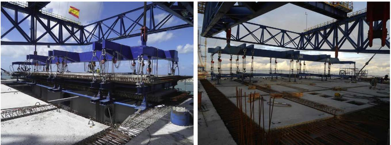
Figura 11. Colocación de las losas sobre el tablero.
