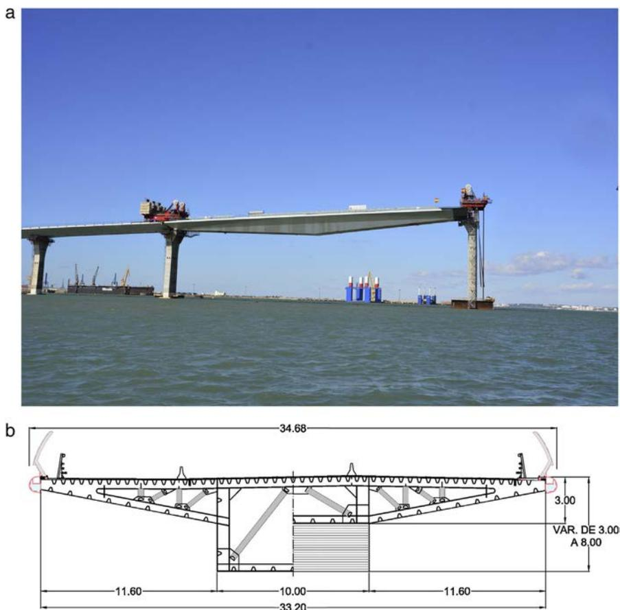
Figura 1. Alzado y sección transversal del puente desmontable.
