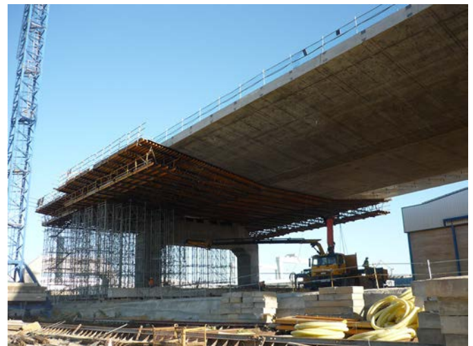
Figura 4. Descimbrando en fase de ejecución.
