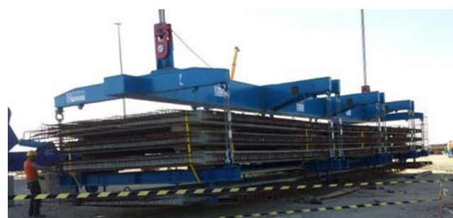
Figura 17. Paquete de losas y balancín de izado.
