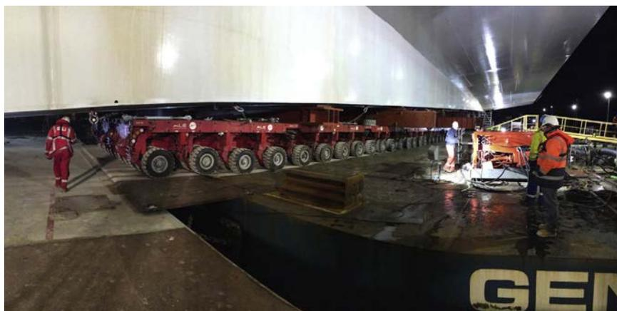
Figura 11. Embarque del tramo desmontable en la pontona.
