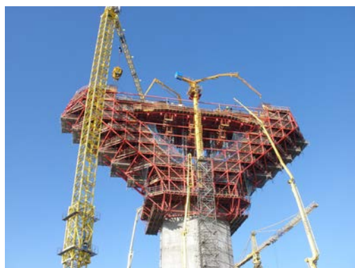
Figura 12. Cimbra de riostra.
