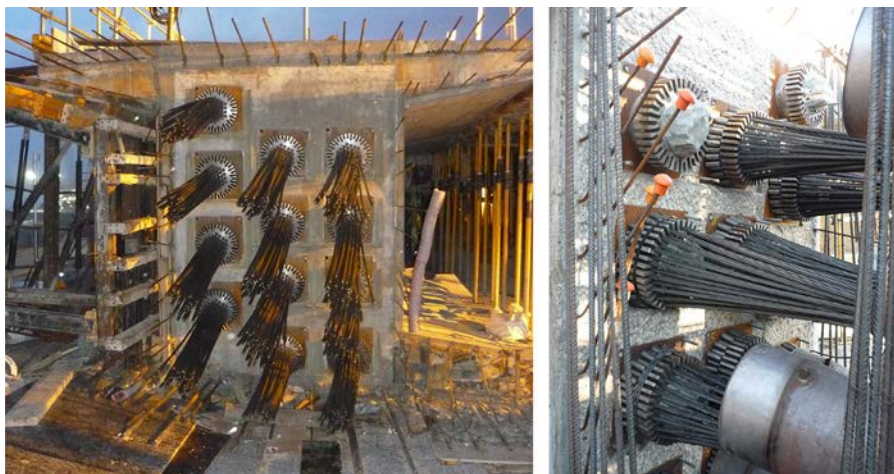
Figura 11. Anclajes en alma del pretensado de construcción y acopladores.
