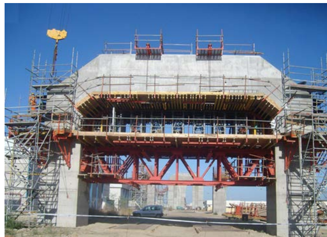
Figura 8. Construcción de pilas pórtico en tierra.
