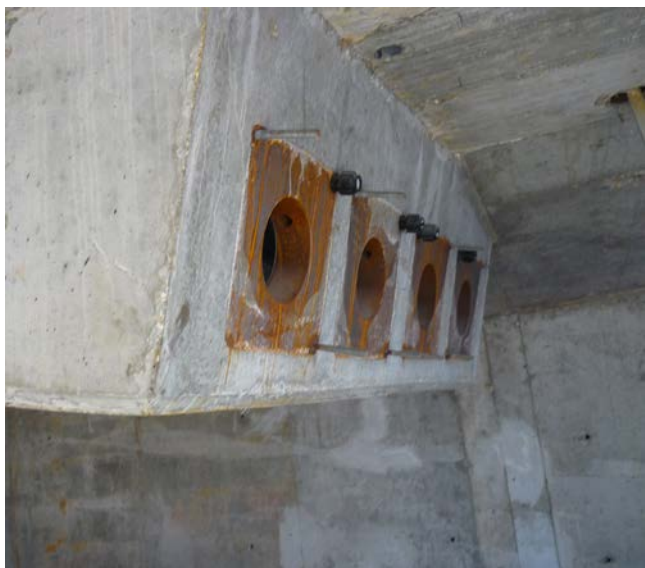
Figura 12. Anclajes pretensado en segunda fase.
