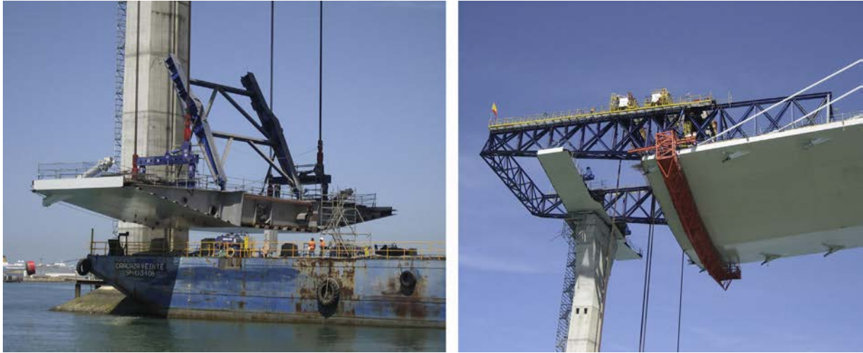
Figura 4. Izado de la última dovela del voladizo (11IP12) con la dovela de pila (0P11) ya colocada.
