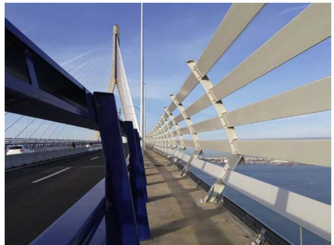
Figura 8. Pantallas antiviento en el tramo atirantado.
