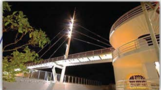
Pasarela atirantada de Nerja sobre la N-340 (Málaga) Proyecto y Asistencia
