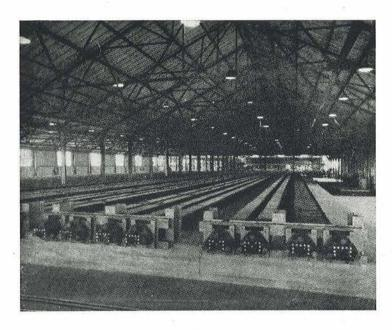
Fig. 8.—Placas de anclaje para fijar los alambres tesos.
