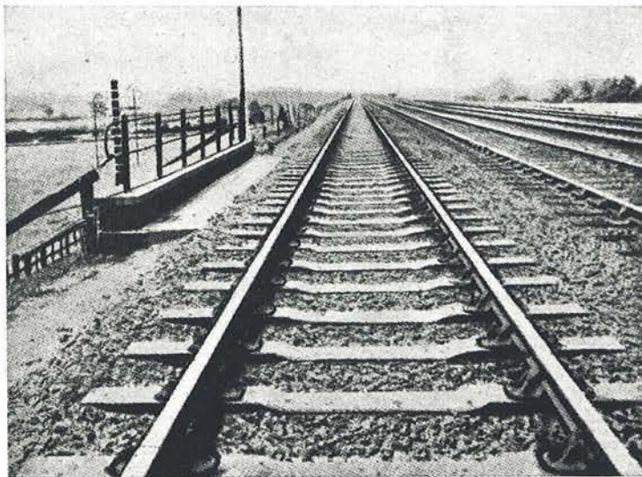
Fig. 10.—Vista de una vía férrea montada sobre traviesas de hormigón pretensado.
