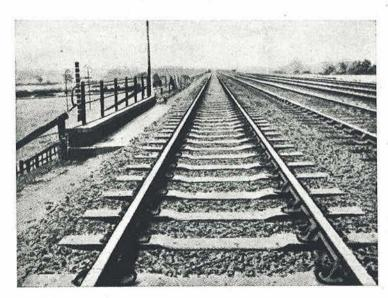
Fig. 10. - Vista de una vía férrea montada sobre traviesas de hormigón pretensado.
