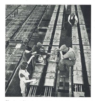
Fig. 5.—Aplicando la segunda vibración a los moldes ya llenos.
