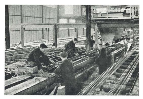
Fig. 4.—Colocación de los testeros en los moldes. Al fondo, la tolva de carga.
