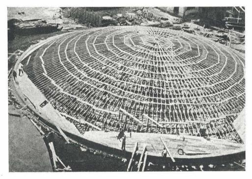
Flig. 8.— Construcción de la cubierta. Encofrado para moldear la cúpula.
