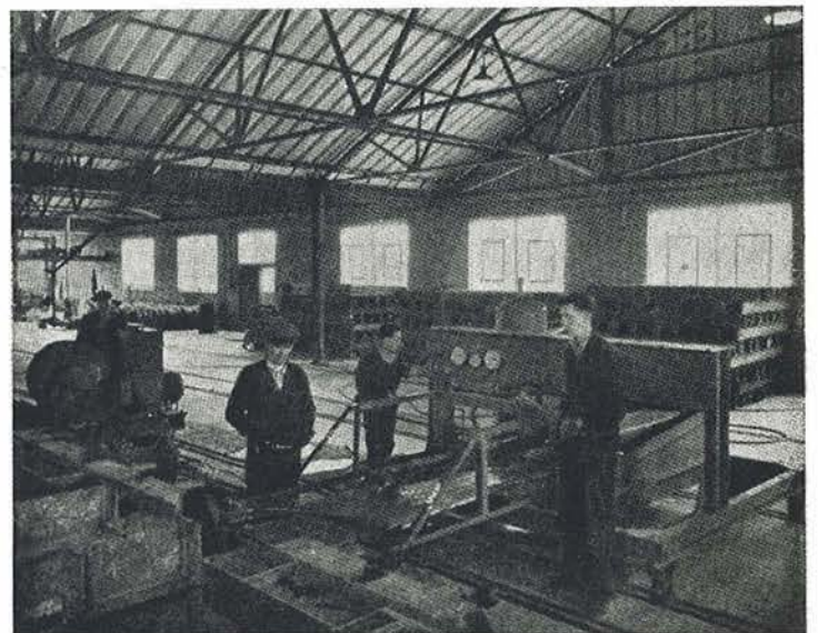
Fig. 9.—Tesando los alambres.
