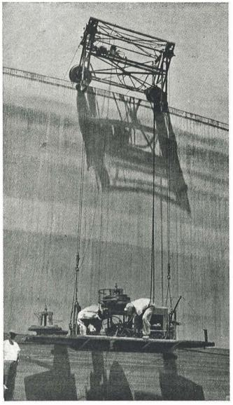
Fig. 3.-Dispositivo para efectuar el pretensado horizontal.
