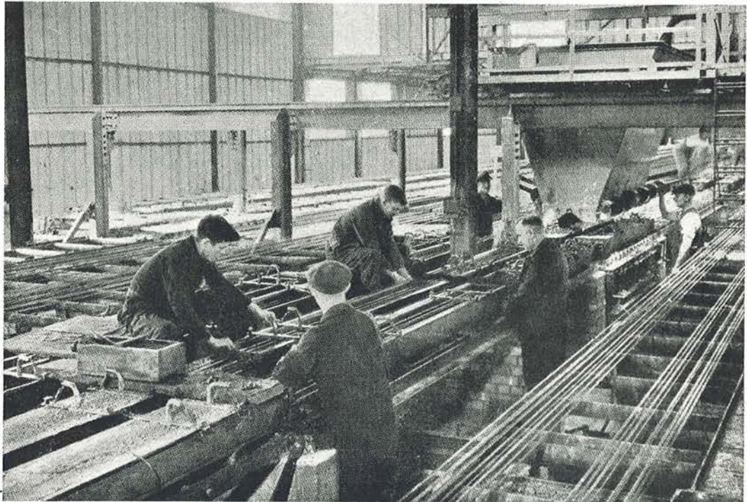
Fig. 4.—Colocación de los testers en los moldes. Al fondo, la tolva de carga.
