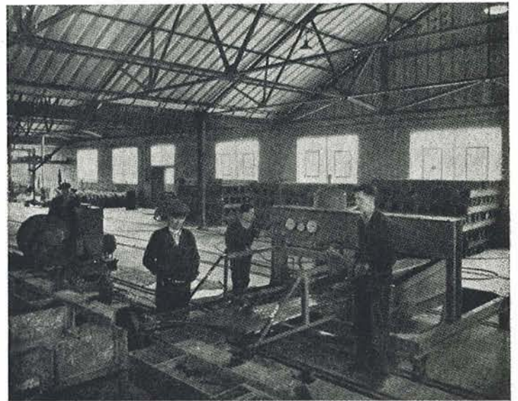
Fig. 9.—Tesando los alambres.
