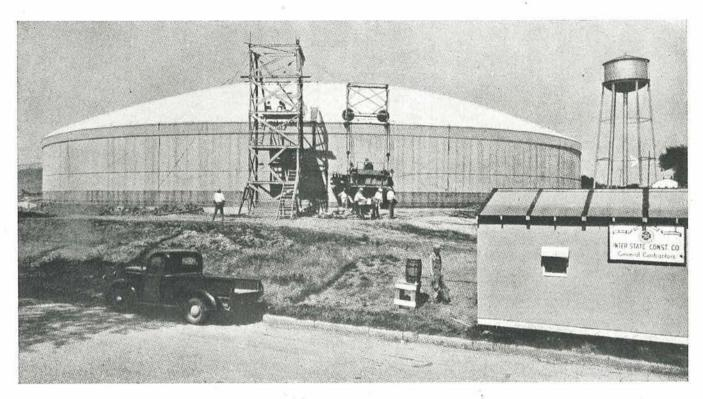
Fig. 5. — Depósito de agua en Kansas City. Diámetro 55 m. Altura 4,95 m. Capacidad 18.000 m³.
