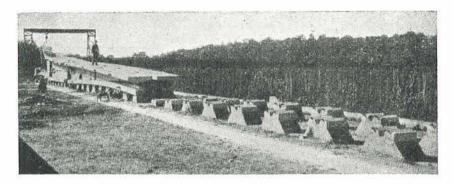
${\bf Fig.~5}$  Bancada para el montaje de las vigas.
