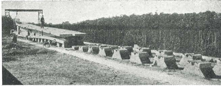
Fig. 5 Bancada para el montaje de las vigas.
