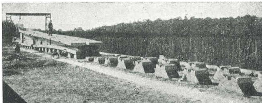
Fig. 5 Bancada para el montaje de las vigas.
