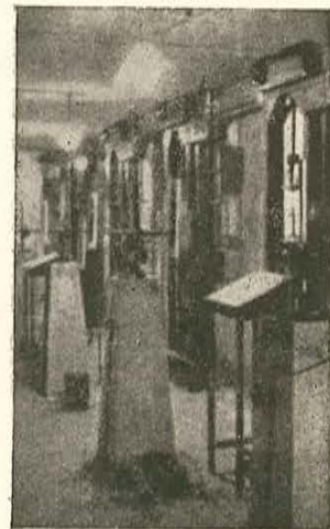
Fig. 4.—Batería de máquinas de la estación de Lovaina.
