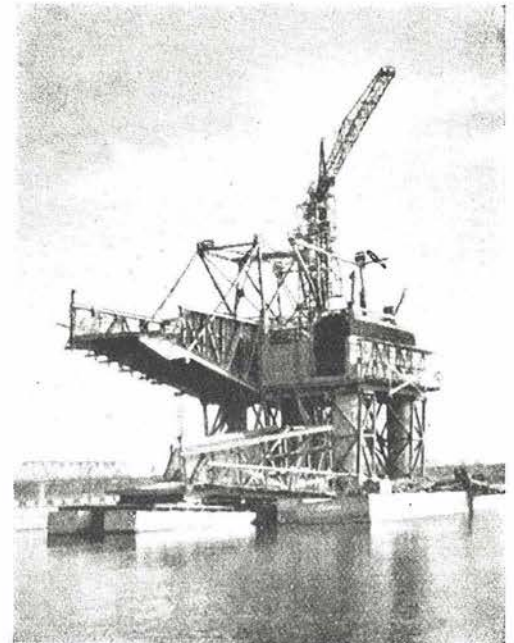
Construcción de los soportes circulares de coronación de una de las pilas. Pueden verse los elementos metálicos que servirán después para soportar la cimbra de las vigas en ménsula.
