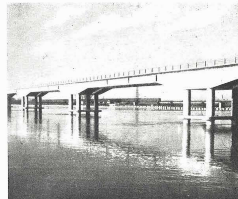
Vista de uno de los tramos, de 65 m de luz, en el puente ya terminado.
