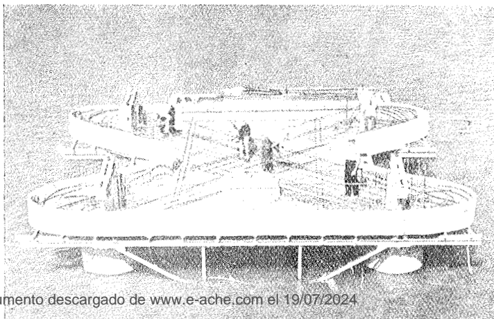
Construcción de una de las placas de hormigón armado, de 60 cm de espesor, que enlaza las cabezas de los pilotes de cimentación de las pilas.
