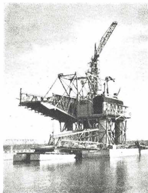
Construcción de los soportes circulares de coronación de una de las pilas. Pueden verse los elementos metálicos que servirán después para soportar la cimbra de las vigas en ménsula.
