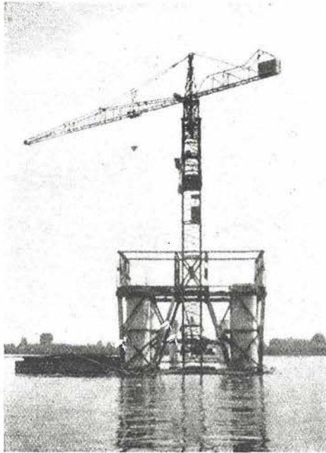
Construcción de los soportes circulares de coronación de una de las pilas. Pueden verse los elementos metálicos que servirán después para soportar la cimbra de las vigas en ménsula.
