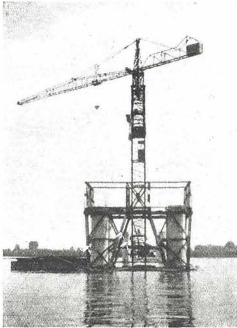
Construcción de los soportes circulares de coronación de una de las pilas. Pueden verse los elementos metálicos que servirán después para soportar la cimbra de las vigas en ménsula.
